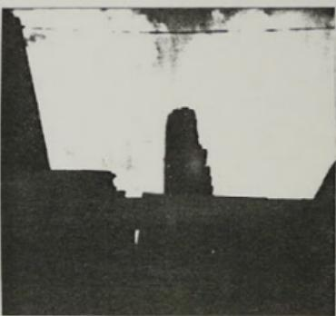
FOTO N° 06 - Detalhe de parede superior renquecente do imóvel nº 11 com risco de desabamento. Manta escoramento imediatamente sob o risco de causar acidente nos moradores da casa ao lado.
