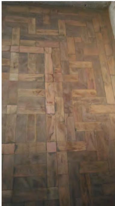
Foto 9: Lixamento superficial para substituição de peças.
