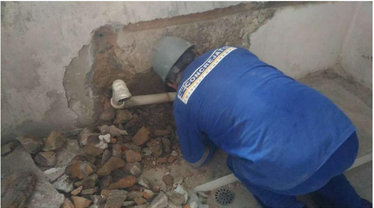
Foto 37: Execução do novo sistema de hidráulica (esgoto; alimentação de água e alimentação de água de reuso).
