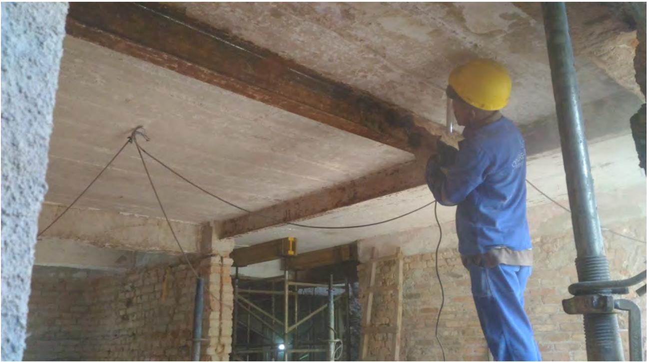
Foto 13: Tratamento das vigas metálica existentes.
