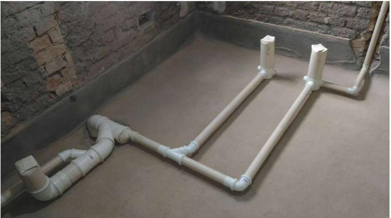
Foto 23 – Execução do novo sistema de hidráulica (esgoto; alimentação de água e alimentação de água de reuso).
