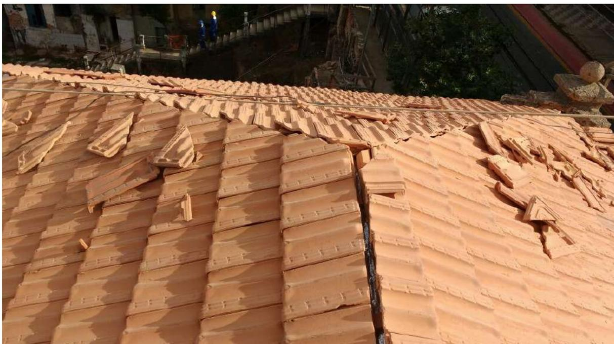
Foto 39: Recortes da telha e cummeira do telhado
