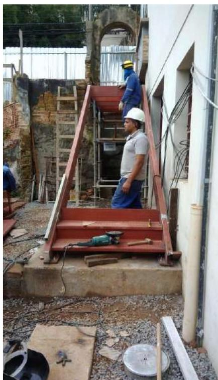
Foto 19: Montagem da escadaria metálica da fachada lateral
