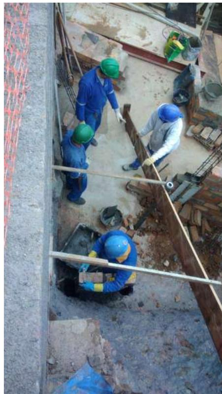
Foto 27: Reorganização dos níveis do talude e acesso a passarela;
