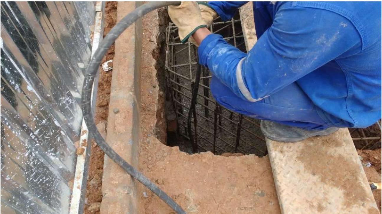
Foto 18: Concretagem dos blocos.
