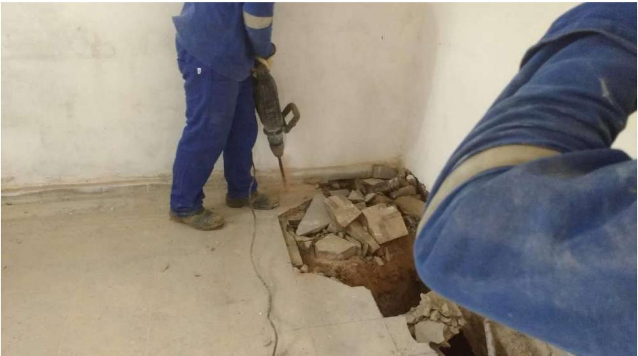
Foto 66: Demolição dos pisos do -2 subsolo
