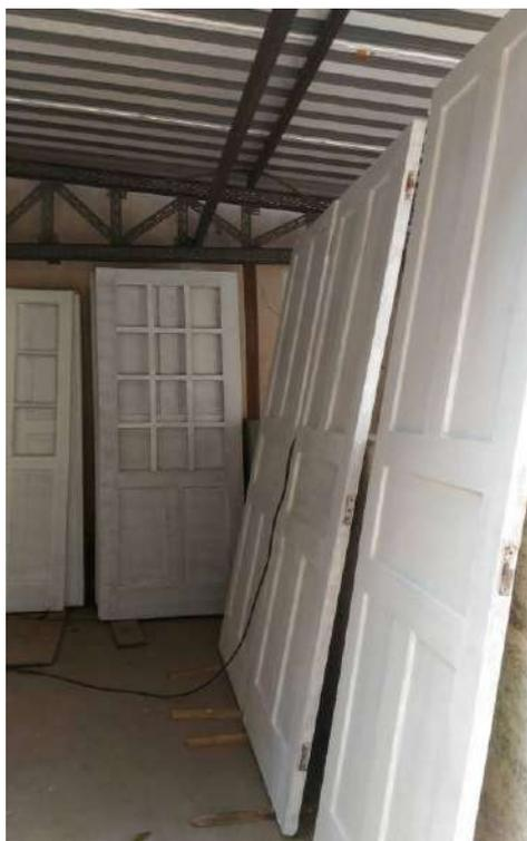
Foto 11: Esquadrias emassadas – Preparação para pintura de acabamento.
