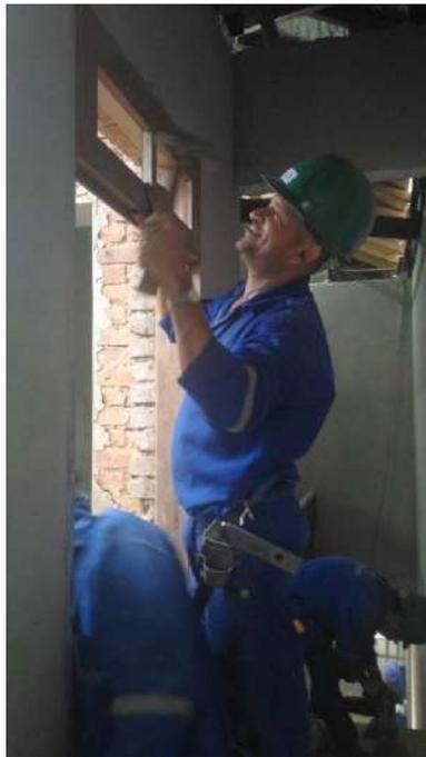
Foto 34: Instalação de nova bandeira de madeira.
