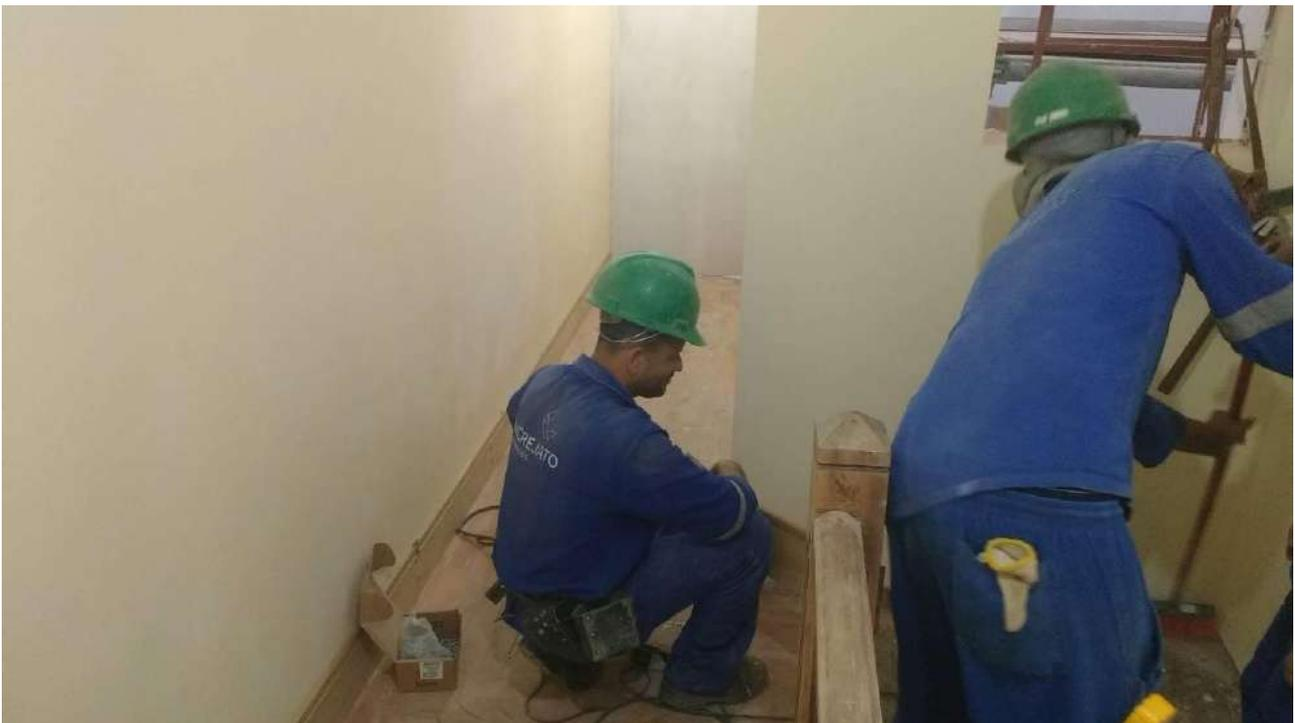
Foto 40: Instalação dos rodapés de acabamento.
