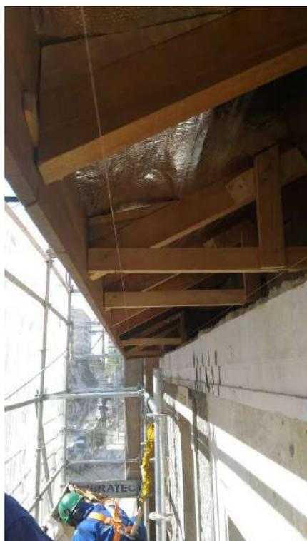
Foto 42: Madeiramento do Beiral e testeira
