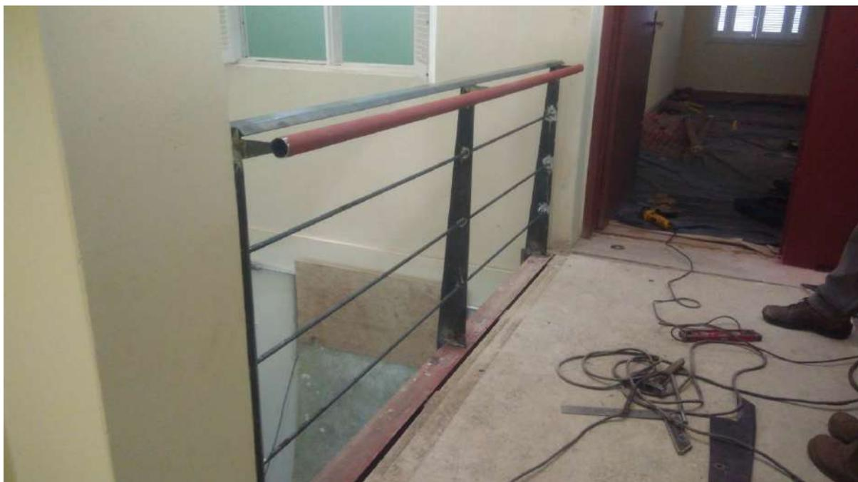
Foto 45: Instalação do guarda corpo da passarela interna;
