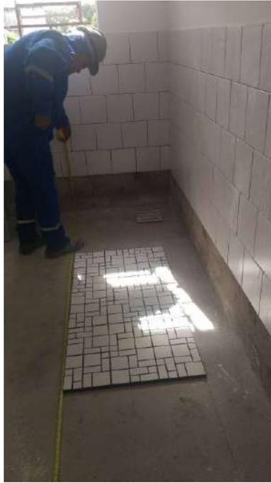
Foto 31: Instalação dos ladrilhos hidráulicos.
