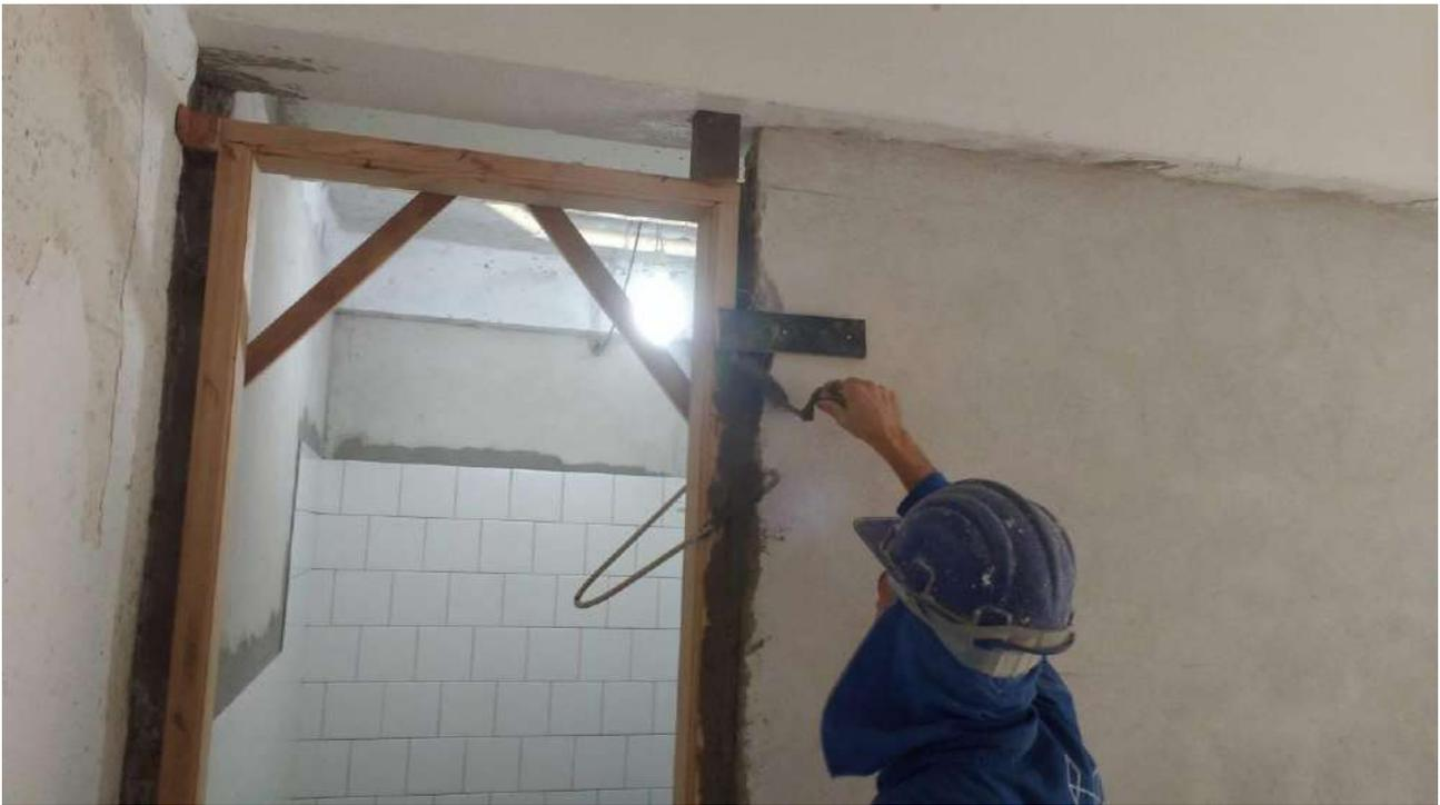
Foto 45: Instalação de batente -2 subsolo.
