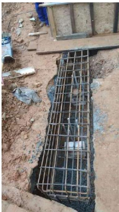
Foto 13: Blocos para sustentação de escadaria e passarela metálica.
