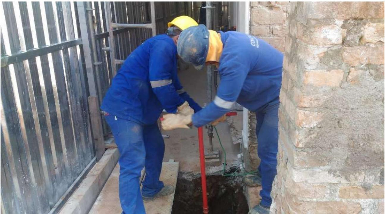
Foto 02: Abertura das valas para execução dos blocos da escadaria.
