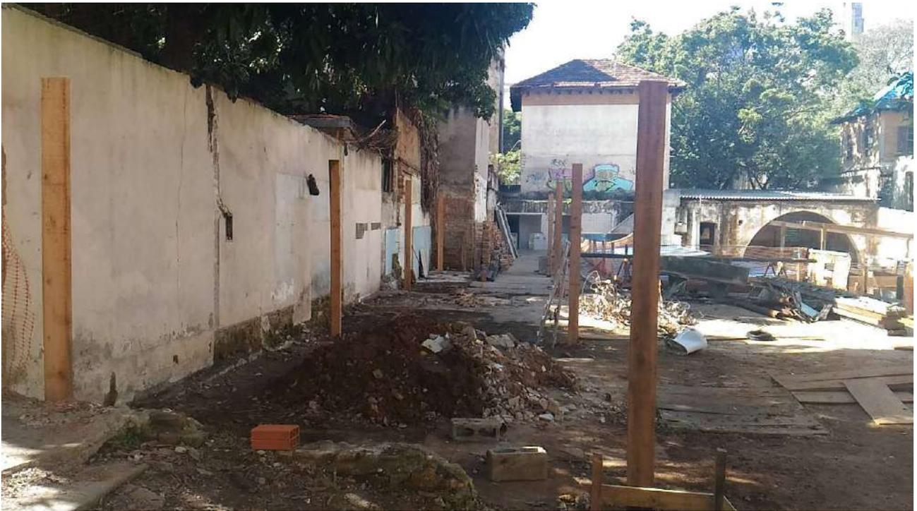
Foto 05: Montagem do barracão de apoio à obra
