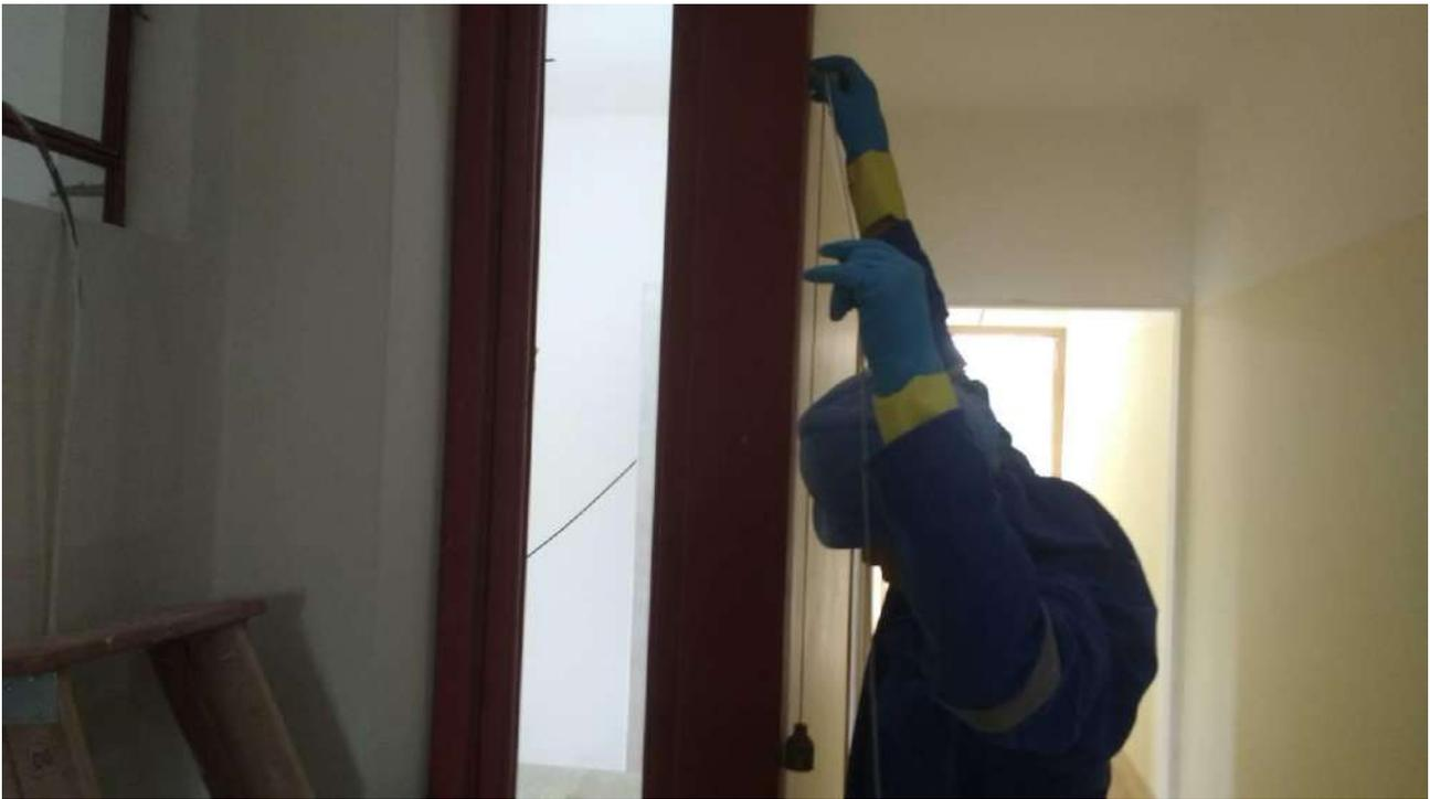
Foto 67: Instalação das esquadrias metálicas.
