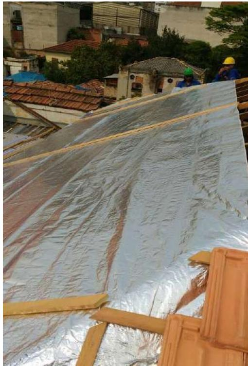
Foto 20 – Instalação da manta de subcobertura do telhado
