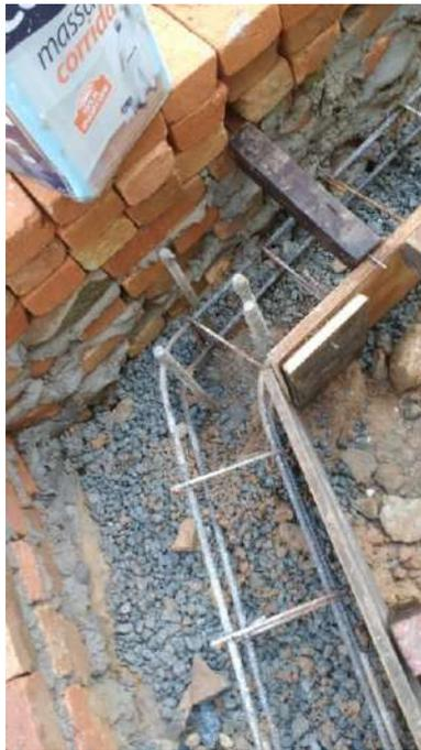
Foto 73: Execução de viga invertida no talude.
