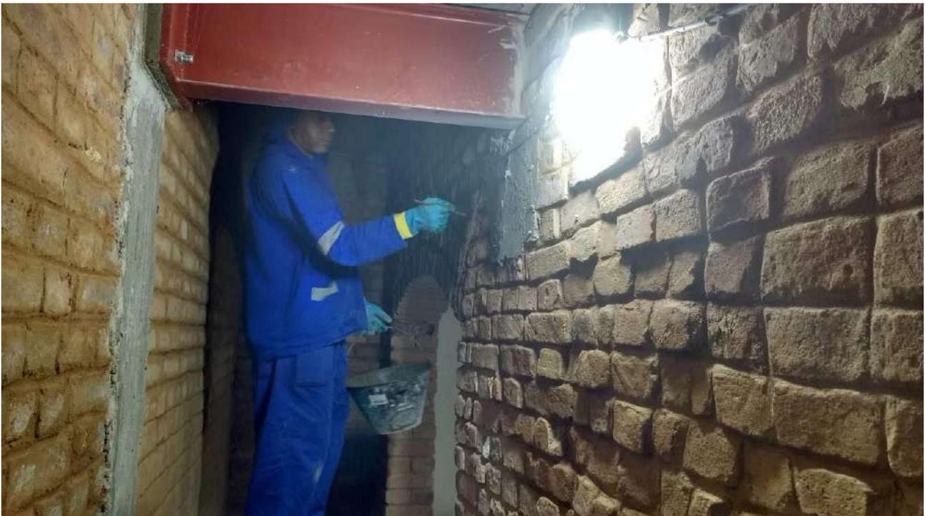
Foto 24: Acabamento dos tijolos aparentes do -1 subsolo.
