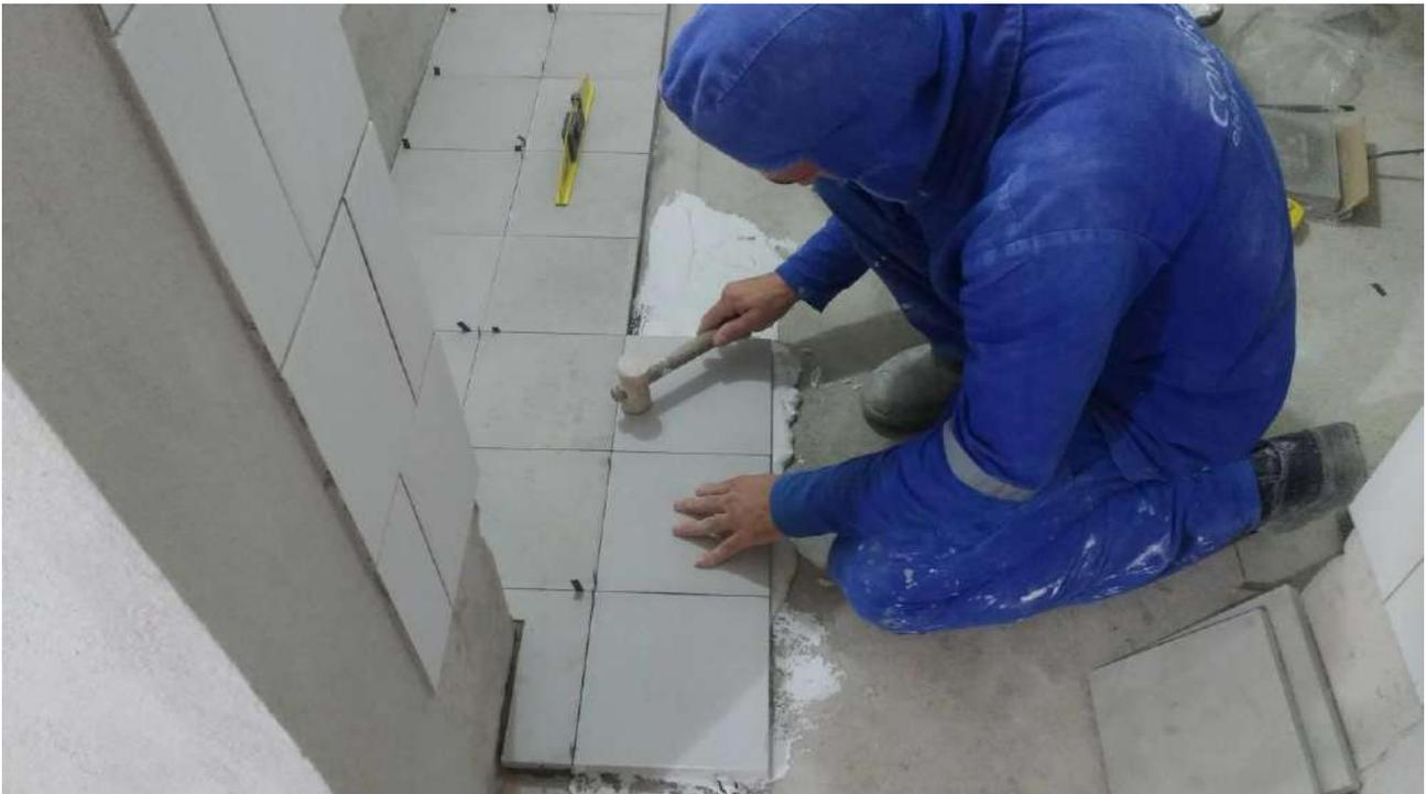
Foto 60: Instalação de ladrilho hidráulico.
