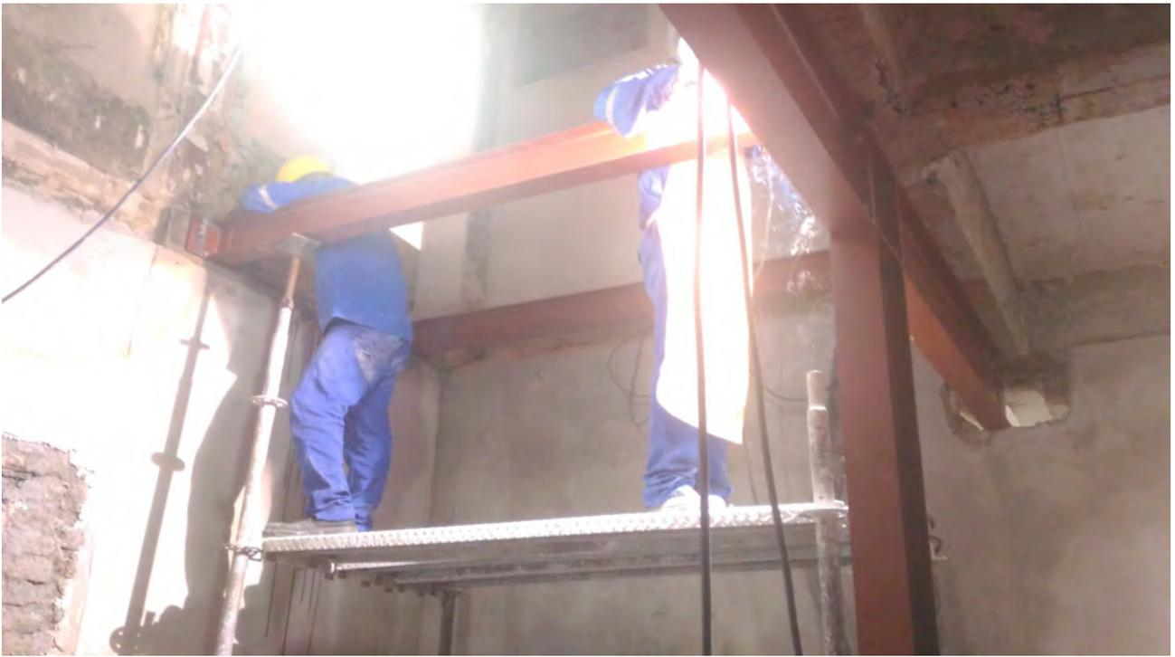
Foto 39: Instalação da passarela metálica.
