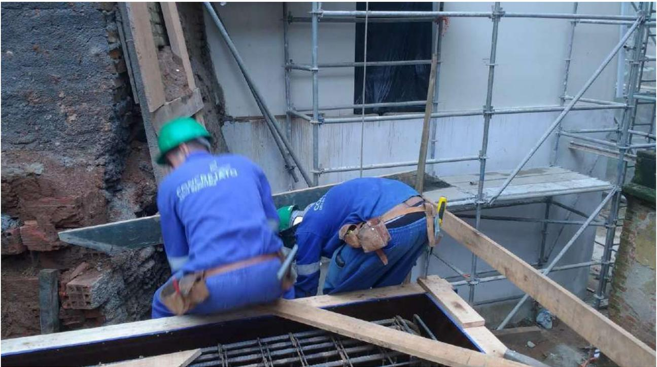
Foto 03: Execução de fôrma e armadura das vigas em balanço de sustentação da passarela metálica.
