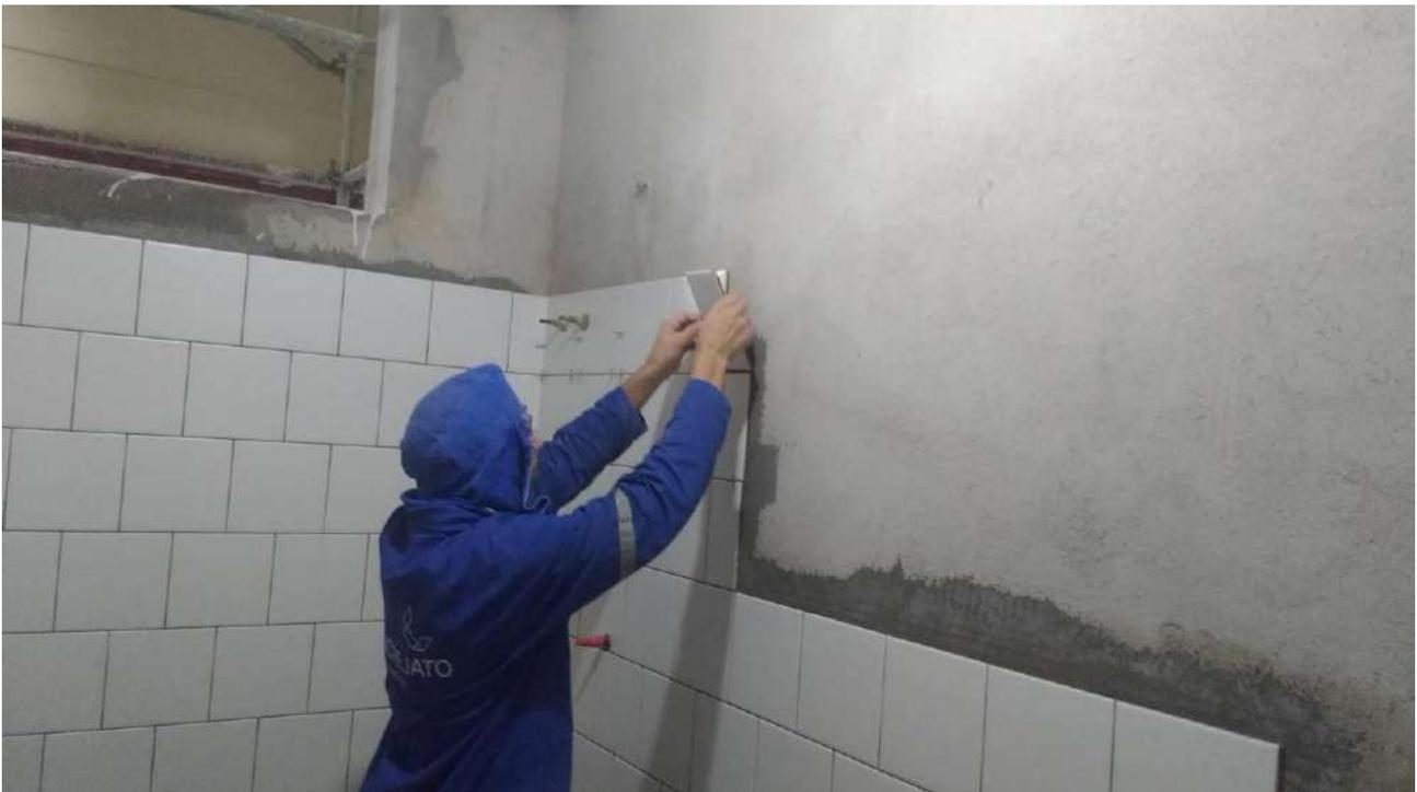
Foto 58: Instalação de revestimento cerâmico no -2 subsolo.
