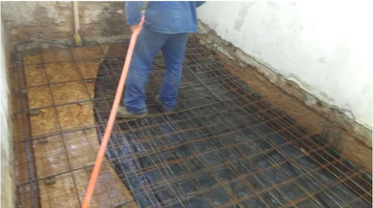
Foto 47: Armação das laje da cozinha do -2 subsolo.
