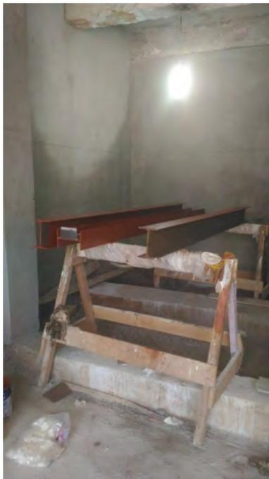
Foto 18: Instalação dos pilares e vigas metálicas no -1 subsolo.
