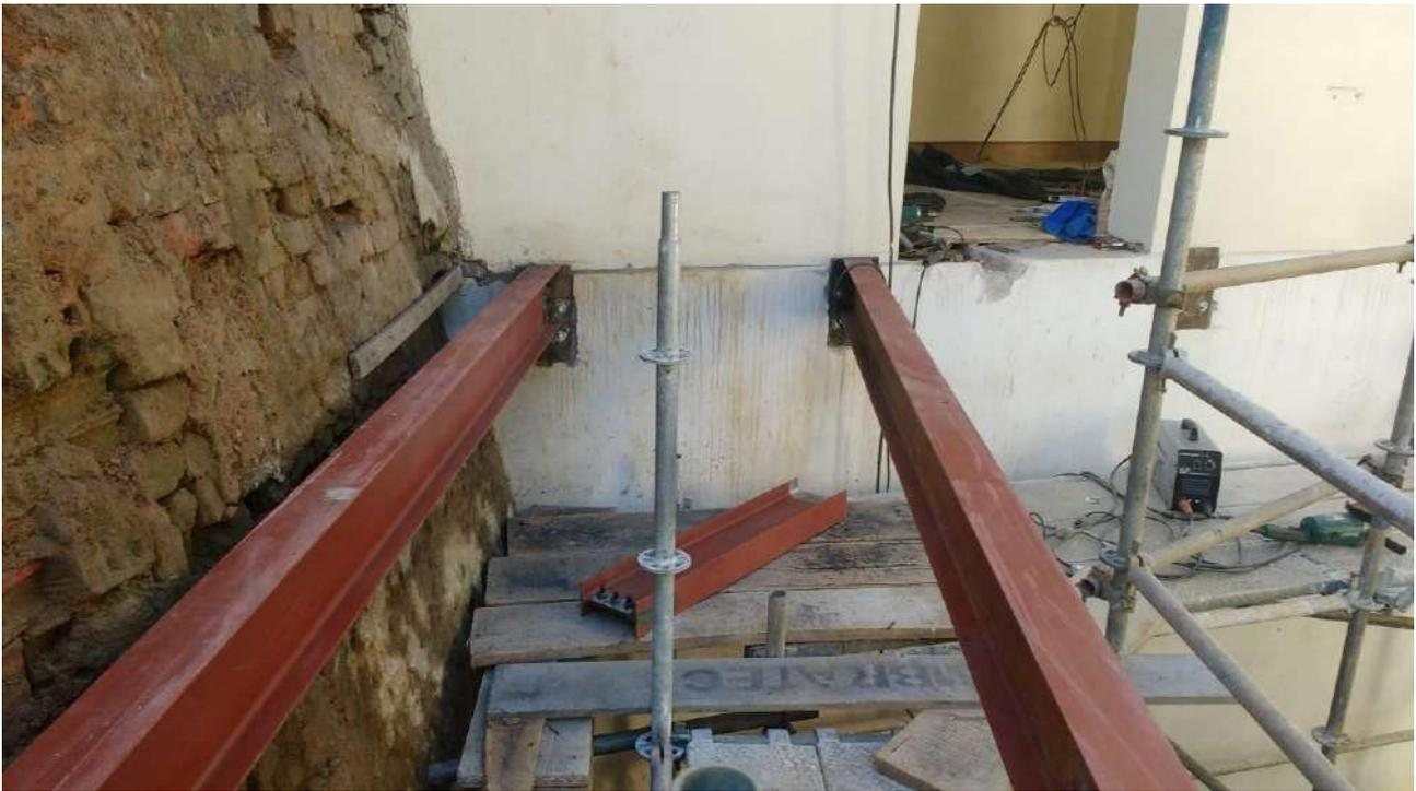
Foto 33: Montagem da passarela metálica de acesso ao -2 pavimento.
