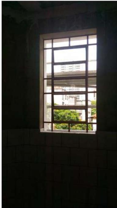
Foto 33: Instalação de vitrô metálico novo.
