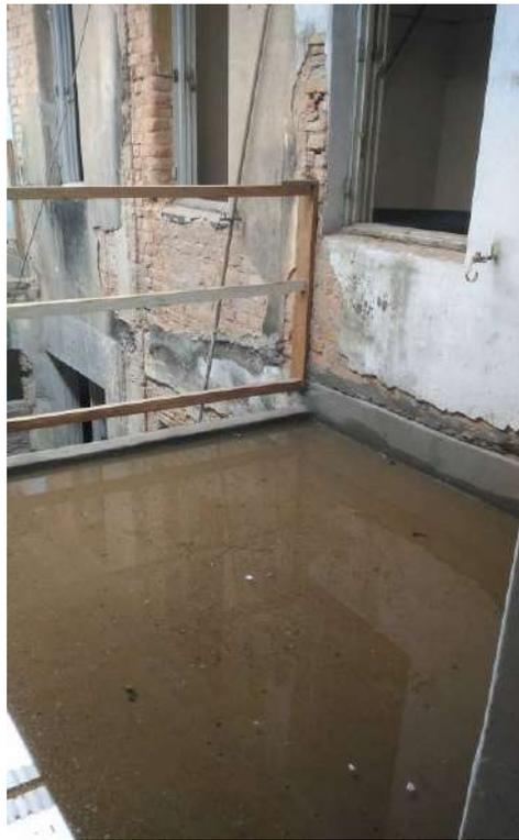
Foto 37: Teste da impermeabilização externa.
