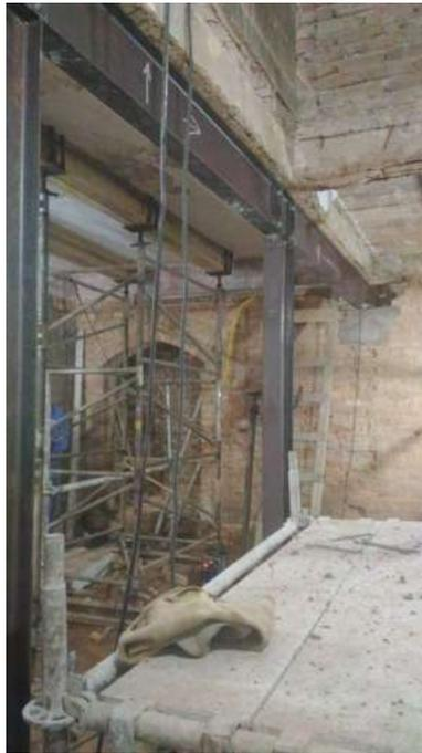
Foto 15: Instalação dos pilares e vigas metálicas no -1 subsolo.
