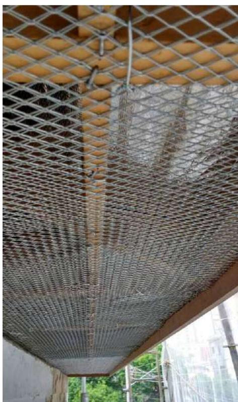
Foto 66: Instalação das telas deployer .
