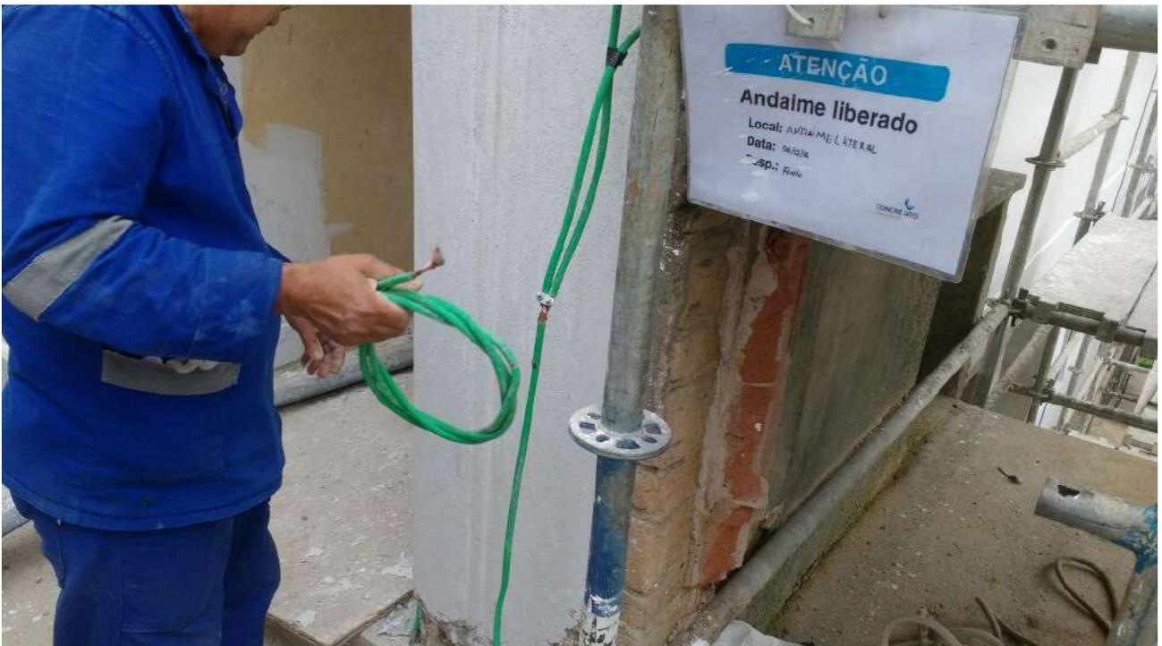
Foto 42: Aterramentos das estruturas metálicas.
