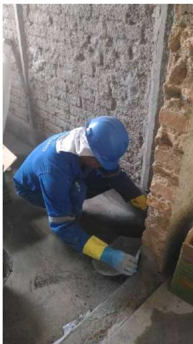
Foto 65: Aplicação de manta poliéster nos pisos.
