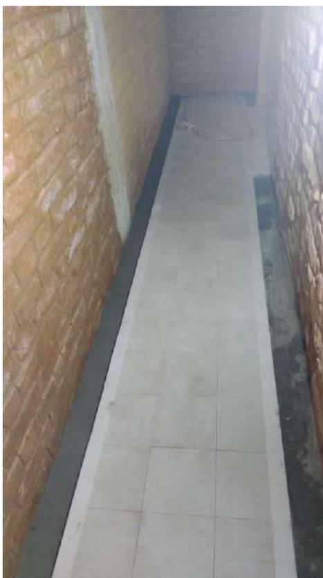
Foto 65: Acabamento do recuo dos pisos no -1 subsolo.
