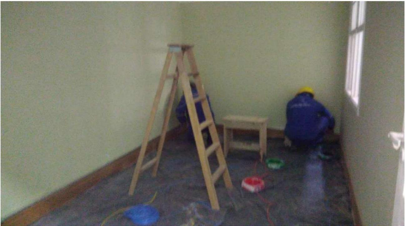
Foto 18: Instalação dos rodapés de madeira.
