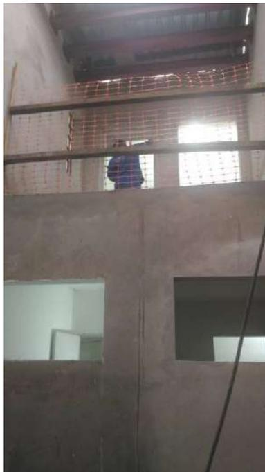
Foto 22: Preparação para massa fina na fachada dos poço.
