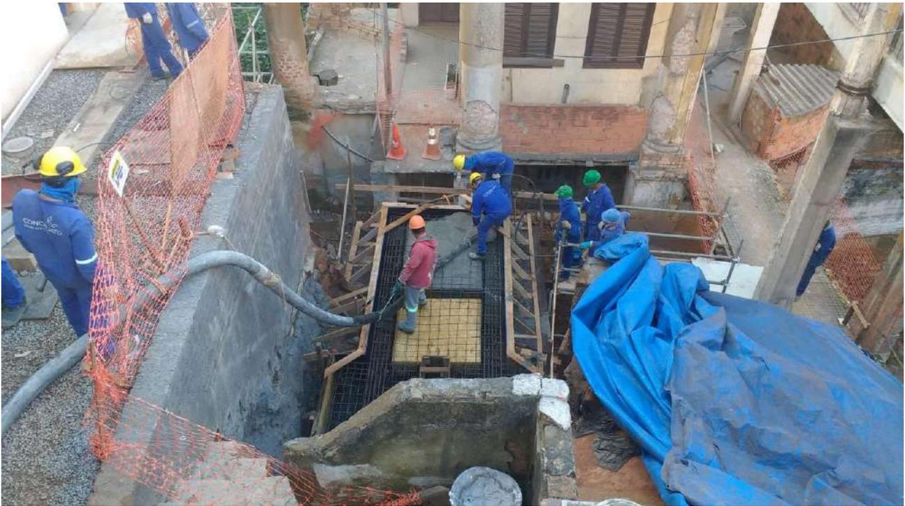
Foto 05: Concretagem das vigas de concreto.
