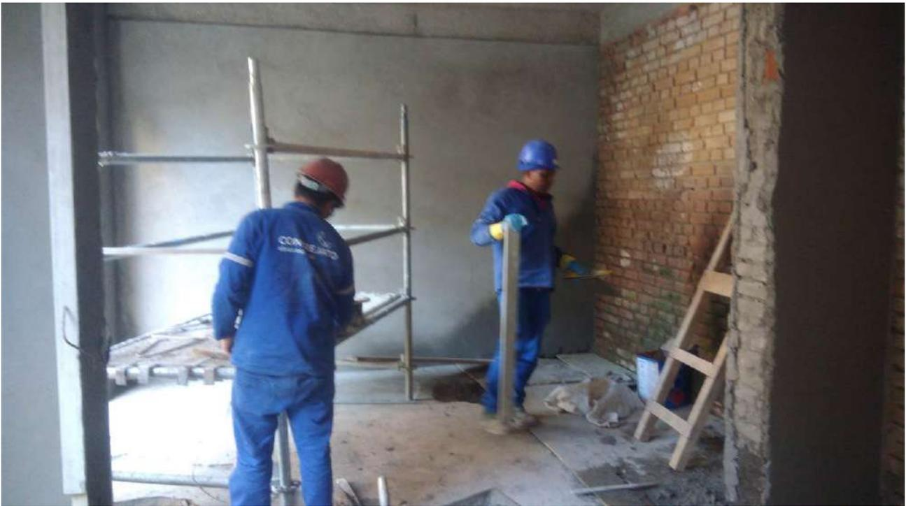
Foto 94: Revestimentos dos pilares do -3 subsolo;
