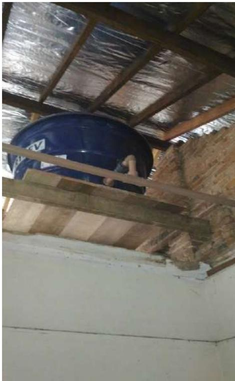
Foto 30: Instalação das caixas d' água e execução do barrilete.
