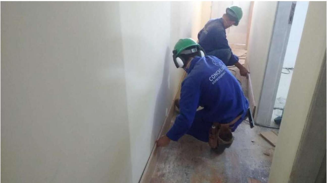
Foto 50: Instalação de rodapés de madeira.
