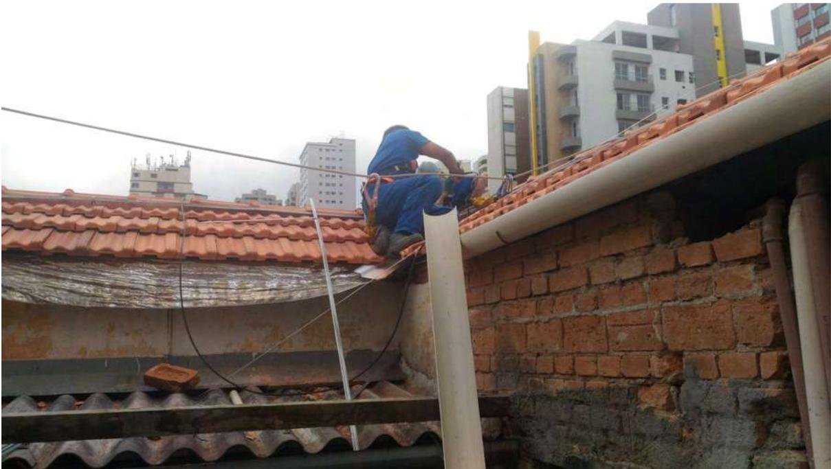
Foto 20: Instalação do para-raio da Casa 11
