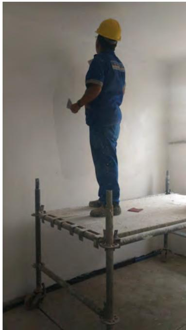
Foto 05: Emassamento das alvenarias.
