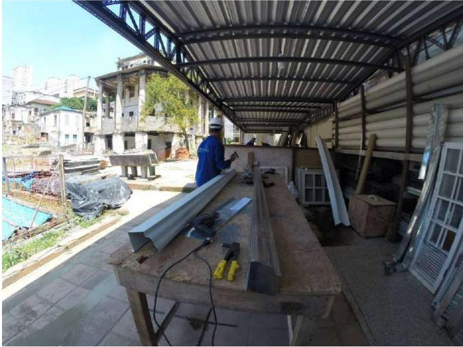
Foto 01: Preparação e instalação das calhas da Casa 11
