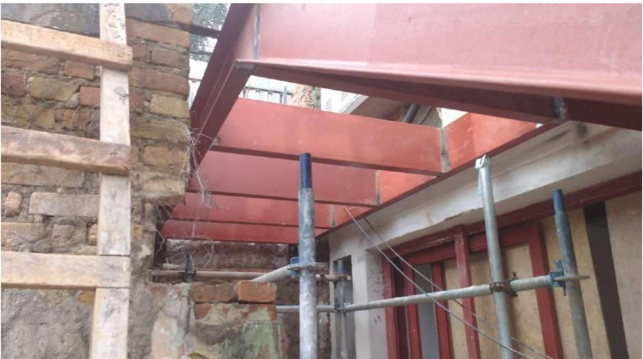
Foto 16: Montagem da escadaria metálica da fachada lateral
