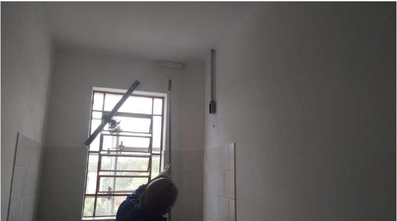
Foto 46: Instalação da infra aparente de elétrica
