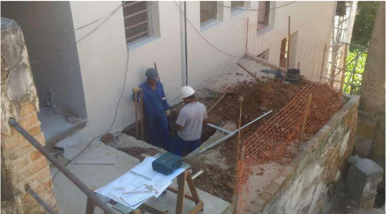
Foto 06: Abertura das valas para execução dos blocos da escadaria.
