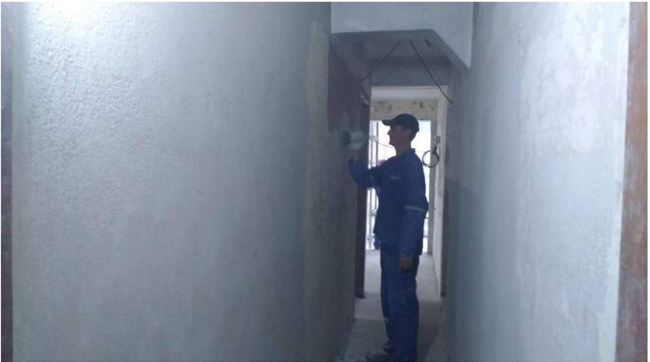
Foto 23: Preparação da alvenaria para emassamento.
