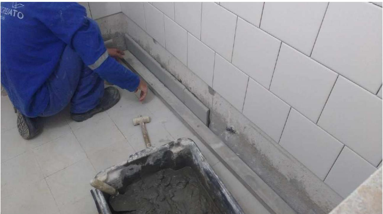
Foto 44: Instalação de rodapé nos banheiros do -2 subsolo.
