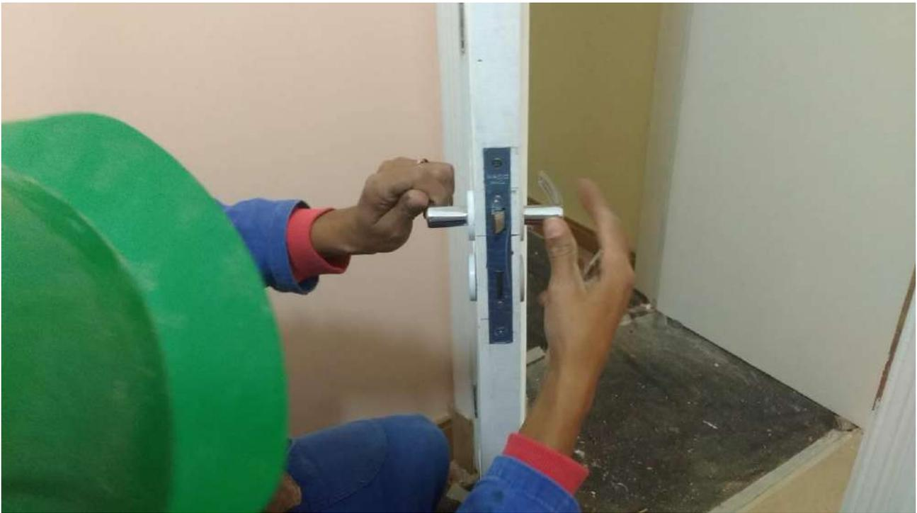
Foto 71: Instalação das fechaduras.
