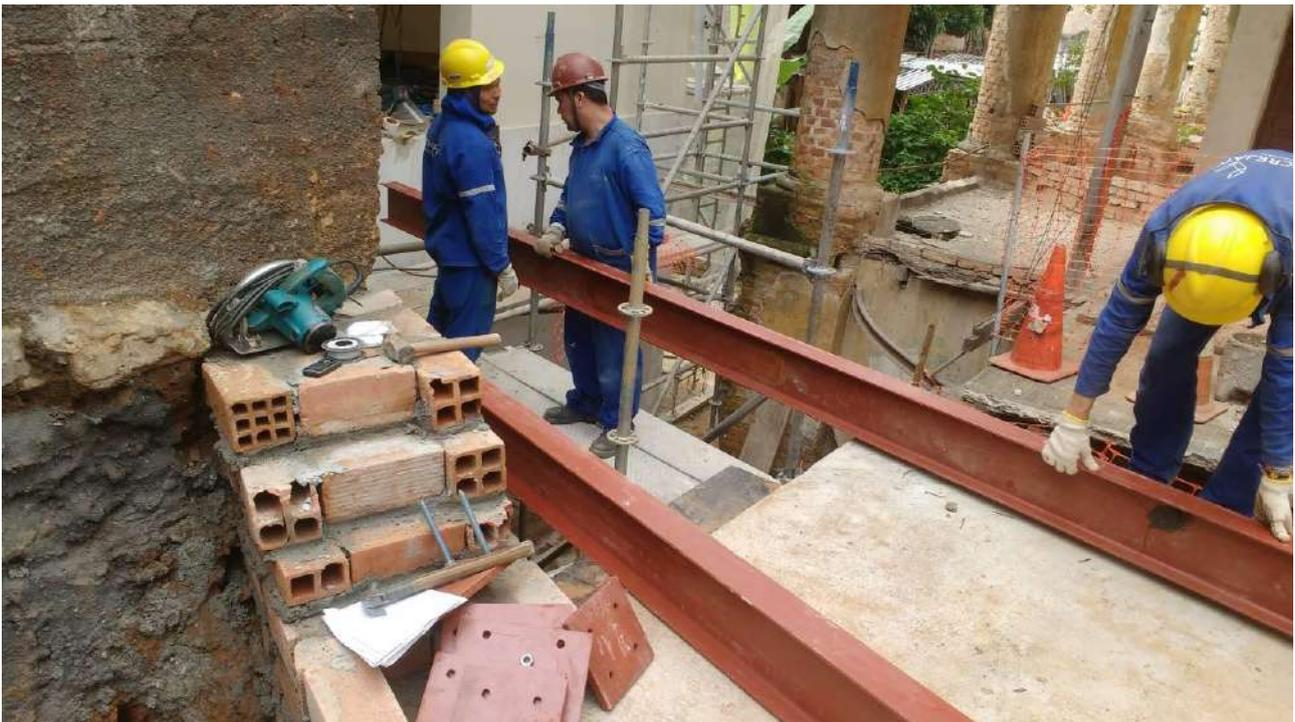
Foto 30: Montagem da passarela metálica de acesso ao -2 pavimento.
