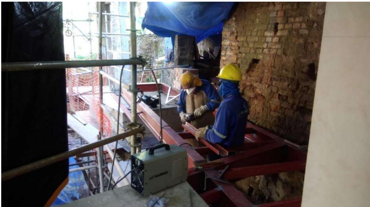
Foto 40: Montagem da passarela metálica de acesso ao -2 pavimento
