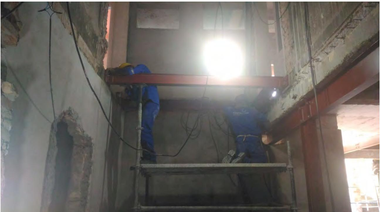
Foto 40: Instalação da passarela metálica.
