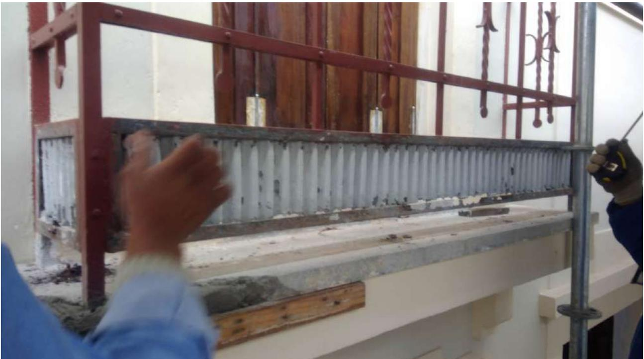
Foto 67: Substituição da chapa ondulada da fachada;
