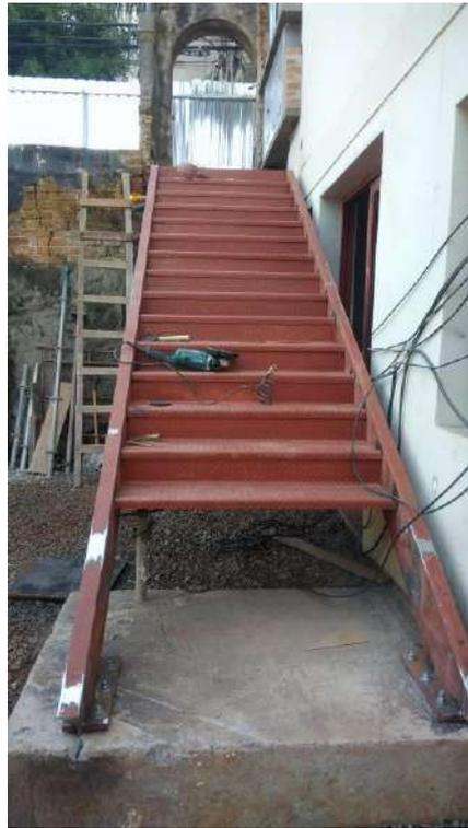
Foto 27: Montagem da escadaria metálica.
