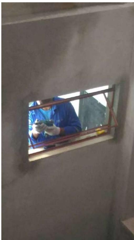
Foto 04: Instalação das esquadrias metálicas.
