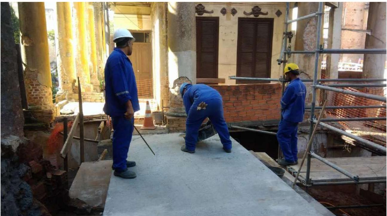
Foto 12: Desfôrma dos blocos de e vigas de concreto.
