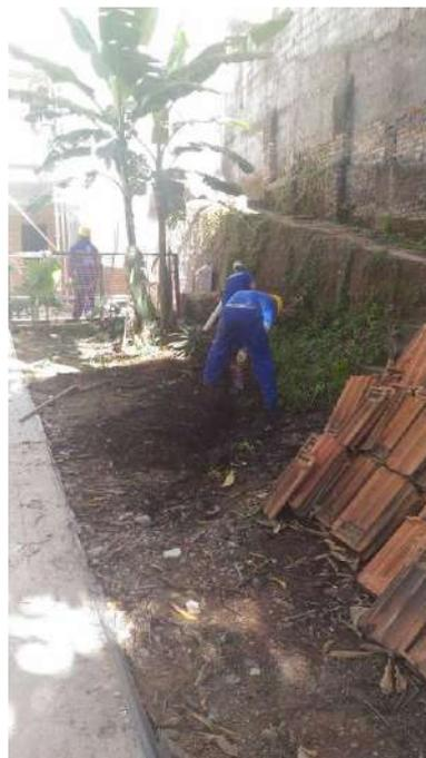
Foto 38: Execução de vala e caixa de esgoto da Casa 11
