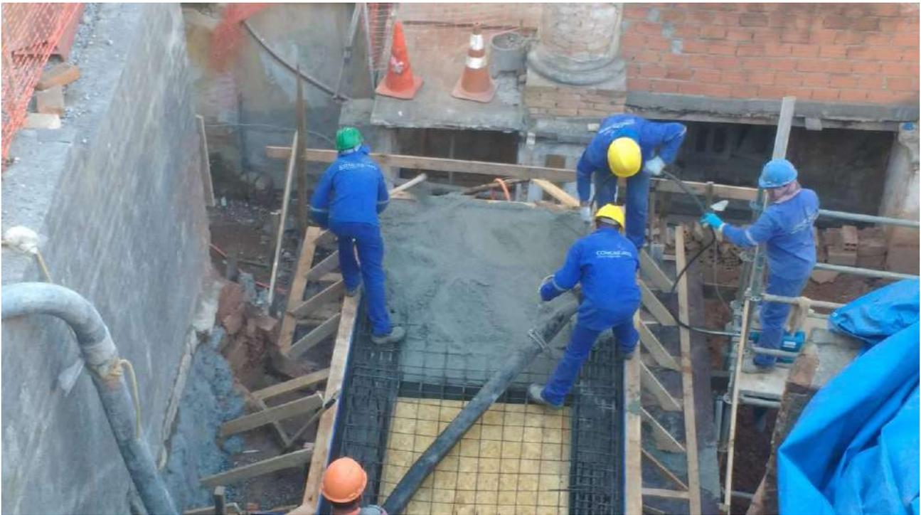
Foto 07: Concretagem das vigas de concreto.
