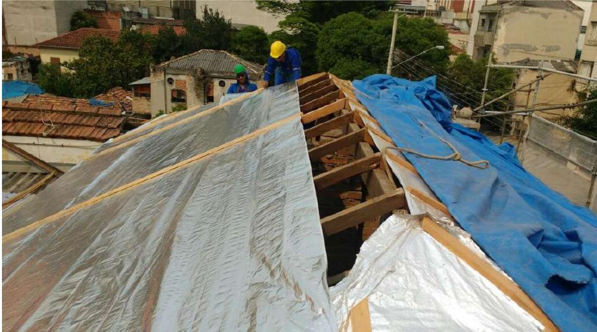
Foto 21: Instalação da manta de subcobertura do telhado
