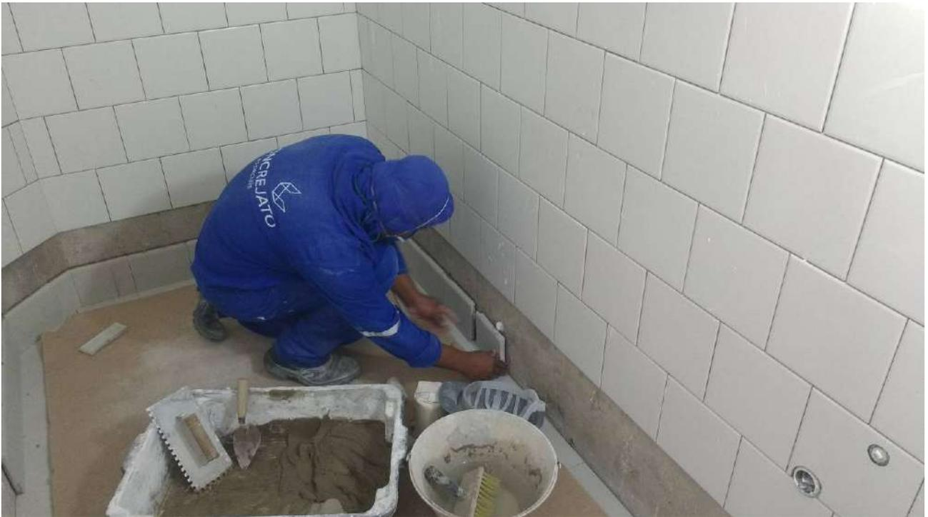
Foto 01: Instalação dos rodapés
