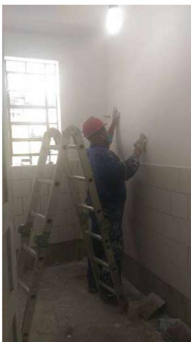
Foto 26: Lixamento para pintura de acabamento.
