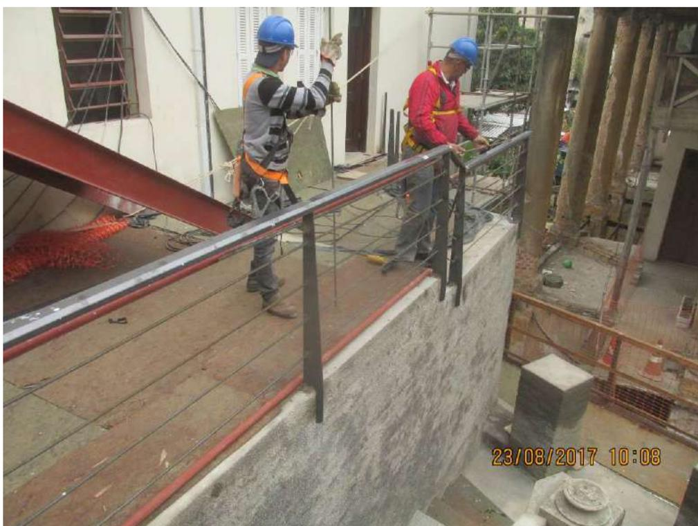
Foto 16: Instalação do guarda corpo do talude;
