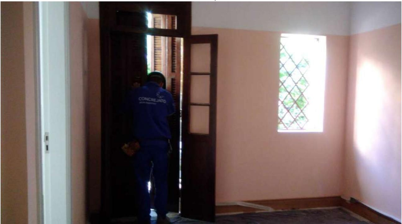
Foto 11: Instalação das fechaduras das portas balcões;
