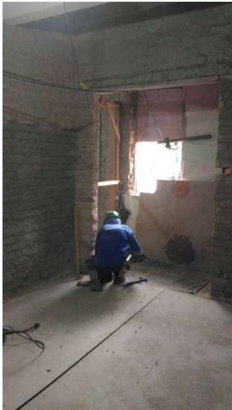
Foto 07: Instalação dos batentes das portas de madeira.
