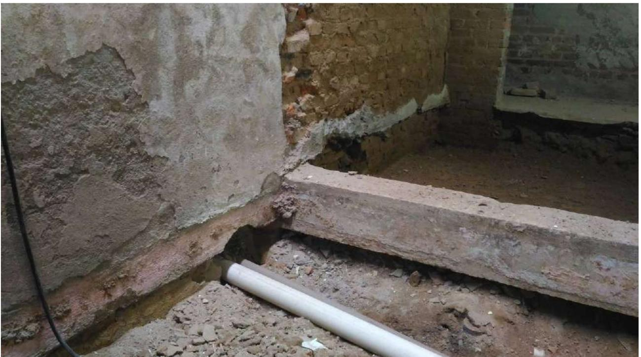
Foto 24 – Execução do novo sistema de hidráulica (esgoto; alimentação de água e alimentação de água de reuso).
