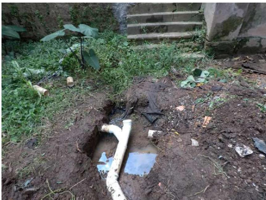
Foto 04 – Instalação da tubulação para redirecionamento da água de esgoto do vizinho – casa 11
