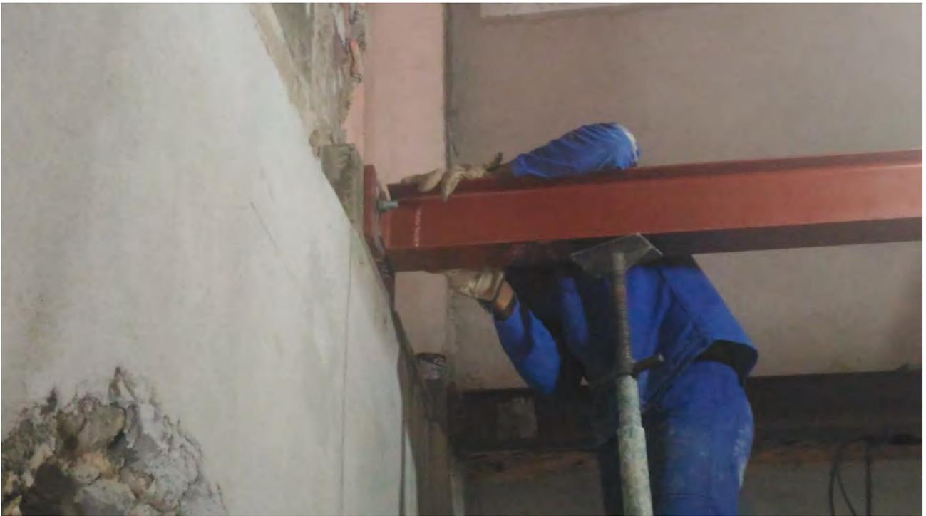
Foto 39: Instalação da passarela metálica.
