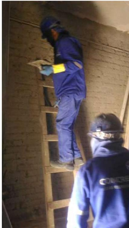
Foto 57: Chapisco das alvenarias internas
