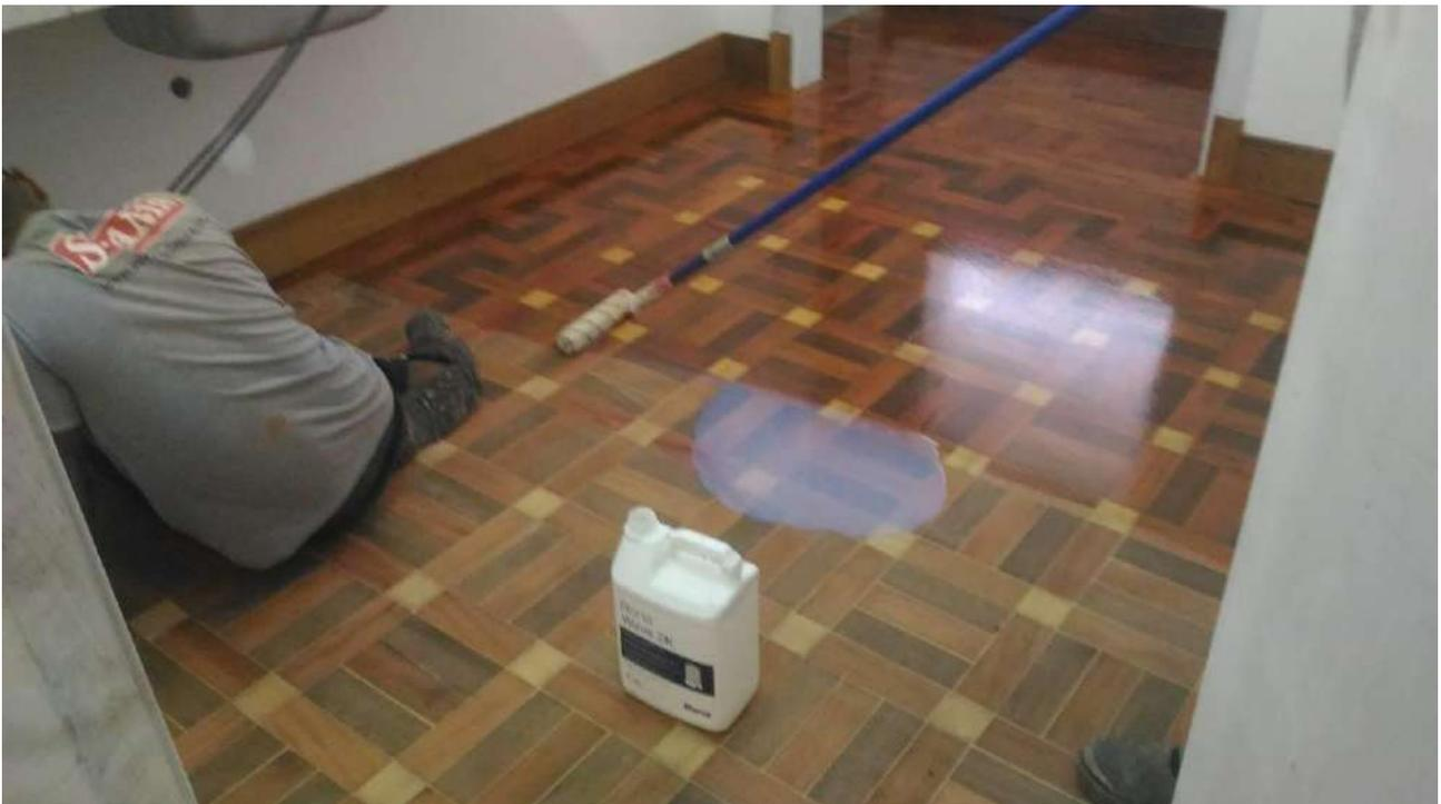
Foto 62: Aplicação de acabamento nos pisos de madeira.
