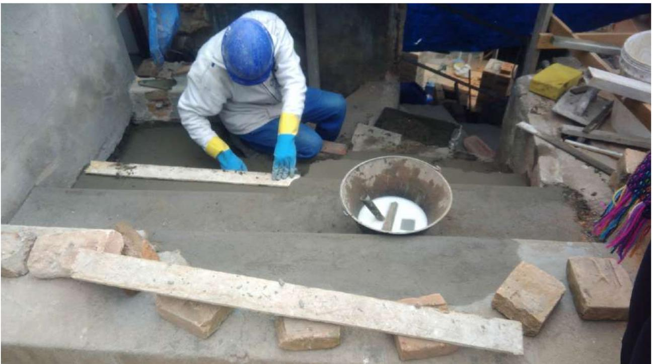
Foto 61: Revestimento dos degraus da escadaria.
