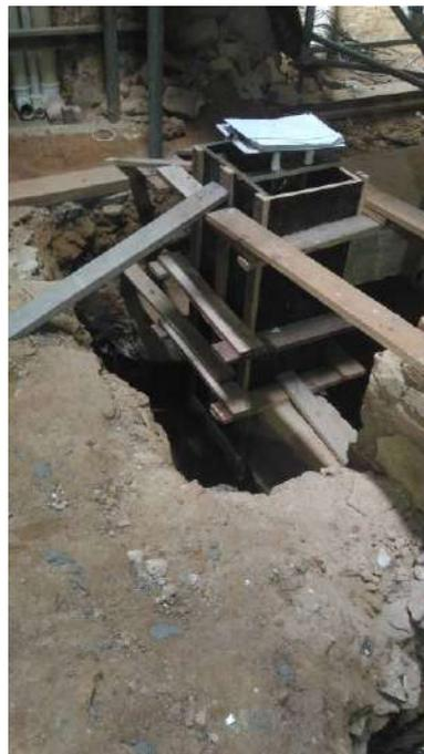
Foto 24: Execução das fôrmas para concretagem.
