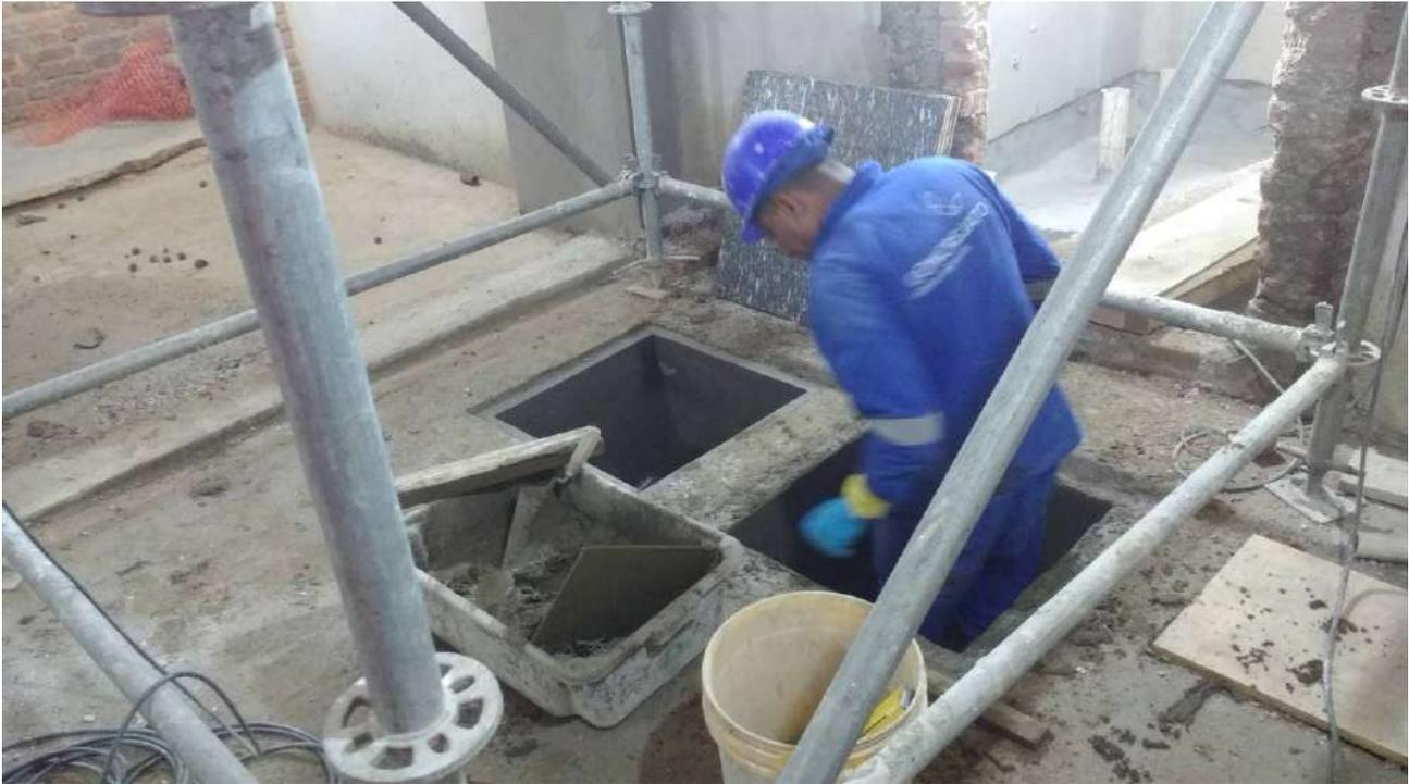
Foto 03: Acabamento das caixas de passagem – águas pluviais, esgoto e caixa de gordura.
