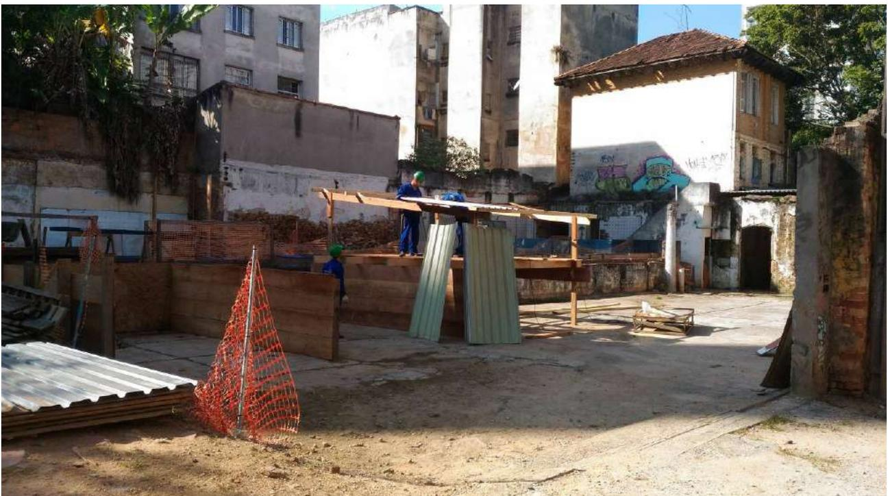
Foto 08: Montagem das baias de agregados do canteiro de obras.
