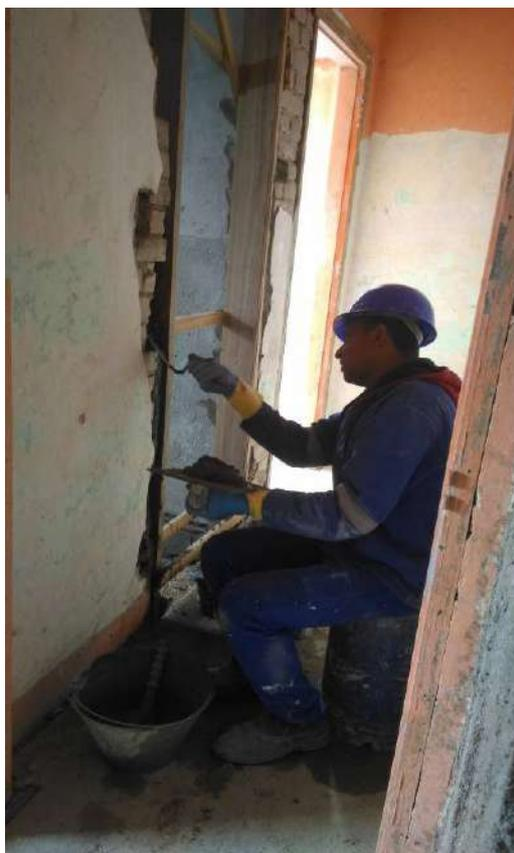
Foto 13: Fixação dos novos batentes.
