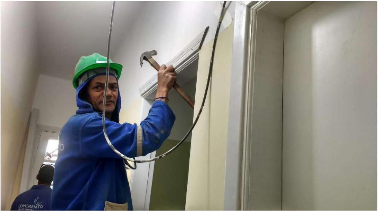
Foto 63: Instalação das guarnições.
