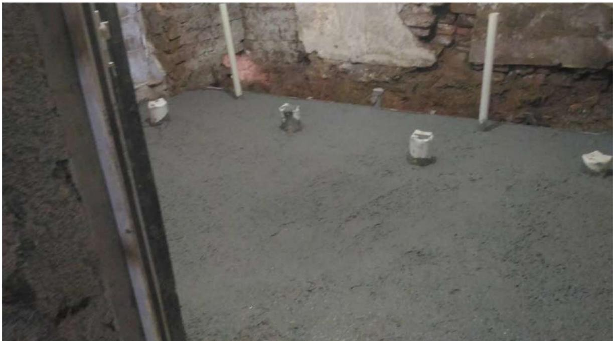
Foto 28: Concretagem dos pisos.
