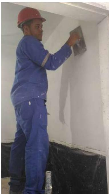
Foto 25: Emassamento das alvenarias.
