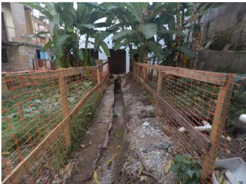
Foto 03 – Instalação da tubulação para redirecionamento da água – casa 11
