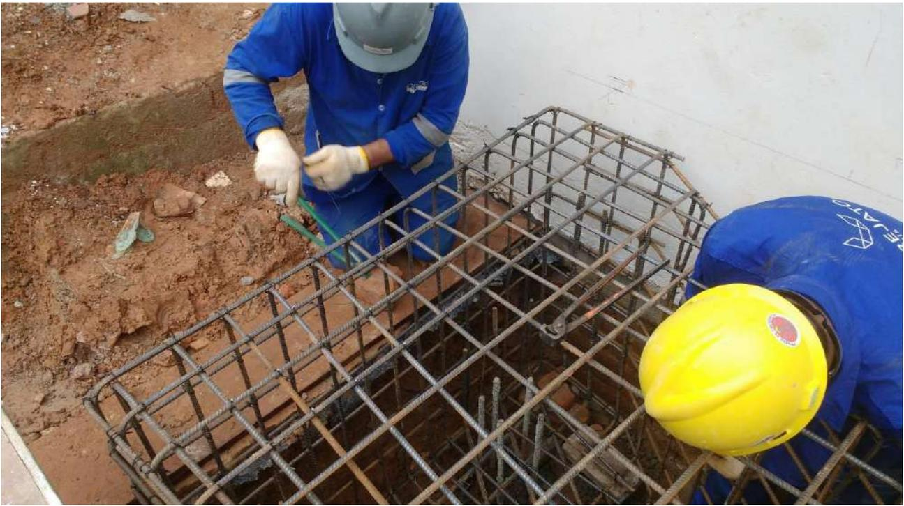
Foto 19: Blocos para sustentação de escadaria e passarela metálica..
