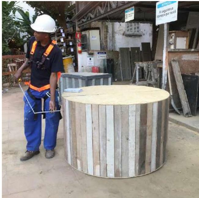
FOTO 01 – Fôrma de madeira para concretagem da contenção da bacia – casa 11
