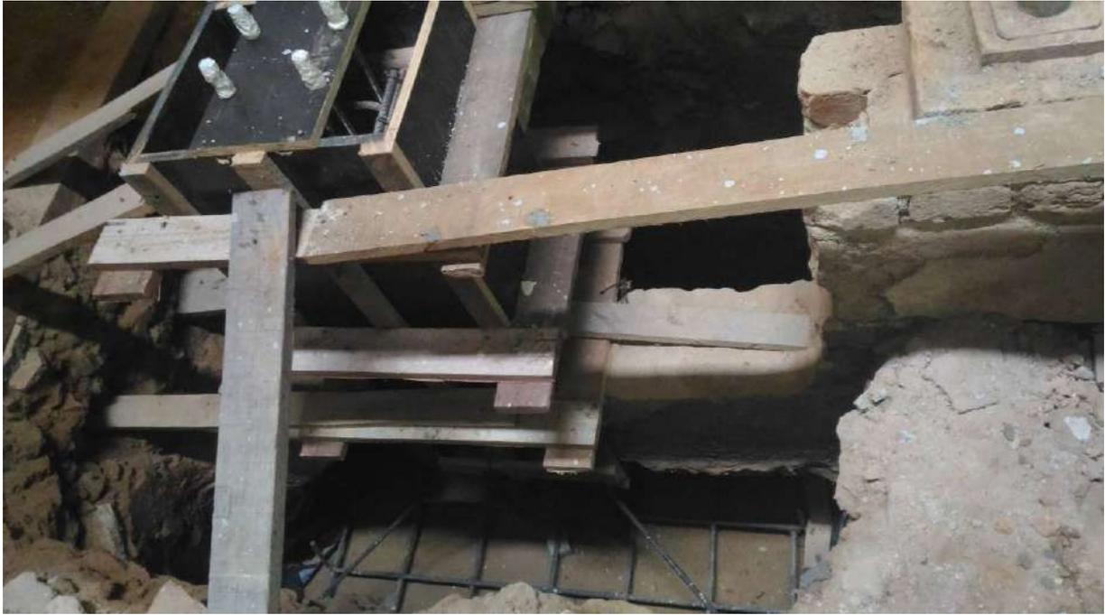
Foto 25: Execução das fôrmas para concretagem.
