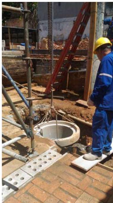
Foto 26: Instalação da caixa de água pluvial.
