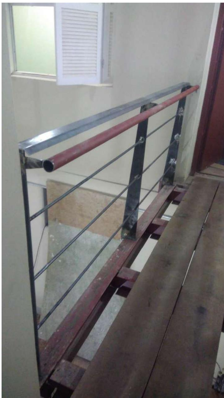
Foto 57: Instalação do guarda-corpo da passarela central;
