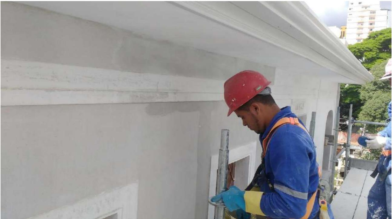
Foto 09: Aplicação de fundo selador – preparação para pintura das fachadas.
