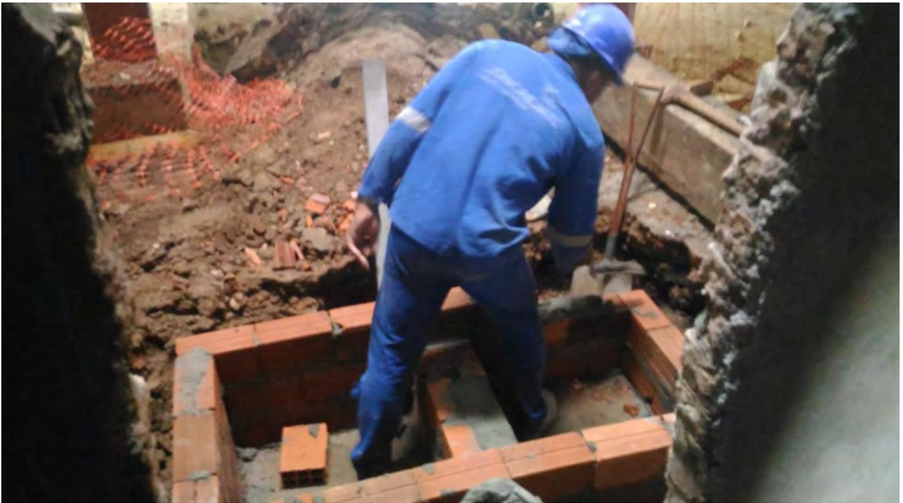
Foto 29: Execução de caixas de passagem do sistema de esgoto e águas pluviais da Casa .
