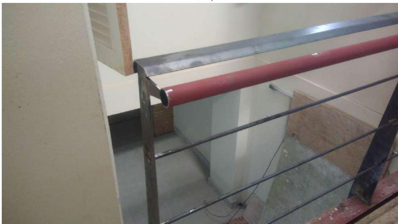
Foto 46: Instalação do guarda corpo da passarela interna;
