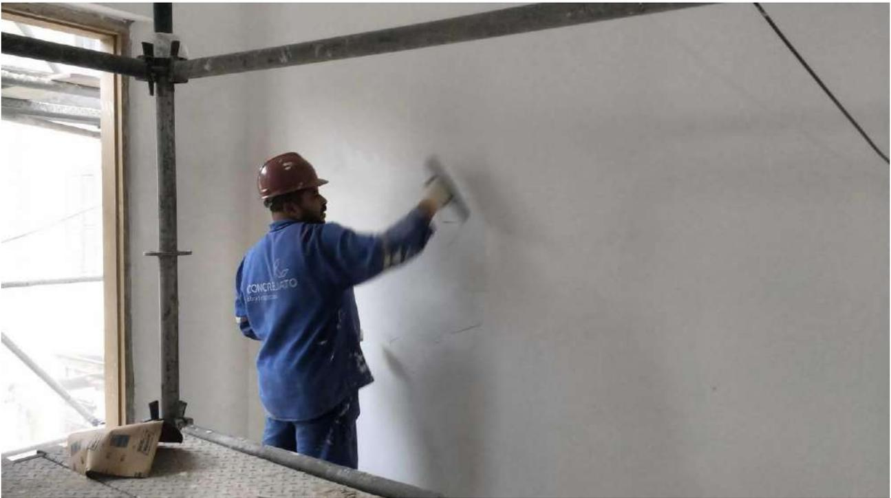
Foto 27: Emassamento das alvenarias do -2 subsolo.
