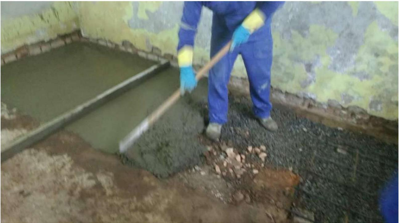
Foto 67: Execução da laje do -2 subsolo – cozinha.
