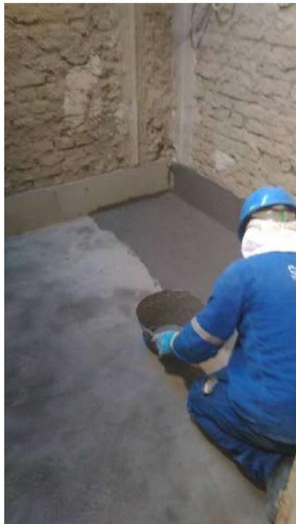
Foto 50: Impermeabilização cimentícia dos pisos das áreas molhadas.
