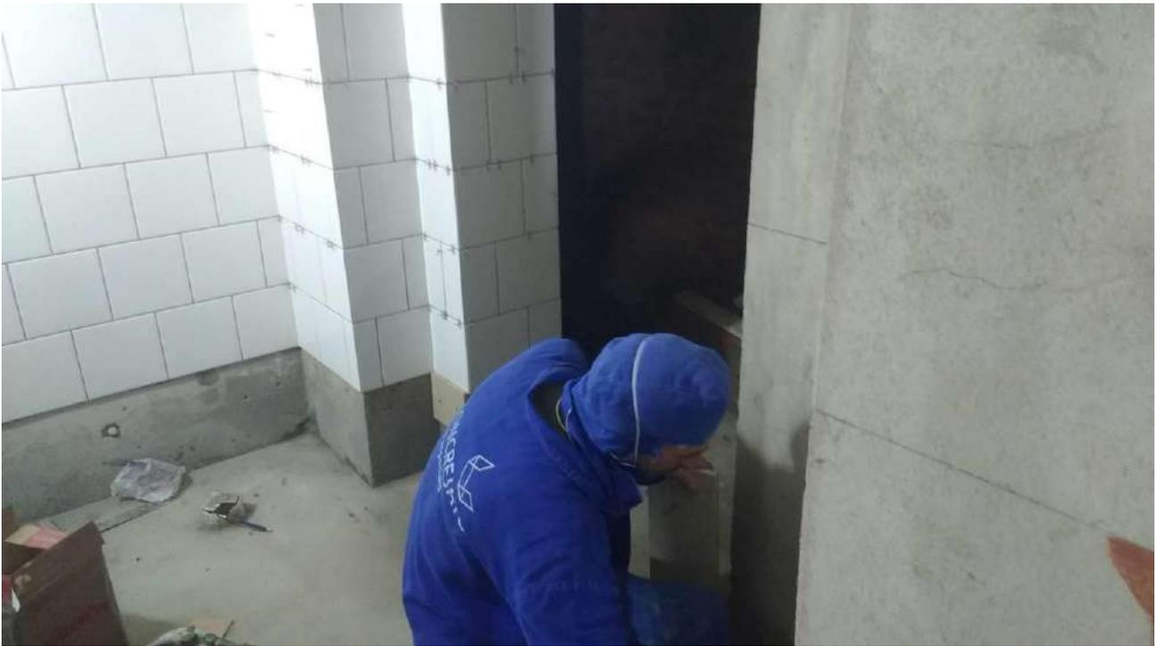
Foto 63: Instalação de ladrilho hidráulico.
