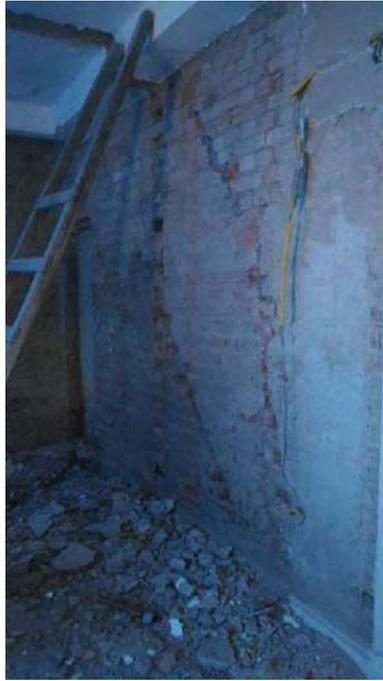
Foto 44: Remoção das argamassas internas danificadas e desprendidas do substrato
