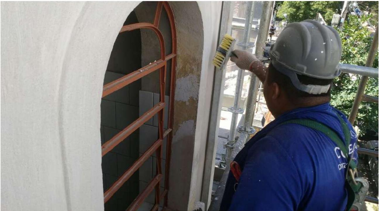
Foto 11: Aplicação de água de cal na fachada
