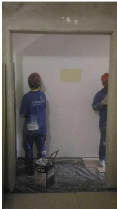
Foto 24: Lixamento da massa corrida nas alvenarias.
