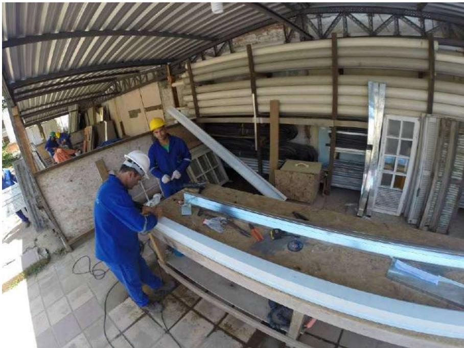
Foto 02: Preparação e instalação das calhas da Casa 11
