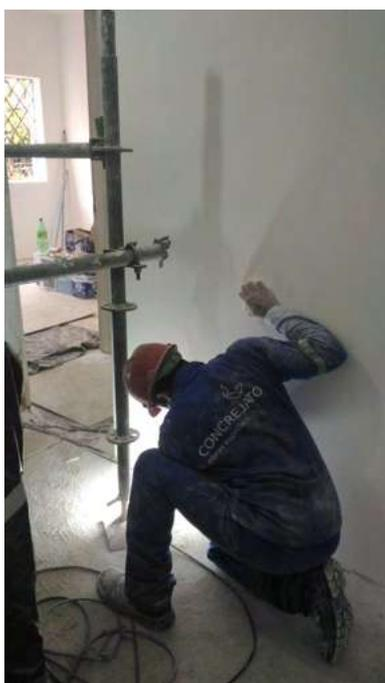
Foto 04: Lixamento das alvenarias.
