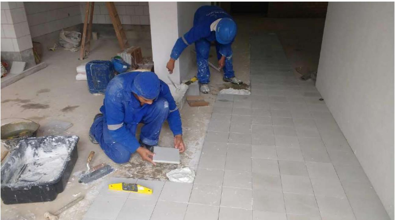
Foto 42: Instalação do piso ladrilho hidráulico.
