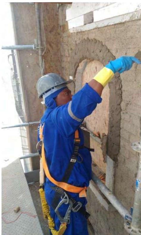
Foto 55: Acabamento – execução dos detalhes da fachada frontal.
