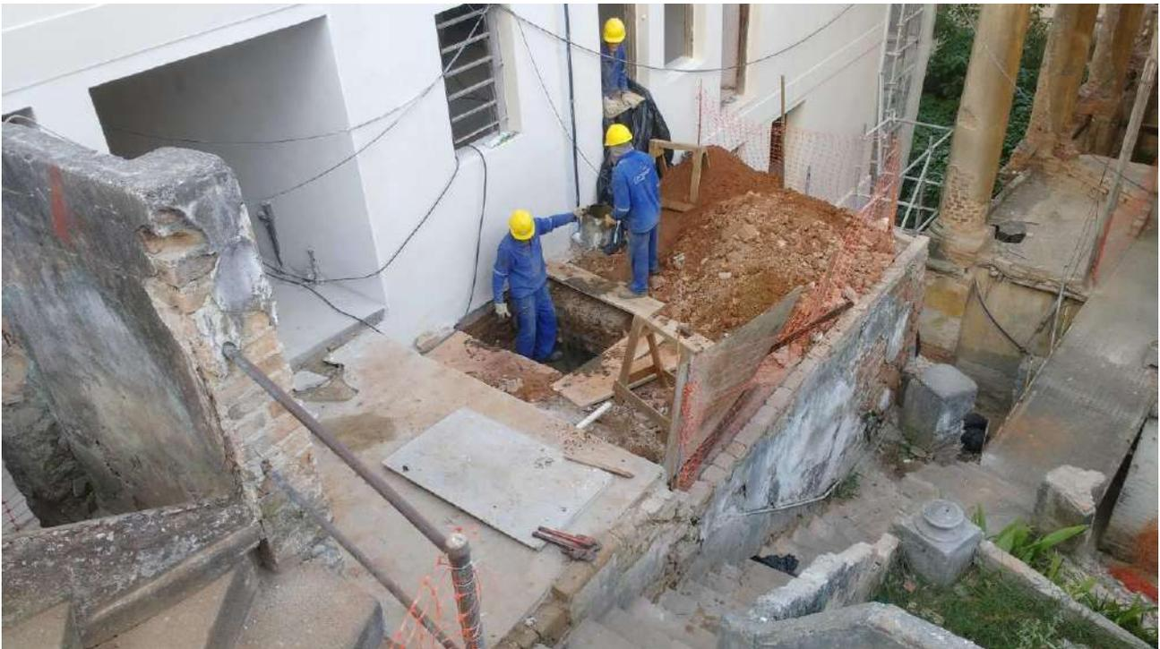
Foto 04: Abertura das valas para execução dos blocos da escadaria.
