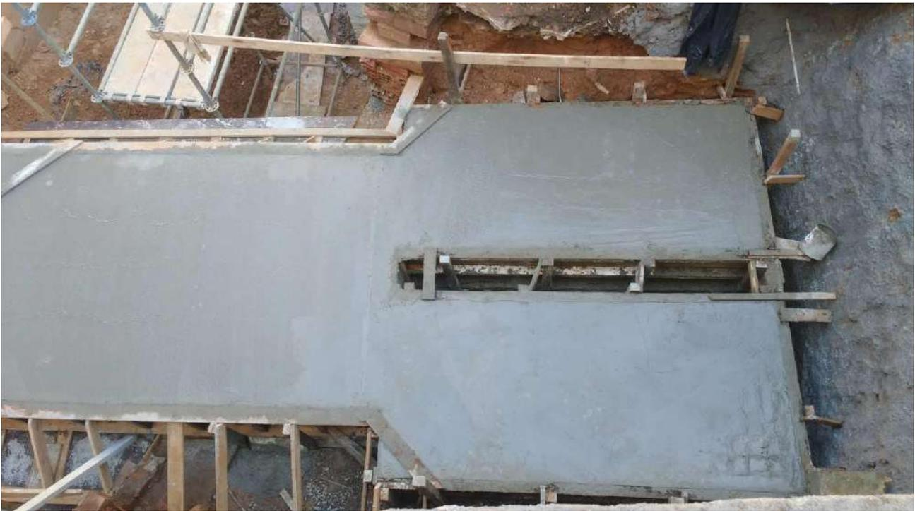
Foto 09: Concretagem das vigas de concreto.
