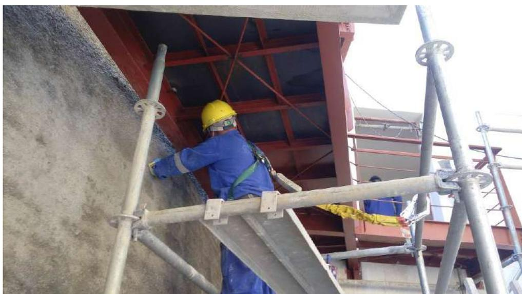
Foto 12 – Pintura lisa da passarela metálica.
