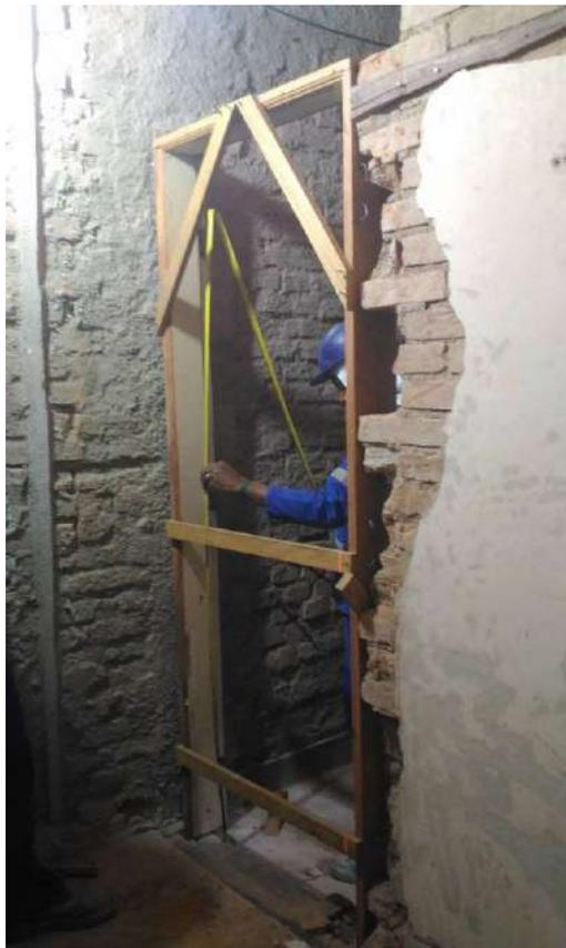
Foto 06: Instalação dos batentes das portas de madeira.
