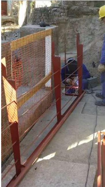
Foto 14 – Reparos com solda no guarda corpo da passarela metálica
