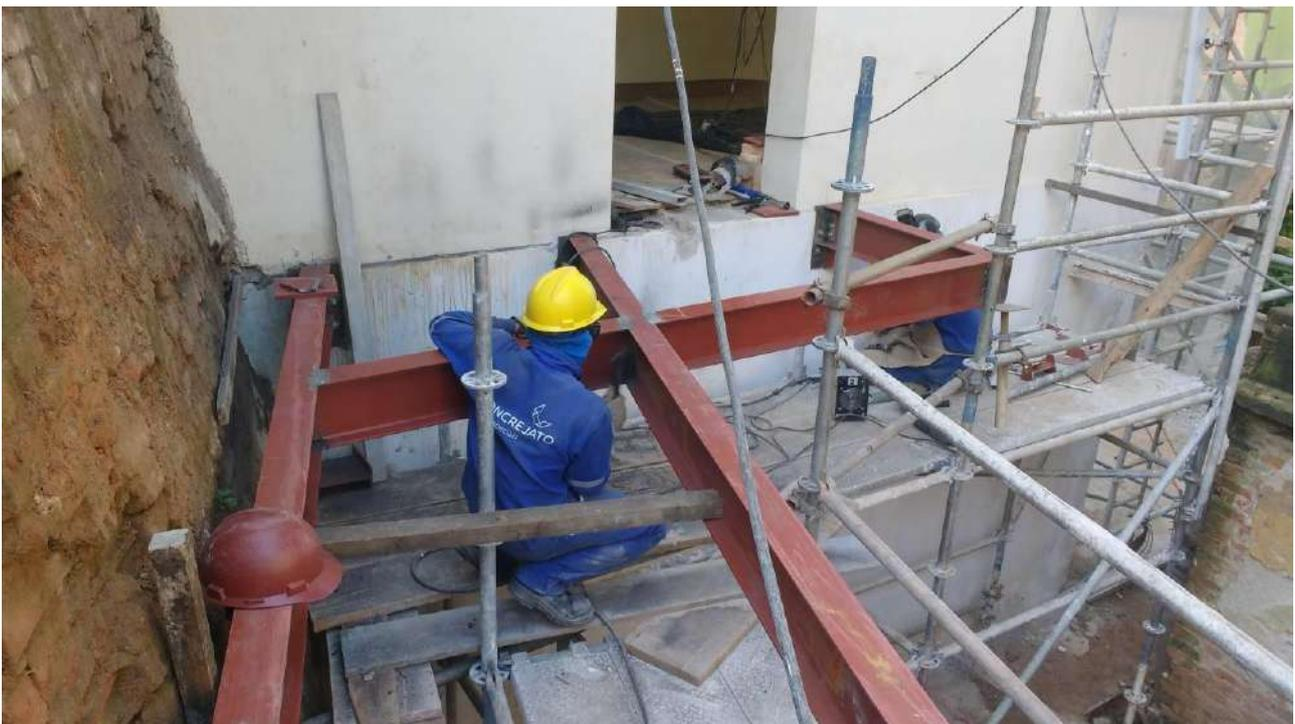
Foto 34: Montagem da passarela metálica de acesso ao -2 pavimento.
