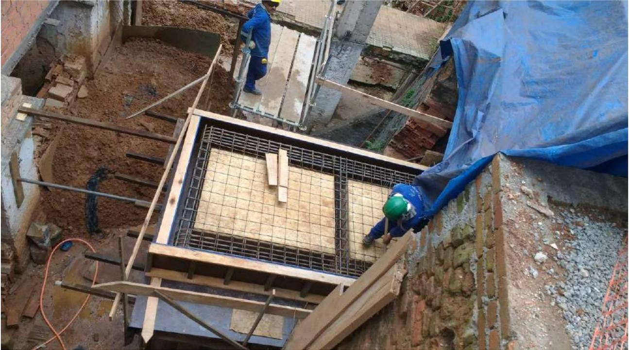
Foto 01: Execução de fôrma e armadura das vigas em balanço de sustentação da passarela metálica.
