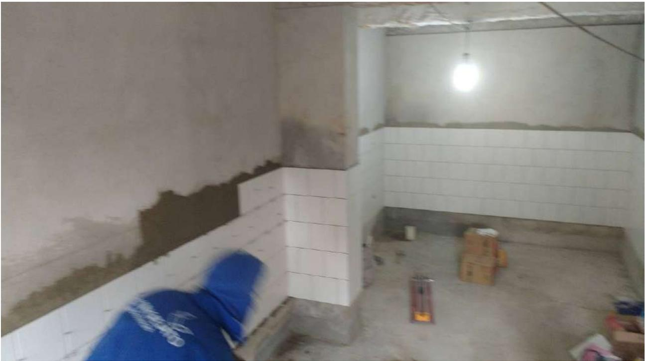
Foto 13: Instalação de revestimento cerâmico.
