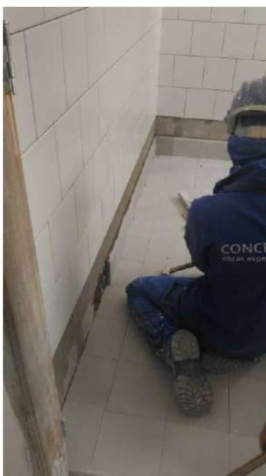
Foto 28: Instalação dos pisos em ladrilho hidráulico.
