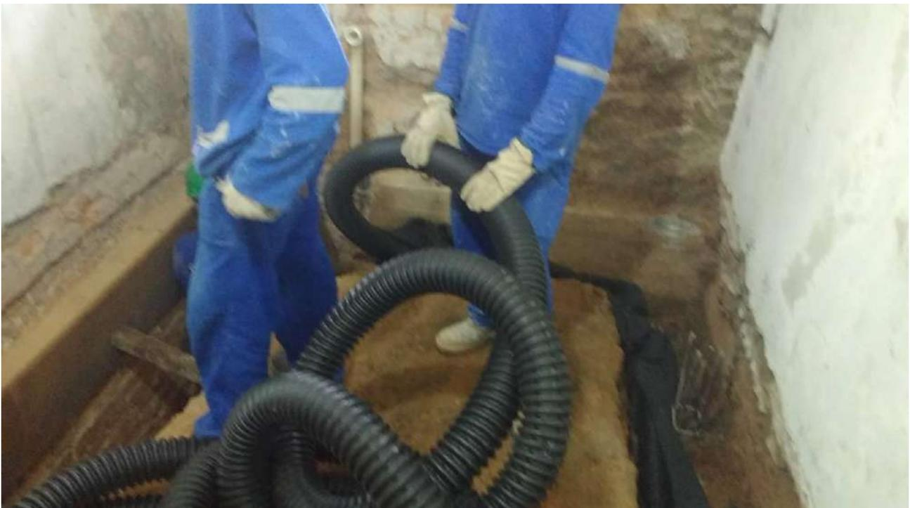
Foto 34: Drenagem do talude na -2 subsolo.
