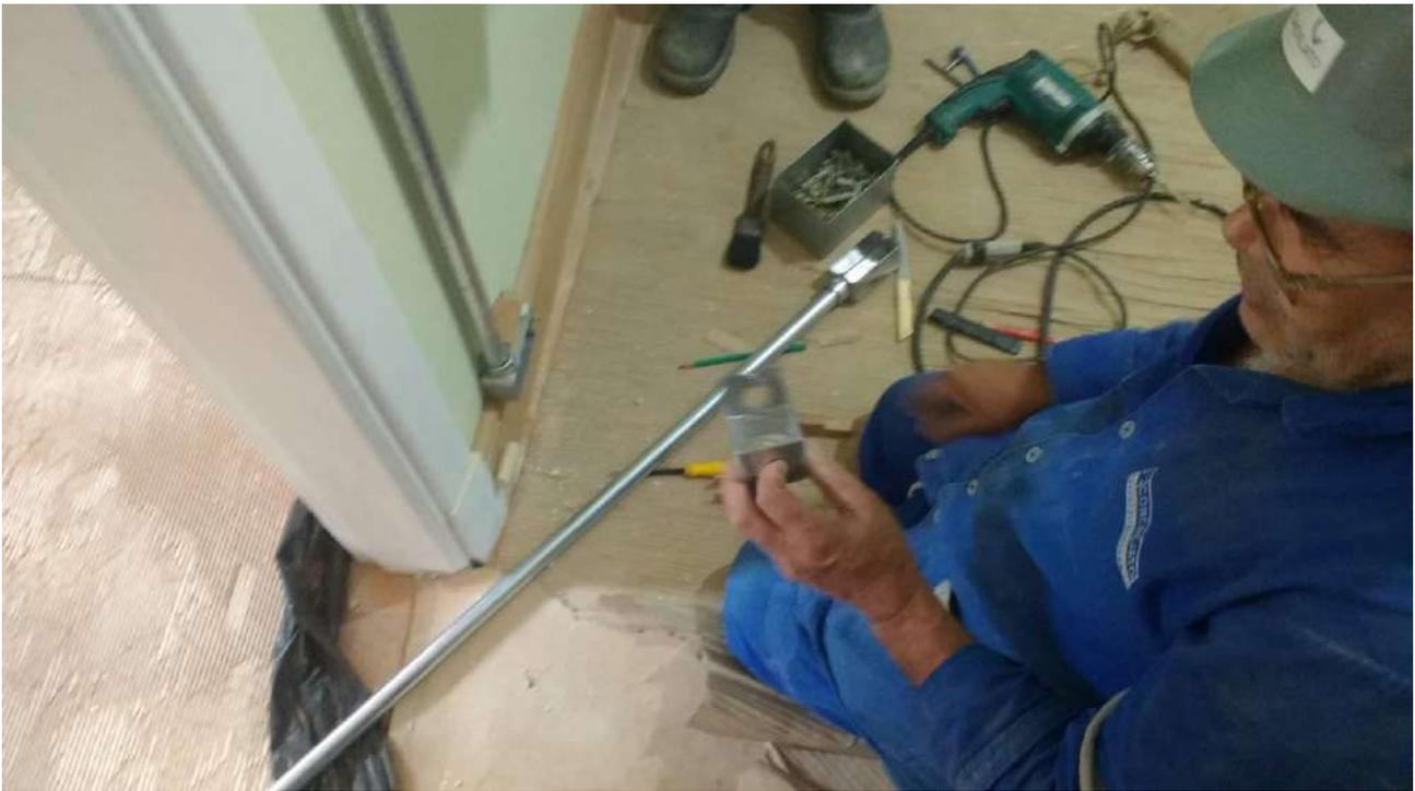
Foto 45: Instalação da infra aparente de elétrica
