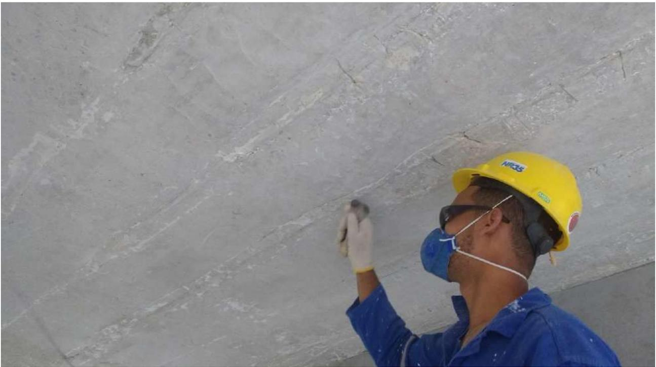
Foto 16: Limpeza fina da laje de concreto – Pav -1 subsolo
