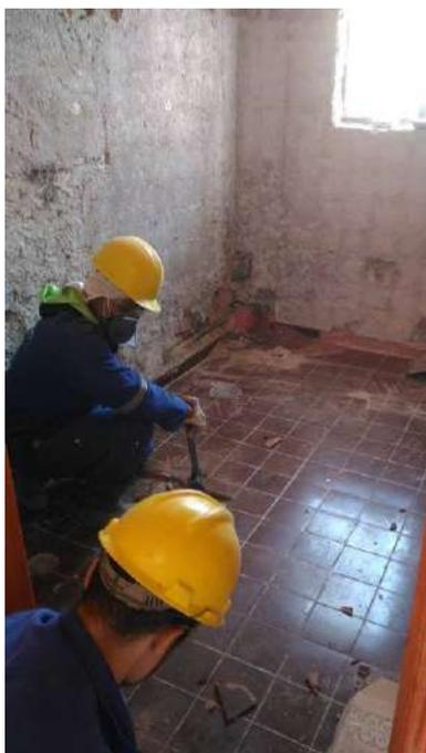
Foto 23: Remoção dos revestimentos modernos e peças sanitárias da Casa 11
