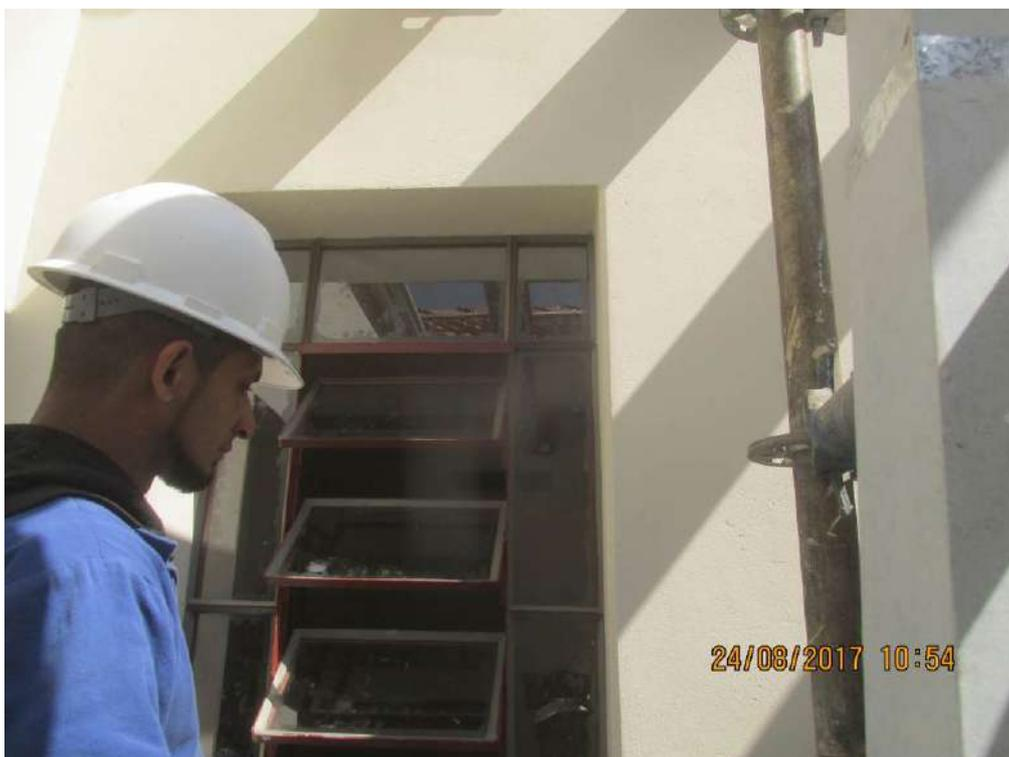
Foto 03: Instalação de vidros nas esquadrias.
