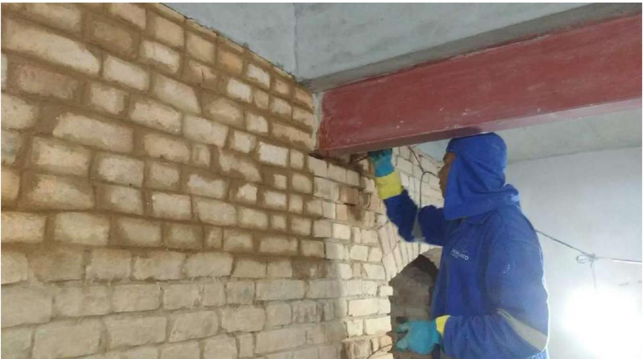
Foto 28: Acabamento dos tijolos aparentes do -1 subsolo.
