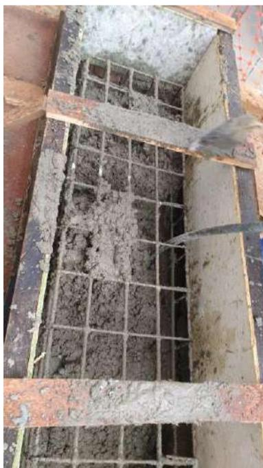
Foto 21: Concretagem dos blocos.
