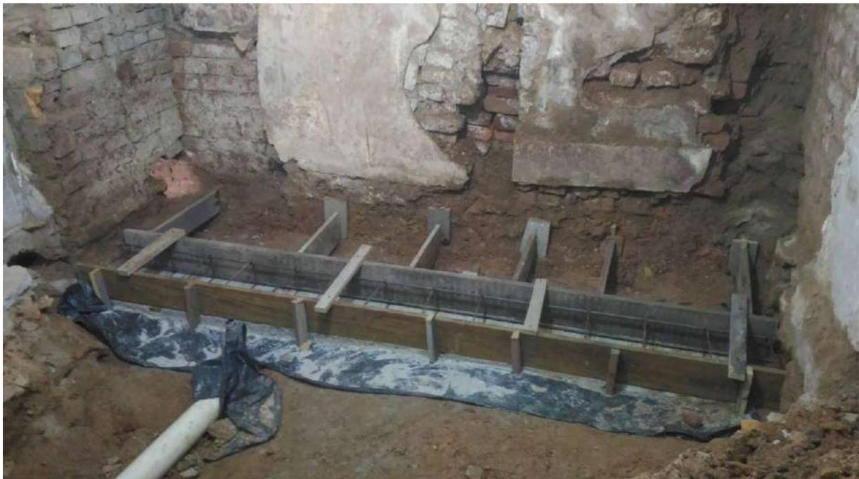
Foto 62: Viga baldrame para nova alvenaria no pavimento -1 sub.
