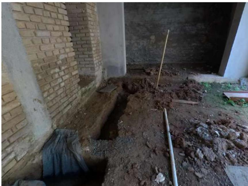
Foto 05 – Escavação manual para execução das caixas coletoras – casa 11
