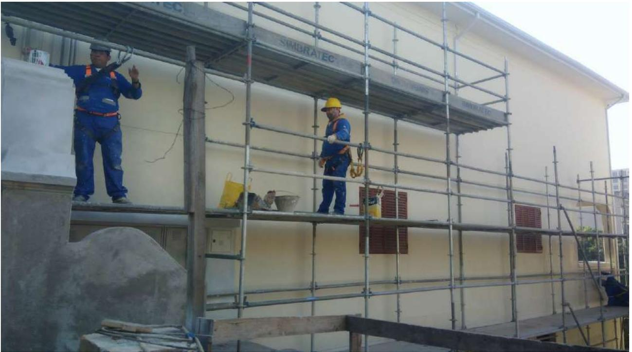
Foto 41: Pintura final de acabamento da fachada lateral;
