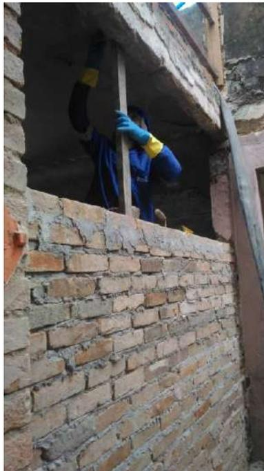
Foto 64: Elevação de alvenaria de fechamento
