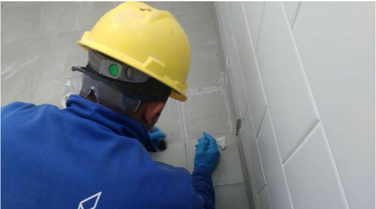
Foto 32: Rejuntamento dos pisos de rejuntas;
