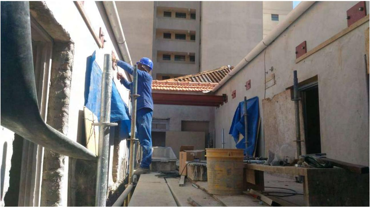
Foto 11: Instalação dos consoles metálicos para a cobertura metálica.
