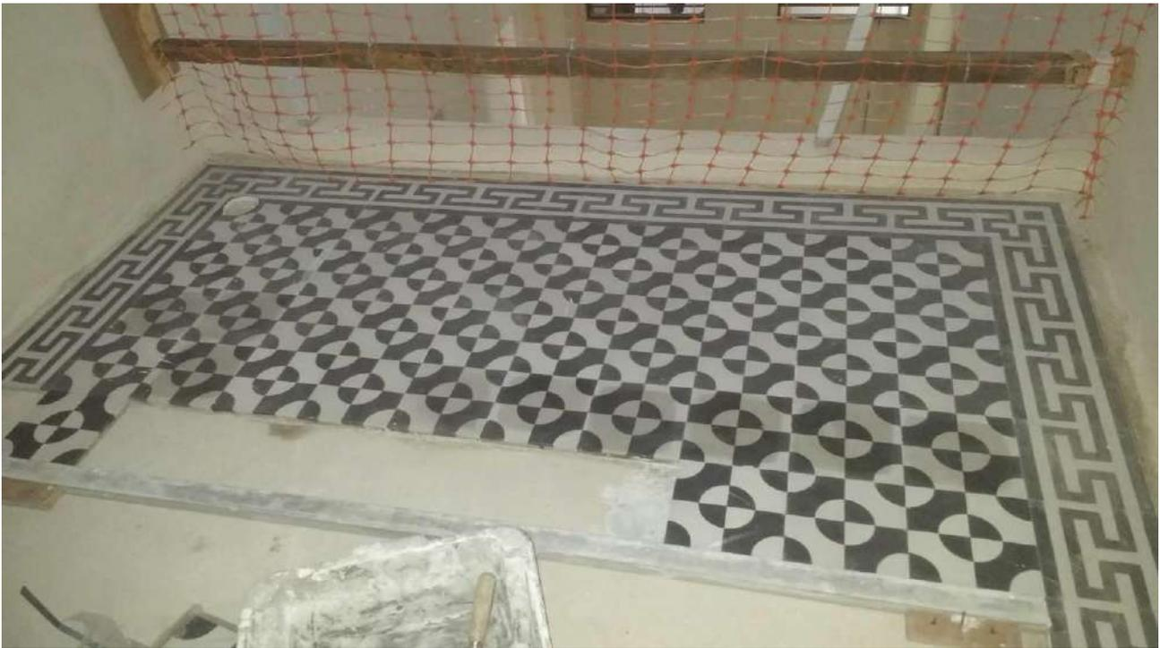
Foto 63: Instalação dos pisos das varandas.
