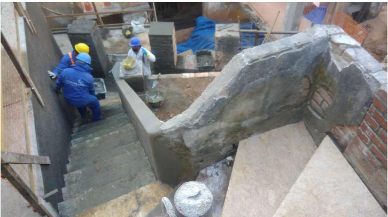
Foto 77: Revestimento do guarda corpo da escadaria;
