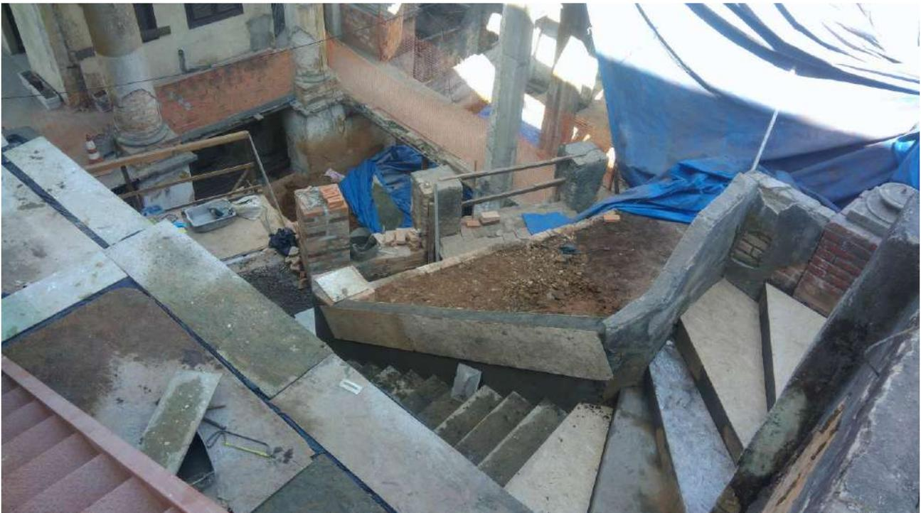
Foto 75: Revestimento do guarda corpo da escadaria;
