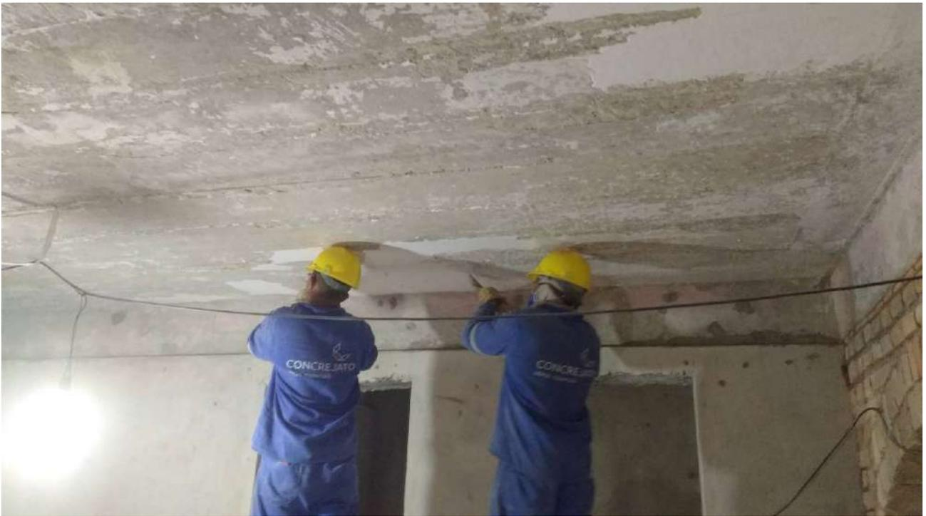
Foto 15: Decapagem das tintas da laje do -1 subsolo.
