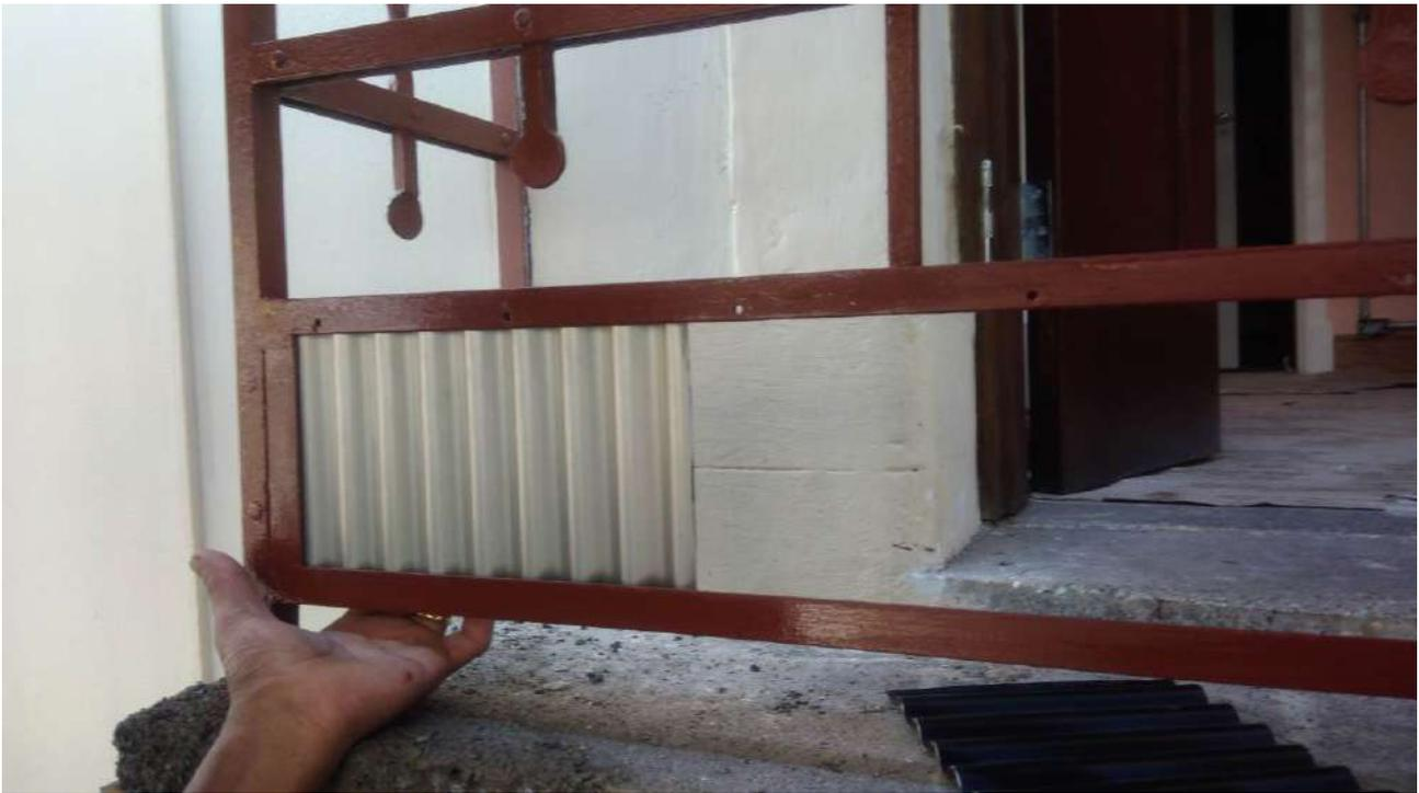
Foto 80: Substituição da chapa ondulada da fachada;
