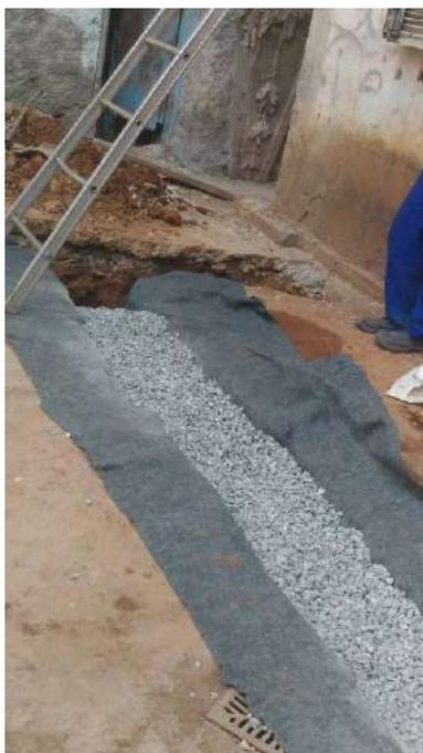
Foto 18: Execução da drenagem provisória da Casa 11- área externa
