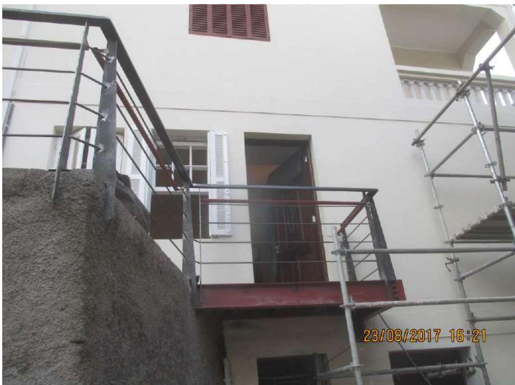
Foto 12: Instalação do guarda corpo do talude;
