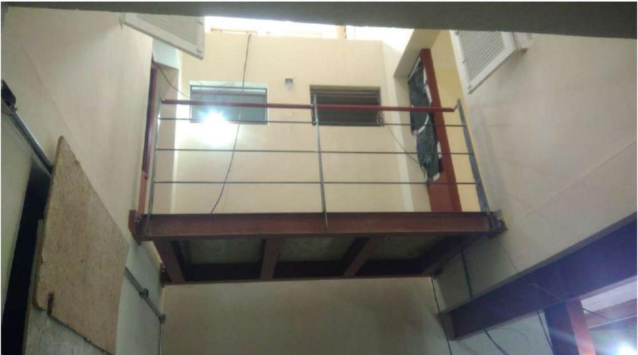
Foto 48: Instalação do guarda corpo da passarela interna;
