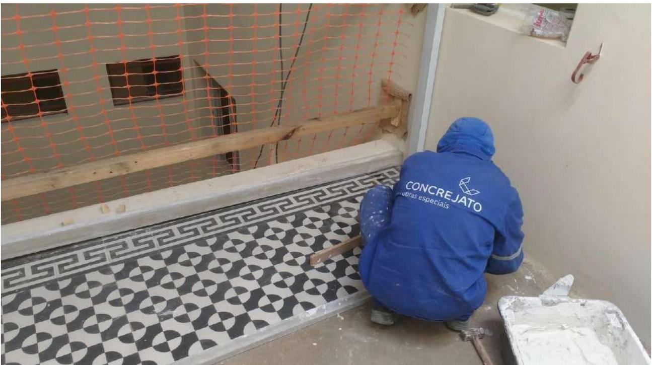
Foto 66: Instalação dos pisos das varandas.
