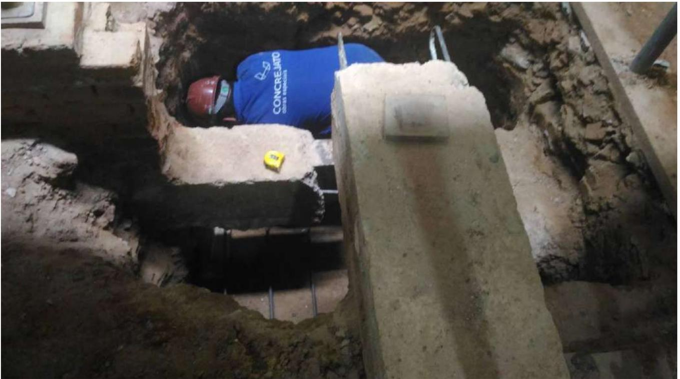
Foto 19: Escavação manual para reforço no -1Pav.
