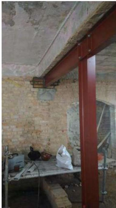
Foto 17: Instalação dos pilares e vigas metálicas no -1 subsolo..
