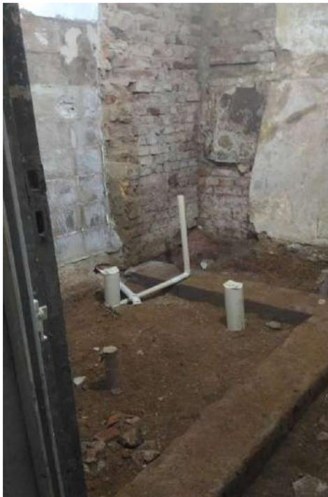
Foto 28: Execução do novo sistema de hidráulica (esgoto; alimentação de água e alimentação de água de reuso)
