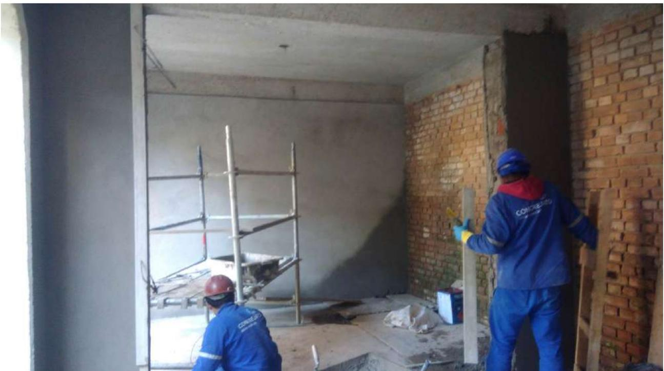
Foto 93: Revestimentos dos pilares do -3 subsolo;
