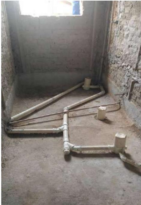
Foto 26: Execução do novo sistema de hidráulica (esgoto; alimentação de água e alimentação de água de reuso).
