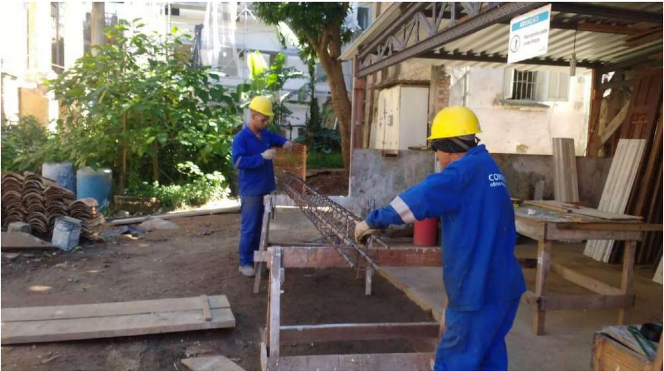
Foto 78: Armação das brocas do talude.
