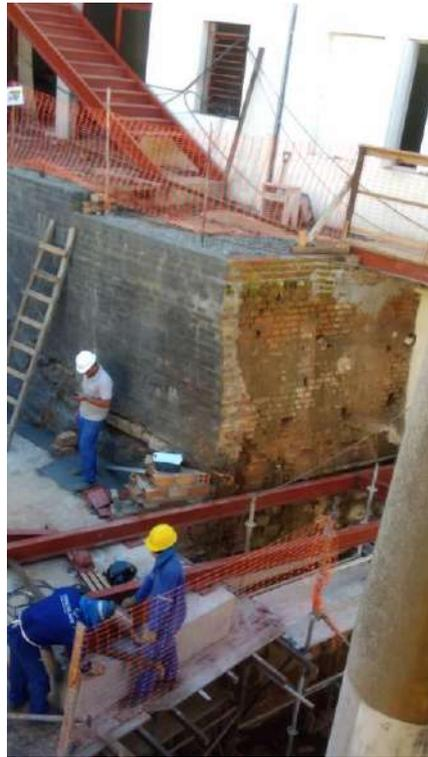
Foto 37: Montagem da passarela metálica de acesso ao -2 pavimento
