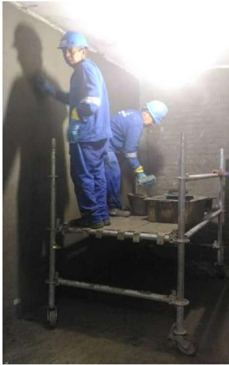
Foto 61: Regularização das alvenarias internas.
