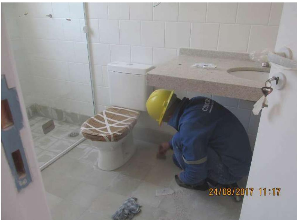
Foto 02: Rejunte dos pisos de ladrilho hidraulico
