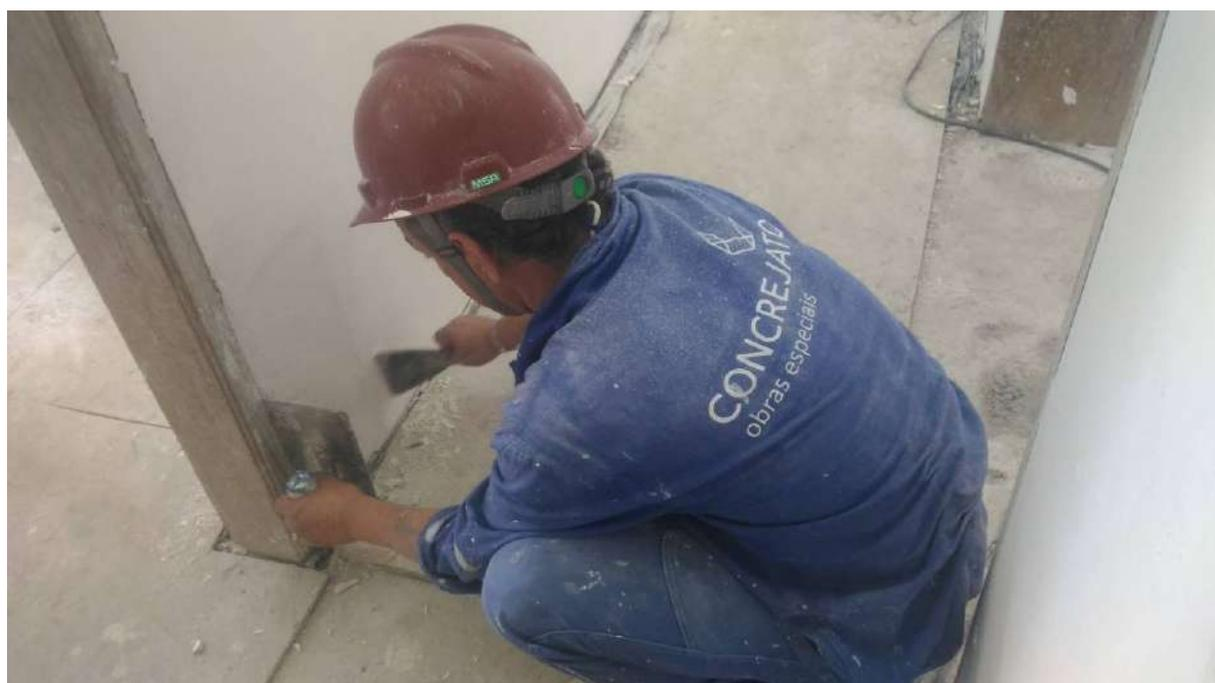
Foto 08: Emassamento das alvenarias.
