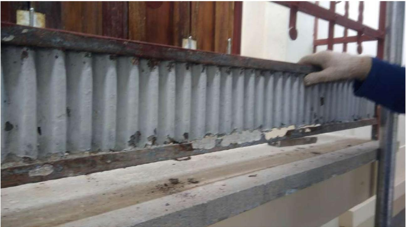
Foto 68: Substituição da chapa ondulada da fachada;
