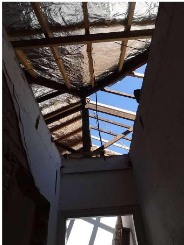
Foto 16: Remoção das telhas; substituição dos caibros e instalação da manta de subcobertura
