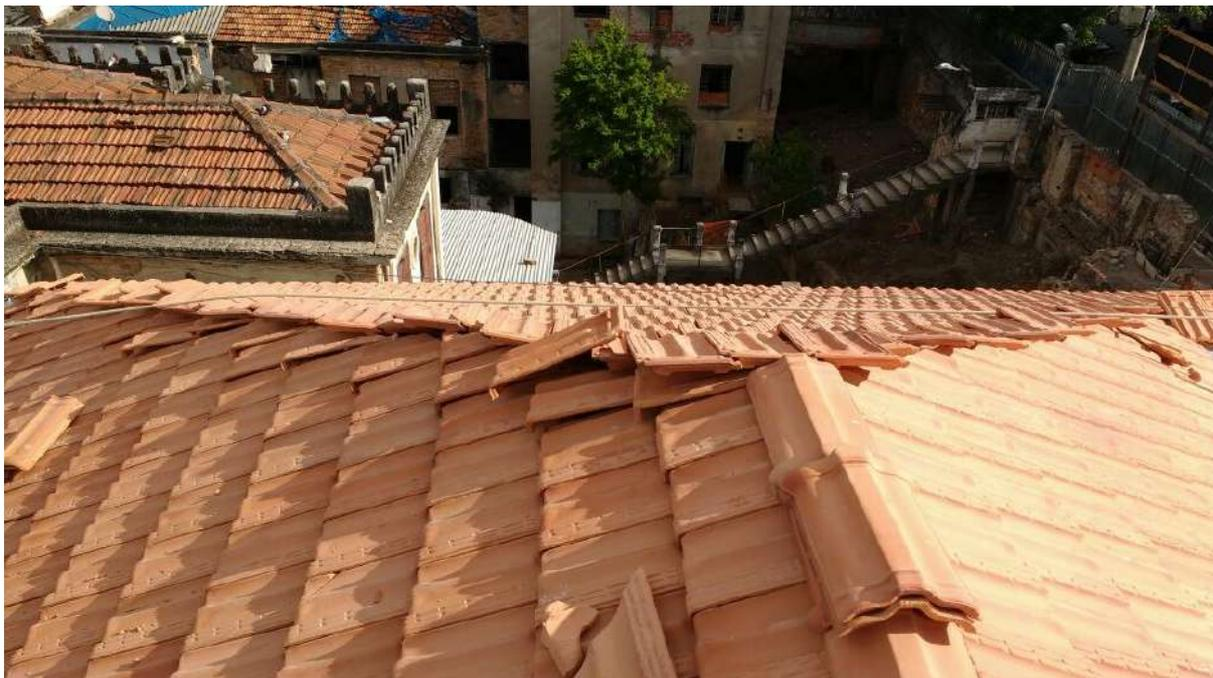
Foto 37: Recortes da telha e cummeira do telhado
