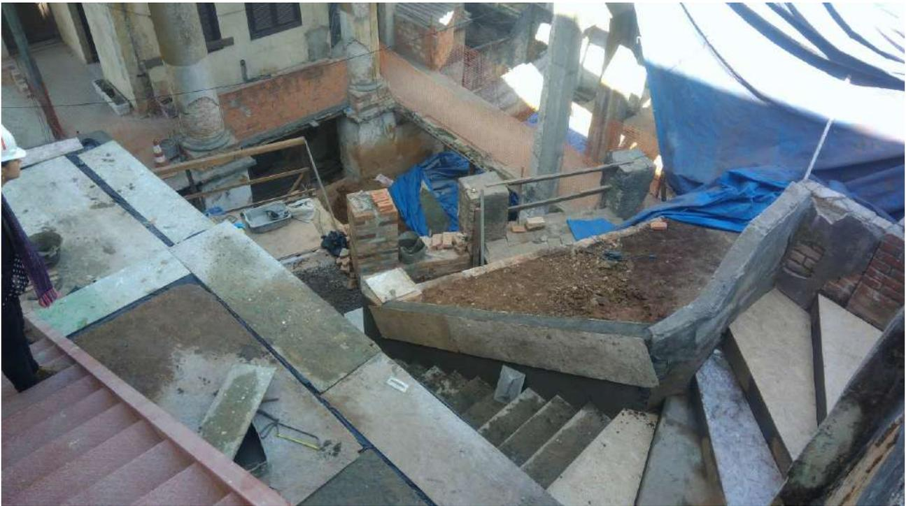
Foto 76: Revestimento do guarda corpo da escadaria;
