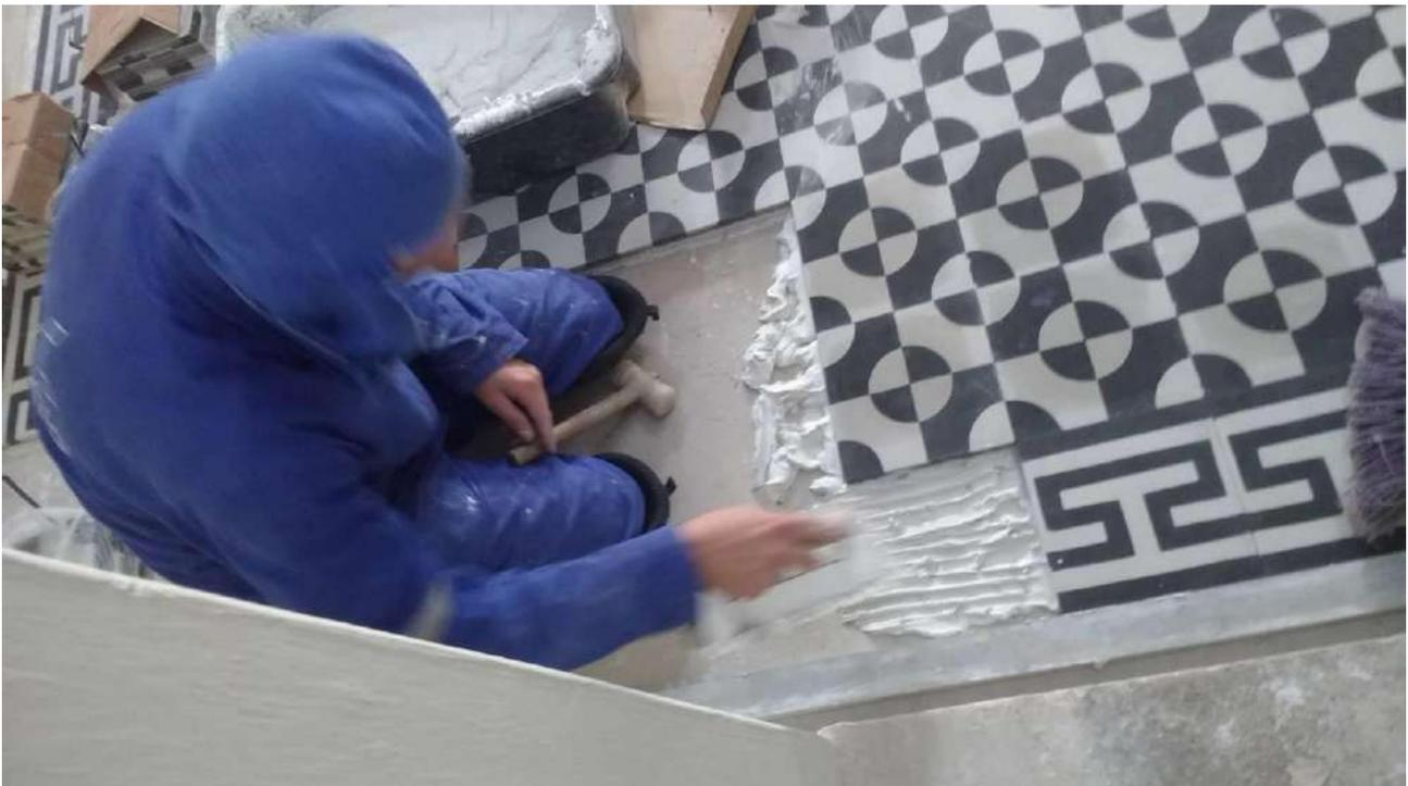
Foto 64: Instalação dos pisos das varandas.
