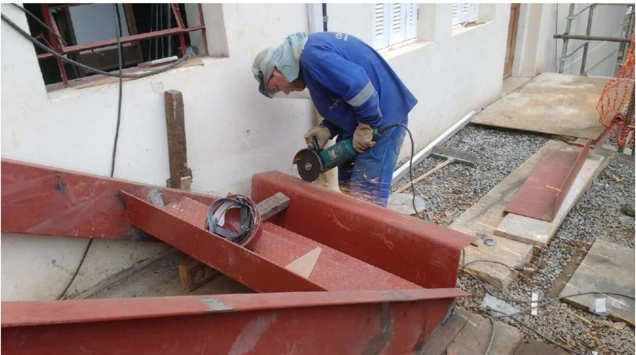
Foto 18: Montagem da escadaria metálica da fachada lateral
