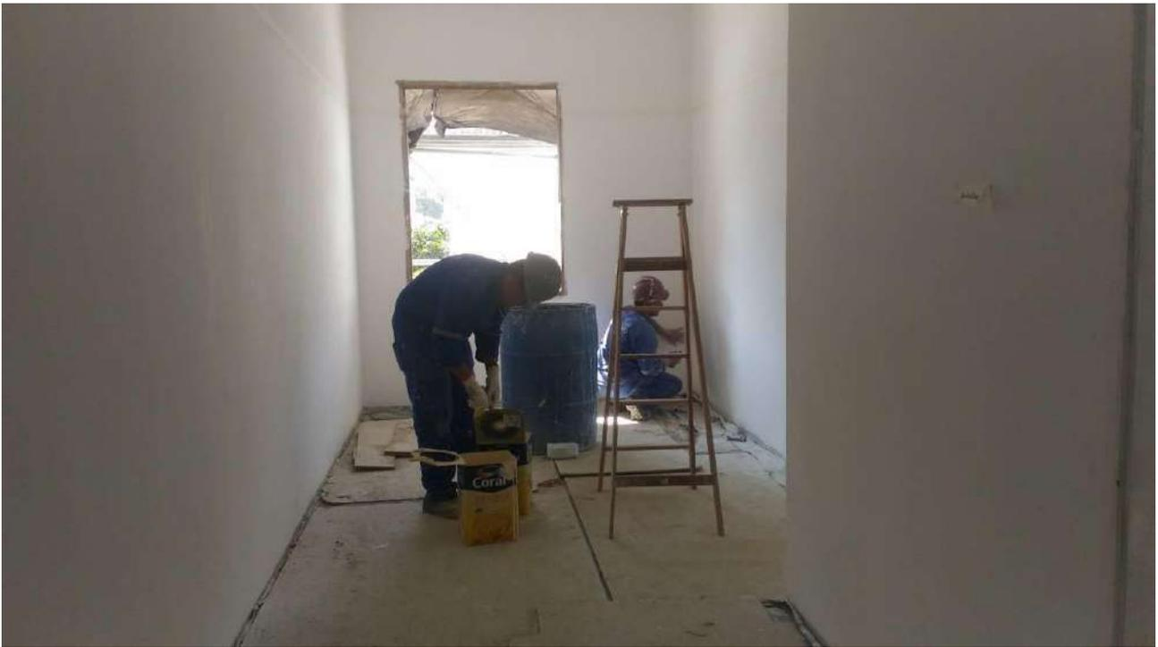
Foto 07: Pintura de acabamento das alvenarias internas.
