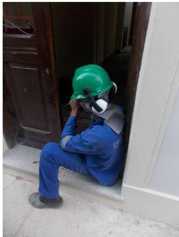
Foto 34: Instalação da fechadura das portas.
