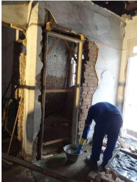
Foto 68: Instalação de batentes
