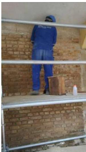
Foto 71: Limpeza das juntas dos tijolos aparentes
