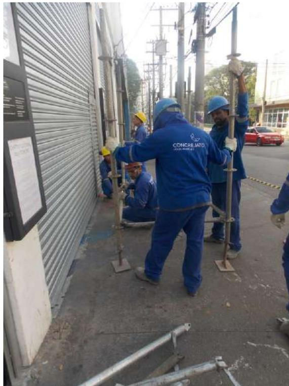
Foto 06 – Montagem do andaime para instalação do letreiro – Galpão
