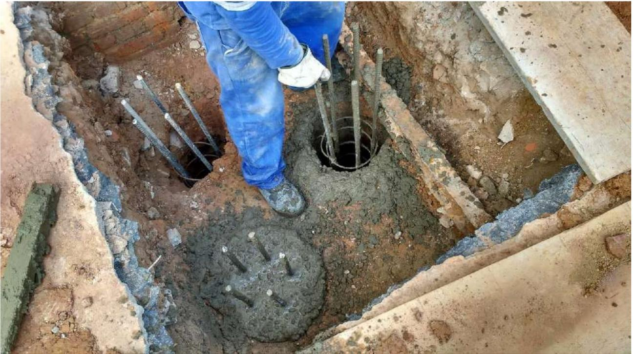
Foto 11: Concretagem das brocas dos blocos.
