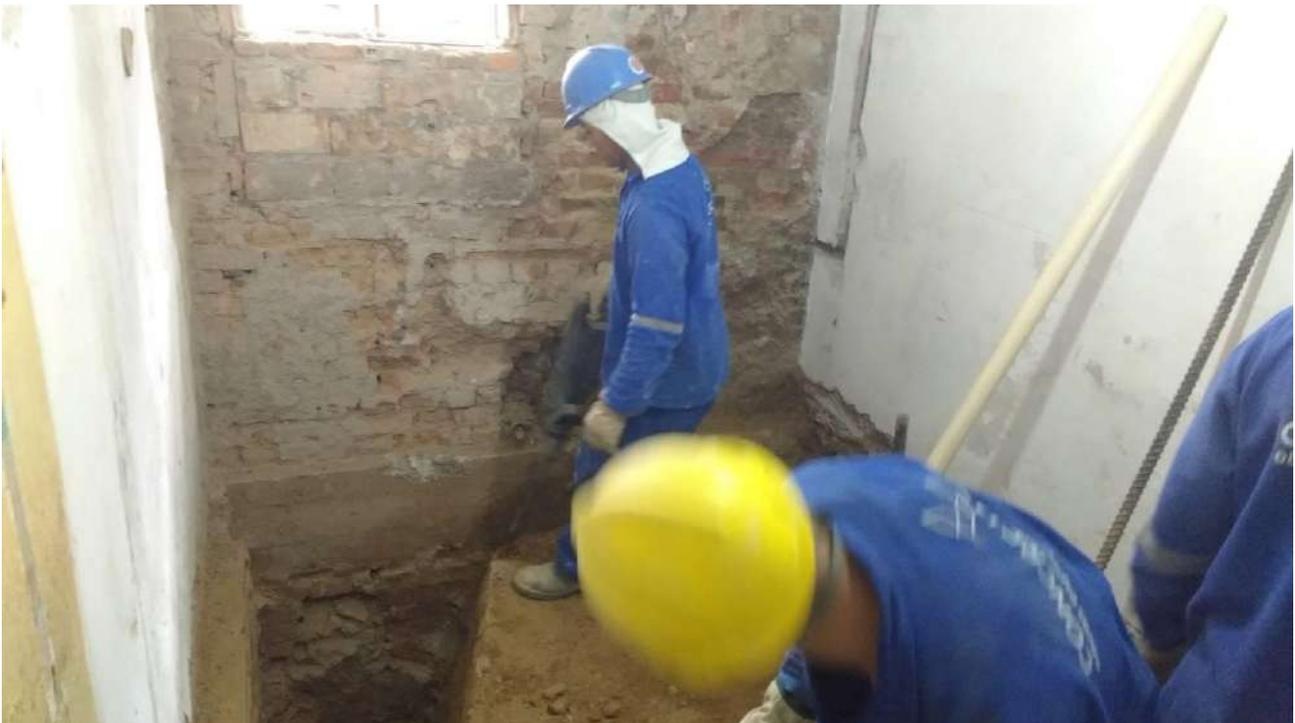
Foto 18: Demolição da laje da cozinha do -2 subsolo.
