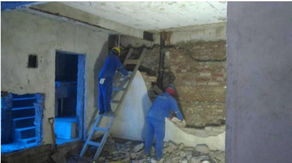
Foto 43: Desmonte das alvenarias – Pavimento -1
