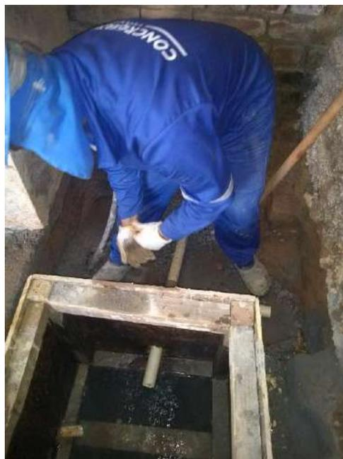
Foto 04 – Execução da caixa coletora de alvenaria – Casa 11
