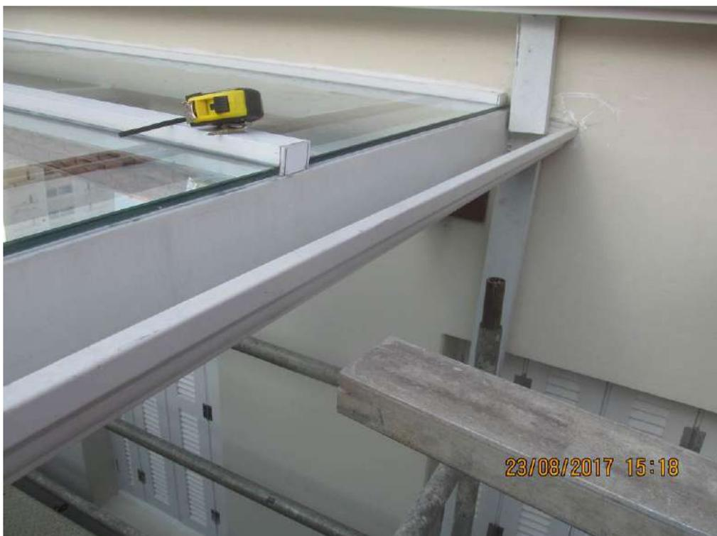
Foto 08: Instalação da calha e descidas;
