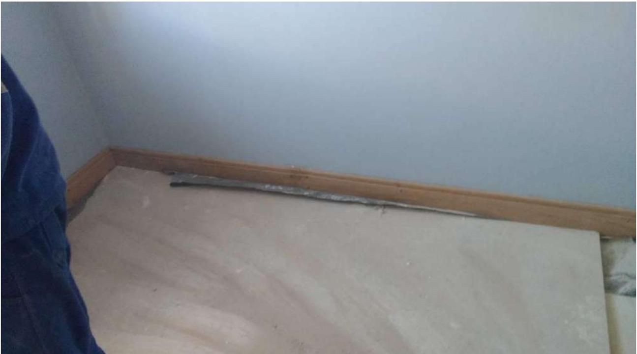
Foto 42: Instalação dos rodapés de acabamento.
