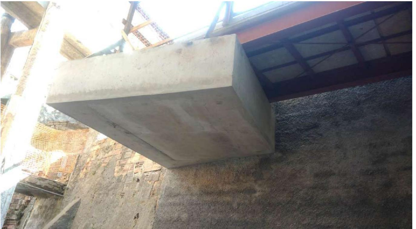
Foto 65: Viga em balanço de sustentação da passarela.
