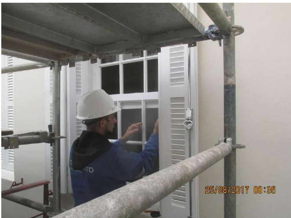
Foto 54: Instalação dos vidros;
