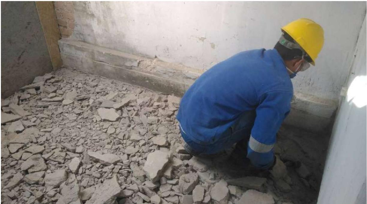
Foto 45: Remoção do contrapiso existente
