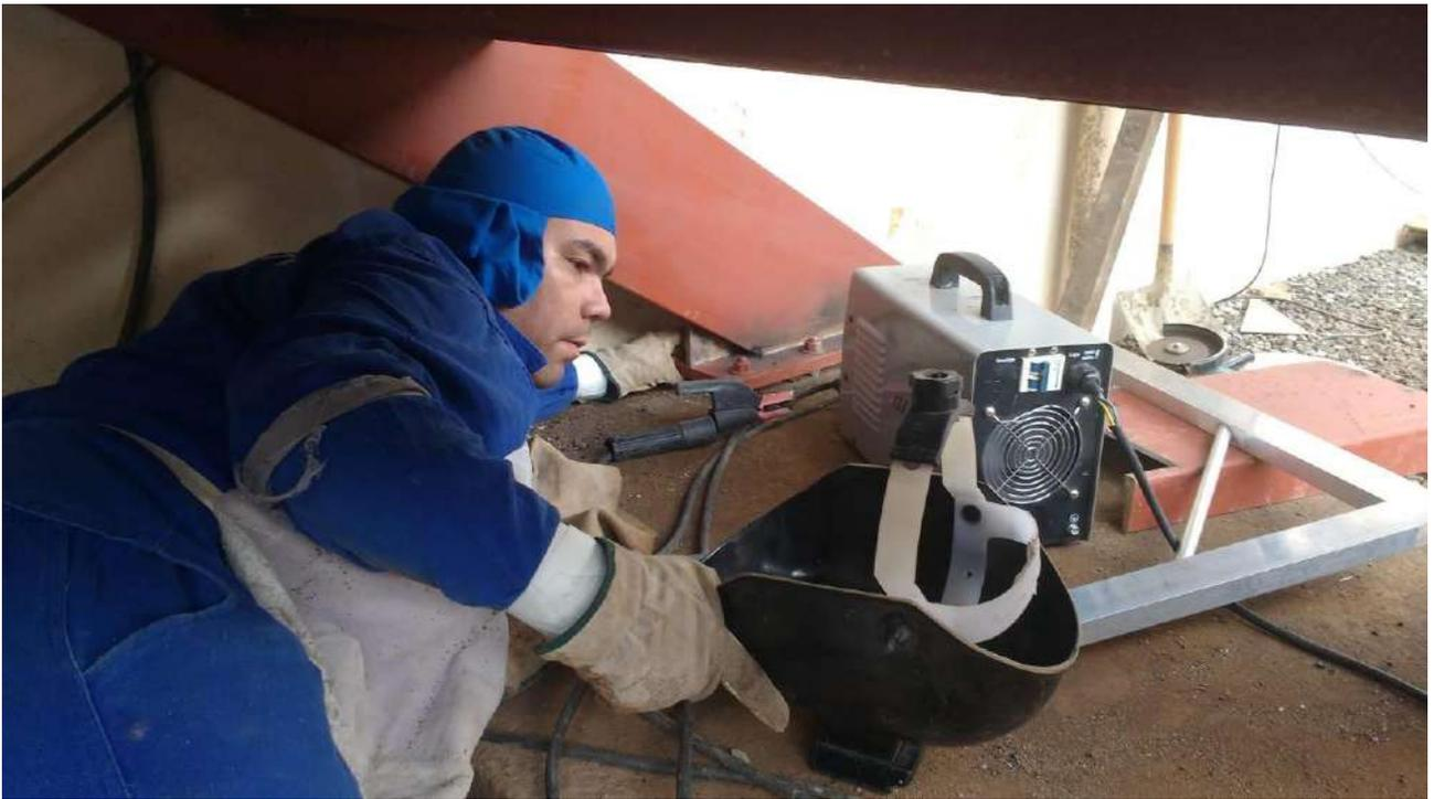
Foto 25: Montagem da escadaria metálica.
