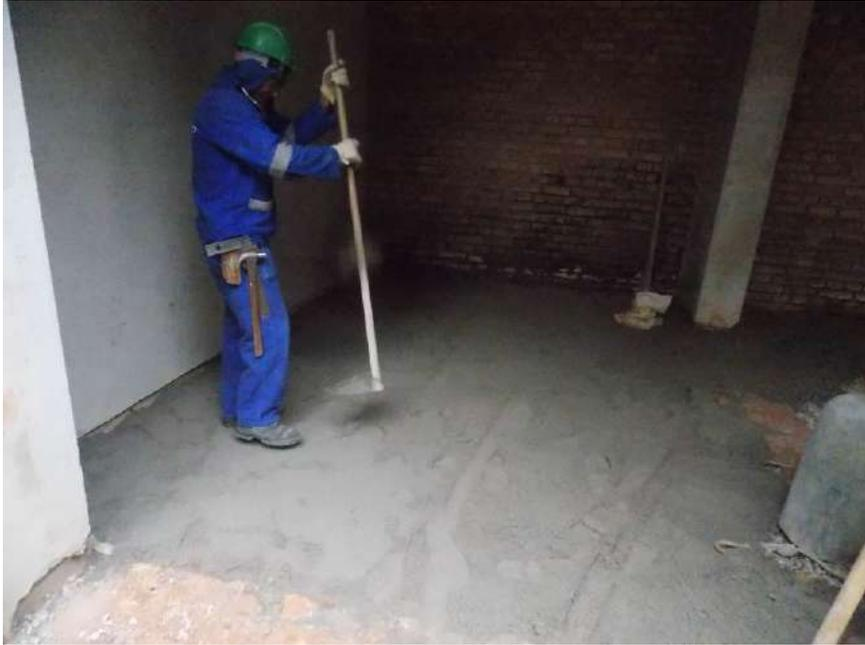
Foto 09 – Preparação para assentamento dos pisos intertravados – Casa 11
