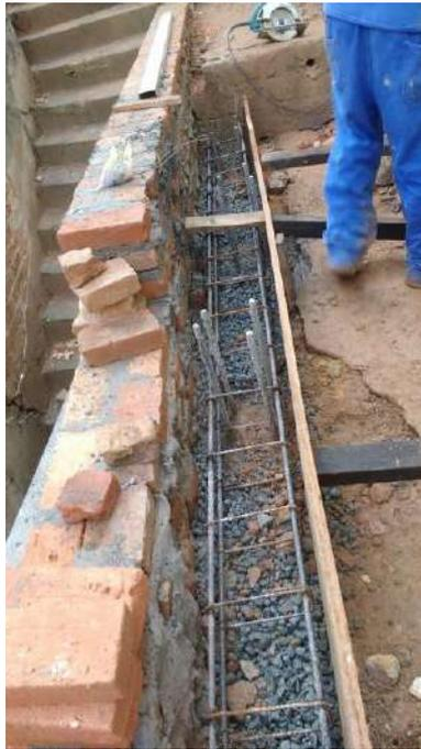
Foto 74: Execução de viga invertida no talude.
