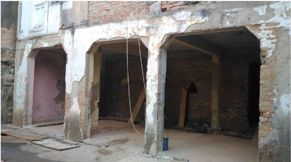
Foto 39: Abertura dos arcos do subsolo – Pavimento -3
