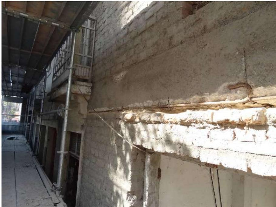
Foto 11: Remoção das argamassas desprendidas da fachada
