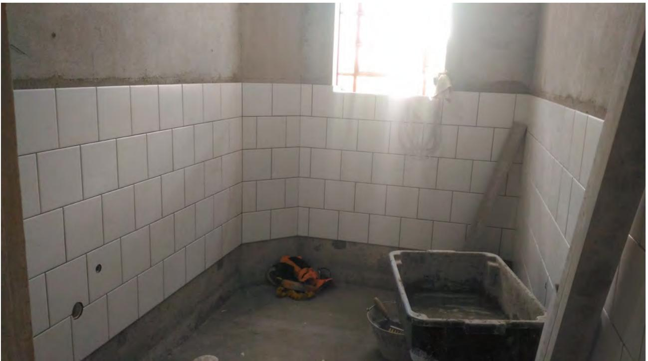
Foto 26: Instalação de revestimento cerâmico nas áreas molhadas.
