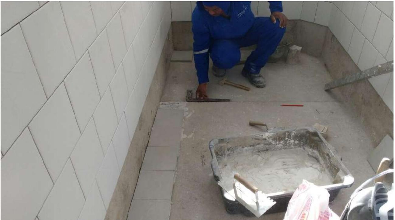
Foto 27: Instalação de ladrilho hidráulico
