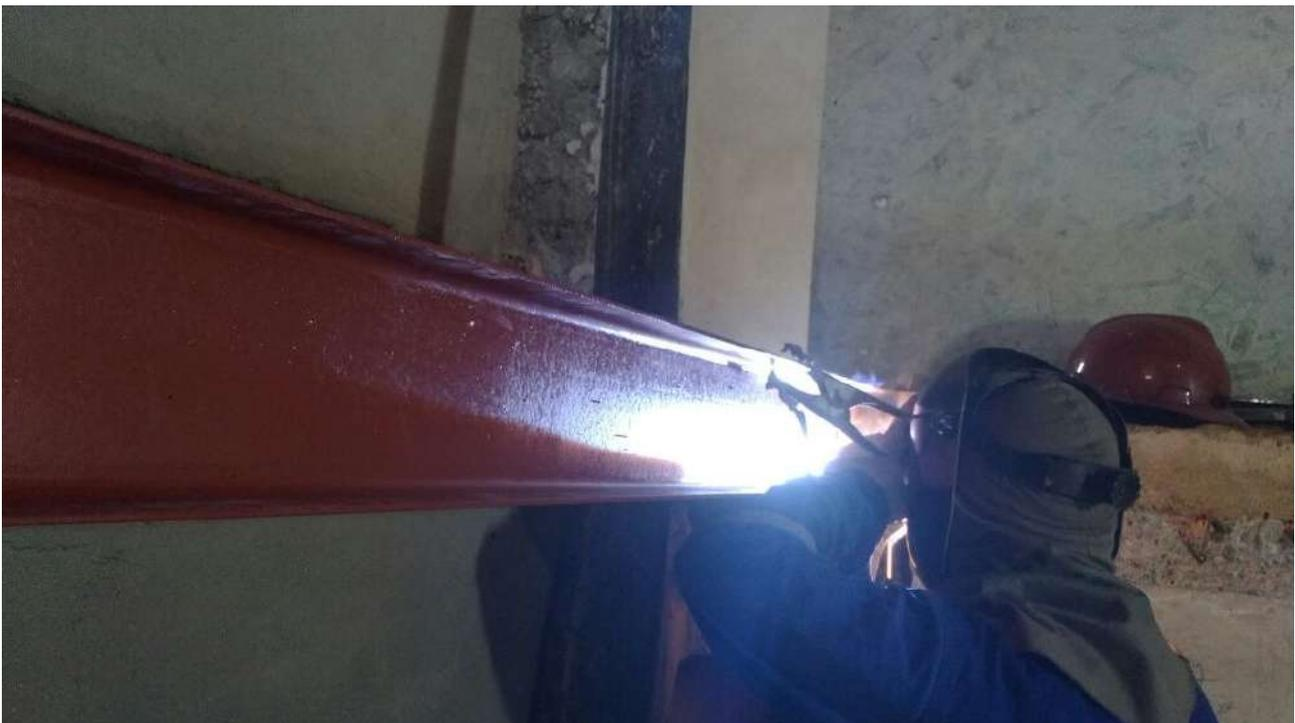
Foto 38: Instalação da passarela metálica.
