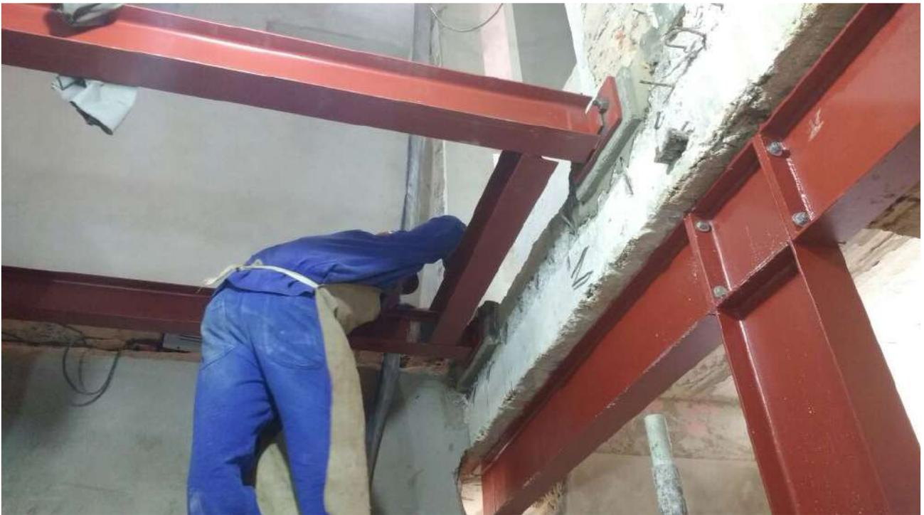
Foto 36: Instalação da passarela metálica.
