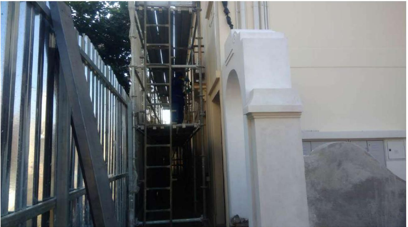
Foto 70: Substituição da chapa ondulada da fachada;
