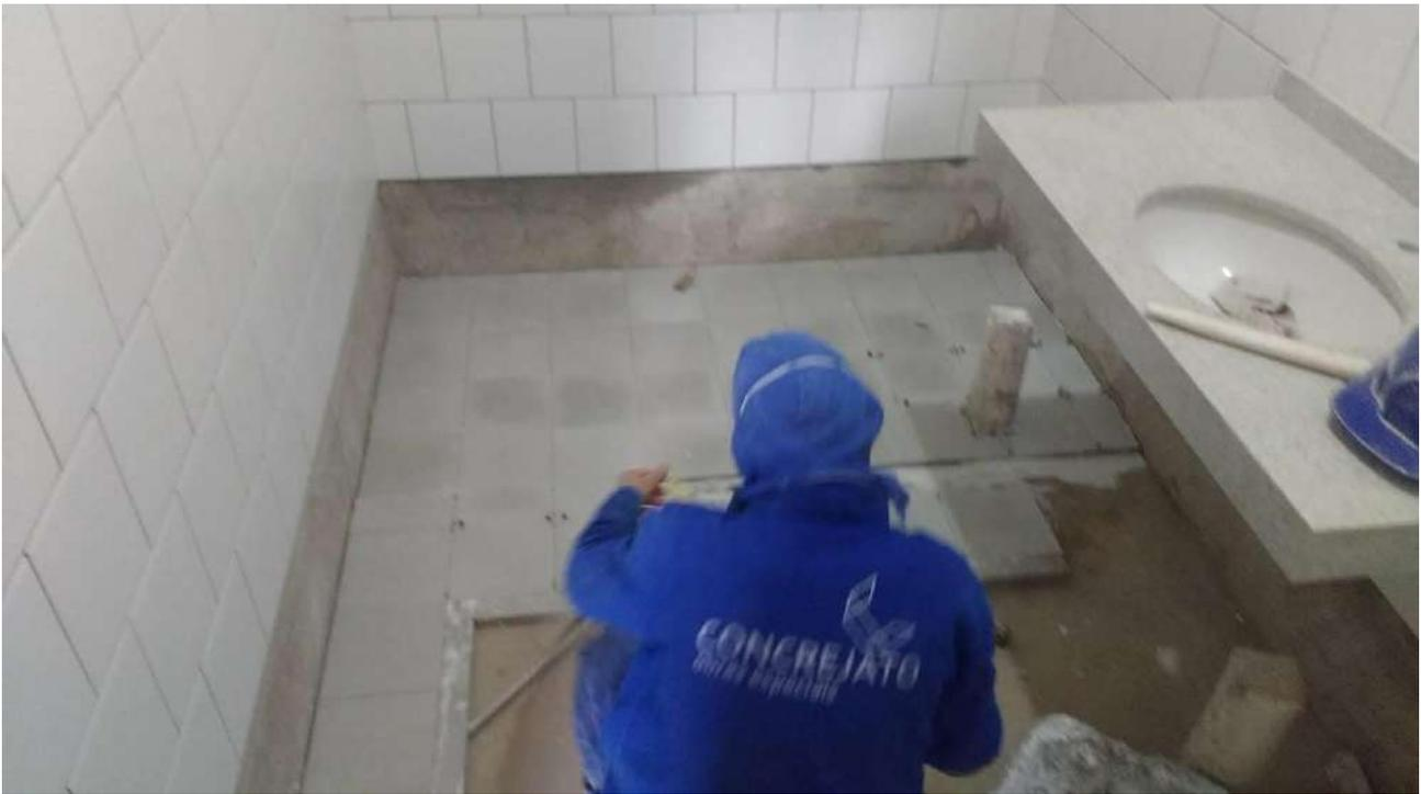
Foto 37: Instalação dos pisos de ladrilho hidráulico.
