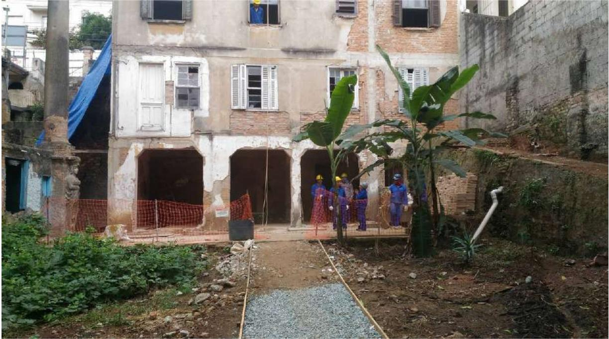
Foto 38: Abertura dos arcos do subsolo – Pavimento -3
