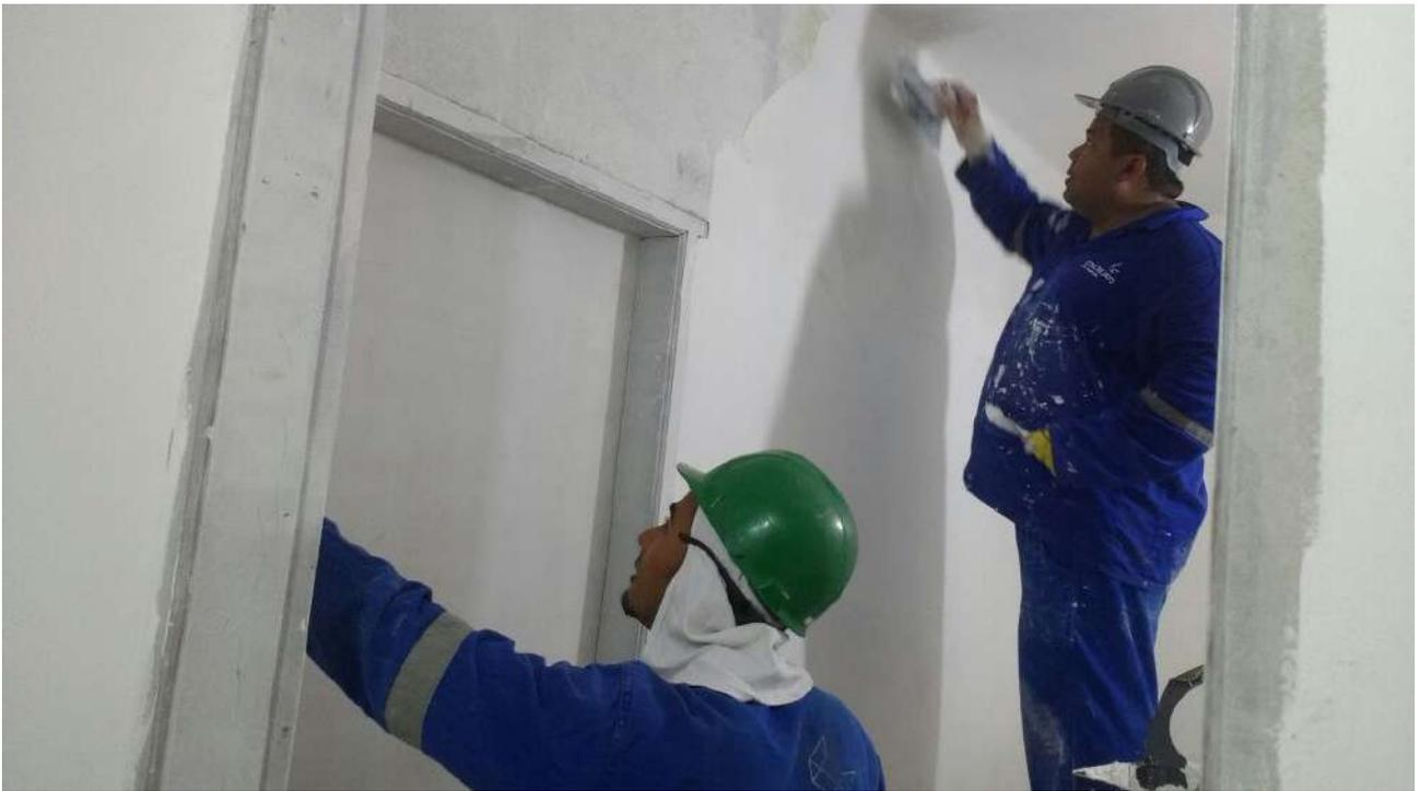
Foto 15: Emassamento das alvenarias.
