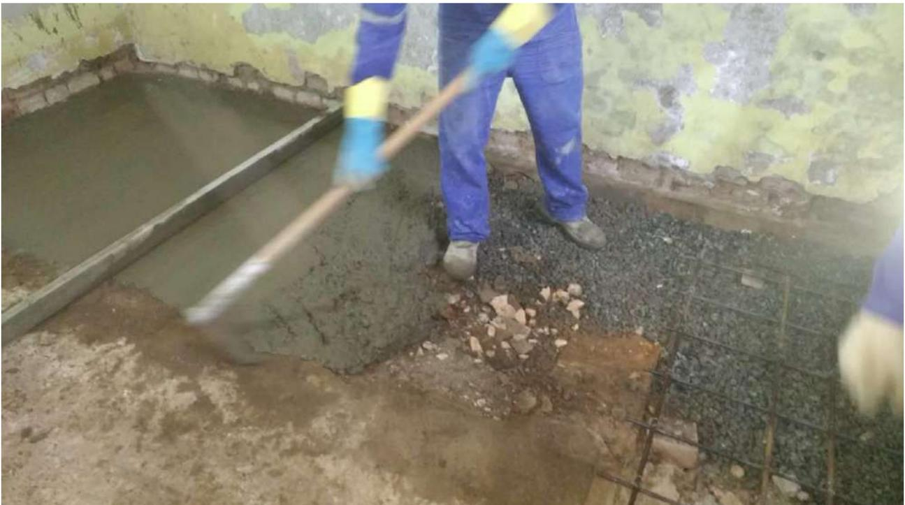
Foto 68: Execução da laje do -2 subsolo – cozinha.
