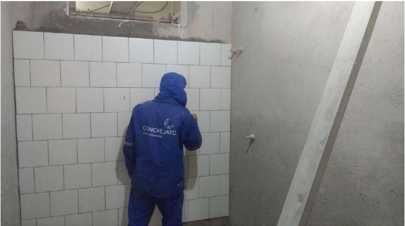
Foto 57: Instalação de revestimento cerâmico na cozinha do -2 subsolo.
