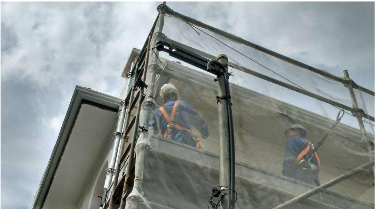
Foto 10: Instalação de descidas de águas pluviais na fachada.
