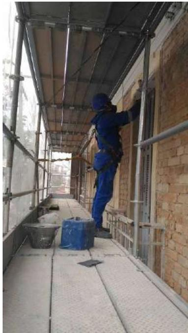
Foto 47: Decapagem das tintas látex da fachada frontal e remoção dos revestimentos desprendidos da fachada
