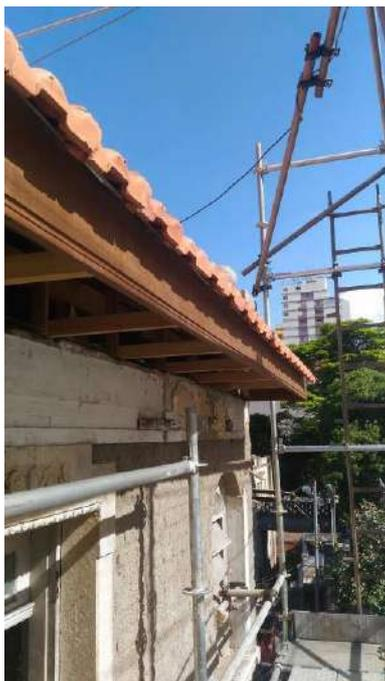
Foto 41: Instalação da testeira do telhado
