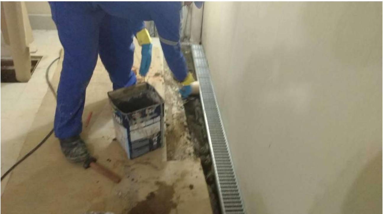
Foto 40: Instalação da grelha no -1 subsolo.
