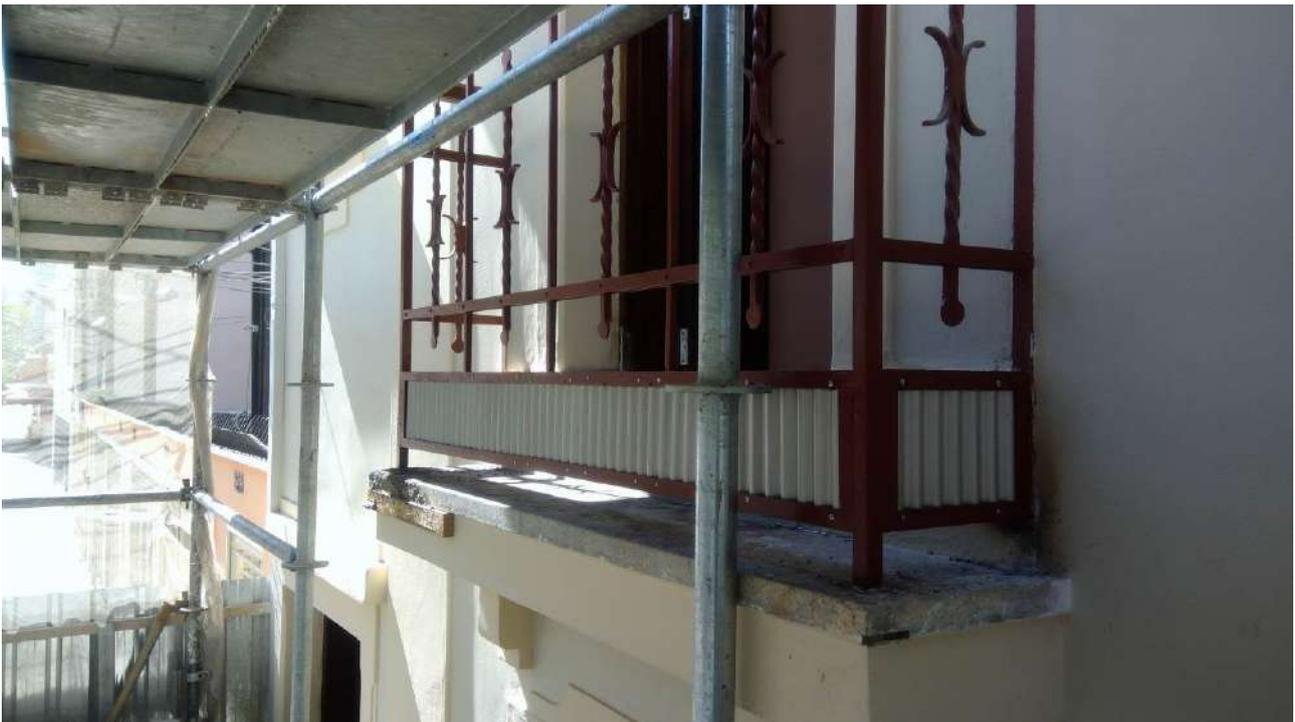
Foto 85: Substituição da chapa ondulada da fachada;
