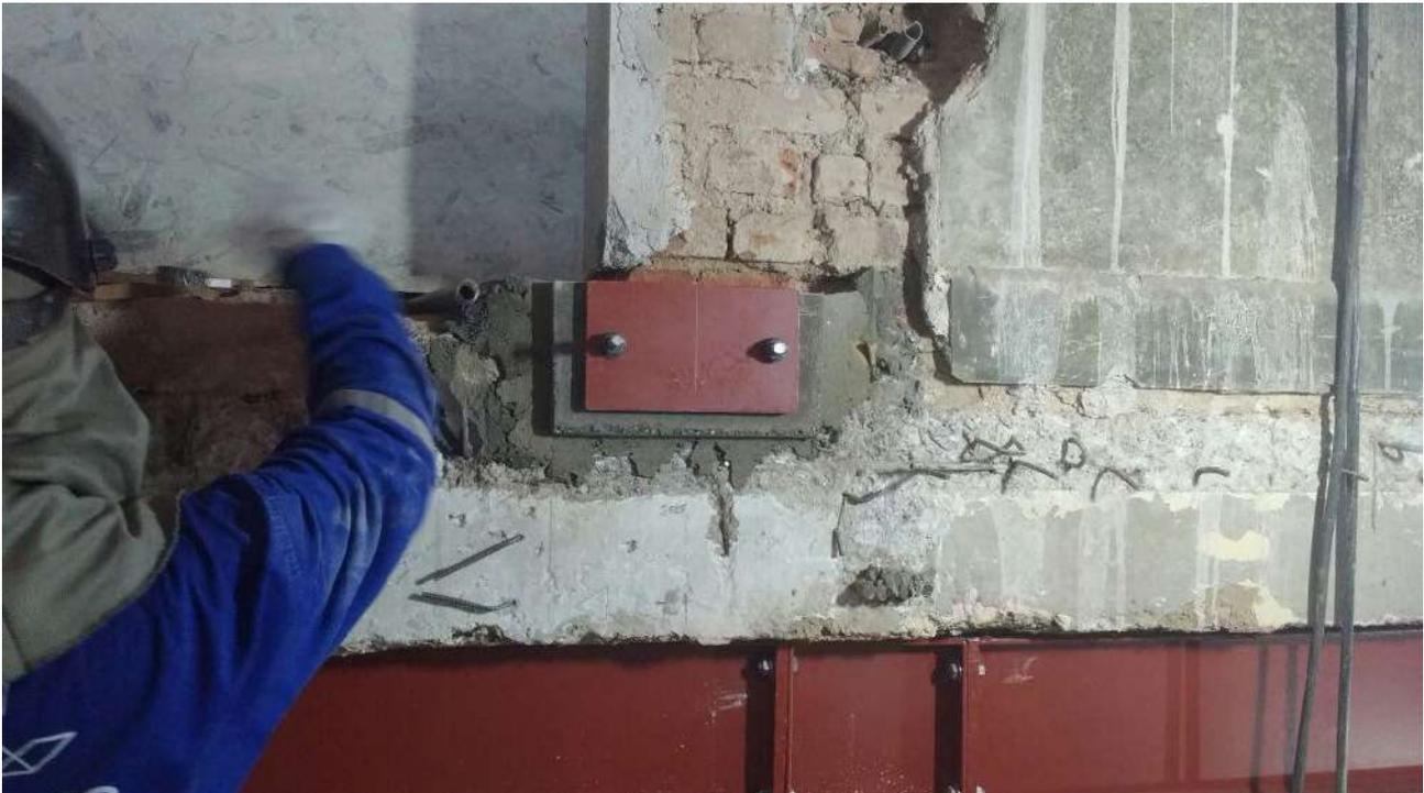
Foto 37: Instalação da passarela metálica.
