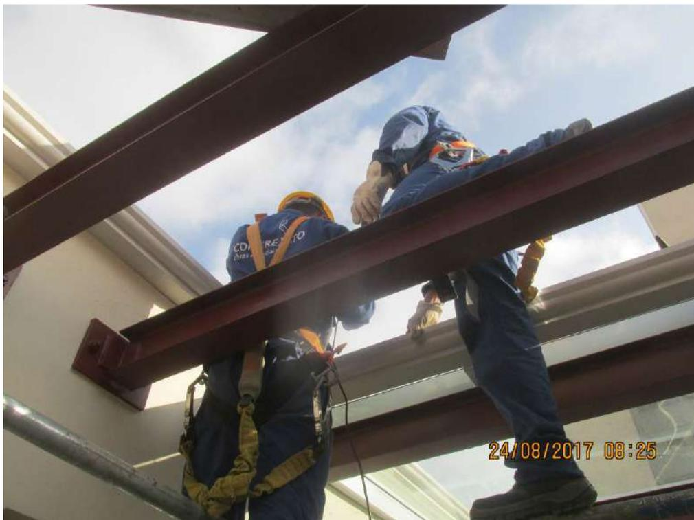
Foto 06: Instalação de calha da cobertura de vidro;
