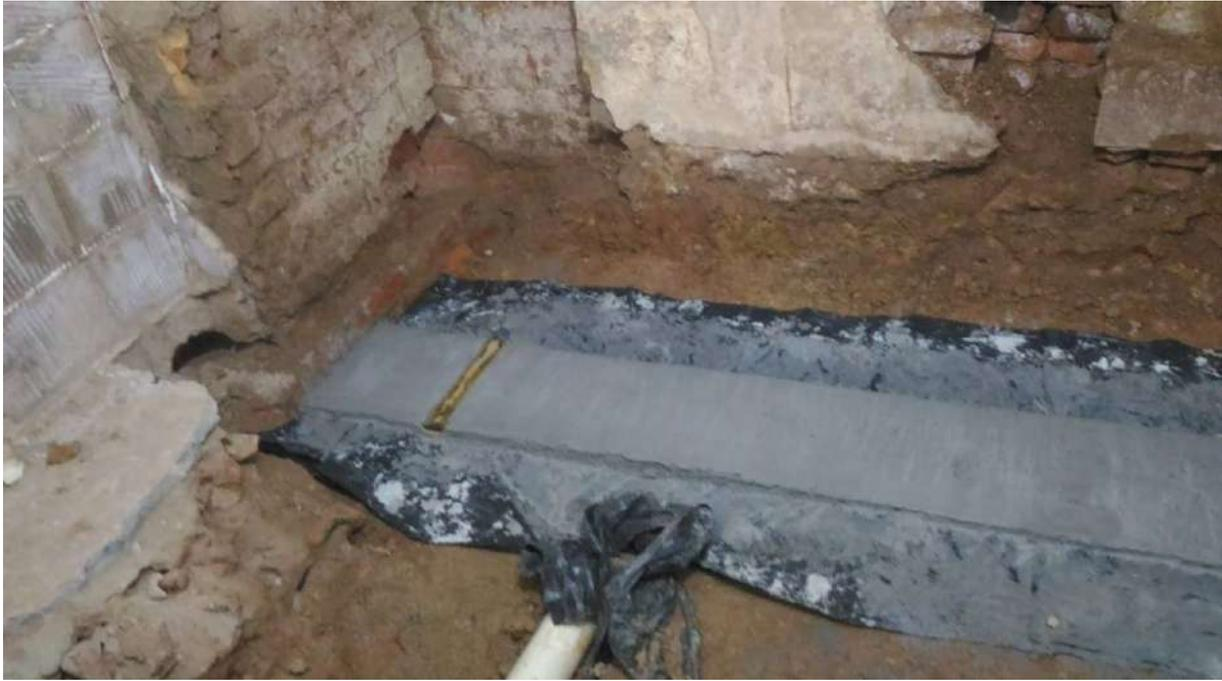
Foto 63: Concretagem da viga baldrame
