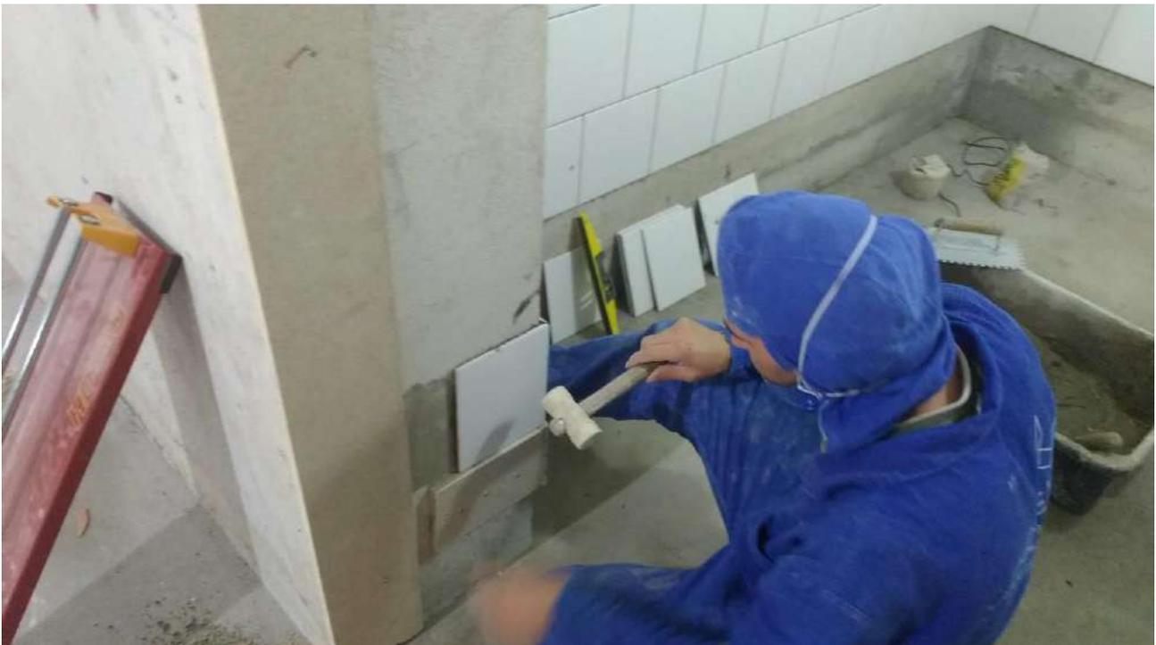
Foto 64: Instalação de revestimento cerâmico.
