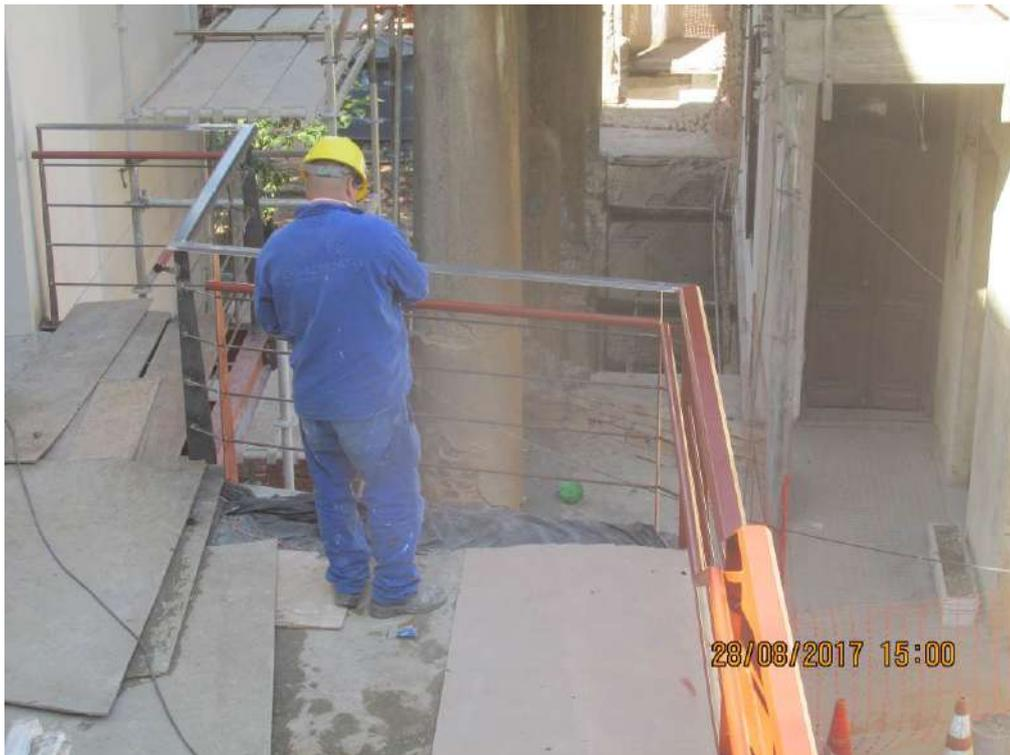
Foto 49: Pintura de acabamento do guarda corpo
