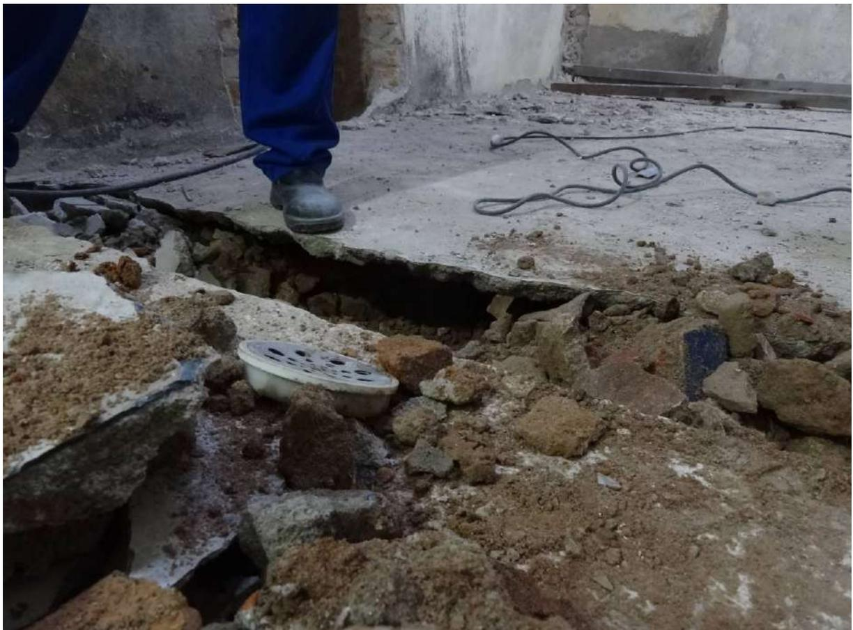
Foto 46: Demolição dos pisos do pátio central e retirada das tubulações de esgoto
