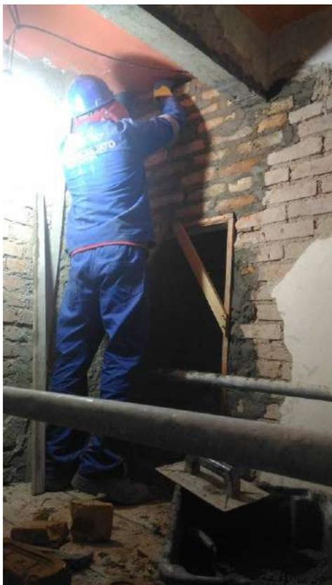
Foto 12: Remontagem da alvenaria.
