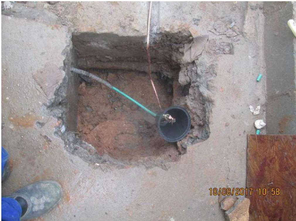
Foto 47: Aterramento do quadro elétrico
