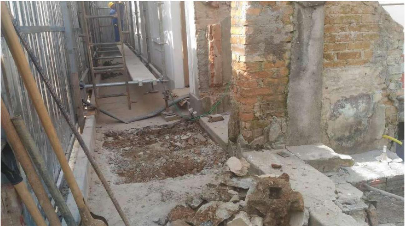
Foto 01: Abertura das valas para execução dos blocos da escadaria.
