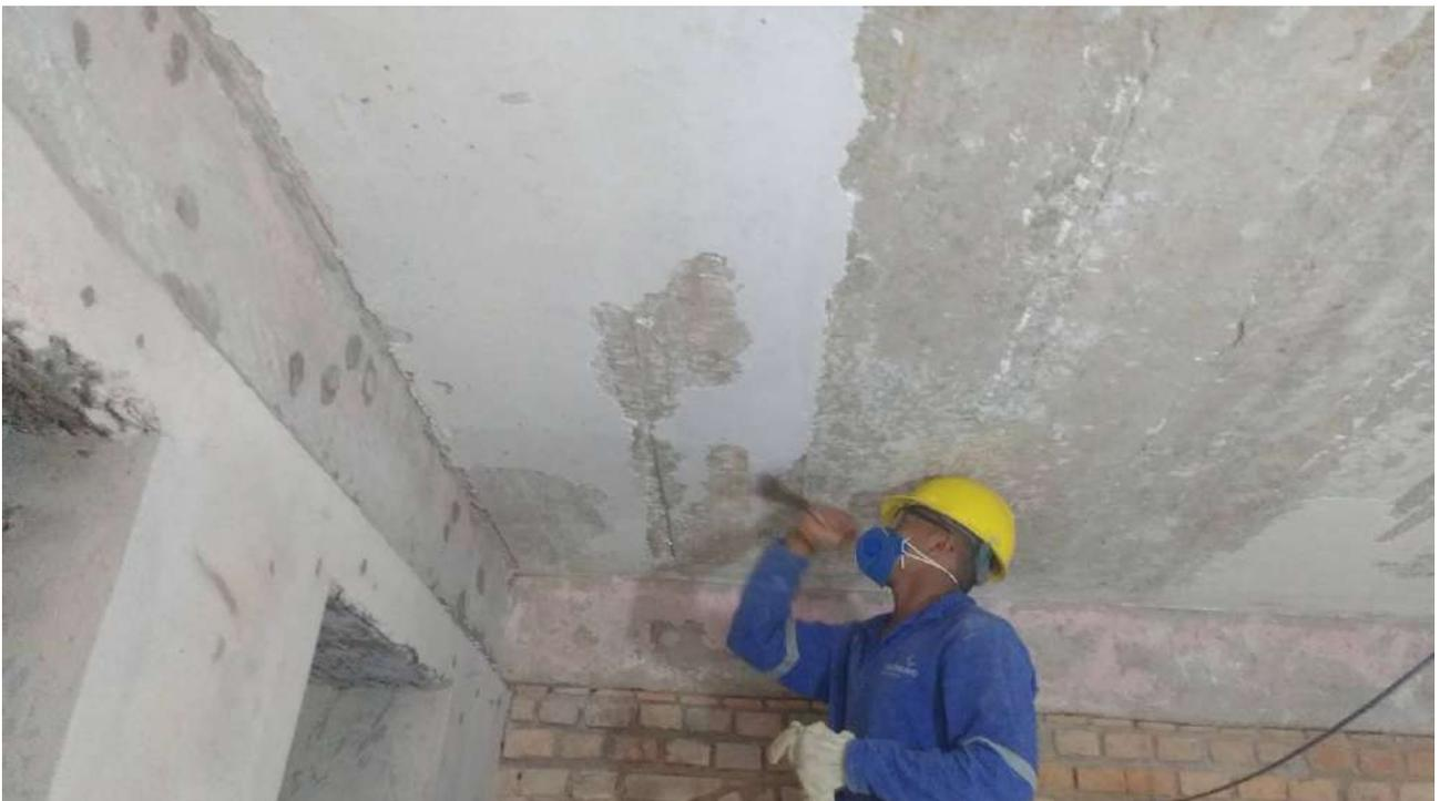
Foto 14: Decapagem das tintas da laje do -1 subsolo.
