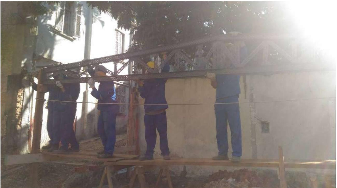
Foto 07: Montagem do barracão de apoio à obra
