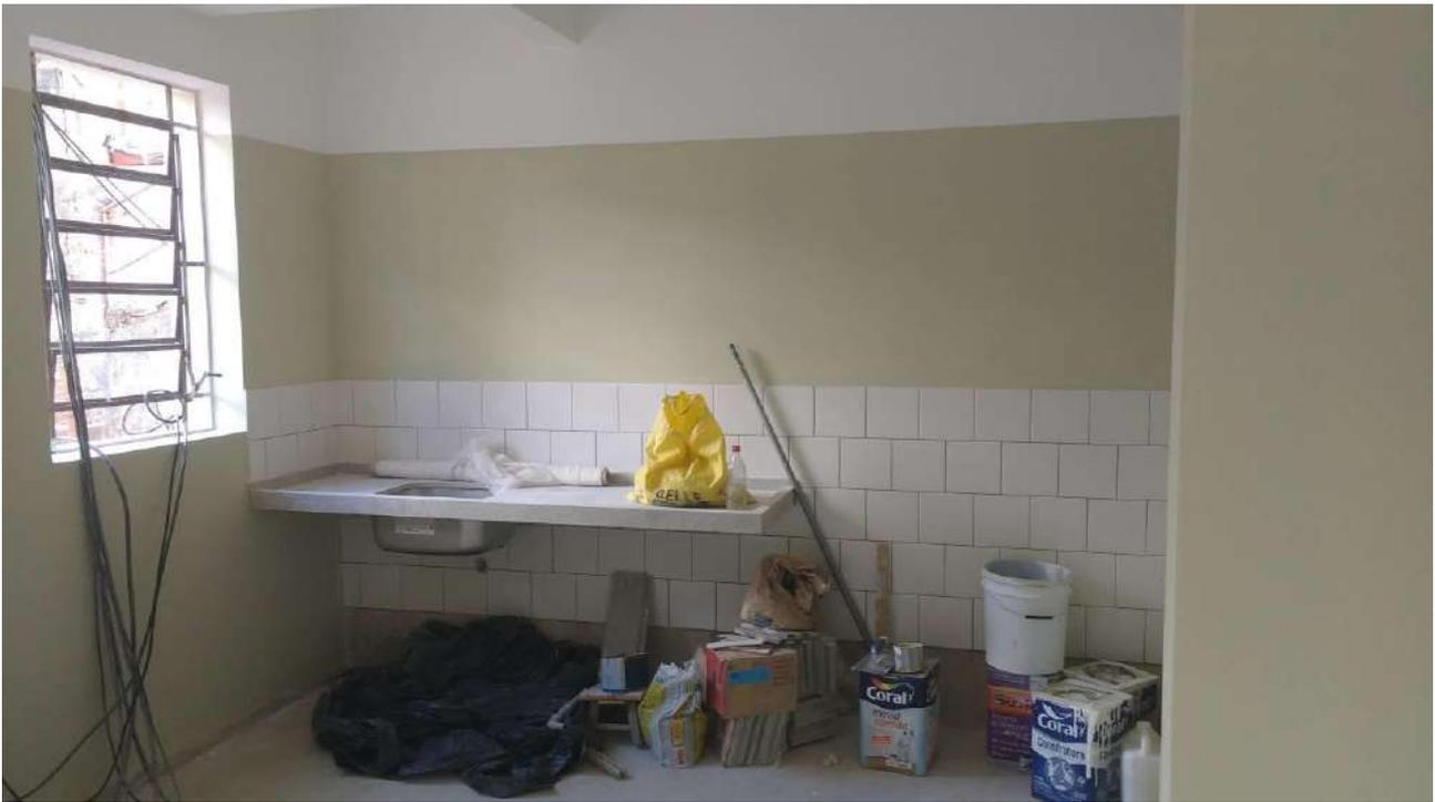
Foto 53: Pintura de acabamento das alvenarias internas.
