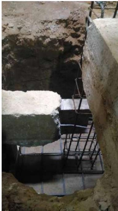
Foto 21: Execução da armadura de aço para o reforço.
