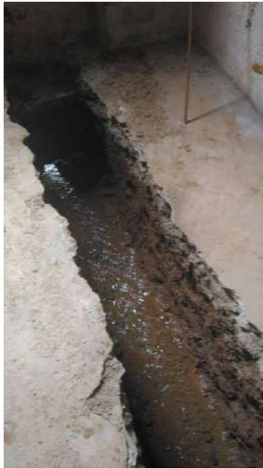
Foto 15: Abertura das valas para drenagem do talude
