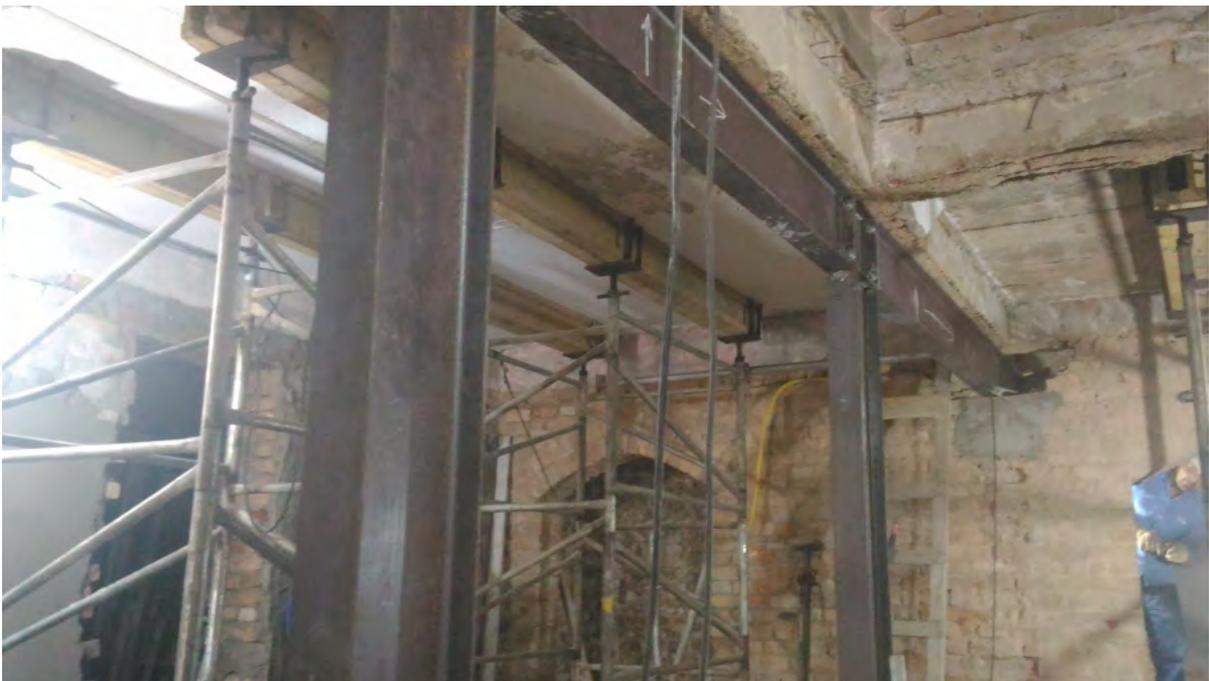
Foto 16: Instalação dos pilares e vigas metálicas no -1 subsolo.
