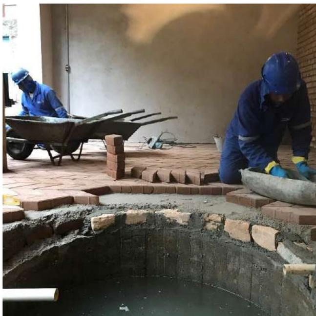
Foto 05 – Instalação dos pisos intertravados – Casa 11
