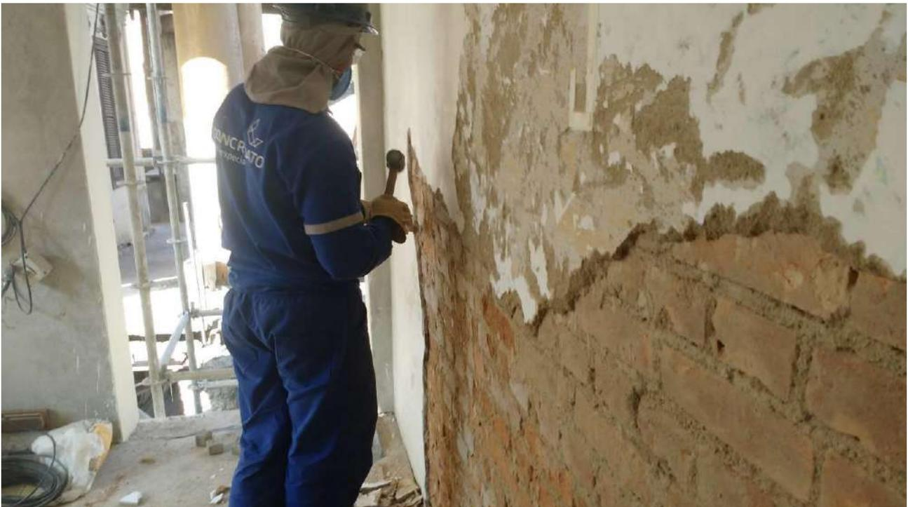
Foto 52: Remoção das argamassas danificadas do -2 subsolo.
