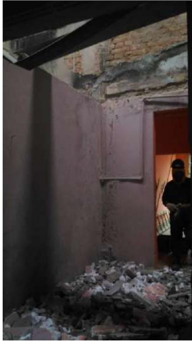
Foto 25: Demolições das intervenções posteriores no poço de iluminação da Casa 11
