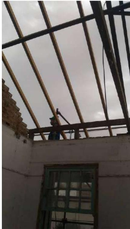
Foto 17: Substituição dos caibros danificados
