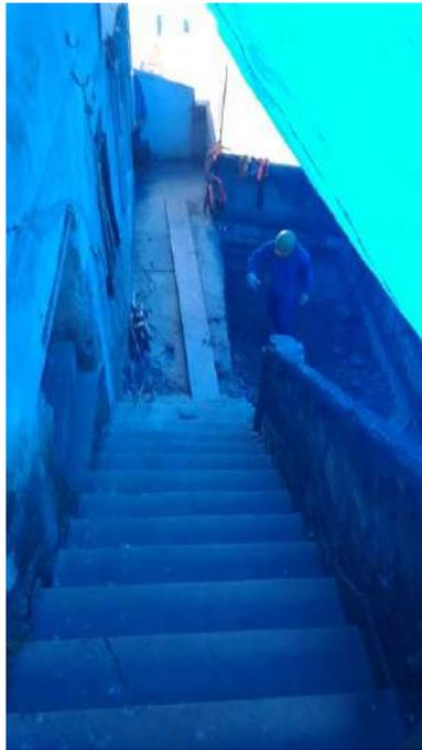
Foto 31: Demolição cuidadosa dos pisos que estavam cedidos devido a movimentação do aterro.
