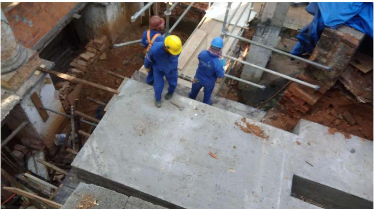
Foto 10: Desfôrma dos blocos de e vigas de concreto.
