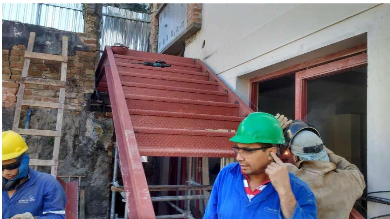
Foto 20: Instalação dos degraus da escadaria.
