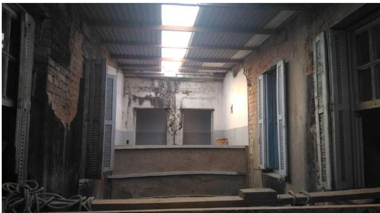
Foto 37: Demolição das interferências internas no poço do iluminação da Casa 11
