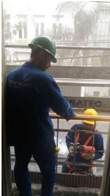
Foto 36 – Substituição da madeira do peitoril da varanda.
