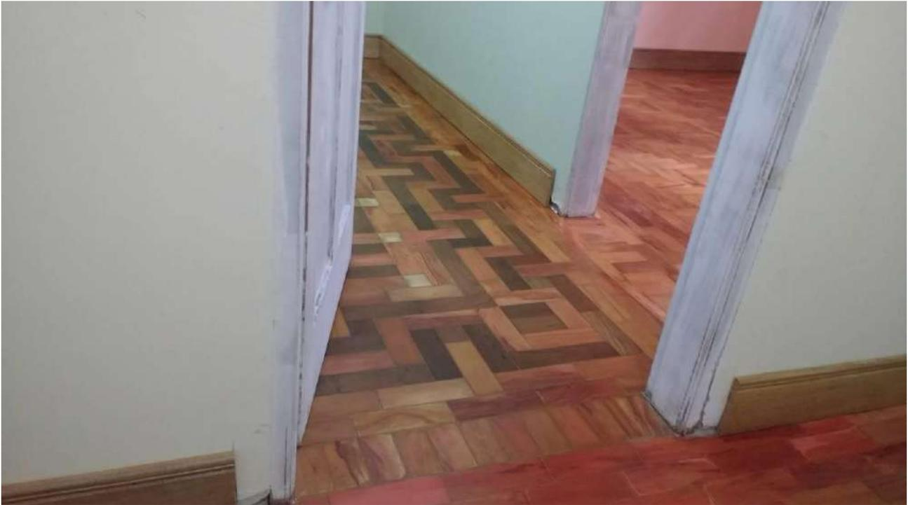
Foto 37: Raspagem e acabamento dos pisos de madeira.
