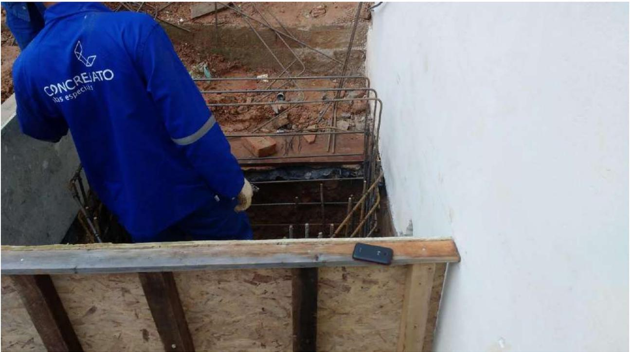
Foto 15: Blocos para sustentação de escadaria e passarela metálica.
