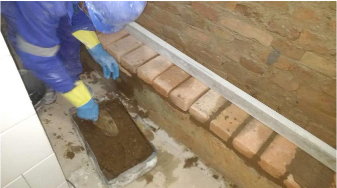
Foto 17: Execução do banco de alvenaria no banheiro feminino no -1 subsolo.
