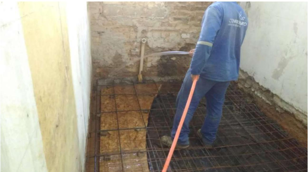
Foto 46: Armação das laje da cozinha do -2 subsolo.
