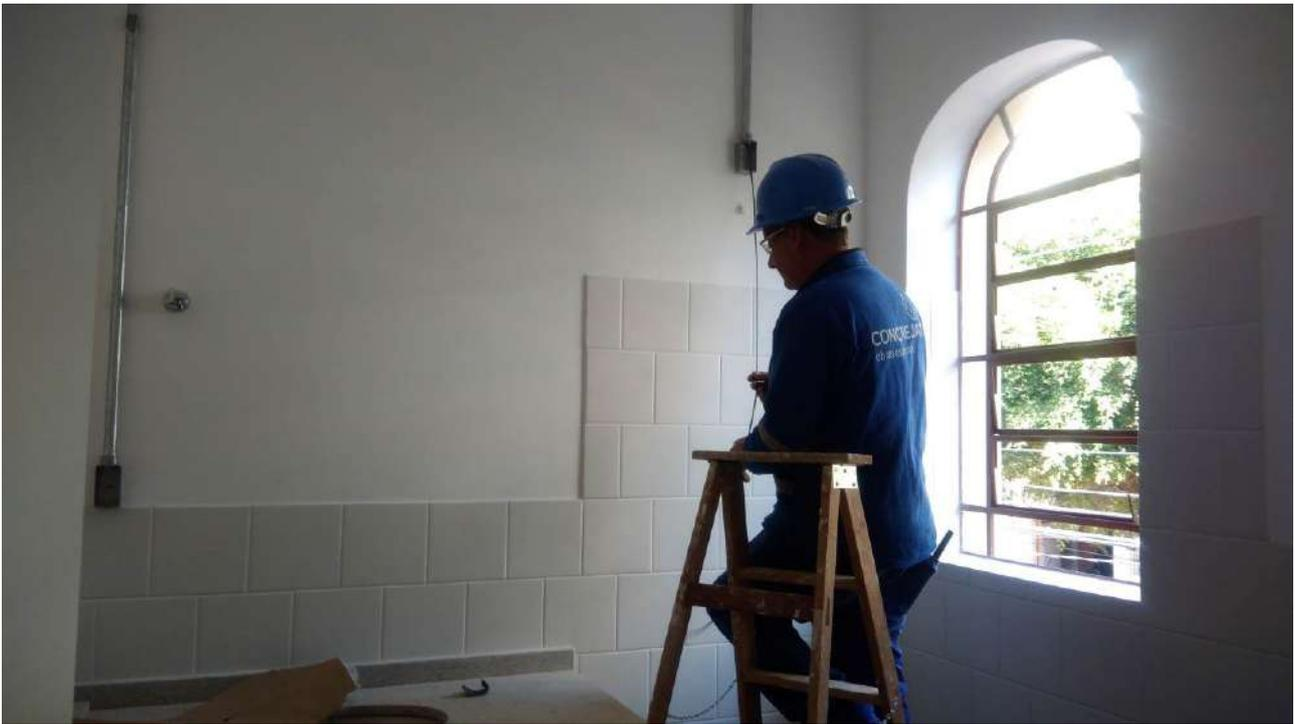
Foto 14: Passagem do cabeamento de elétrica;
