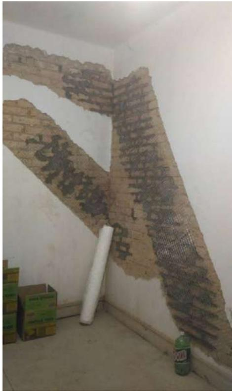
Foto 17: Instalação das telas galvanizadas.
