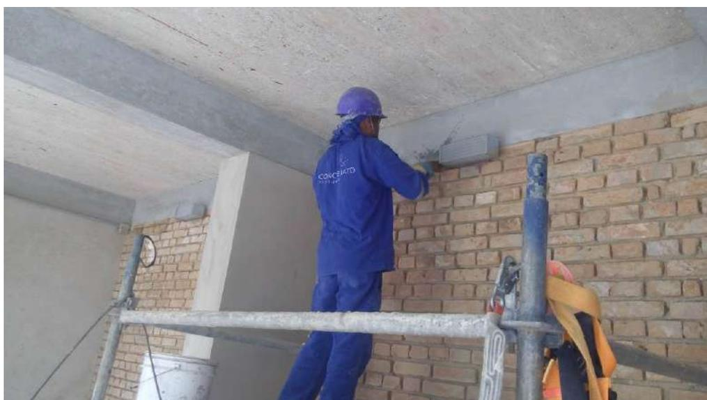
Foto 19 – Revisão na parede de tijolos – 3° Pavimento
