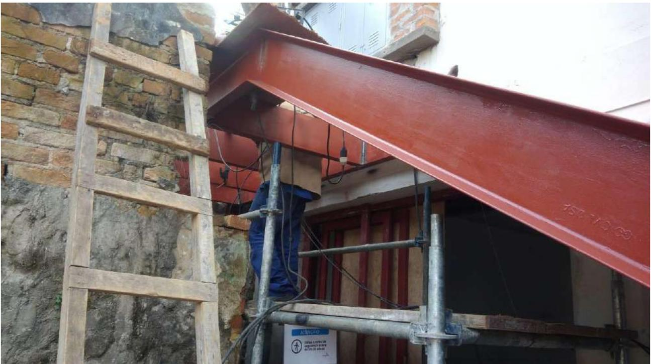
Foto 28: Montagem da escadaria metálica.
