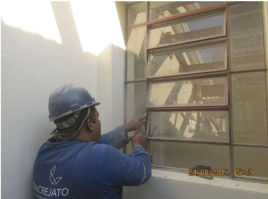
Foto 01: Instalação de vidros nas esquadrias.
