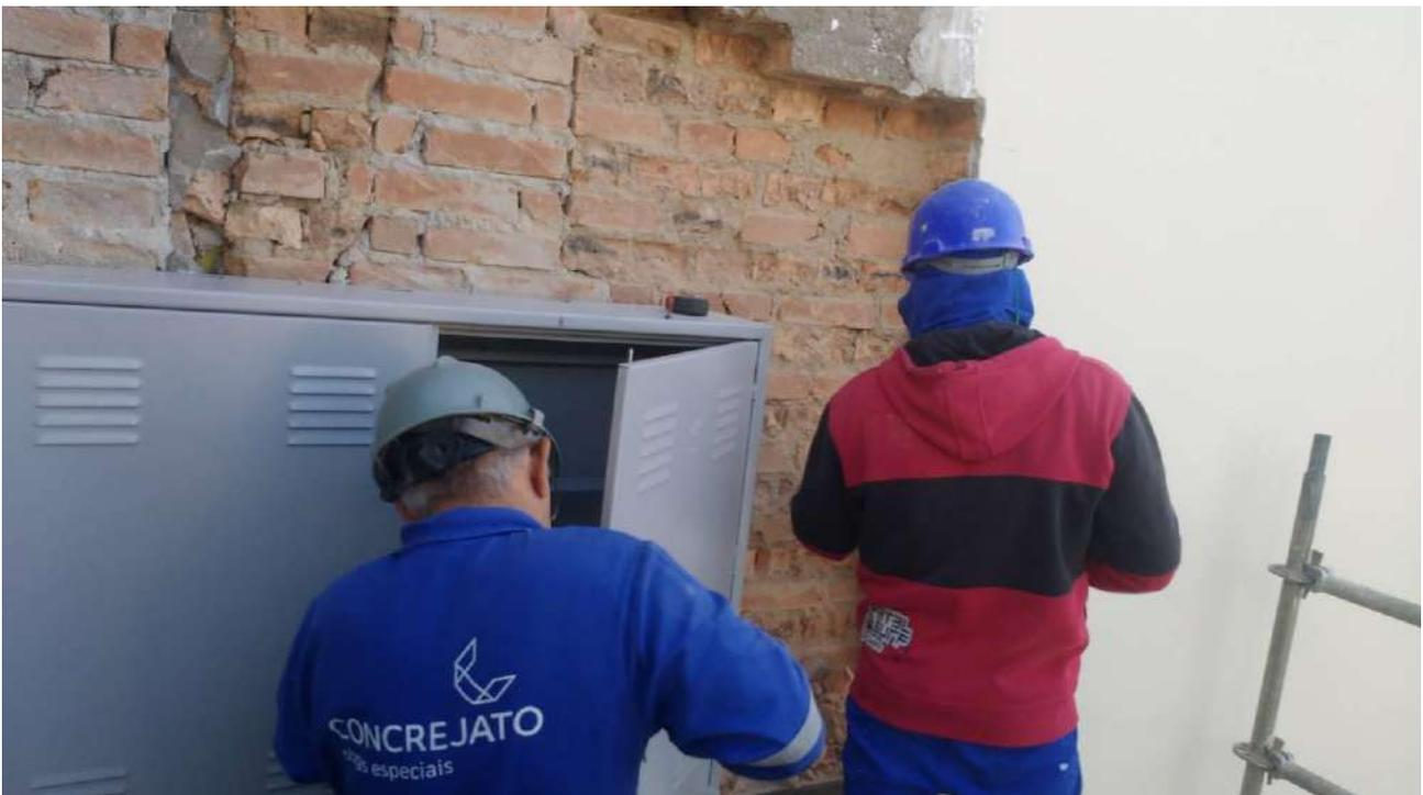
Foto 76: Instalação de quadro elétrico – entrada de energia da Casa 11.
