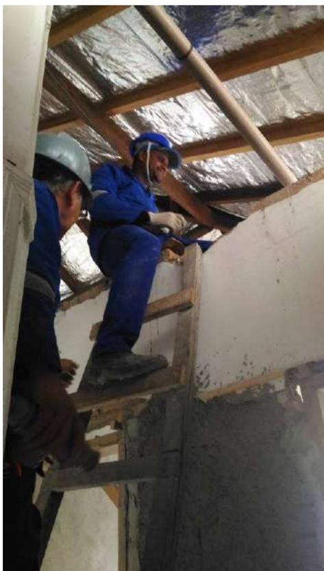
Foto 31: Instalação das caixas d' água e execução do barrilete.
