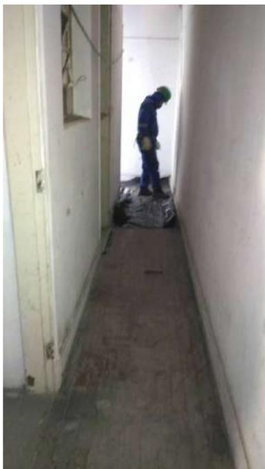
Foto 11: Proteção dos pisos de madeira.
