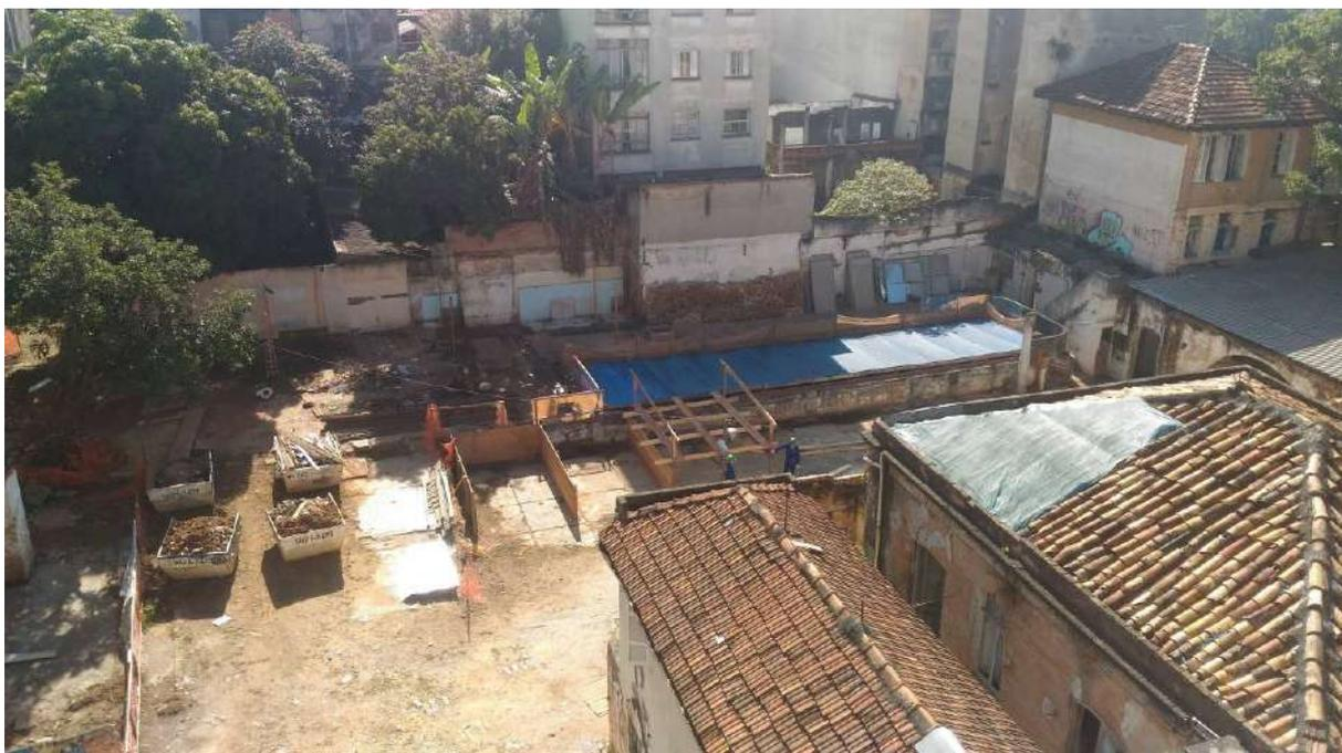
Foto 09: Montagem das baias de agregados do canteiro de obras.
