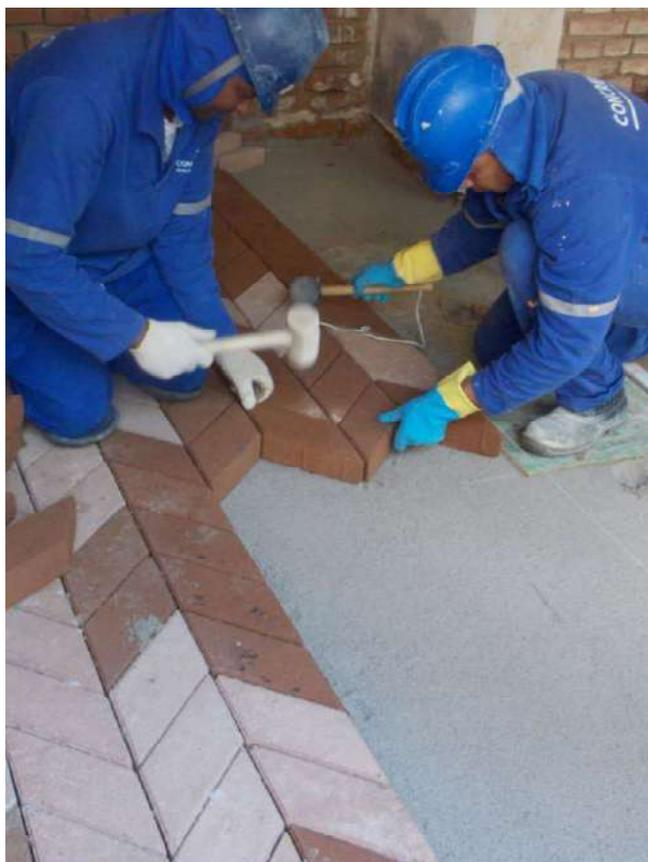
Foto 03 – Instalação dos pisos intertravados – Casa 11
