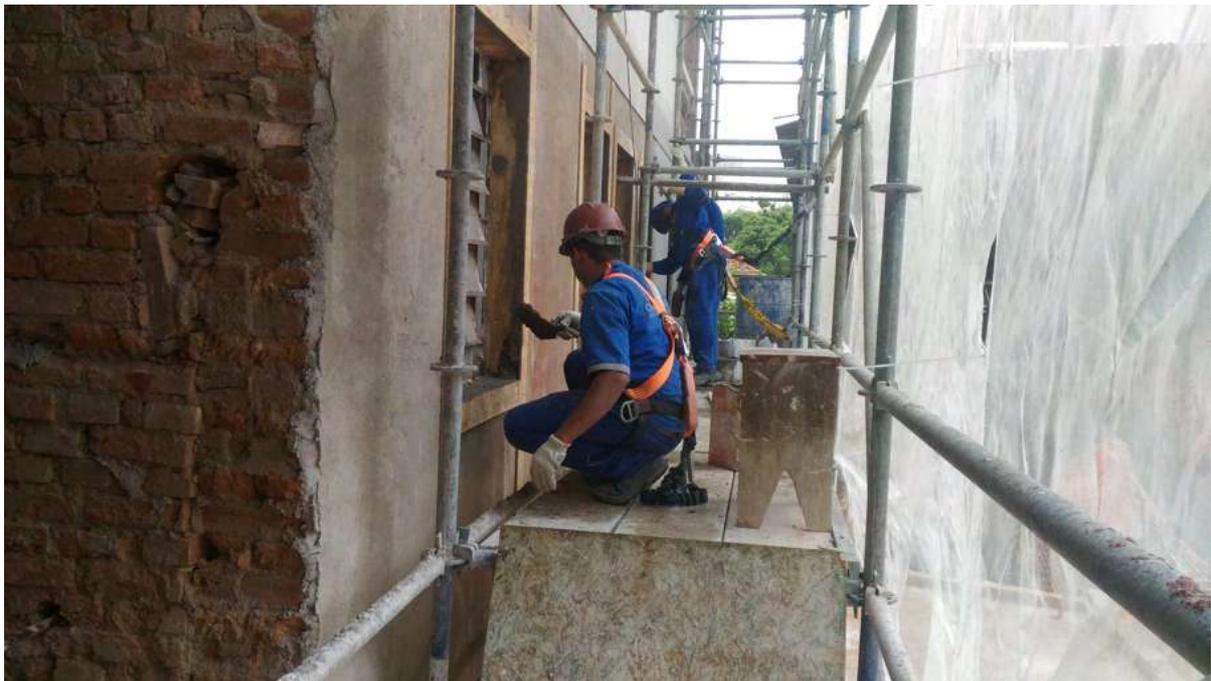
Foto 06: Execução dos requadros da fachada lateral
