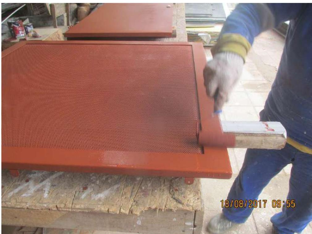
Foto 56: Pintura de acabamento das grades da fachada frontal;
