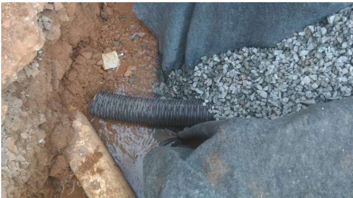
Foto 19: Execução da drenagem provisória da Casa 11- área externa
