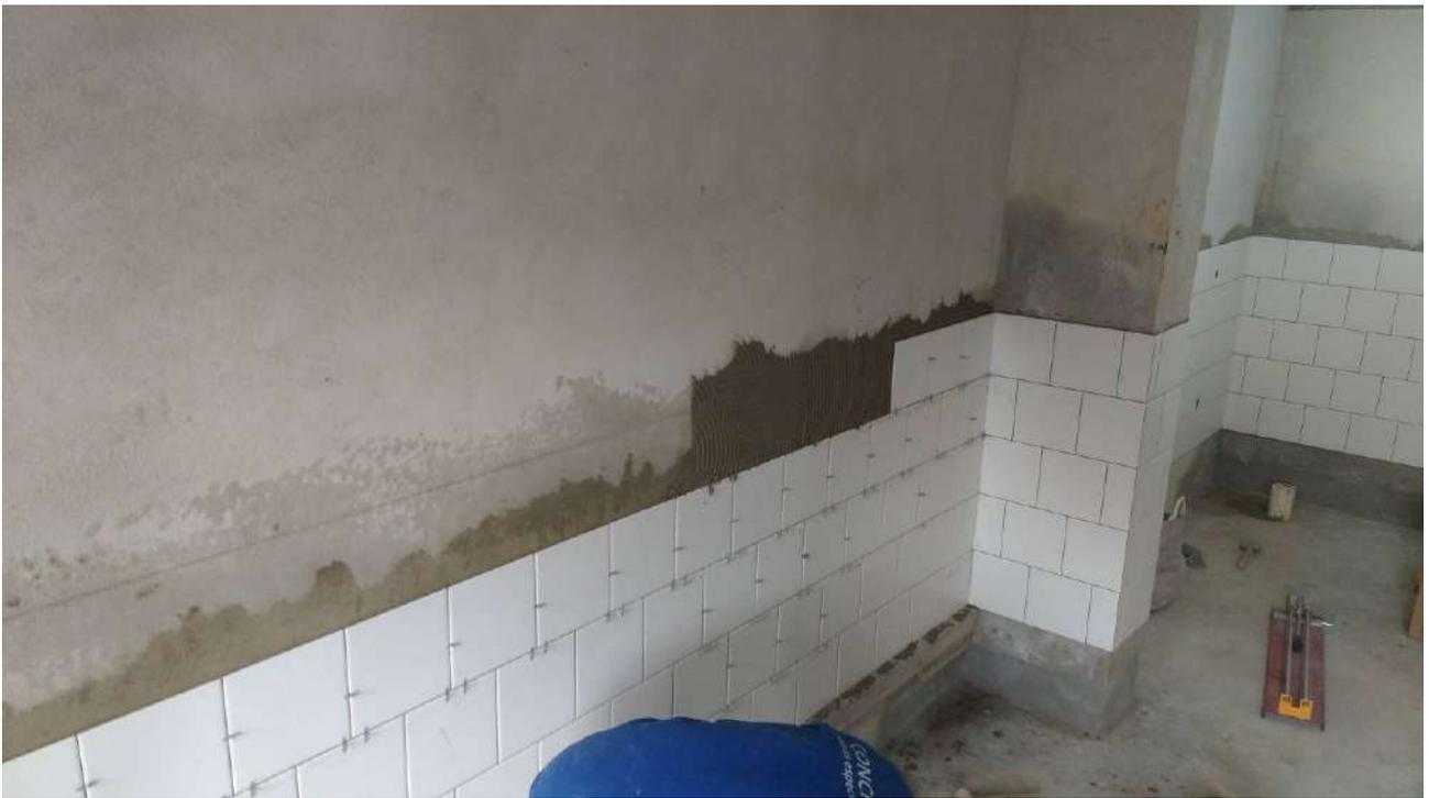
Foto 12: Instalação de revestimento cerâmico.
