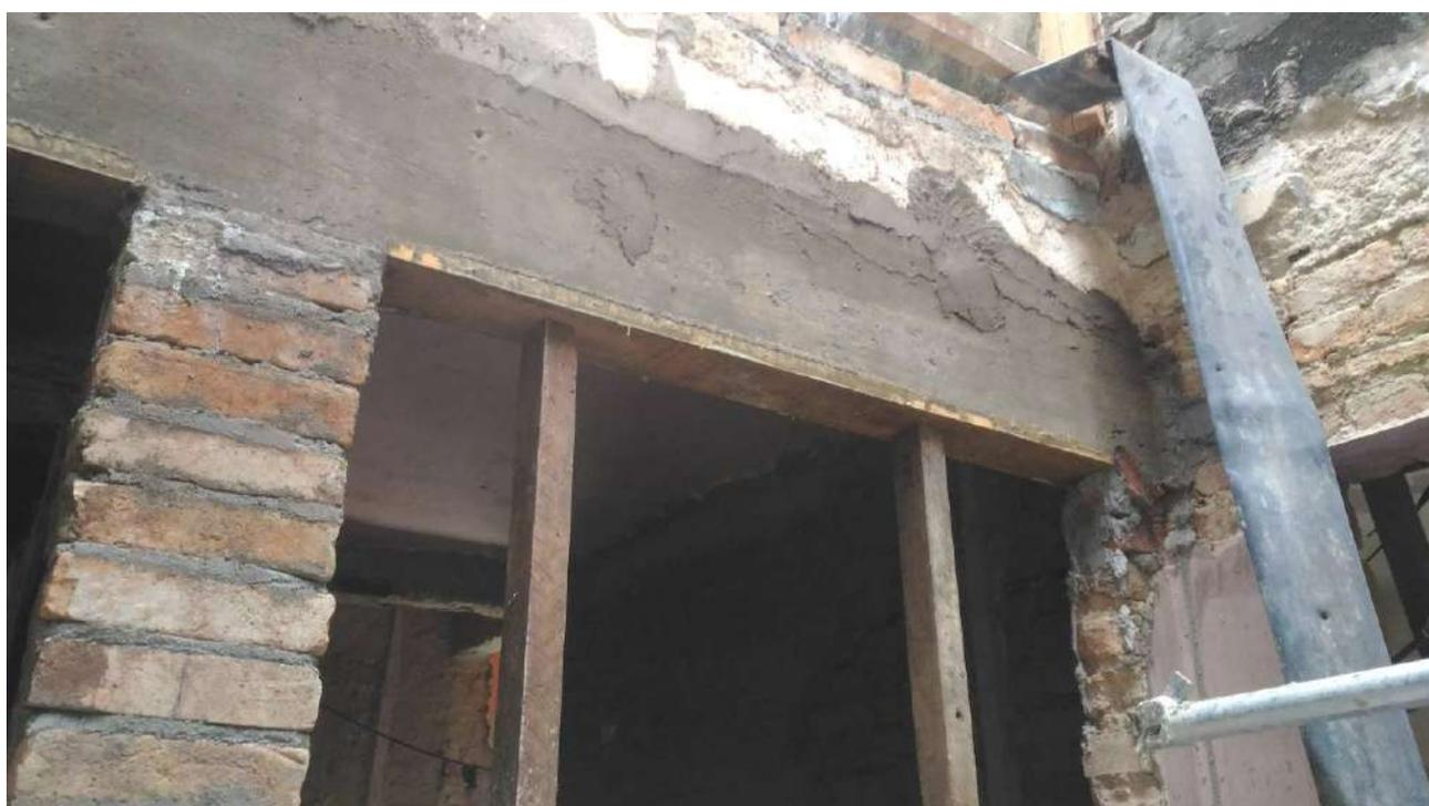
Foto 14: Execução de viga de concreto para verga das esquadrias dos banheiros.
