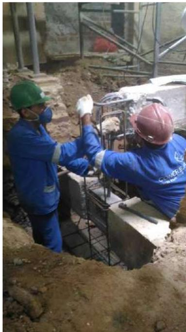
Foto 22: Execução da armadura de aço para o reforço.
