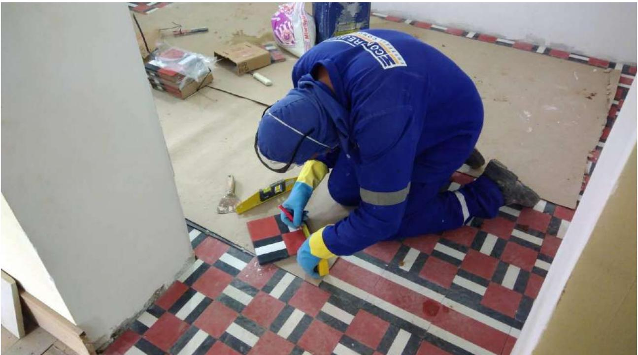
Foto 58: Instalação do piso em ladrilho hidráulico da cozinha do -2 subsolo.
