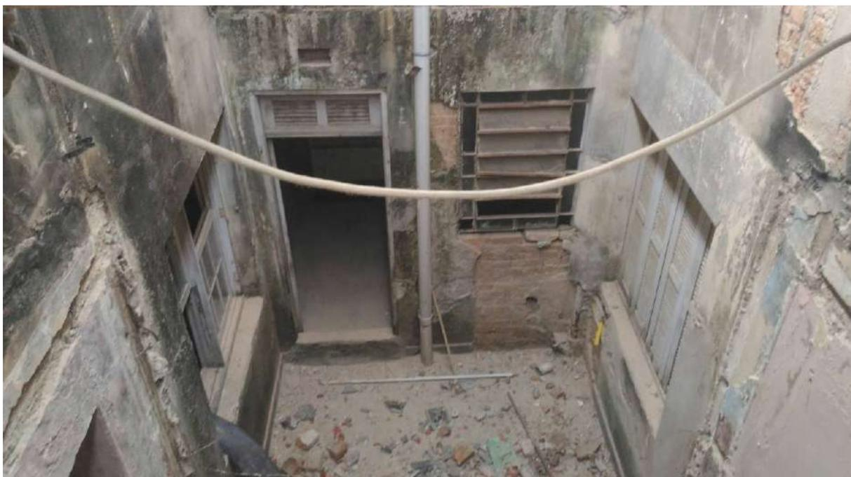
Foto 36: Demolição das interferências internas no poço do iluminação da Casa 11
