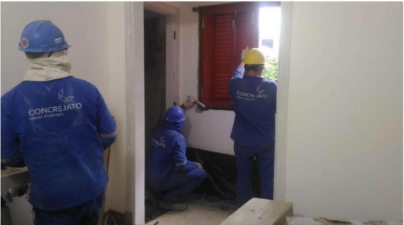
Foto 70: Instalação das esquadrias metálicas
