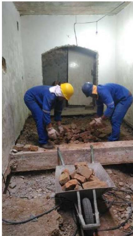
Foto 54: Demolição dos pisos do pátio central – 1 subsolo
