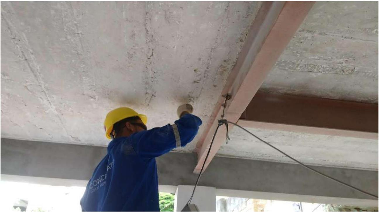
Foto 15: Limpeza fina da laje de concreto – Pav -1 subsolo
