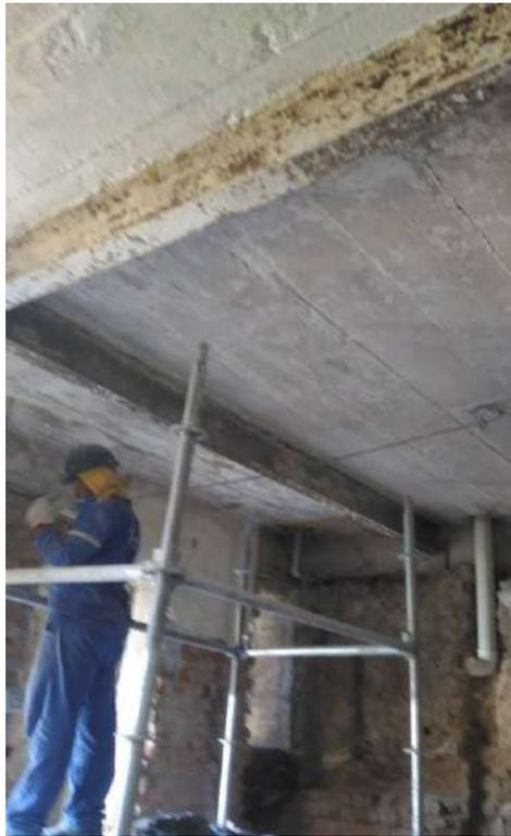
Foto 63: Remoção mecânica das tintas dos forros.
