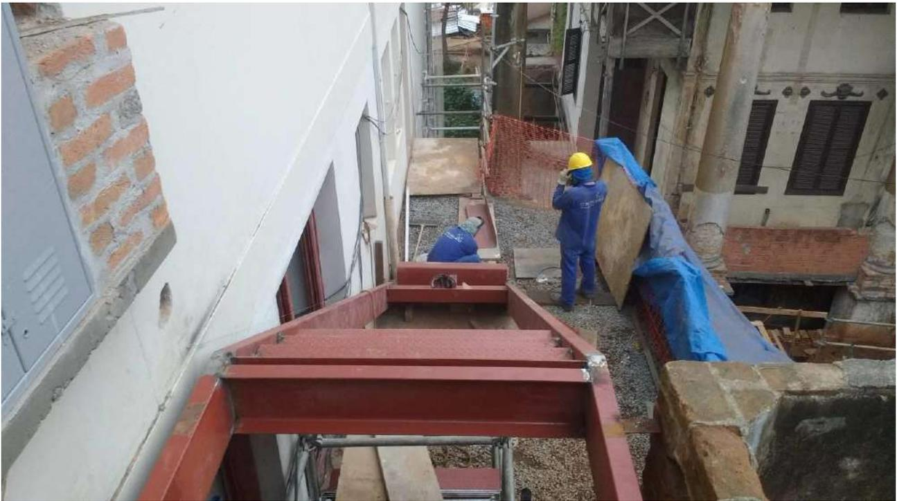
Foto 17: Montagem da escadaria metálica da fachada lateral
