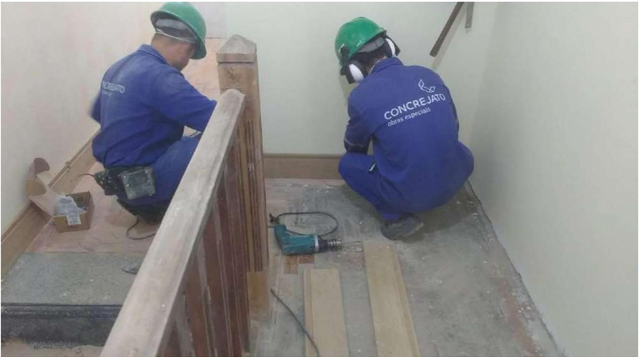
Foto 41: Instalação dos rodapés de acabamento.
