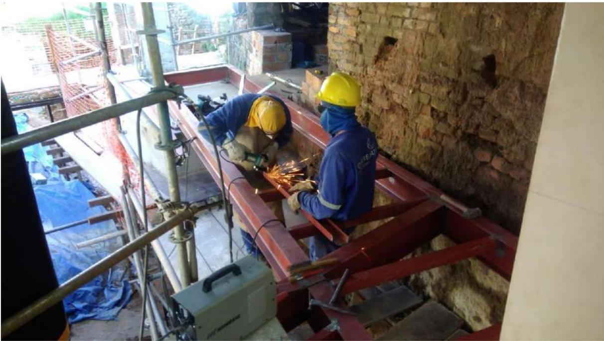
Foto 39: Montagem da passarela metálica de acesso ao -2 pavimento
