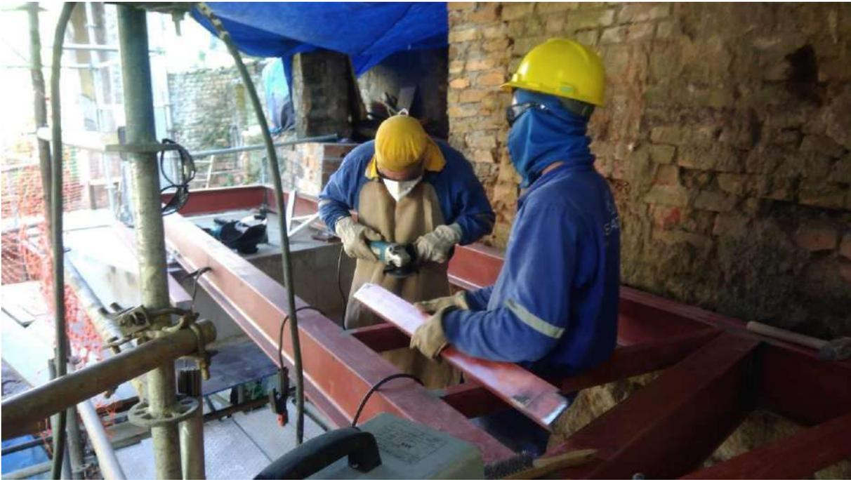
Foto 41: Montagem da passarela metálica de acesso ao -2 pavimento
