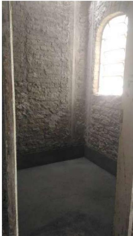
Foto 49: Impermeabilização cimentícia dos pisos das áreas molhadas.
