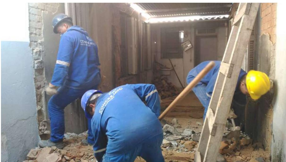
Foto 04: Desmonte das alvenarias
