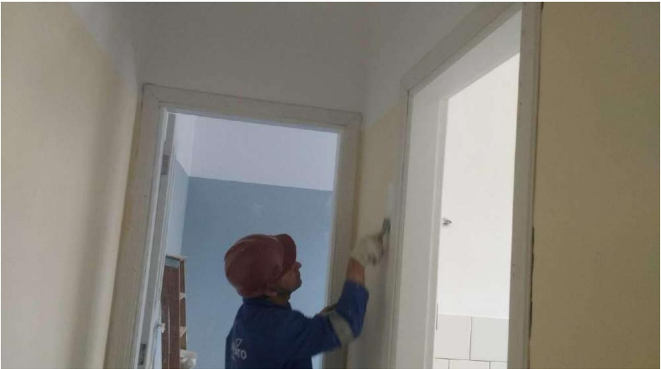
Foto 55: Pintura de acabamento das alvenarias.
