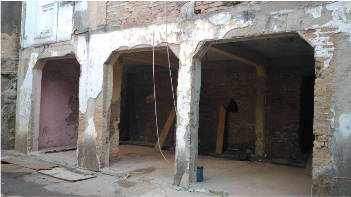
Foto 40: Abertura dos arcos do subsolo – Pavimento -3
