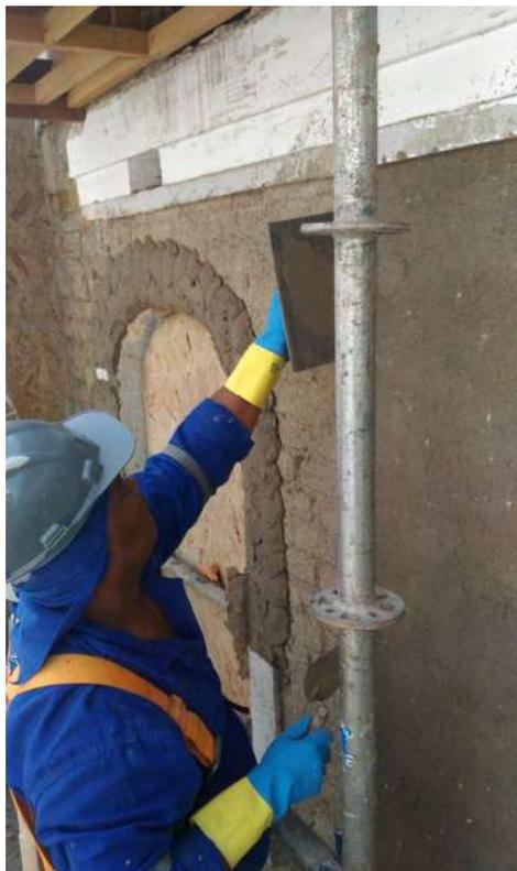
Foto 54: Acabamento – execução dos detalhes da fachada frontal.
