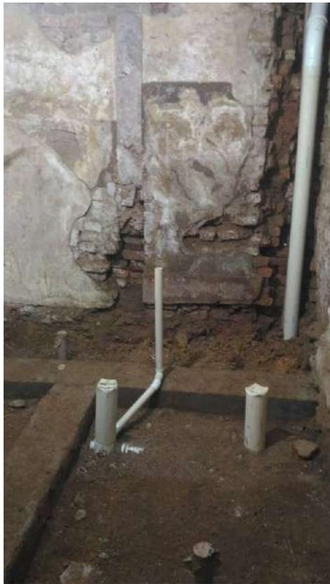
Foto 29: Execução do novo sistema de hidráulica (esgoto; alimentação de água e alimentação de água de reuso)
