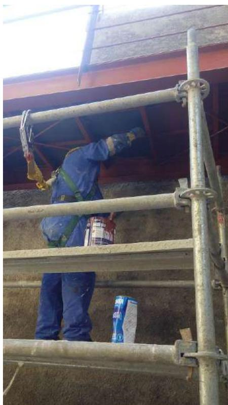
Foto 11 – Pintura lisa da passarela metálica.
