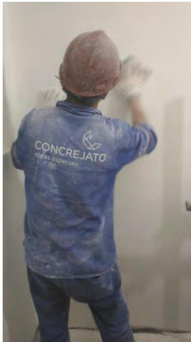
Foto 09: Lixamento das alvenarias.
