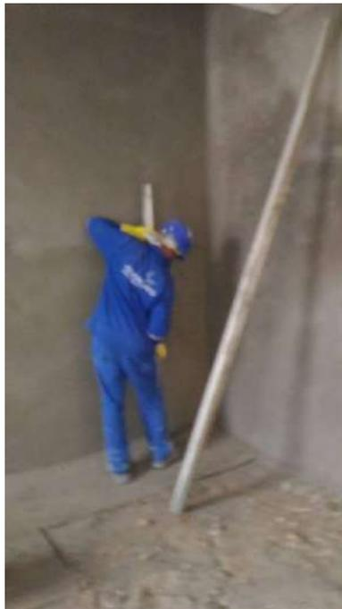
Foto 59: Emboço das alvenarias internas
