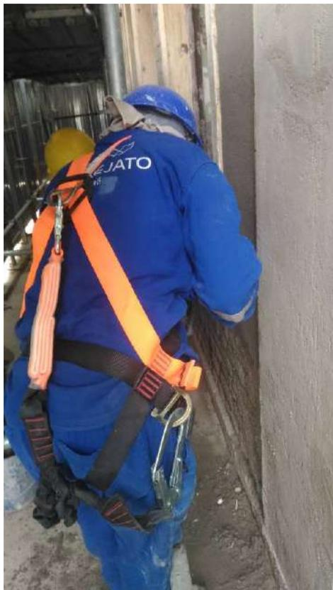
Foto 52: Acabamento – emboço na fachada frontal.
