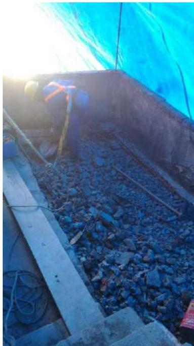
Foto 32: Demolição cuidadosa dos pisos que estavam cedidos devido a movimentação do aterro.
