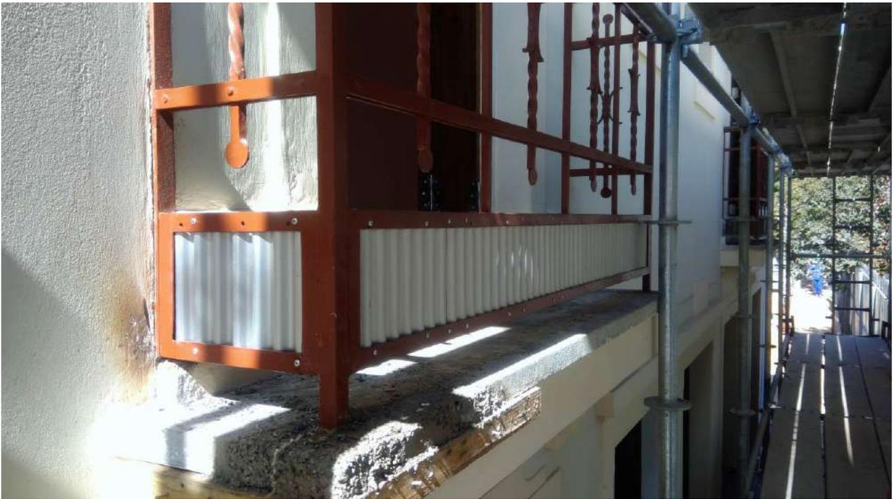
Foto 86: Substituição da chapa ondulada da fachada;
