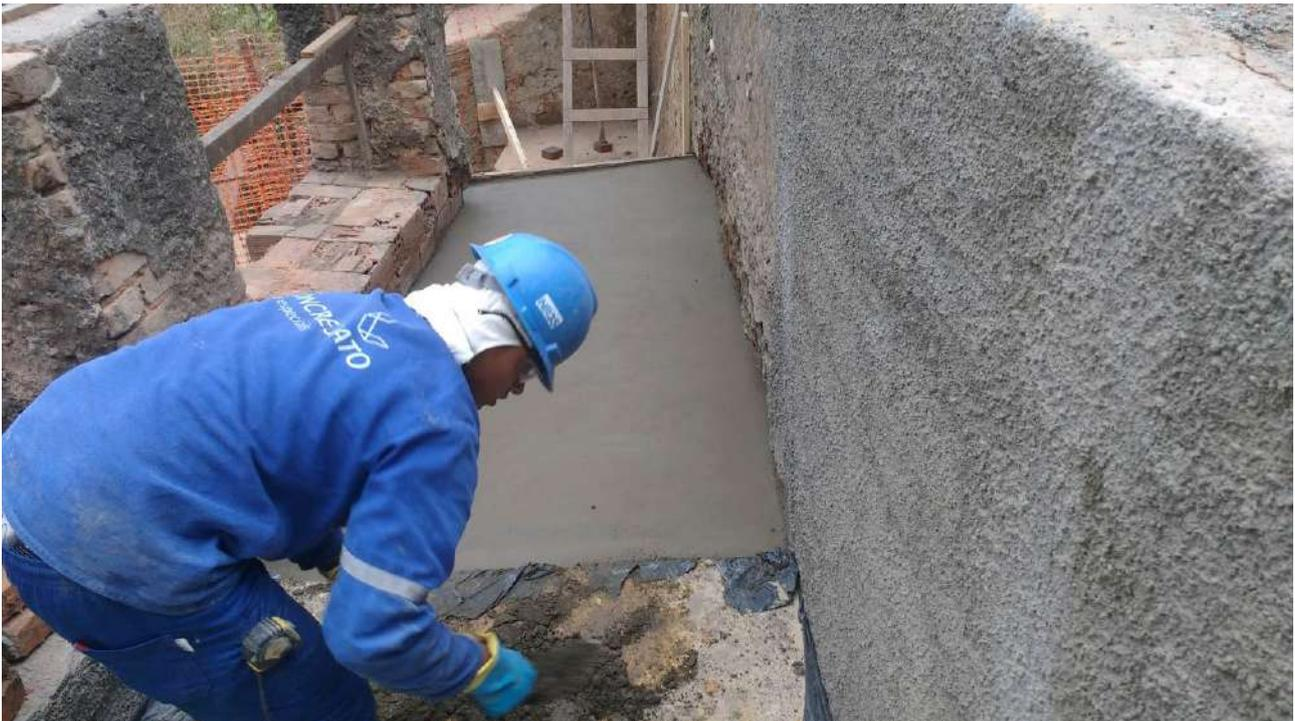
Foto 67: Concretagem do piso do talude.
