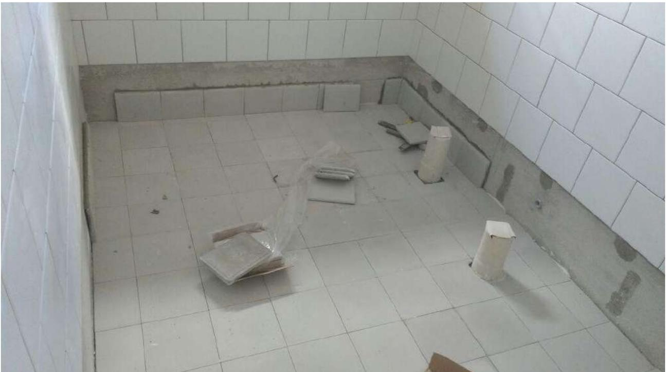
Foto 62: Instalação de ladrilho hidráulico.
