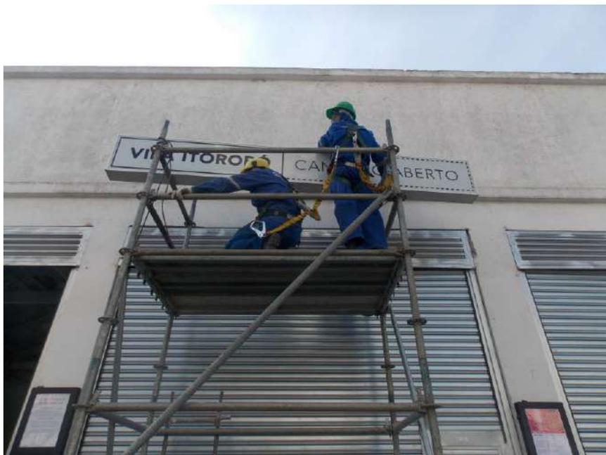
Foto 08 – Instalação da placa – Galpão
