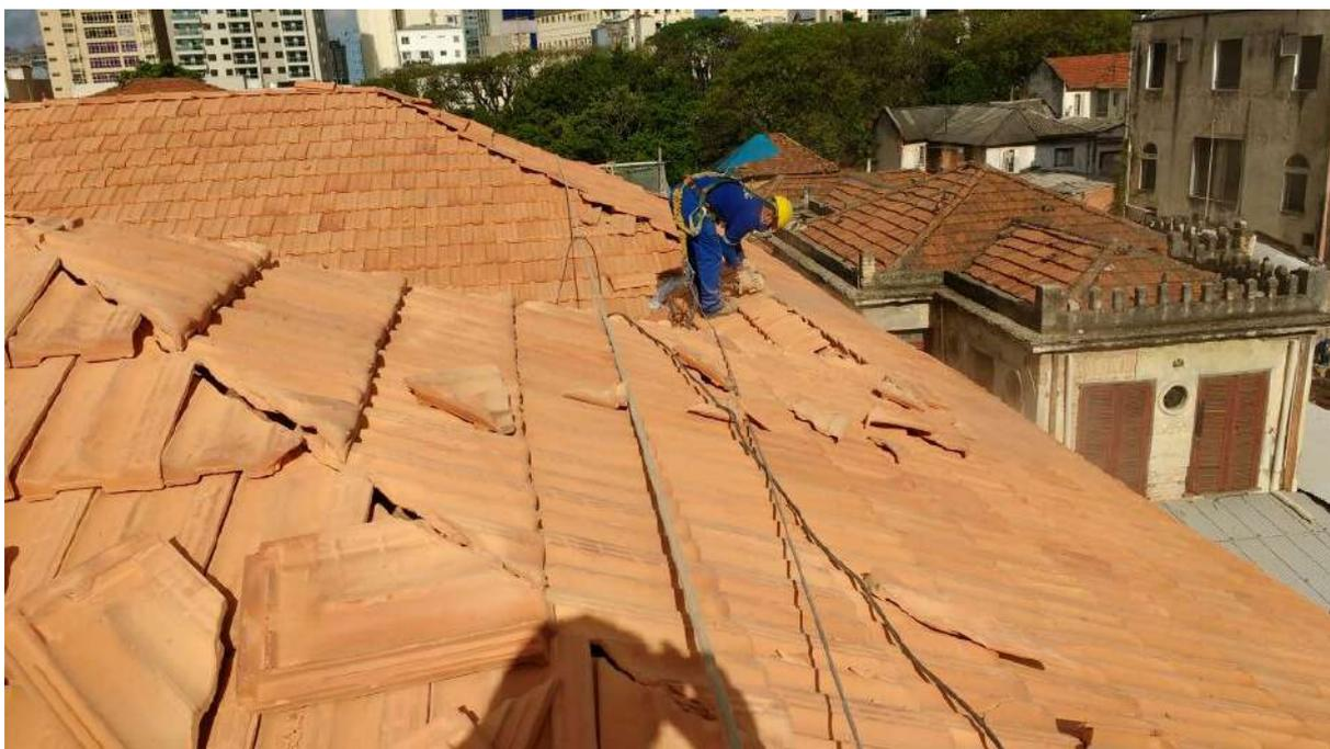
Foto 38: Recortes da telha e cummeira do telhado
