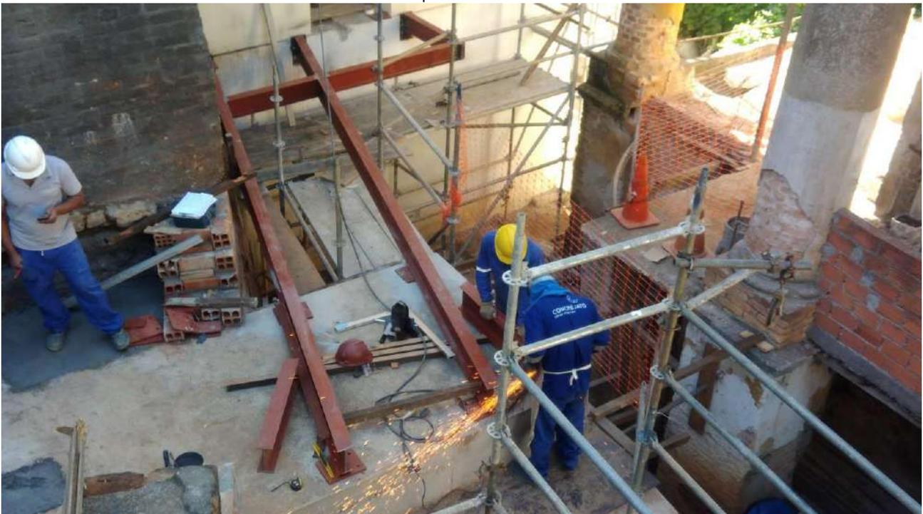
Foto 36: Montagem da passarela metálica de acesso ao -2 pavimento..
