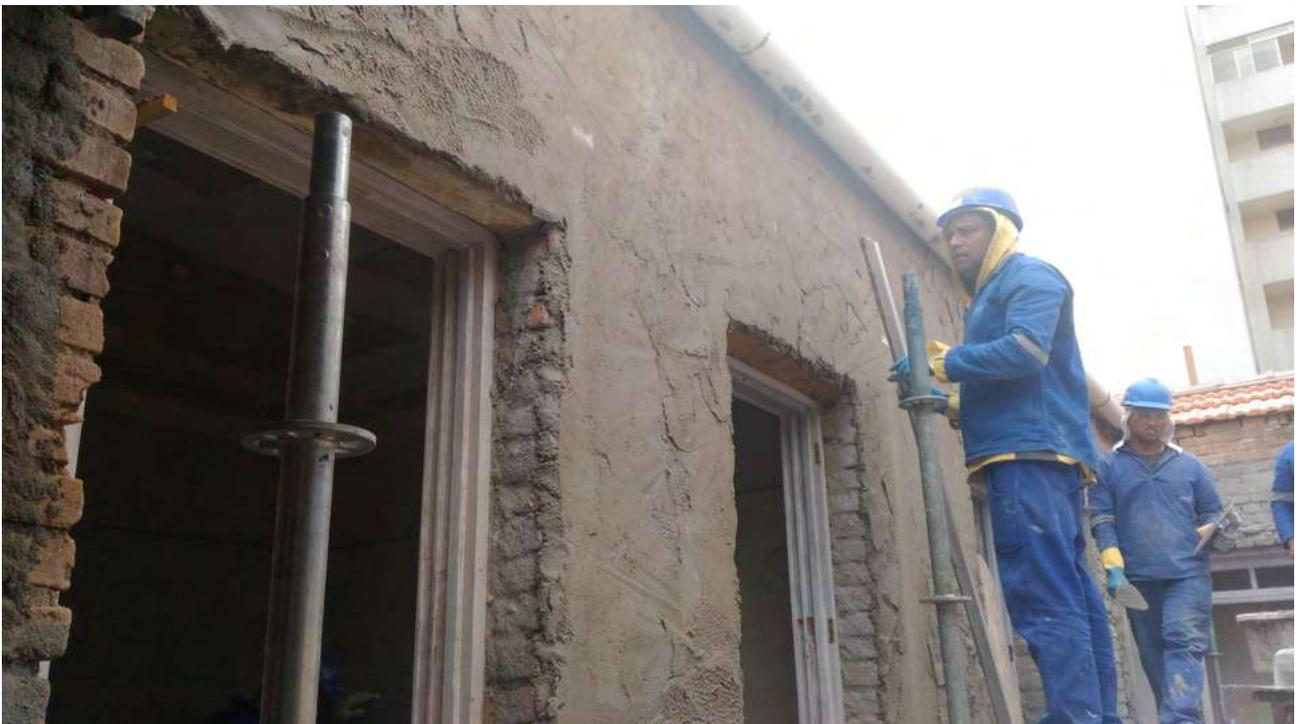
Foto 24: Execução do emboço da fachada interna.
