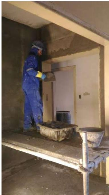
Foto 60: Emboço das alvenarias internas
