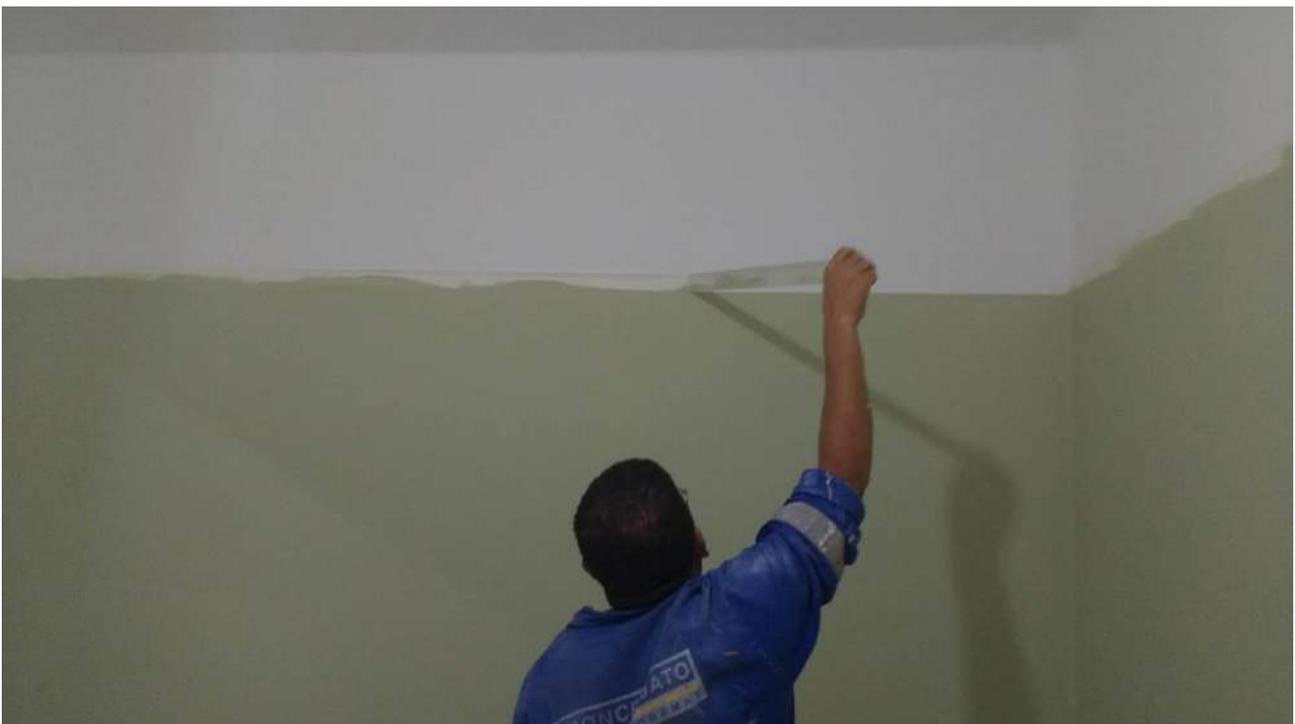
Foto 04: Pintura de acabamento das alvenarias internas.
