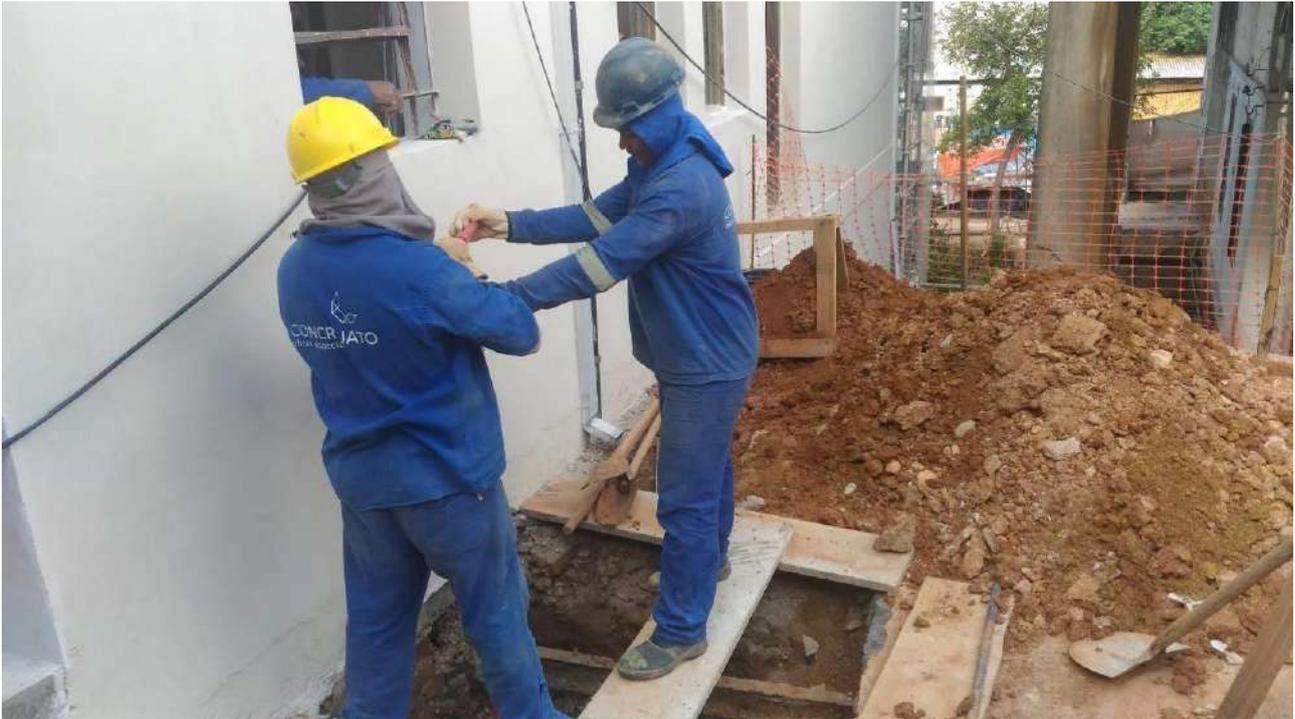
Foto 07: Abertura das valas para execução dos blocos da escadaria.
