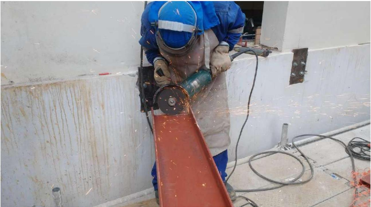
Foto 31: Montagem da passarela metálica de acesso ao -2 pavimento.
