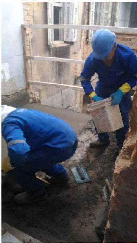
Foto 47: Regularização dos pisos a impermeabilizar
