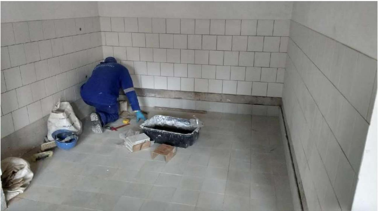
Foto 41: Instalação de rodapé na cozinha coletiva.
