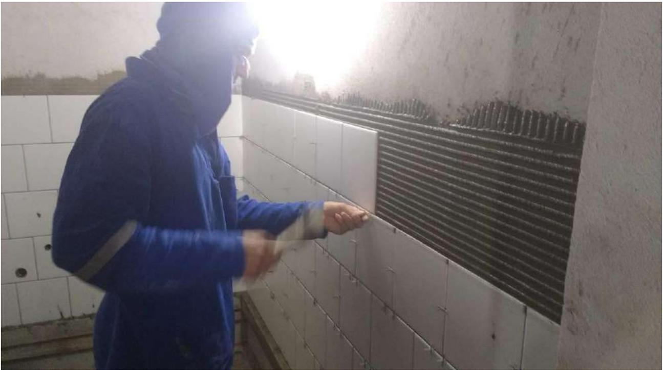
Foto 61: Instalação de revestimento cerâmico.
