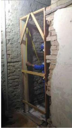
Foto 13: Instalação da batentes
