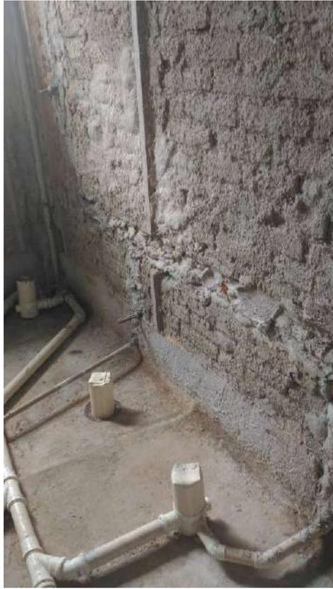
Foto 25: Execução do novo sistema de hidráulica (esgoto; alimentação de água e alimentação de água de reuso).
