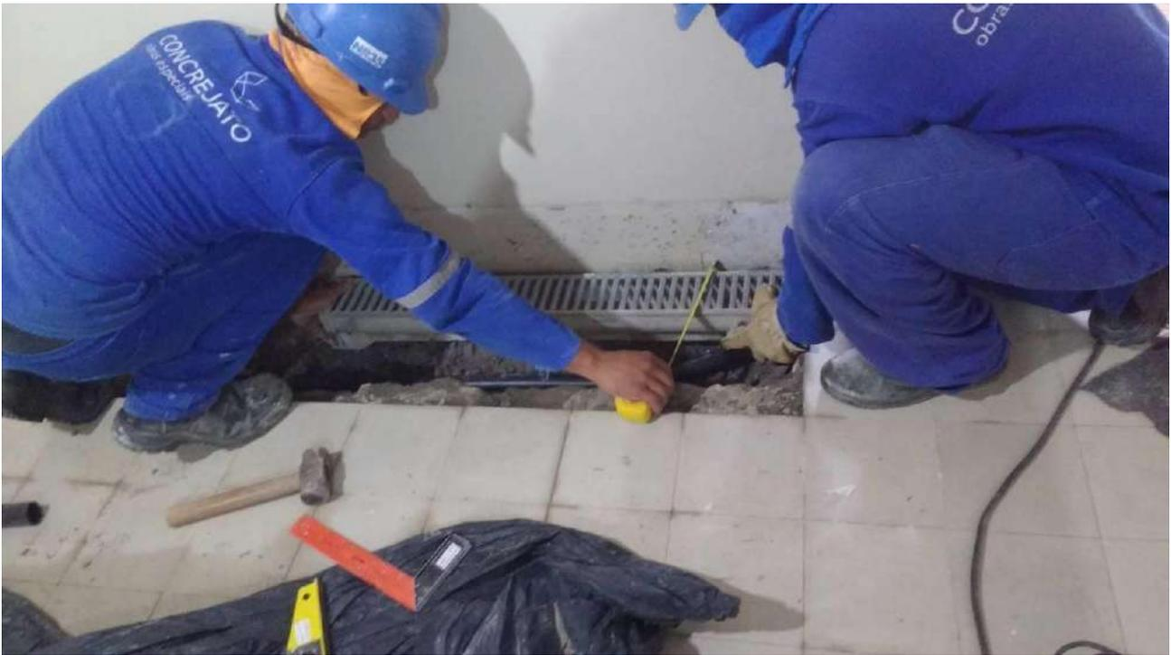
Foto 47: Instalação de ralo linear no -1 subsolo
