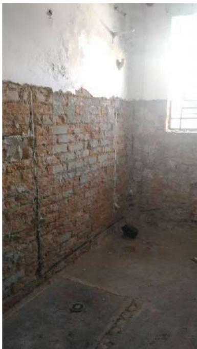
Foto 24: Remoção dos revestimentos modernos e peças sanitárias da Casa 11
