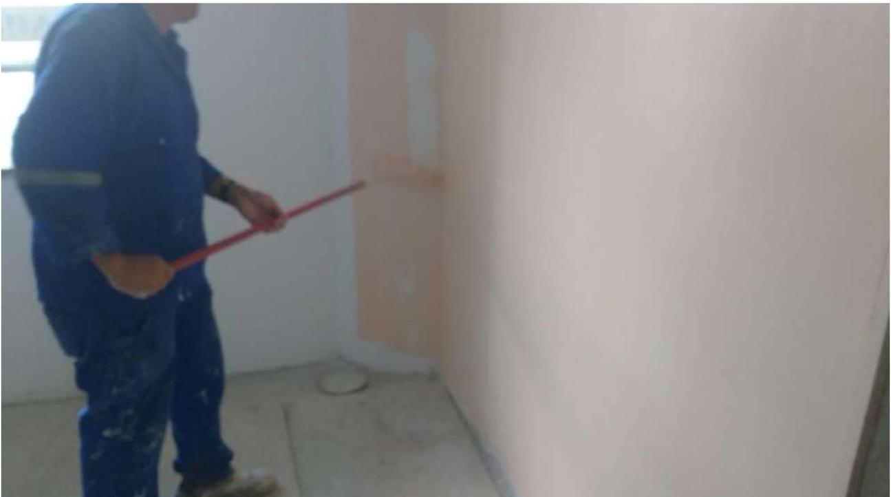
Foto 54: Pintura de acabamento das alvenarias internas.
