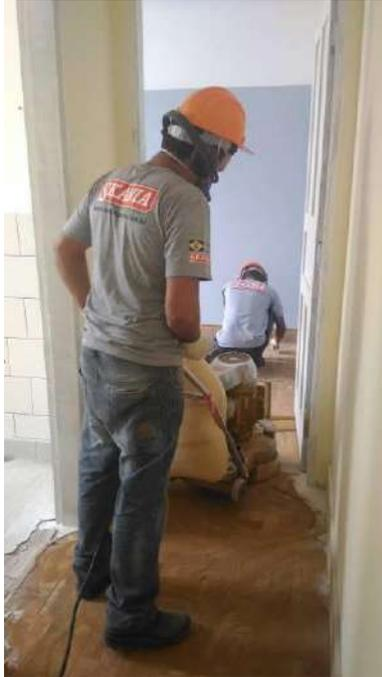
Foto 35: Raspagem e acabamento dos pisos de madeira.
