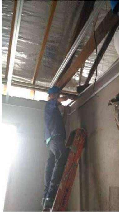
Foto 39: Instalação da estrutura auxiliar do forro de gesso.
