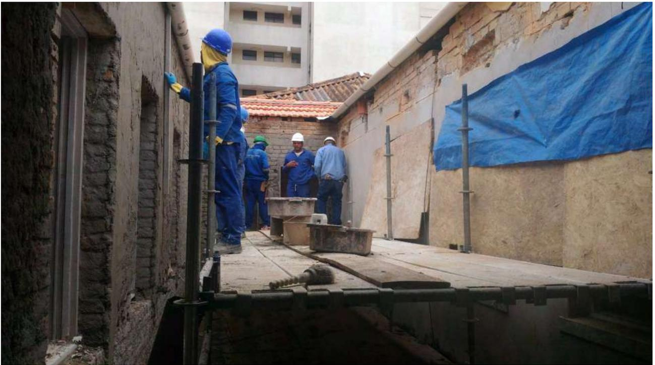
Foto 25: Execução do emboço da fachada interna.
