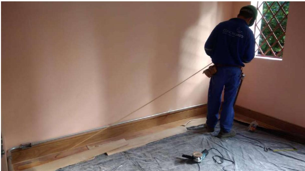
Foto 68: Instalação do cordão de acabamento dos pisos de madeira.
