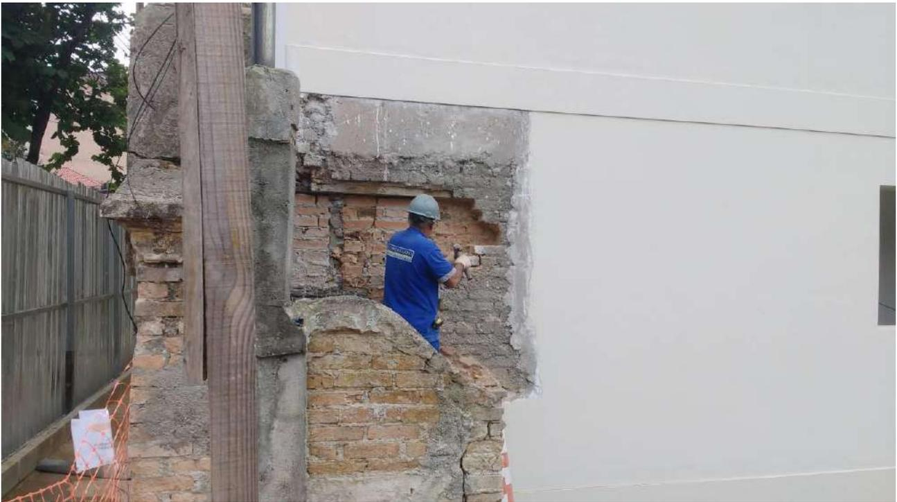
Foto 23: Abertura da alvenaria para instalação da entrada de energia e telefonia.
