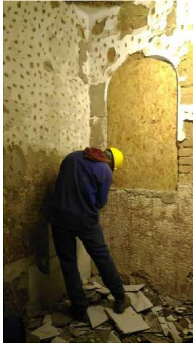
Foto 21: Remoção dos revestimentos modernos e peças sanitárias da Casa 11
