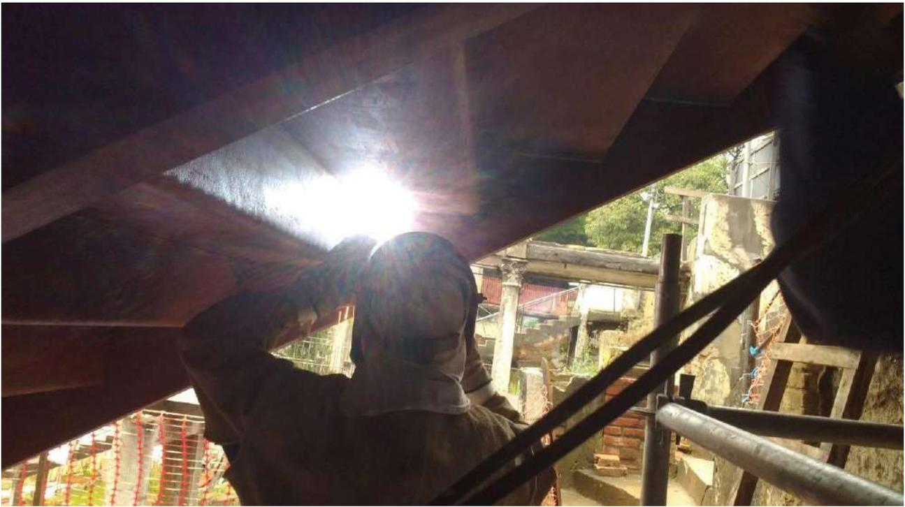
Foto 23: Instalação dos degraus.
