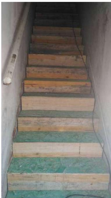
Foto 13: Proteção dos pisos de madeira.
