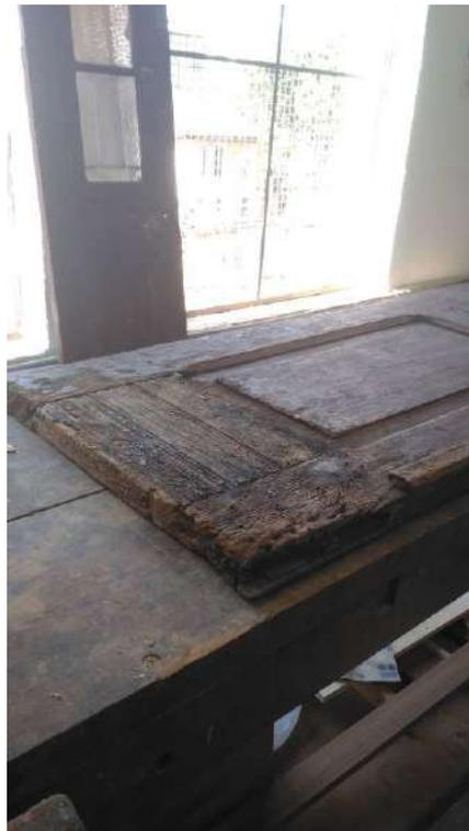
Foto 10: Identificação do madeiramento danificado para restauro
