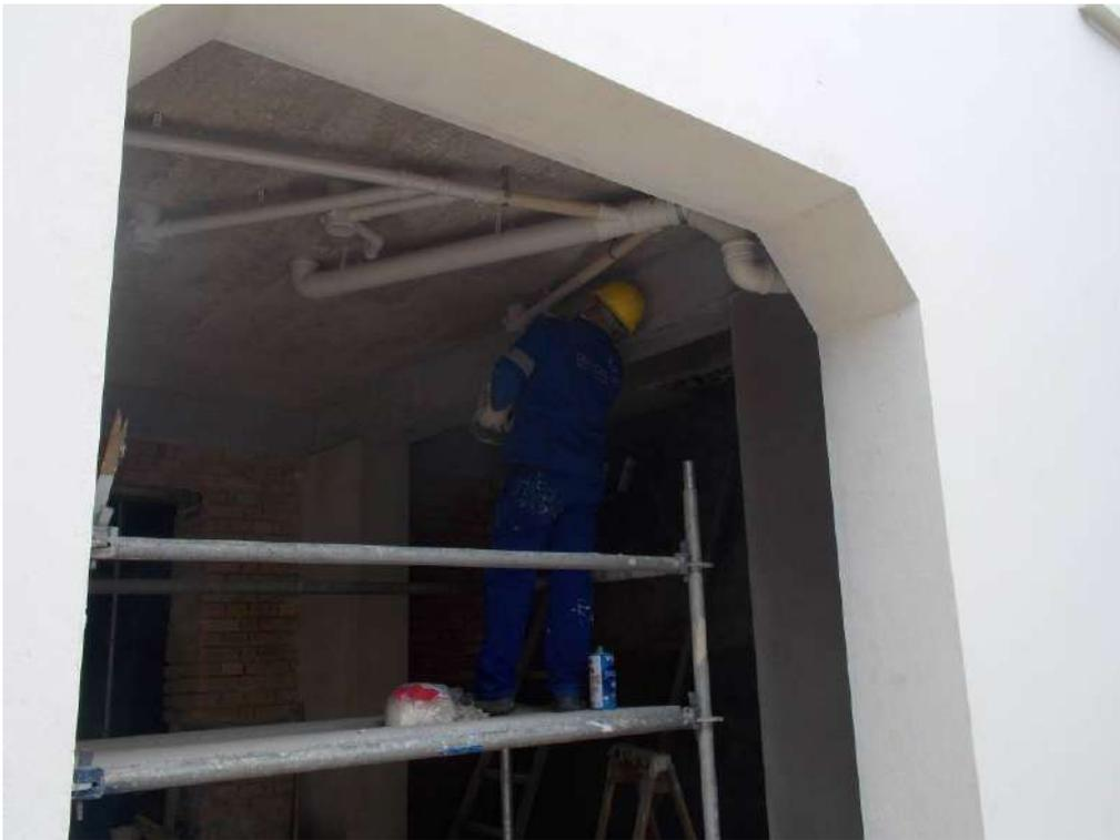
Foto 35: Pintura de acabamento de tubulações;
