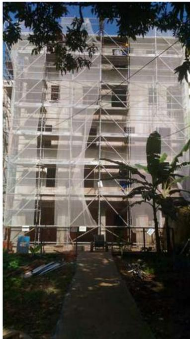
Foto 05: Execução do reboco de acabamento da fachada.
