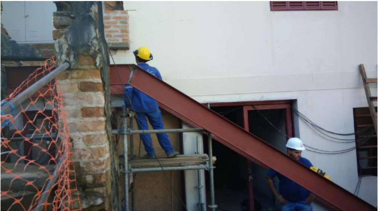
Foto 15: Montagem da escadaria metálica da fachada lateral
