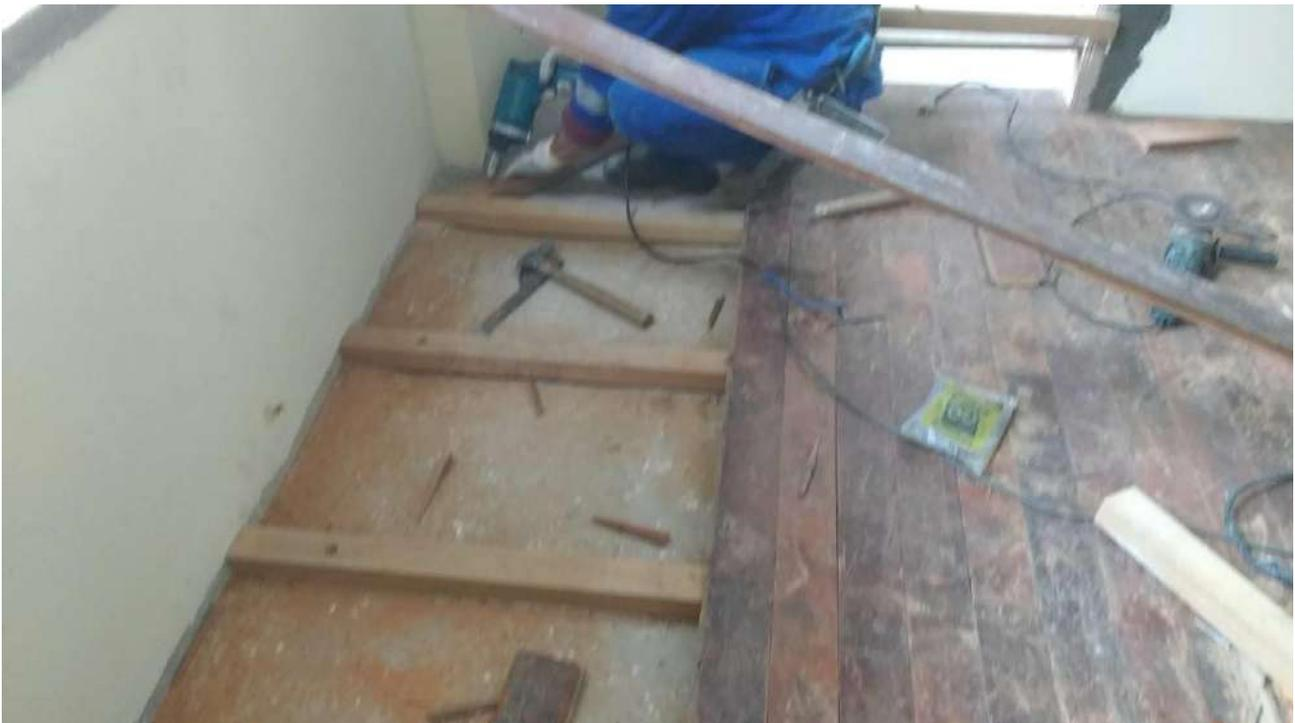
Foto 42: Instalação dos pisos de madeira no quarto do -2 subsolo.
