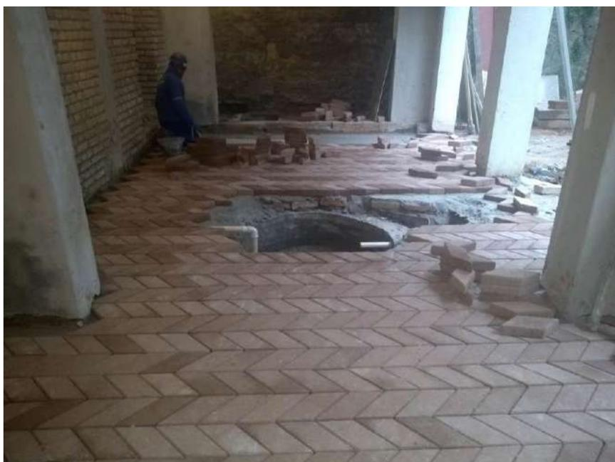
Foto 04 – Instalação dos pisos intertravados – Casa 11
