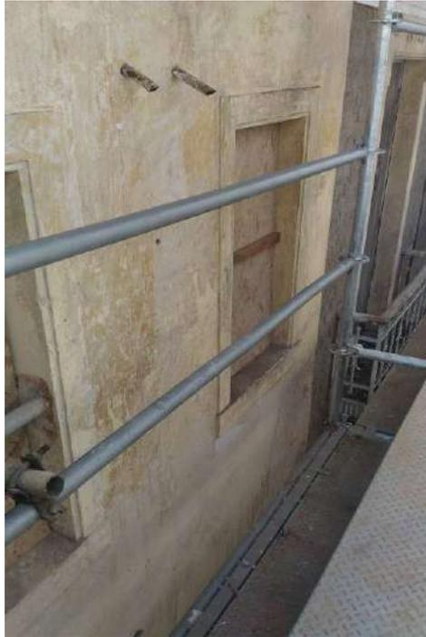
Foto 51: Trecho original da fachada frontal – decapagem mecânica das tintas
