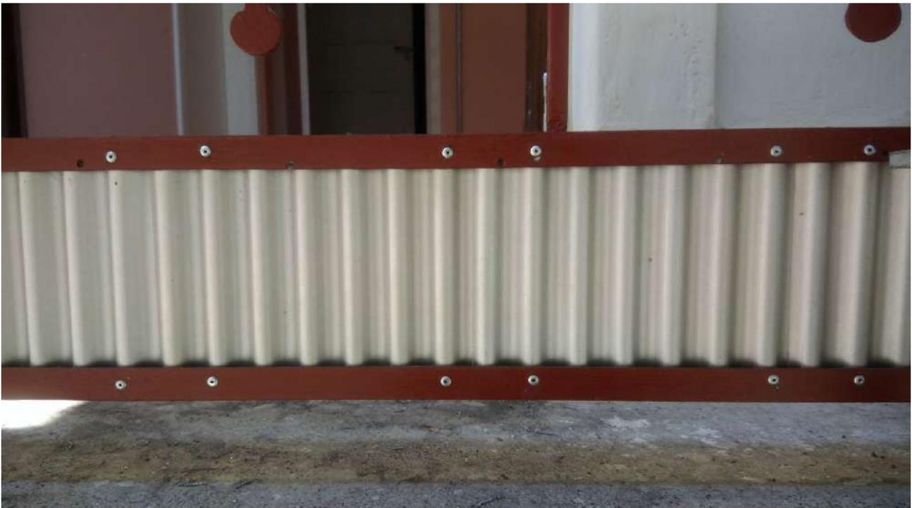
Foto 87: Substituição da chapa ondulada da fachada;
