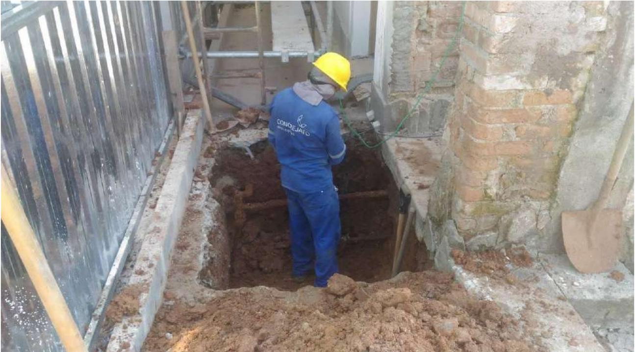
Foto 03: Abertura das valas para execução dos blocos da escadaria.
