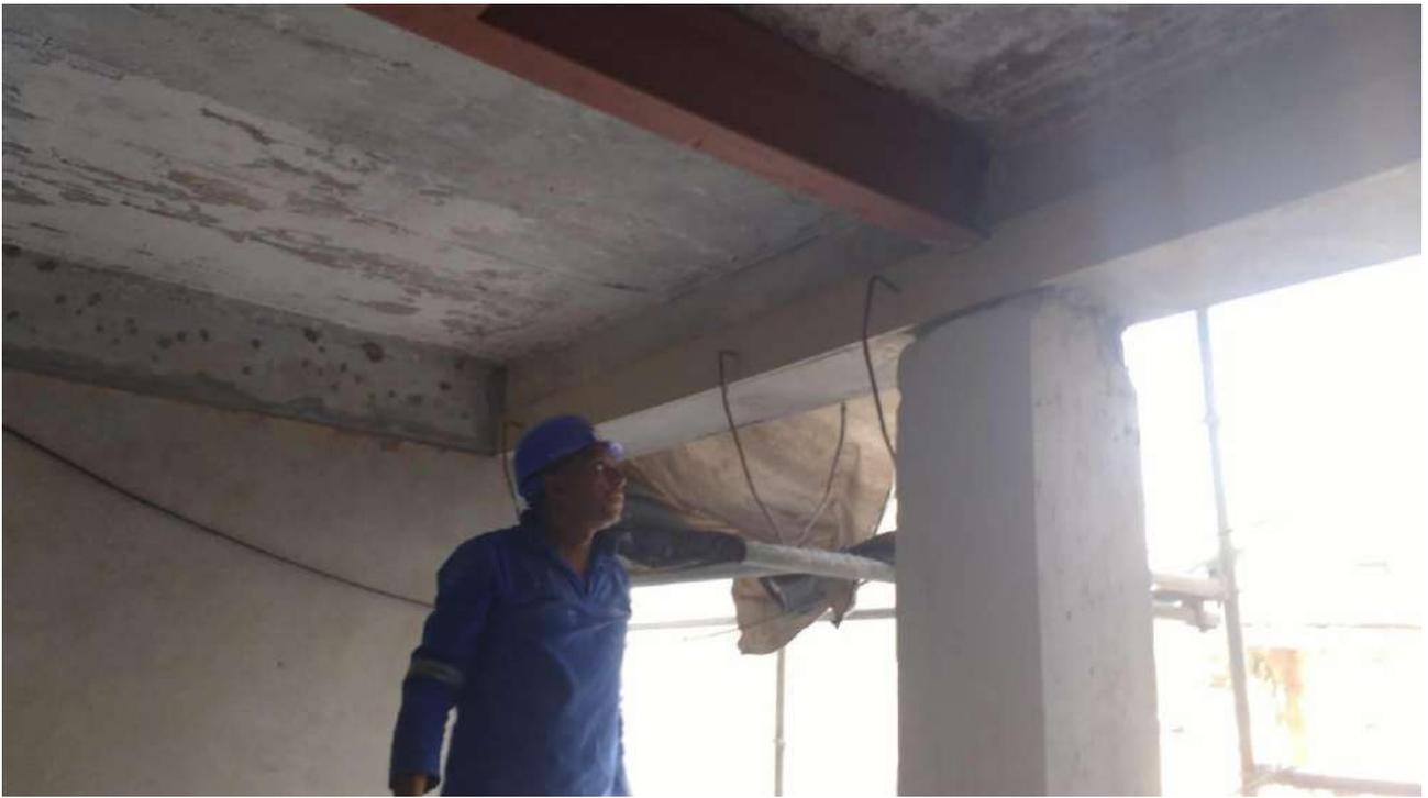
Foto 69: Requado para a instalação das portas metálicas.
