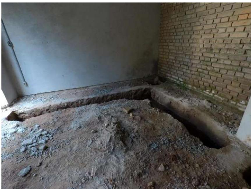
Foto 06 – Escavação manual para execução das caixas coletoras
