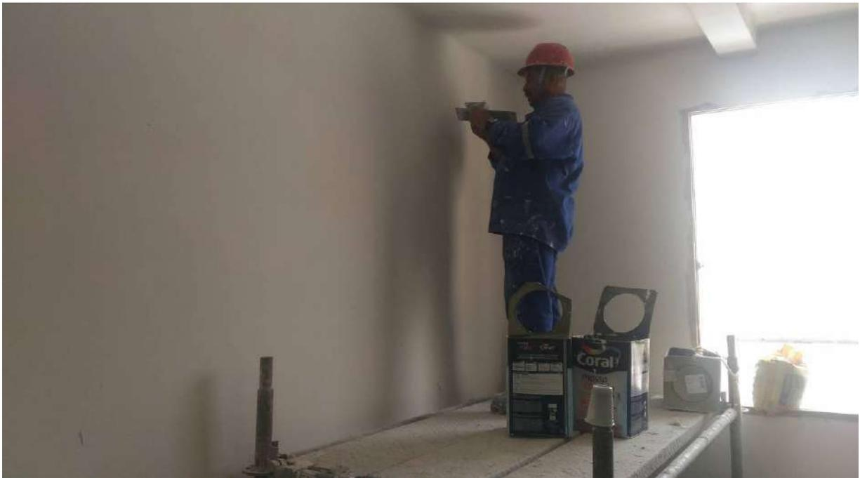
Foto 09: Emassamento das alvenarias.
