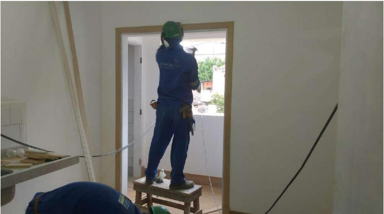
Foto 44: Instalação de guarnição.
