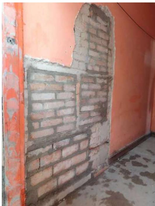
Foto 70: Fechamentos dos vãos em alvenaria
