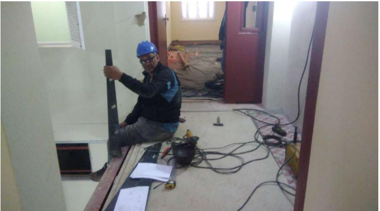
Foto 42: Instalação do guarda corpo da passarela interna;
