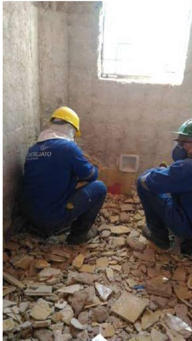
Foto 22: Remoção dos revestimentos modernos e peças sanitárias da Casa 11
