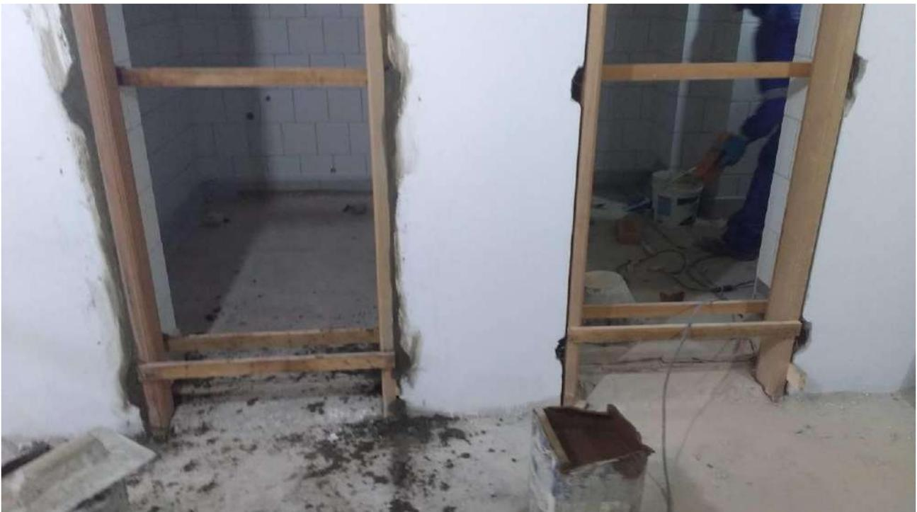
Foto 44: Instalação dos batentes das portas de acesso do -1 subsolo.
