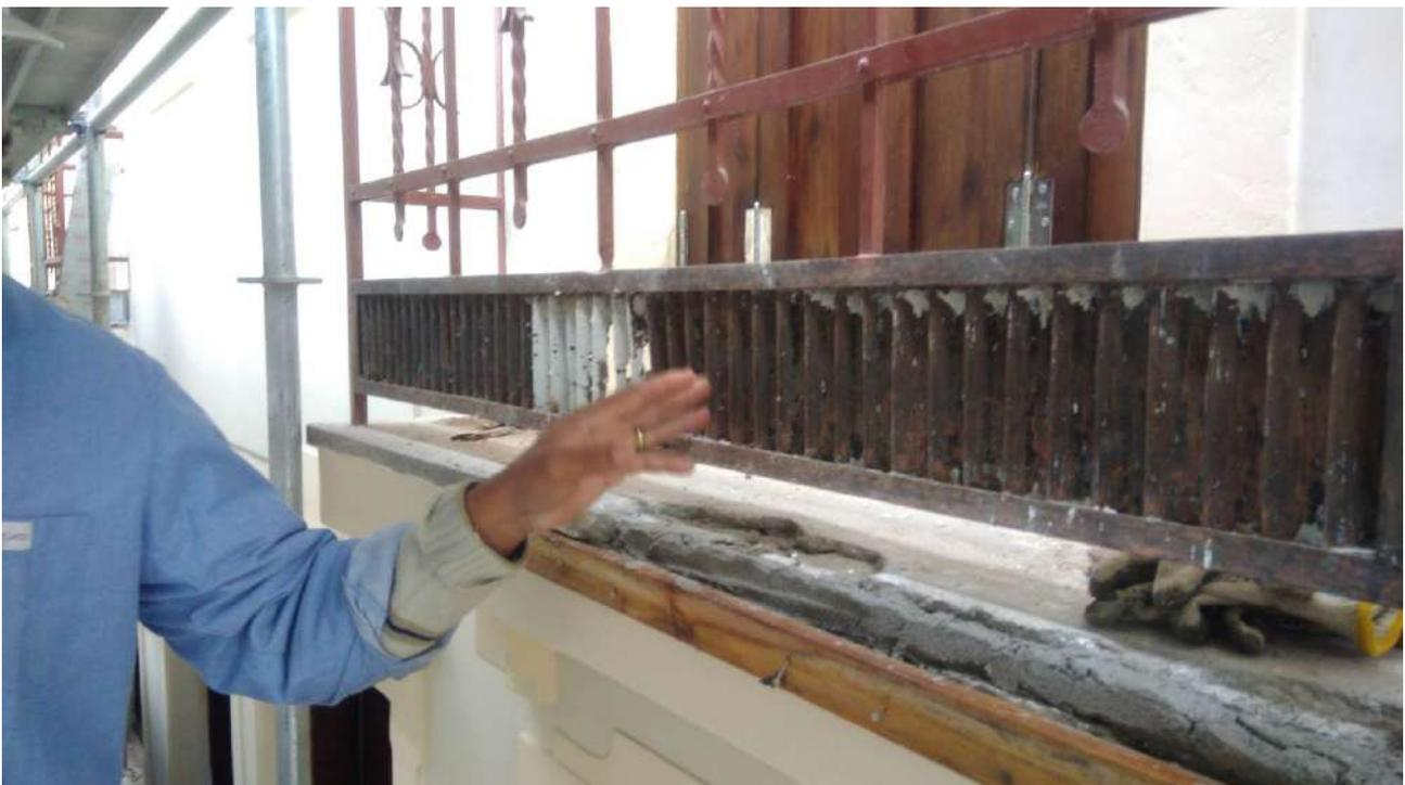
Foto 69: Substituição da chapa ondulada da fachada;
