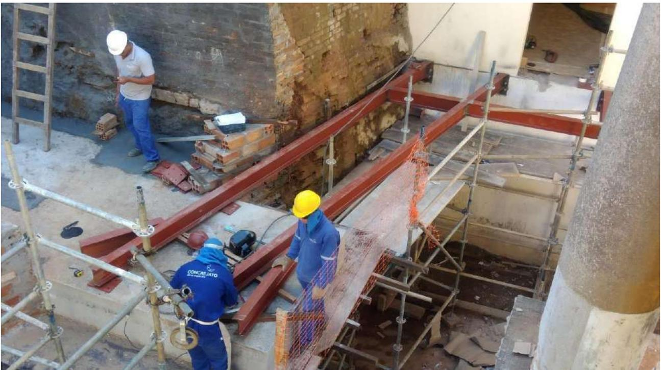
Foto 38: Montagem da passarela metálica de acesso ao -2 pavimento
