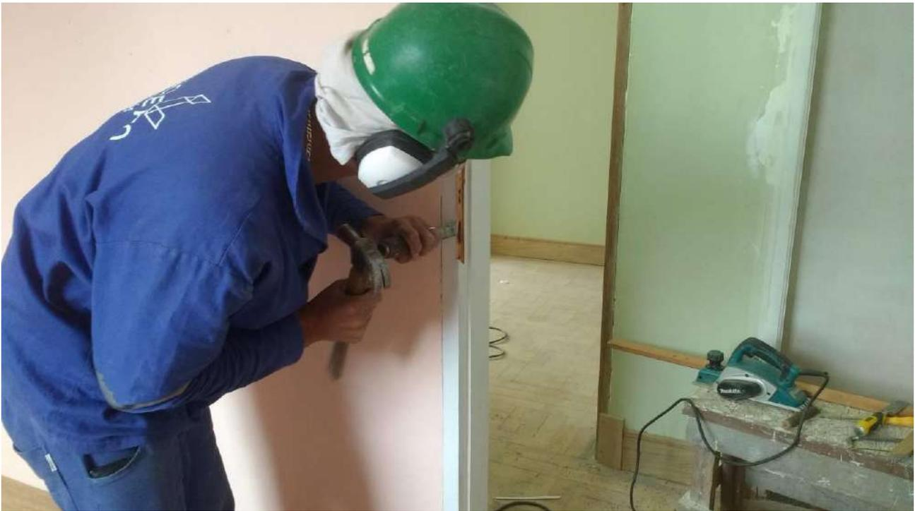
Foto 43: Instalação das fechaduras
