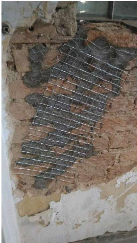
Foto 19: Instalação das telas galvanizadas.
