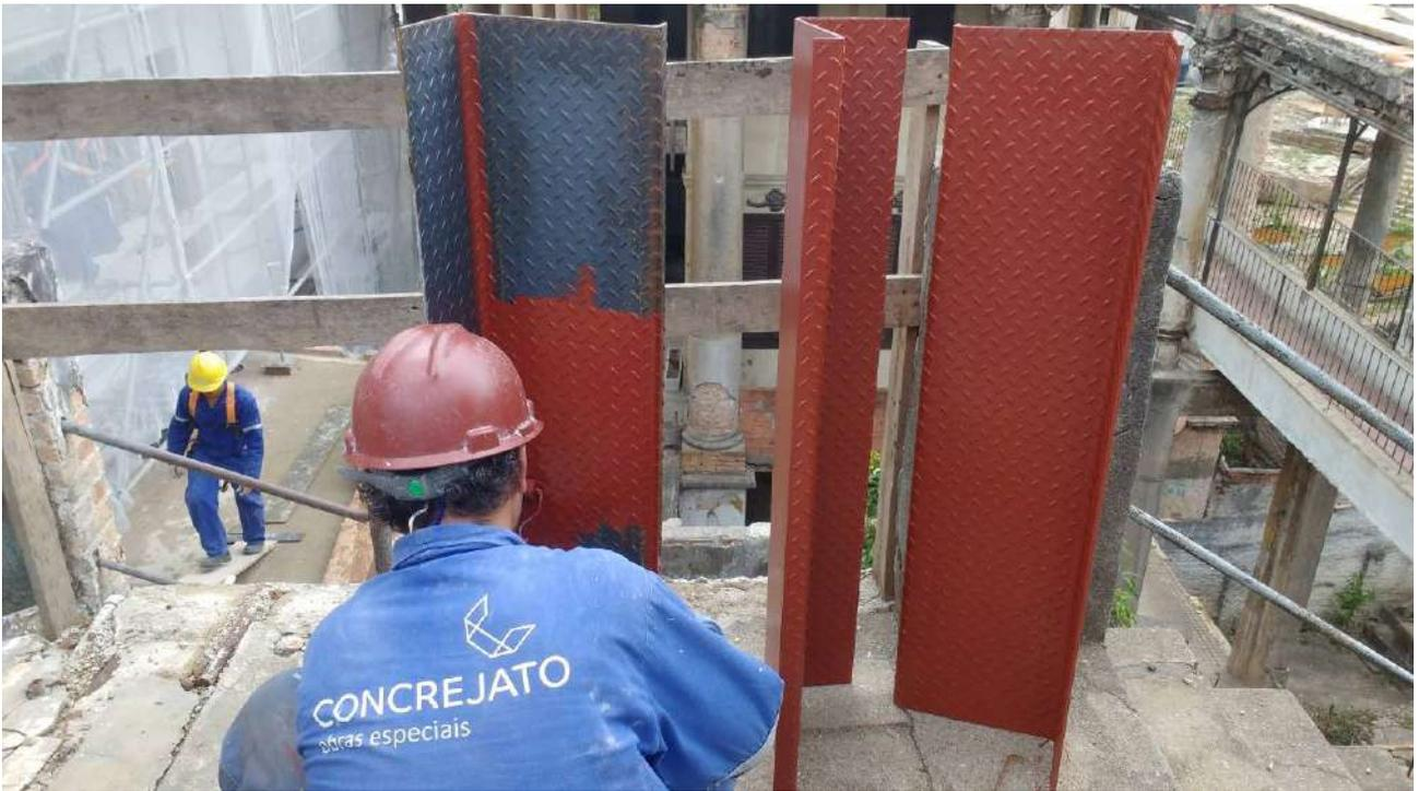
Foto 21: Pintura dos degraus da escadaria metálica externa.
