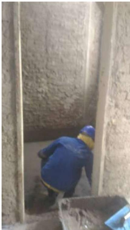
Foto 48: Impermeabilização cimentícia dos pisos das áreas molhadas.
