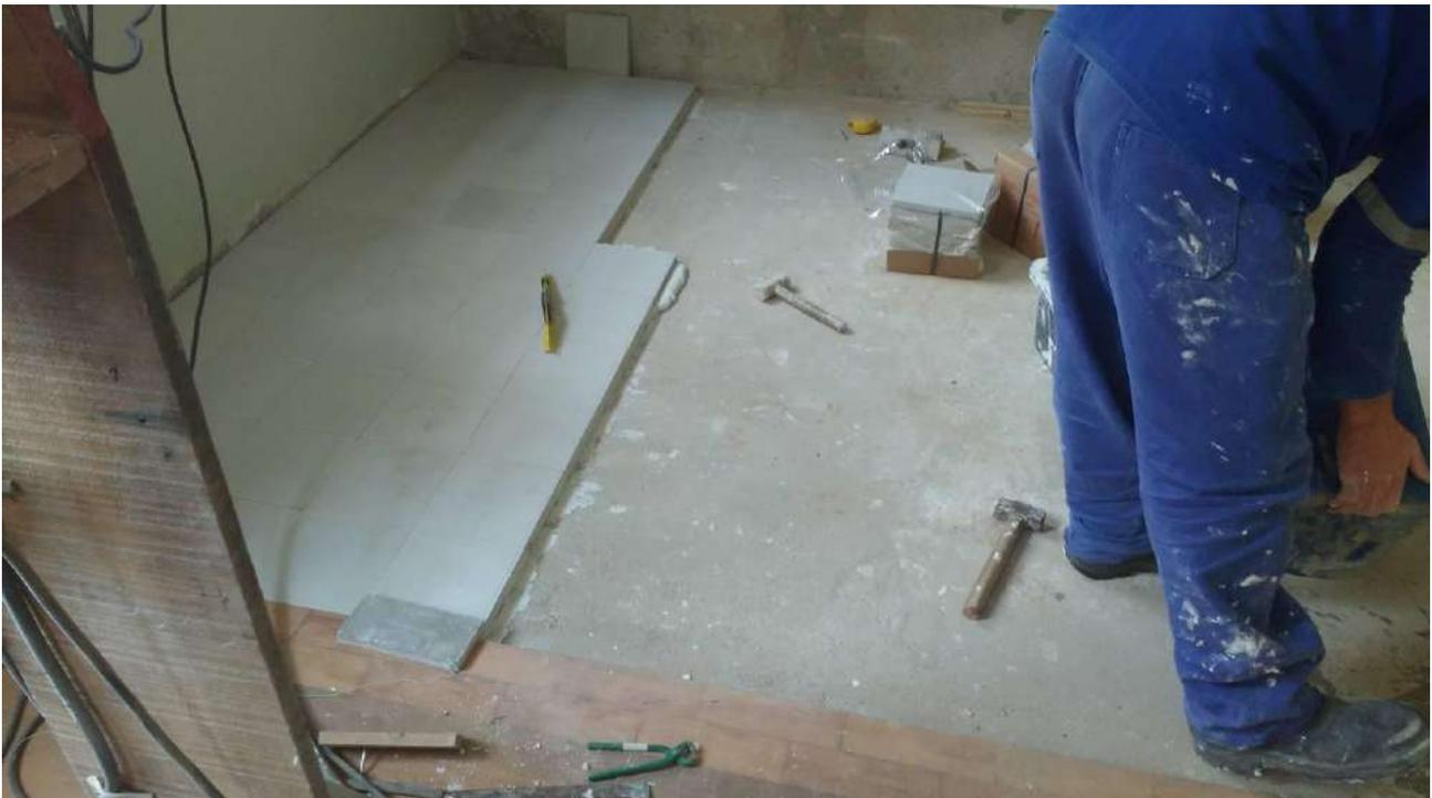
Foto 38: Instalação dos pisos de ladrilho hidráulico.
