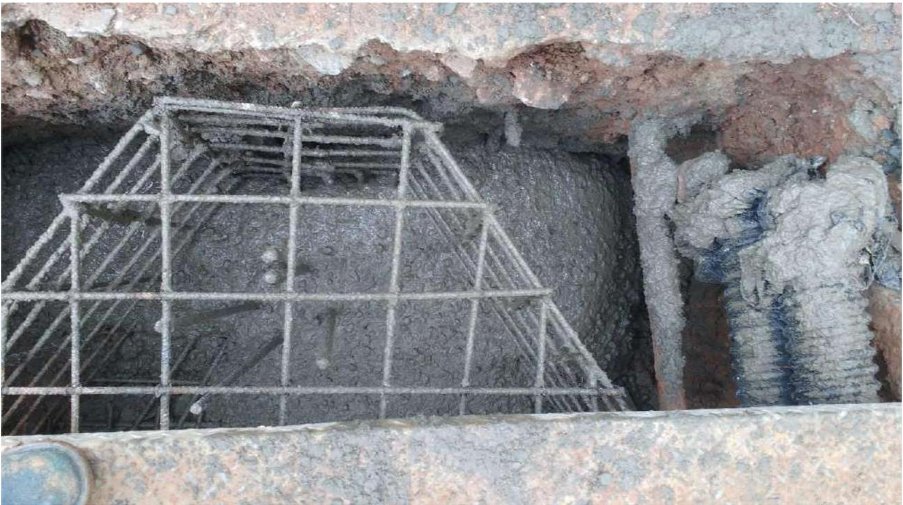
Foto 17: Concretagem dos blocos.
