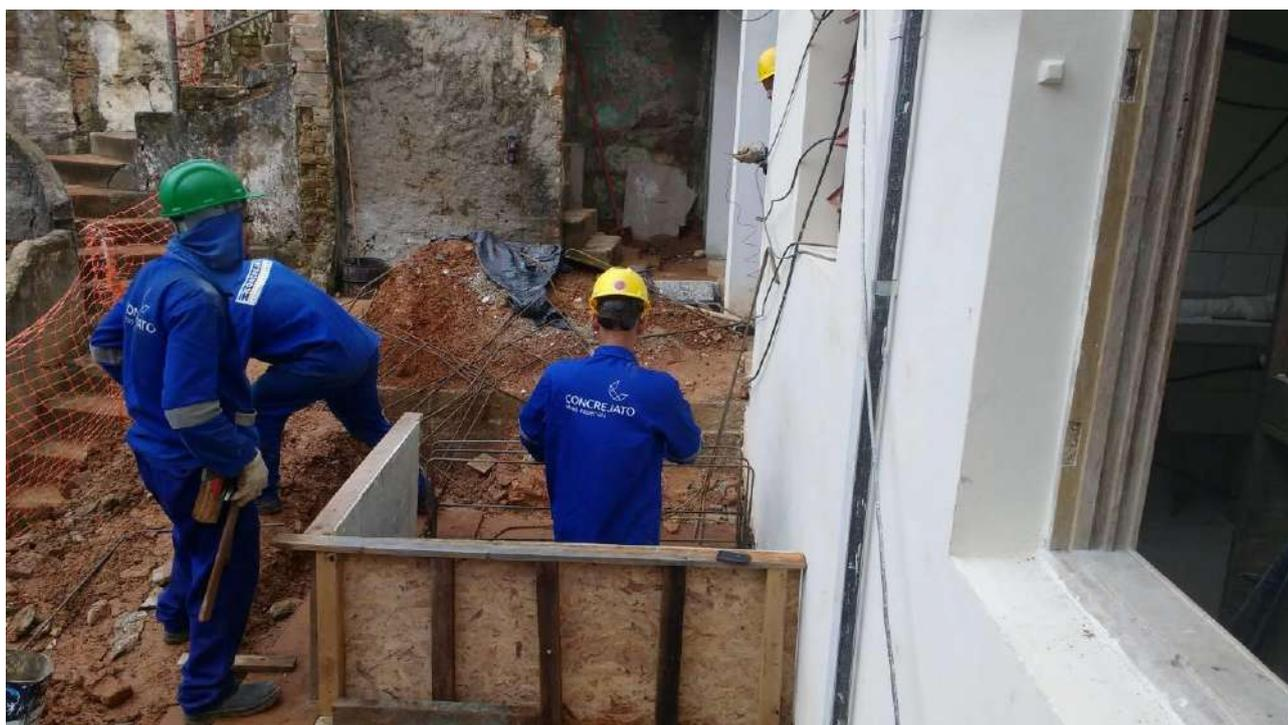
Foto 14: Blocos para sustentação de escadaria e passarela metálica.
