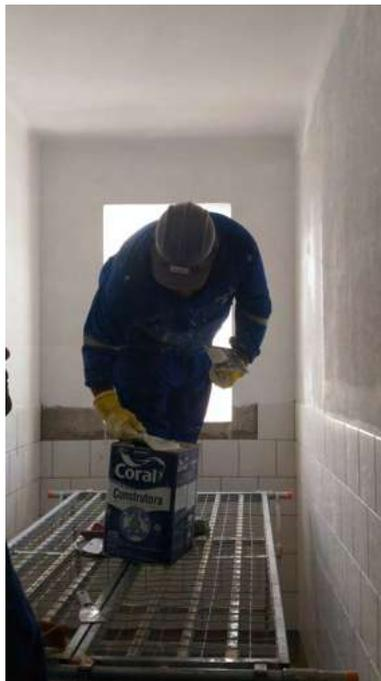
Foto 10: Emassamento das alvenarias.
