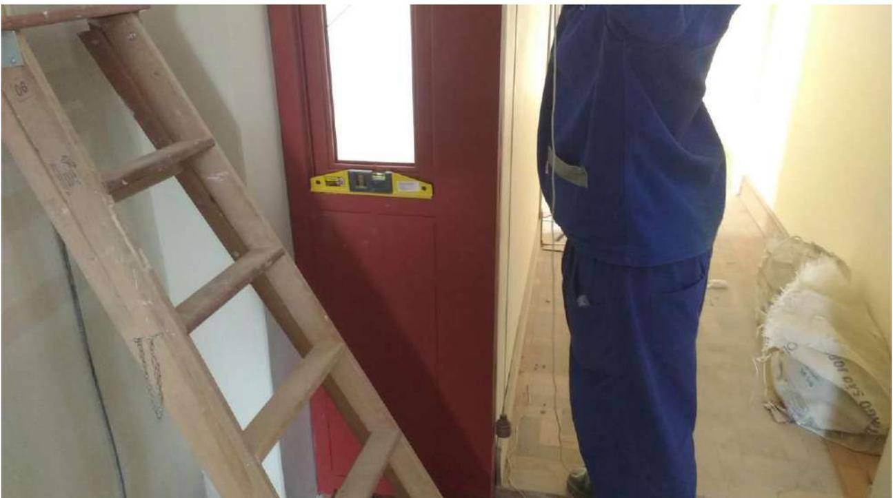
Foto 68: Instalação das esquadrias metálicas
