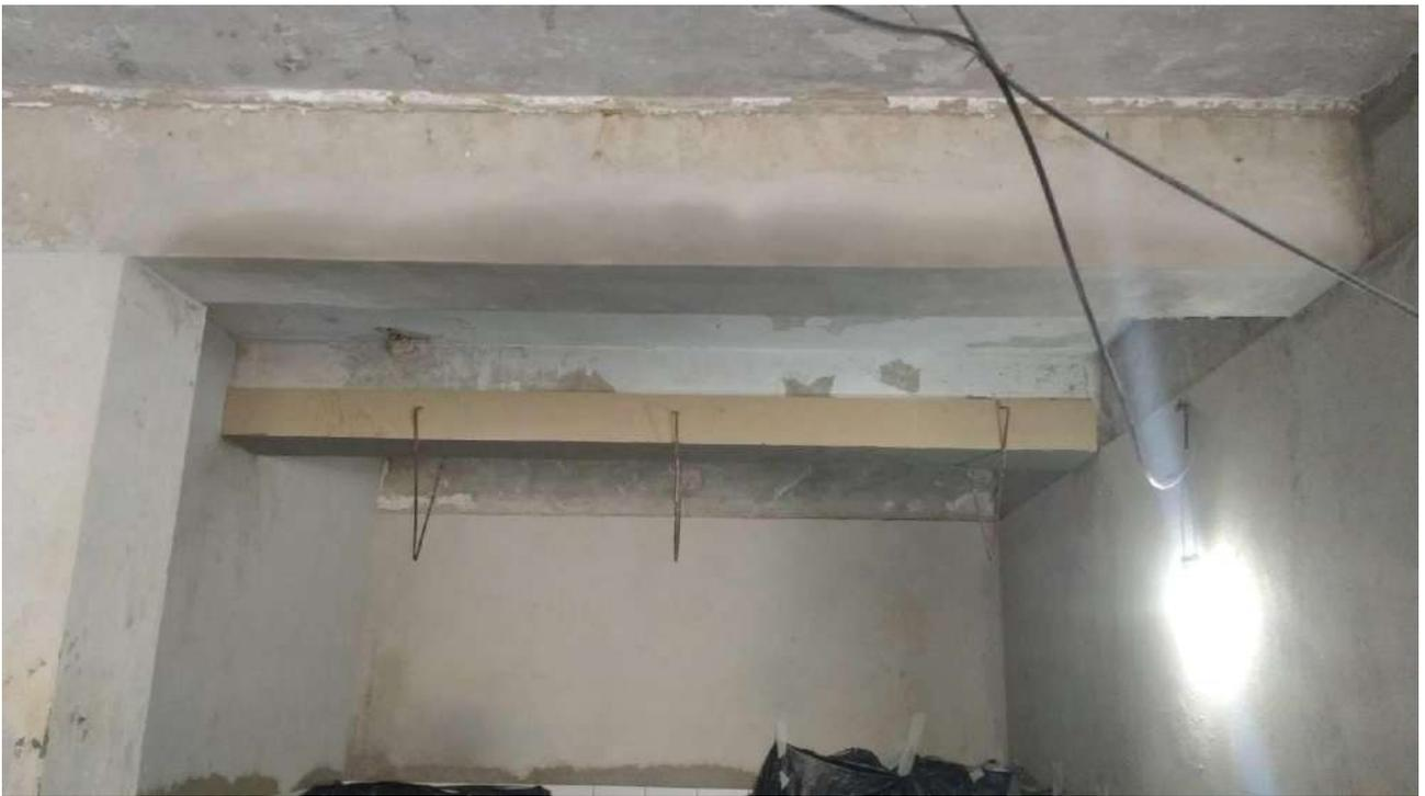
Foto 70: Tratamento das vigas de concreto.
