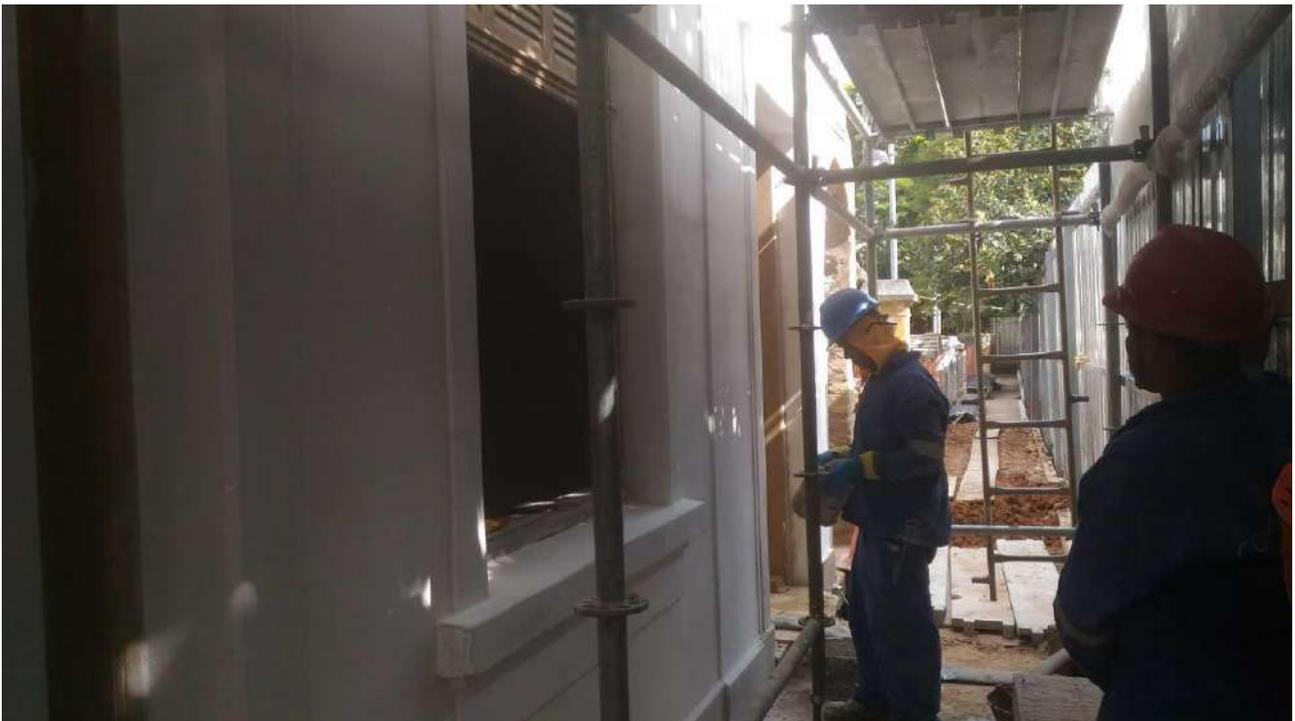
Foto 08: Lixamento fino da fachada – preparação para pintura de acabamento.
