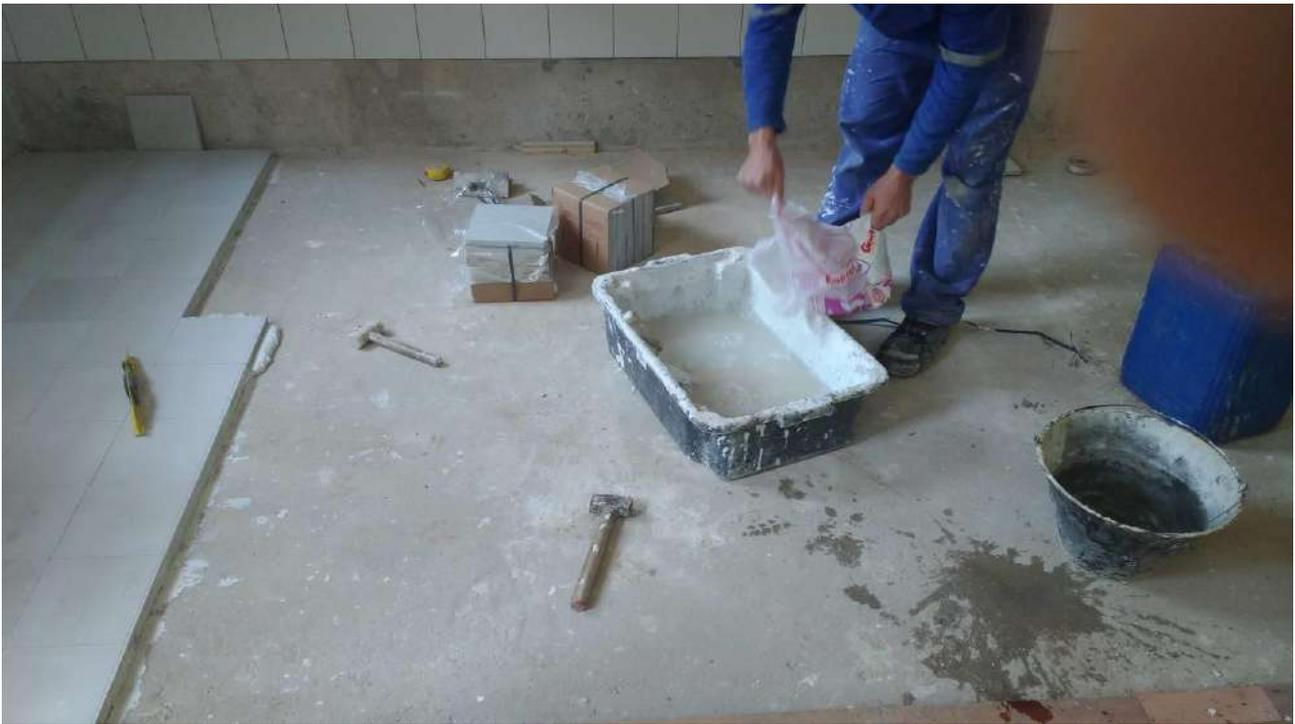
Foto 39: Instalação dos pisos de ladrilho hidráulico.
