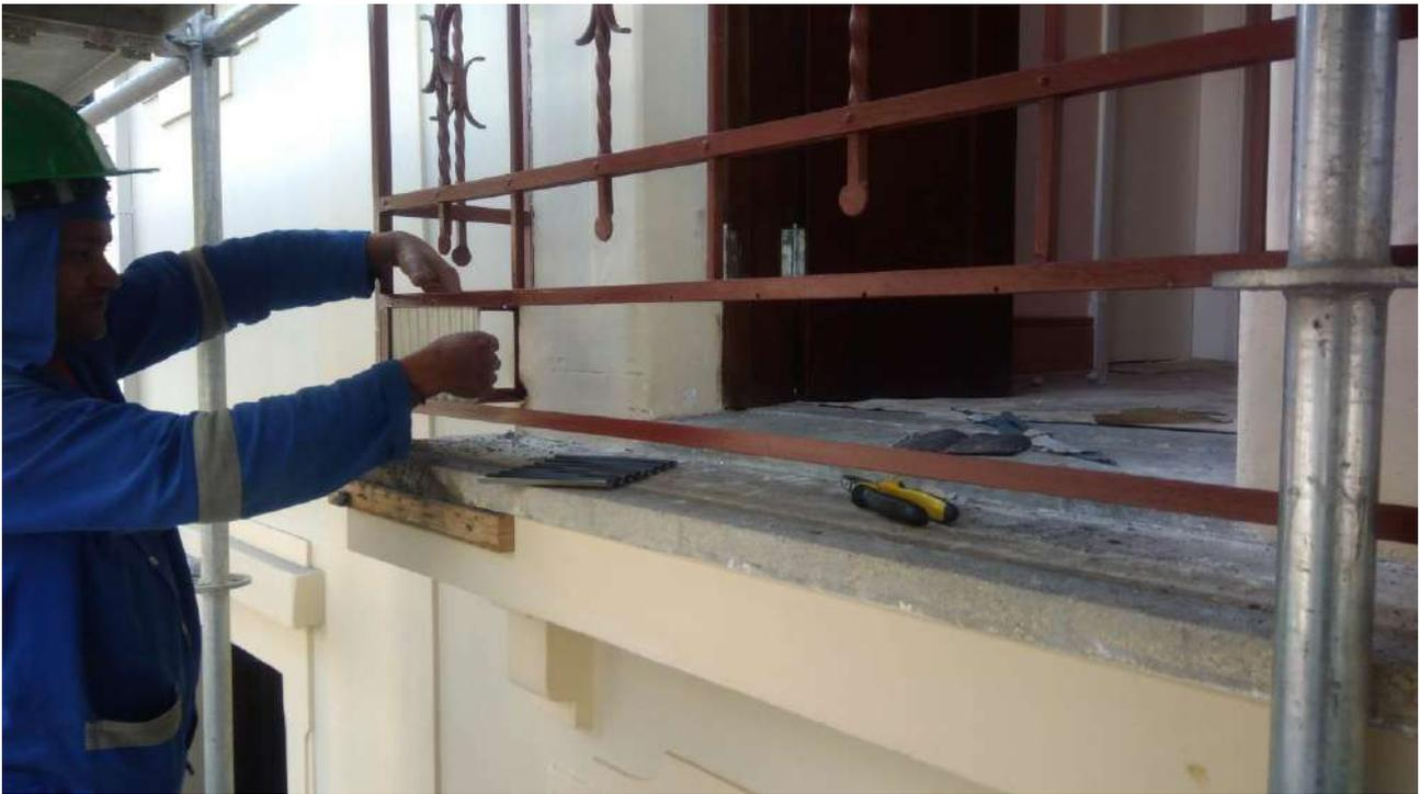
Foto 78: Substituição da chapa ondulada da fachada;
