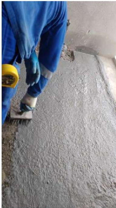
Foto 05: Impermeabilização cimentícia no -1 subsolo
