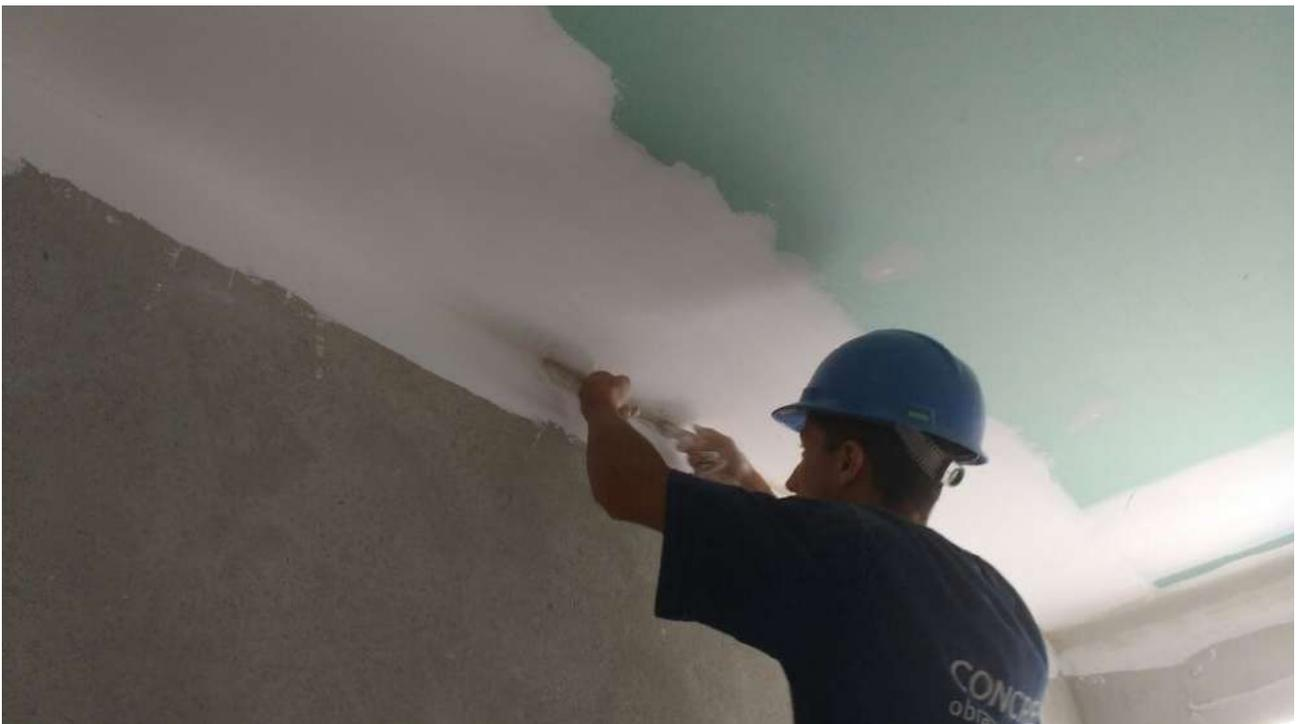
Foto 44: Execução de curvatura em gesso.
