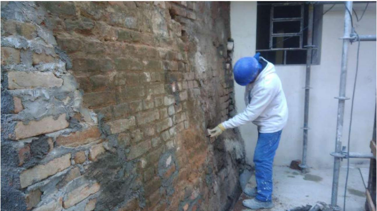
Foto 26: Embrechamento dos tijolos do talude
