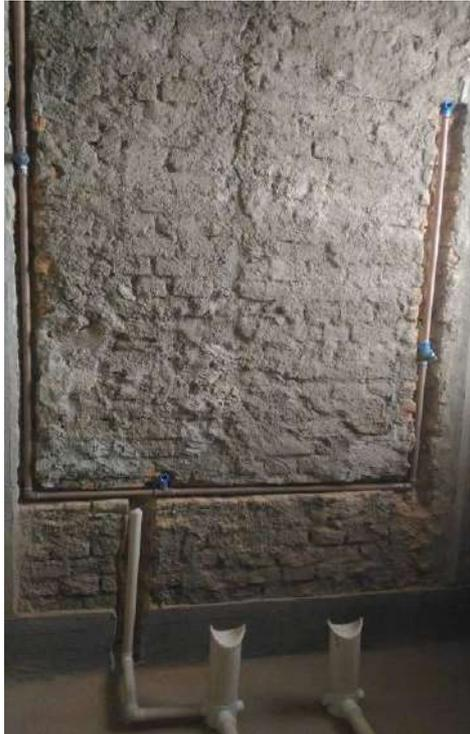
Foto 33: Execução do novo sistema de hidráulica (esgoto; alimentação de água e alimentação de água de reuso)
