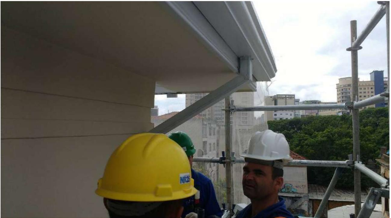
Foto 17: Instalação das descidas de águas pluviais
