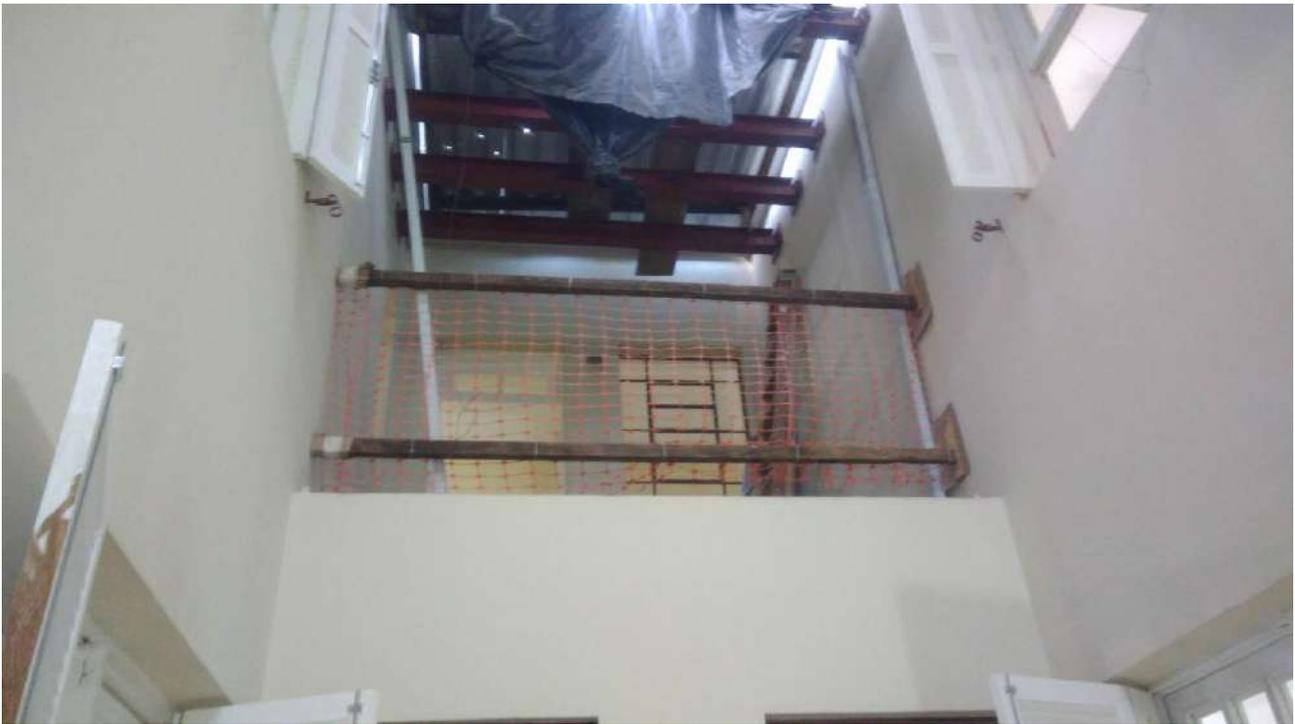
Foto 43: Instalação do guarda corpo;
