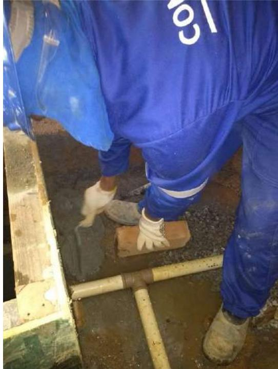
Foto 03 – Execução da caixa coletora de alvenaria – Casa 11
