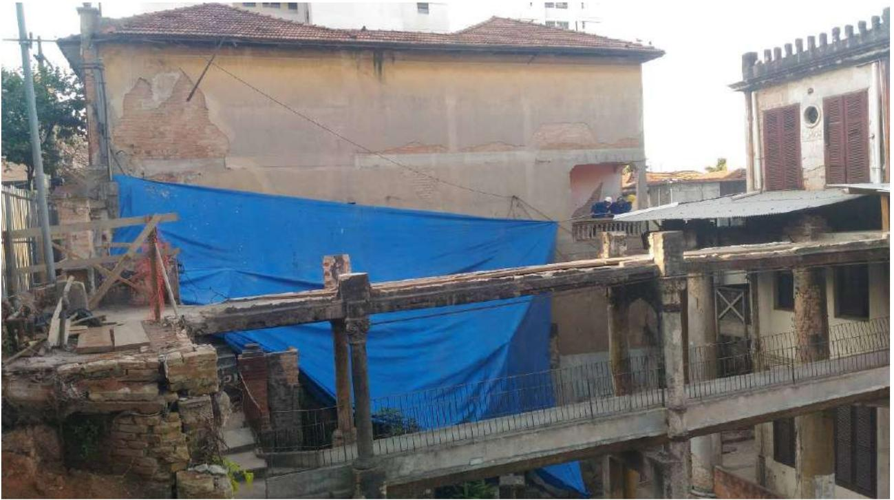
Foto 32: Proteções provisórias para demolições do platô lateral
