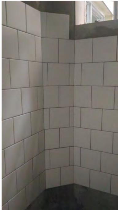
Foto 25: Instalação de revestimento cerâmico nas áreas molhadas..
