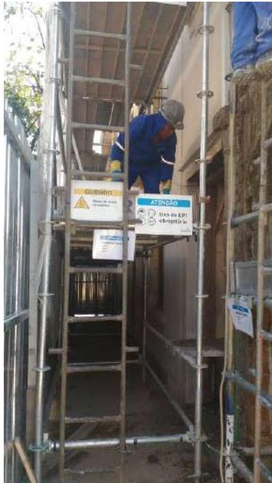
Foto 32: Reboco na fachada e execução dos frisos.
