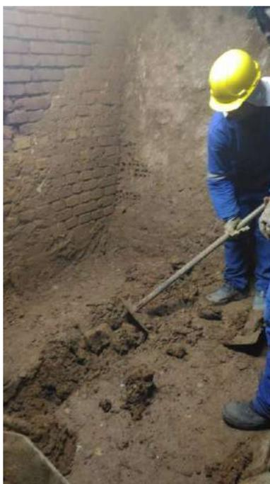
Foto 14: Abertura das valas para drenagem do talude
