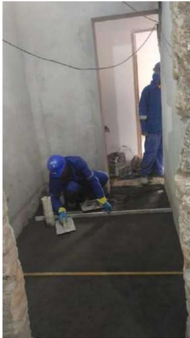
Foto 59: Execução de contrapiso de concreto.
