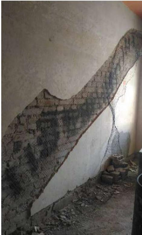
Foto 18: Instalação das telas galvanizadas.
