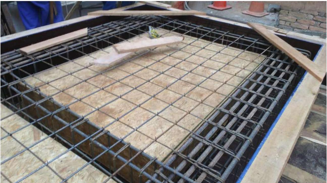
Foto 02: Execução de fôrma e armadura das vigas em balanço de sustentação da passarela metálica.
