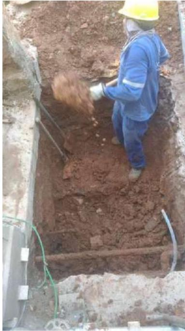
Foto 05: Abertura das valas para execução dos blocos da escadaria.
