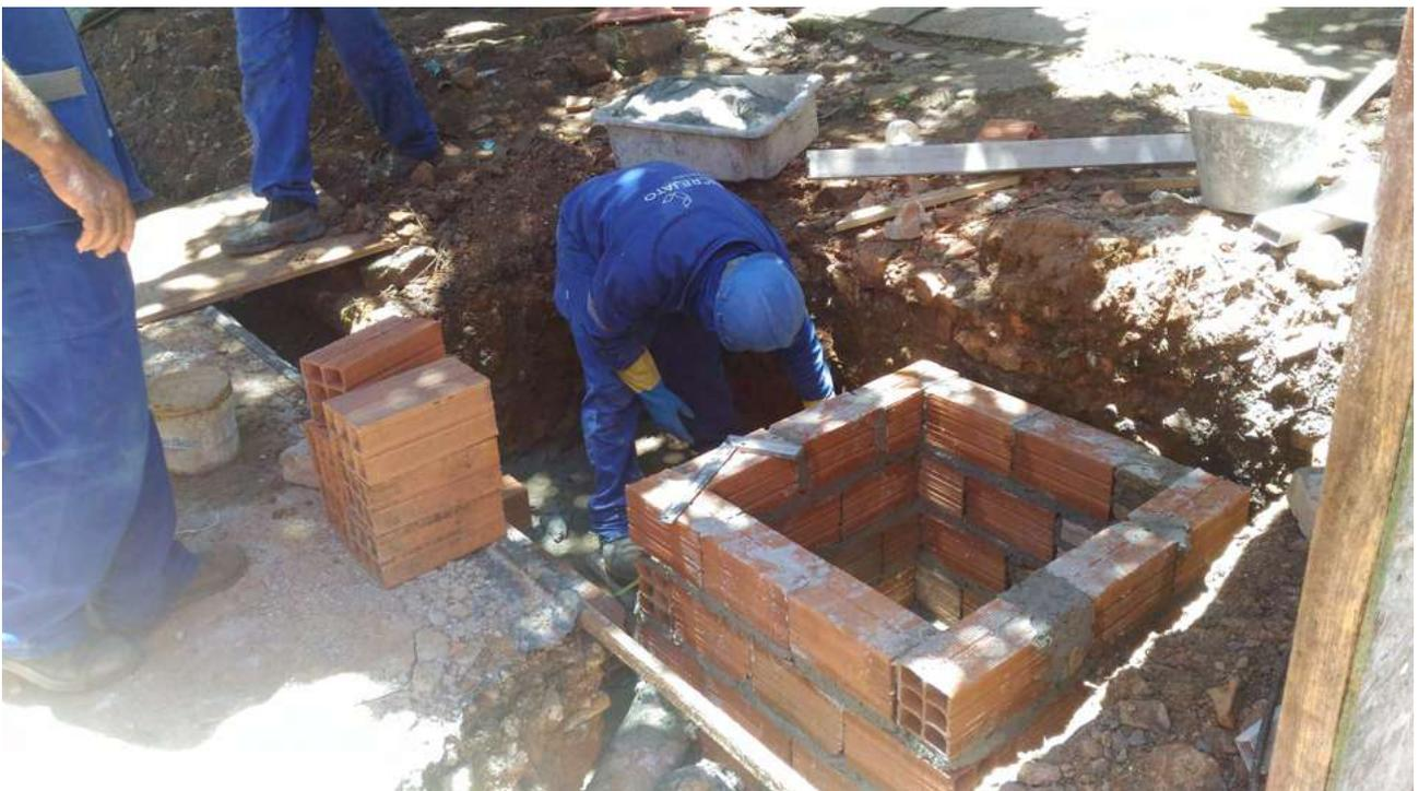
Foto 28: Execução de caixas de passagem do sistema de esgoto e águas pluviais da Casa 11.
