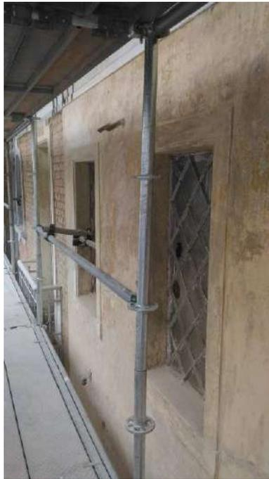
Foto 46: Decapagem das tintas látex da fachada frontal
