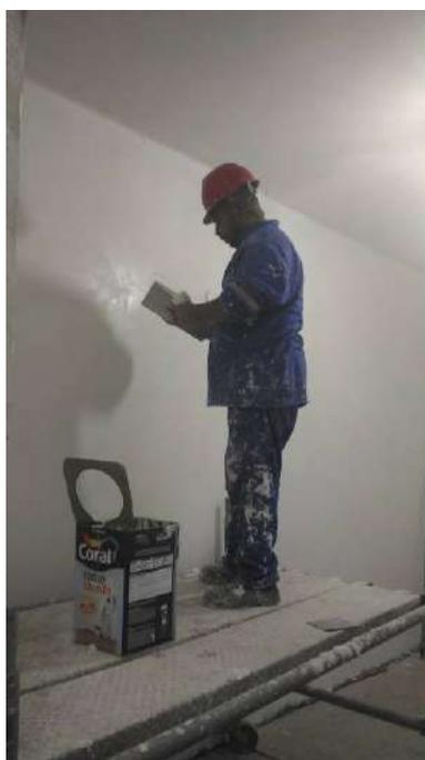
Foto 12: Emassamento das alvenarias.
