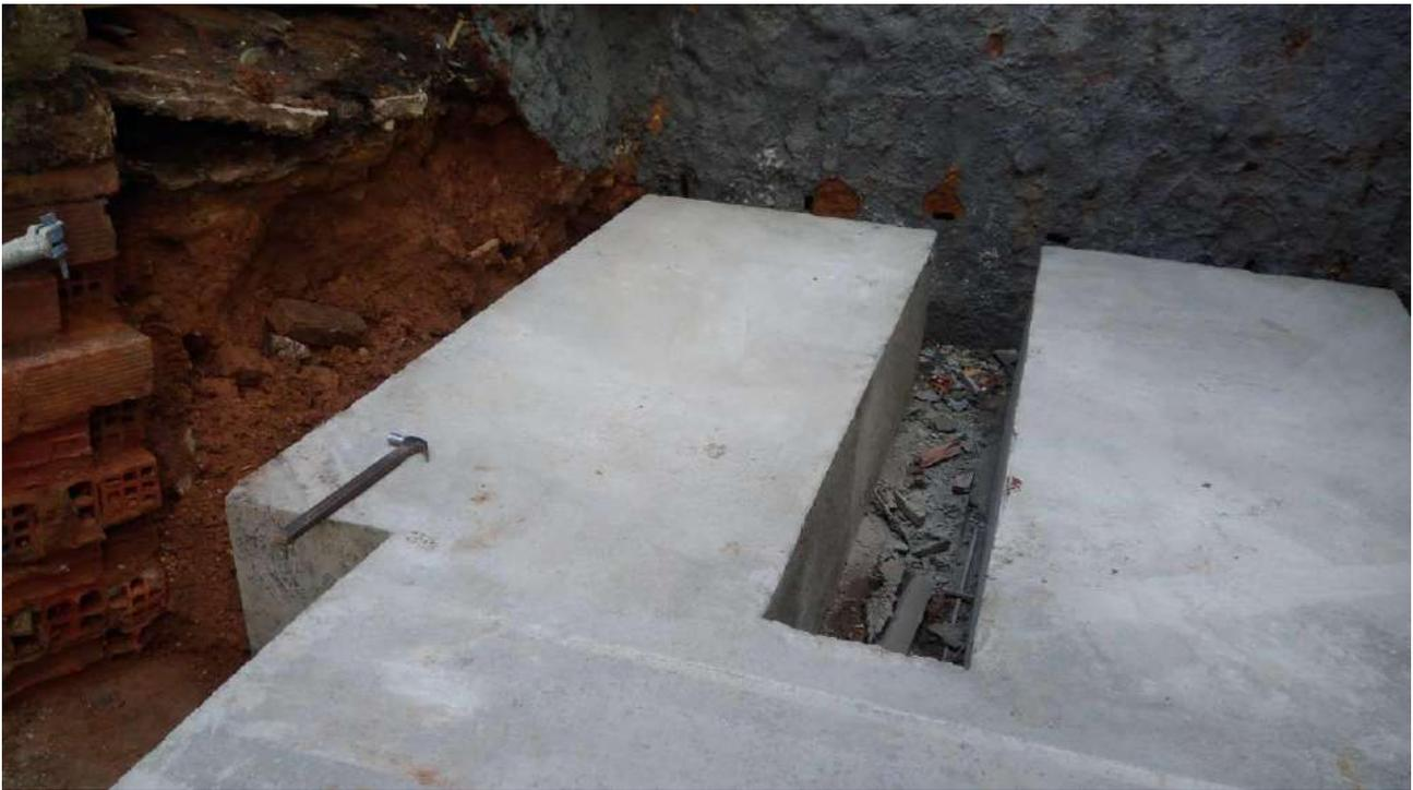
Foto 11: Desfôrma dos blocos de e vigas de concreto.
