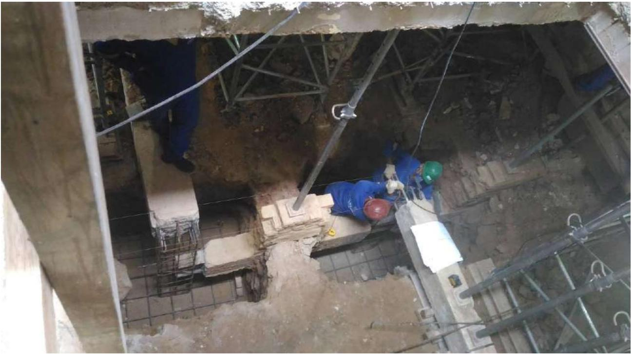
Foto 23: Armação das ferragens - Bloco de reforço -1Pav.
