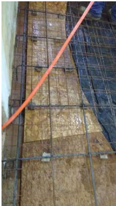
Foto 48: Armação das laje da cozinha do -2 subsolo.
