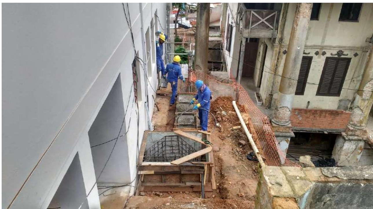
Foto 22: Concretagem dos blocos.
