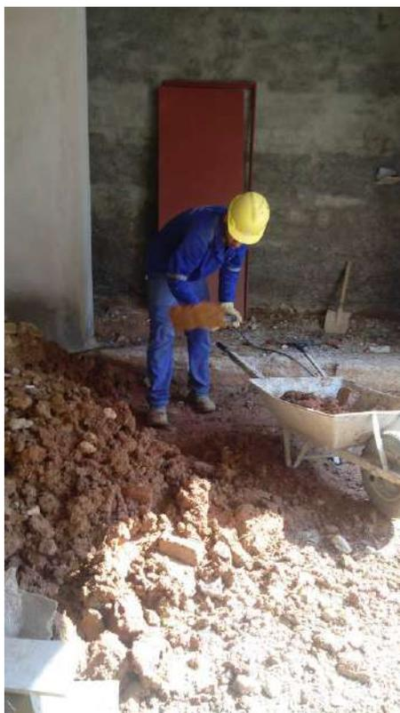
Foto 18 – Remoção de entulho do aterro do – 3° Subsolo
