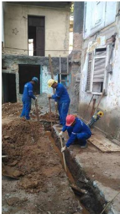
Foto 16: Abertura das valas para drenagem do talude
