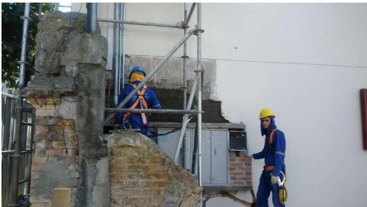
Foto 69: Instalação das entrada de energia da Eletropaulo.
