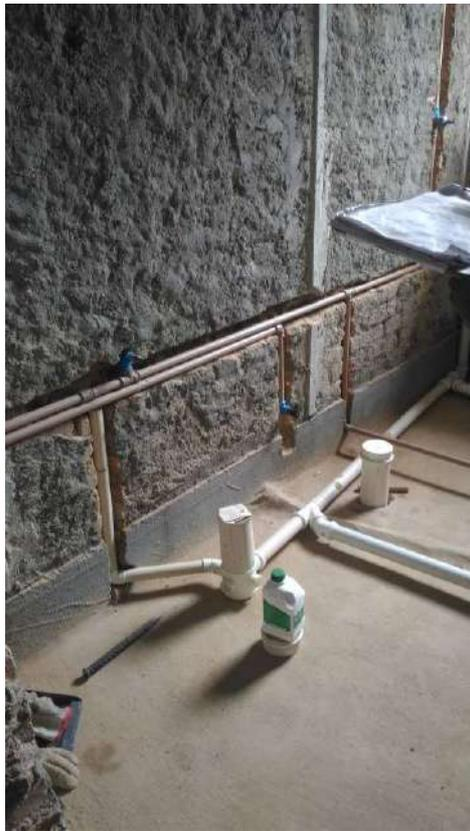
Foto 27: Execução do novo sistema de hidráulica (esgoto; alimentação de água e alimentação de água de reuso).
