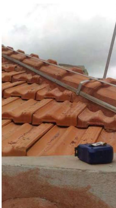
Foto 21: Instalação do para-raio da Casa 11
