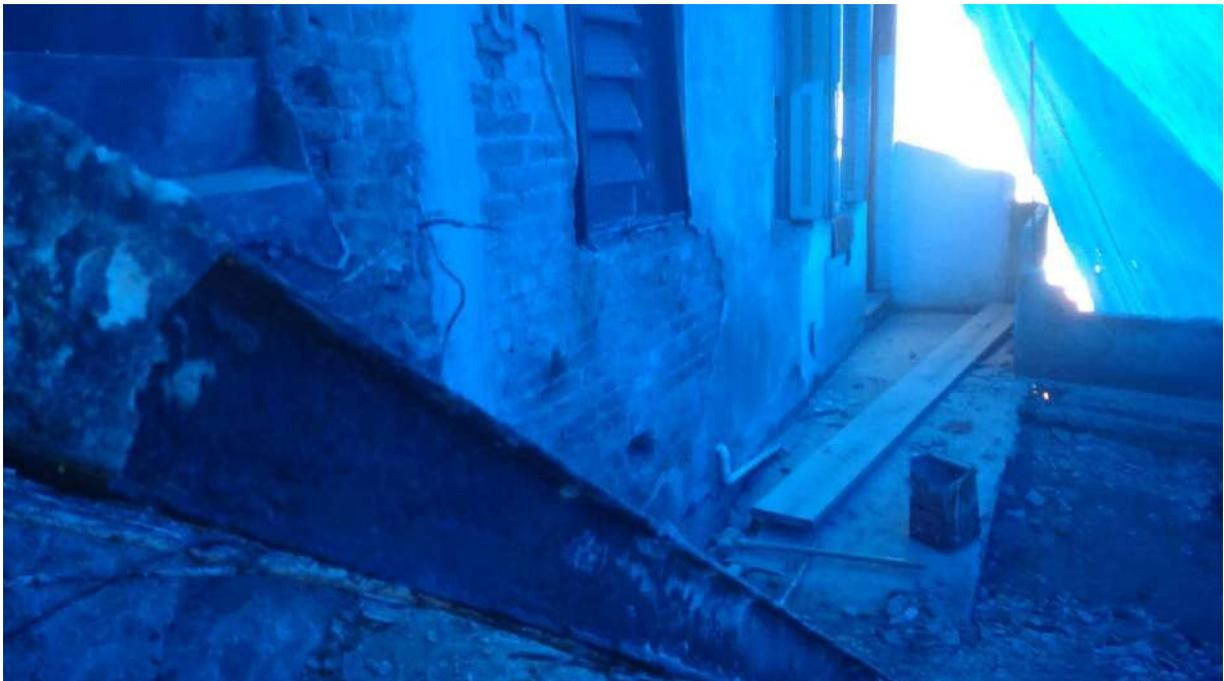
Foto 34: Demolição da escadaria de concreto da fachada lateral
