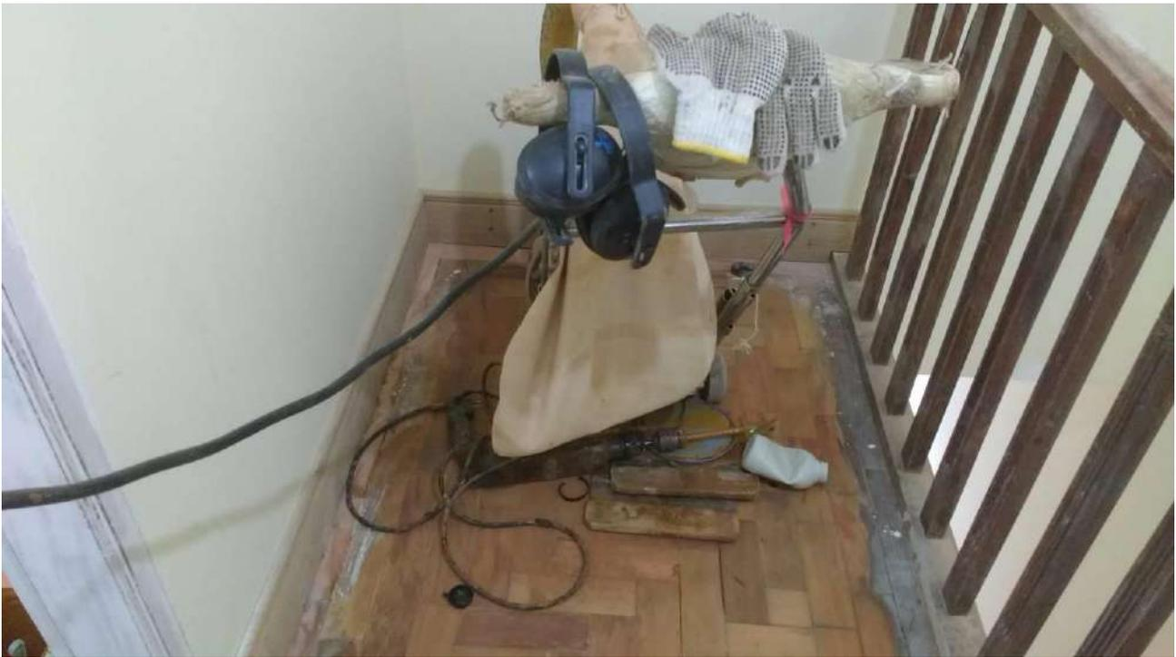
Foto 39: Raspagem e acabamento dos pisos de madeira.
