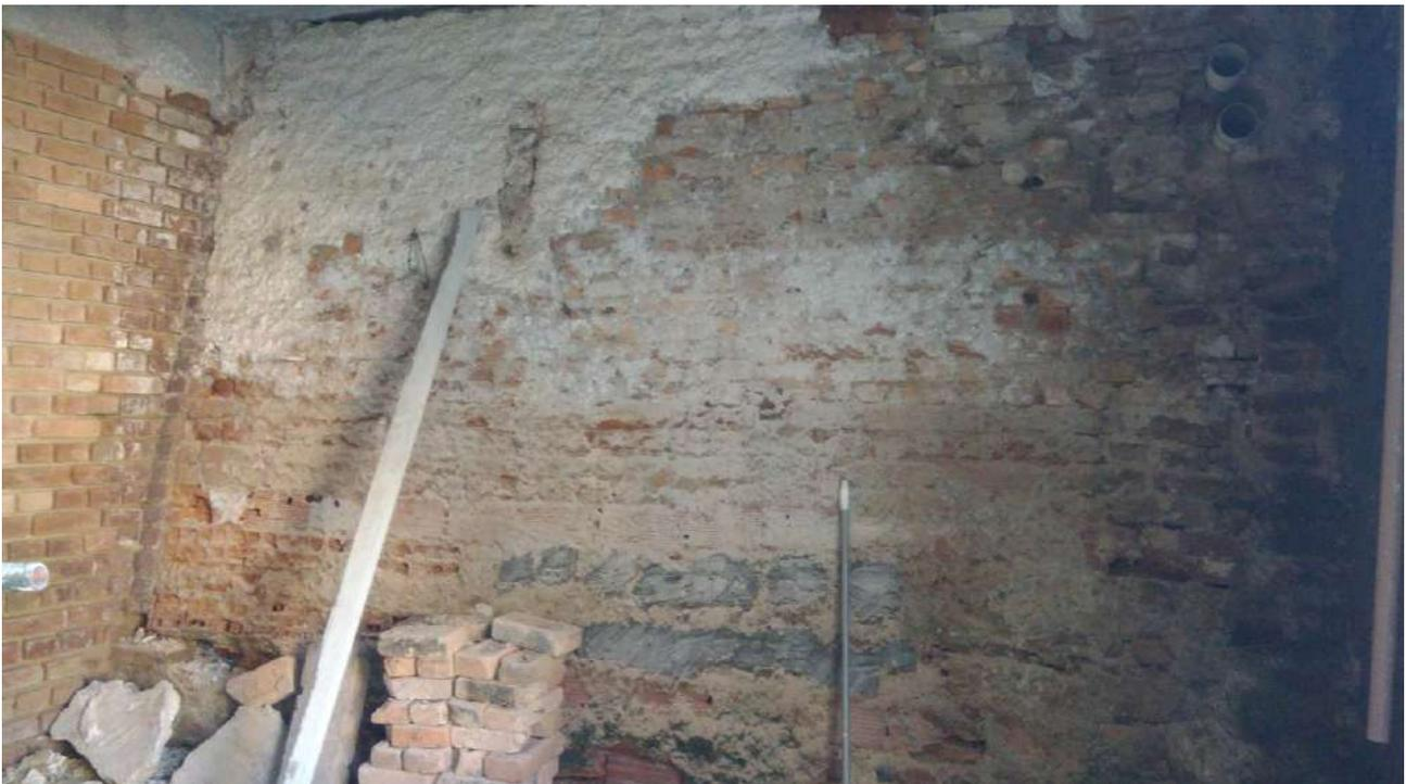
Foto 95: Limpeza das argamassas do talude;
