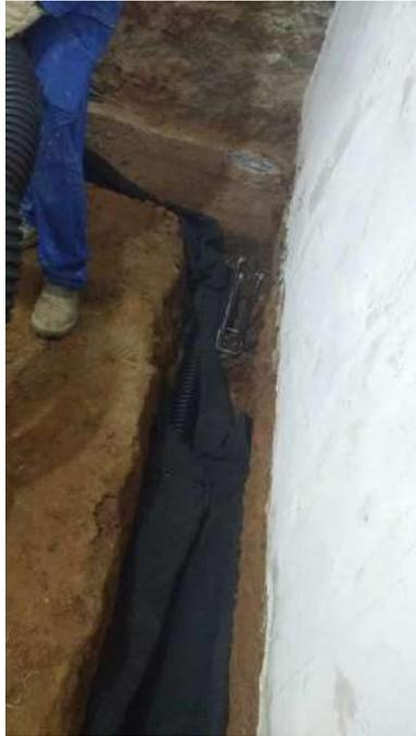
Foto 35: Drenagem do talude na -2 subsolo.
