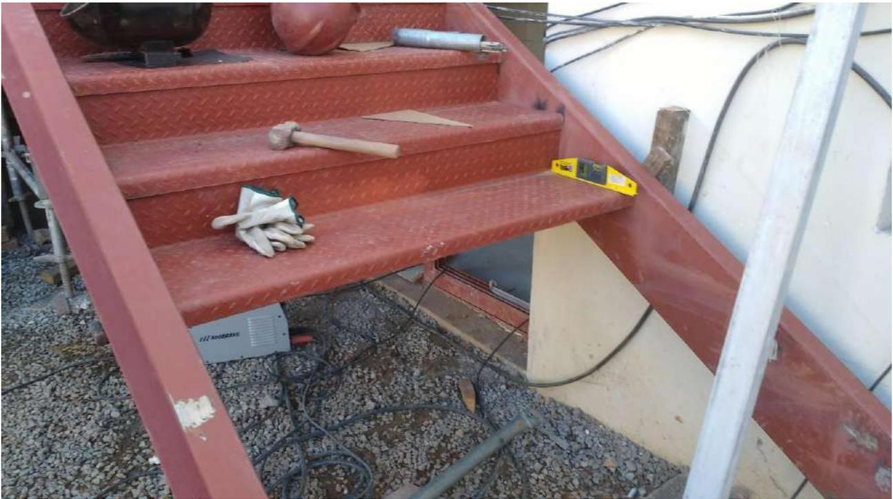
Foto 21: Instalação dos degraus da escadaria.
