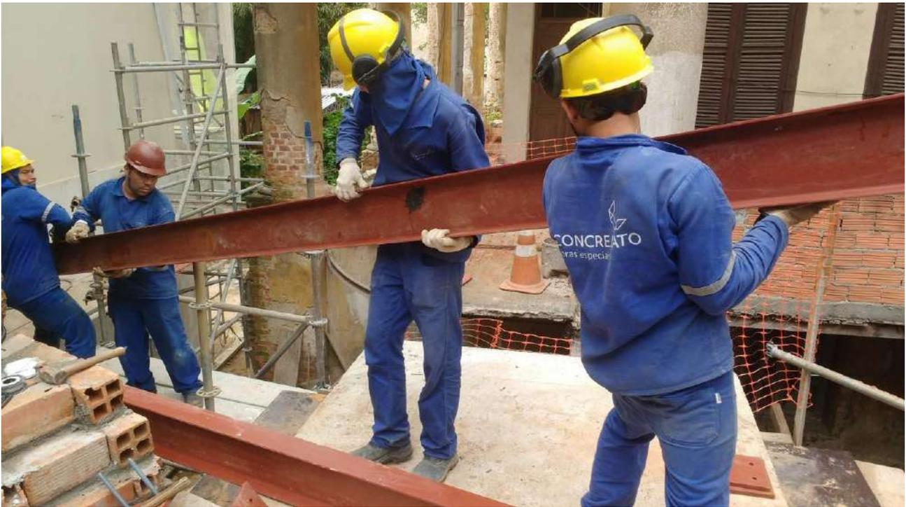
Foto 29: Montagem da passarela metálica de acesso ao -2 pavimento.
