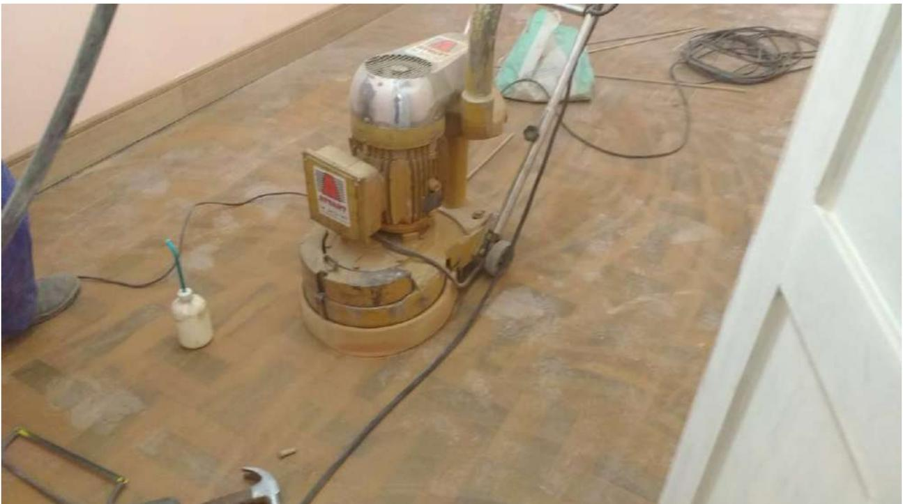
Foto 38: Raspagem e acabamento dos pisos de madeira.
