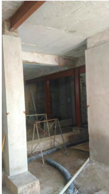
Foto 12: Instalação dos pilares e vigas metálicas no -1 subsolo.
