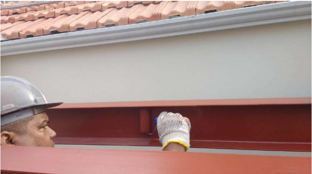
Foto 05: Pintura de acabamento das estruturas metálicas da cobertura.
