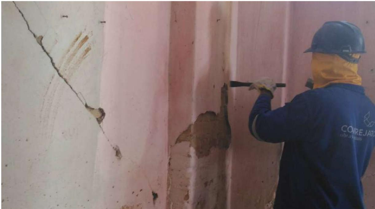
Foto 30: Abertura das trincas
