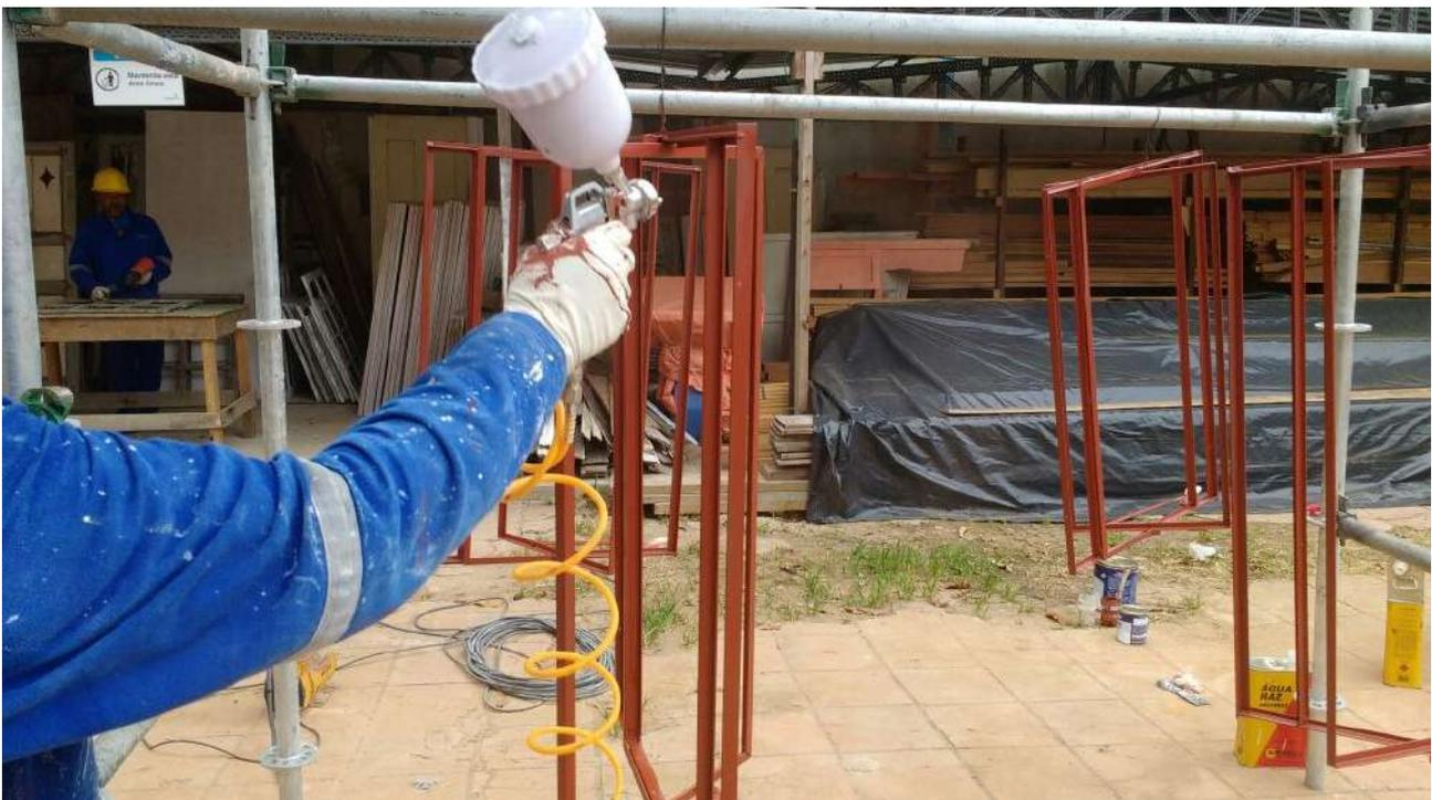
Foto 14: Aplicação de fundo epóxi nas novas esquadrias metálicas
