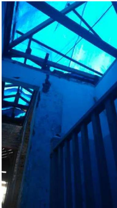
Foto 18: Fechamento provisório da cobertura em lona reforçada
