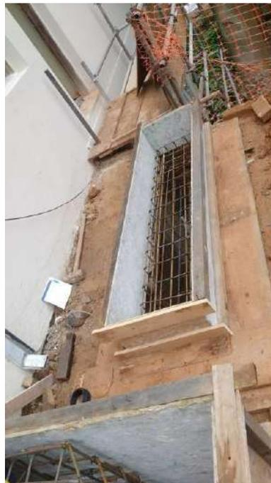
Foto 20: Blocos para sustentação de escadaria e passarela metálica.
