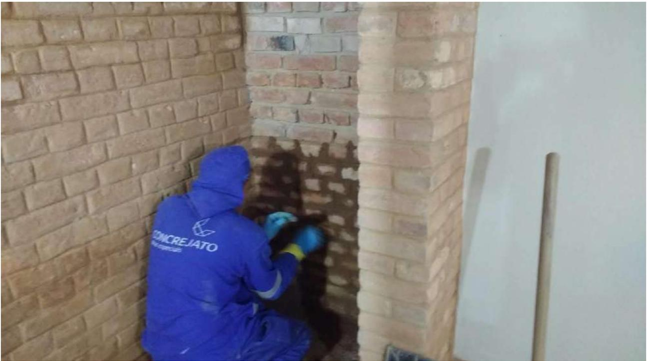
Foto 29: Acabamento dos tijolos aparentes do -1 subsolo.
