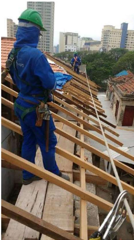
Foto 19: Substituição dos caibros danificados
