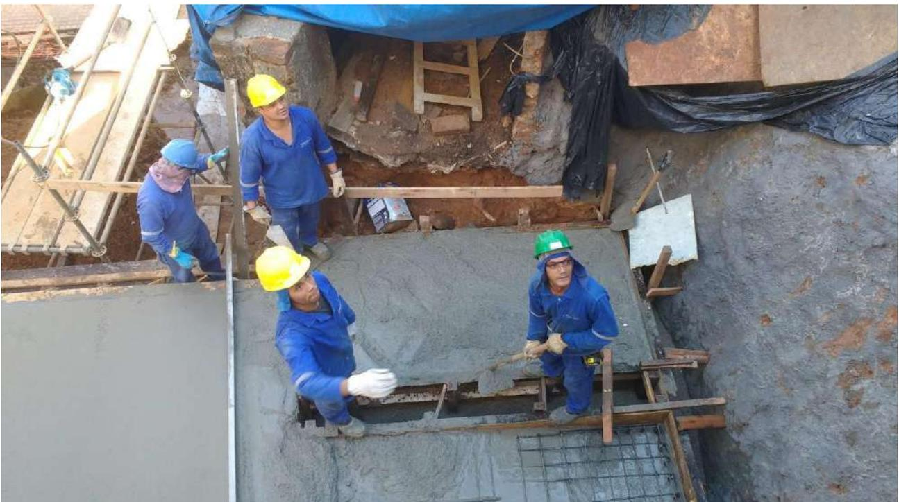
Foto 08: Concretagem das vigas de concreto.
