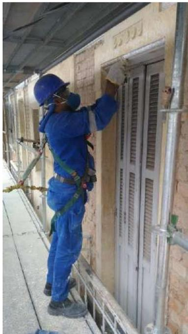
Foto 45: Decapagem das tintas látex da fachada frontal
