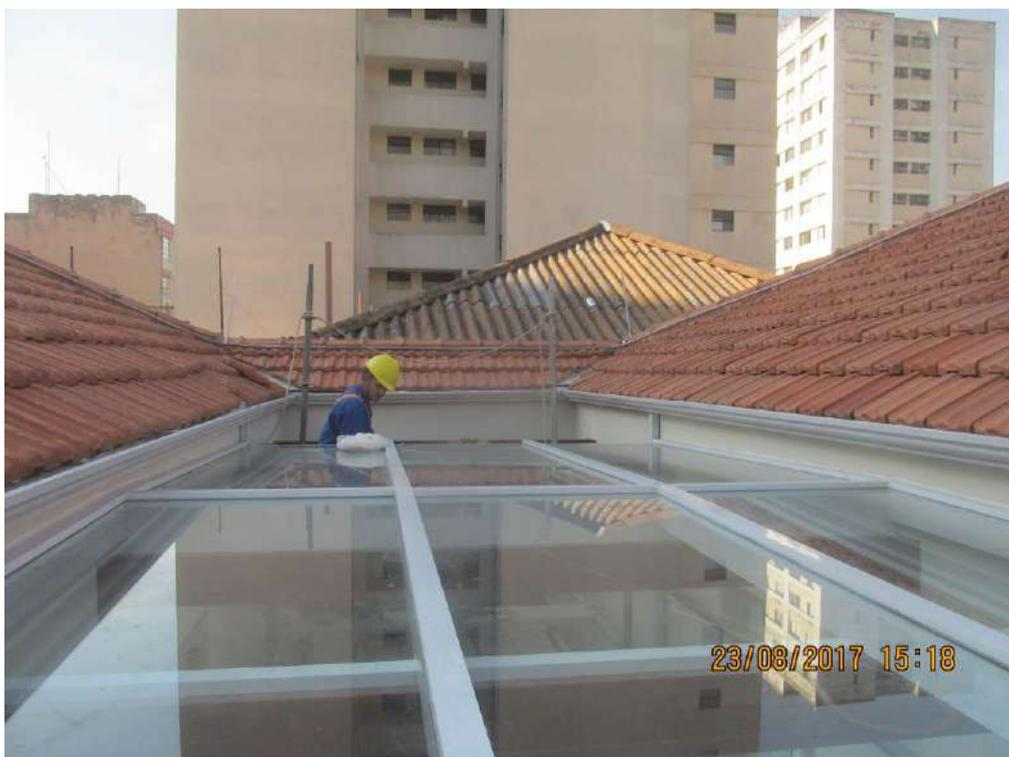
Foto 07: Instalação da cobertura de vidro;
