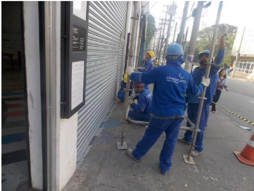
Foto 05- Montagem do andaime para instalação do letreiro – Galpão
