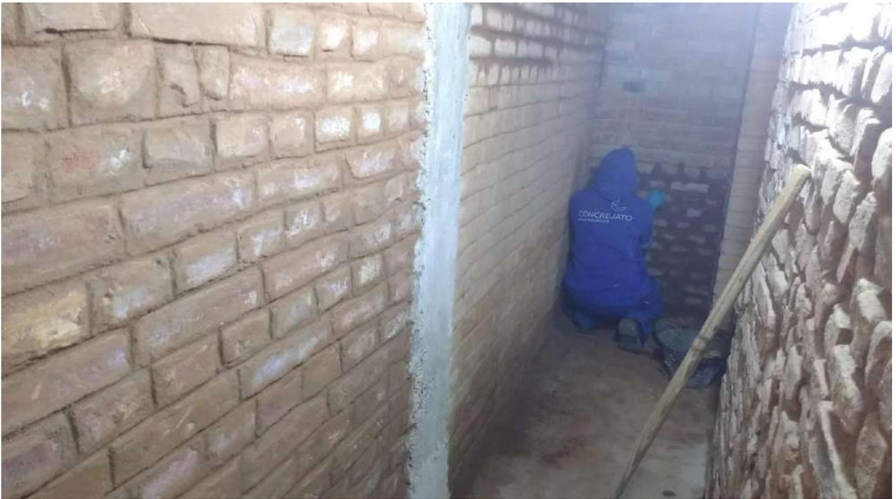
Foto 31: Acabamento dos tijolos aparentes do -1 subsolo.
