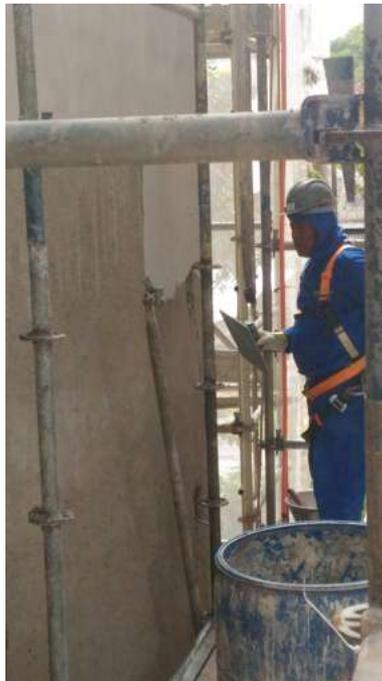
Foto 03: Execução do reboco de acabamento da fachada.
