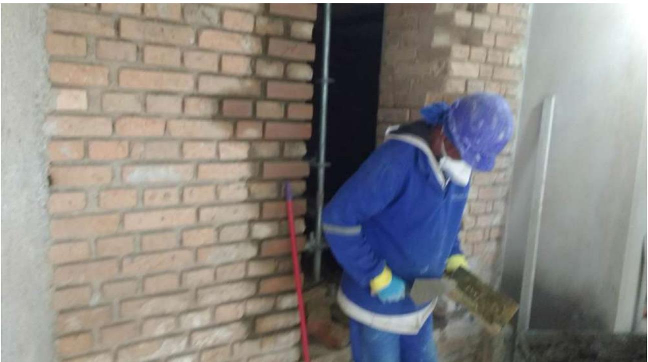
Foto 26: Limpeza dos tijolos do – 3 pavimento
