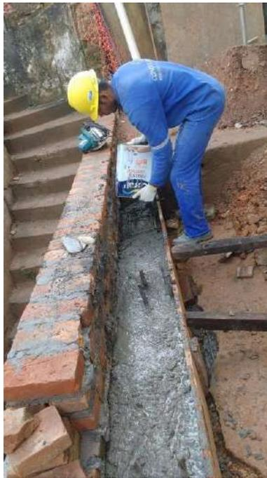
Foto 75: Execução de viga invertida no talude.
