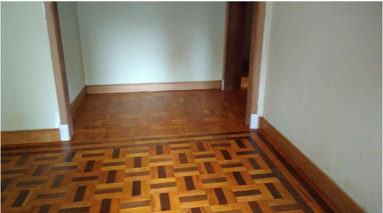
Foto 62: Aplicação de resina anti-chamas nos pisos de madeira.
