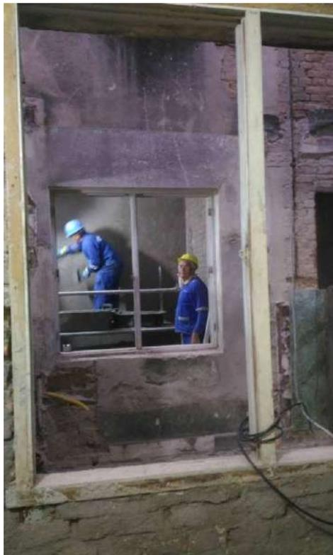
Foto 62: Regularização das alvenarias internas.
