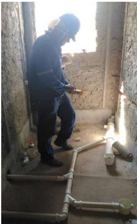
Foto 32: Execução do novo sistema de hidráulica (esgoto; alimentação de água e alimentação de água de reuso).
