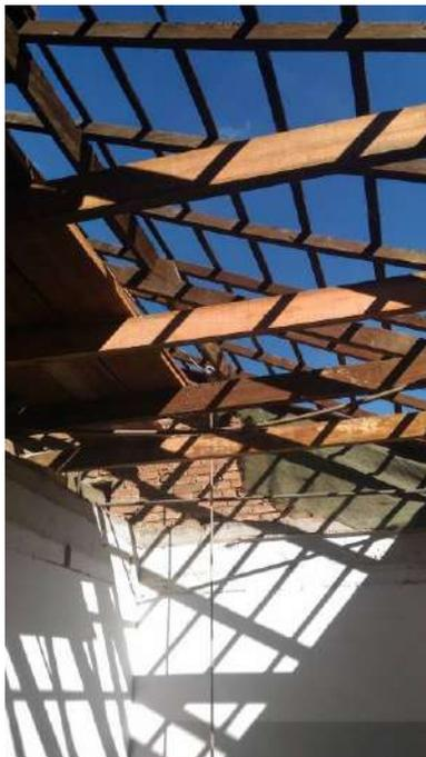
Foto 28: Remoção das telhas da água interna do telhado
