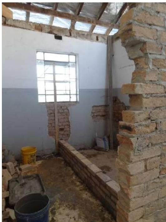
Foto 69: Elevação de alvenaria de vedação
