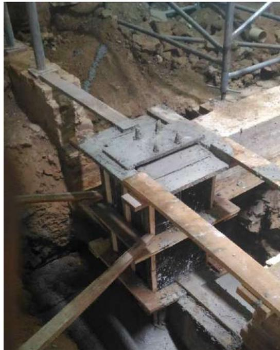
Foto 26: Concretagem do bloco de reforço – 1Pav.
