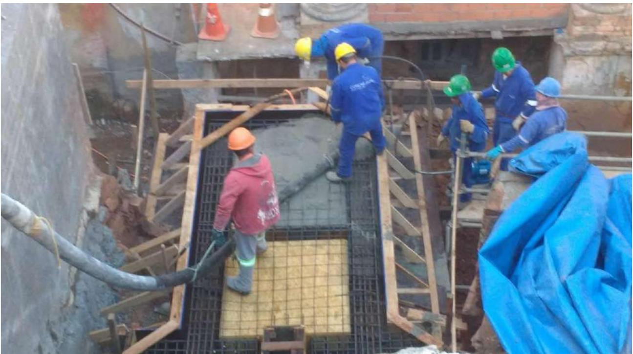
Foto 06: Concretagem das vigas de concreto.
