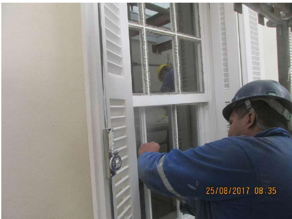
Foto 53: Instalação dos vidros;
