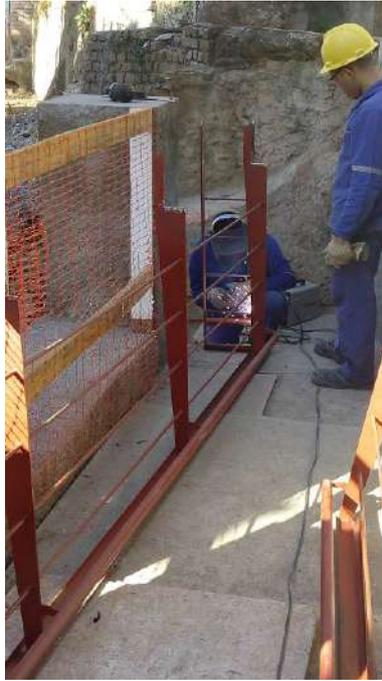
Foto 13 - Reparos com solda no guarda corpo da passarela metálica
