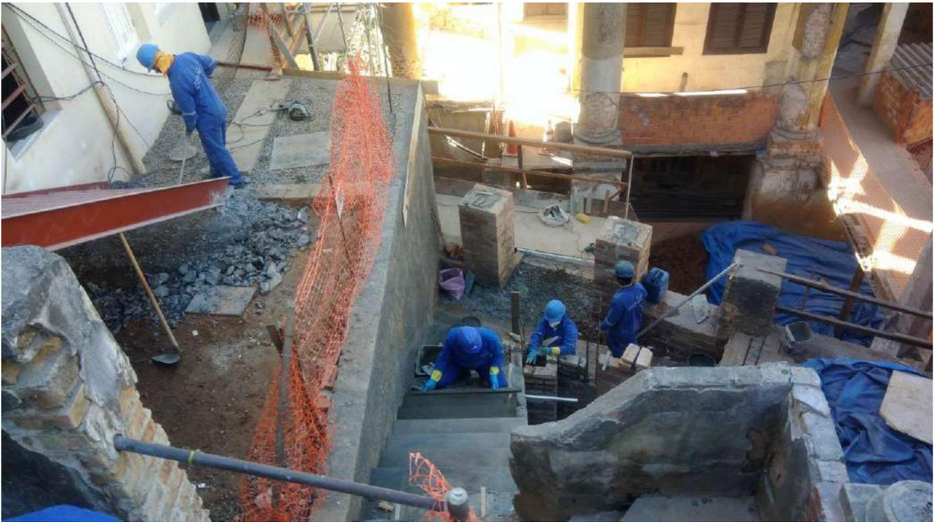
Foto 46: Revestimento da escadaria externa do talude
