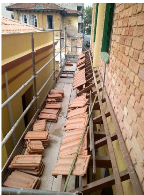
Foto 02 – Restauração dos tijolos da fachada
