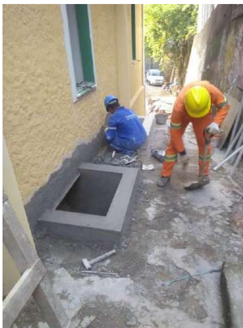
Foto 13 – Execução da argamassa de acabamento das clarabóia
