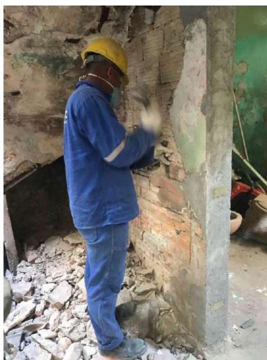
Foto 18- Demolição das alvenarias internas – Casa 07
