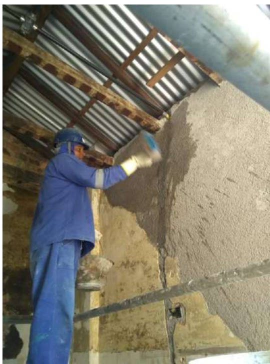
Foto 07 – Execução do emboço das paredes internas
