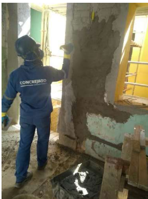
Foto 13 – Execução do chapisco das paredes internas
