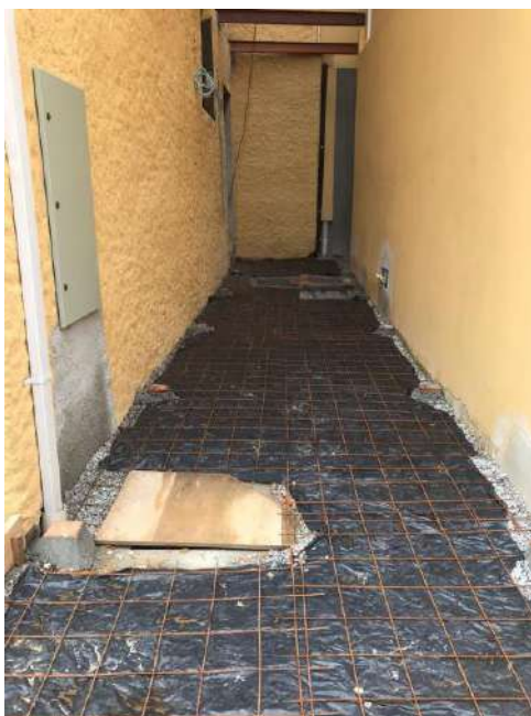
Foto 13 – Armação para execução da concretagem
