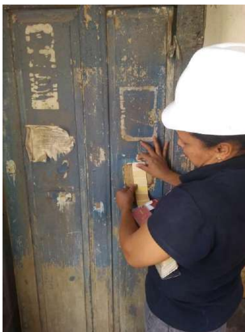
Foto 34 – Prospecção das portas de madeira
