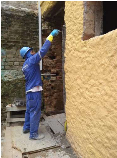
Foto 06 – Execução do emboço do batente
