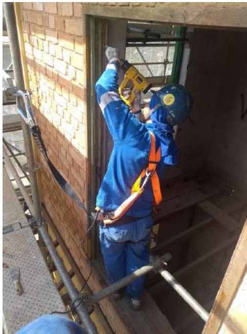
Foto 15 – Decapagem dos batentes de madeira existentes – Casa 07
