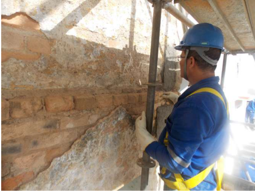
Foto 03 – Remoção cuidadosa da argamassa existente da fachada principal – Casa 07
