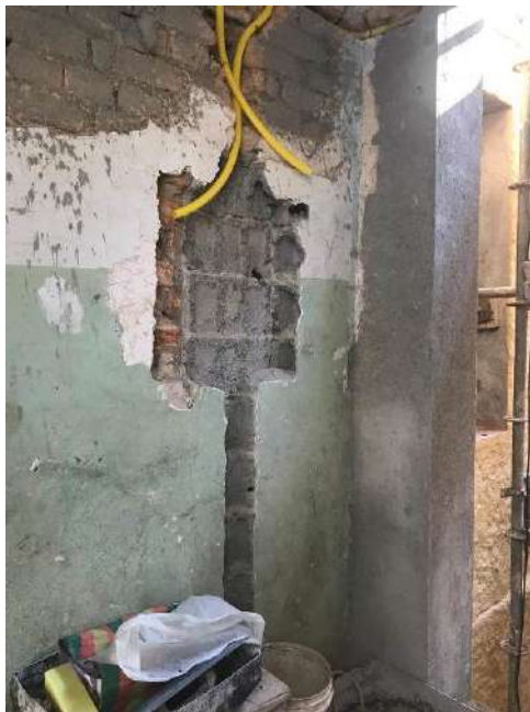
Foto 28 – abertura do vão para instalação dos quadros elétricos
