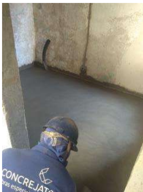
Foto 21 - Execução do piso cimento queimado
