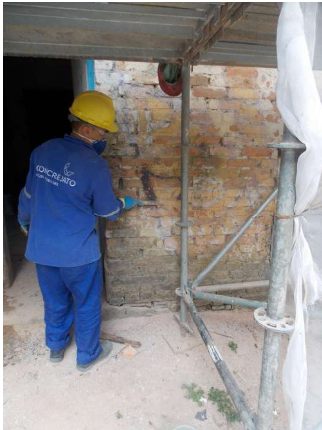
Foto 01 – Limpeza dos tijolos existentes na fachada – Casa 07
