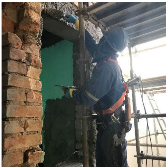
Foto 12 – Ajustes dos vãos em alvenaria – Casa 07
