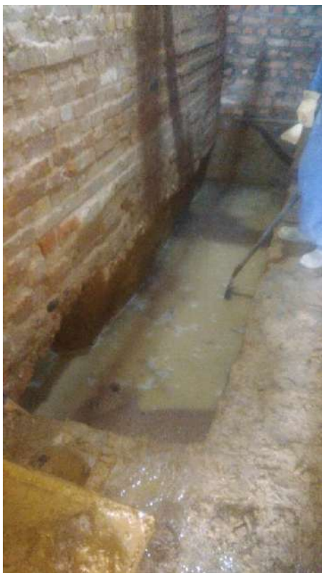
Foto 01- Bombeamento da água para sapata – casa 07
