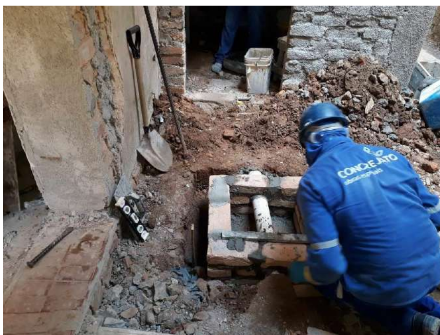
Foto 02 – Execução da caixa coletora e do piso cimentado
