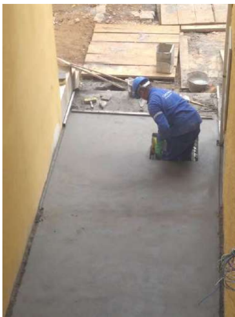
Foto 01 – Execução do piso cimentado área externa
