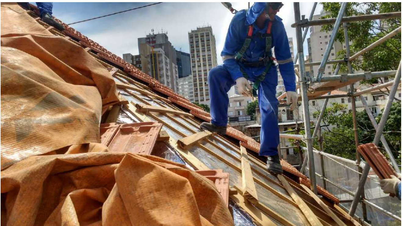
Foto 09- Instalação das telhas
