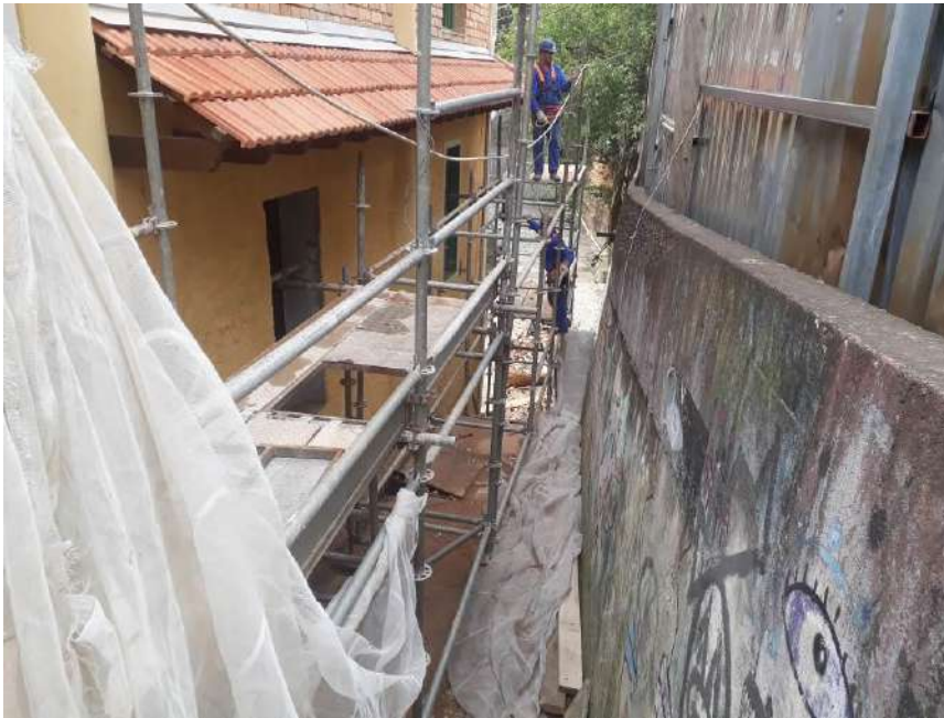
Foto 51 – Desmontagem do andaime da fachada lateral
