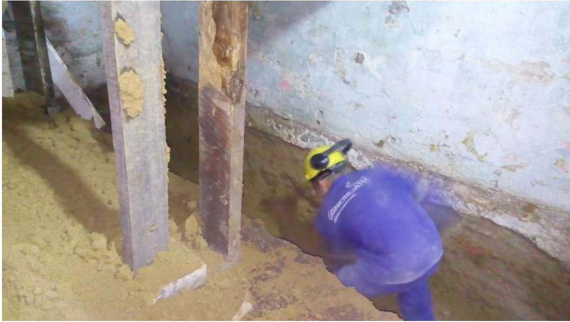
Foto 03 –Escavação manual – Casa 07
