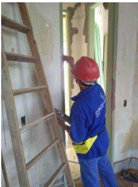
Foto 22 – Aplicação de massa para madeira nos batentes
