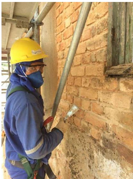
Foto 05 – Limpeza dos tijolos aparentes da fachada casa 7
