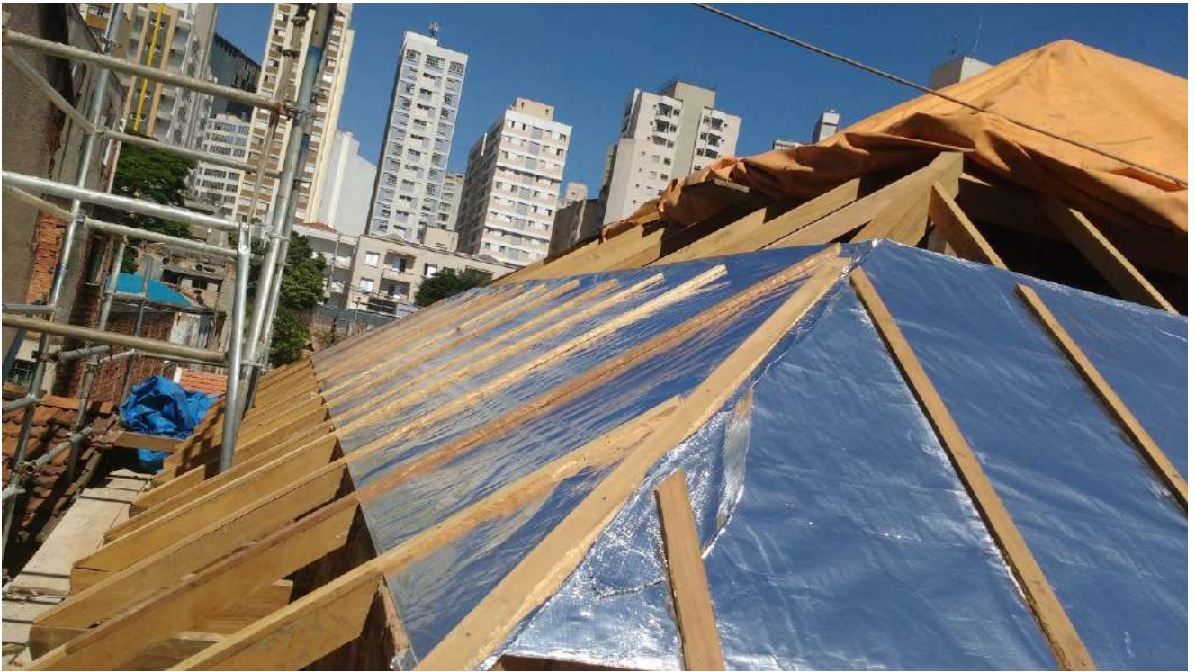
Foto 27- Instalação das manta de alumínio
