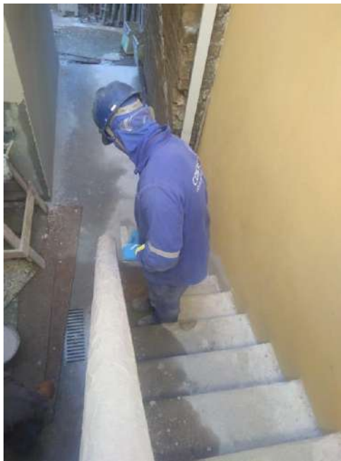
Foto 08 – Execução da argamassa de acabamento do corrimão
