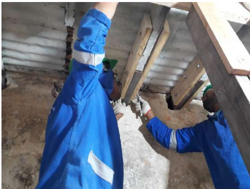
Foto 27 – Restauro dos barrotes danificados
