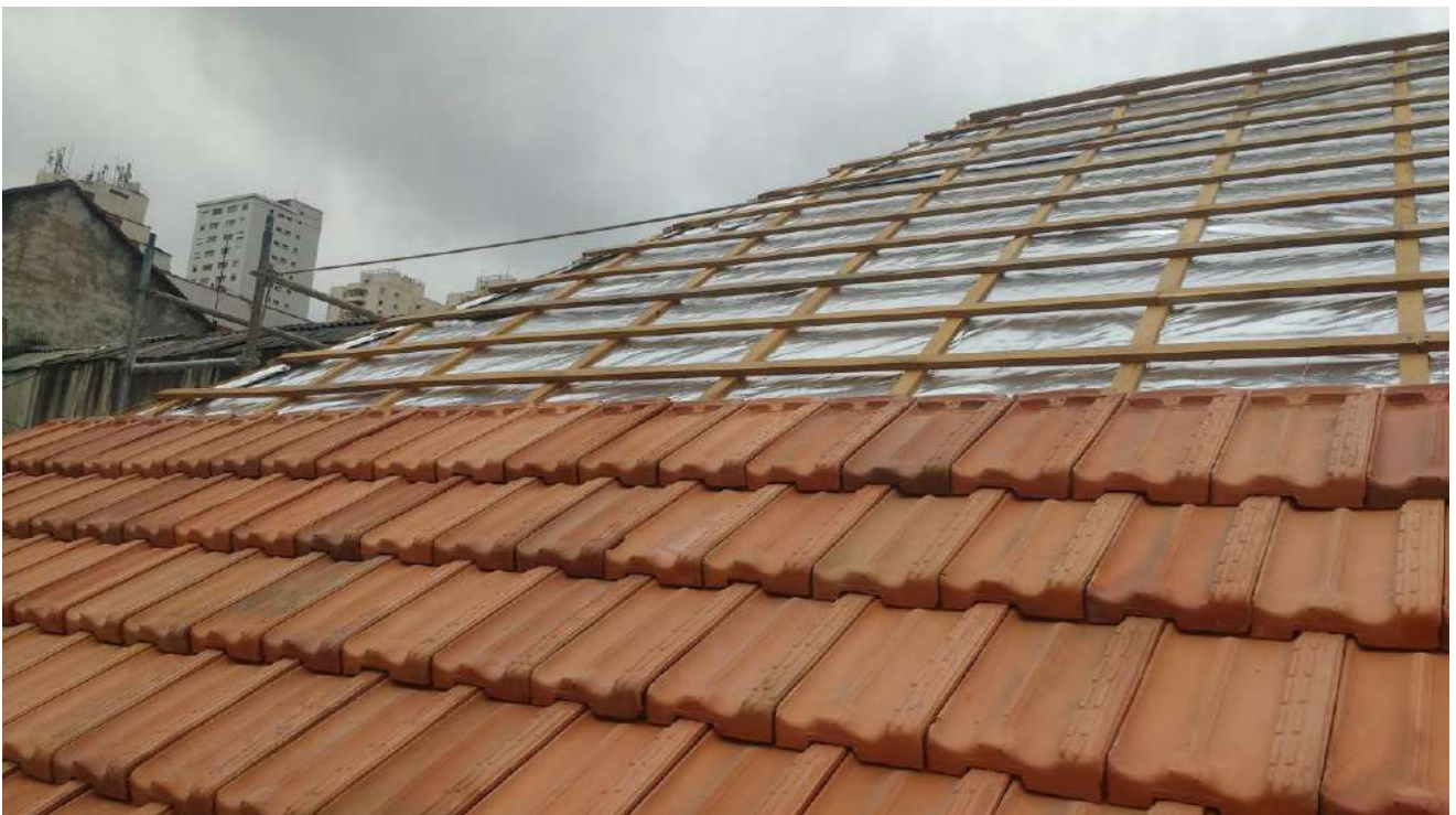
Foto 16- Instalação das telhas
