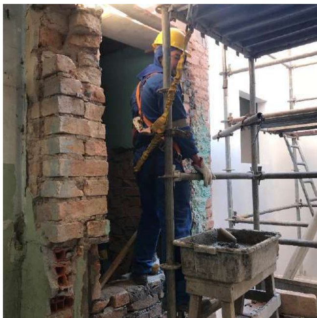
Foto 11 – Ajustes dos vãos em alvenaria – Casa 07
