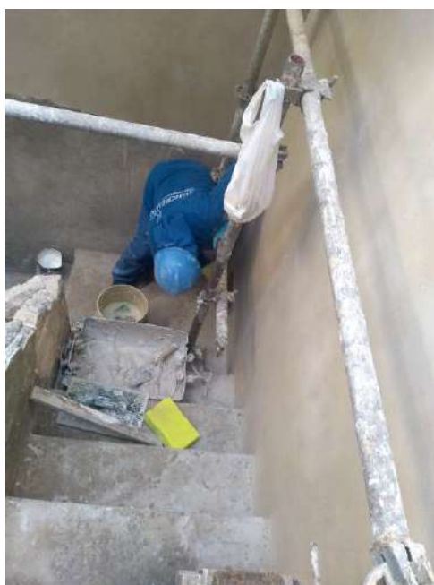
Foto 24 – Execução da argamassa de acabamento da fachada dos fundos
