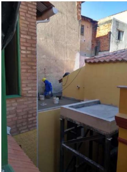
Foto 19 - Impermeabilização da cobertura
