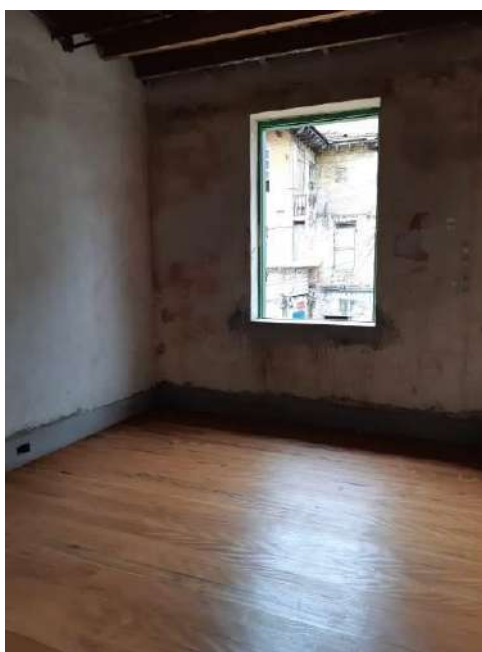
Foto 24 – Tratamento dos assoalhos de madeira
