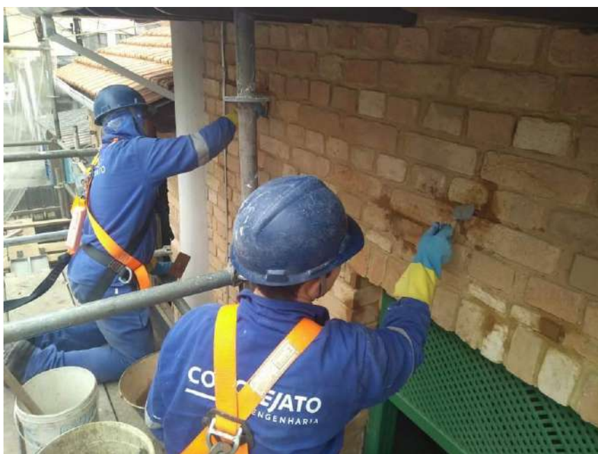
Foto 28 – Restauração dos tijolos existentes da fachada lateral
