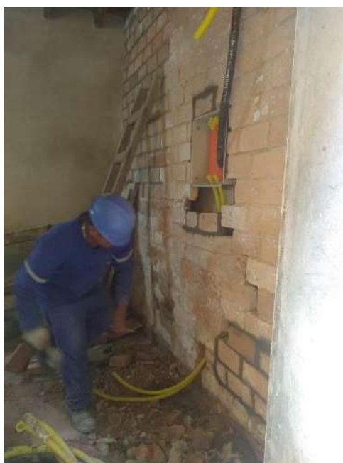
Foto 06 - Recuperação da alvenaria existente após a passagem dos conduite
