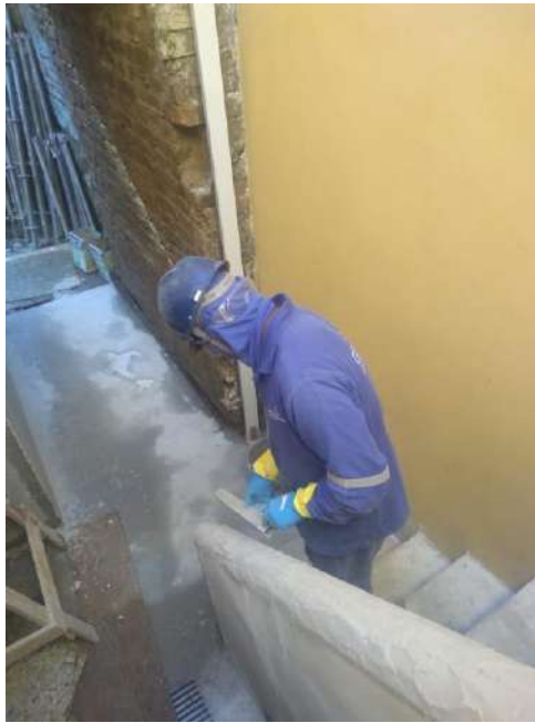
Foto 07 – Execução da argamassa de acabamento no corrimão
