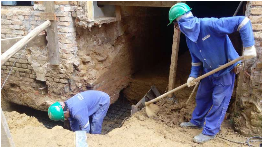
Foto 04- Instalação das ferragens da fundação da casa 07
