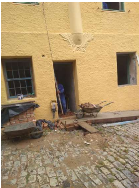
Foto 13 – Remoção dos batentes de madeira existente
