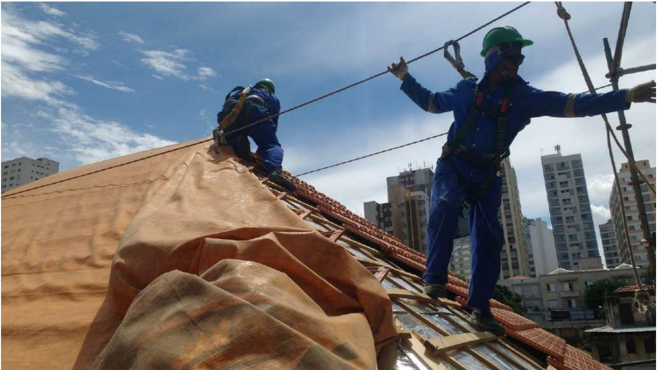
Foto 11- Instalação das telhas
