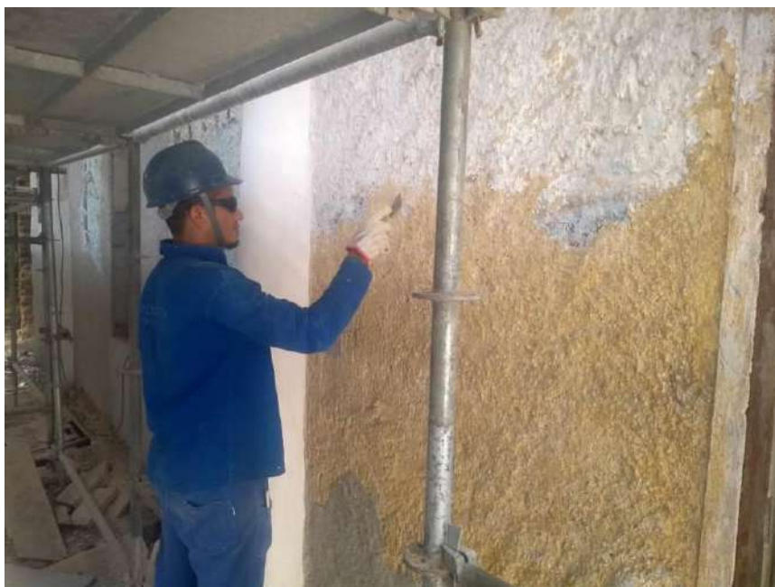
Foto 15 – Decapagem da fachada lateral
