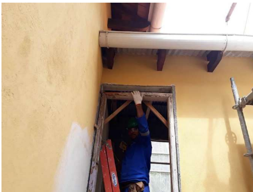
Foto 33 – Correção dos batentes de madeira
