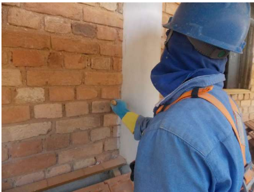
Foto 05 – Limpeza fina dos tijolos – Casa 07
