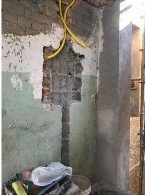
Foto 27 – Abertura do vão para instalação dos quadros elétricos
