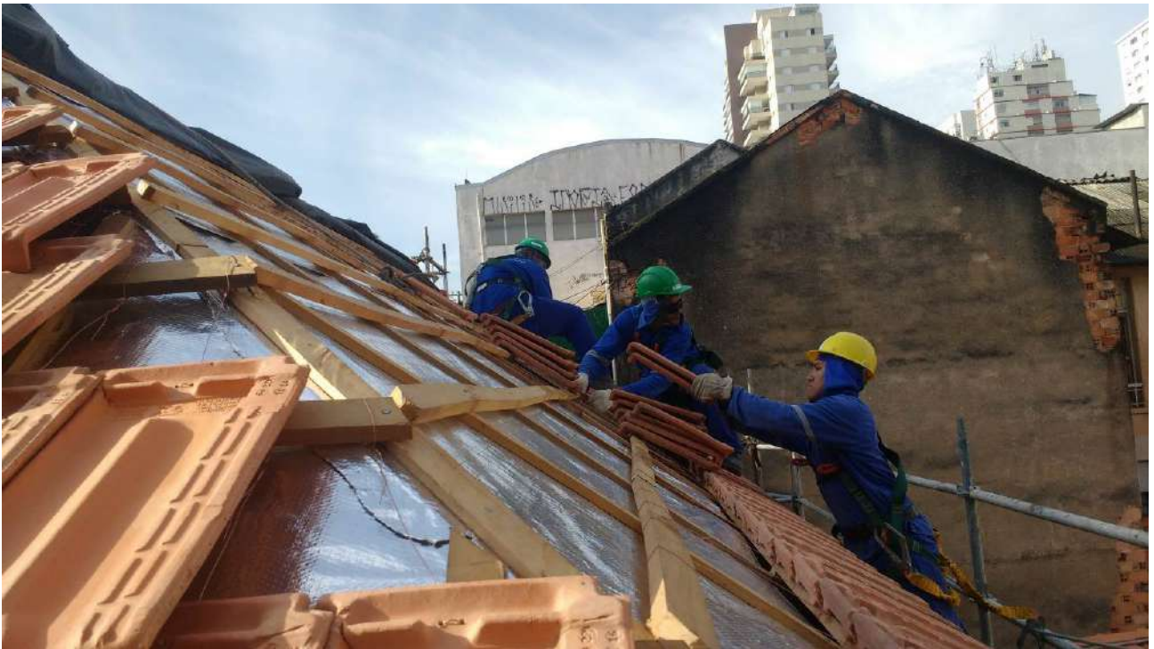
Foto 07- Instalação das telhas
