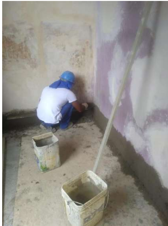
Foto 11 – Execução do rodapé
