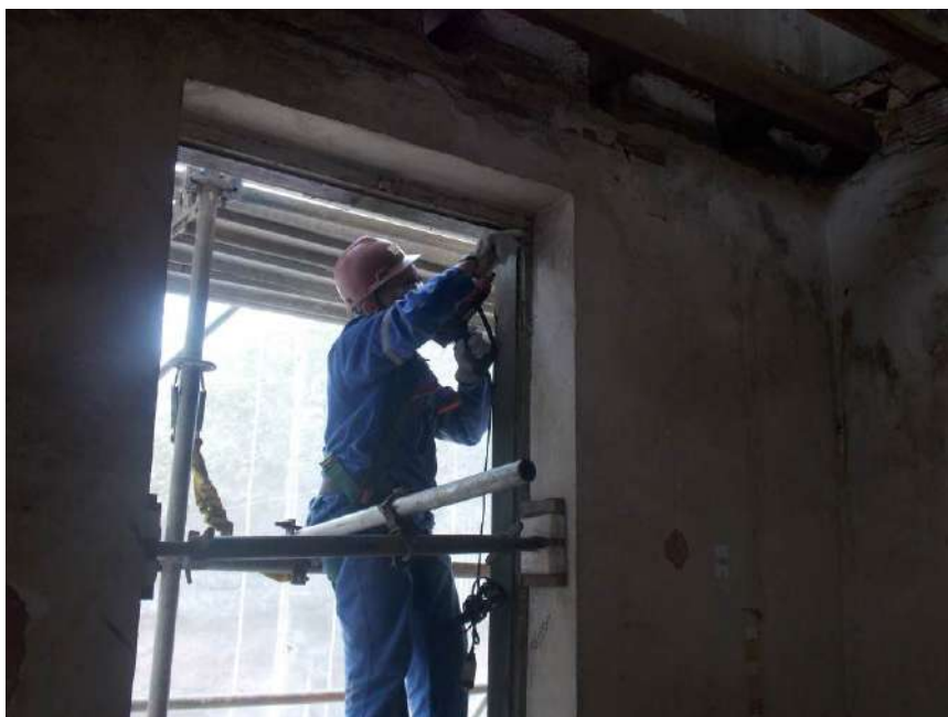
Foto 09 – Decapagem da esquadria de madeira – Casa 07
