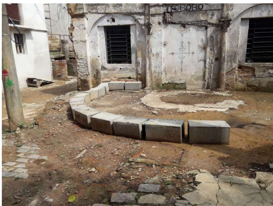
Foto 14 – Remoção das raízes das árvores
