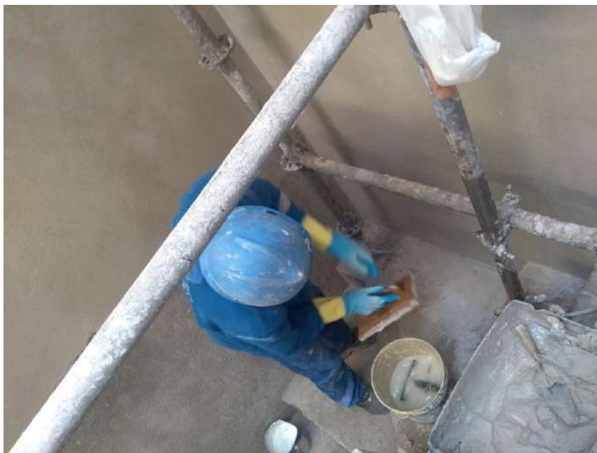
Foto 23 – Execução da argamassa de acabamento da fachada dos fundos
