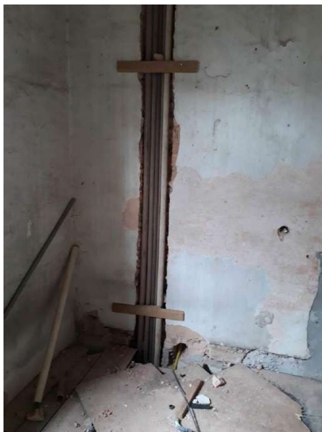
Foto 48 – Instalação das tubulações de alimentação da caixa d'água
