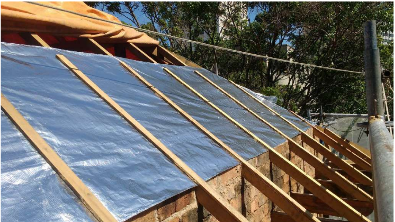
Foto 28- Instalação das manta de alumínio
