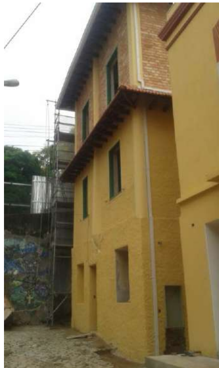
Foto 30 – Fachada da casa 7 após desmontagem do andaime – Casa 07
