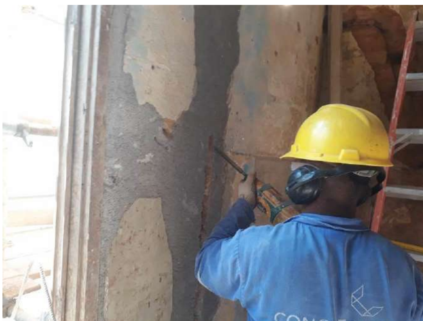
Foto 46 – Abertura dos vãos para passagem de infra de eletrica
