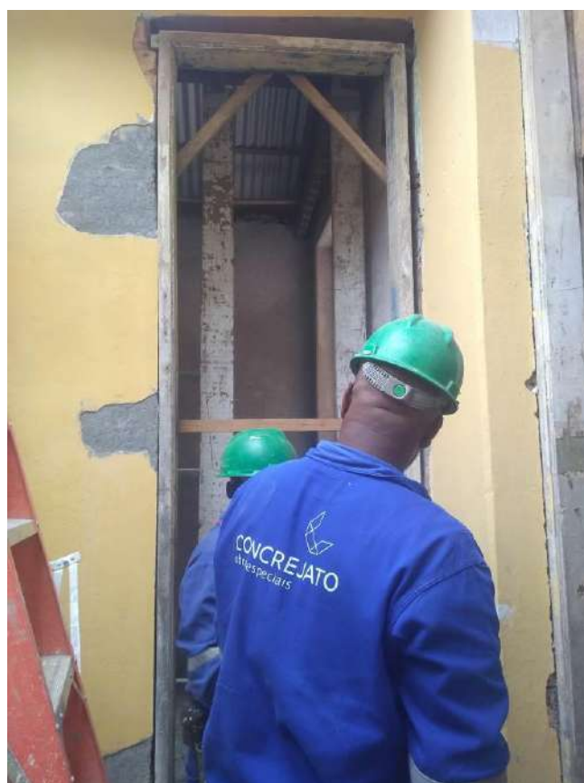
Foto 34 – Correção dos batentes de madeira
