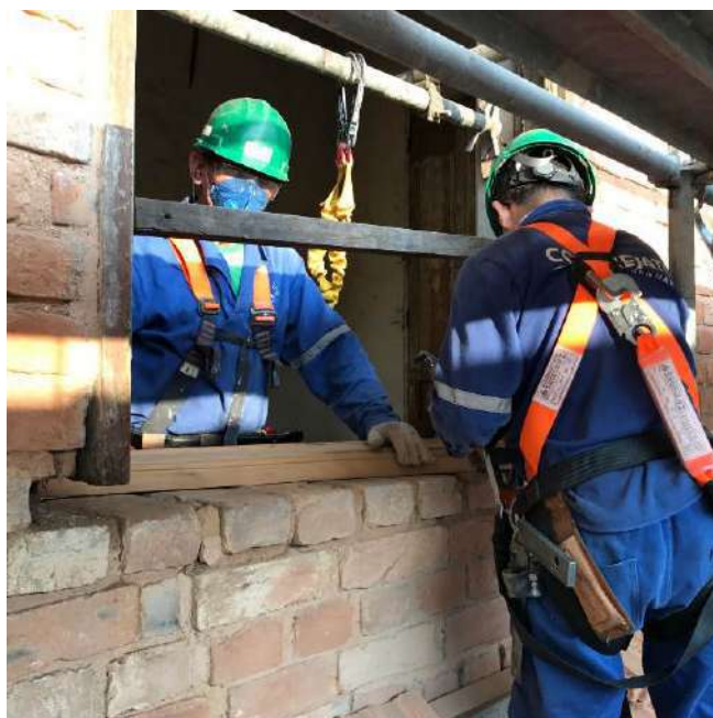
Foto 04 – Substituição da pingadeira de madeira das janelas da fachada – Casa 07
