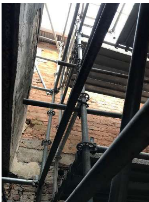
Foto 16- Remoção da revestimento das fachadas das fundos – Casa 07
