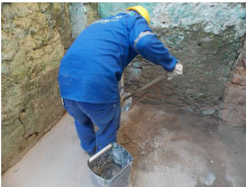
Foto 01 – Remoção de entulho – Casa 07
