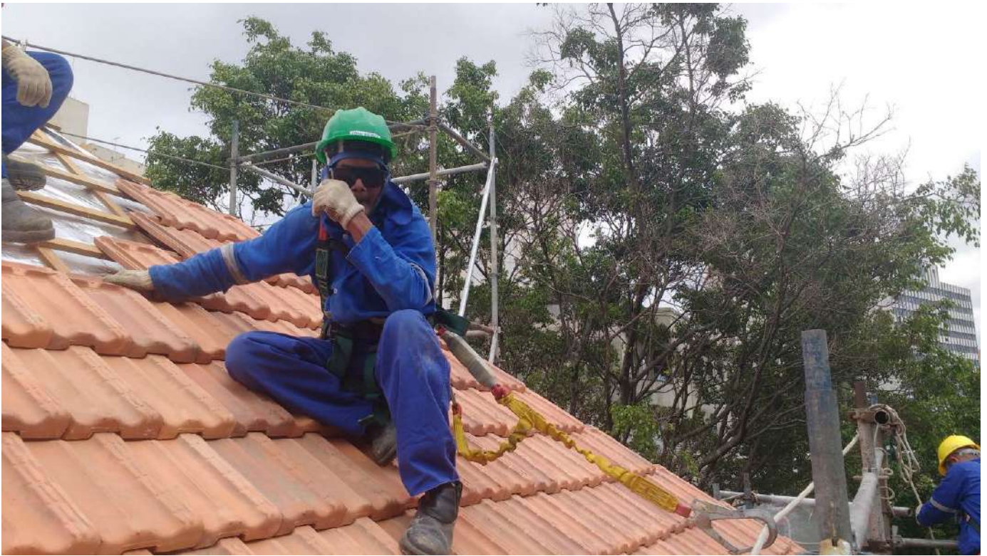
Foto 15- Instalação das telhas
