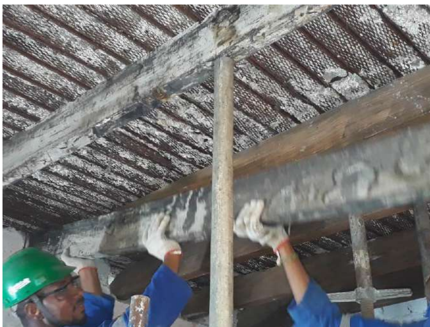
Foto 19 – Substituição dos barrotes de madeira
