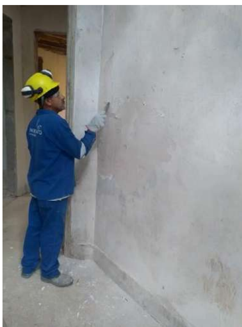
Foto 30 – Decapagem cuidadosa das paredes internas
