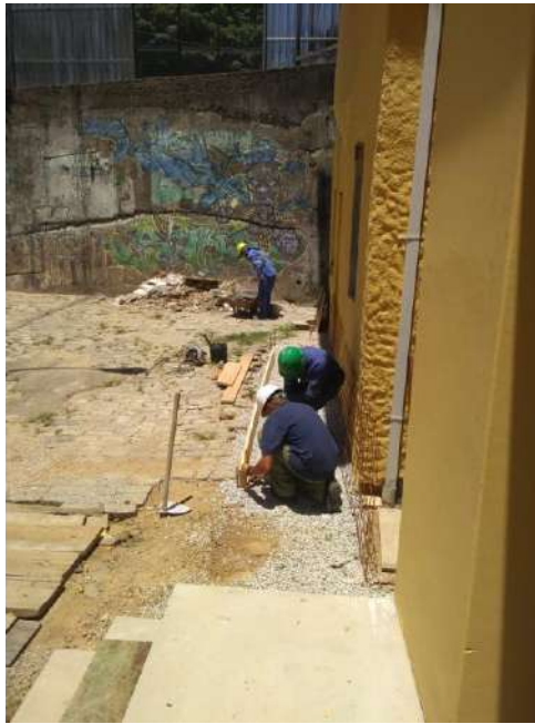
Foto 09 – Execução da forma para execução da concretagem
