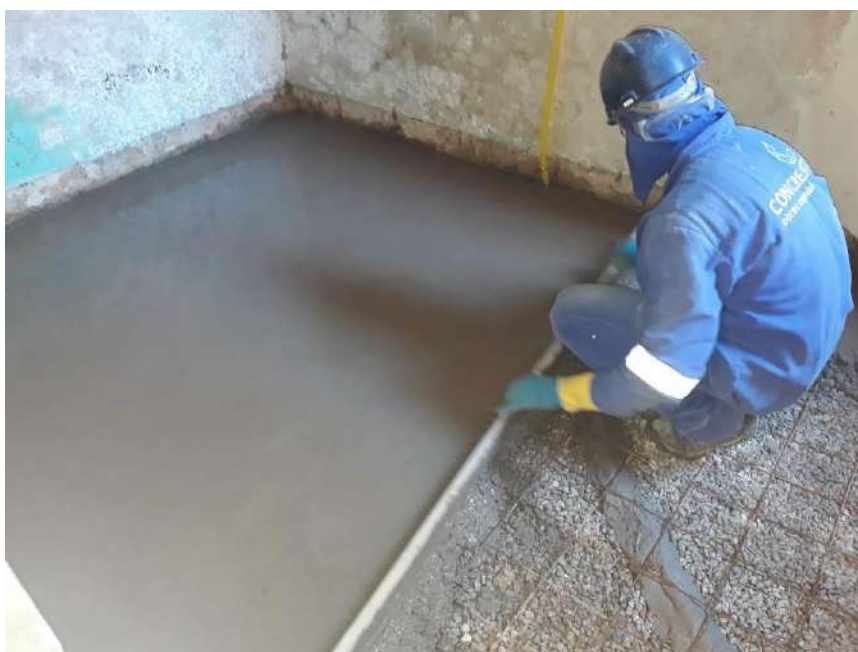
Foto 13 - Execução do piso cimentado
