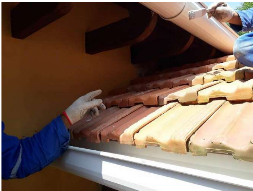
Foto 40 – Pintura das calhas na cobertura
