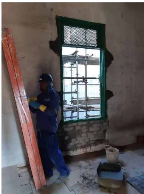
Foto 11 – Recuperação da alvenaria existente – Casa 07
