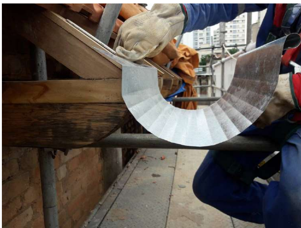
Foto 06 – Instalação das calhas na cobertura
