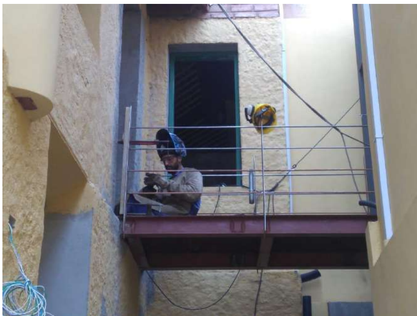
Foto 05 – Instalação do guarda corpo metálico da passarela de acesso do elevador
