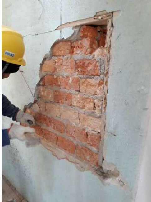
Foto 19 – Demolição manual para passagem dos conduite
