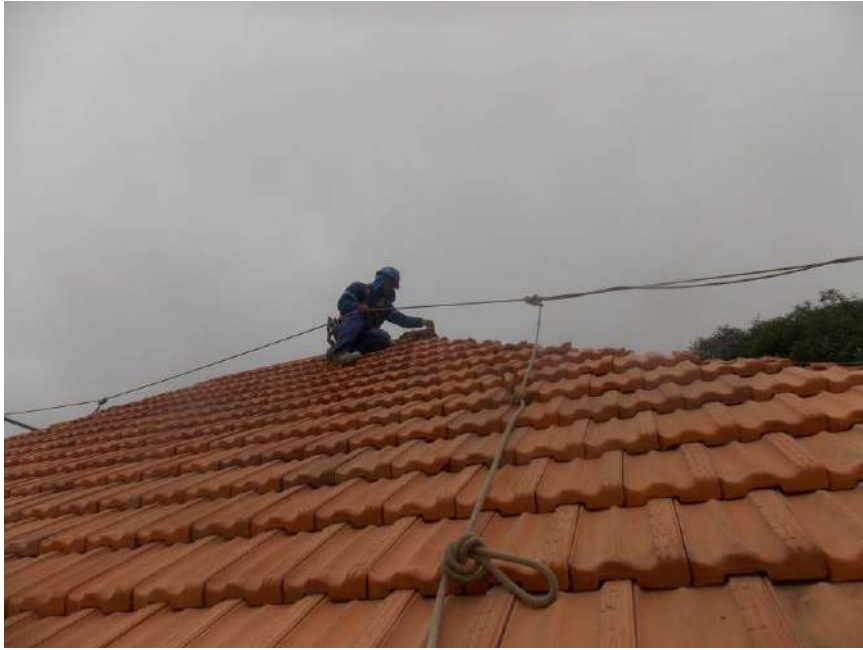
Foto 03 – Instalação das cumeeiras – Casa 07
