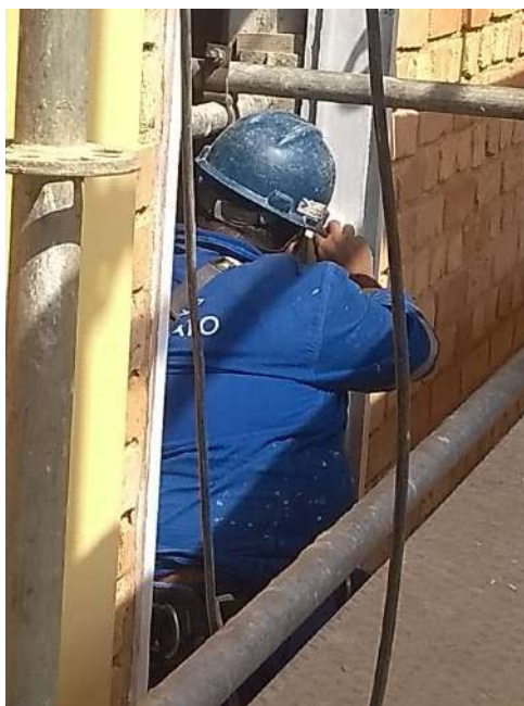
Foto 17 – Aplicação de massa para madeira nos batentes existentes – Casa 07
