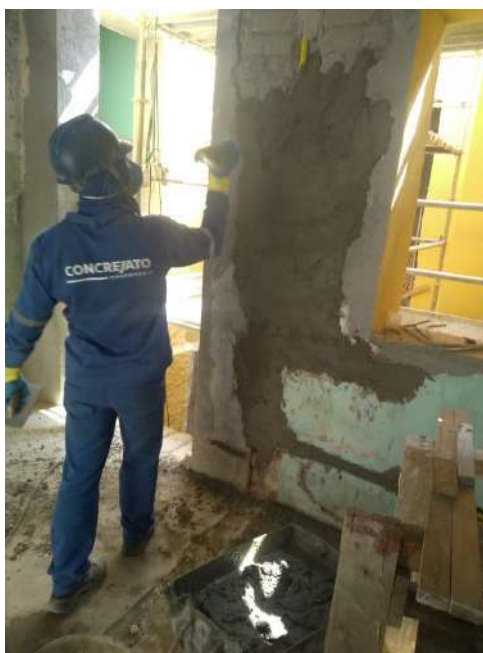
Foto 02 – Chumbamento da tubulação de eletrica nas paredes internas – Casa 07
