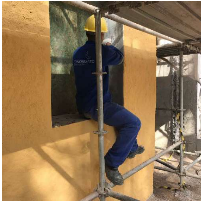
Foto 13 – Decapagem dos batentes – Casa 07
