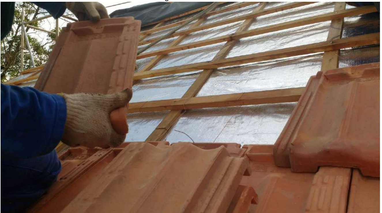
Foto 04- Amarração das telhas
