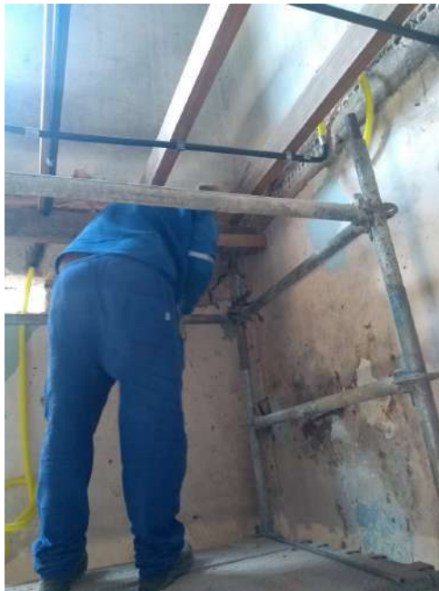
Foto 21 – Escoramento da alvenaria existente – Casa 07
