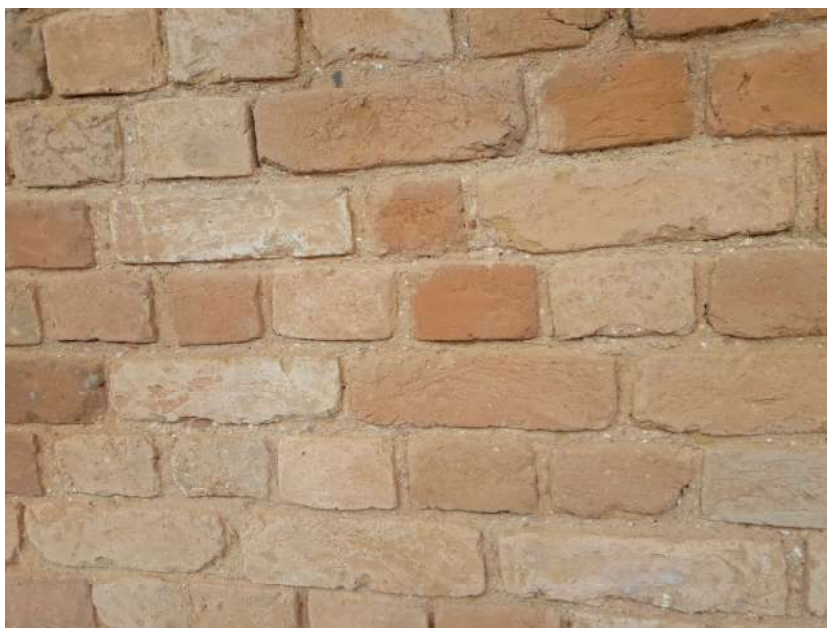
Foto 15 – Limpeza dos tijolos aparentes da fachada
