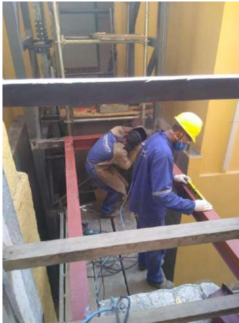
Foto 01 – Instalação do guarda corpo metálico
