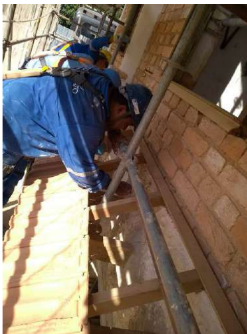
Foto 07 Preparação para pintura da fachada– Casa 07
