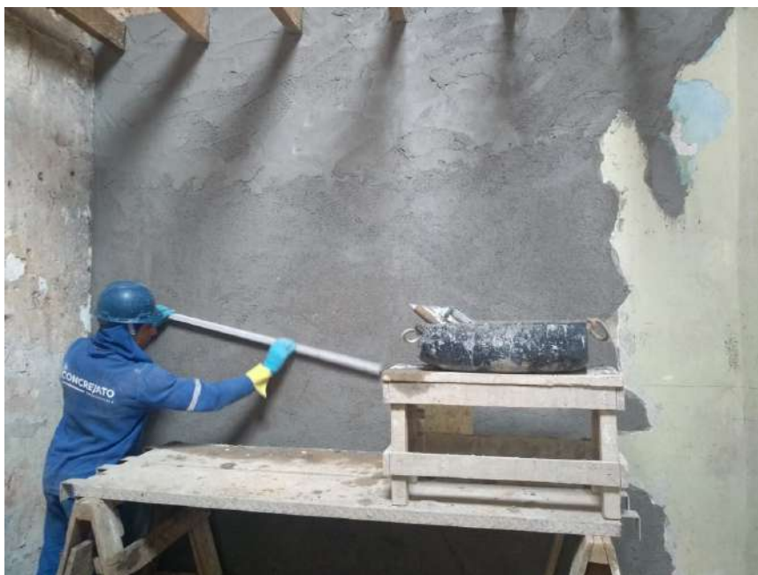
Foto 09 Execução do emboço das paredes internas – Casa 07
