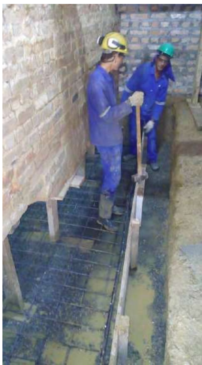
Foto 07 – Instalação da armação – Casa 07
