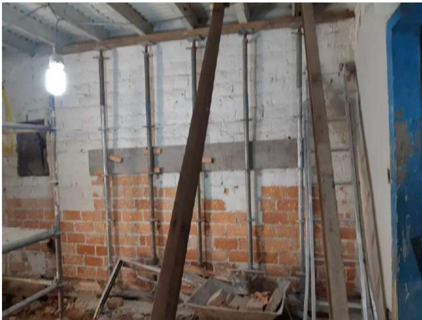
Foto 22 – Escoramento do forro e da alvenaria existente
