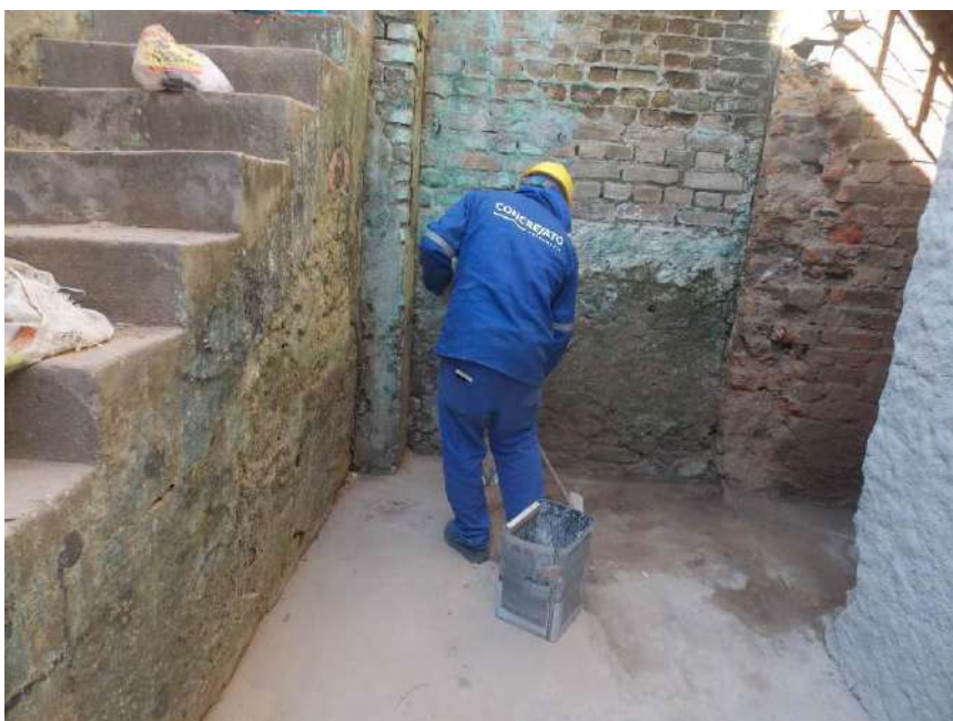
Foto 02 – Execução da limpeza fina – Casa 07
