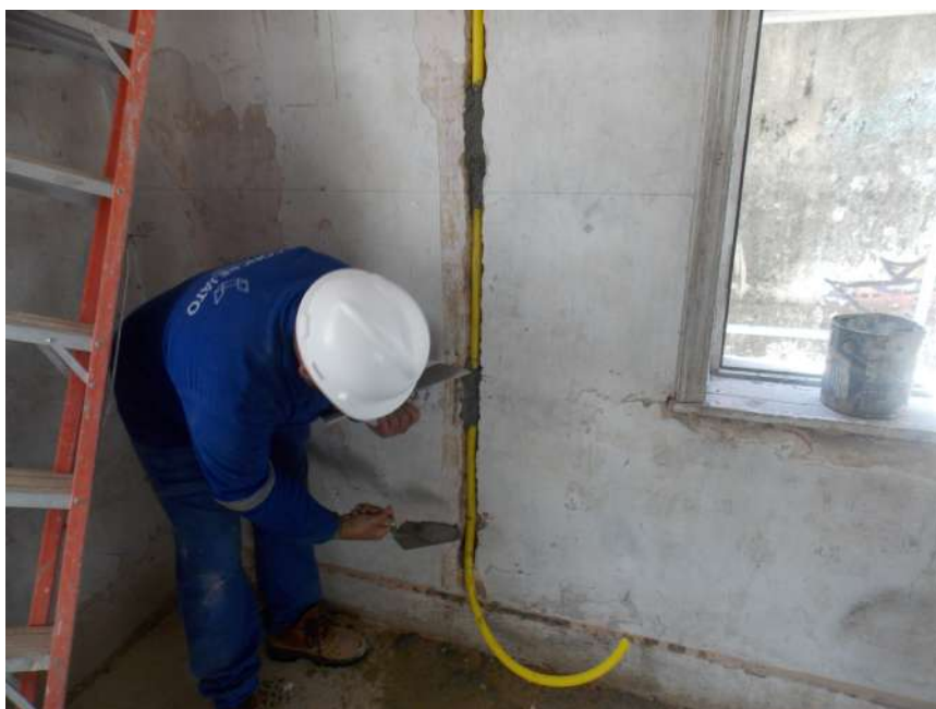
Foto 04 – Instalação dos conduites – Casa 07
