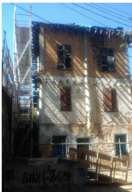
Foto 08: Montagem do andaime – casa 07
