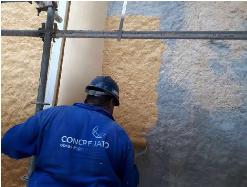
Foto 37 – Pintura mineral da fachada lateral
