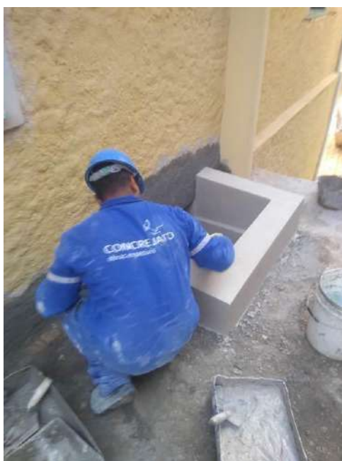
Foto 14 - Execução da argamassa de acabamento das clarabóia
