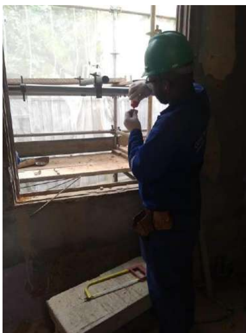
Foto 24 – Recuperação do batente de madeira existente
