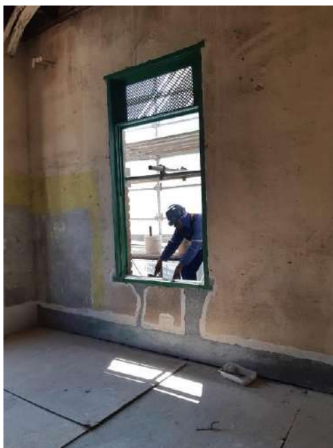
Foto 25 – Execução de acabamento nas esquadrias
