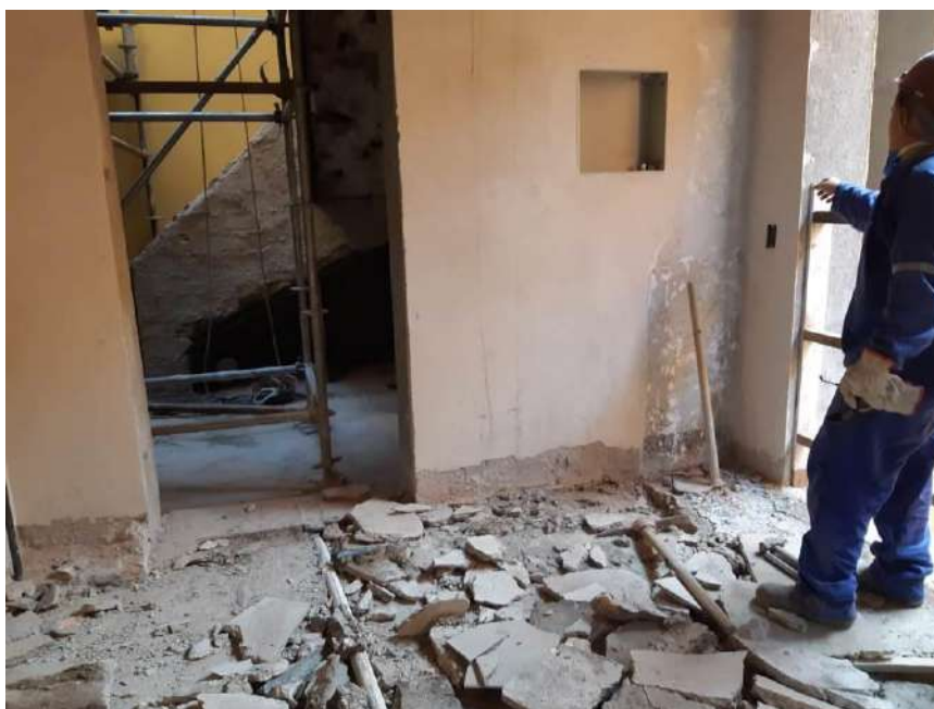
Foto 09 – Demolição manual do piso existente – Casa 07
