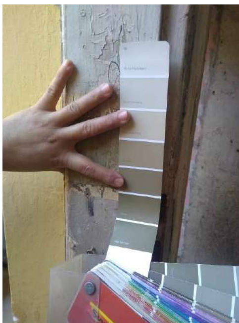
Foto 35 – Prospecção dos batentes de madeira
