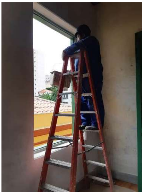
Foto 21 – Pintura lisa dos batentes de madeira
