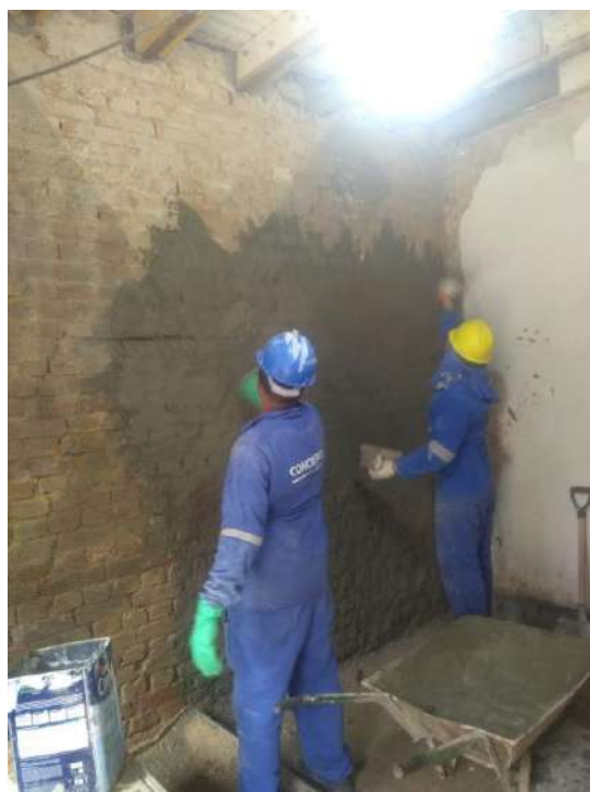
Foto 17 – Tratamento e recuperação da alvenaria existente
