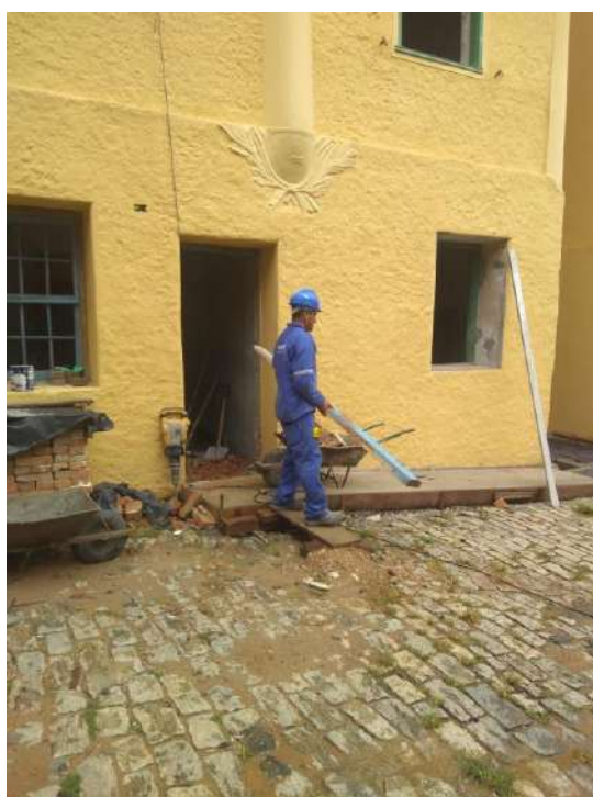
Foto 14 – Remoção do batente de madeira existente
