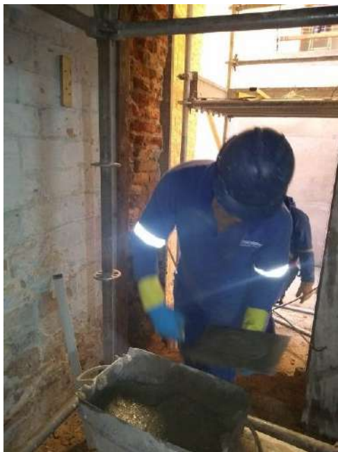
Foto 18 – Abertura da porta conforme orientação do projeto
