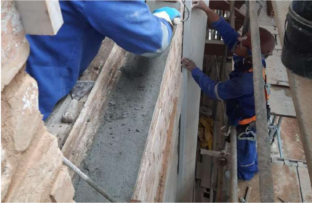
Foto 17 – Instalação das descidas de água e acabamento nos topos das janelas
