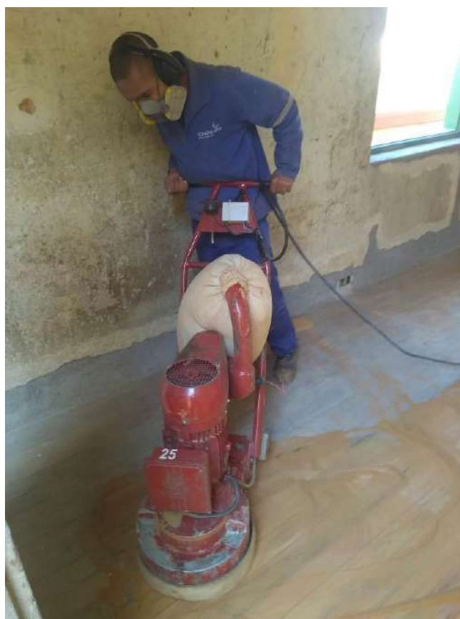
Foto 26 – Lixamento dos assoalhos de madeira
