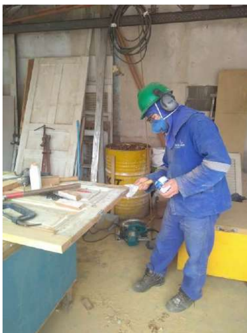
Foto 37 – Restauração das portas de madeira
