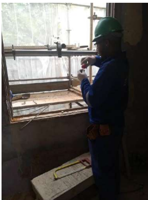
Foto 23 – Recuperação do batente de madeira existente
