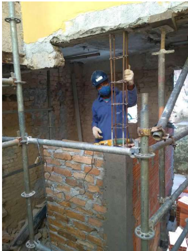
Foto 24 – Elevação da alvenaria
