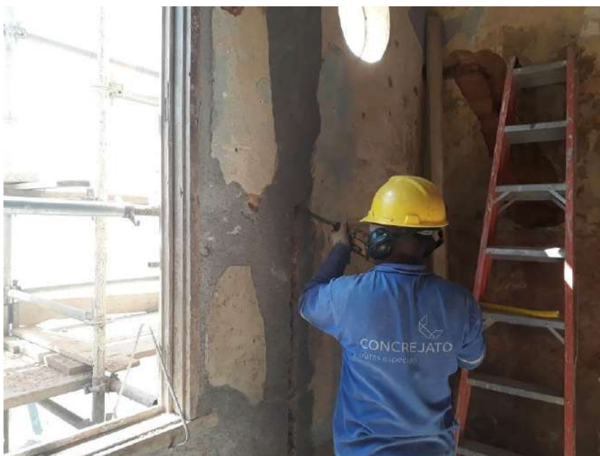
Foto 45 – Abertura dos vãos para passagem de infra de eletrica
