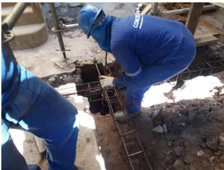
Foto 13 – Instalação da armação da viga baldrame
