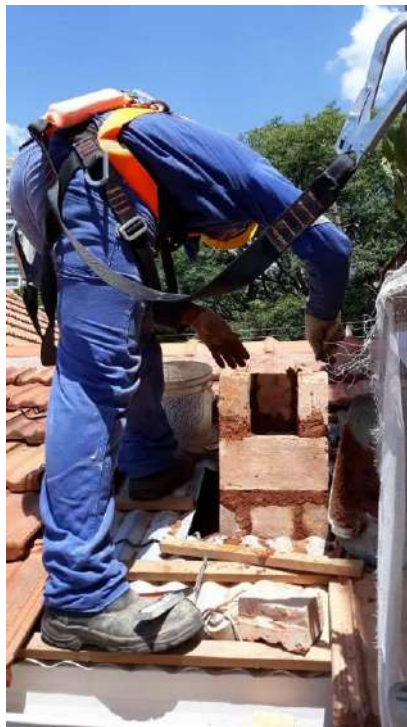
Foto 17 - Execução da chaminé na cobertura
