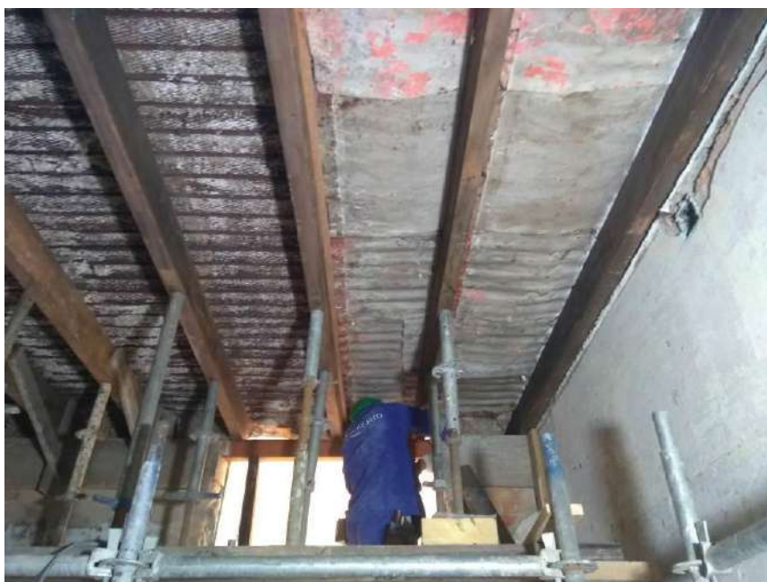
Foto 21 – Instalação de reforço metálico para apoio dos barrotes
