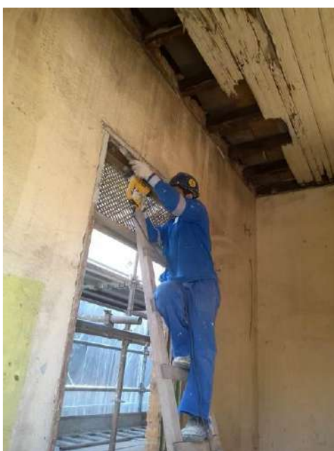
Foto 32– Decapagem dos batentes de madeira
