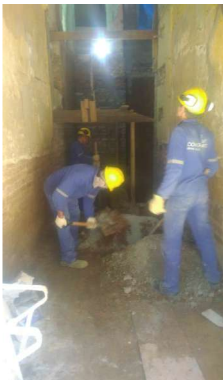
Foto 02- Escavação para reforço estrutural – casa 07
