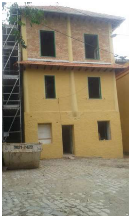
Foto 31– Fachada da casa 7 após desmontagem do andaime – Casa 07
