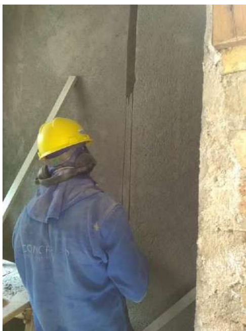
Foto 14 – Demolição manual para passagem dos conduítes
