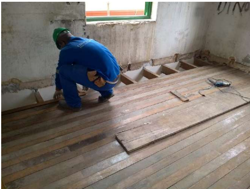
Foto 06 – Instalação dos assoalhos de madeira
