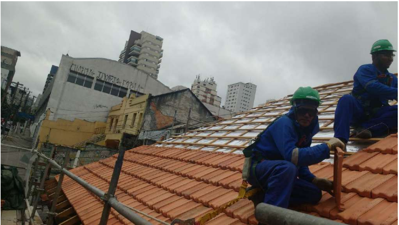
Foto 17- Instalação das telhas
