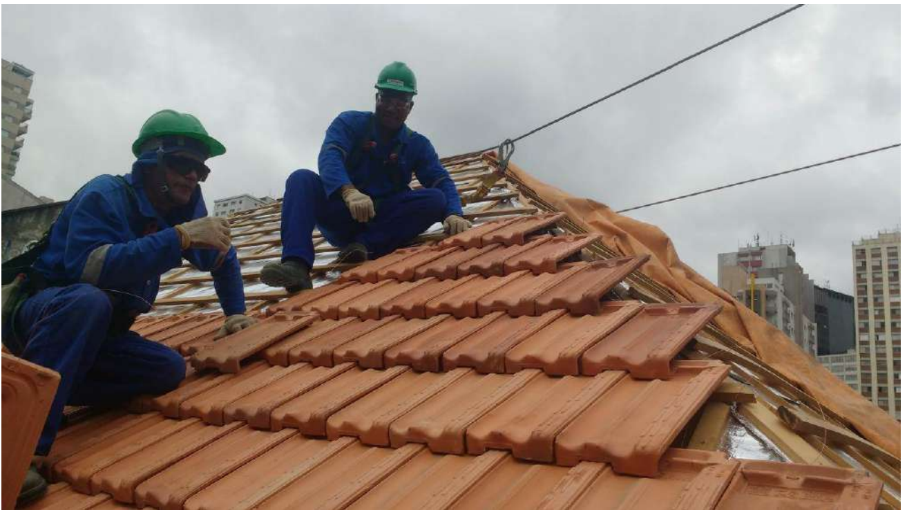
Foto 18- Instalação das telhas
