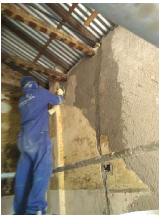
Foto 08 – Execução do emboço das paredes internas
