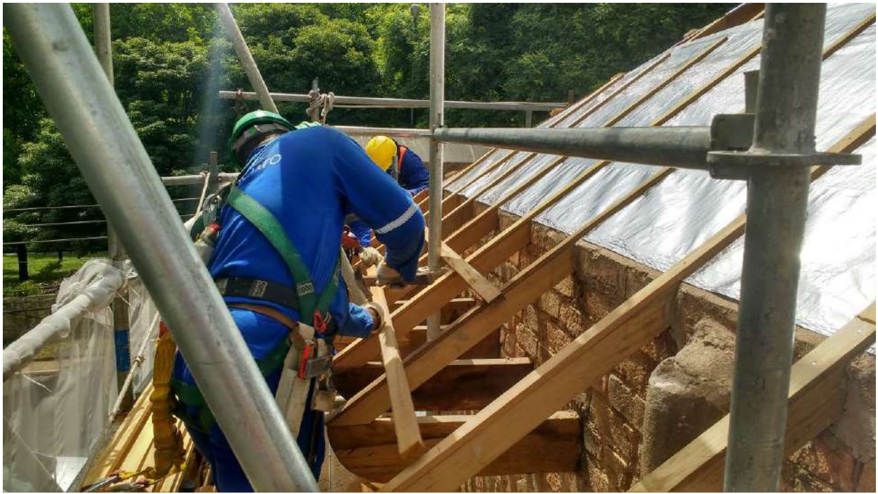
Foto 23- Instalação das manta de alumínio
