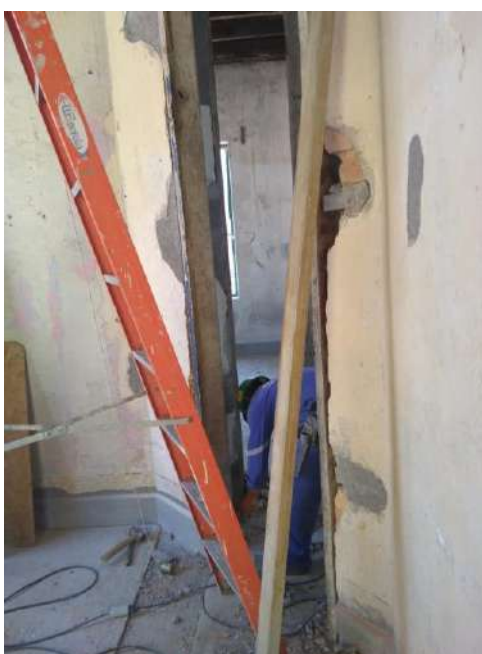
Foto 17 – Instalação do batente de madeira
