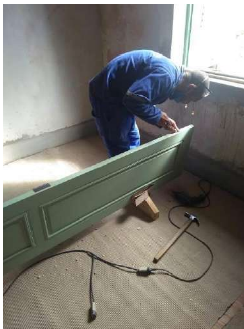
Foto 19 – Instalação das portas de madeira
