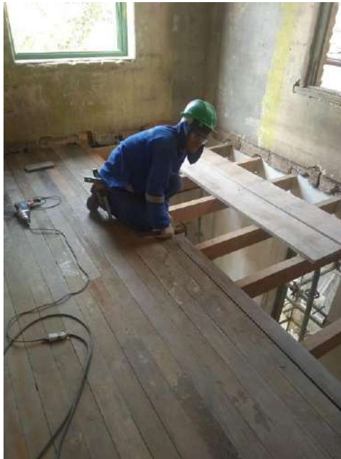
Foto 01 – Instalação dos assoalhos de madeira – Casa 07
