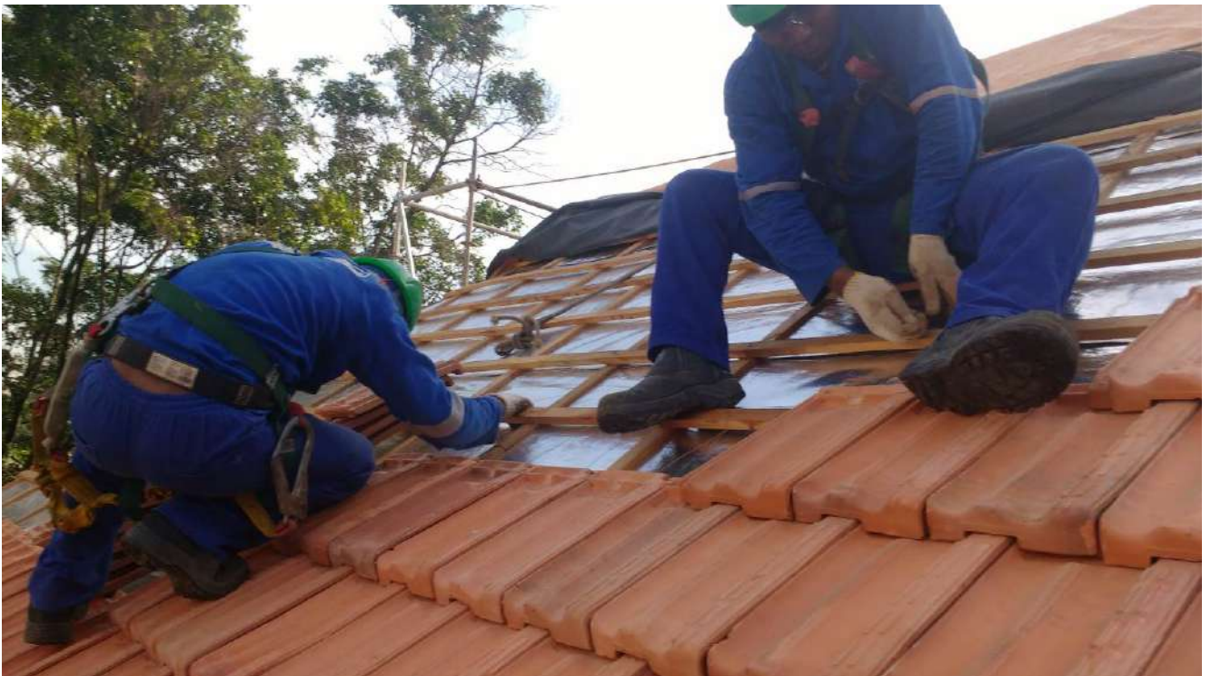
Foto 06- Amarração das telhas
