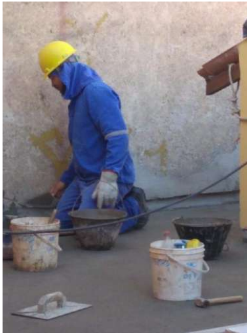
Foto 18 – Impermeabilização da cobertura
