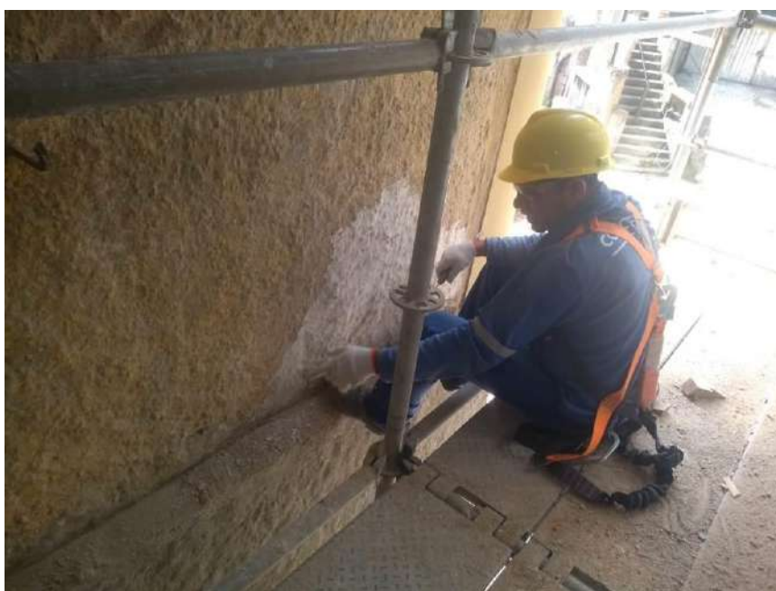
Foto 16 – Decapagem da fachada lateral
