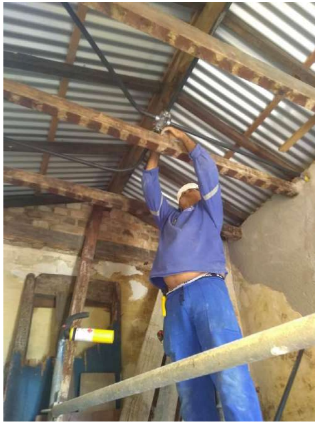
Foto 01 –Execução de infra para elétrica
