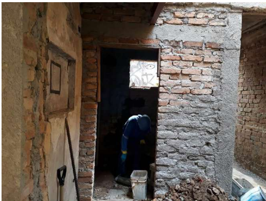
Foto 07 – Execução do emboço das paredes internas
