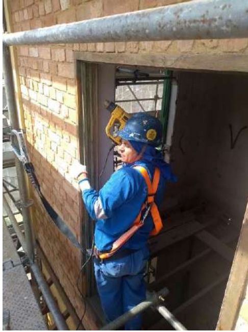
Foto 21 – Decapagem mecânica dos batentes de madeira
