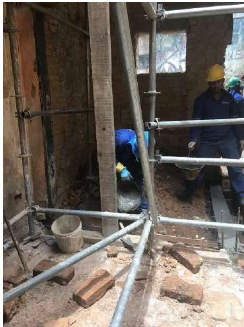
Foto 17 – Concretagem da viga baldrame
