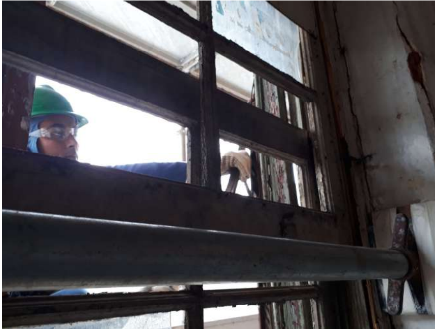
Foto 05 – Remoção das janelas – Casa 07
