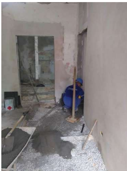
Foto 07 – Execução do piso cimentado
