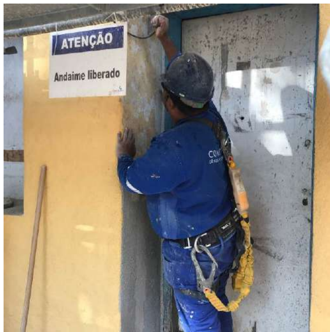
Foto 14 – Decapagem da alvenaria – Casa 07
