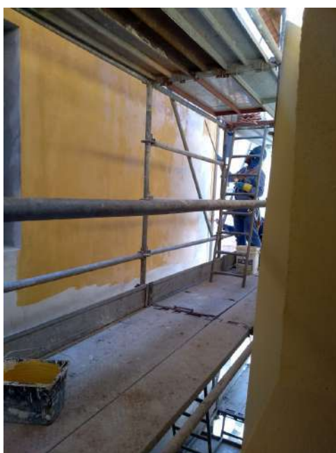
Foto 14 – Pintura lisa da fachada lateral – Casa 07
