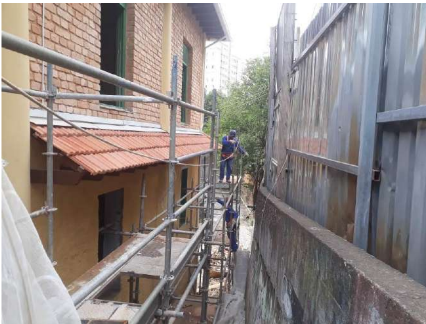
Foto 52 – Desmontagem do andaime da fachada lateral
