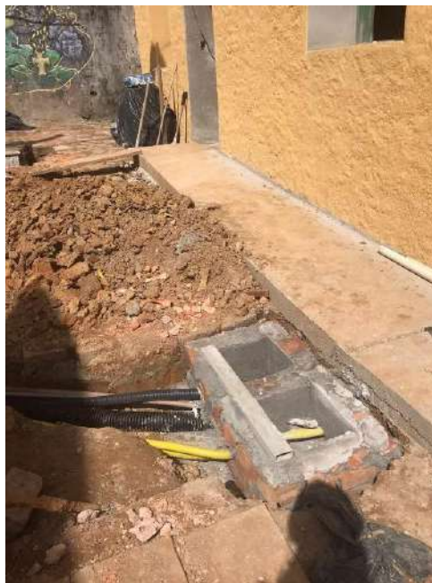
Foto 12 - Elevação da alvenaria para execução das caixas coletoras
