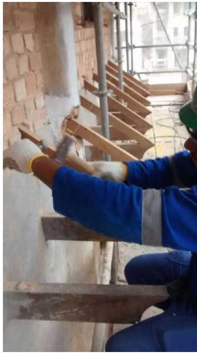
Foto 07 – Instalação dos caibros – Casa 07
