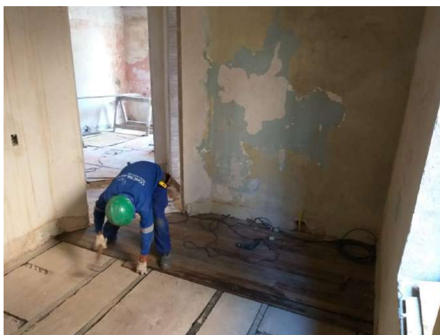
Foto 16 – Instalação dos assoalhos de madeira
