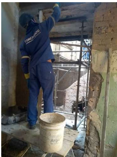
Foto 09 – Execução do emboço das paredes internas
