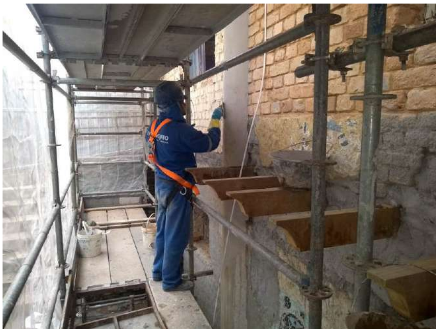
Foto 03 – Execução da argamassa de acabamento da pilastra da fachada
