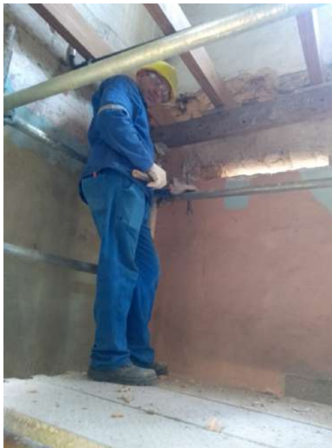
Foto 22 – Escoramento para reforços – Casa 07
