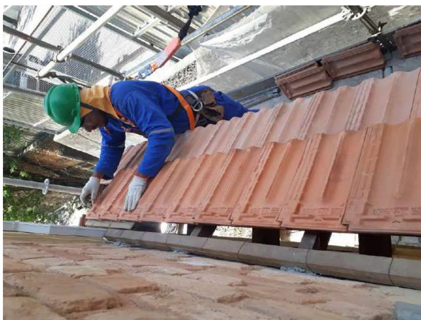
Foto 08 – Instalação das telhas francesas da cobertura da fachada lateral
