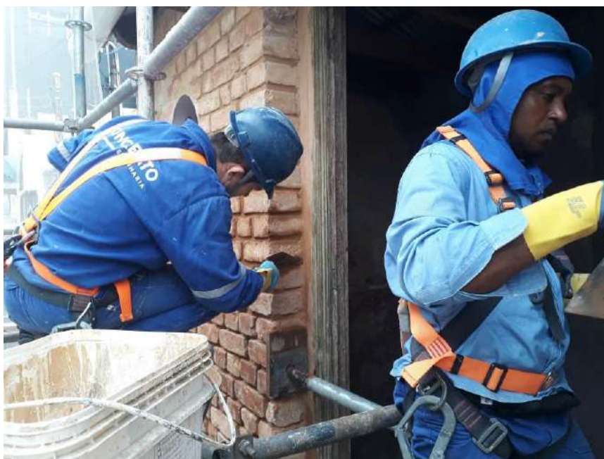
Foto 29 – Restauração dos tijolos existentes da fachada lateral
