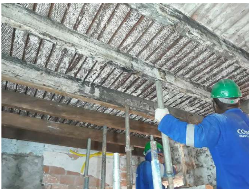
Foto 20 – Substituição dos barrotes de madeira
