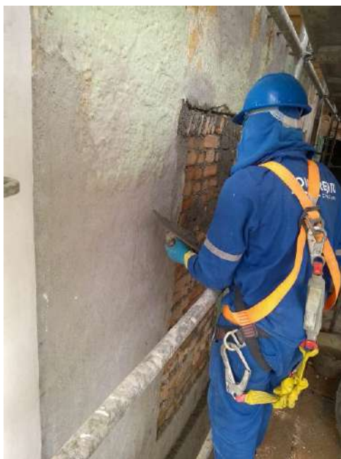
Foto 01 – Fechamento dos vãos da fachada seguindo as orientações do projeto – Casa 07
