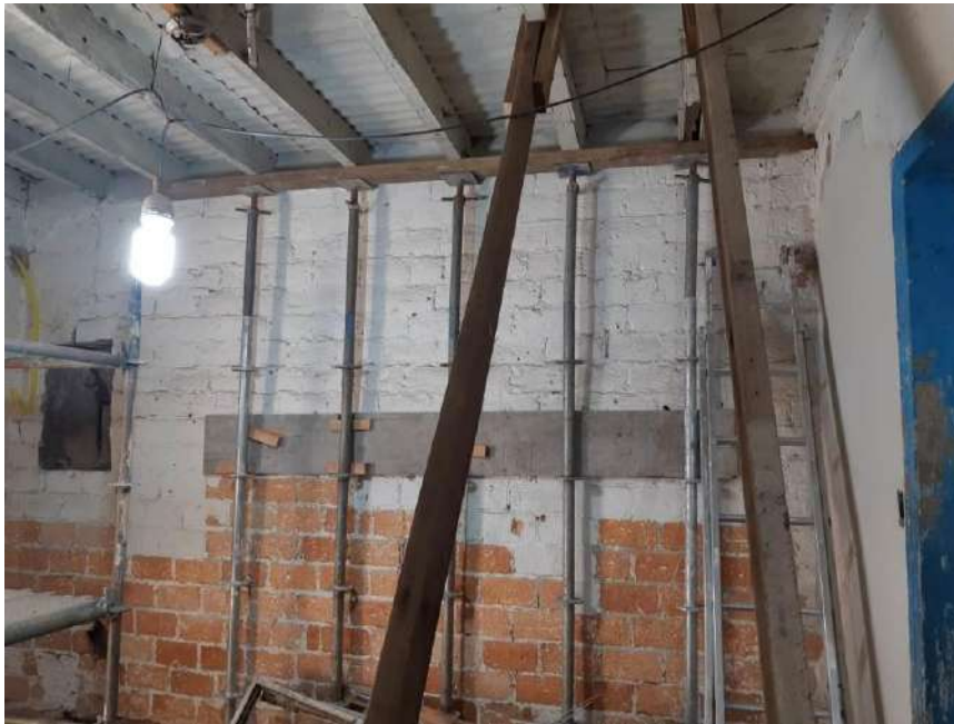
Foto 21 – Escoramento do forro e da alvenaria existente
