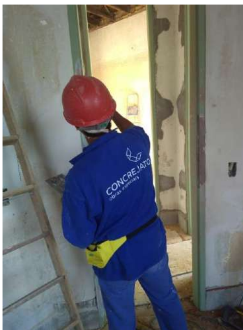
Foto 23 - Aplicação de massa para madeira nos batentes
