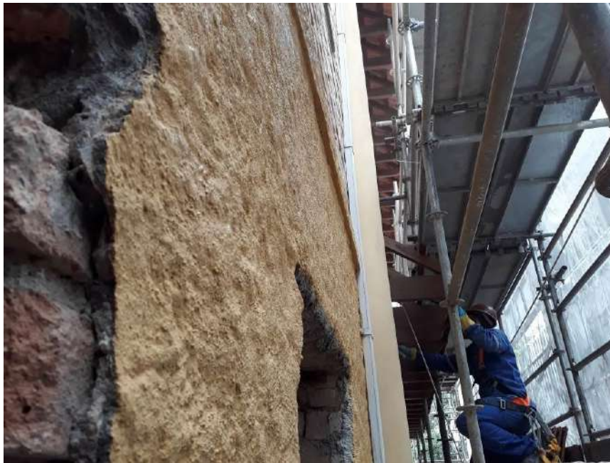
Foto 38 – Pintura mineral da fachada lateral
