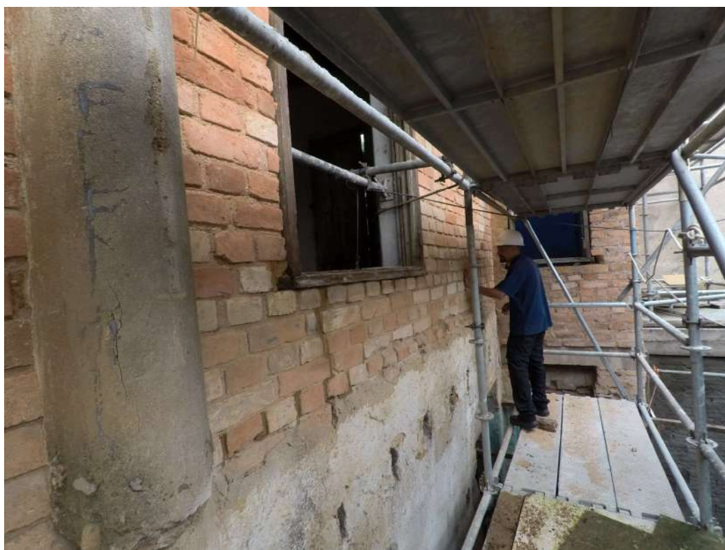
Foto 16 – Limpeza dos tijolos aparentes da fachada
