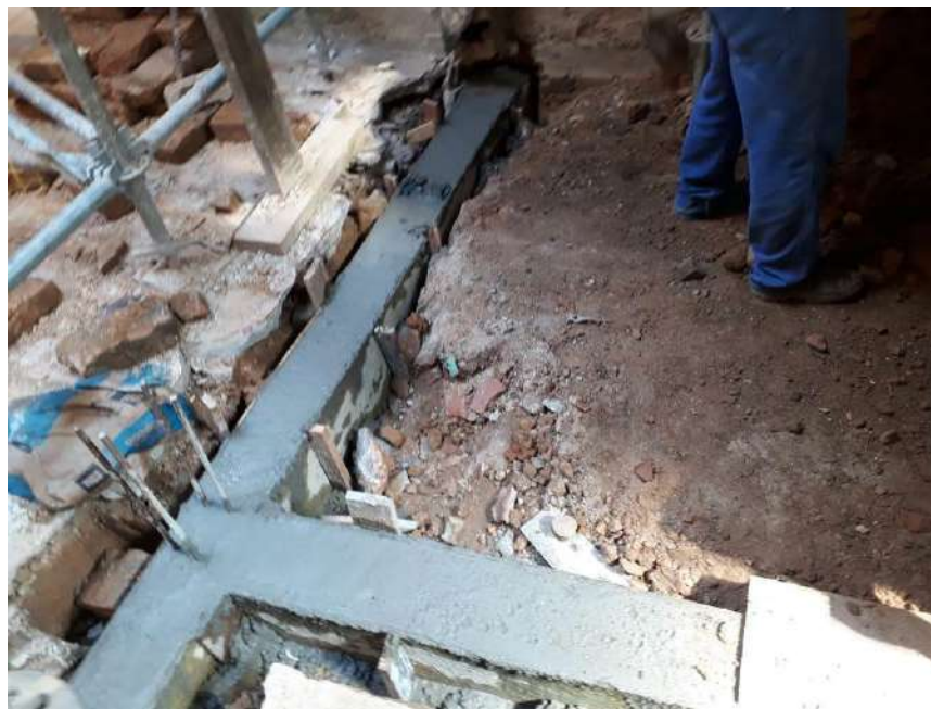
Foto 18 – Viga baldrame concretada
