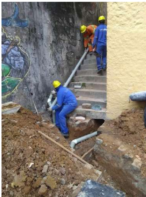
Foto 18 – Instalação das tubulações
