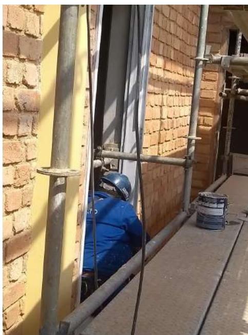
Foto 18 – Aplicação de massa para madeira nos batentes existentes – Casa 07
