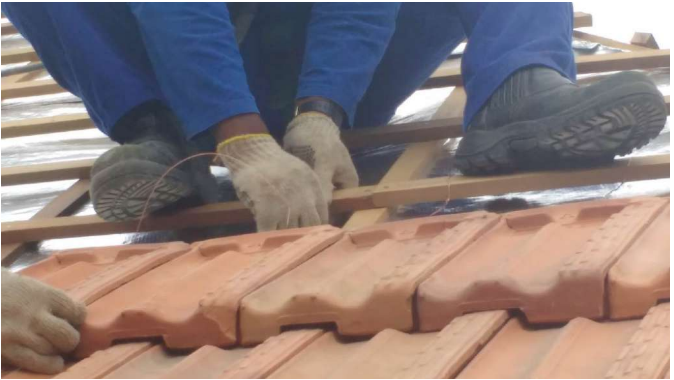
Foto 13- Instalação das telhas
