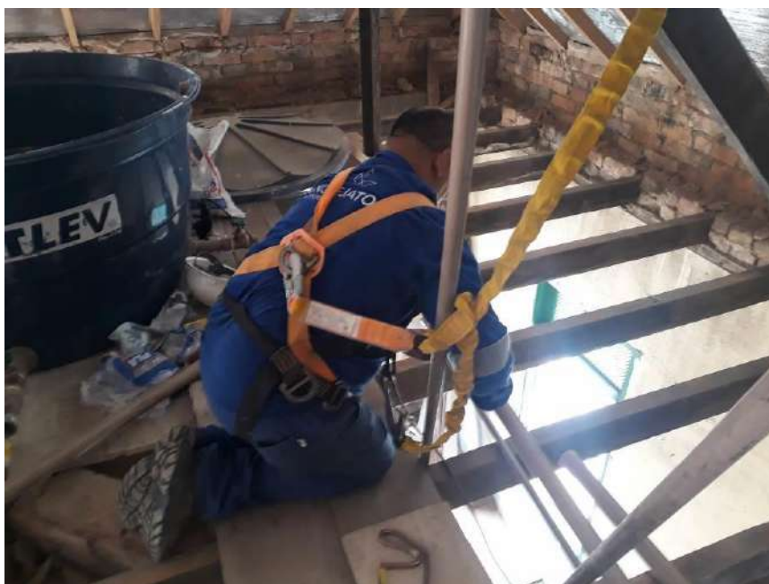
Foto 53 – Instalação da caixa de água
