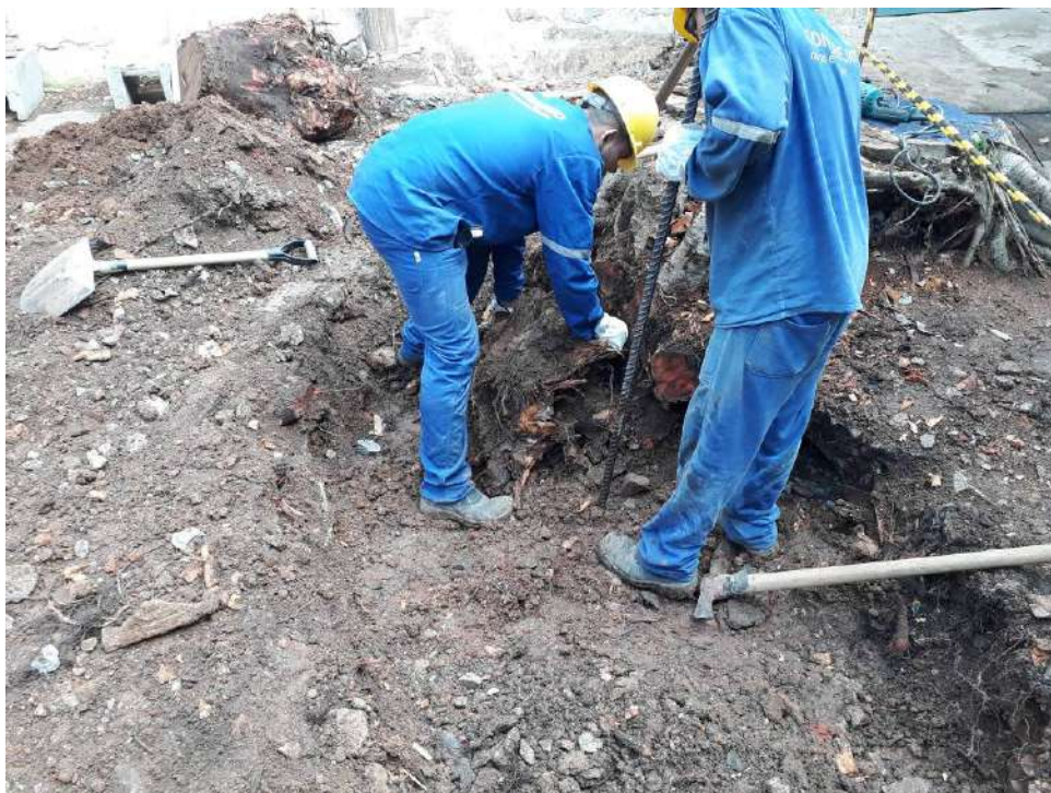
Foto 13 – Remoção das raízes das árvores
