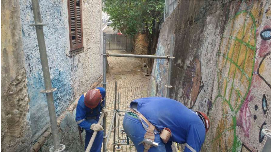
Foto 01 – Montagem do andaime – Casa 07
