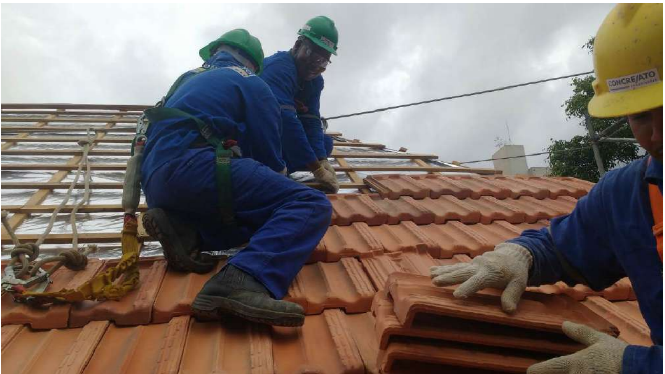
Foto 14- Instalação das telhas
