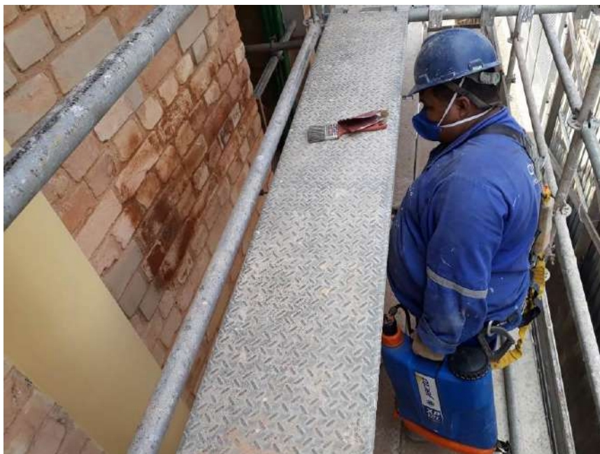
Foto 43 – Aplicação de hidrofugante na fachada lateral
