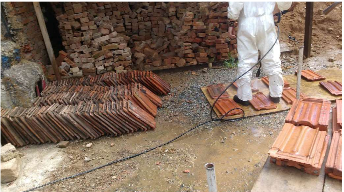
Foto 02- Lavagem das telhas existentes
