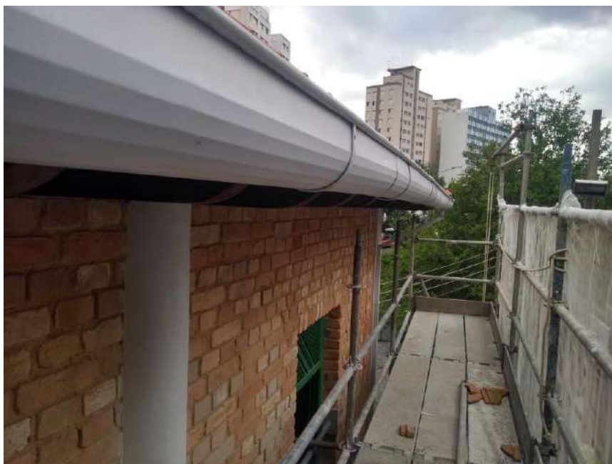
Foto 27 – Instalação das calhas na cobertura
