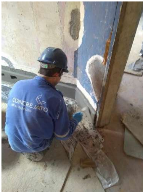
Foto 06 – Execução do rodapé
