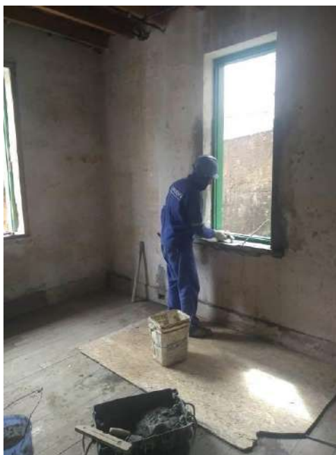
Foto 04 – Execução da argamassa de acabamento do peitoril das janelas
