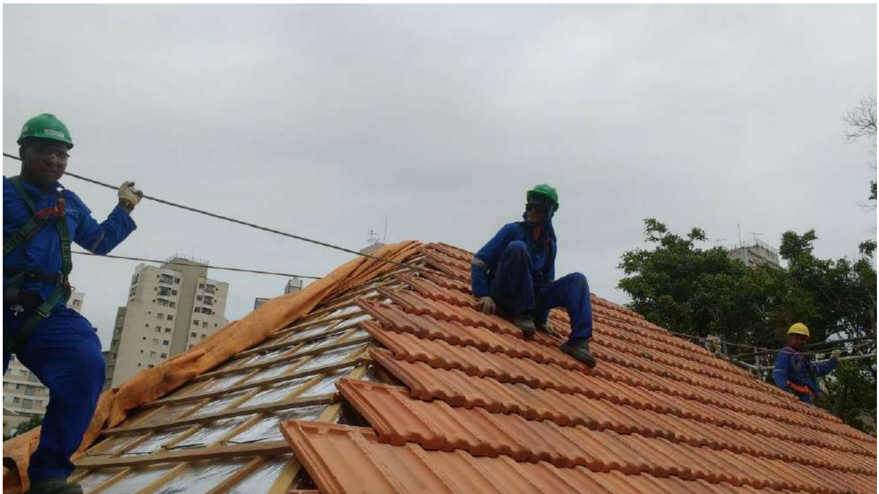
Foto 12- Instalação das telhas
