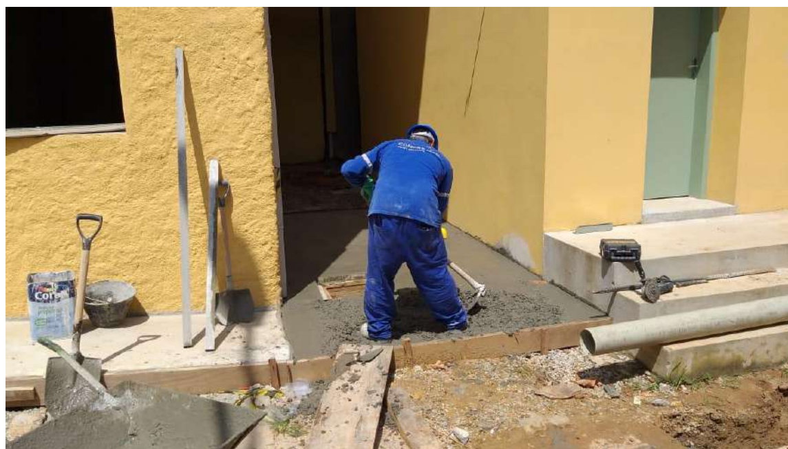
Foto 20 – Execução da concretagem
