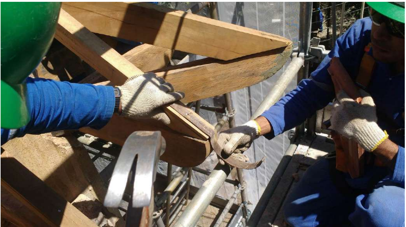
Foto 26- Instalação de suporte
