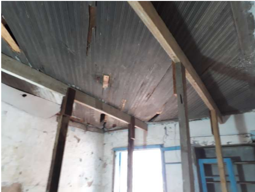
Foto 04 – escoramento do forro de madeira – Casa 07
