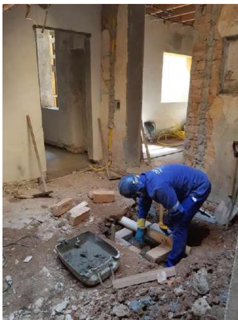
FOTO 01 – EXECUÇÃO DA CAIXA COLETORA
