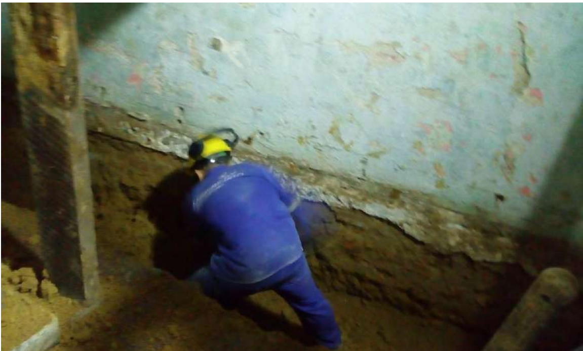
Foto 04 – escavação manual – Casa 07
