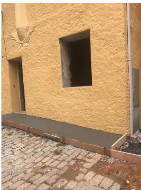
Foto 12 – Execução da concretagem da rampa
