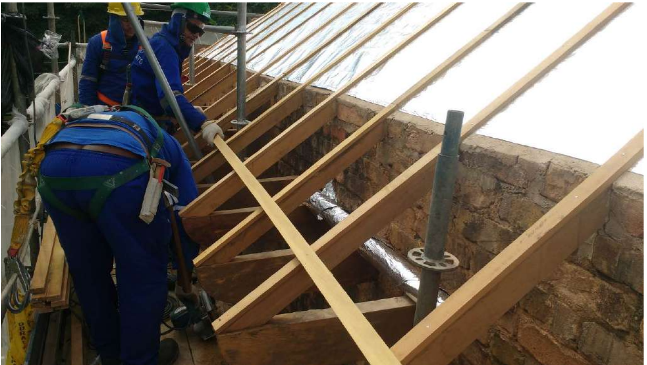
Foto 19- Instalação de ripa e contraripa
