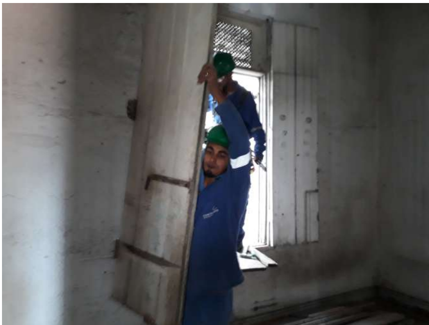
Foto 06 – Remoção das janelas – Casa 07
