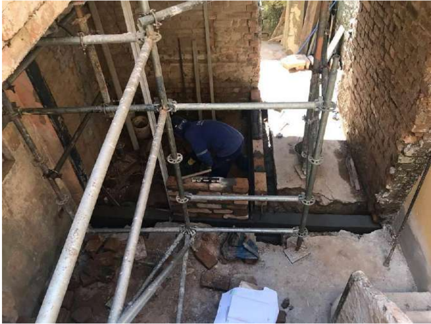
Foto 23 – Elevação da alvenaria
