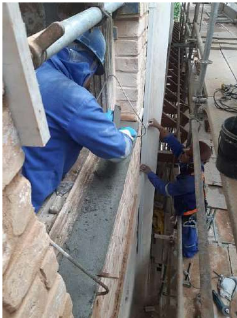
Foto 18 – Instalação das descidas de água e acabamento nos topos das janelas
