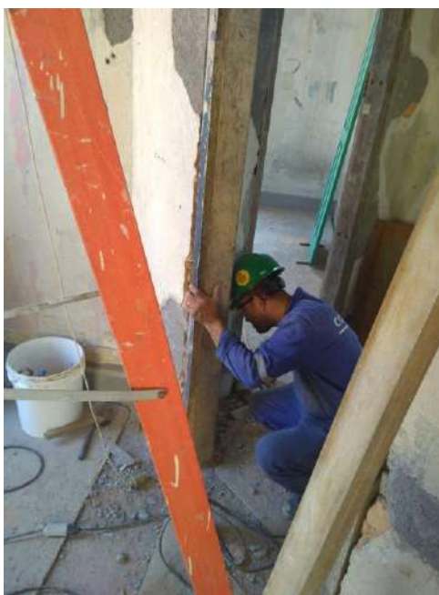
Foto 16 – Instalação do batente de madeira
