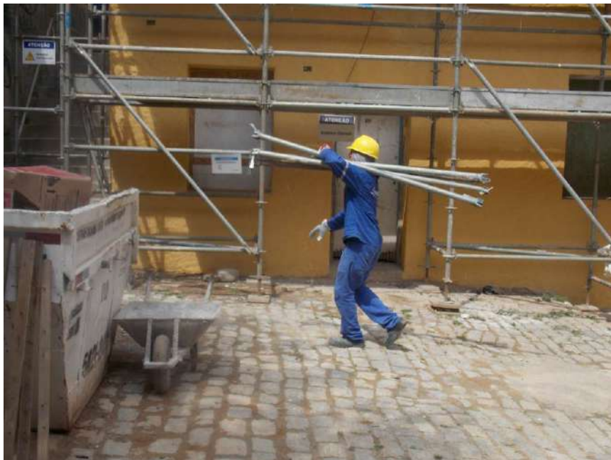
Foto 08 – Desmontagem do andaime fachadeiro
