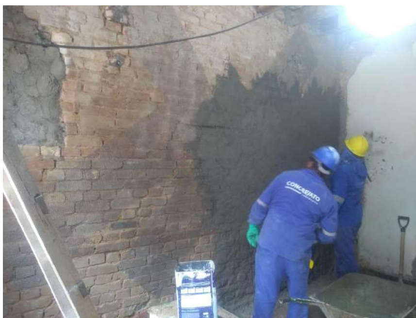
Foto 18 - Tratamento e recuperação da alvenaria existente
