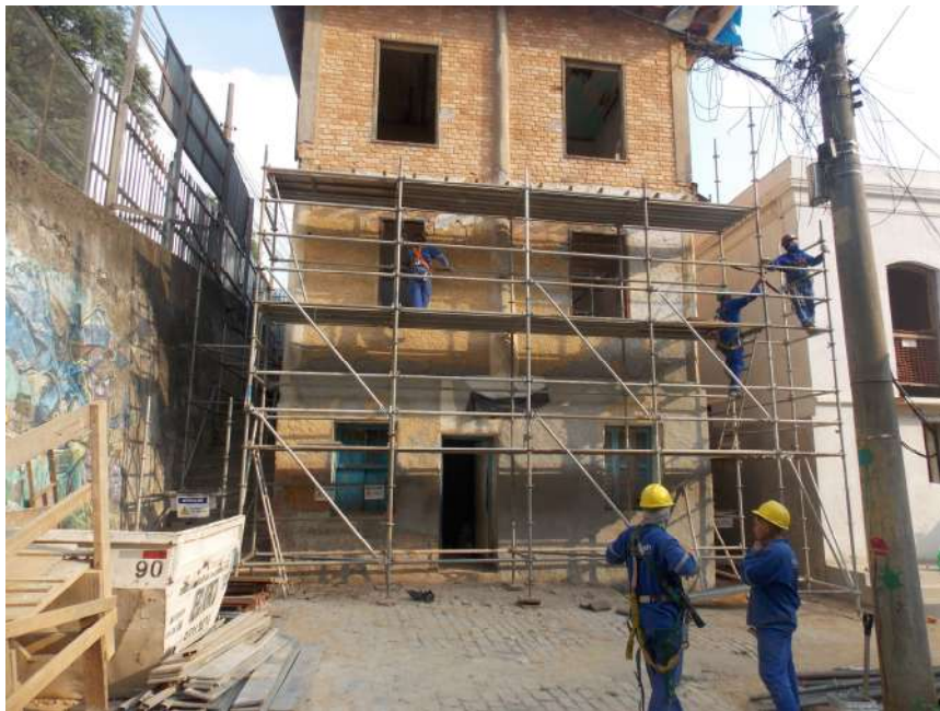
Foto 02 – Remontagem do andaime –Seguindo solicitação do ministério do trabalho
