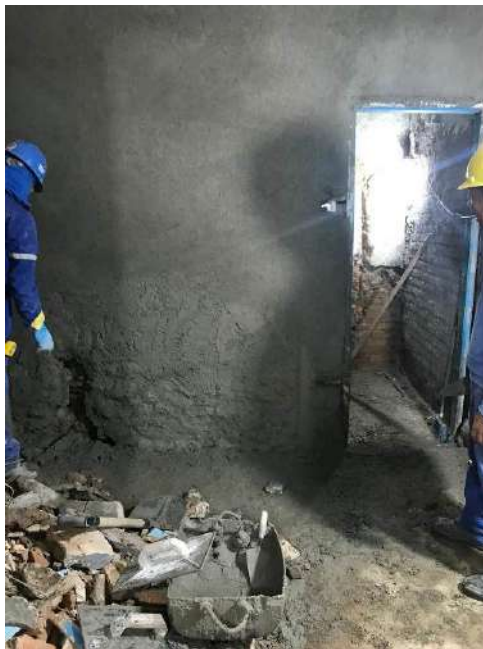
Foto 12 – Execução do emboço das paredes internas – térreo
