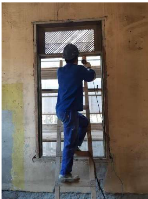
Foto 33 – Decapagem dos batentes de madeira
