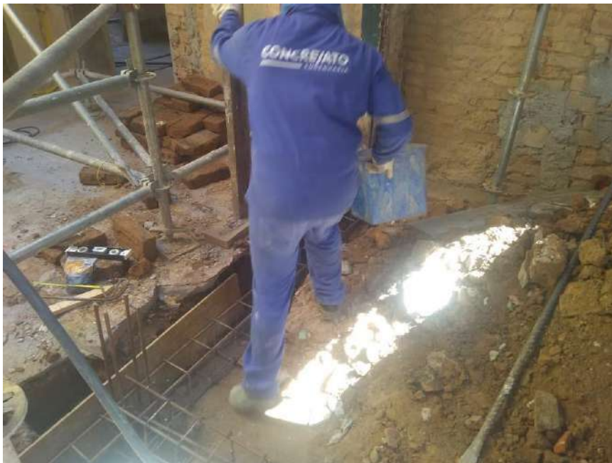
Foto 16 – Instalação da forma para concretagem
