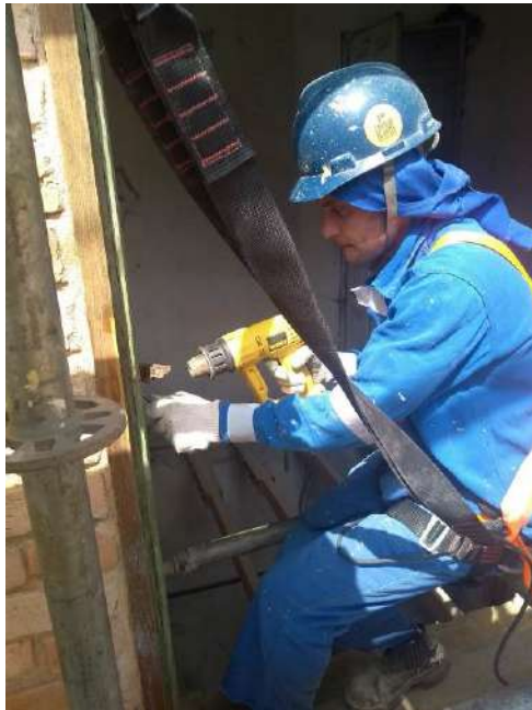
Foto 22 – Decapagem mecânica dos batentes de madeira
