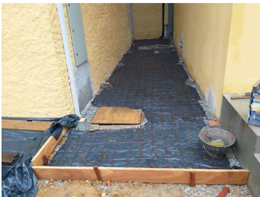
Foto 14 – Armação e forma para execução da concretagem
