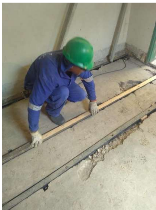
Foto 15 – Instalação do assoalho de madeira
