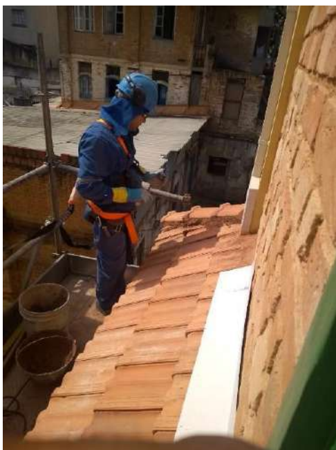
Foto 05 – Instalação da cumeeira da cobertura lateral – Casa 07
