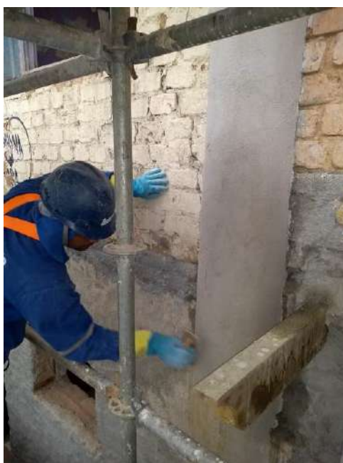
Foto 04 – Execução da argamassa de acabamento da pilastra da fachada
