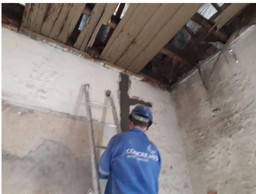
Foto 50 – Fechamento das aberturas feitas para instalação da tubulação
