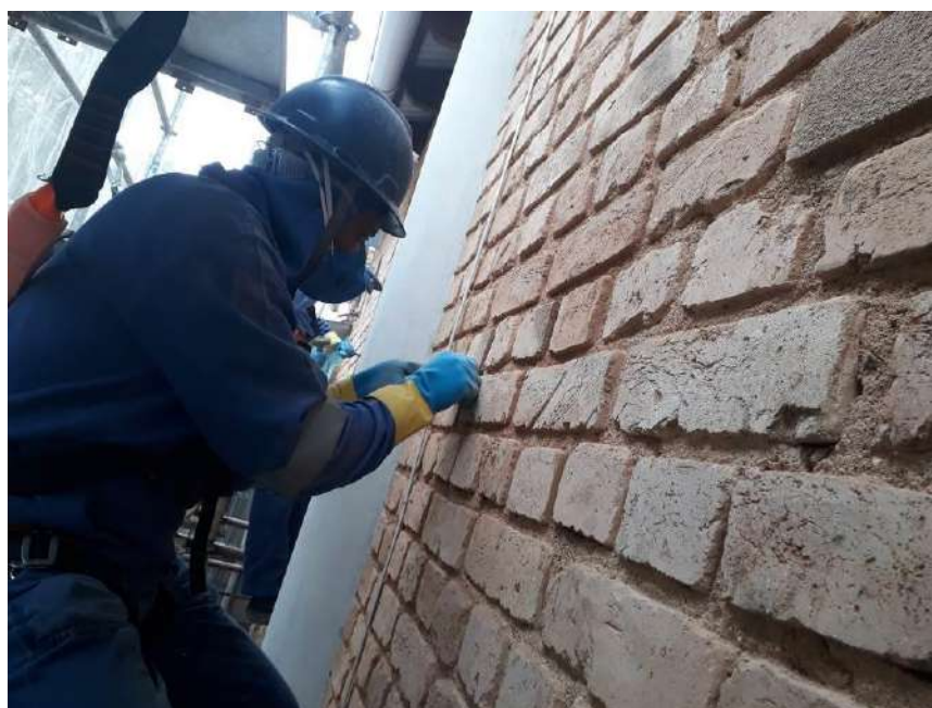
Foto 30 – Restauração dos tijolos existente da fachada lateral
