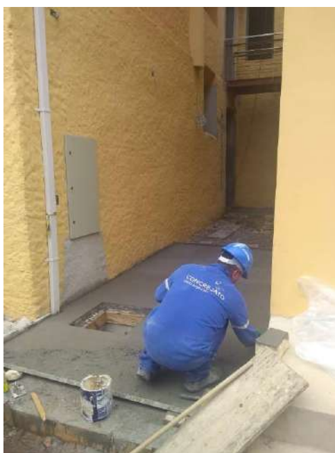
Foto 02 - Execução do piso cimentado área externa
