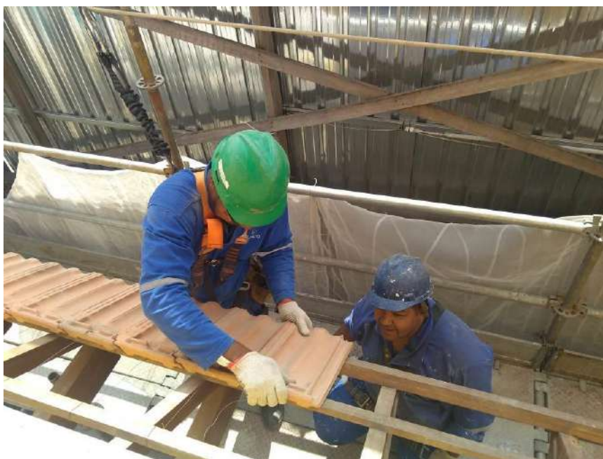
Foto 07 – Instalação das telhas francesas na cobertura da fachada lateral
