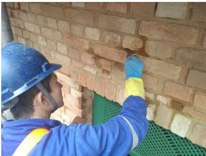
Foto 29 – Restauração dos tijolos existentes da fachada lateral
