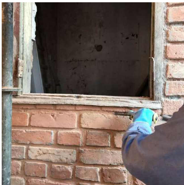
Foto 03 – Substituição da pingadeira de madeira das janelas da fachada – Casa 07
