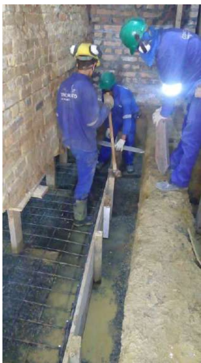
Foto 08 – Instalação da armação – Casa 07
