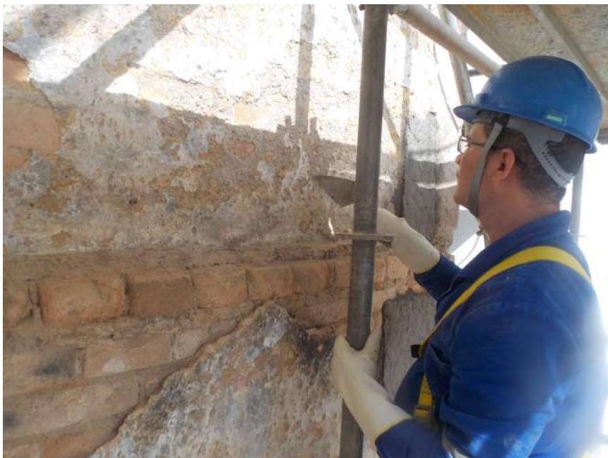
Foto 04 – Remoção cuidadosa da argamassa existente da fachada principal – Casa 07
