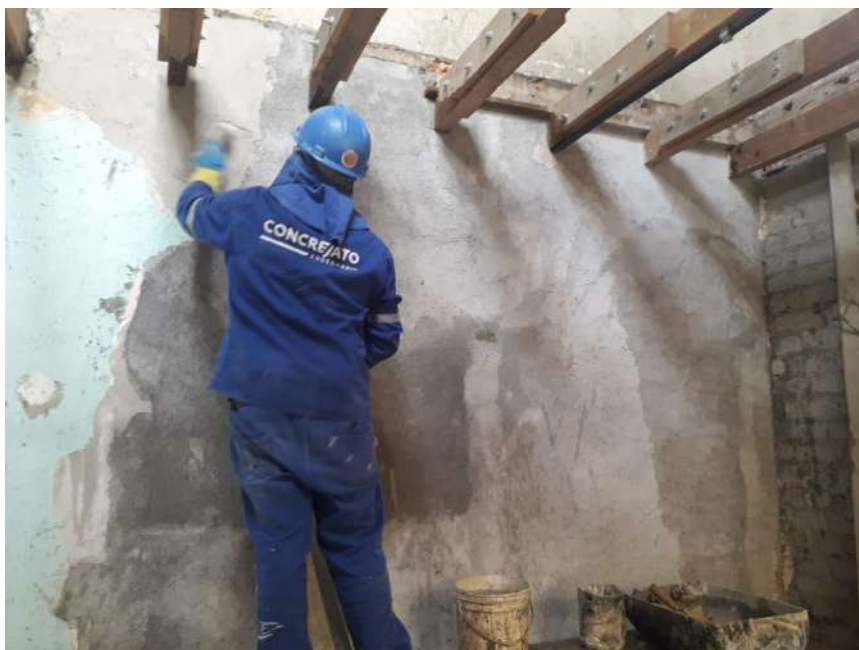
Foto 05 – Execução da argamassa de acabamento das paredes internas – Casa 07
