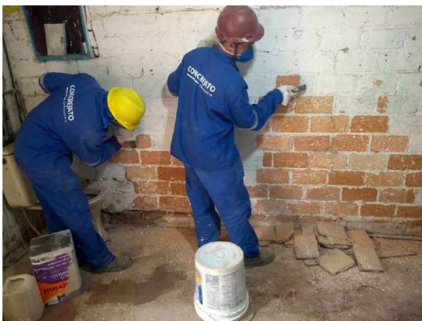
Foto 08 – Decapagem manual das paredes internas – Casa 07
