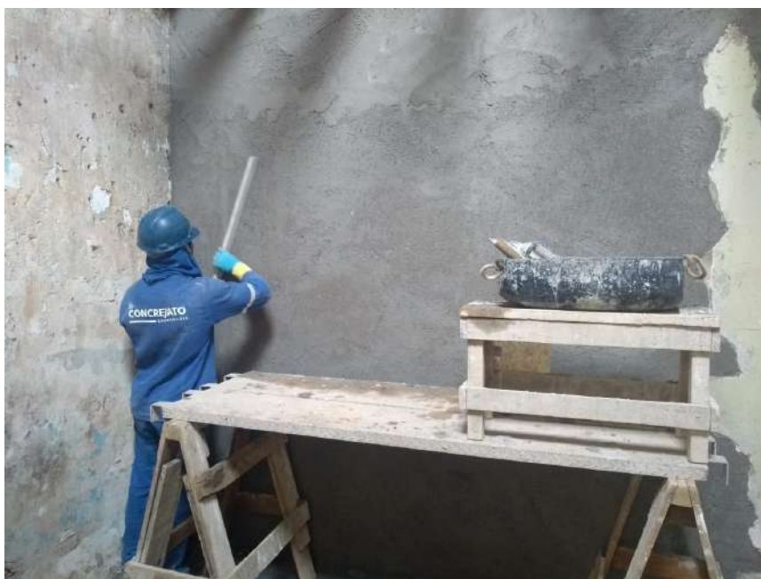
Foto 10 – Execução do emboço das paredes internas – Casa 07
