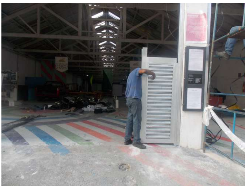
Foto 10 - Instalação do portão metálico do galpão
