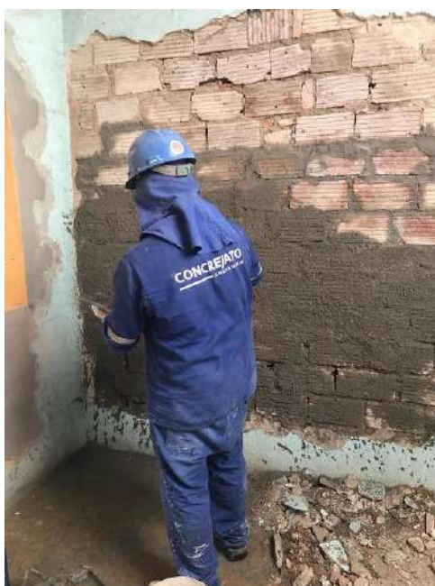
Foto 14 – Execução do chapisco das paredes internas
