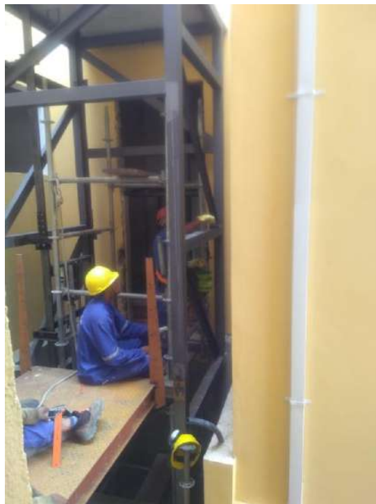
Foto 04 – Execução da pintura lisa da estrutura metálica do elevador
