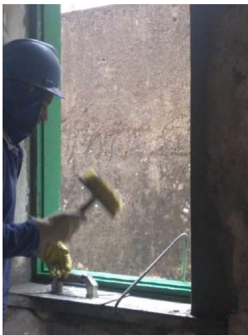
Foto 03 – Execução da argamassa de acabamento do peitoril das janelas
