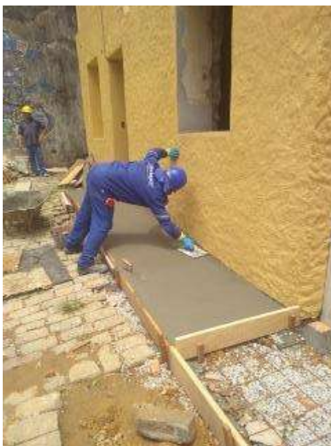
Foto 11 – Execução da concretagem da rampa
