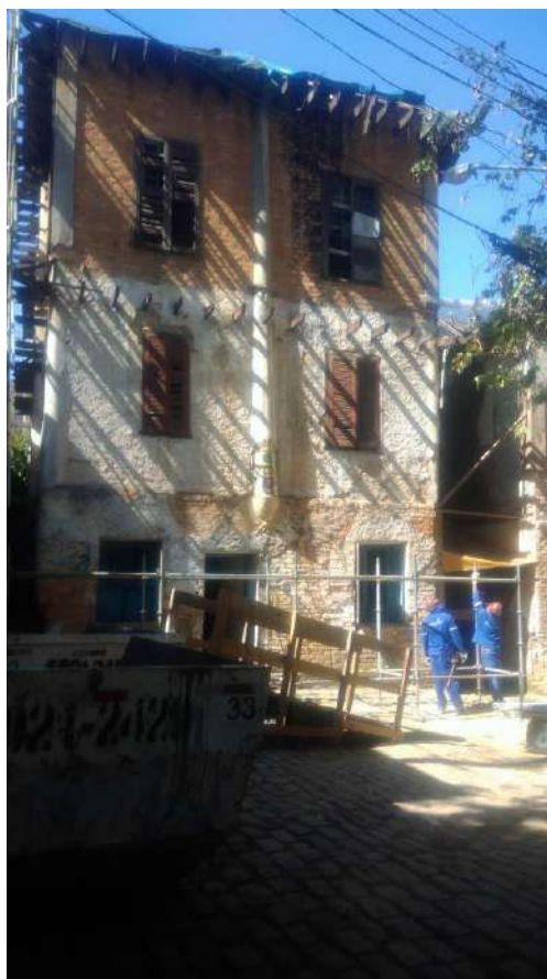
Foto 06- Montagem do andaime – casa 07
