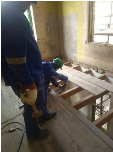
Foto 02 – Instalação dos assoalhos de madeira – Casa 07
