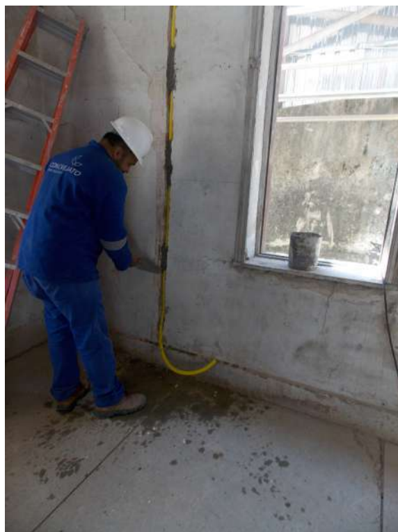
Foto 03 – Instalação dos conduites – Casa 07
