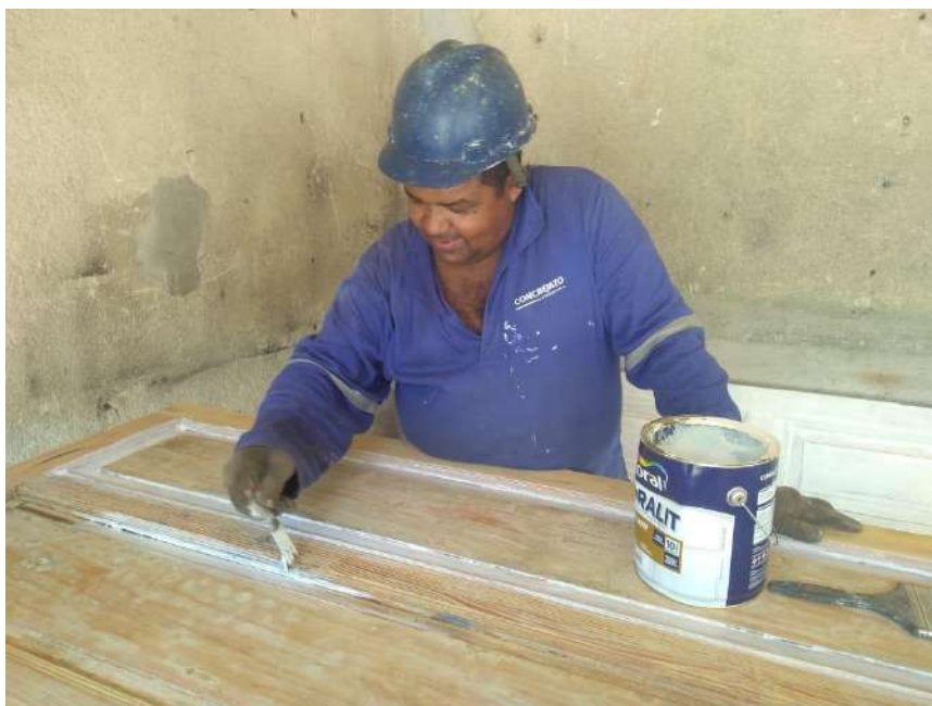
Foto 01 – Aplicação de massa de madeira nas portas
