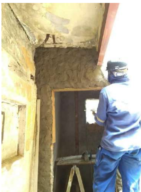
Foto 09 – Execução do emboço das paredes externas
