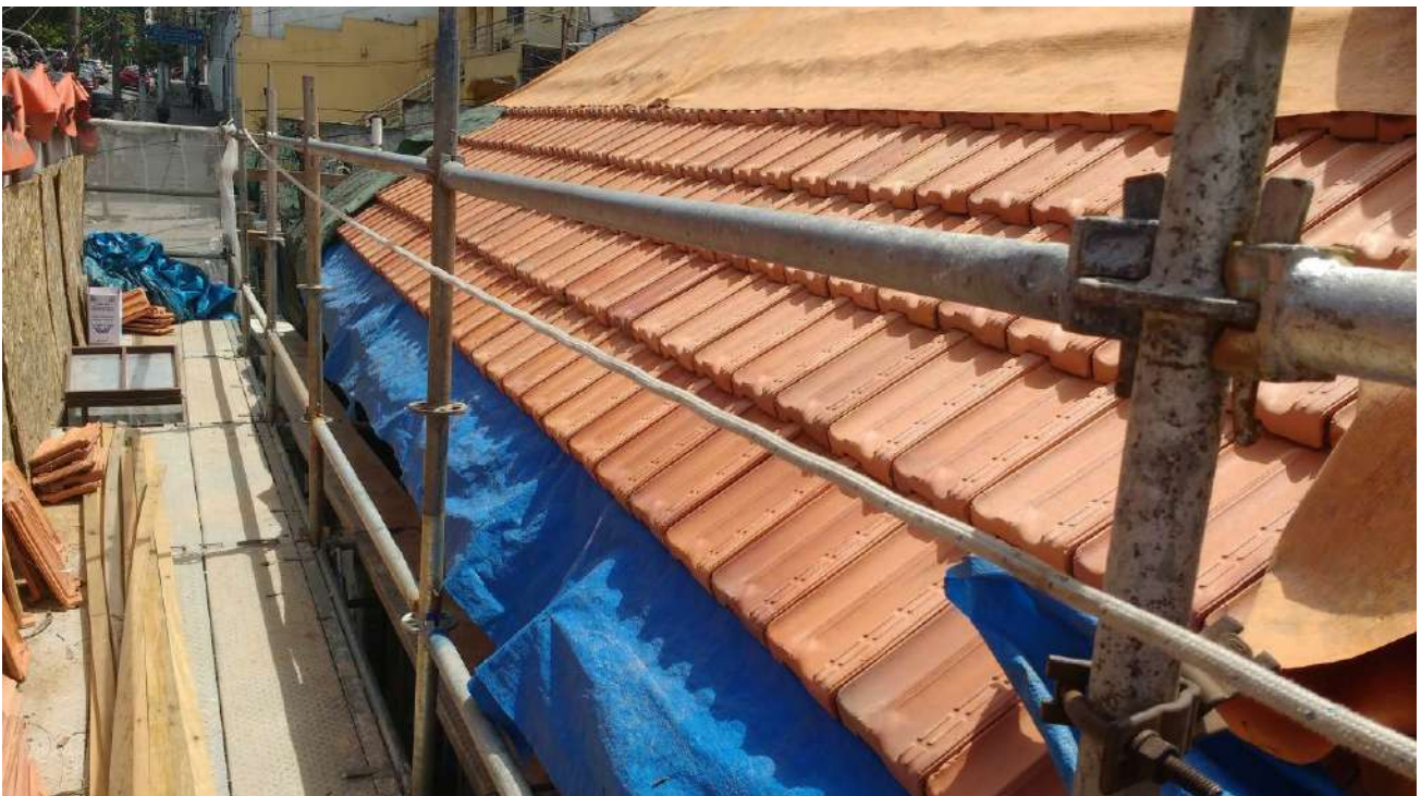
Foto 08- Instalação das telhas
