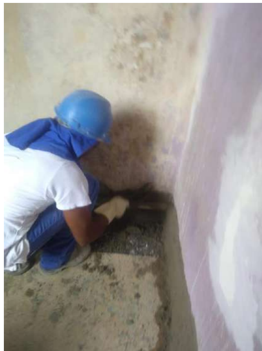
Foto 12 – Execução do rodapé
