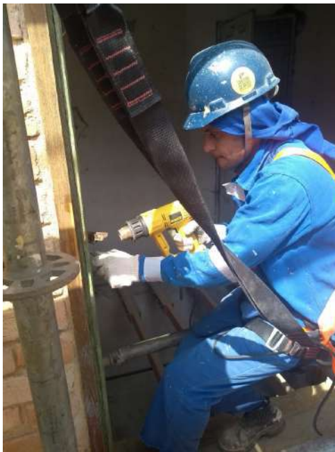
Foto 16 – Decapagem dos batentes de madeira existentes – Casa 07
