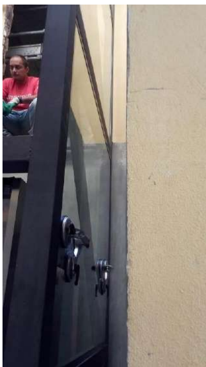
Foto 16 - Instalação dos vidros do elevador
