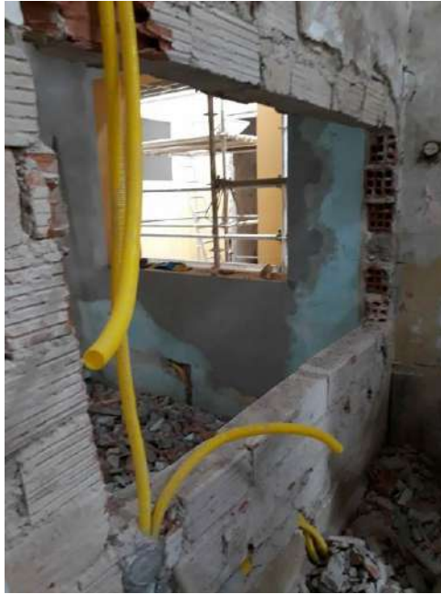
Foto 25 – Abertura dos vãos conforme orientação dos projetos
