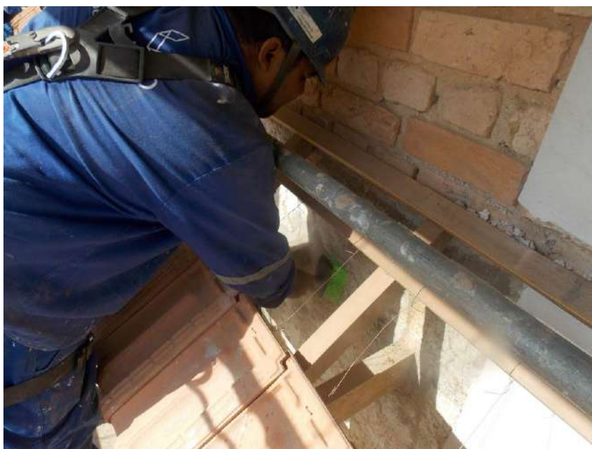
Foto 08 – Preparação para pintura da fachada– Casa 07
