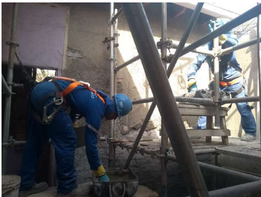
Foto 11 – Execução do emboço das paredes externas – Casa 07
