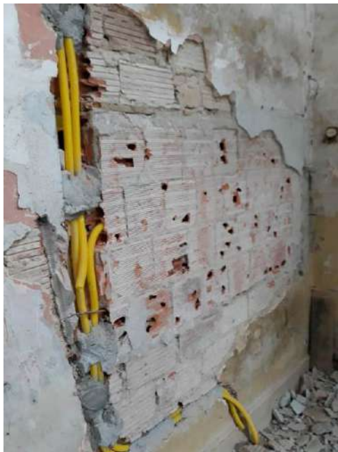
Foto 20 – Instalação do conduite
