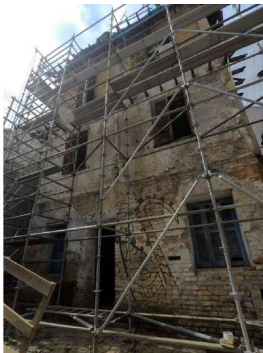
Foto 07 – Montagem do andaime – Casa 07
