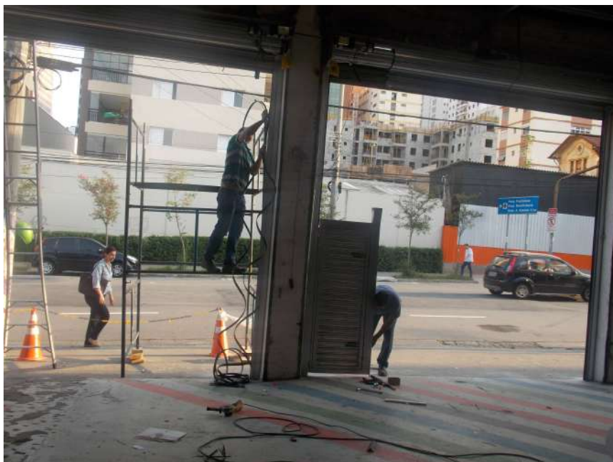
Foto 07 – Instalação do portão metálico no galpão
