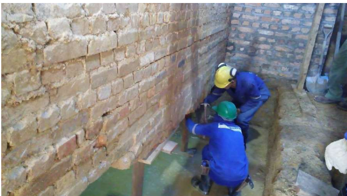
Foto 06 – Instalação do escoramento – Casa 07
