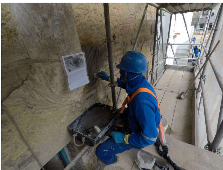
Foto 04 – Restauração do ornato da fachada principal
