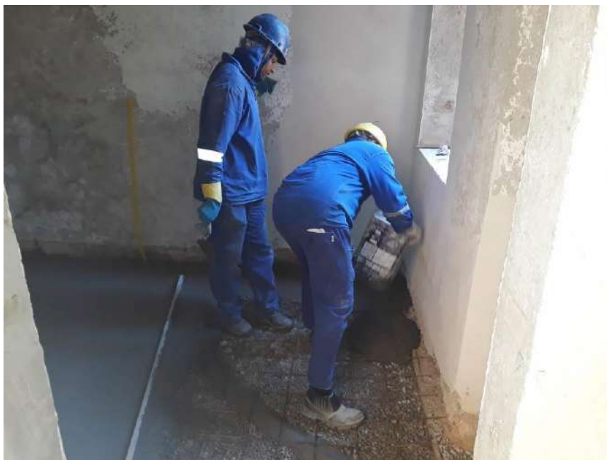
Foto 12 – Execução do piso cimentado
