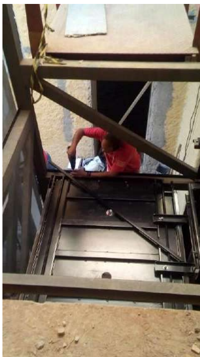
Foto 15 – Instalação dos vidros do elevador
