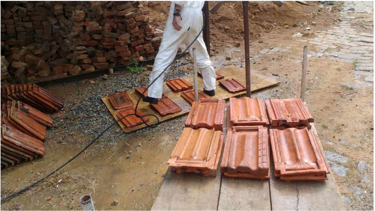
Foto 03- Lavagem das telhas existentes
