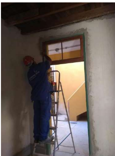
Foto 22 – Pintura dos batentes de madeira
