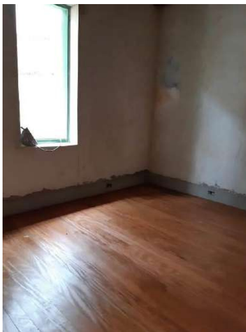
Foto 23 – Tratamento dos assoalhos de madeira
