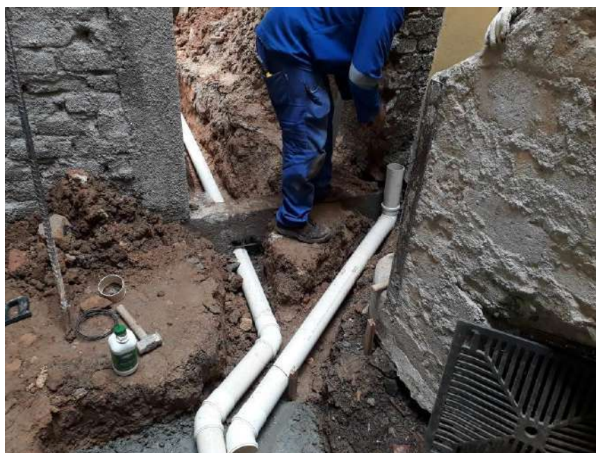
Foto 04 – Passagem das tubulações
