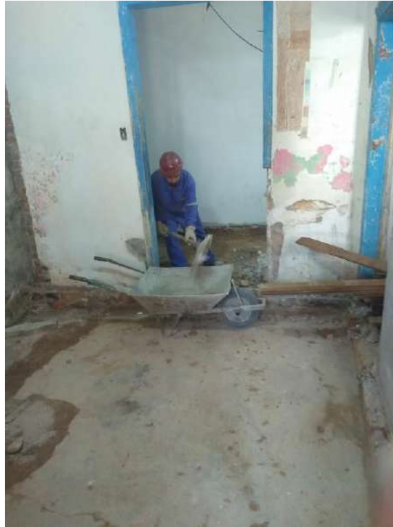
Foto 58 – Remoção do entulho
