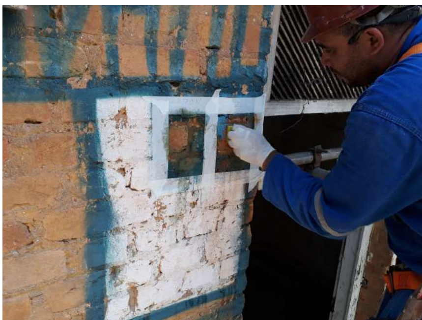
Foto 2 – Teste de remoção da pichação da fachada principal – Casa 07
