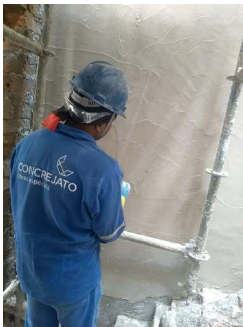
Foto 19 – Execução da argamassa de acabamento nas paredes externas – Casa 07
