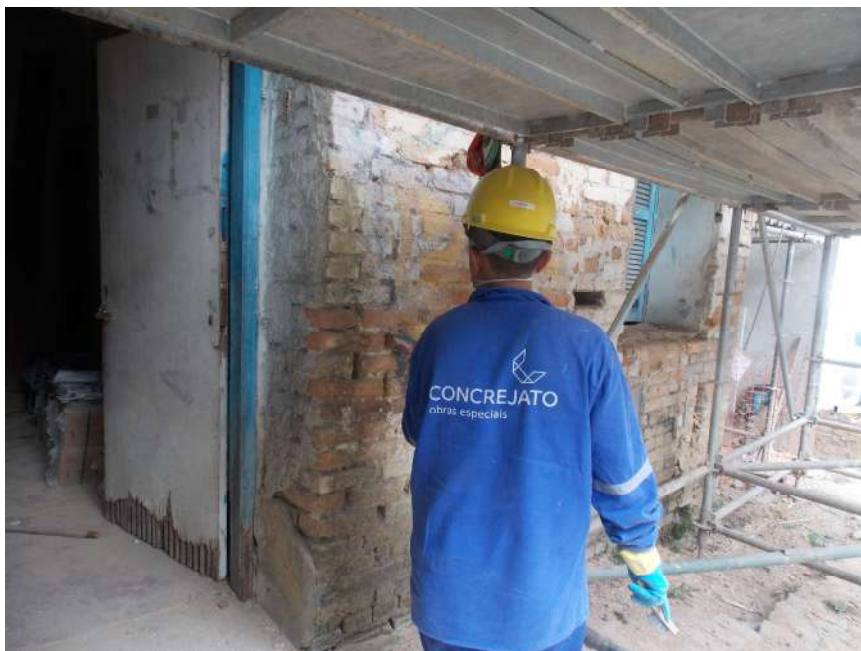
Foto 02 – Limpeza dos tijolos existentes na fachada principal – Casa 07
