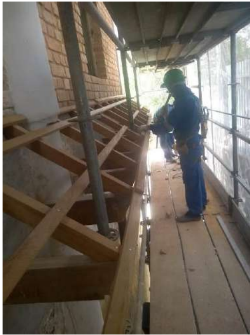
Foto 04 – Instalação das ripas da cobertura lateral – Casa 07
