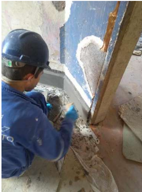
Foto 05 – Execução do rodapé
