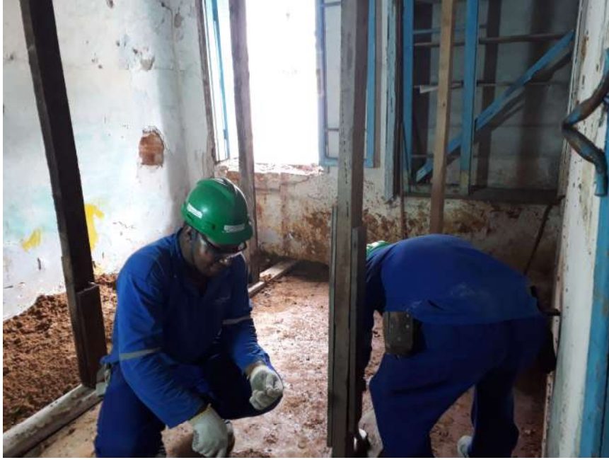
Foto 03 – Escoramento do forro de madeira – Casa 07
