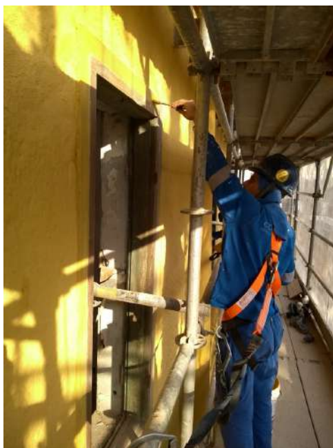
Foto 13 – Pintura lisa da fachada lateral – Casa 07
