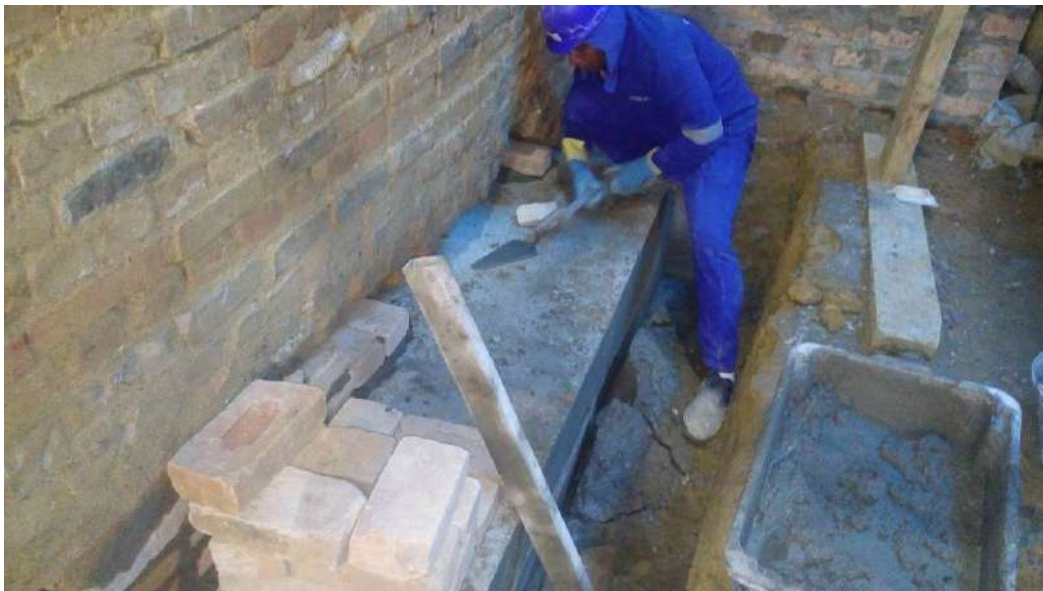
Foto 05- Ajuste da alvenaria para apoio da sapata de reforço – casa 07
