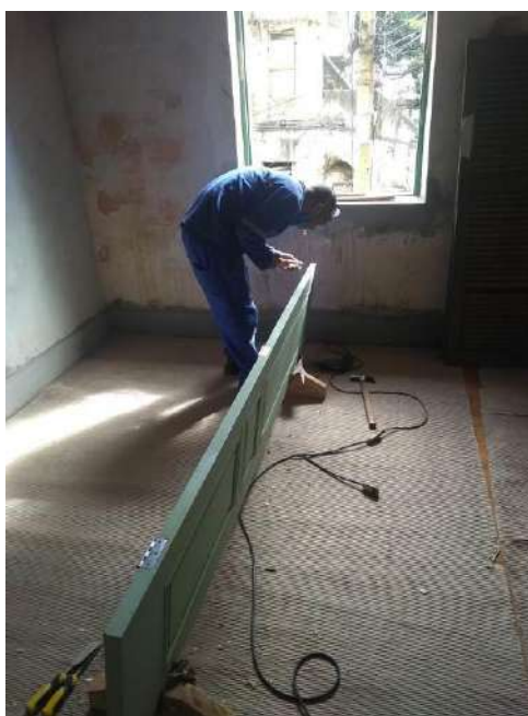
Foto 20 – Instalação das portas de madeira
