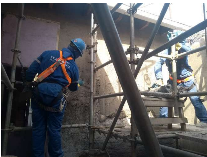
Foto 12 – Execução do emboço das paredes externas – Casa 07
