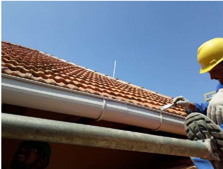
Foto 39 – Pintura das calhas na cobertura
