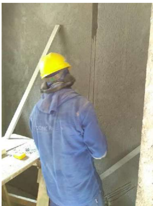
Foto 15 – Demolição manual para passagem dos conduítes
