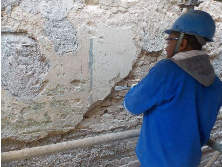
Foto 05 – Remoção da argamassa existente
