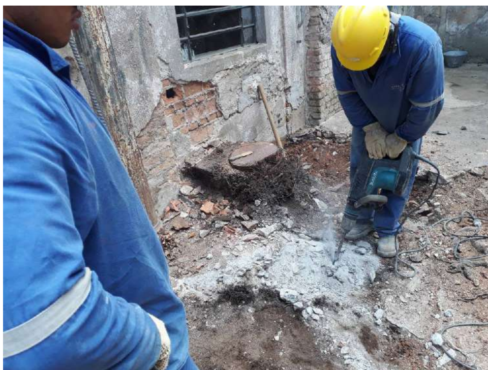
Foto 10 – Escavação mecânica para remoção das raízes das árvores
