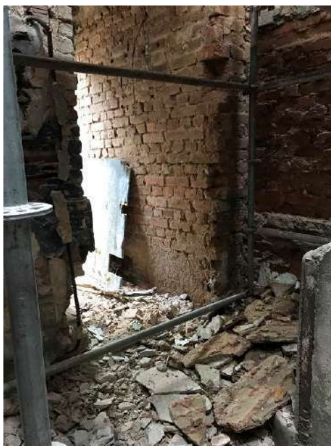
Foto 15 – Remoção da revestimento das fachadas das fundos – Casa 07
