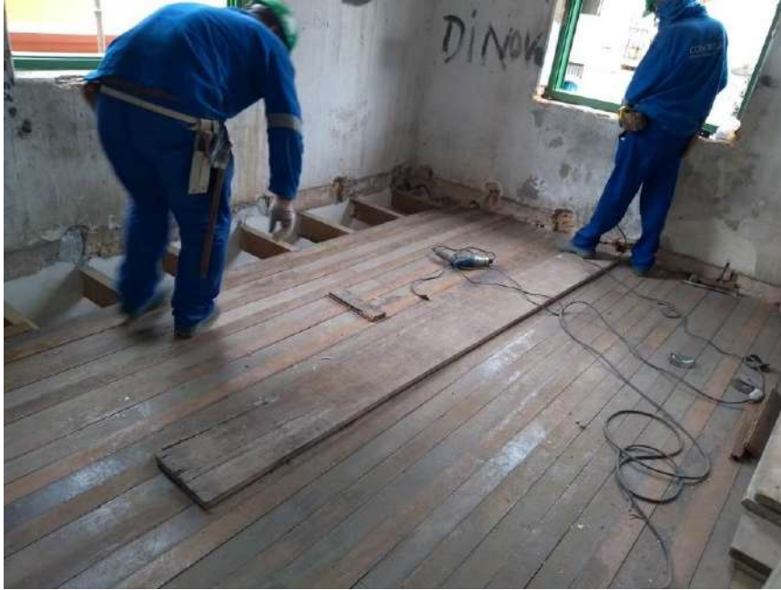
Foto 05 – Instalação dos assoalhos de madeira
