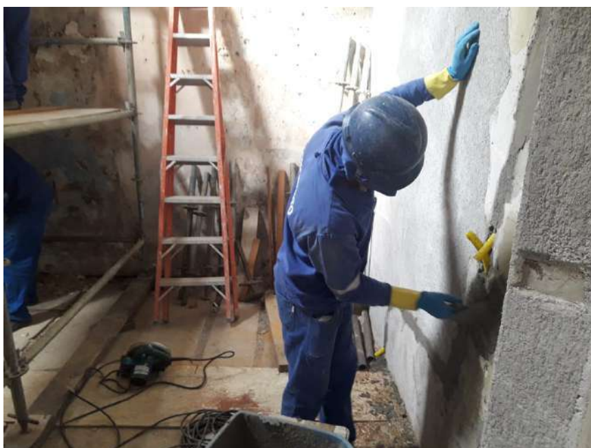
Foto 06 – Execução da argamassa de acabamento das paredes internas – Casa 07
