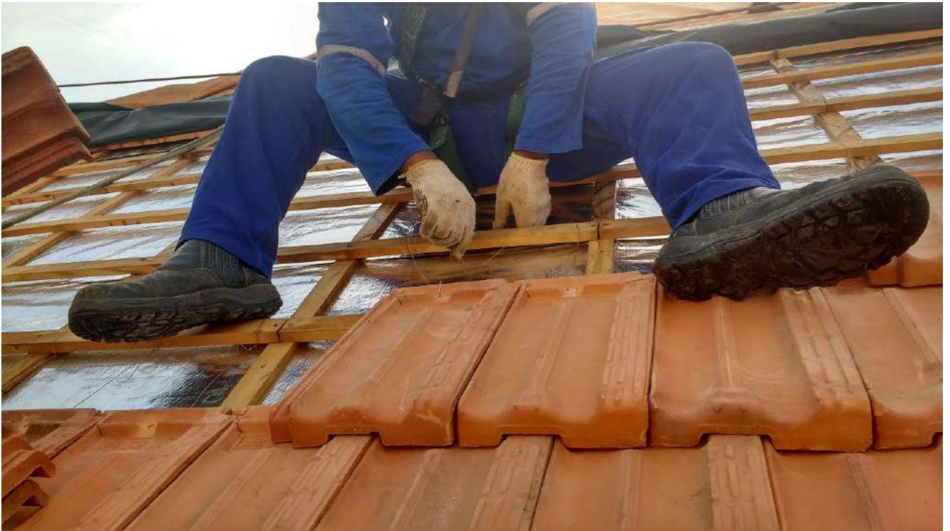
Foto 05- Amarração das telhas
