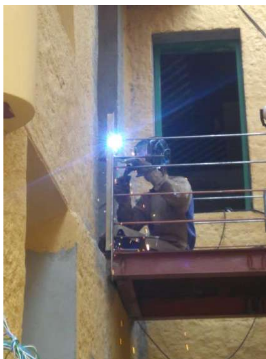
Foto 06 – Instalação do guarda corpo metálico da passarela de acesso do elevador
