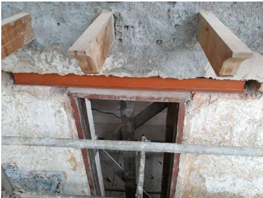
Foto 16 – Instalação do perfil metálico
