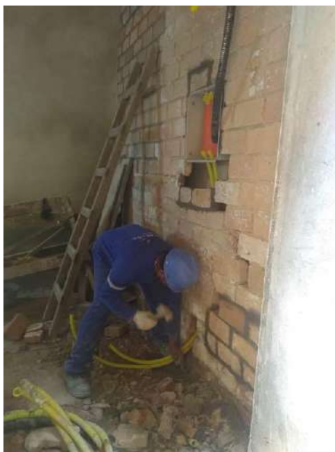
Foto 05 – Recuperação da alvenaria existente após a passagem dos conduite
