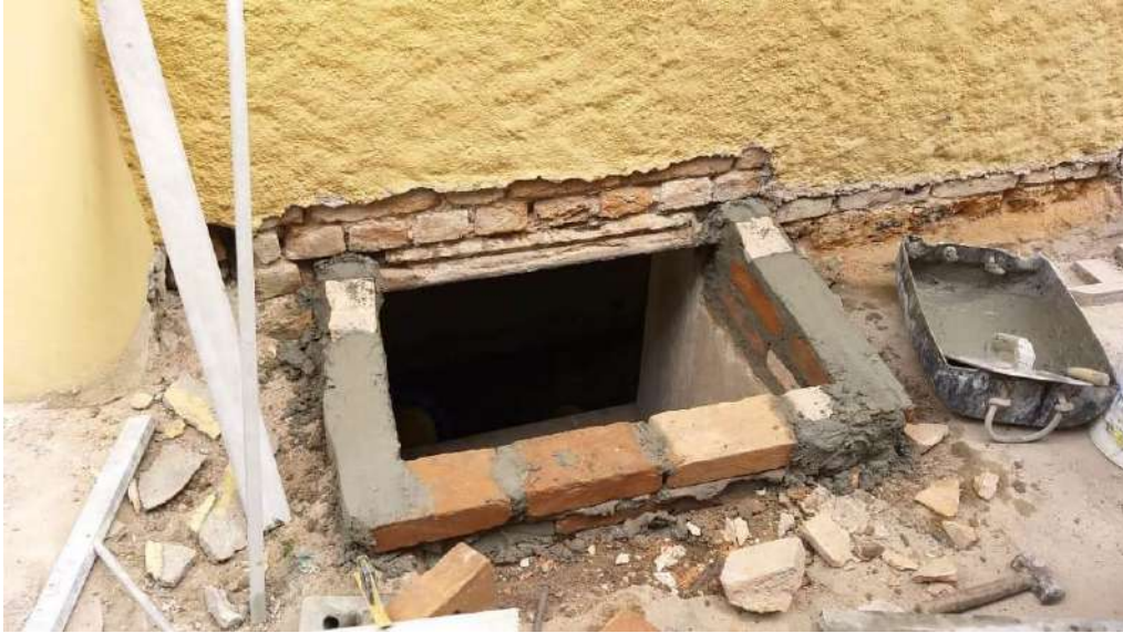
Foto 11 – Elevação da alvenaria para execução da clarabóia
