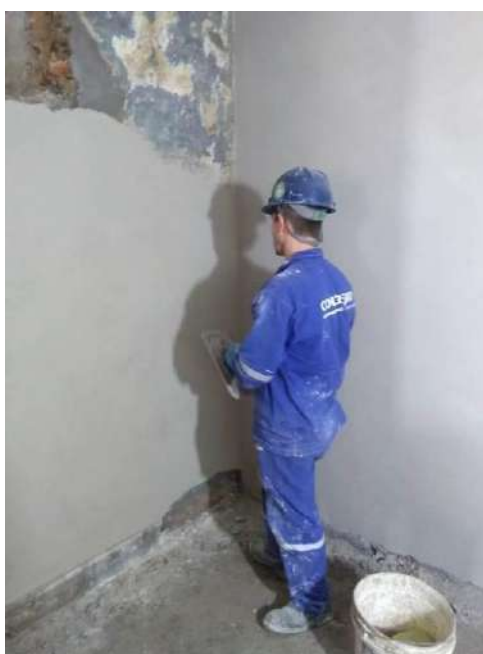
Foto 14 – Execução da argamassa de acabamento das paredes internas
