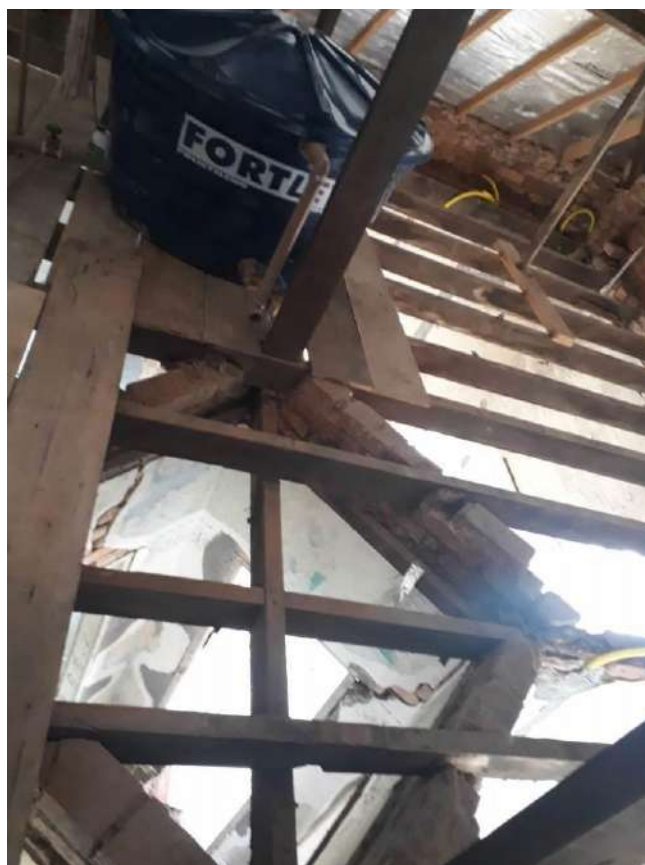
Foto 54 – Instalação da caixa de água
