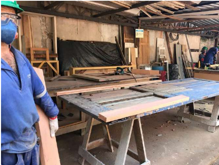
Foto 26 – Restauração das portas de madeira
