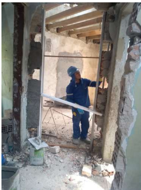
Foto 01 – Abertura dos vãos – Casa 07
