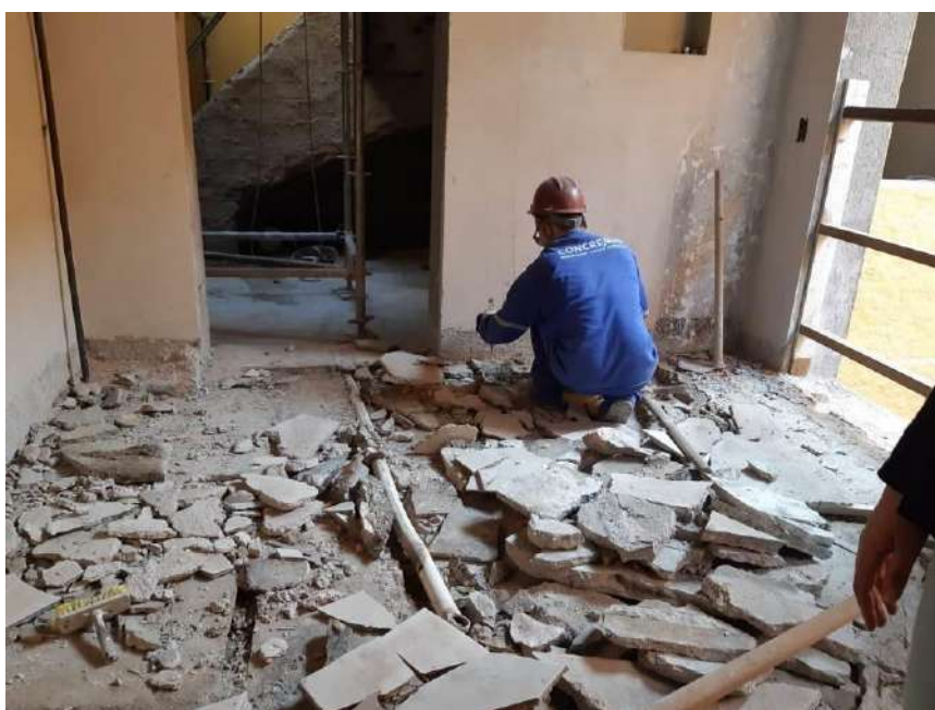
Foto 10 – Demolição manual do piso existente – Casa 07
