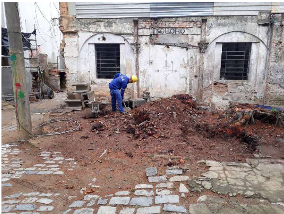
Foto 11 – Escavação manual para remoção das raízes das árvores
