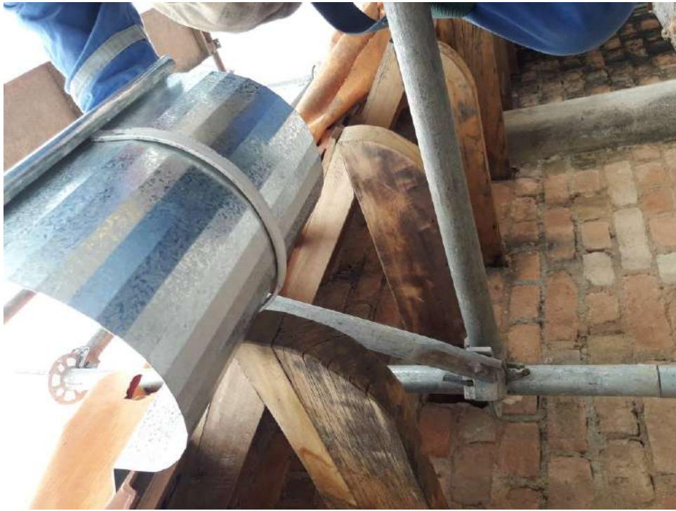
Foto 07 – Instalação das calhas na cobertura
