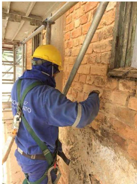
Foto 04 – Limpeza dos tijolos aparentes da fachada casa 7
