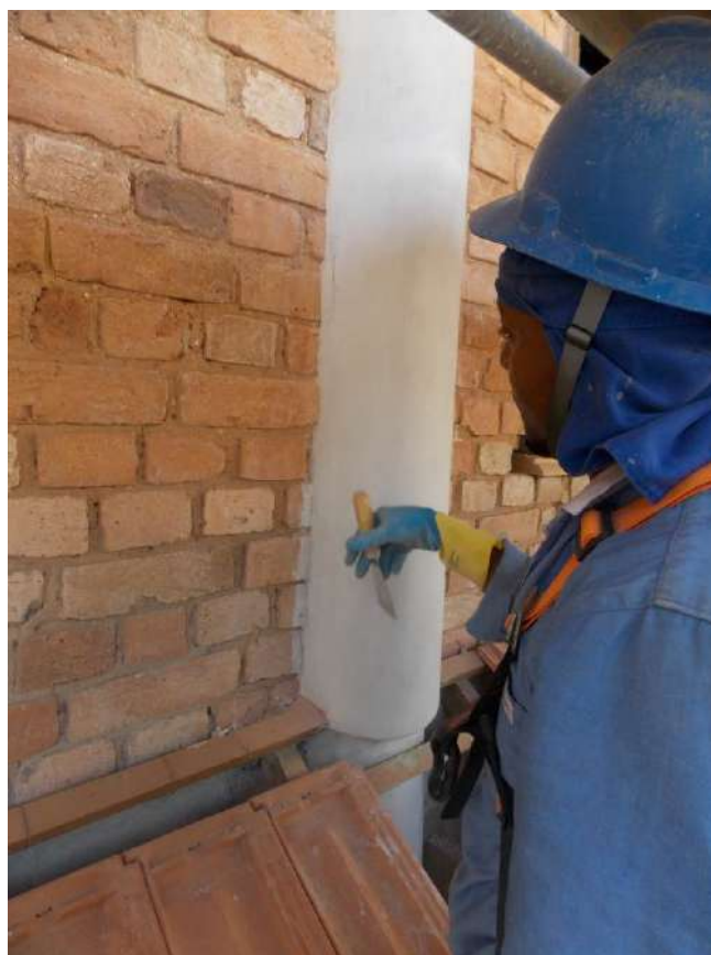
Foto 06 – Limpeza fina dos tijolos – Casa 07
