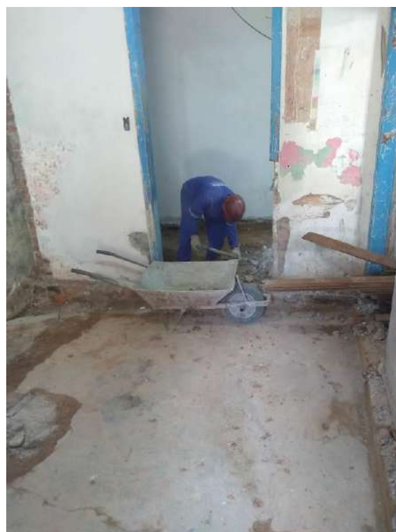
Foto – 57 – Remoção do entulho
