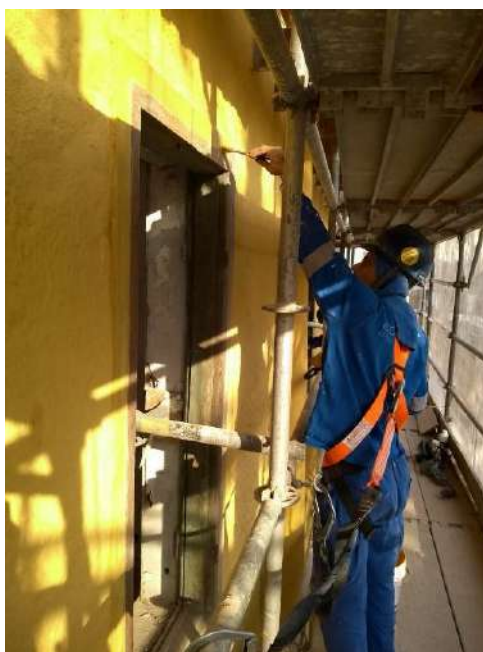
Foto 10 – Pintura com tinta mineral na fachada frontal – Casa 07
