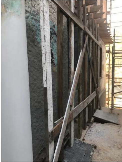
Foto 07 – Escoramento da alvenaria existente – Casa 07
