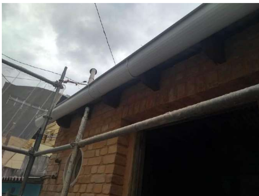
Foto 26- Instalação das calhas na cobertura
