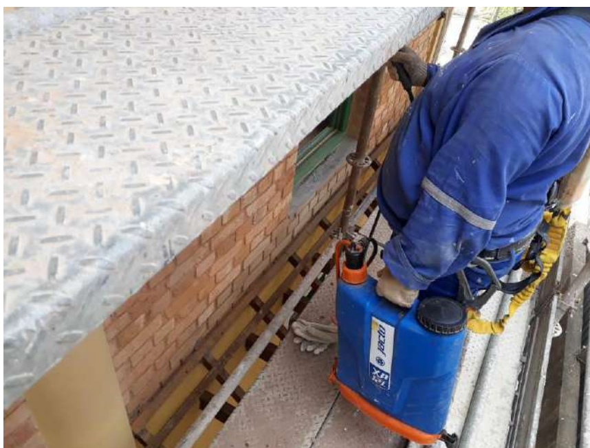
Foto 44 – Aplicação de hidrofugante na fachada lateral
