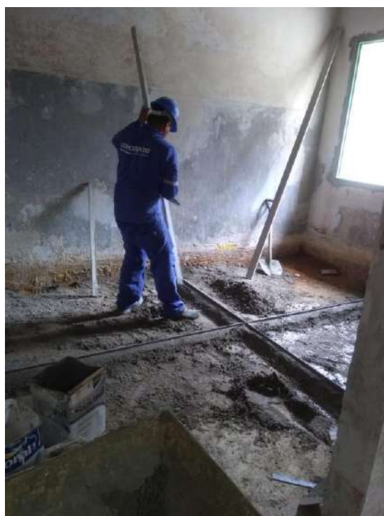
Foto 10 – Instalação da junta de dilatação para execução do piso cimentado
