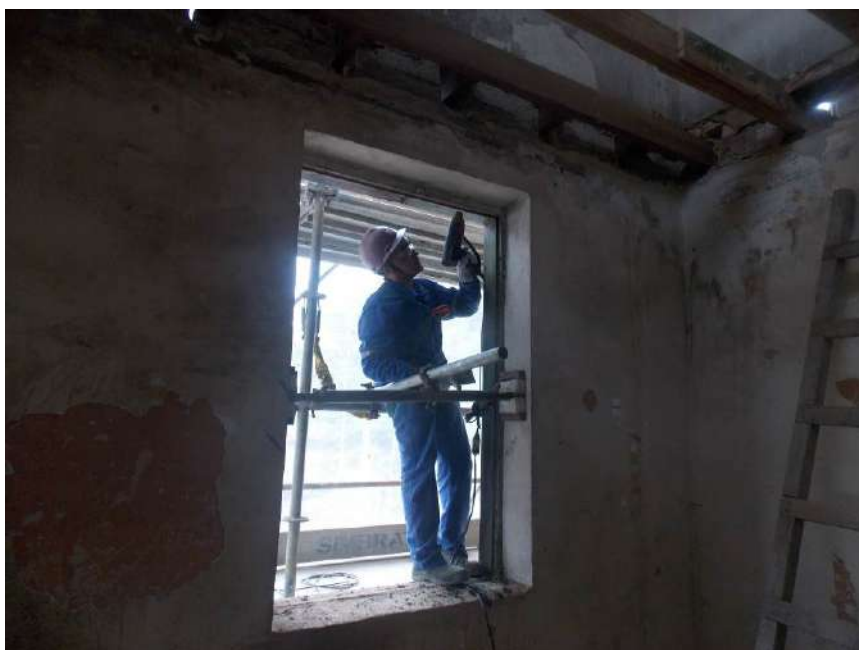
Foto 10 – Decapagem das esquadrias de madeira – Casa 07
