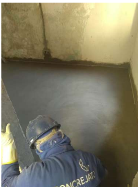
Foto 20 – Execução do piso cimento queimado
