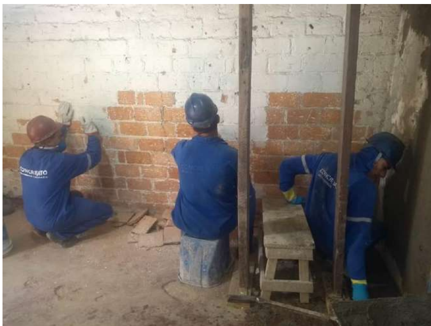
Foto 07 – Decapagem manual das paredes internas – Casa 07
