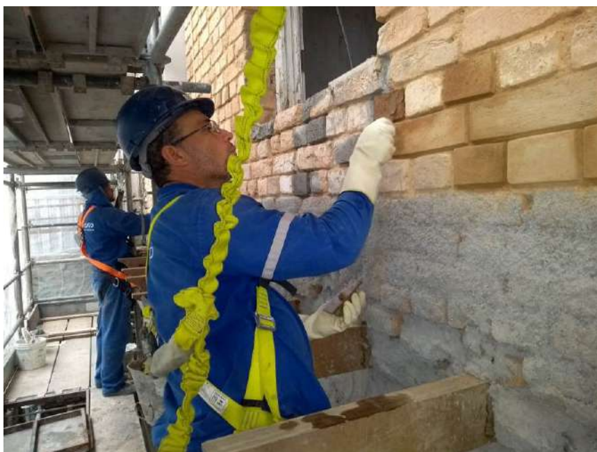
Foto 01 – Restauração dos tijolos da fachada
