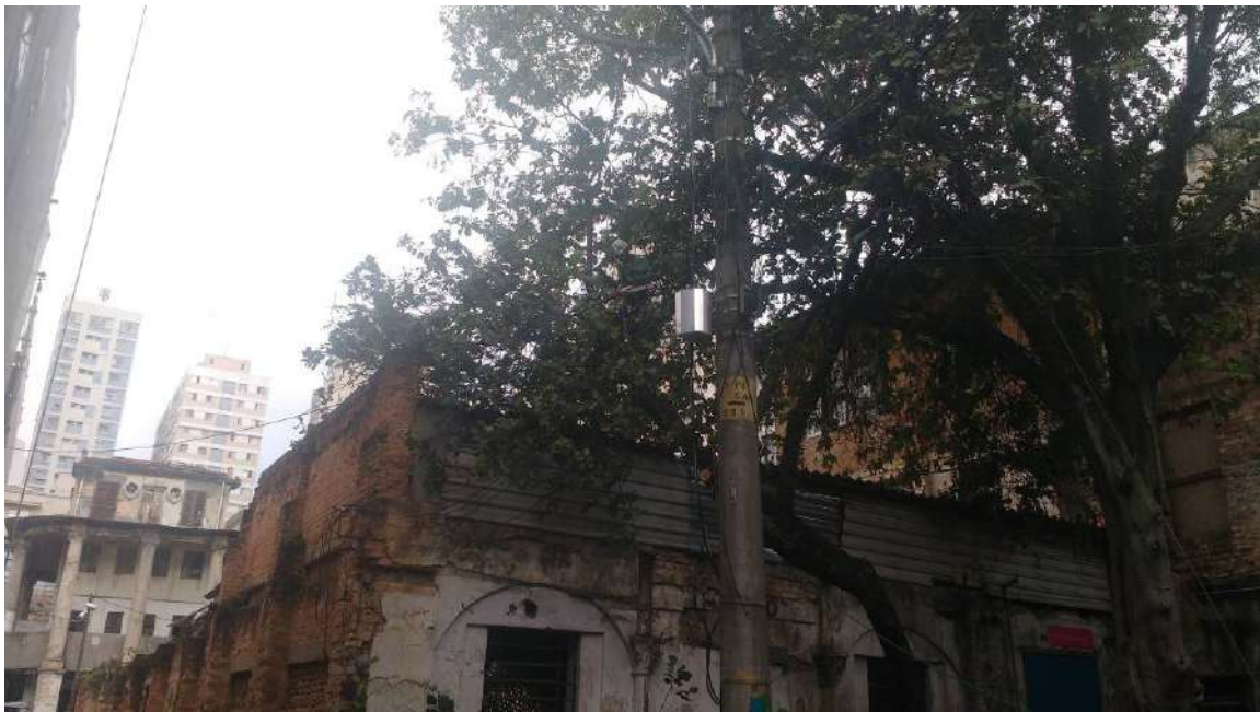
Foto 08 – Execução da poda das árvores
