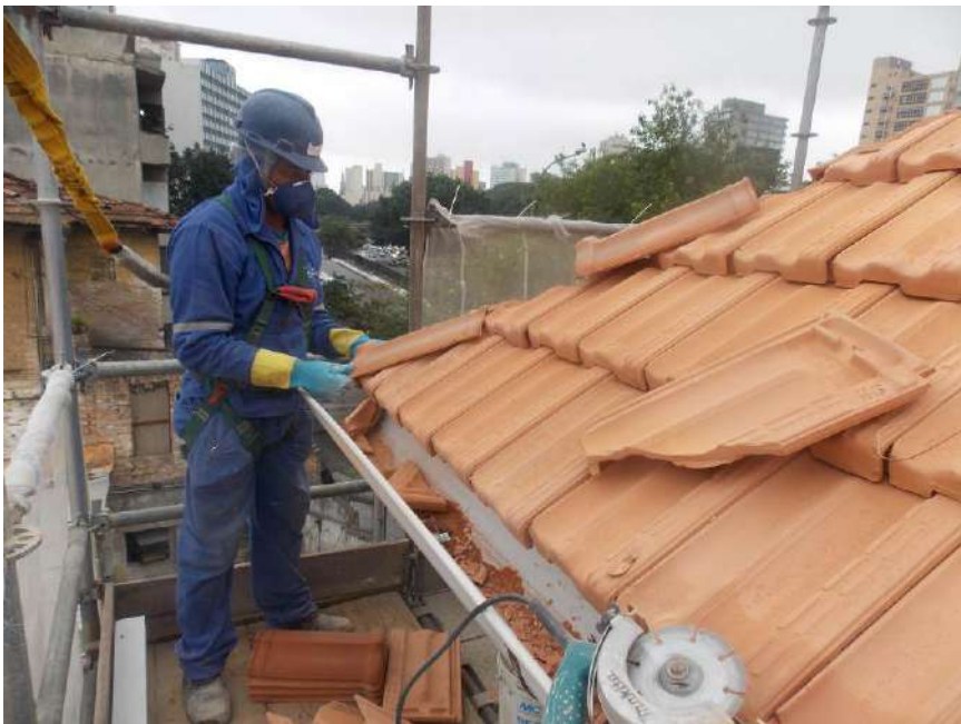
Foto 04 – Instalação da cumeeira – Casa 07
