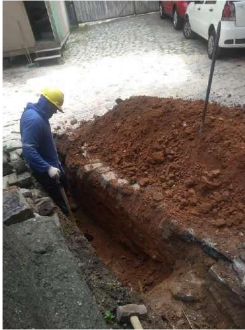
Foto 09 – Escavação manual para passagem das tubulações
