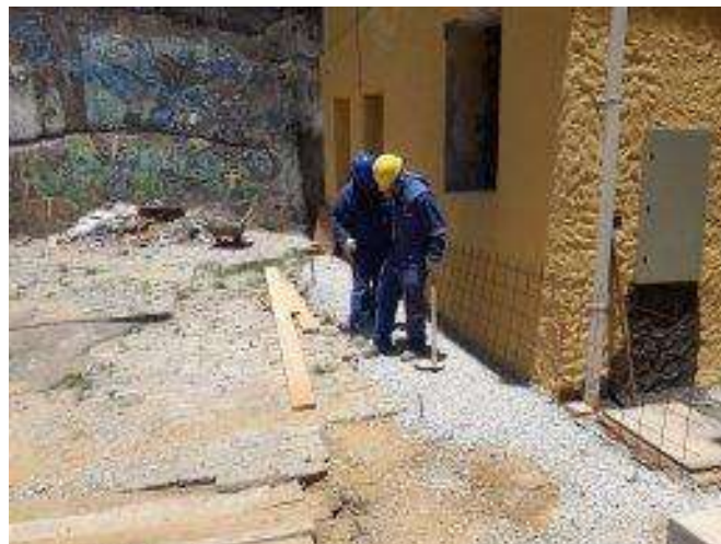
Foto 10 – Execução da forma para execução da concretagem
