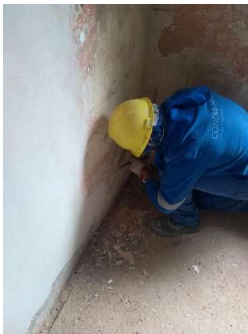
Foto 31 – Decapagem cuidadosa das paredes internas
