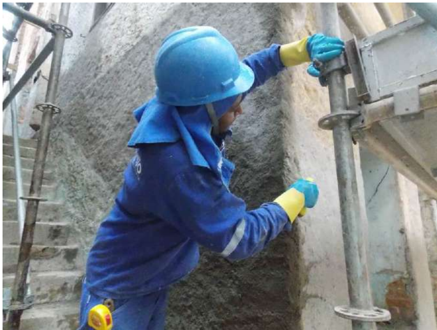
Foto 12 – Execução do chapisco da fachada lateral – Casa 07
