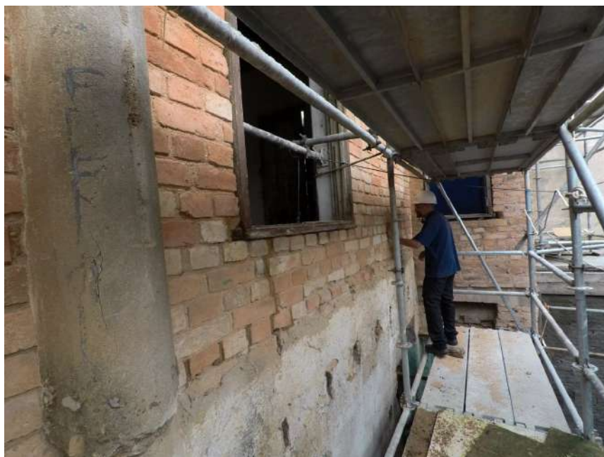
Foto 07 – Limpeza dos tijolos aparentes. Casa 7
