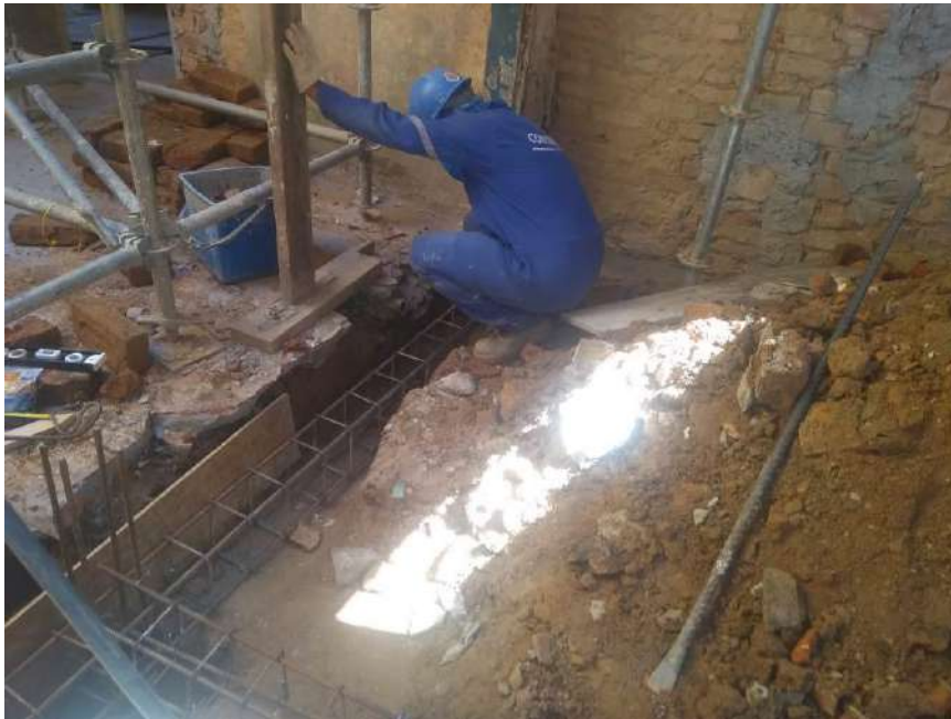
Foto 15 – Instalação da forma para concretagem
