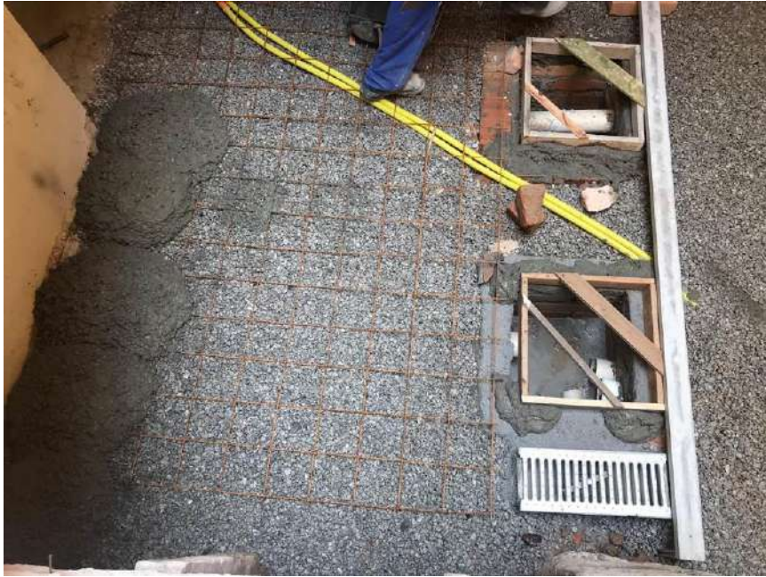
Foto 10 – Execução do piso cimentado da área externa
