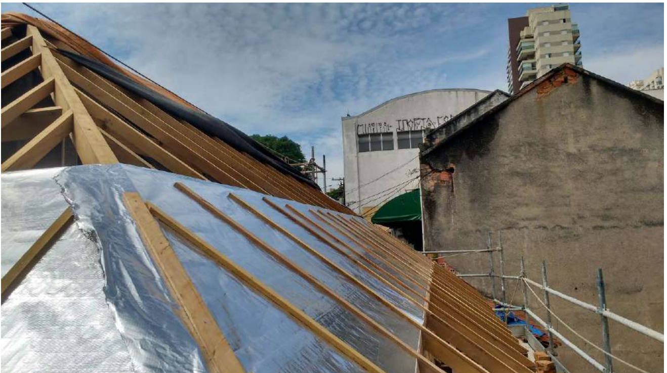
Foto 20- Instalação das manta de alumínio
