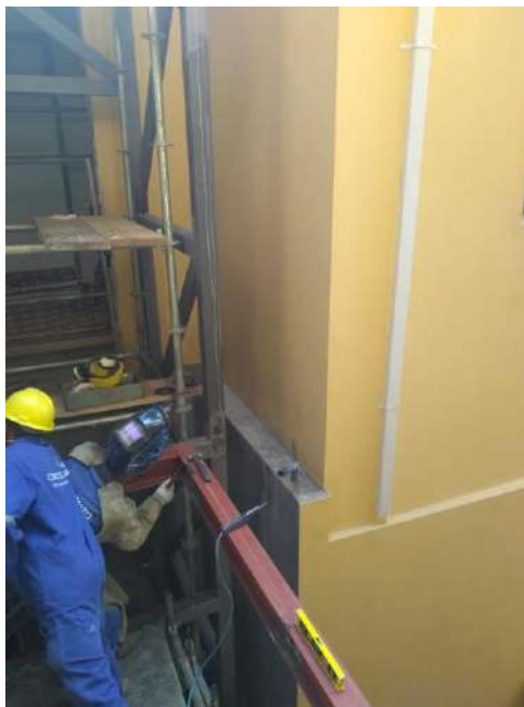
Foto 02 – Instalação do guarda corpo metálico
