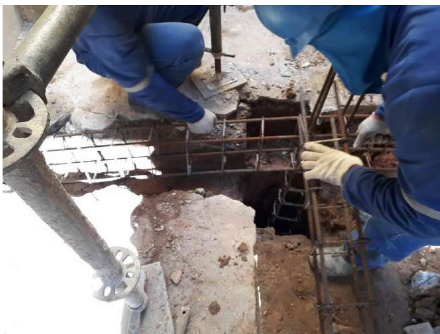
Foto 14 – Instalação da armação da viga baldrame
