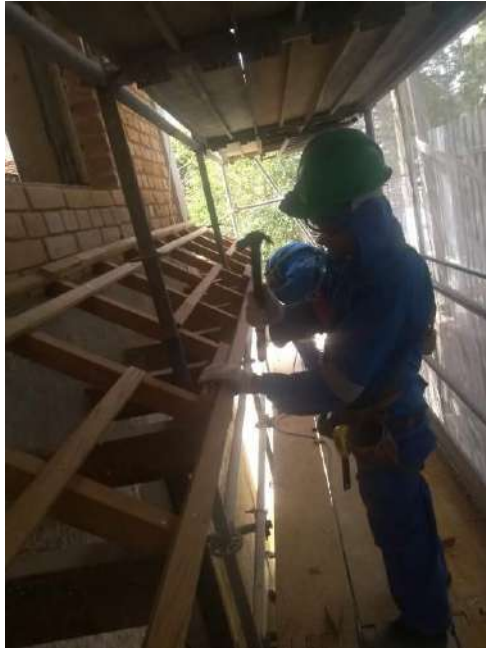
Foto 03 – Instalação das ripas da cobertura lateral – Casa 07
