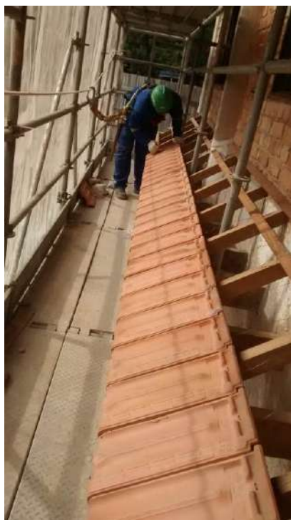
Foto 13 –Instalação das telhas cerâmicas – Casa 07
