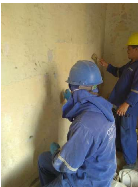
Foto 15 – Decapagem manual das paredes internas
