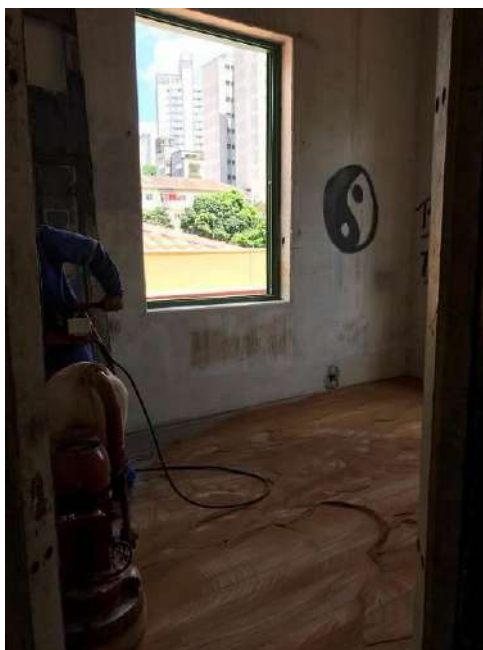
Foto 25 – Lixamento dos assoalhos de madeira
