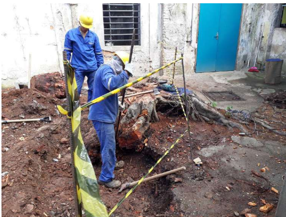
Foto 12 – Remoção das raízes das árvores
