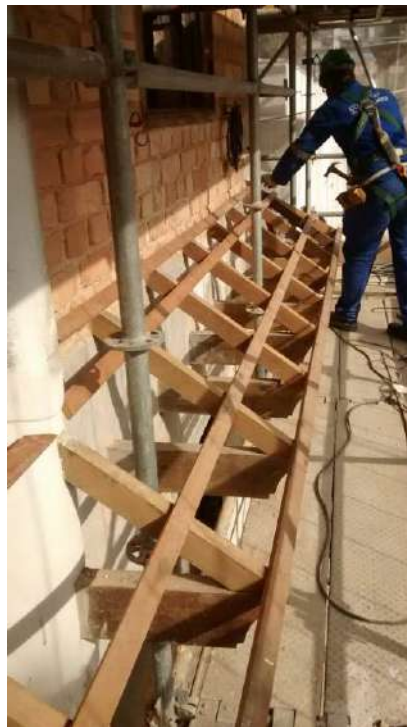
Foto 08 – Instalação das ripas – Casa 07
