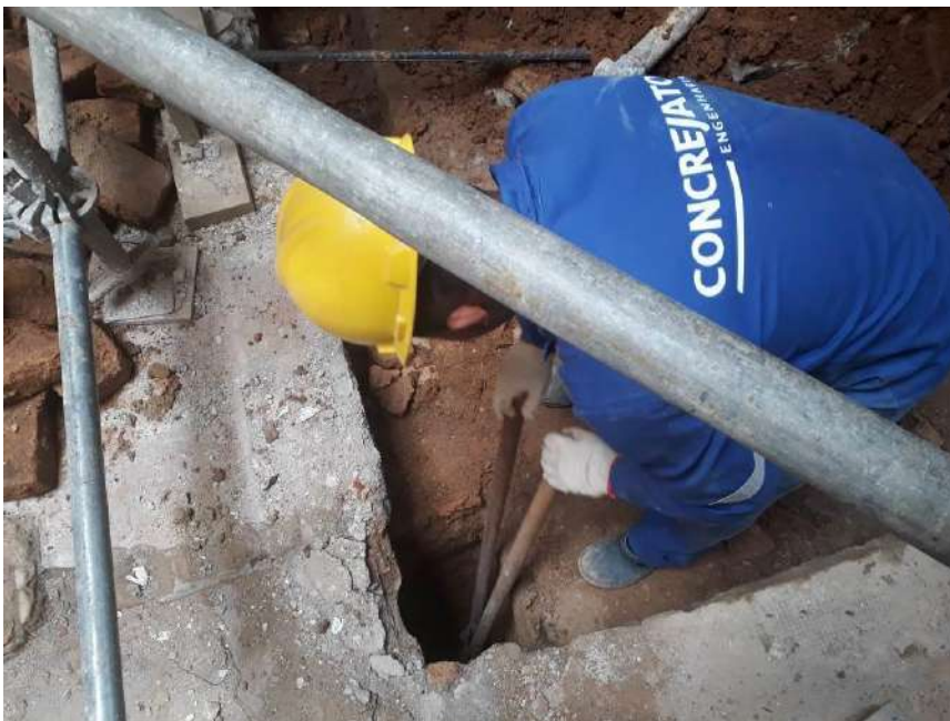
Foto 10– Abertura de vala para execução de brocas de concreto
