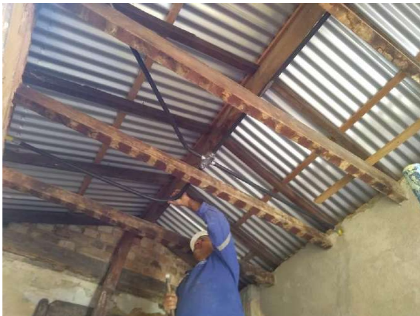
Foto 02 – Execução de infra para elétrica
