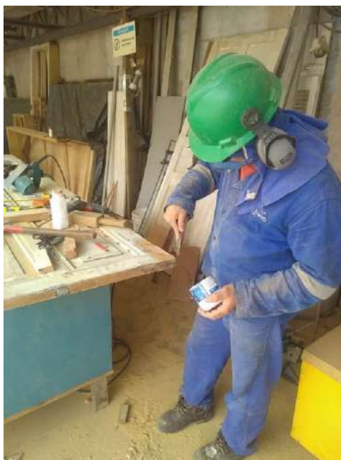
Foto 36 – Restauração das portas de madeira
