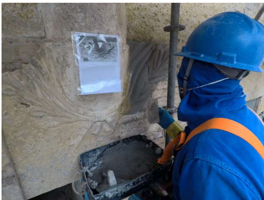
Foto 03 – Restauração do ornato da fachada principal
