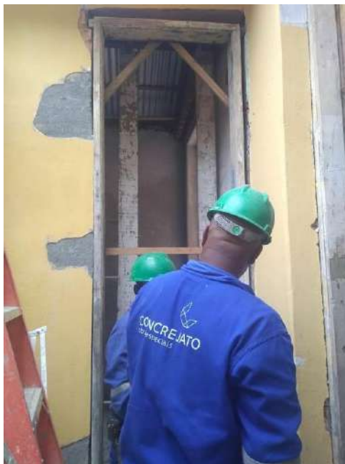
Foto 20 – Ajustes dos batentes de madeira
