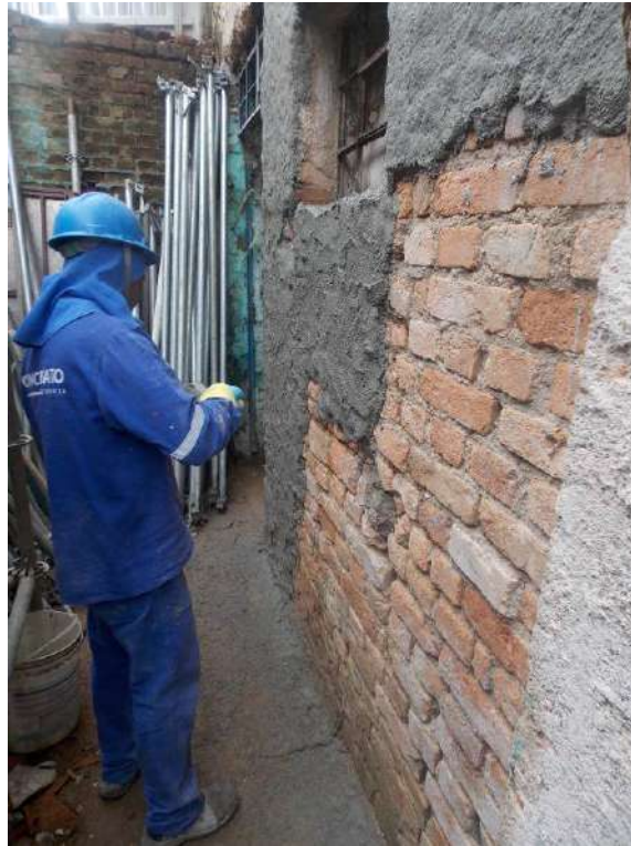
Foto 11 – Execução do chapisco da fachada lateral – Casa 07
