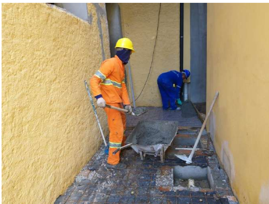
Foto 19 – Execução da concretagem
