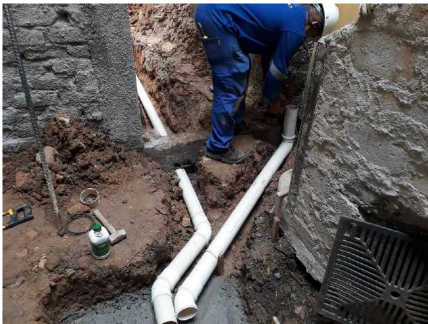
Foto 03 – Passagem das tubulações
