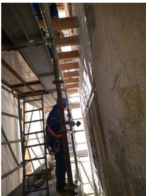
Foto 02 – Elevação da alvenaria – Casa 07
