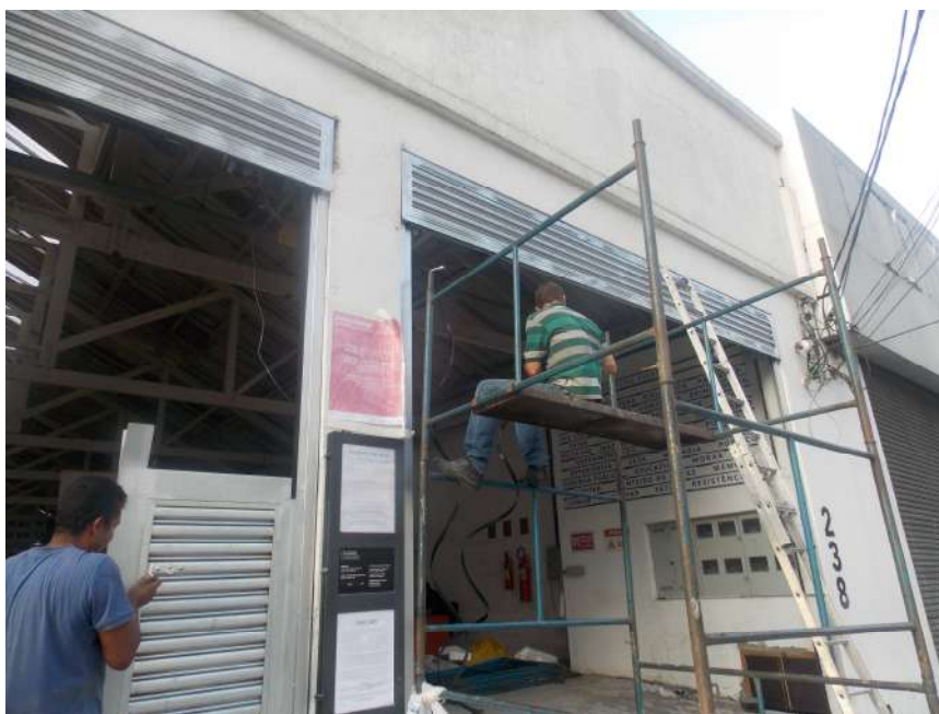
Foto 09 – Instalação do portão metálico do galpão
