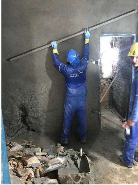
Foto 11 – Execução do emboço das paredes internas – térreo
