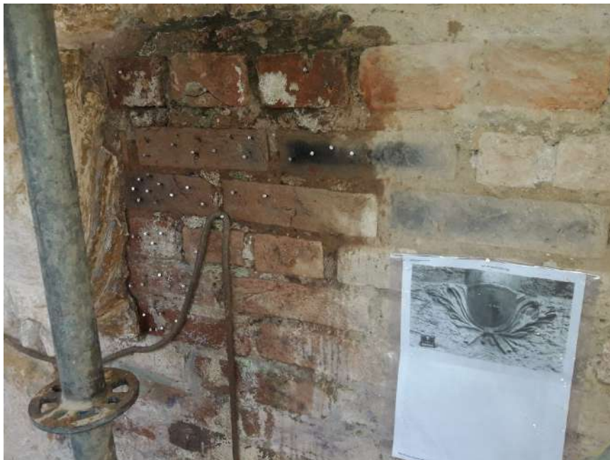
Foto 06 – Remoção do ornato para execução do restauro – Casa 07
