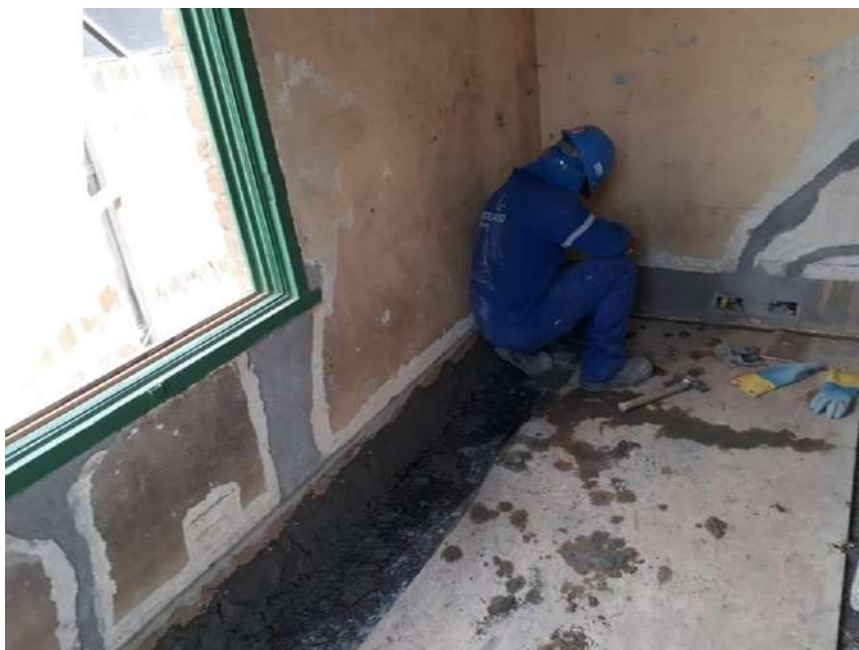
Foto 55 – Execução do rodapé de argamassa do pavimento C
