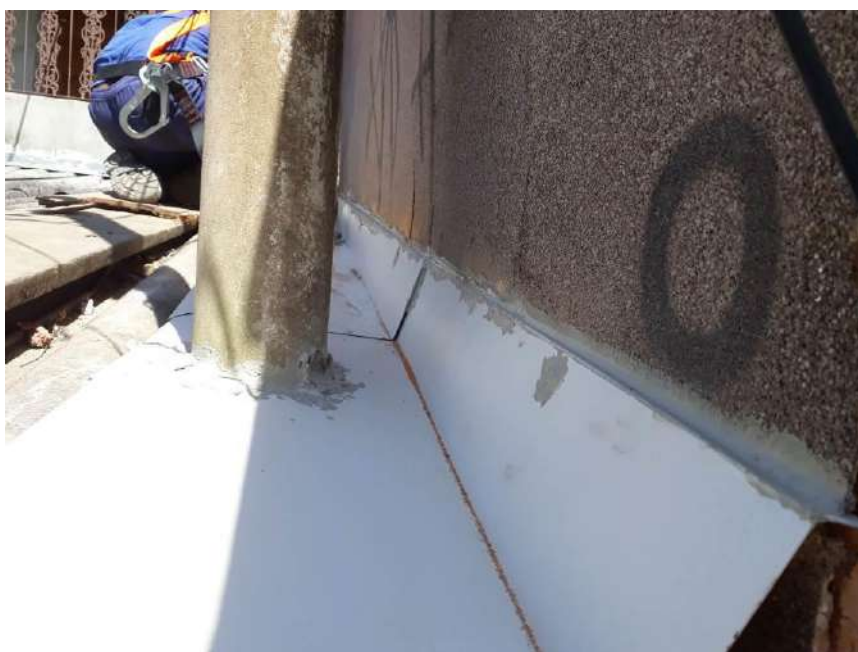
Foto 42 – Instalação do rufo na divisa com o vizinho da Rua Maestro Cardim
