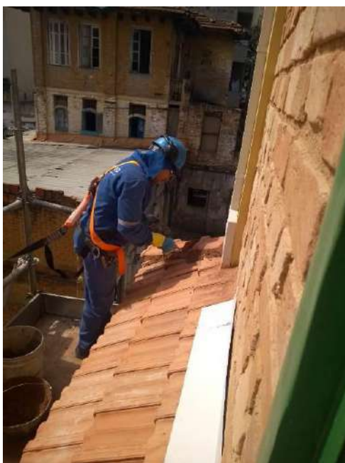
Foto 06 – Instalação da cumeeira da cobertura lateral – Casa 07
