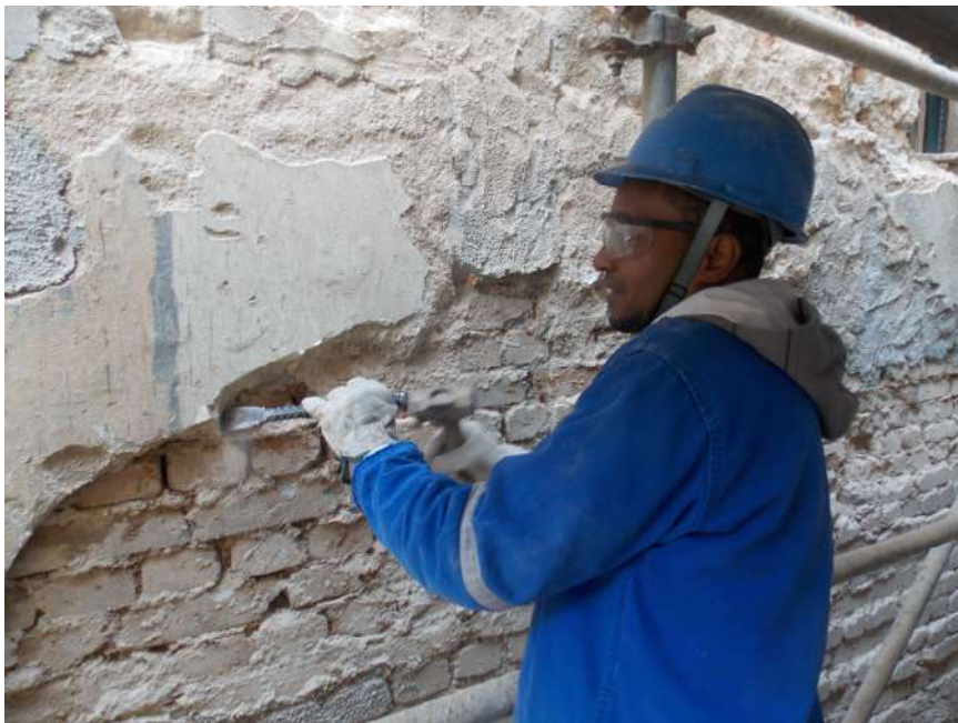
Foto 06– Remoção da argamassa existente
