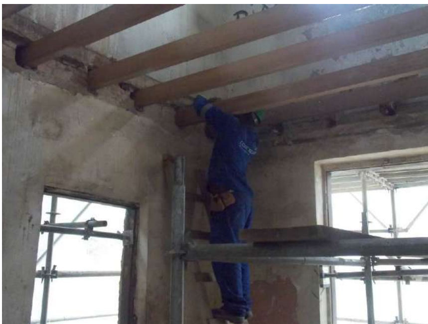
Foto 05 – Instalação dos barrotes de madeira – Casa 07
