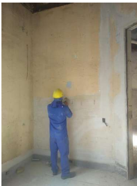
Foto 15 – Decapagem manual das paredes internas
