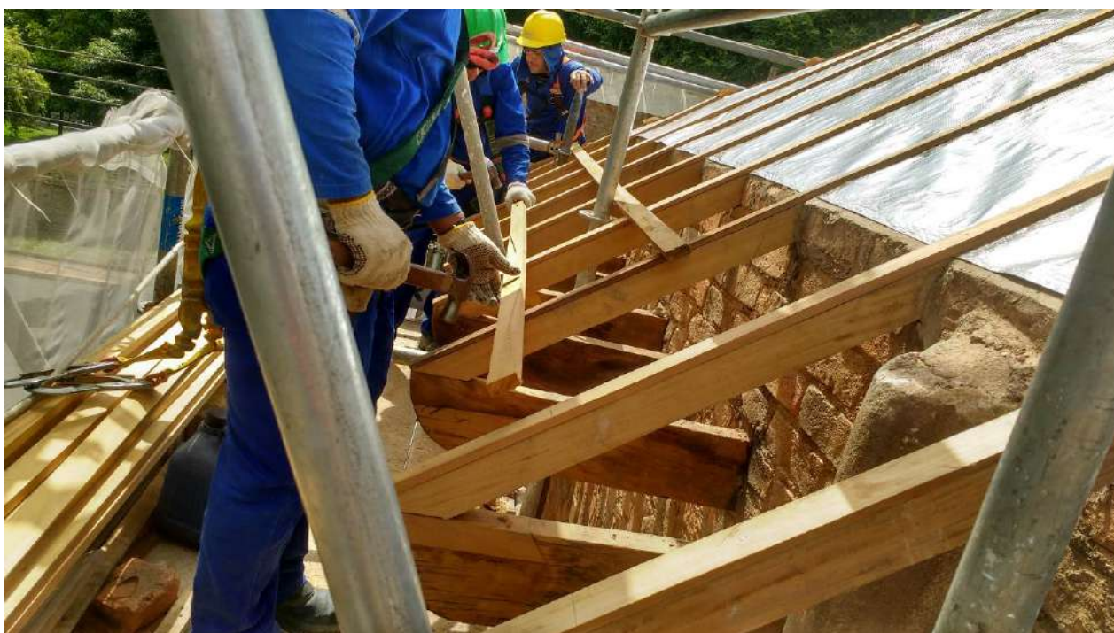
Foto 22- Instalação das manta de alumínio
