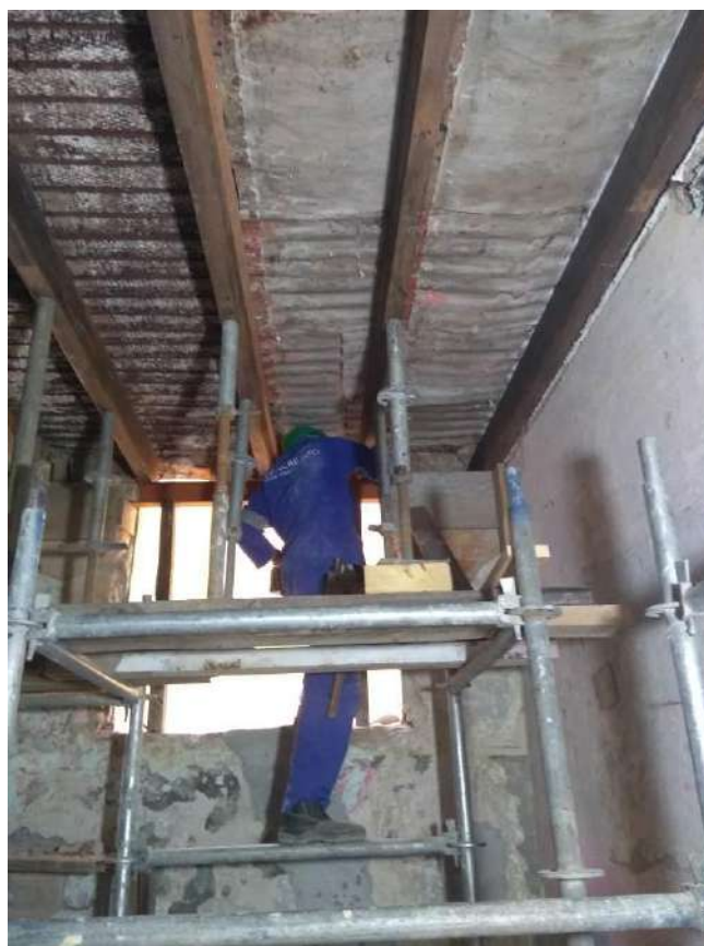
Foto 22 – Instalação de reforço metálico para apoio dos barrotes
