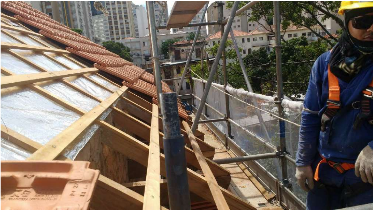
Foto 09- Instalação das telhas
