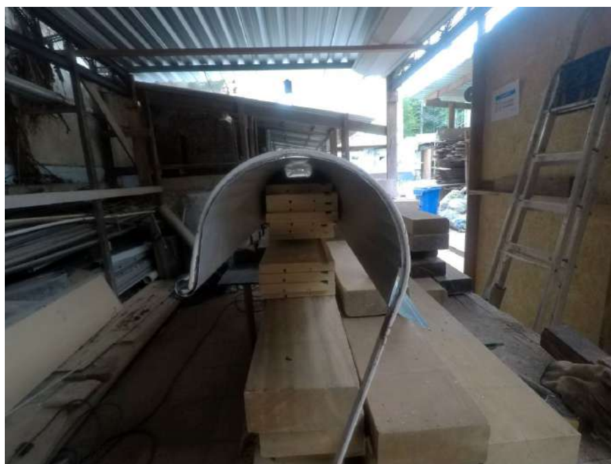
Foto 08 – Execução de calha e suporte da Casa 7
