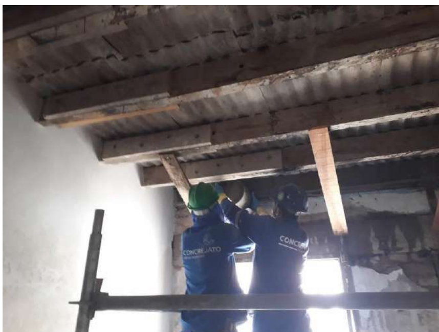
Foto 28 – Restauro dos barrotes danificados
