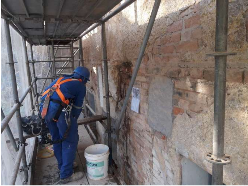
Foto 05 – Remoção do ornato para execução do restauro – Casa 07
