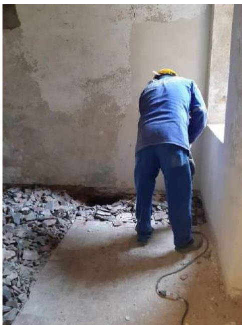
Foto 03 – Demolição mecânica do piso cimentado existente
