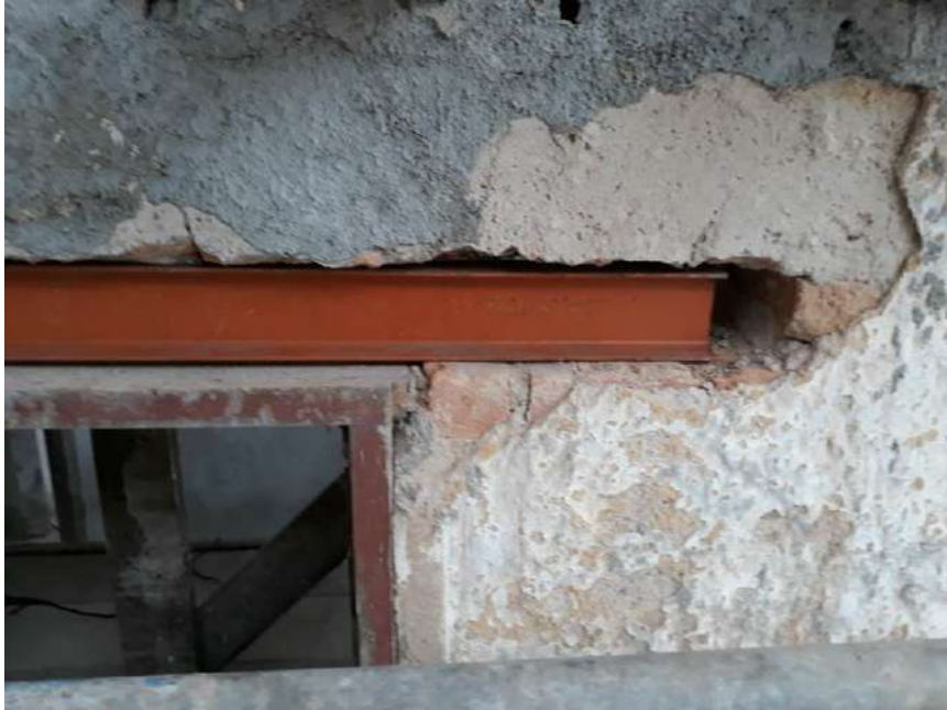
Foto 15 – Instalação do perfil metálico
