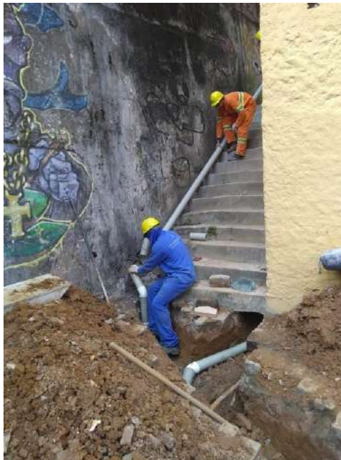
Foto17 – Instalação das tubulações
