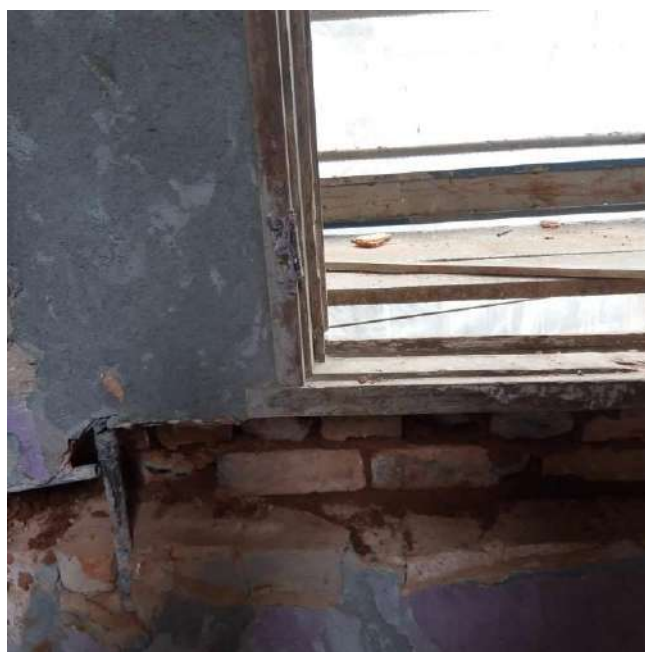
Foto 12 – Execução de contravergas nas janelas – Casa 07
