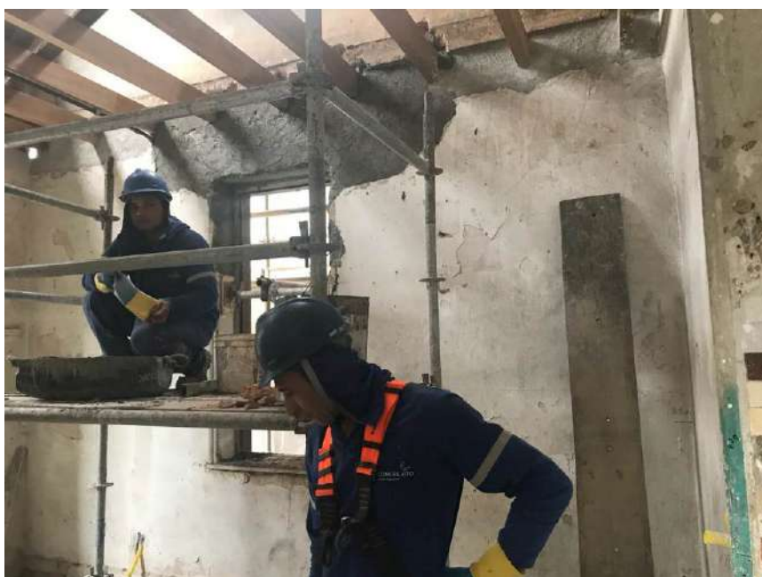
Foto 10 – Execução do emboço das paredes internas
