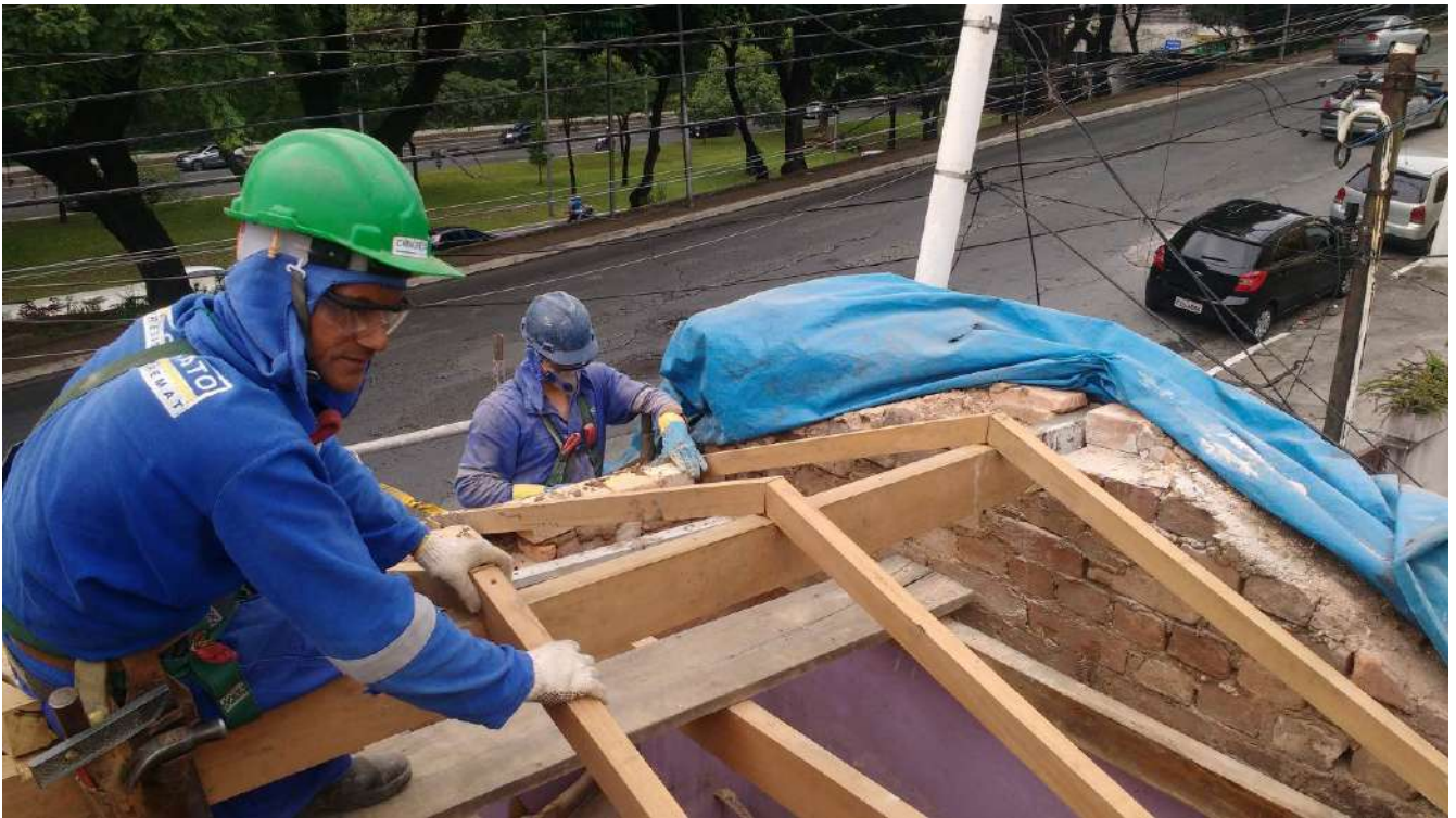
Foto 01- Troca dos caibros
