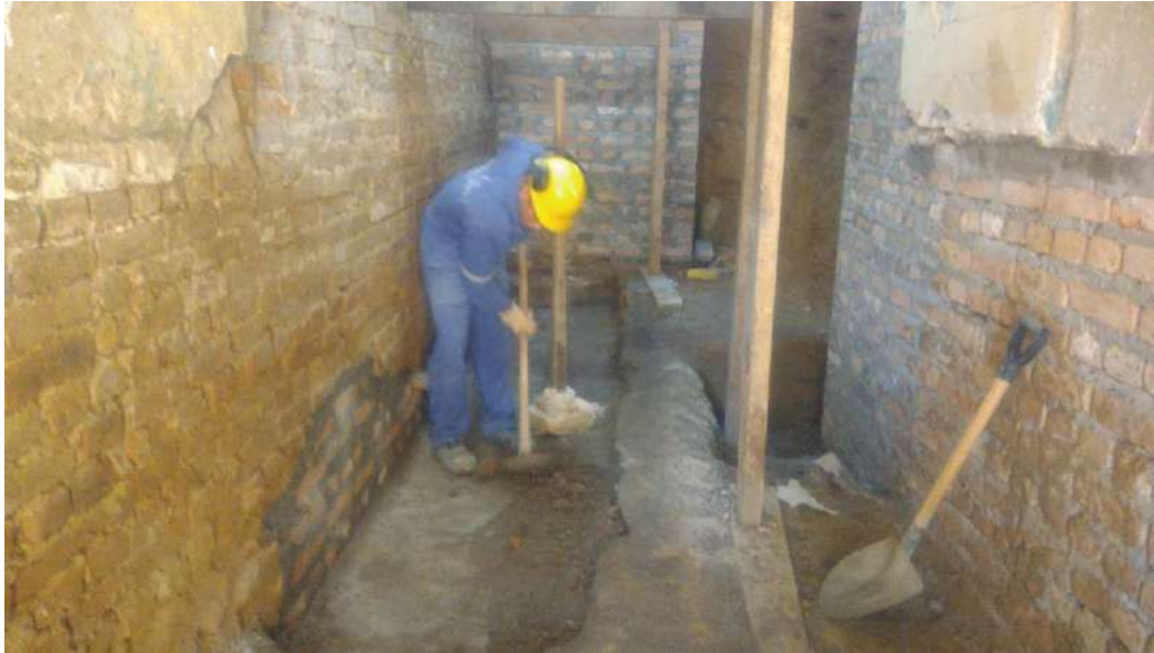
Foto 03- Compactação com solocimento após concretagem – casa 07
