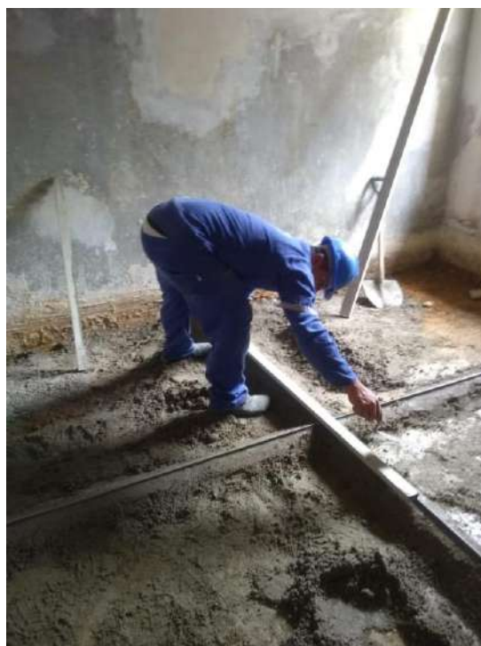
Foto 09 – Instalação das juntas de dilatação para execução do piso cimentado
