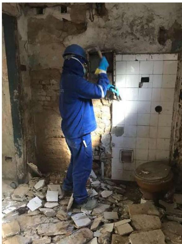
Foto 19- Remoção das cerâmicas – Casa 07
