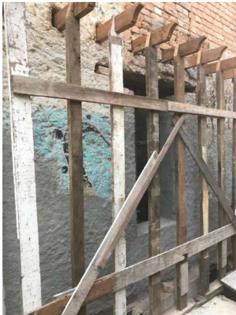
Foto 08 – Escoramento da alvenaria existente – Casa 07
