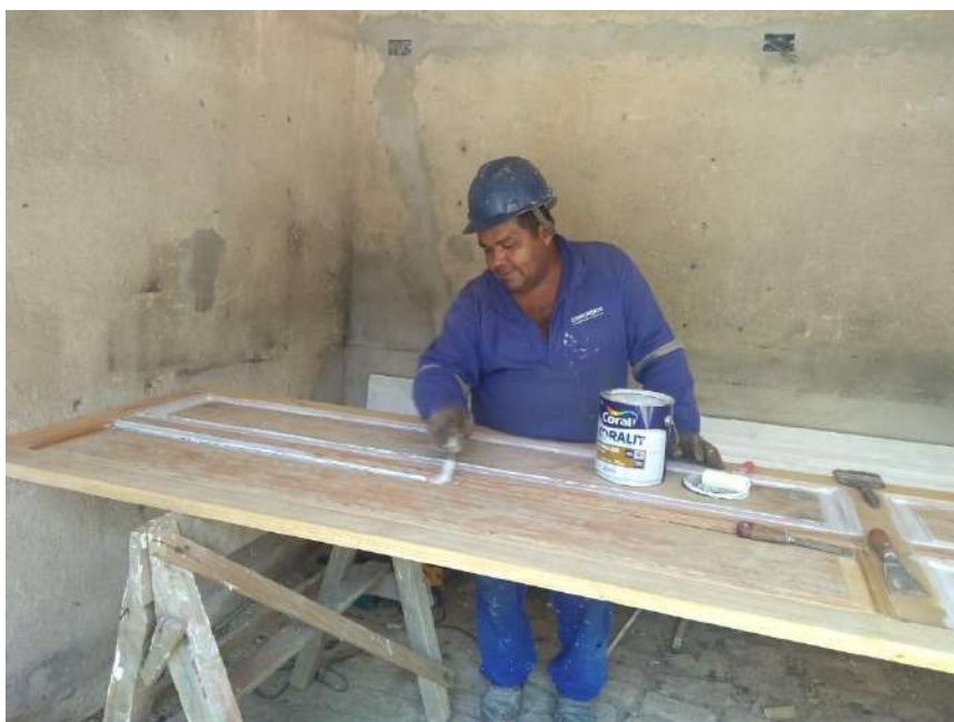
Foto 02 – Aplicação de massa para madeiras nas portas
