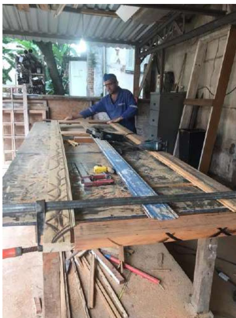
Foto 03 – Execução dos batentes de madeira
