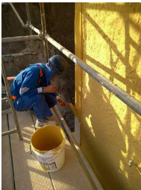
Foto 09 – Pintura com tinta mineral na fachada frontal – Casa 07
