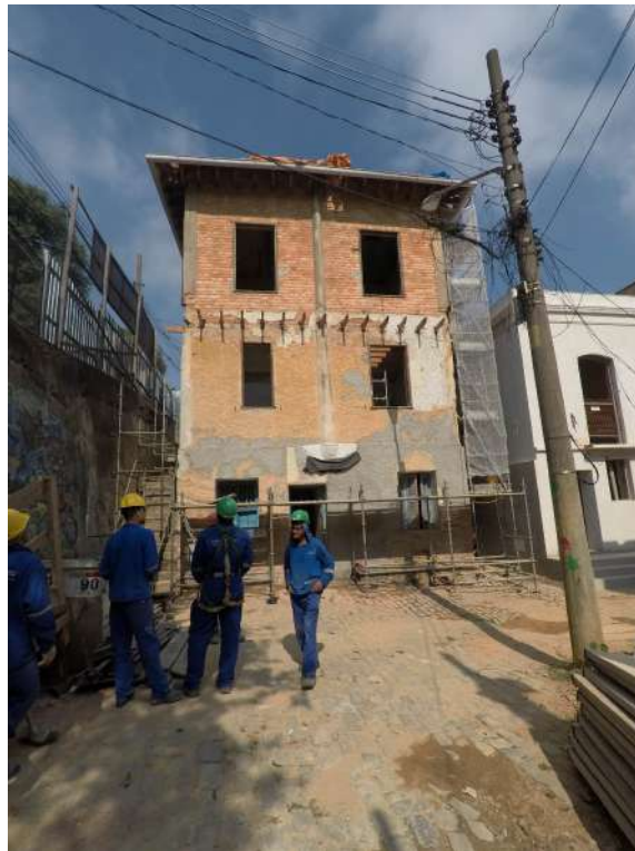
Foto 01 – Remontagem do andaime –Seguindo solicitação do ministério do trabalho
