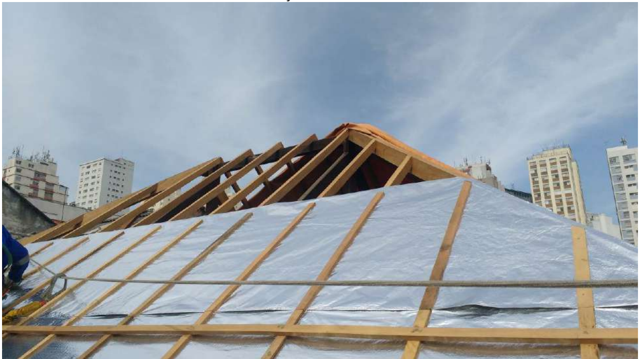
Foto 24- Instalação das manta de alumínio
