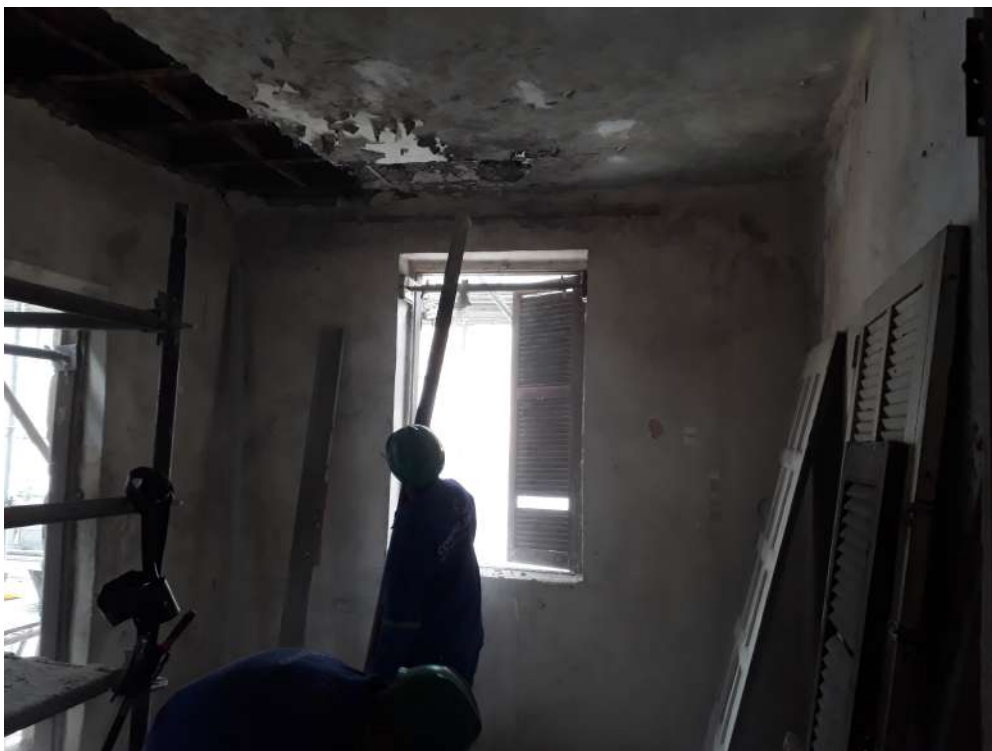
Foto 01 – Remoção dos forros de estuque danificados
