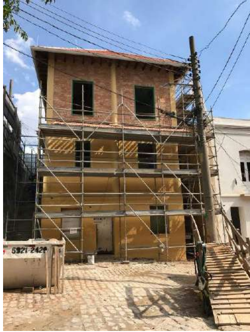
Foto 07 – Desmontagem do andaime fachadeiro
