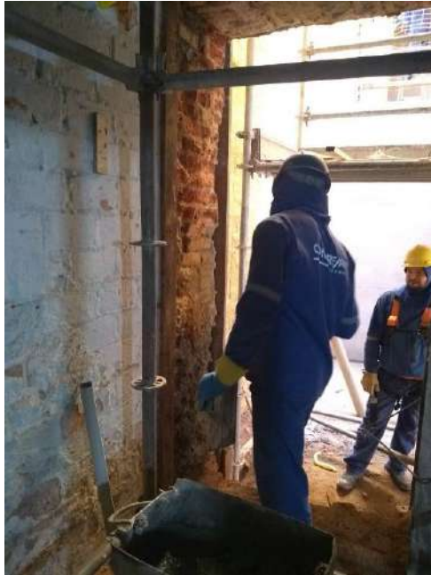
Foto 17 – abertura da porta conforme orientação do projeto
