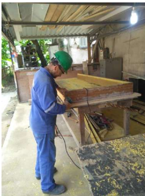
Foto 04 – Execução dos batentes de madeira
