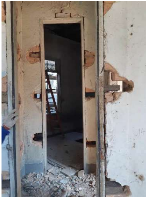
Foto 19 – Ajustes dos batentes de madeira
