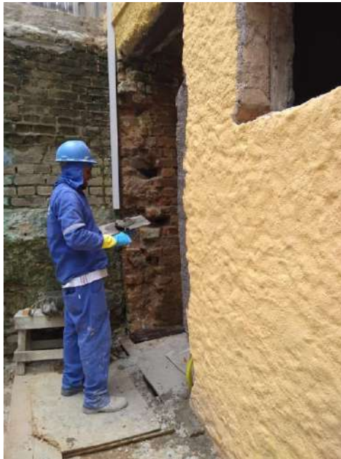
Foto 05- Execução do emboço do batente
