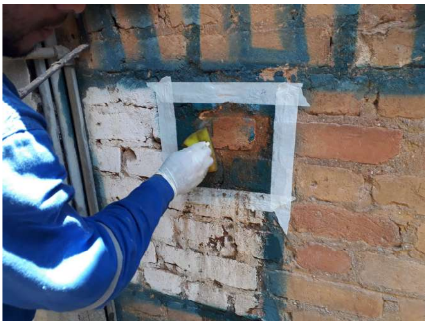
Foto 1 – Teste de remoção da pichação da fachada principal – Casa 07
