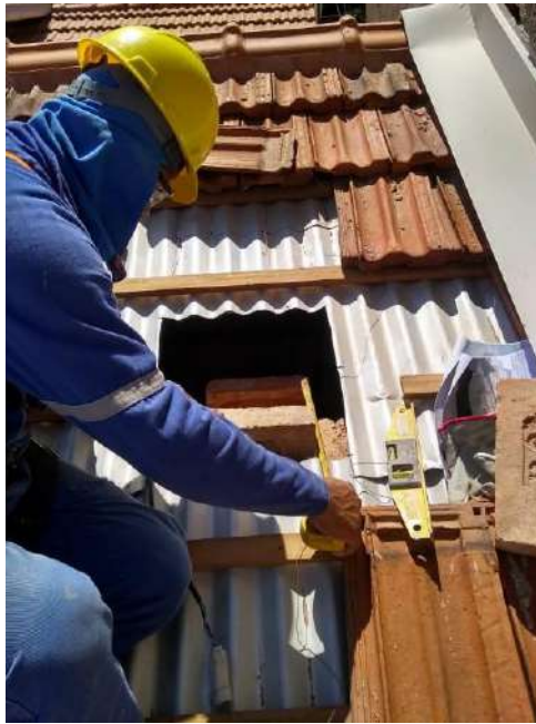
Foto 16 – Execução da chaminé na cobertura
