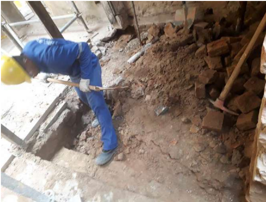
Foto 09 – Escavação manual do solo e execução de viga baldrame
