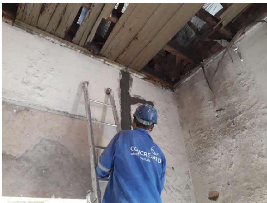
Foto 49 – Fechamento das aberturas feitas para instalação da tubulação
