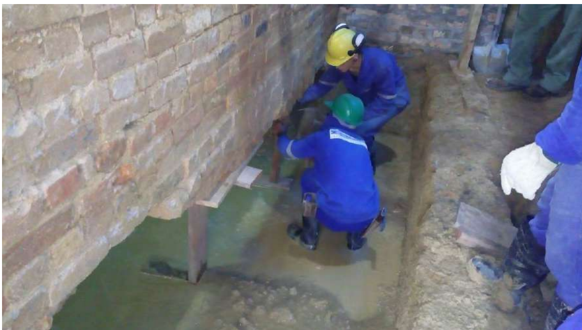
Foto 05 – Instalação do escoramento – Casa 07
