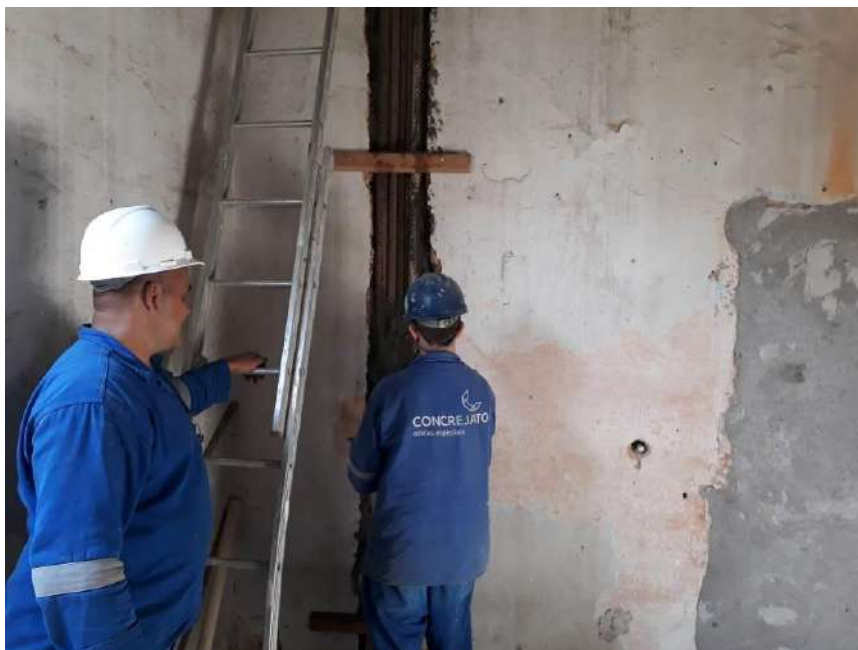
Foto 47 – Instalação das tubulações de alimentação da caixa d'água
