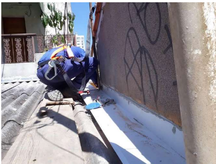
Foto 41 – Instalação do rufo na divisa com o vizinho da Rua Maestro Cardim
