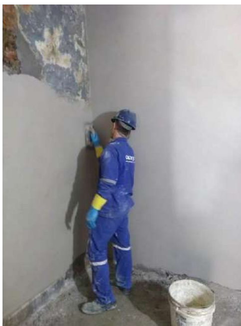
Foto 13 – Execução da argamassa de acabamento das paredes internas
