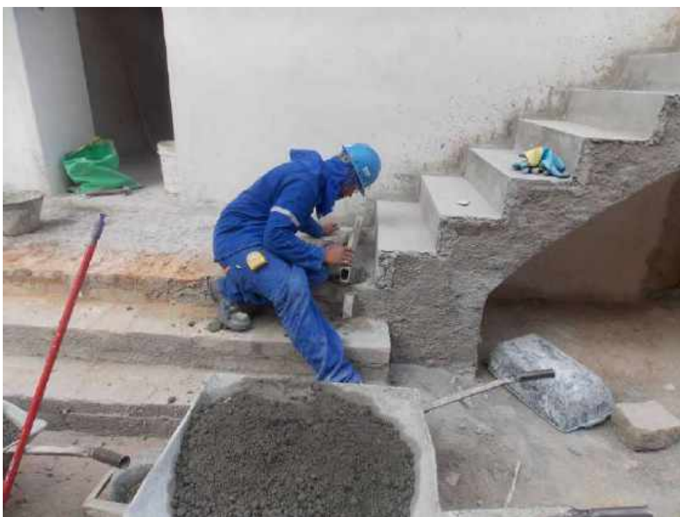
Foto 52 – Regularização da escada – Casa 06
