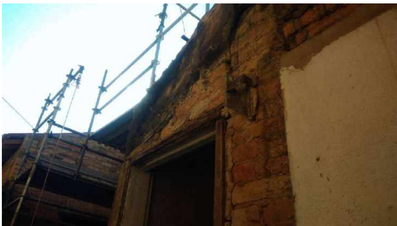
Foto 06: Vista geral da fachada dos fundos;
