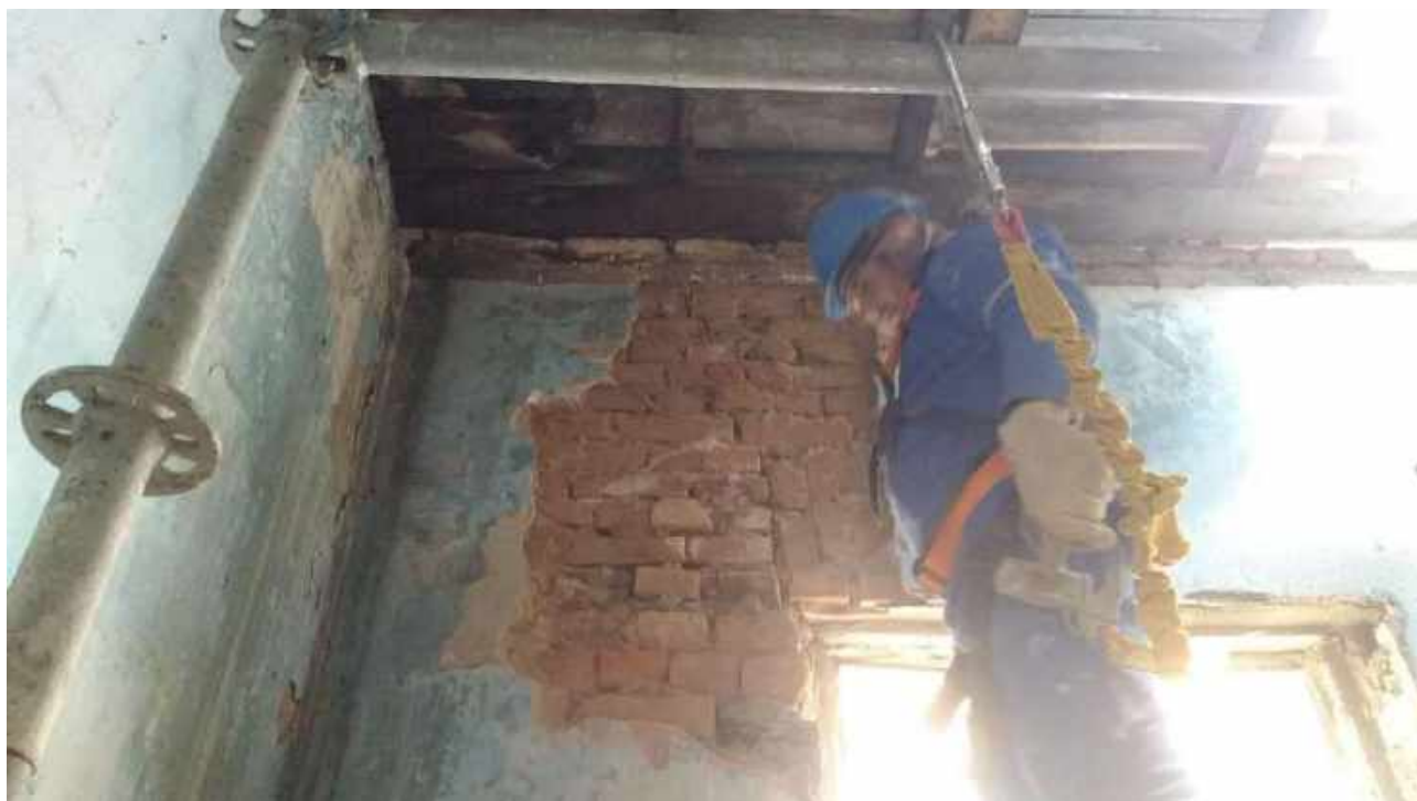
Foto 33: Consolidação das alvenarias – Casa 06.
