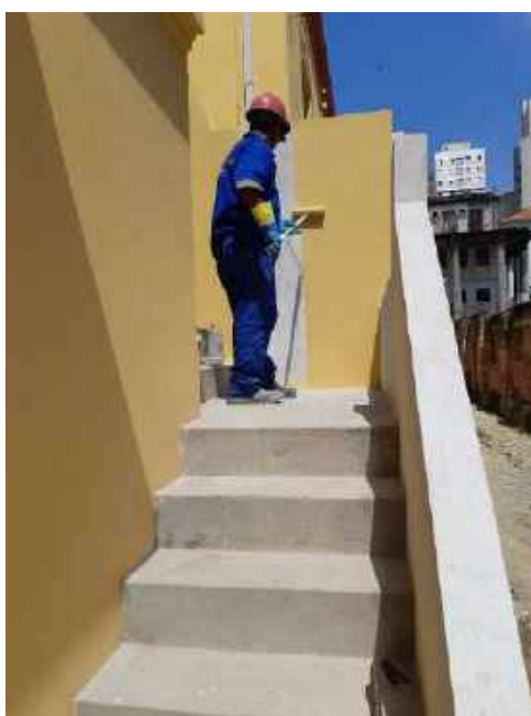
Foto 04 – Pintura lisa com tinta mineral guarda corpo lateral – Casa 06
