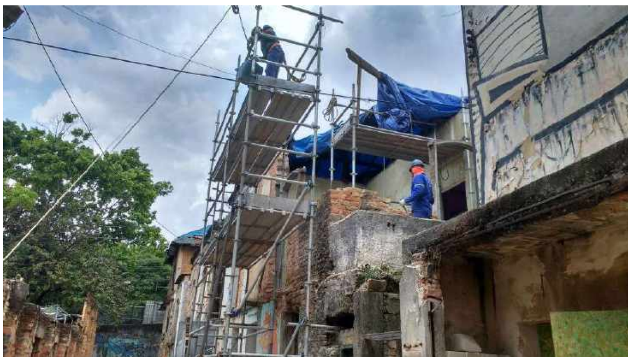
Foto 24: : Desmontagem cuidadosa da alvenaria com reaproveitamento de tijolos – Casa 6.
