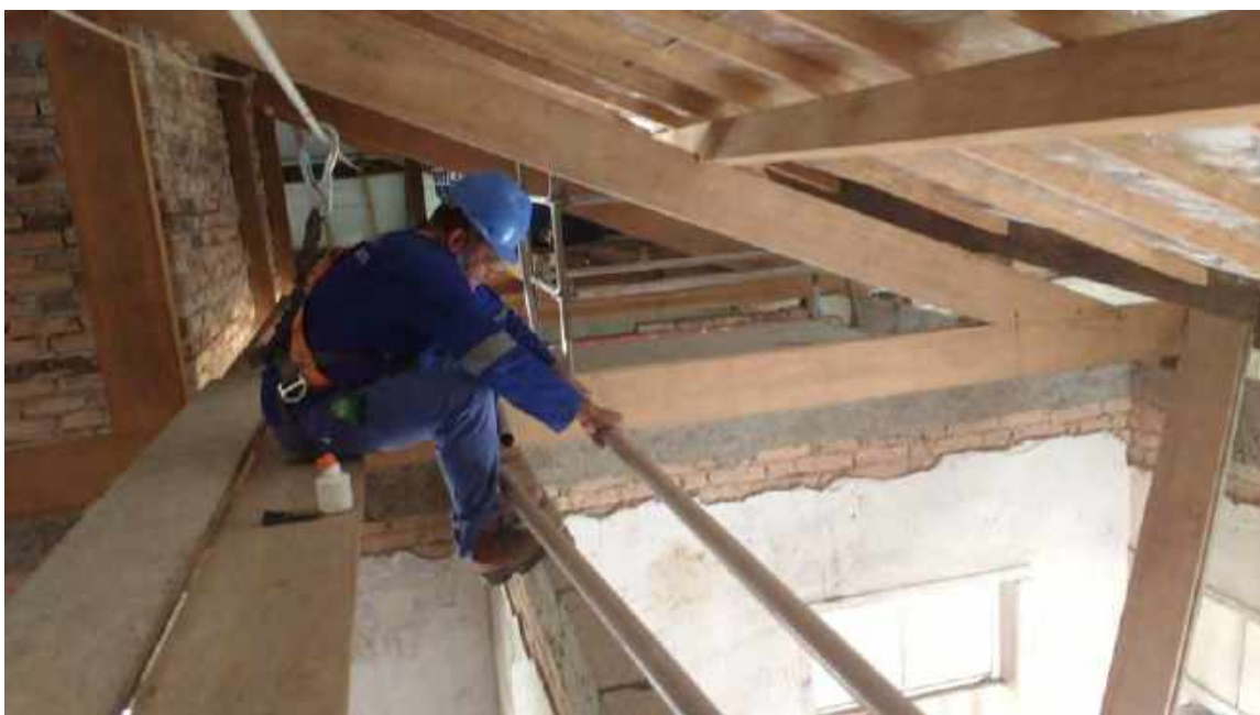
Foto 46 - Instalação das tubulações para instalação da caixa d'água casa 06
