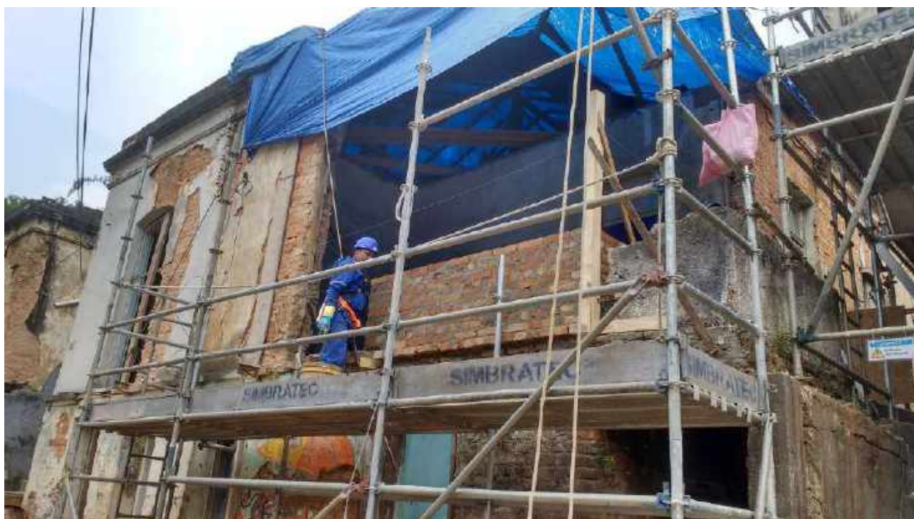
Foto 25: Remontagem da alvenaria.
