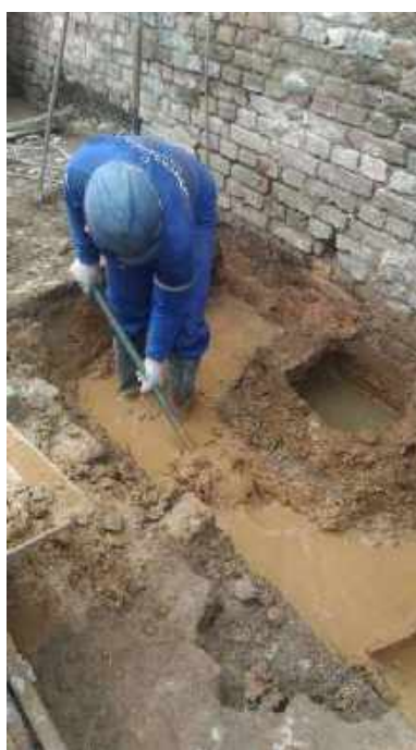
Foto 14: Abertura de vala para reforço na fundação – Casa 6.
