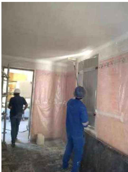
Foto 23 – Execução da pintura lisa do forro – Casa 05
