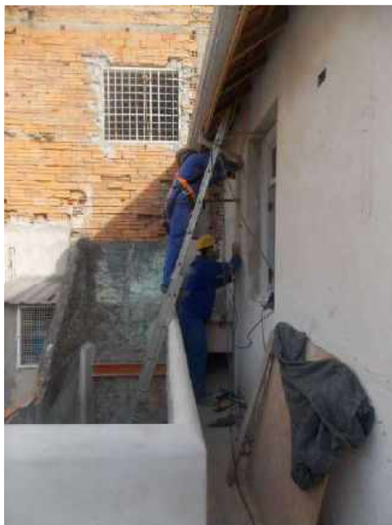
Foto 17 – Instalação das descidas de água – Casa 05
