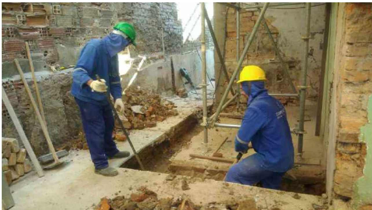
Foto 03: Abertura de vala;
