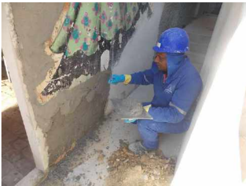
Foto 03 – Execução do emboço da fachada lateral – Casa 05
