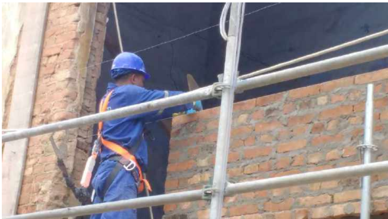
Foto 26: Remontagem da alvenaria.
