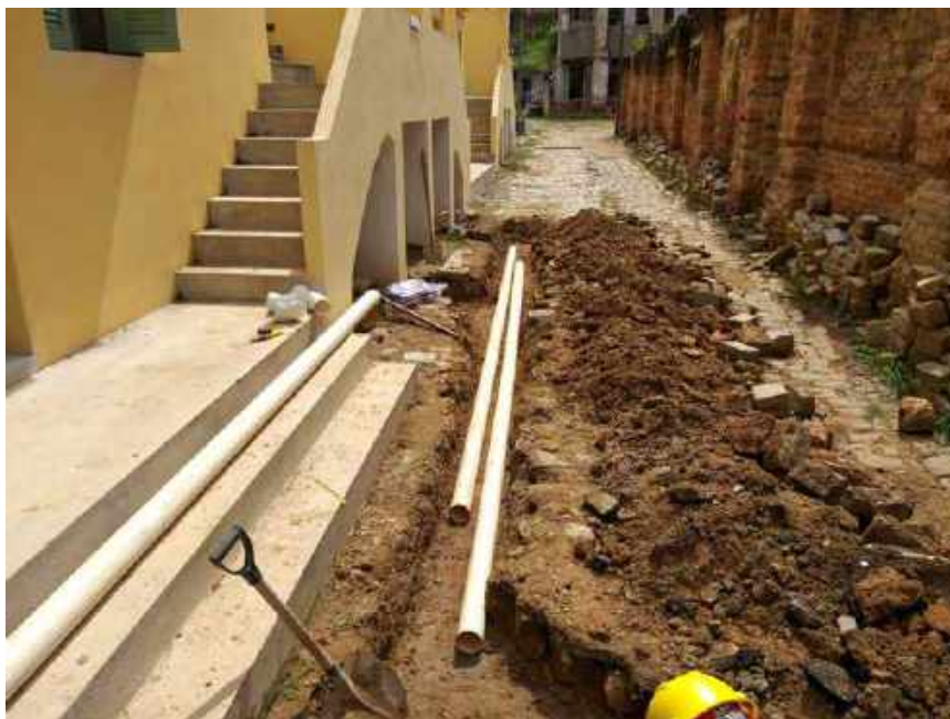
Foto 15 – Instalação das tubulações nas caixas pluviais
