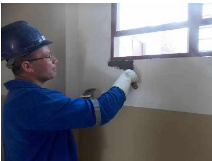
Foto 04 – Fechamento dos vãos das janelas metálicas – Casa 06
