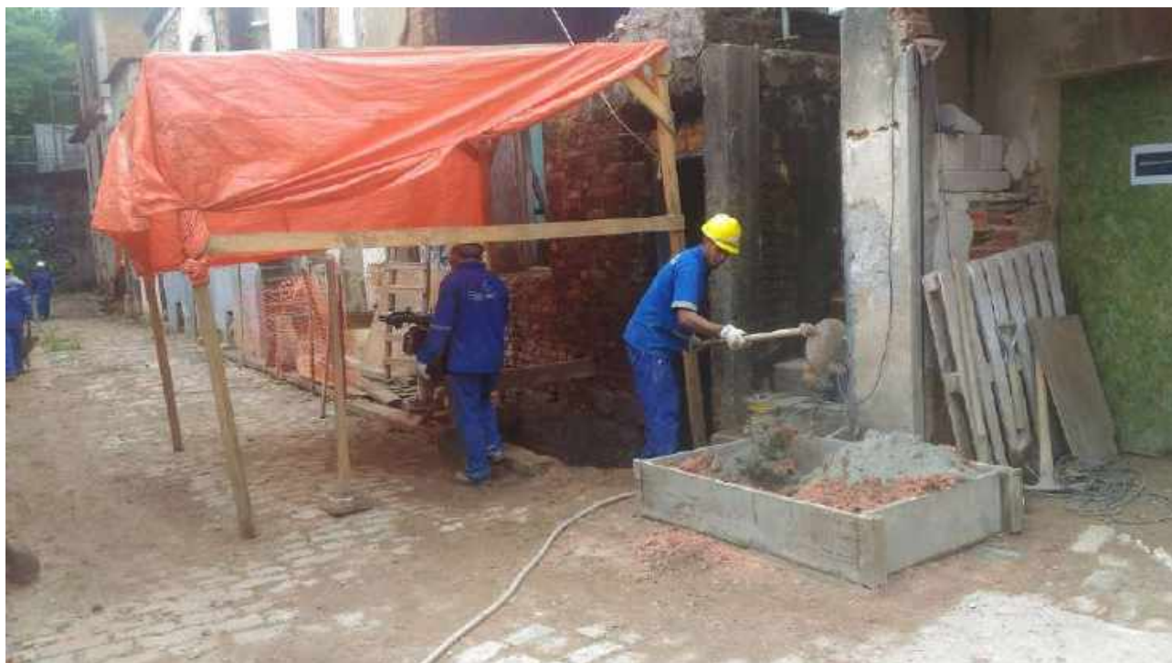
Foto 07: Compactação com solocimento.
