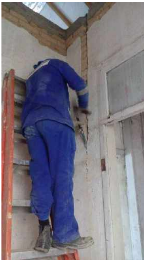
Foto 30 - Abertura para passagem de infra de eletrica – Casa 06
