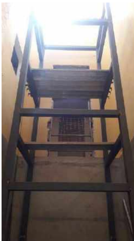
Foto 43 – Montagem da estrutura metálica da plataforma elevatória
