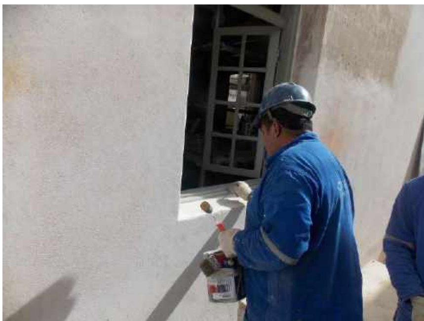
Foto 06 – Pintura lisa das esquadrias de madeira – Casa 05
