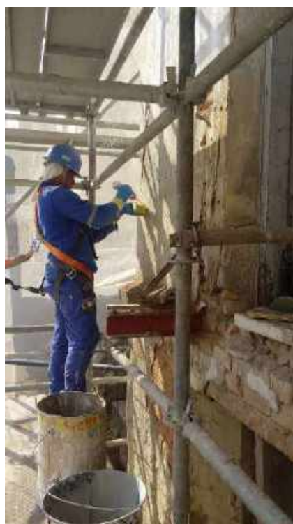
Foto 20 – Consolidação da fachada – Casa 06
