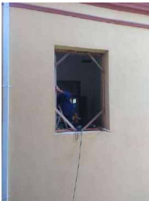
Foto 38 – Instalação dos batentes de madeira
