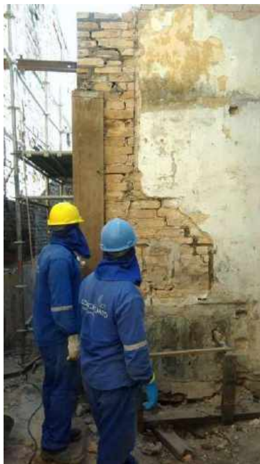
Foto 81: Escoramento e consolidação das alvenarias.
