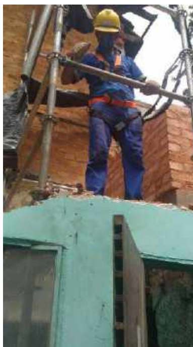
Foto 08: Demolição dos anexos improvisados nos fundos da Casa 6.
