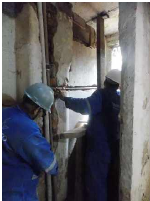
Foto 16 – Instalação da tubulação hidráulica – Casa 06
