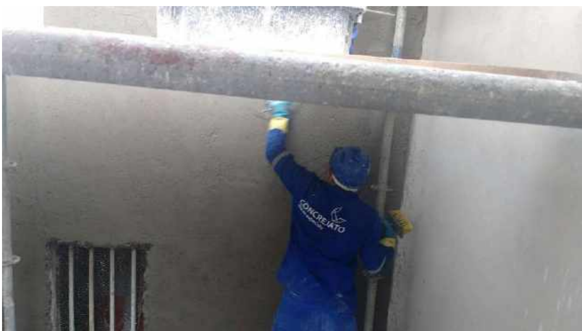
Foto 50 – Execução do emboço na fachada – Casa 05
