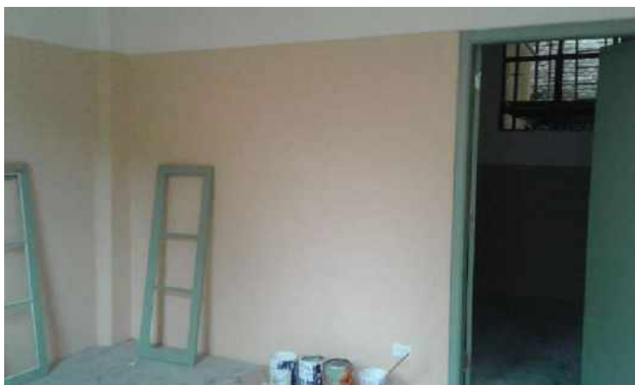
Foto 42– Pintura de acabamento interno – Casa 06
