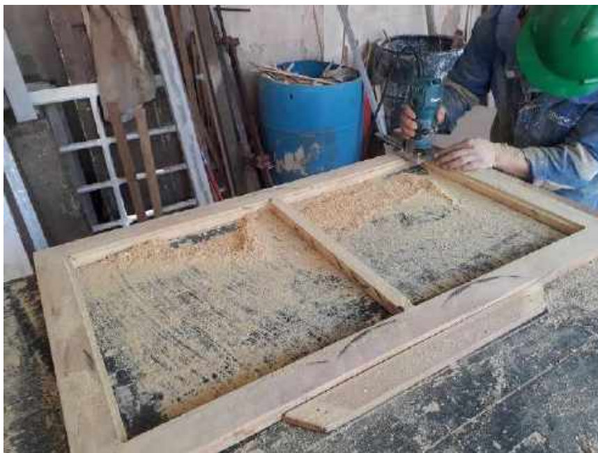
Foto 12 – Execução das esquadrias de madeira – Casa 06
