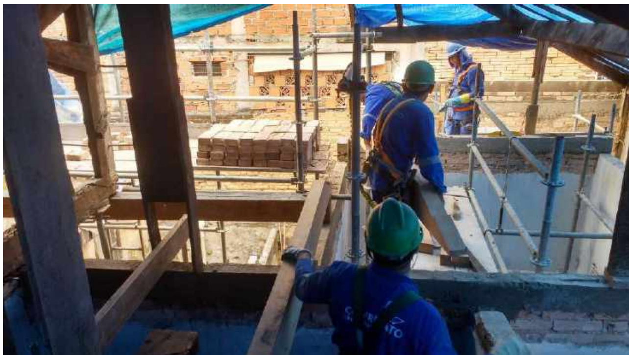
Foto 23: Substituição das peças danificadas da tesoura da Casa 6.
