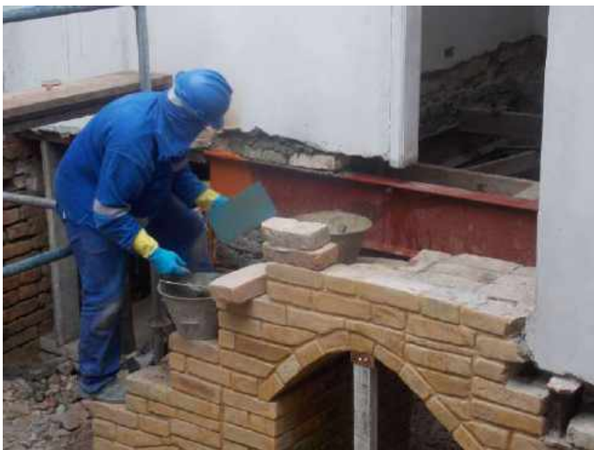
Foto 45 – Instalação d o perfil metálico – Casa 06
