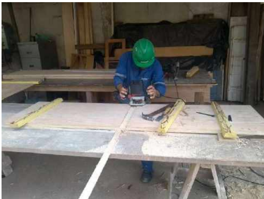
Foto 17 – Execução das portas de madeira – Casa 06
