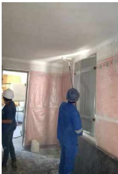
Foto 24 – Execução da pintura lisa do forro – Casa 05
