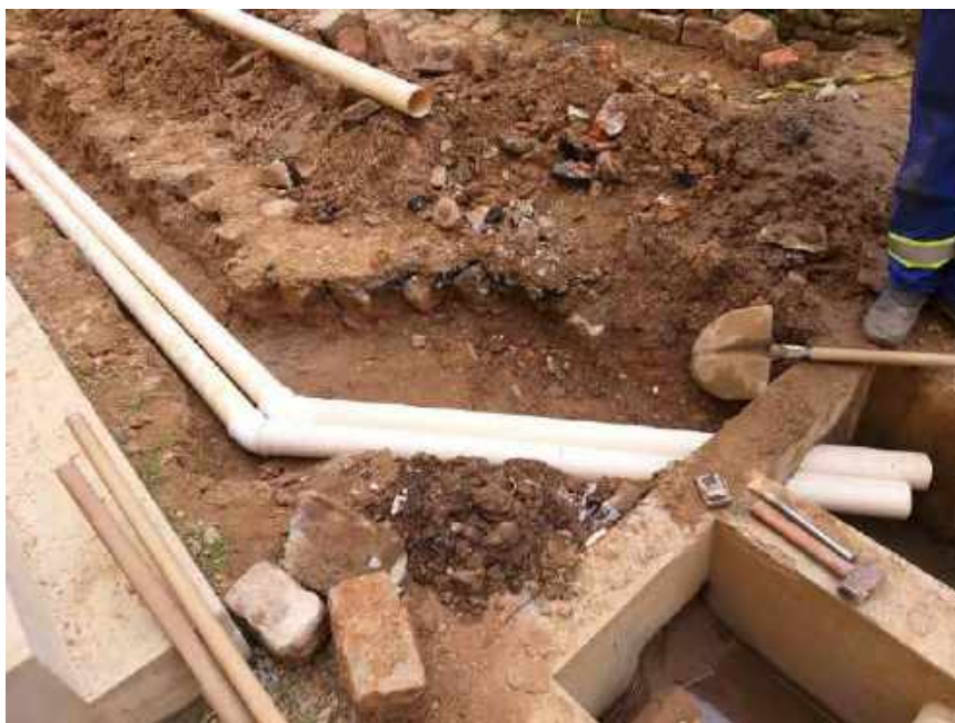
Foto 10 – Instalação da tubulação para caixa de passagem
