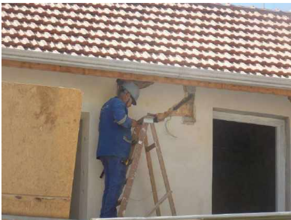
Foto 08 – Instalação dos cabos para execução da elétrica fachada lateral – Casa 0
