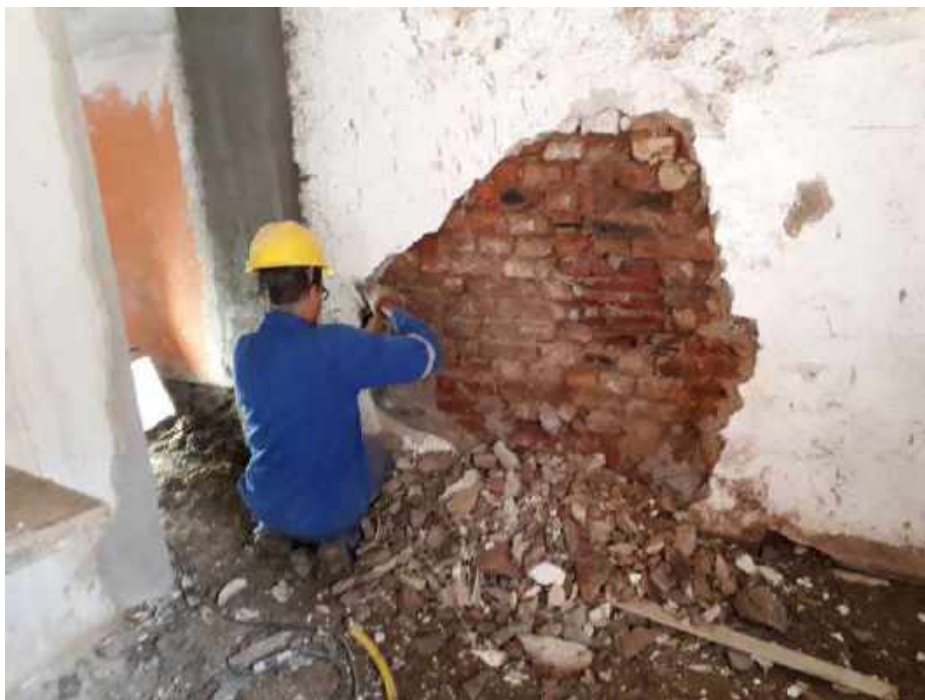
Foto 07 – Remoção do revestimento antigo – Casa 05
