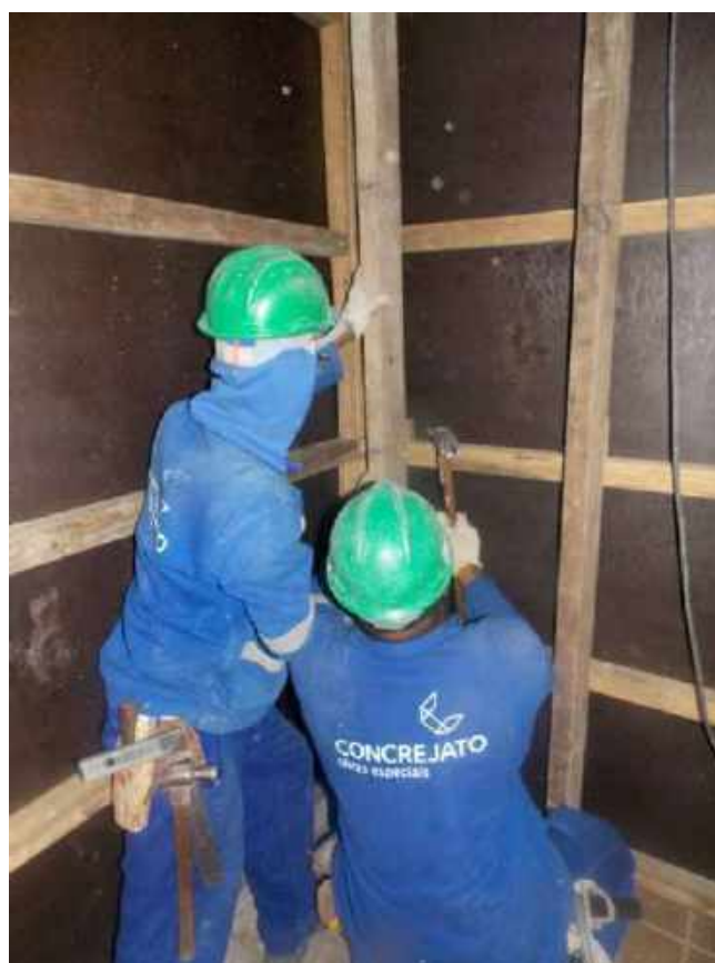
Foto 56 – Execução da forma para concretagem da cortina – Casa 0
