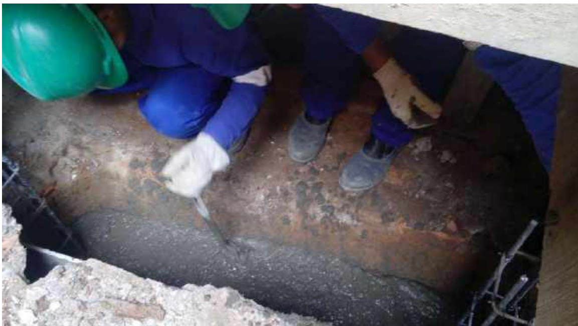
Foto 08 – Concretagem da fundação – Casa 06
