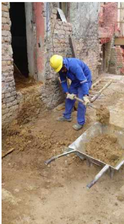
Foto 27 – Remoção dos entulhos – Casa 06
