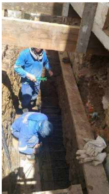
Foto 08: Armação dos blocos de fundação.
