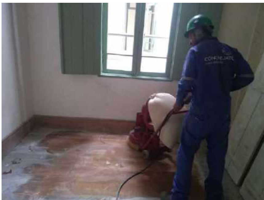
Foto 14 – Lixamento dos assoalhos de madeira – Casa 06
