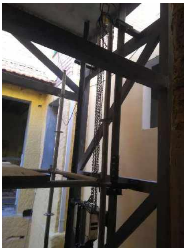
Foto 47 - Montagem da plataforma elevatória
