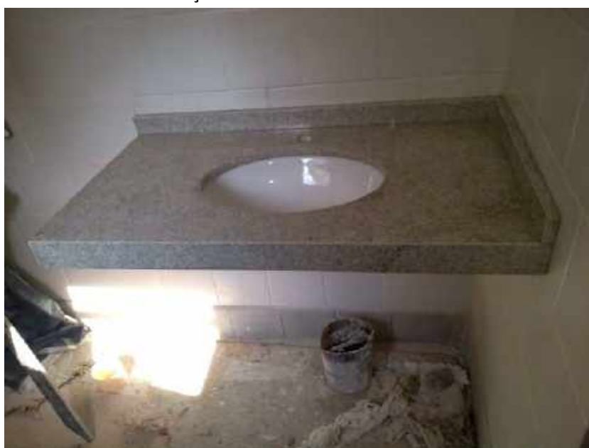
Foto 64 – Instalação das bancadas dos banheiros da Casa 5
