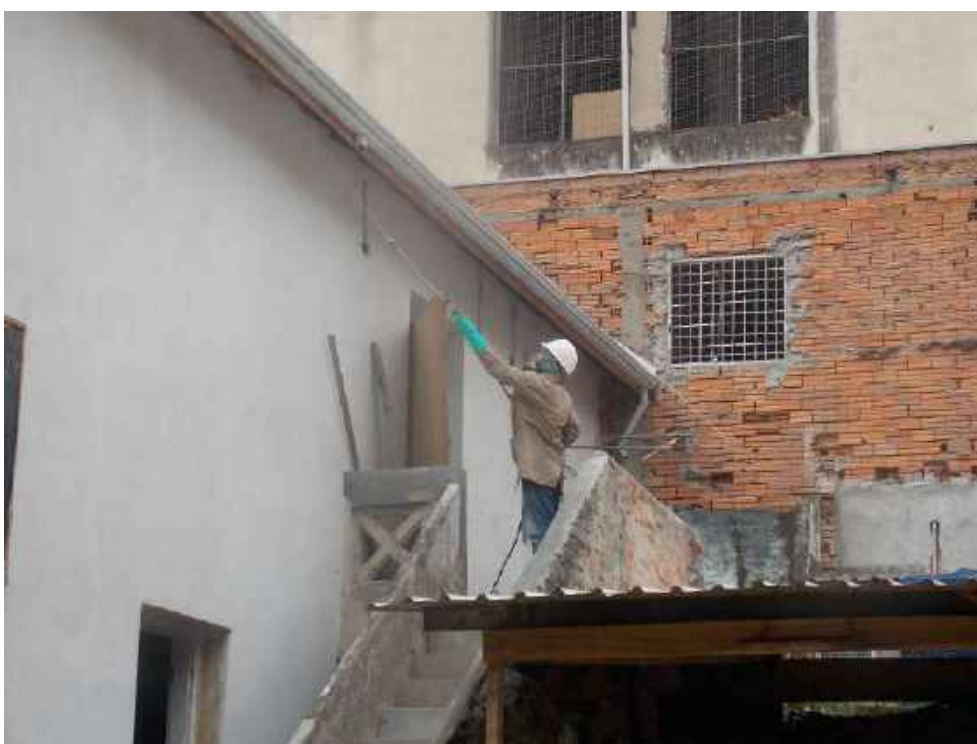
Foto 02 – Execução da descupinização – Casa 05
