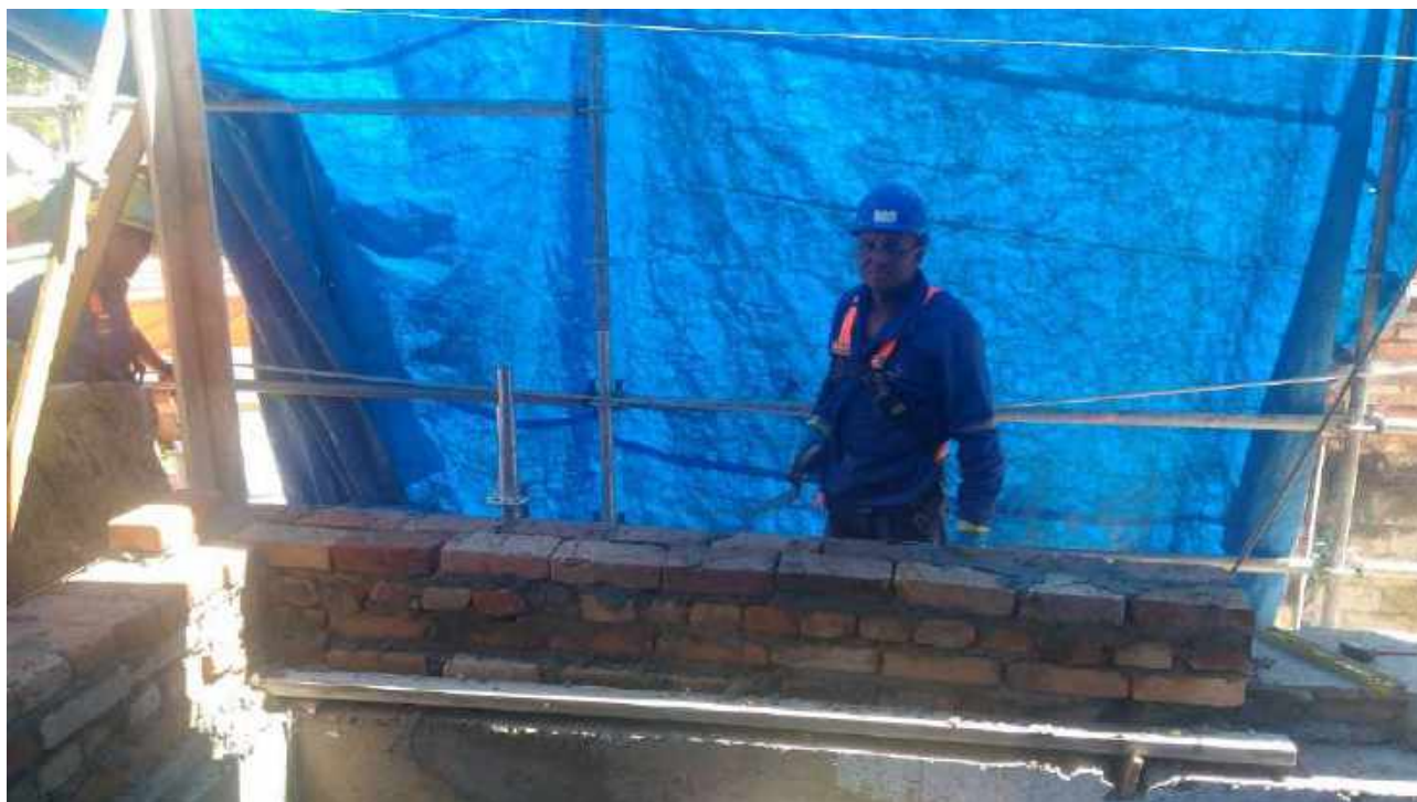
Foto 10: Remontagem da alvenaria – Casa 6.
