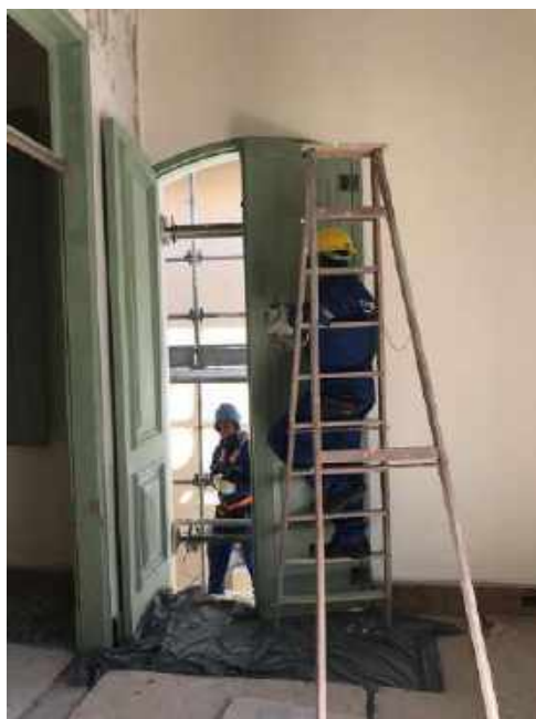
Foto 25 – Execução da pintura lisa das portas de madeira – Casa 06
