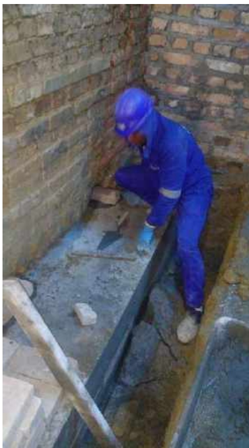
Foto 13 – execução do acabamento da alvenaria após o reforço de fundação
