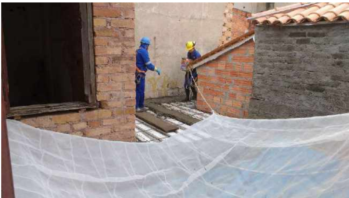
Foto 15 – Concretagem da laje – Casa 06
