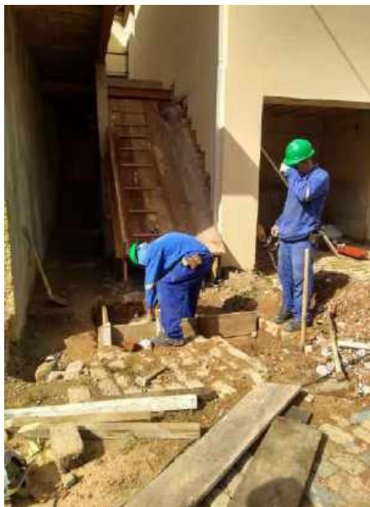
Foto 07 – Execução da forma para concretagem da escada da fachada lateral
