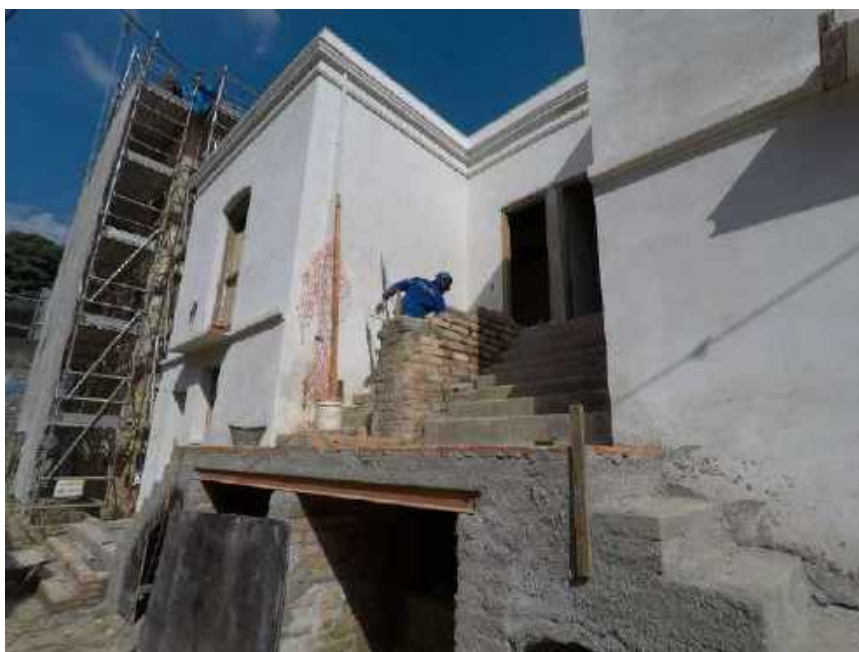
Foto 25 – Elevação da alvenaria – Casa 06
