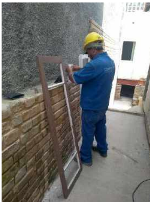
Foto 09 – Aplicação de massa para madeira nas esquadrias – Casa 06
