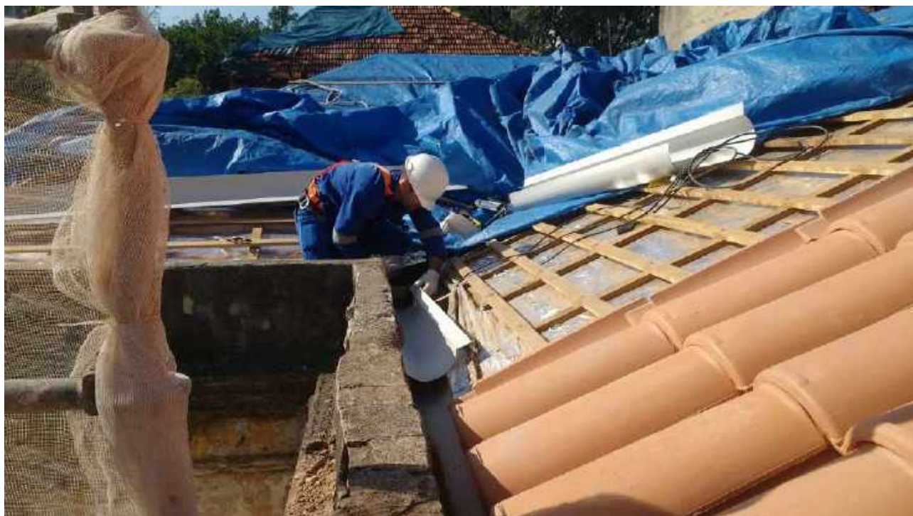
Foto 47: Instalação de calhas - Casa 06.
