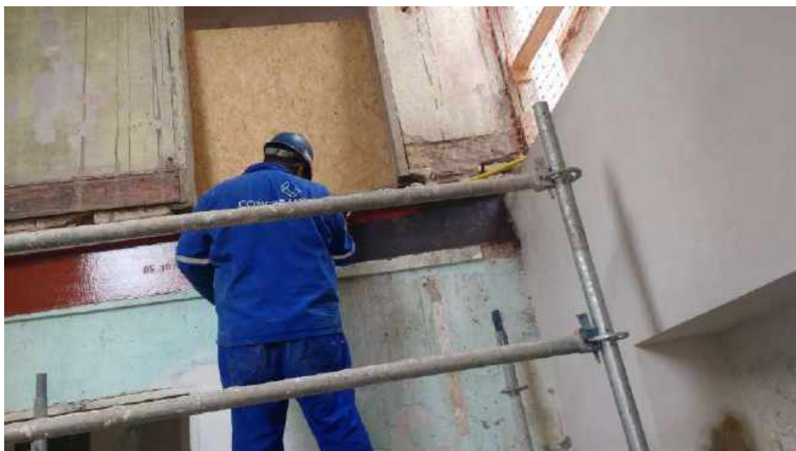
Foto 32 – Recuperação da estrutura metálica – Casa 06
