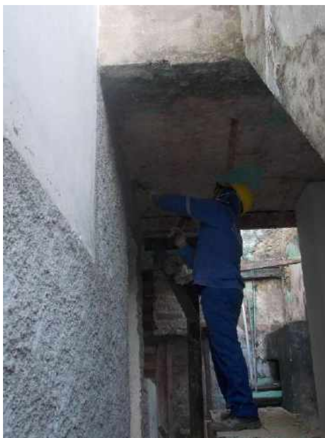
Foto 08 – Remoção do revestimento – Casa 05
