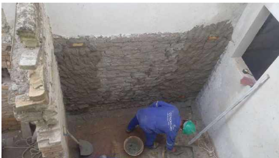
Foto 22 – Execução do chapisco da fachada lateral – Casa 06
