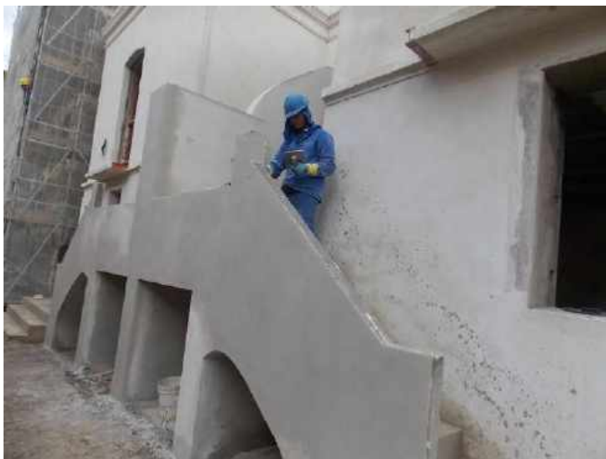
Foto 37 – Execução da argamassa de acabamento do guarda corpo da escada – Casa 06
