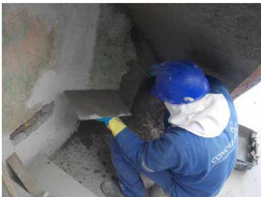
Foto 12 – Execução do emboço abaixo da escada – Casa 05
