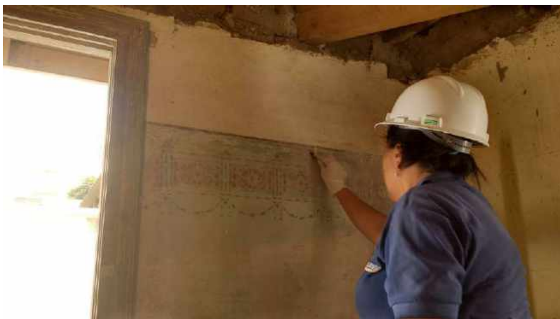
FOTO 02 DECAPAGEM MECANICA – CASA 05
