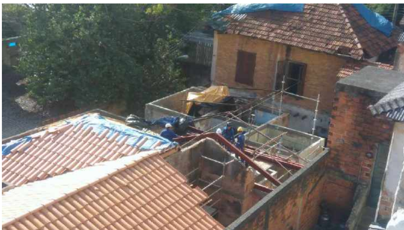
Foto 19: Instalação das tesouras metálicas;
