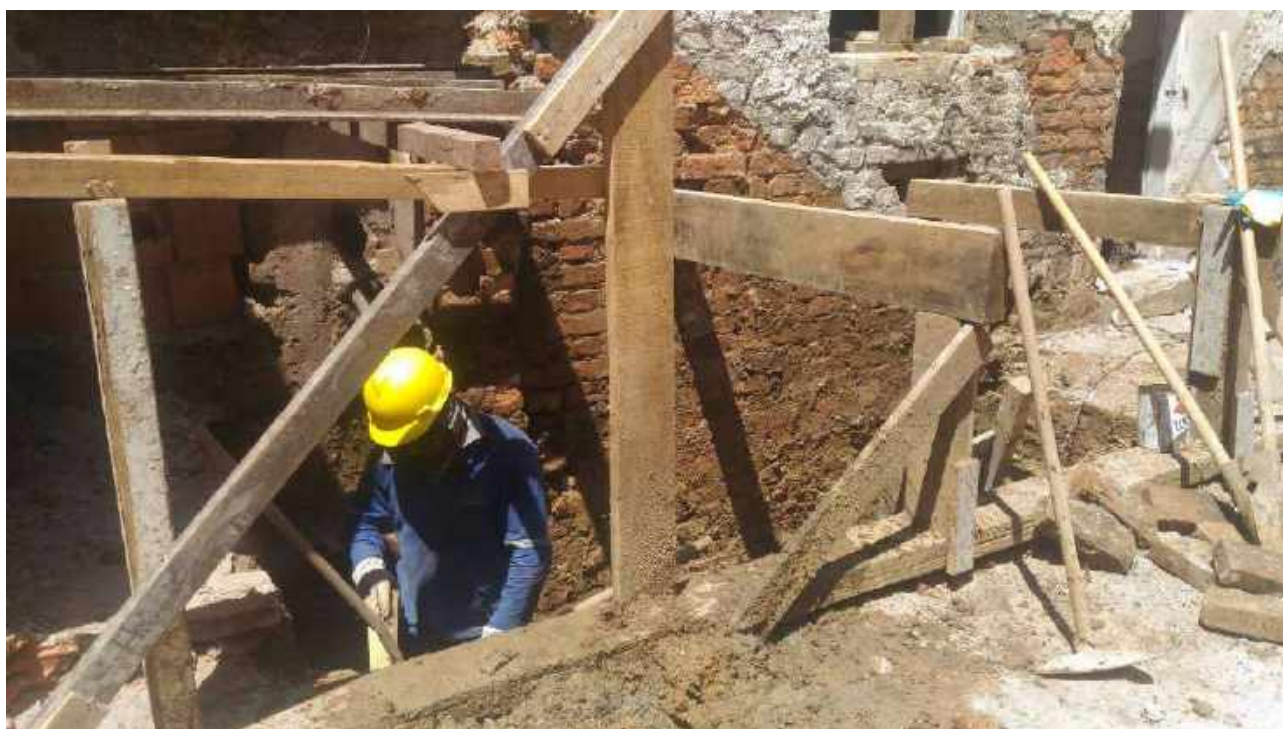
Foto 13: Abertura da vala após desmontagem da escadaria.
