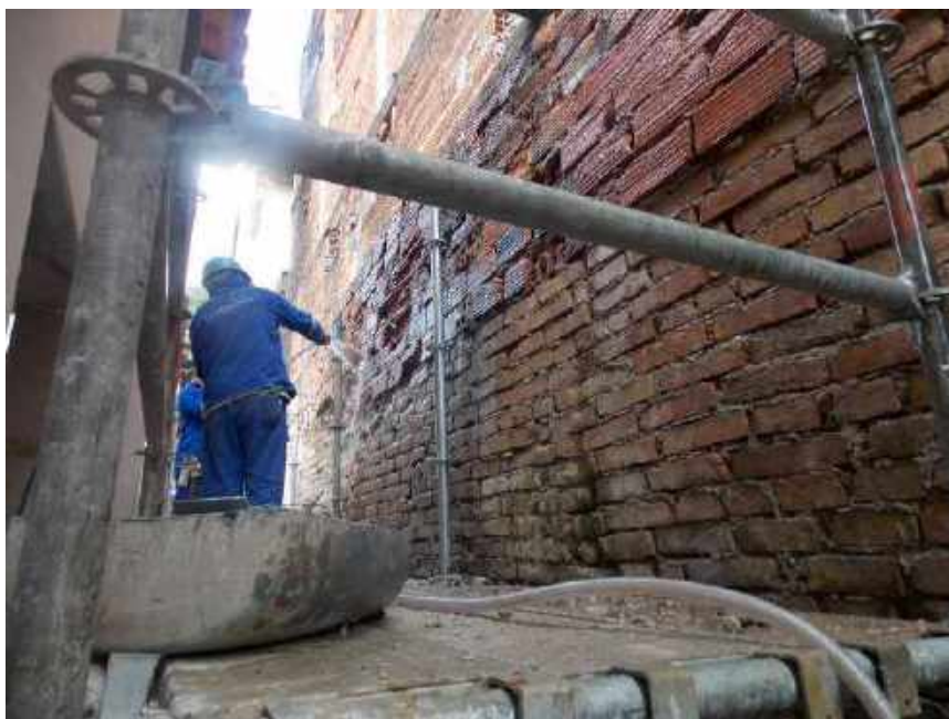
Foto 49 – Limpeza fina dos tijolos da fachada atrás – Casa 06
