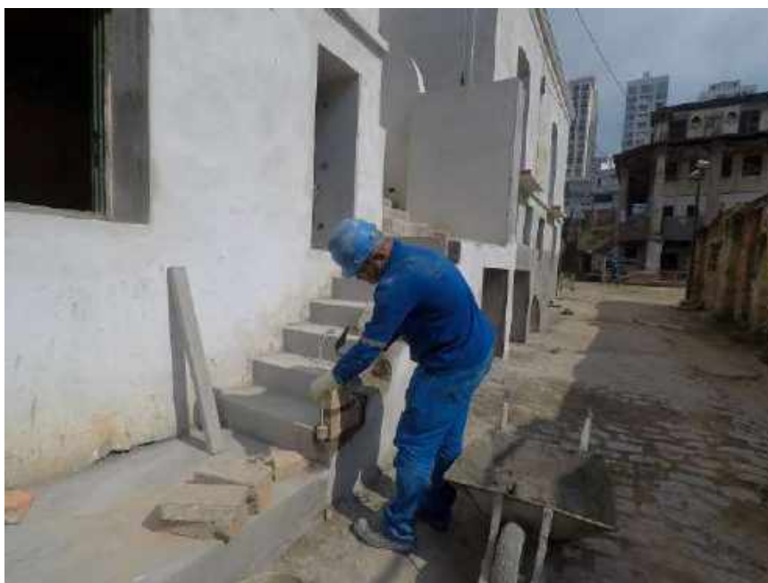
Foto 35 – Elevação da alvenaria – Casa 06
