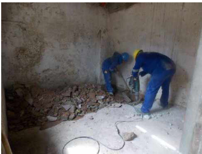
Foto 13 – Execução da escavação mecânica – Casa 06
