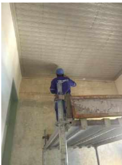
Foto 15 – Instalação do roda-teto
