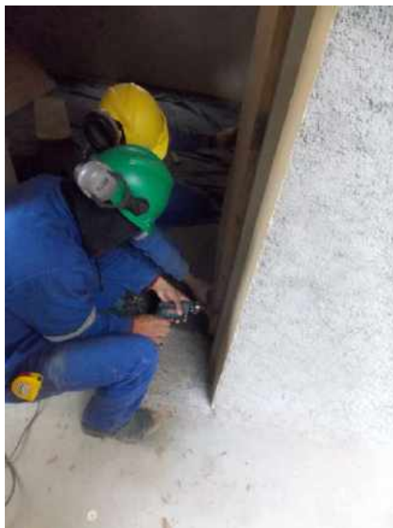
Foto 07 – Instalação das portas de madeira – Casa 05
