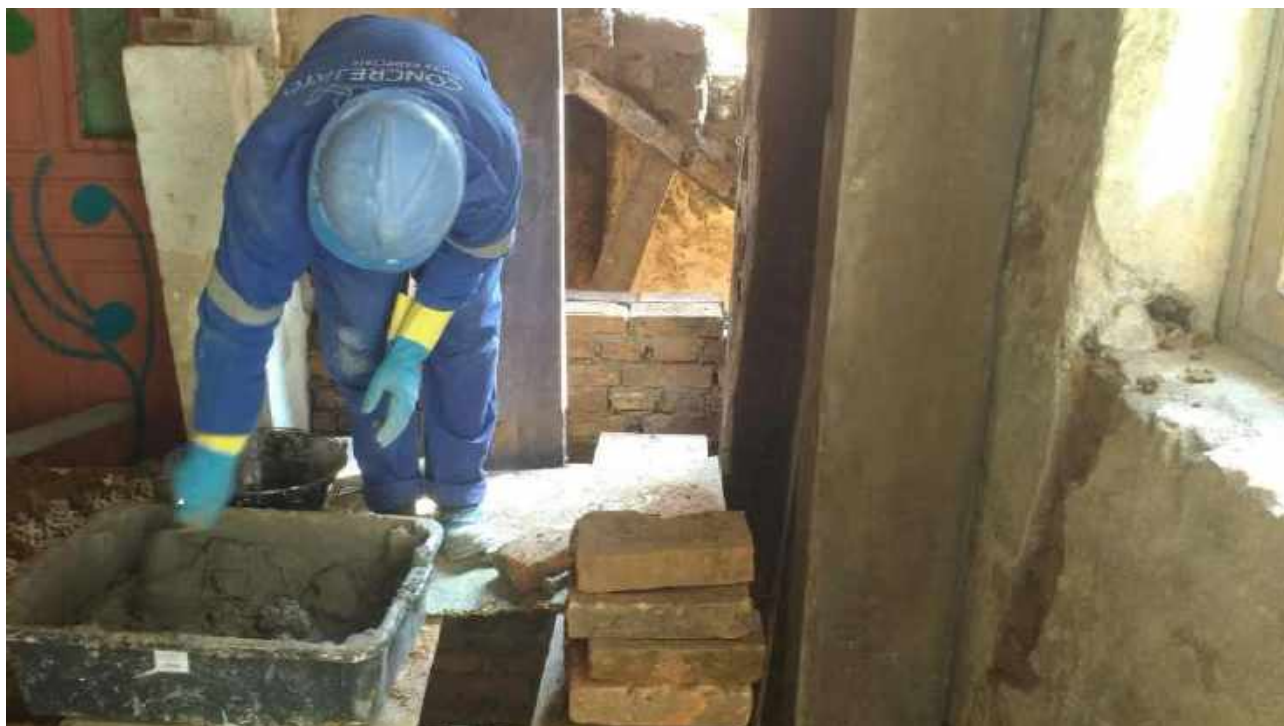
Foto 21: Remontagem da alvenaria danificada – Casa 6.
