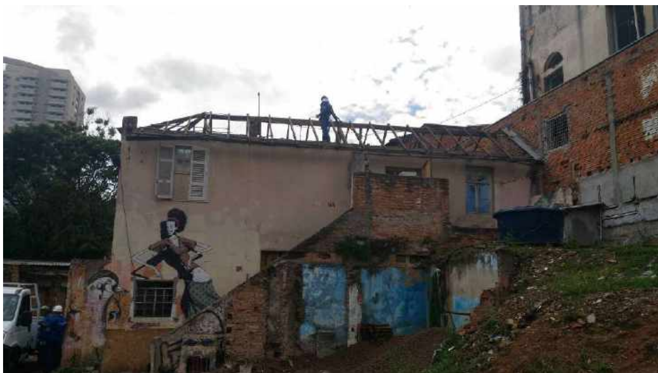
Foto 06: Remoção das telhas, caibros e ripas da Casa 5.
