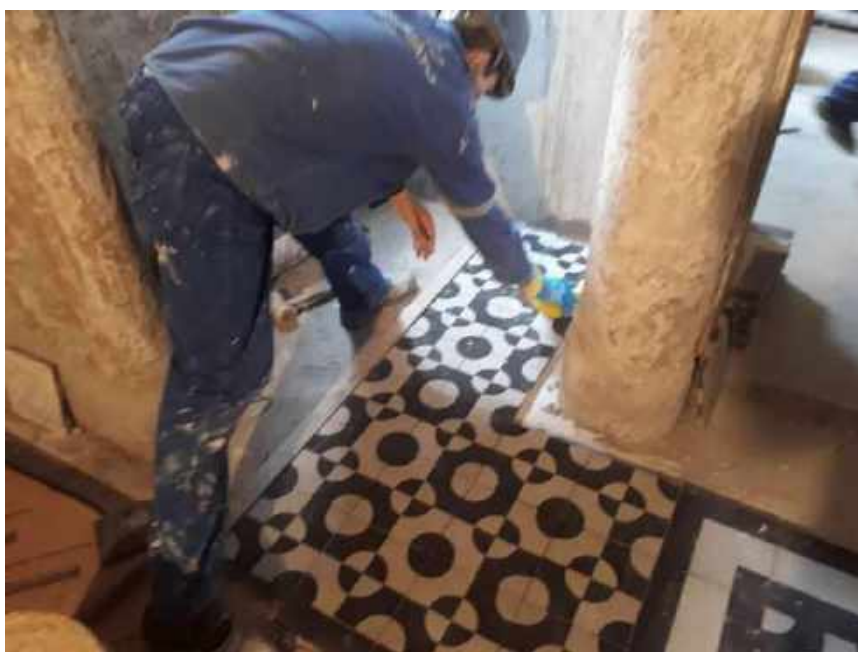
Foto 04 – Instalação dos ladrilhos hidráulicos – Casa 06
