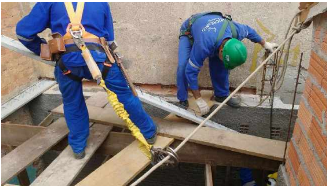
Foto 13 -Execução da laje – Casa 06
