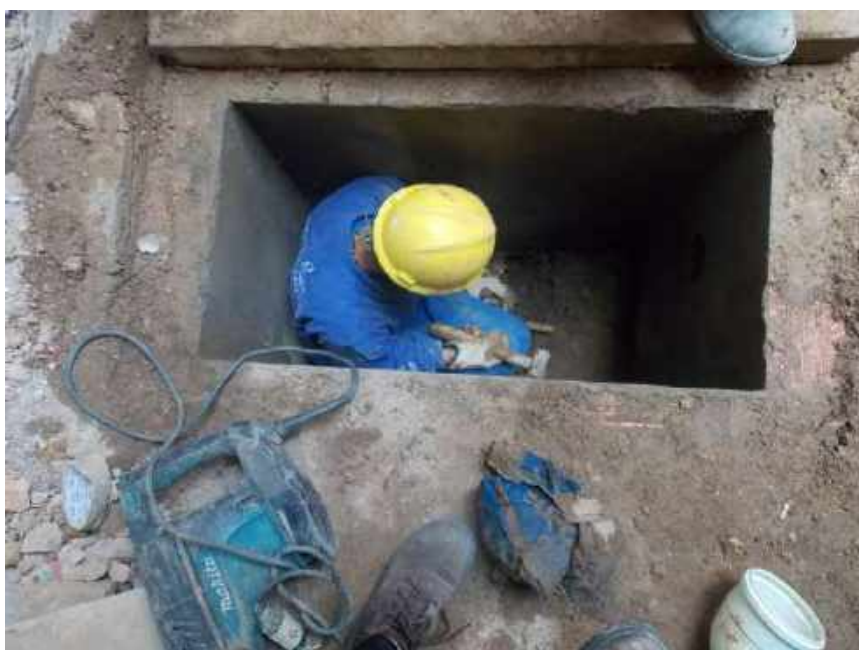
Foto 44 – Instalação da tubulação nas caixas pluviais – Casa 06
