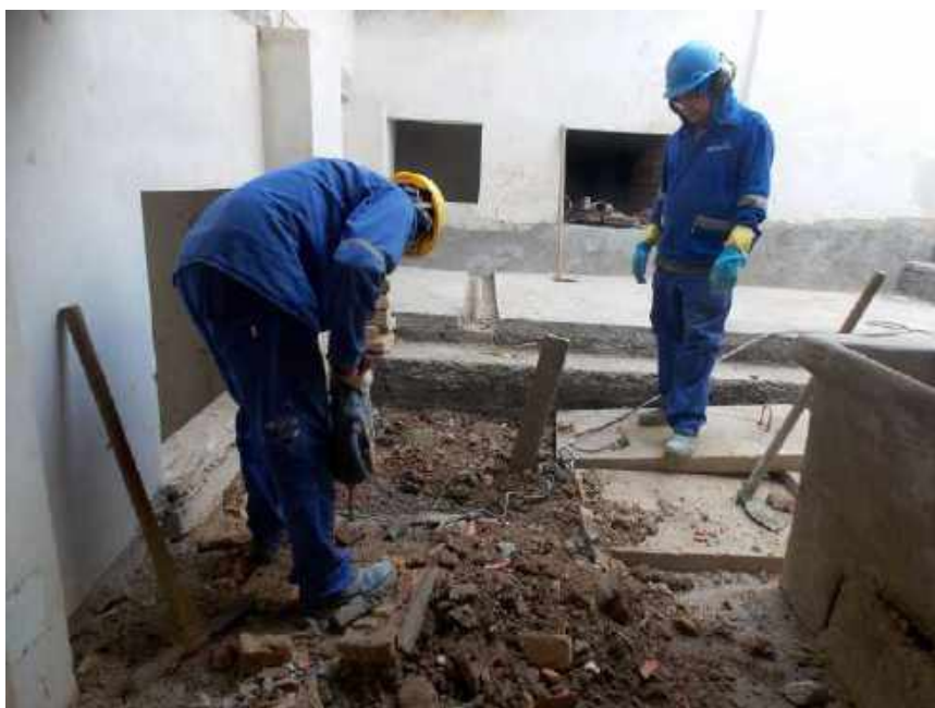
Foto 47 – Escavação mecânica para tratamento da alvenaria existente – Casa 06
