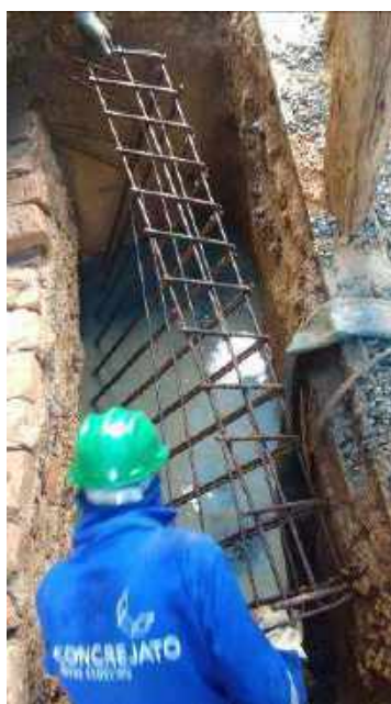
Foto 12: Execução de bloco de reforço – Casa 06.
