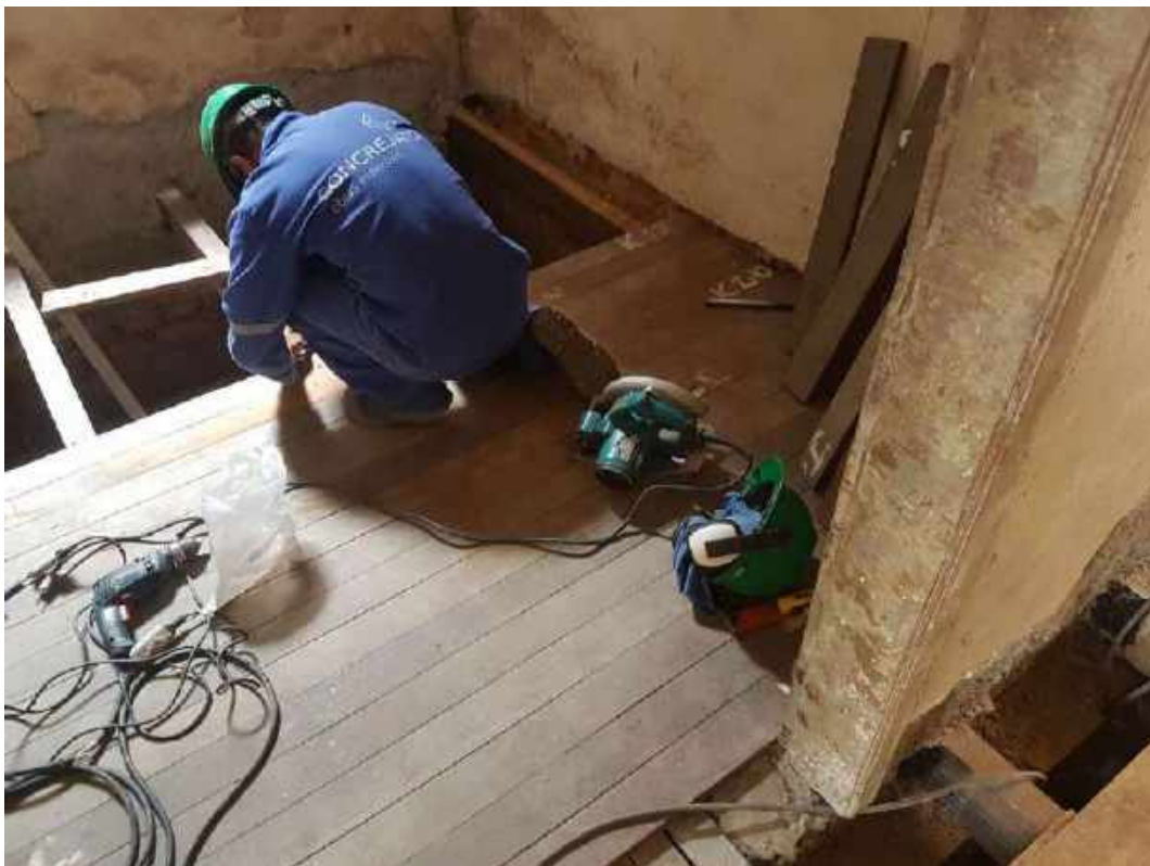
Foto 35 – Instalação dos assoalhos de madeira – Casa 06
