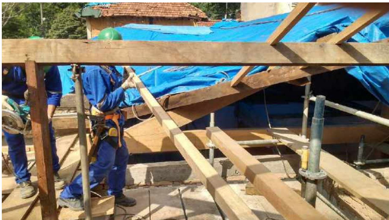
Foto 33: Instalação dos caibros.
