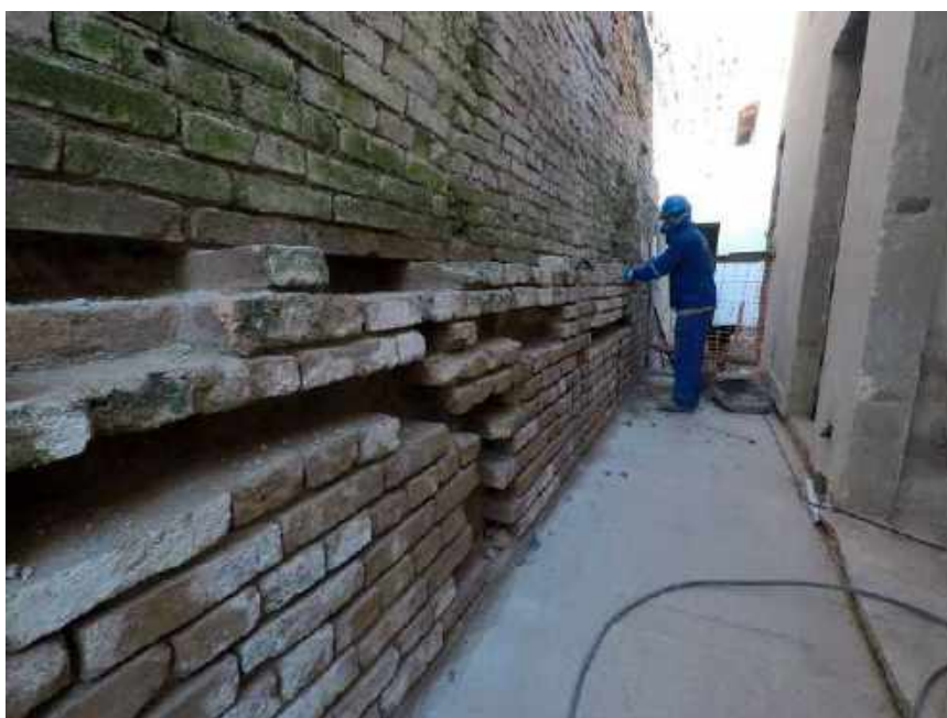
Foto 30 – Restauração dos tijolos da fachada atrás – Casa 06
