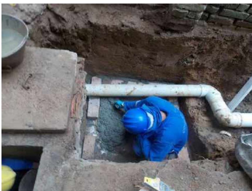
Foto 42 – Fechamento das passagens das tubulações – Casa 06
