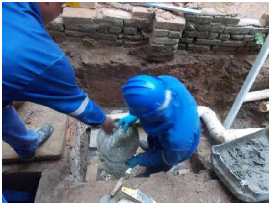
Foto 41- Fechamento das passagens das tubulações – Casa 06
