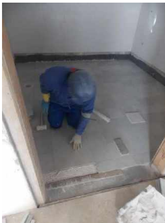
Foto 44 – Instalação dos pisos em ladrilho hidráulico - Casa 06
