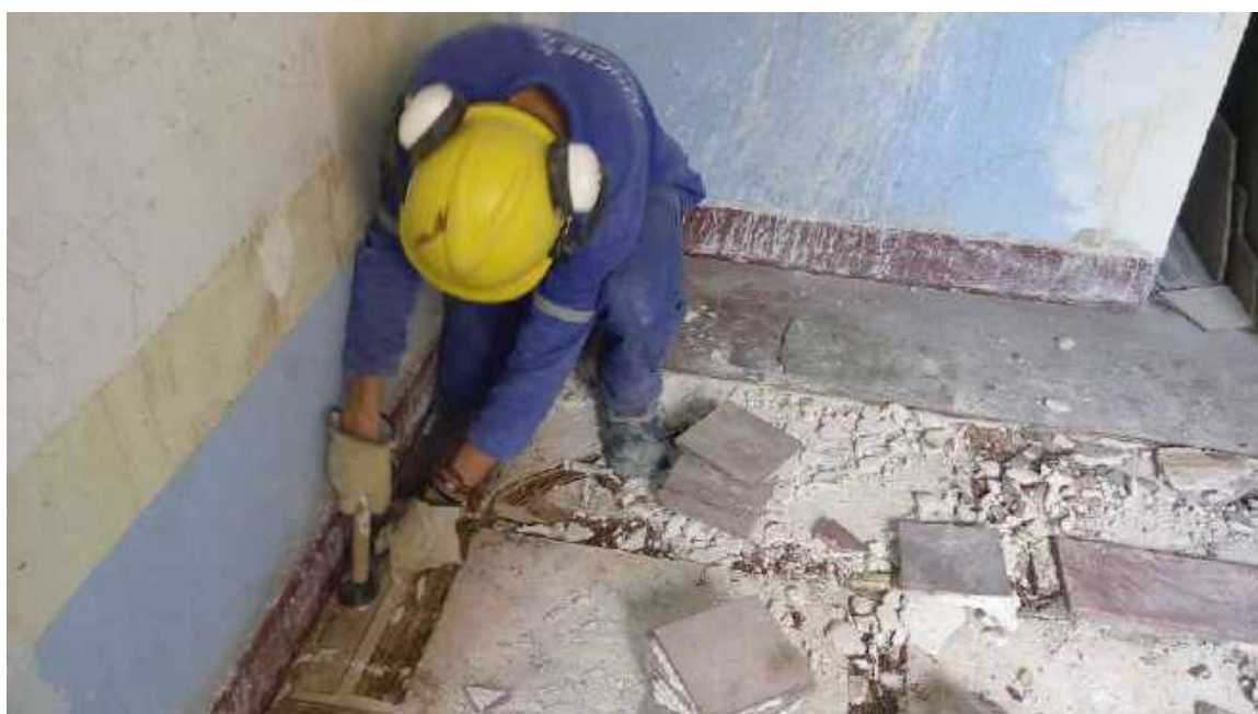
FOTO 06 – REMOÇÃO CUIDADOSA DO PISO DE LADRILHO HIDRAULICO – CASA 05
