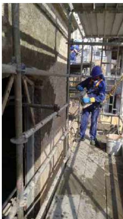
Foto 22 – Execução do embolso na fachada - Casa 06
