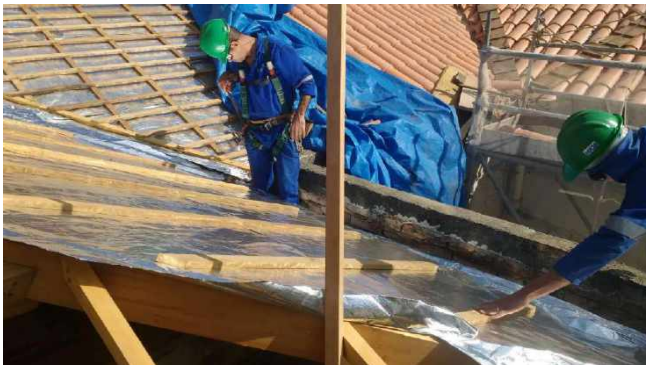
Foto 45: Instalação de manta aluminizada. Casa 06.
