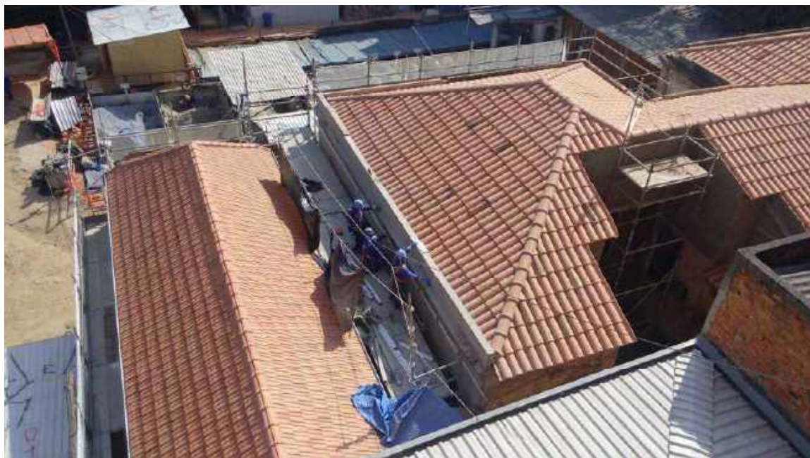
Foto 41 – Execução da argamassa de acabamento no topo da platibanda da casa 06
