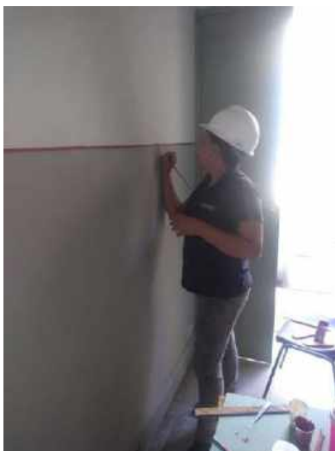
Foto 13 – Execução dos filetes – Casa 06
