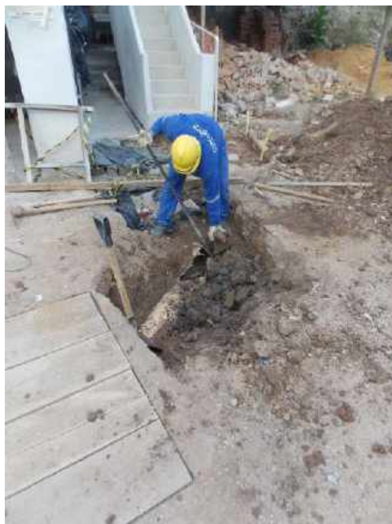
Foto 17 – Escavação manual para troca da tubulação – Casa 05
