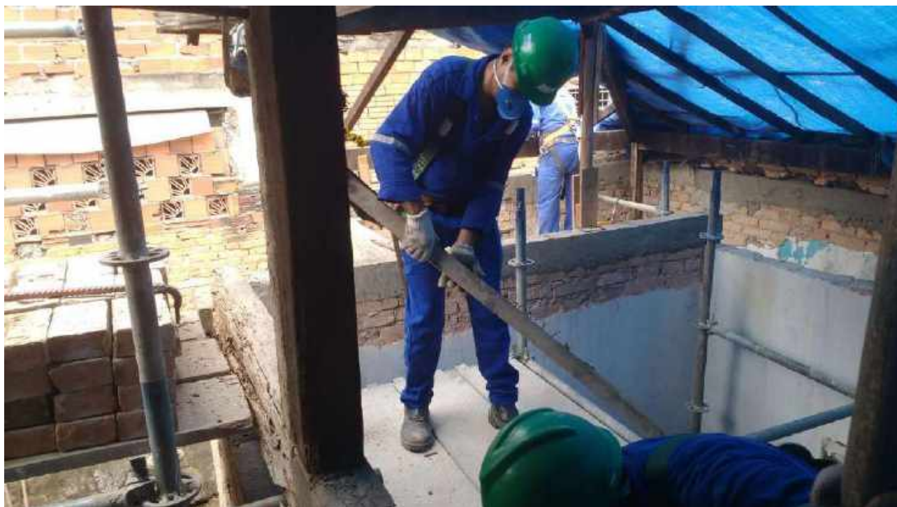
Foto 19: Remoção das peças danificadas.
