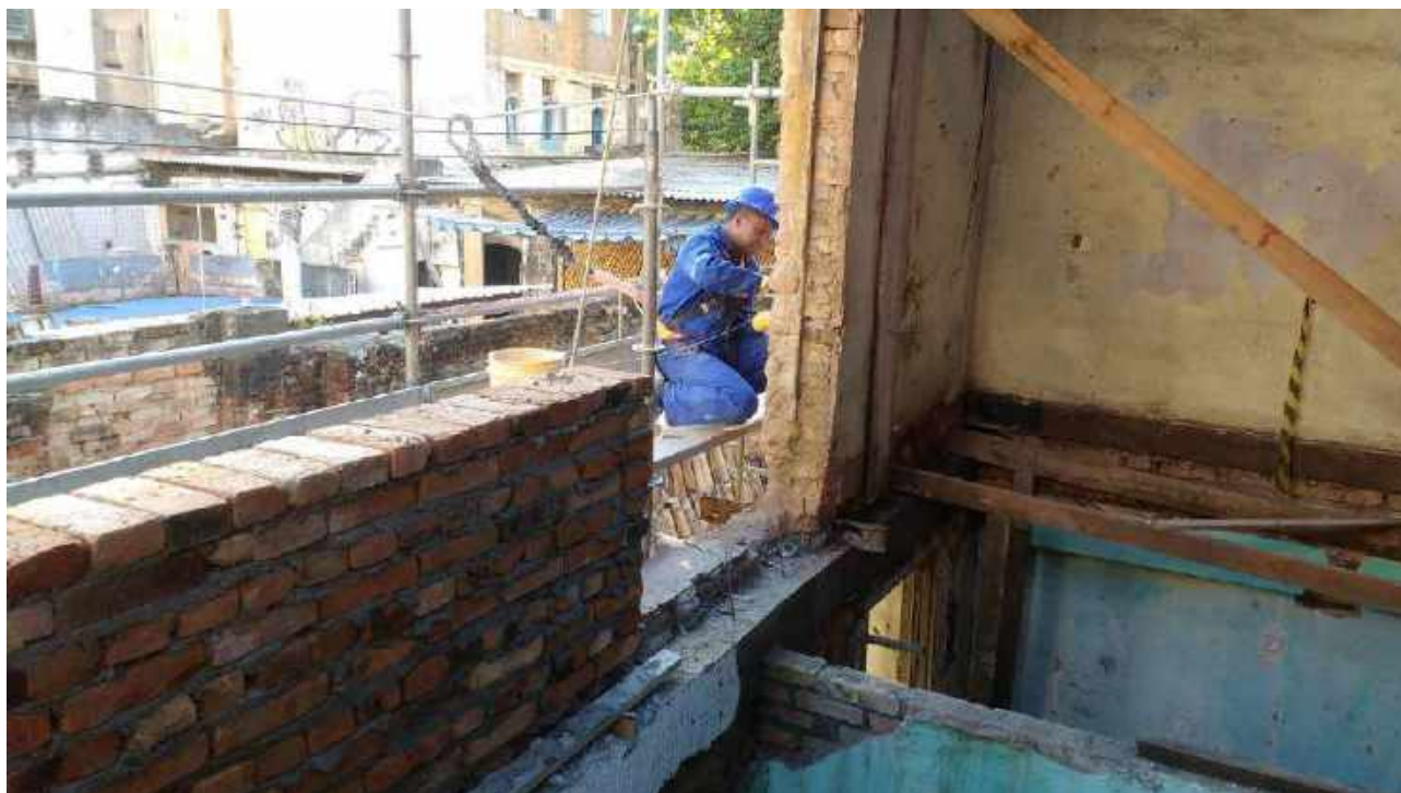
Foto 28: Remontagem da alvenaria.
