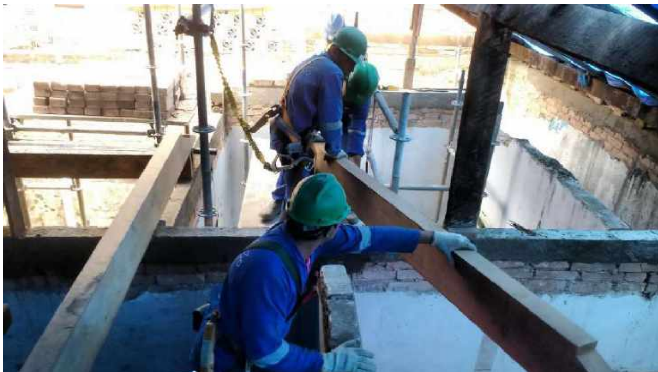
Foto 03: Substituição das peças danificadas da tesoura da Casa 6.
