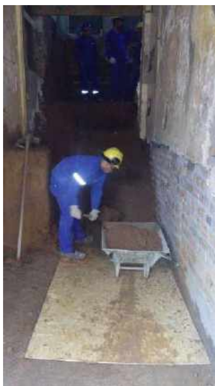
Foto 18 - Escavação manual para execução do reforço – Casa 06
