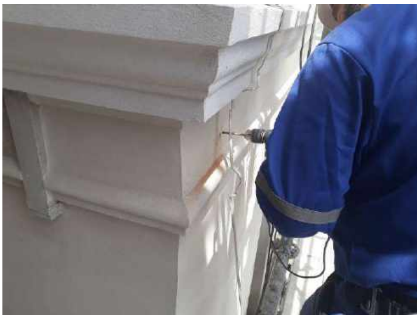
Foto 39 – Instalação das descidas de SPDA – Casa 06
