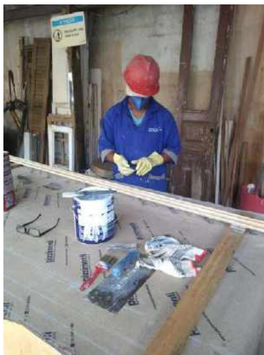
Foto 17 – Aplicação de massa para madeira nos roda - teto
