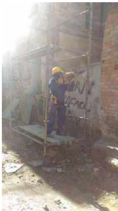
Foto 02: Demolição do anexo entre as casas 6 e 7.
