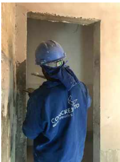
Foto 28 – Execução da argamassa de acabamento das paredes internas – Casa 06
