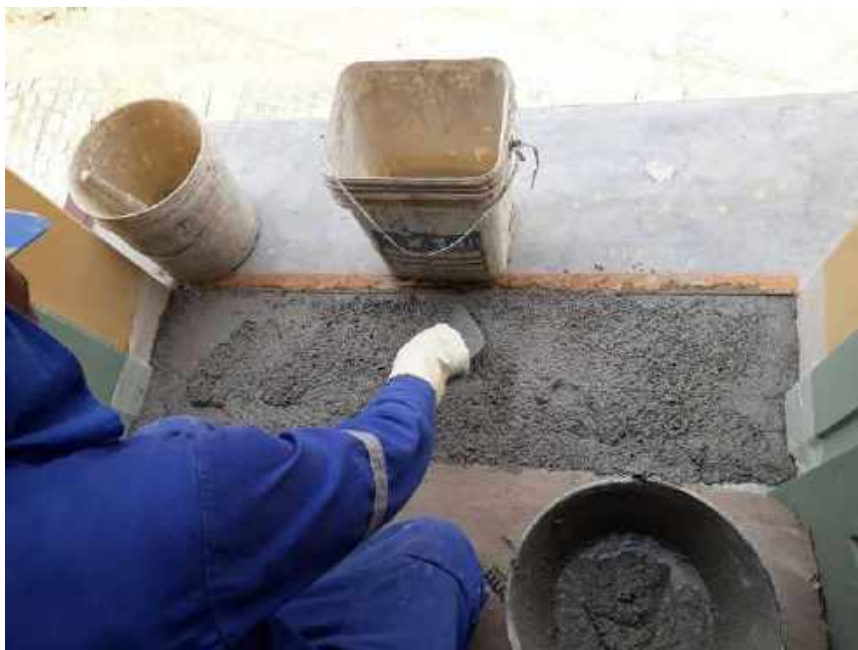
Foto 09 – Execução da soleira das entradas das portas – Casa 06
