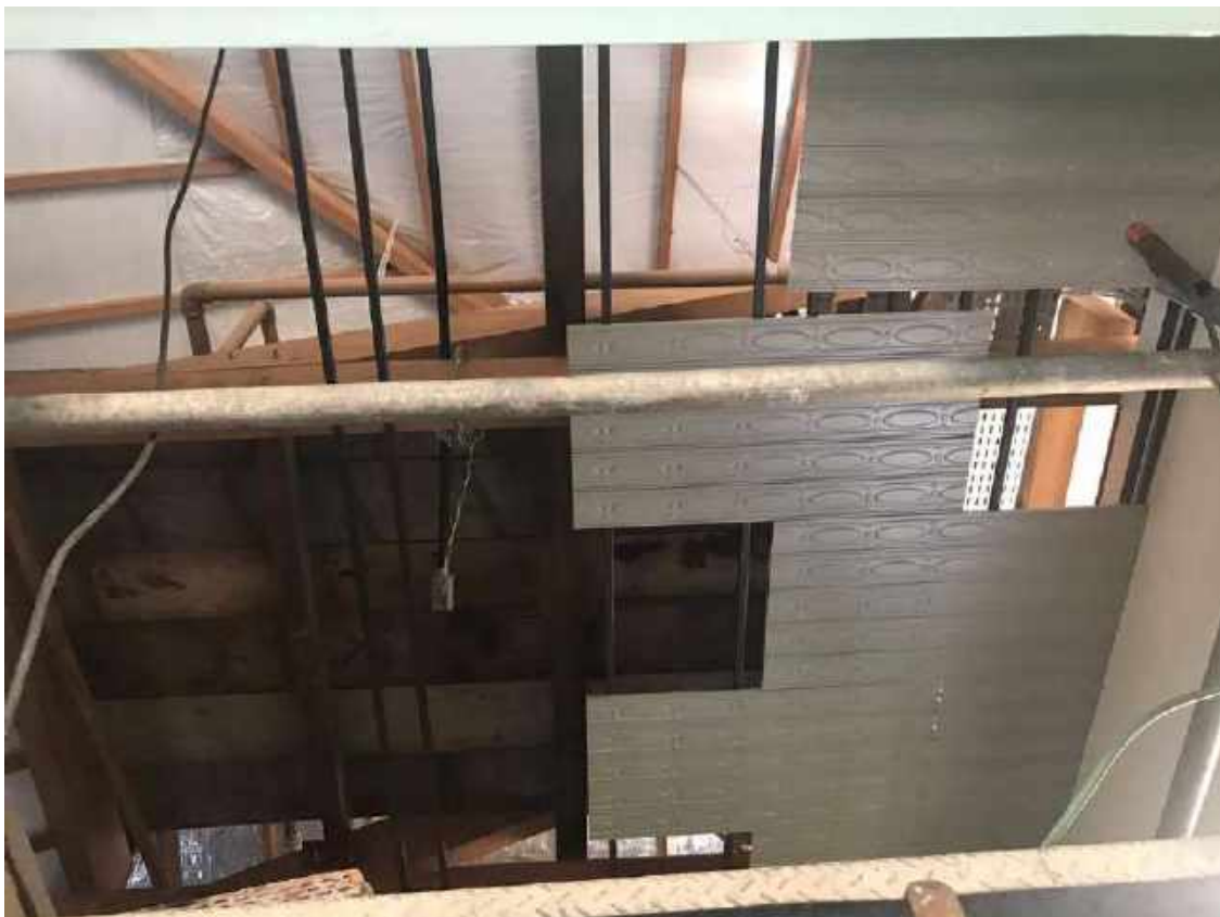
Foto 52 - Montagem do forro metálico – Casa 06
