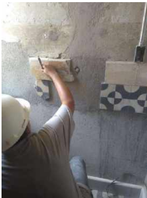
Foto 17 – Remoção de resíduo dos ladrilhos hidráulicos – Casa 06
