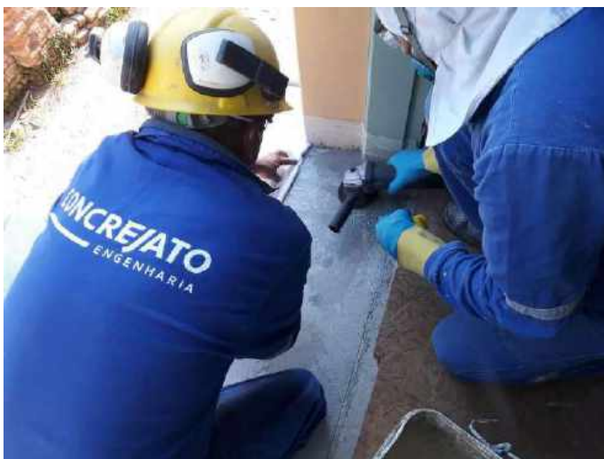
Foto 18 – Lixamento das soleiras das portas – Casa 06
