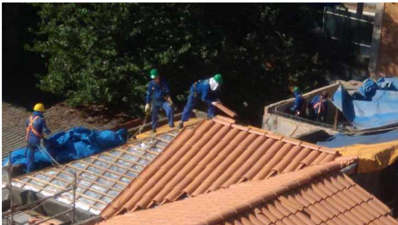
Foto 85: Instalação das telhas capa canal - Casa 06
