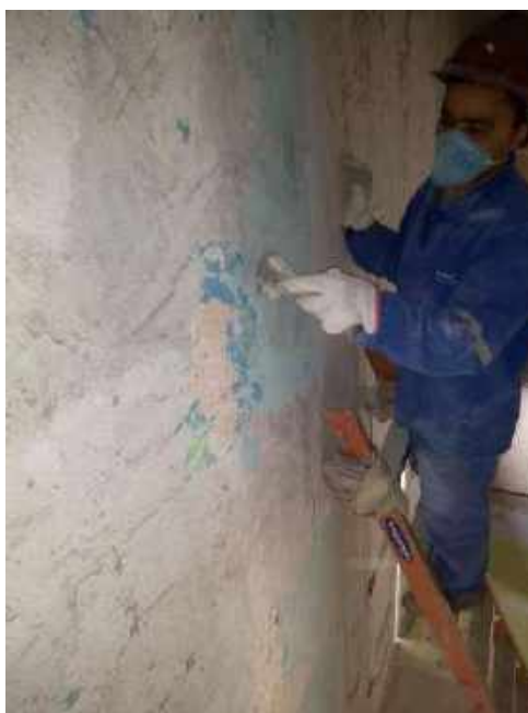
Foto 06 – Decapagem manual das paredes internas – Casa 06
