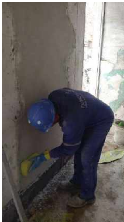
Foto 17 - Execução do emboço
