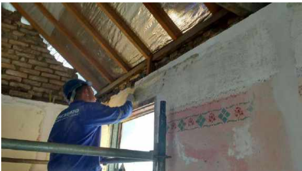
FOTO 01 – DECAPAGEM MECANICA - CASA 05
