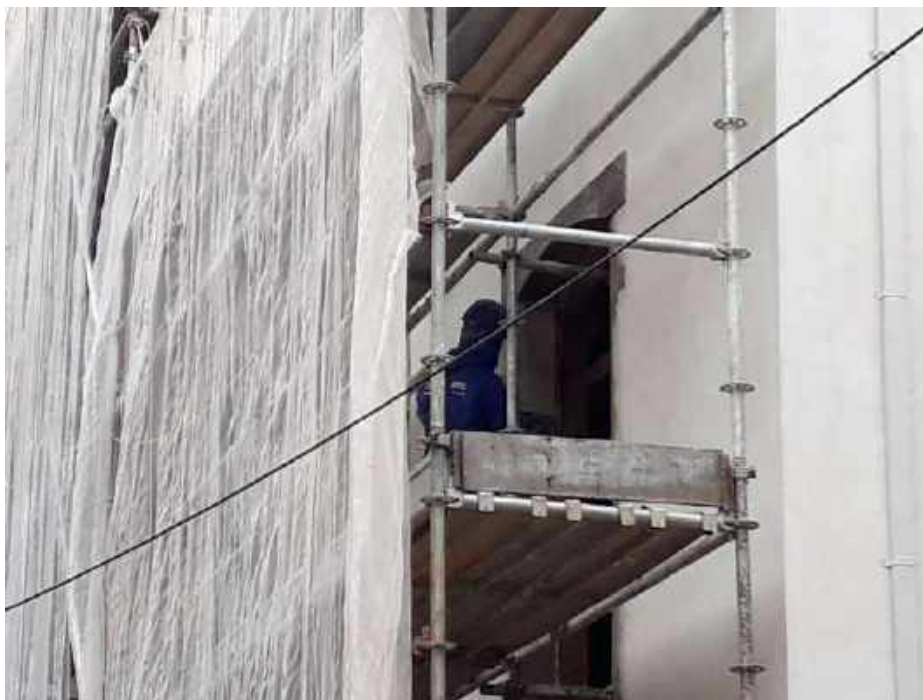
Foto 15 – Regularização das portas e das janelas – Casa 06
