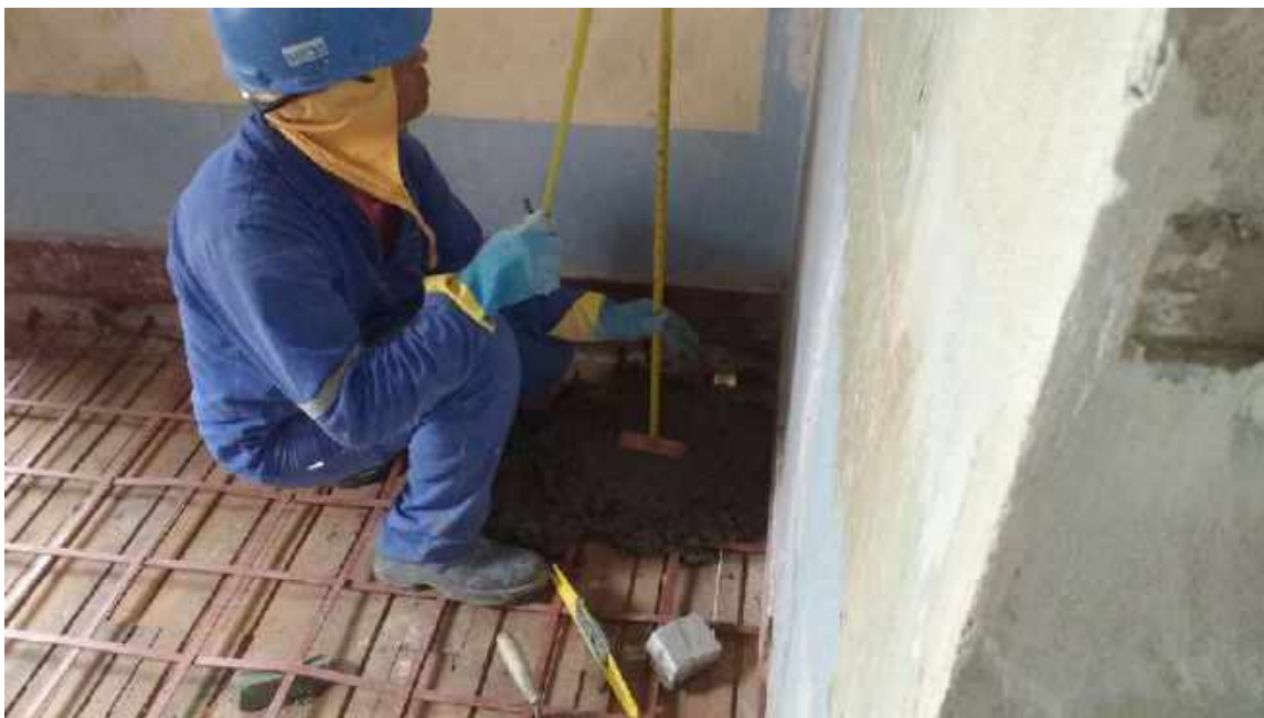
Foto 09 – Execução da concretagem – Casa 05
