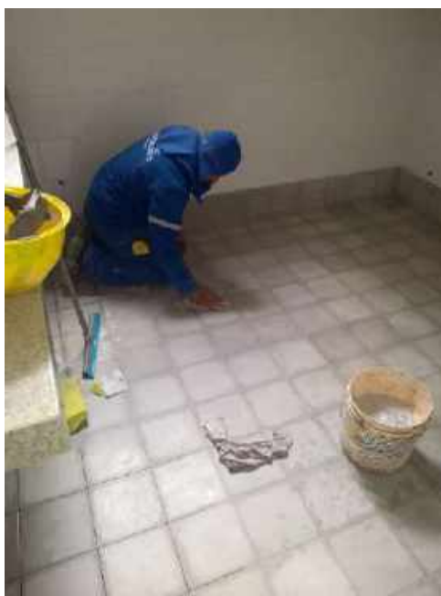
Foto 35 - Aplicação de rejunte nos pisos – Casa 06
