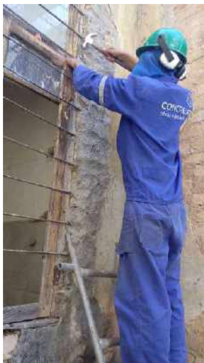
Foto 01 – Remoção das esquadrias e das janelas – Casa 06
