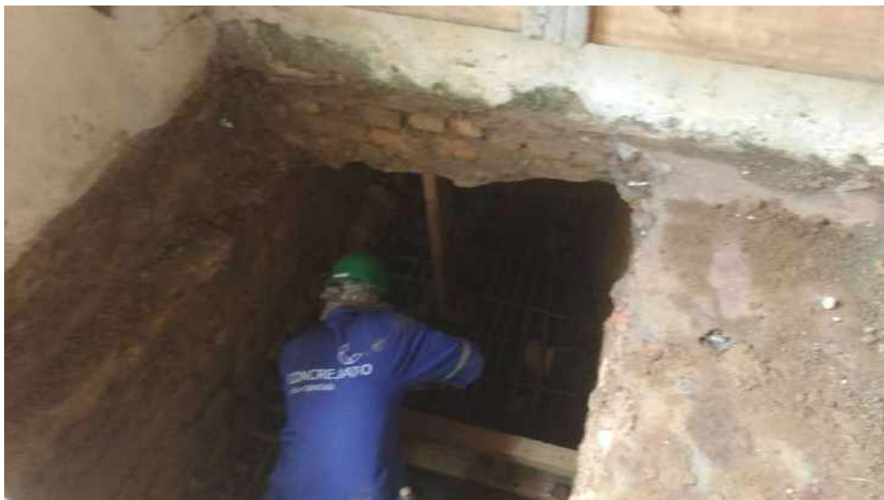
Foto 03: Armação dos blocos de fundação.
