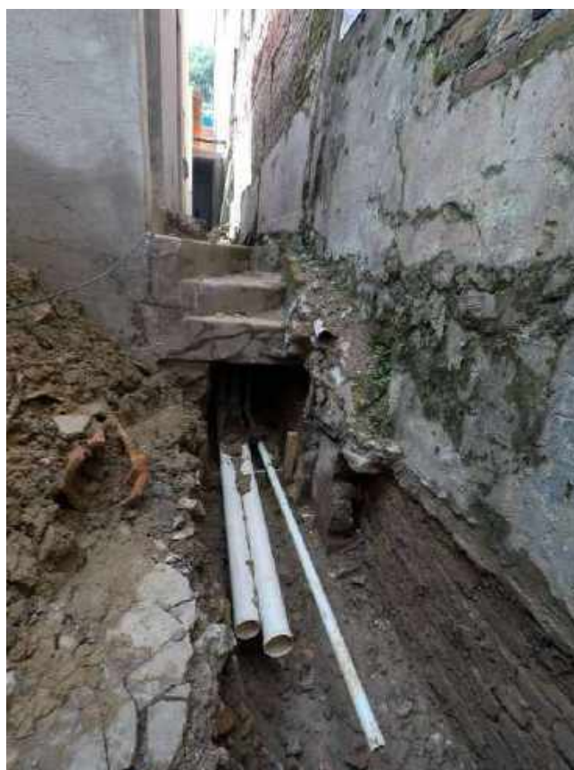
Foto 32 – Instalação das tubulações dos fundos – Casa 06
