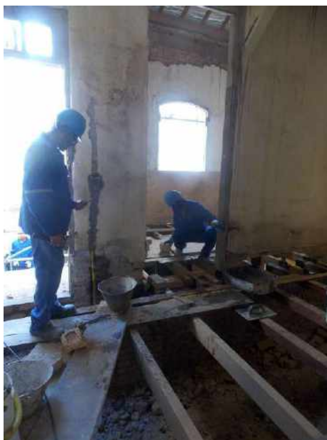
Foto 28 – Recuperação da alvenaria – Casa 06
