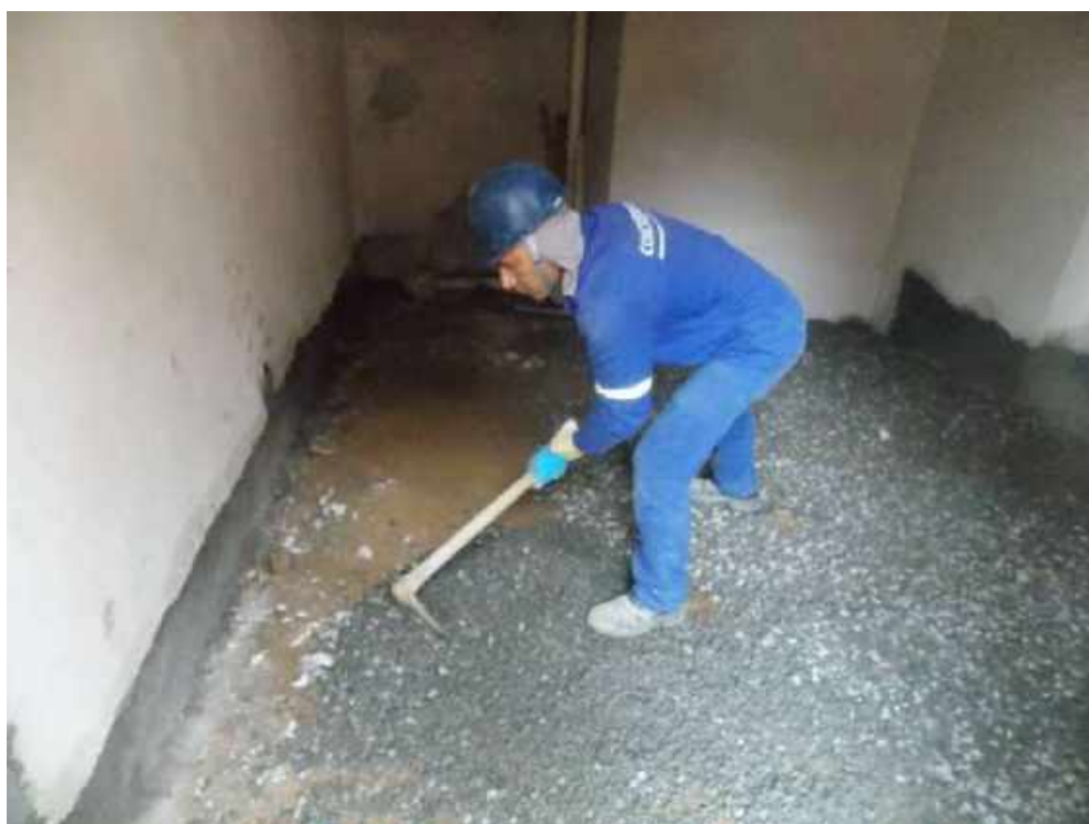
Foto 34 – Execução do contra piso – Casa 06
