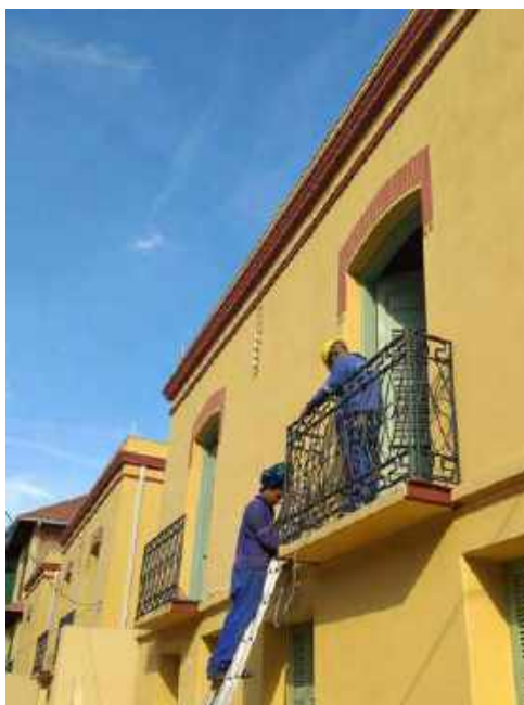
Foto 09 – Instalação do gradil metálico da sacada – Casa 06
