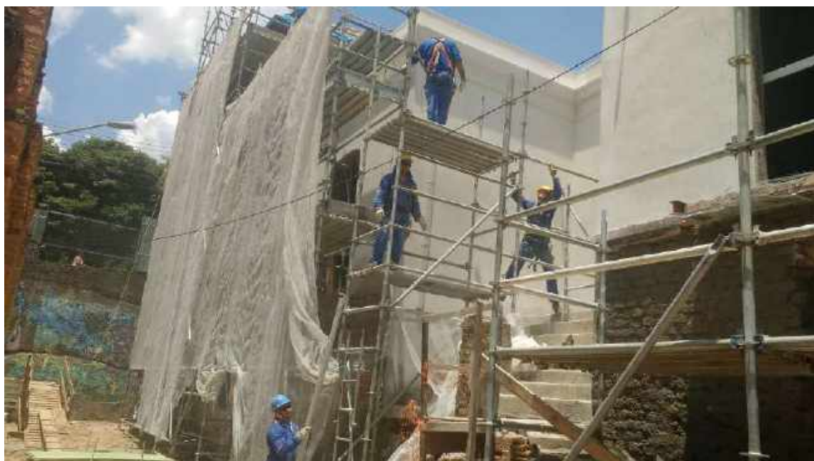
Foto 19 – Desmontagem do andaime – Casa 06
