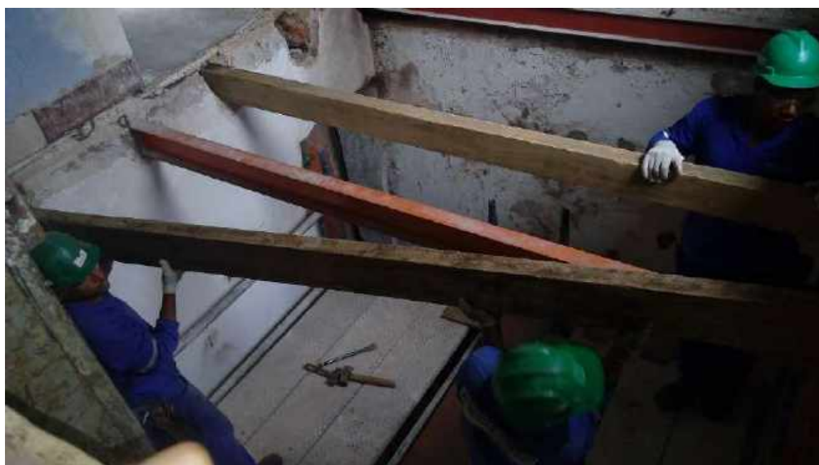
Foto 08 – Instalação dos barrotes - Casa 05
