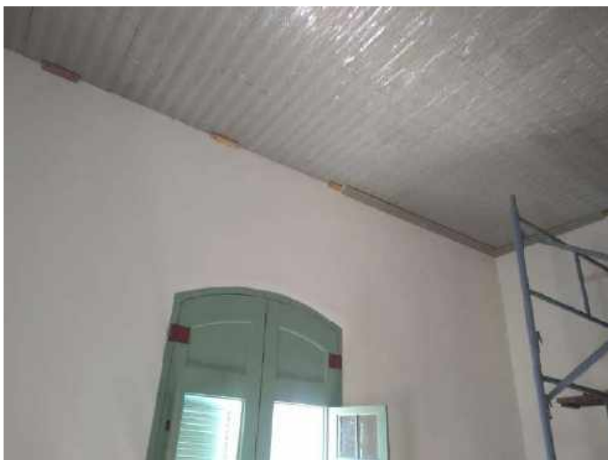
Foto 20 – Instalação do roda - teto no forro metálico
