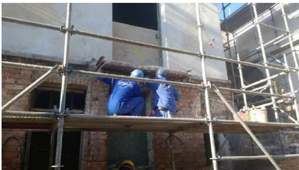
Foto 22 – Execução da varanda – Casa 06
