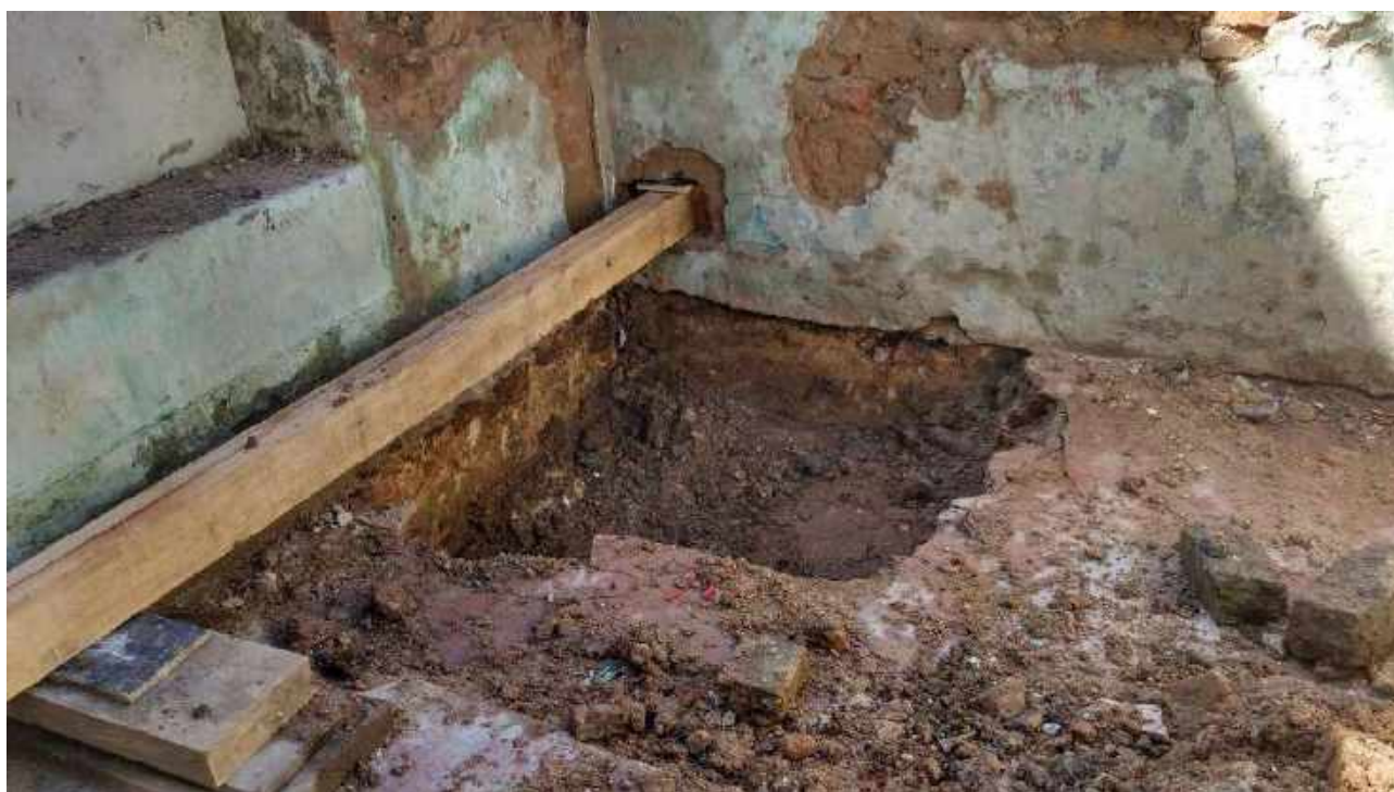
Foto 25: Escoramento de madeira para abertura de vala interna - Casa 6.
