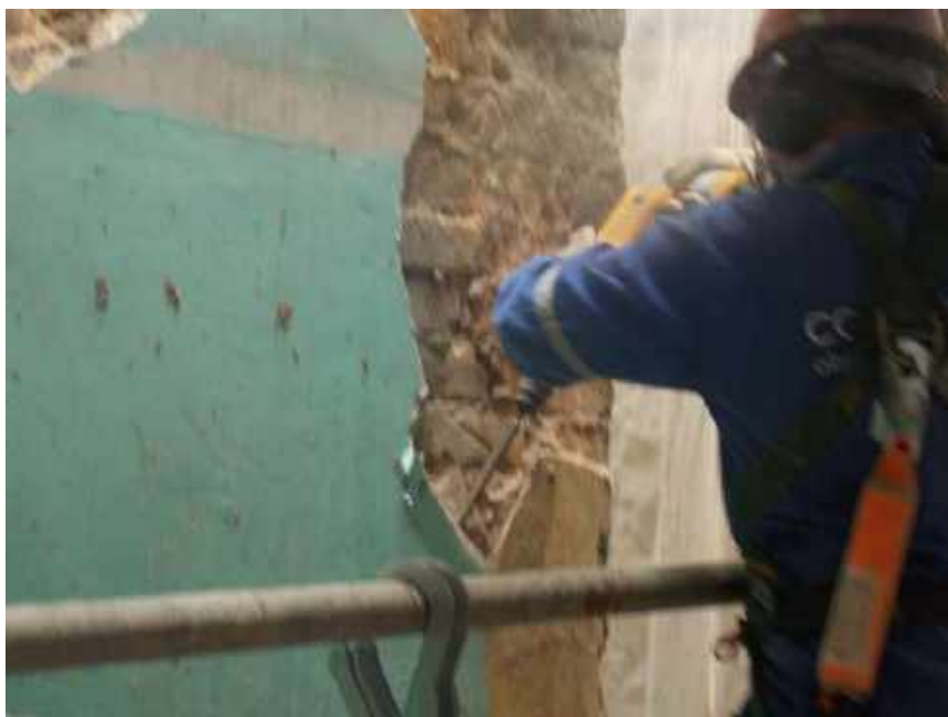
Foto 60 – Remoção da argamassa existente – Casa 06
