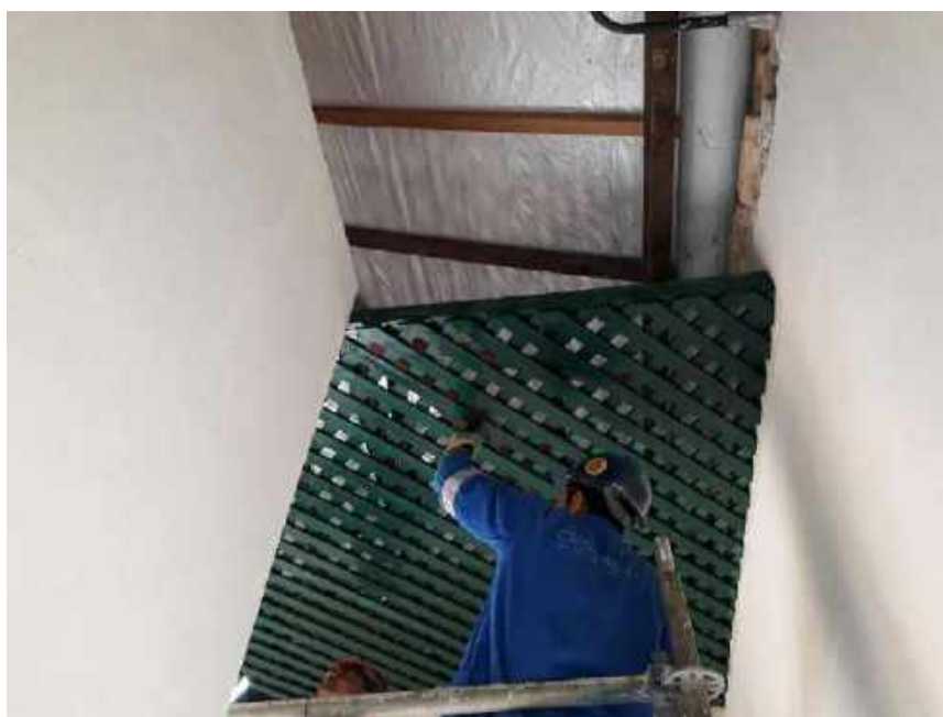
Foto 12 – Execução da pintura lisa do forro treliçado de madeira – Casa 06
