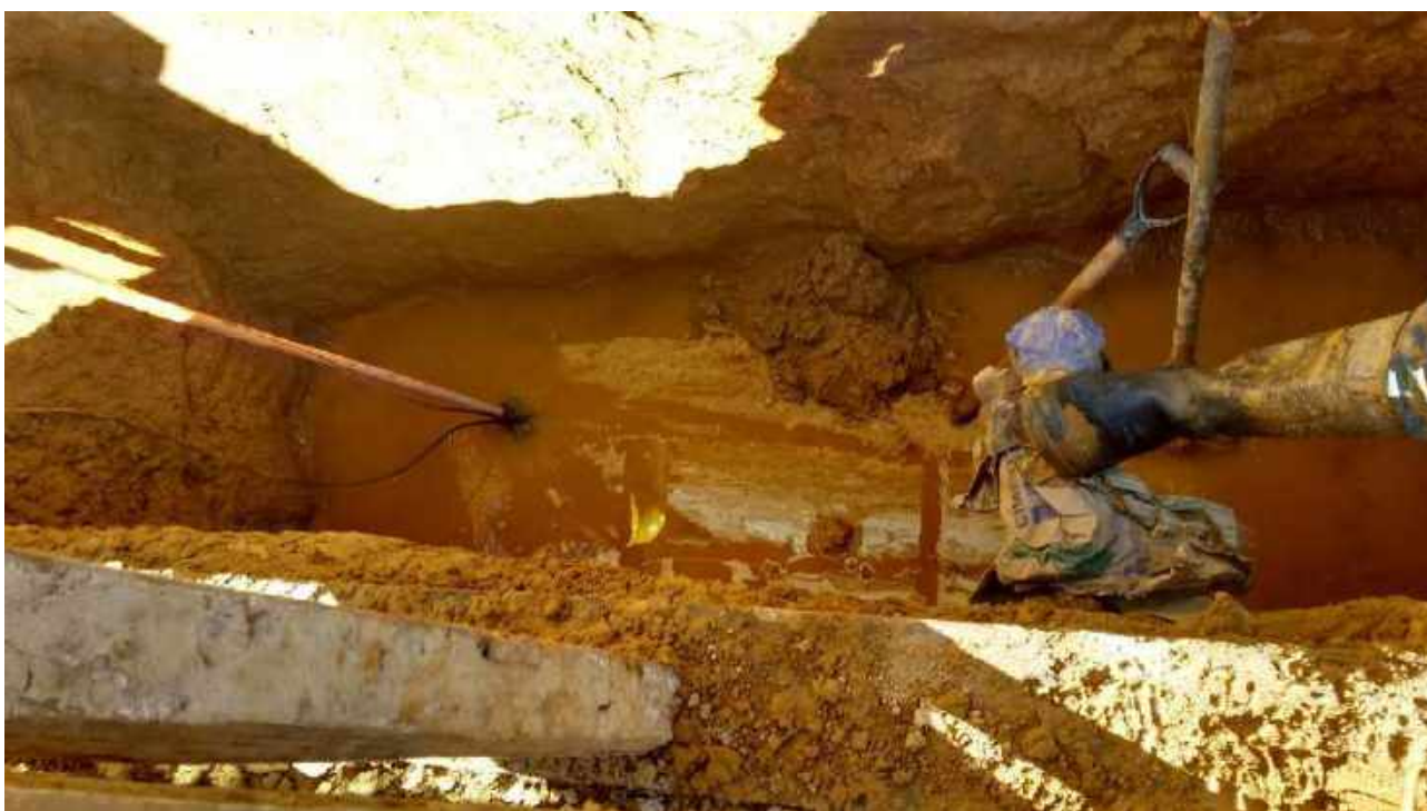
Foto 08: Abertura da vala e bombeamento da água do lençol freático.
