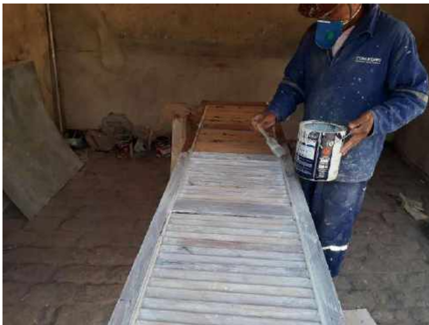
Foto 13 – Aplicação de massa para madeira nas venezianas – Casa 06
