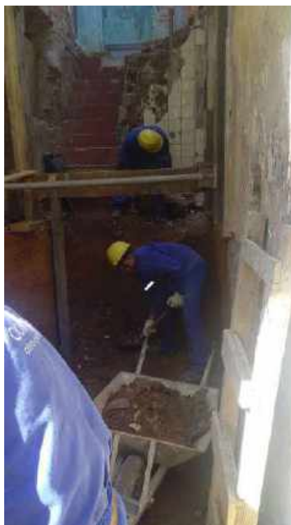
Foto 19 – Remoção de entulho – Casa 06
