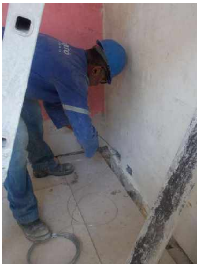
Foto 21 – Instalação dos cabos elétricos – Casa 06
