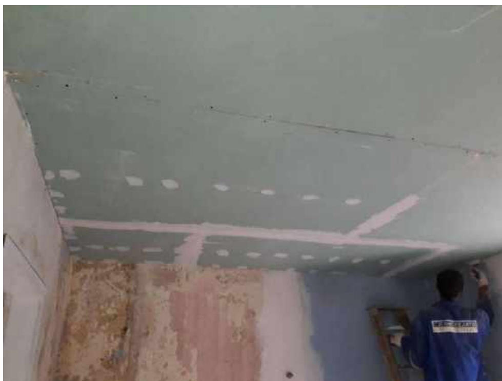
Foto 66 – Instalação do forro – Casa 05
