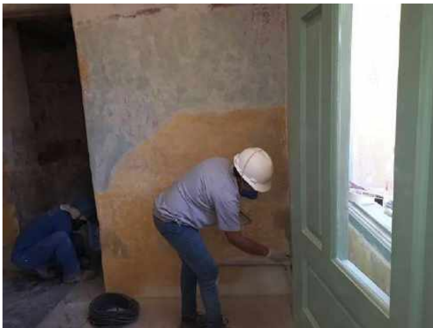
Foto 19 – Fechamento das imperfeições encontrada nas paredes internas – Casa 06
