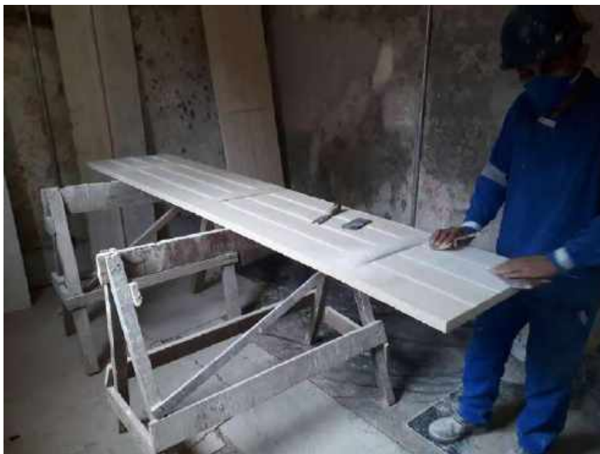
Foto 07 – Lixamento das portas de madeira – Casa 06
