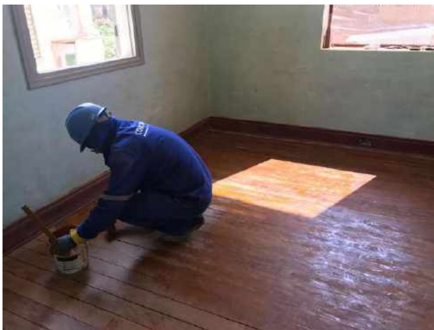
Foto 05 – Calafetação dos juntas do assoalho de madeira – Casa 05
