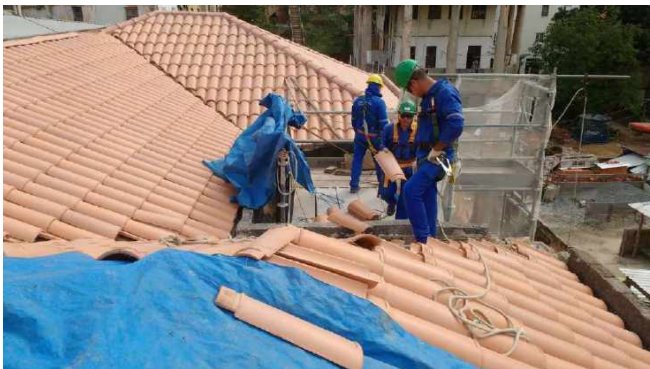
Foto 62: Recortes de telhas e ajustes finais.
