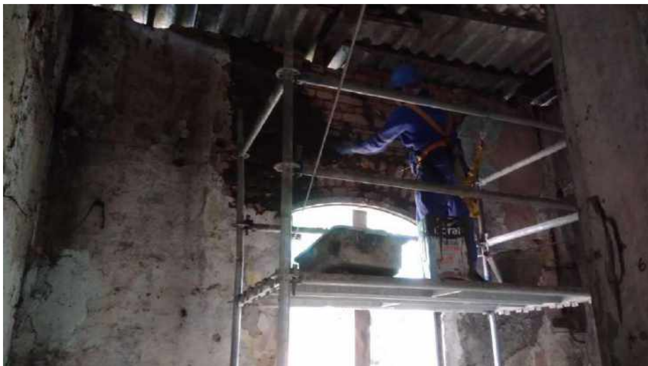
Foto 73: Substituição das peças danificadas da tesoura da Casa 6.
