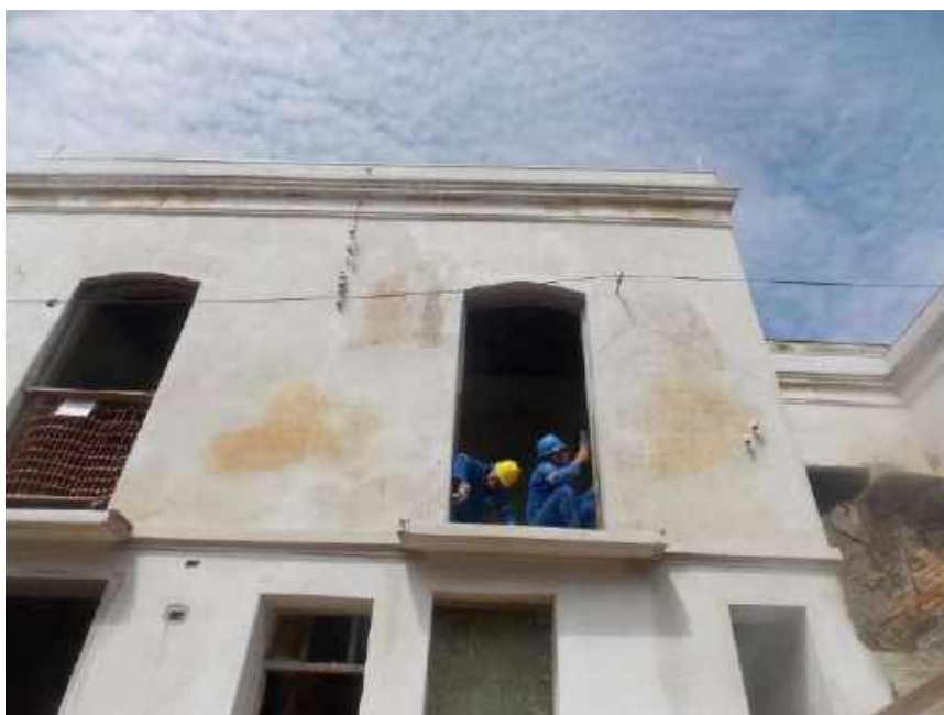
Foto 23 – Execução da argamassa de acabamento na fachada principal – Casa 06
