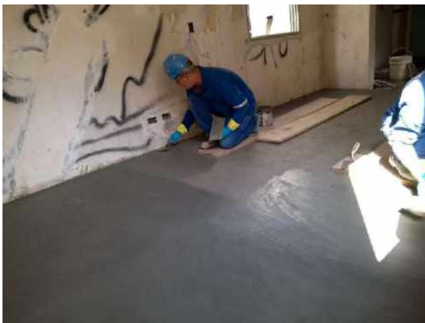
Foto 28 – Pigmentação do piso em cimento queimado pigmentado – Casa 05
