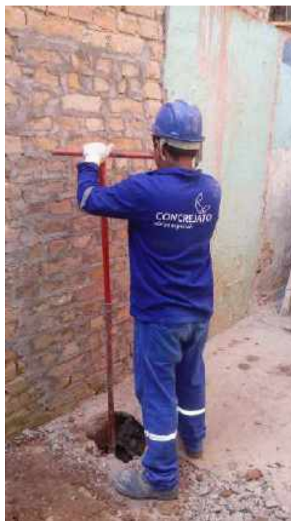
Foto 15 – Escavação manual para regularização do solo – Casa 06
