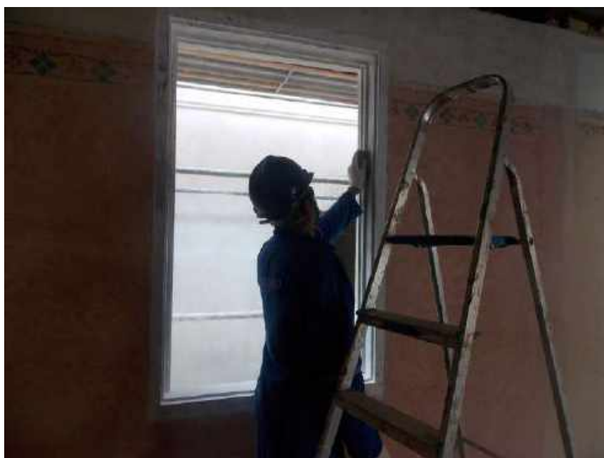
Foto 07 – Lixamento das esquadrias – Casa 05
