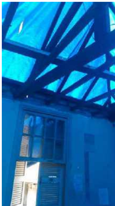
Foto 04: Remoção das telhas, caibros e ripas da Casa 5.
