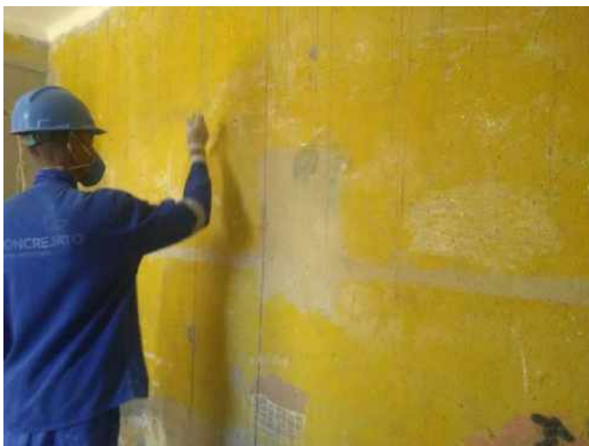
Foto 06 – Decapagem manual das paredes internas – Casa 06
