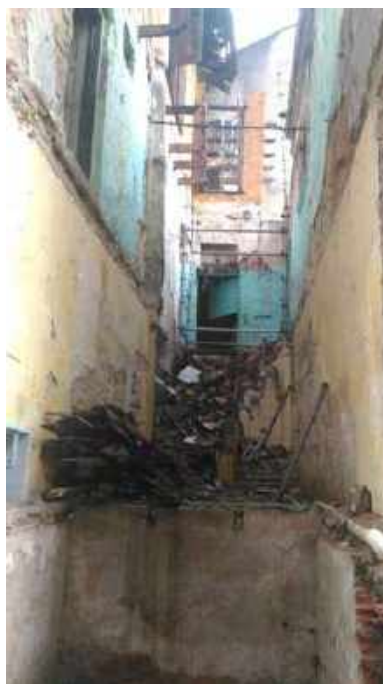
Foto 03: Demolição do anexo entre as casas 6 e 7.
