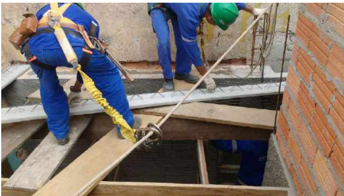
Foto - 14 – Execução da laje – Casa 06
