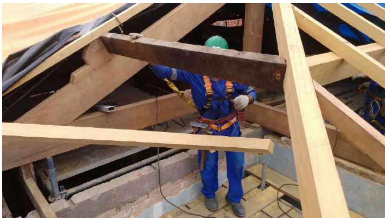
Foto 36: Substituição das peças danificadas da tesoura da Casa 6.
