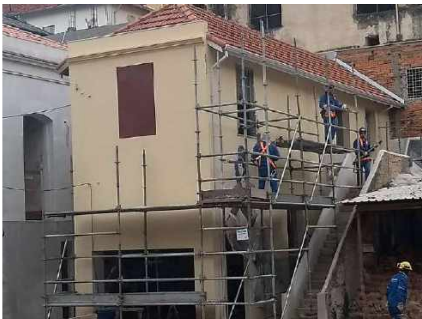
Foto 23 – Desmontagem do andaime da fachada principal – Casa 05
