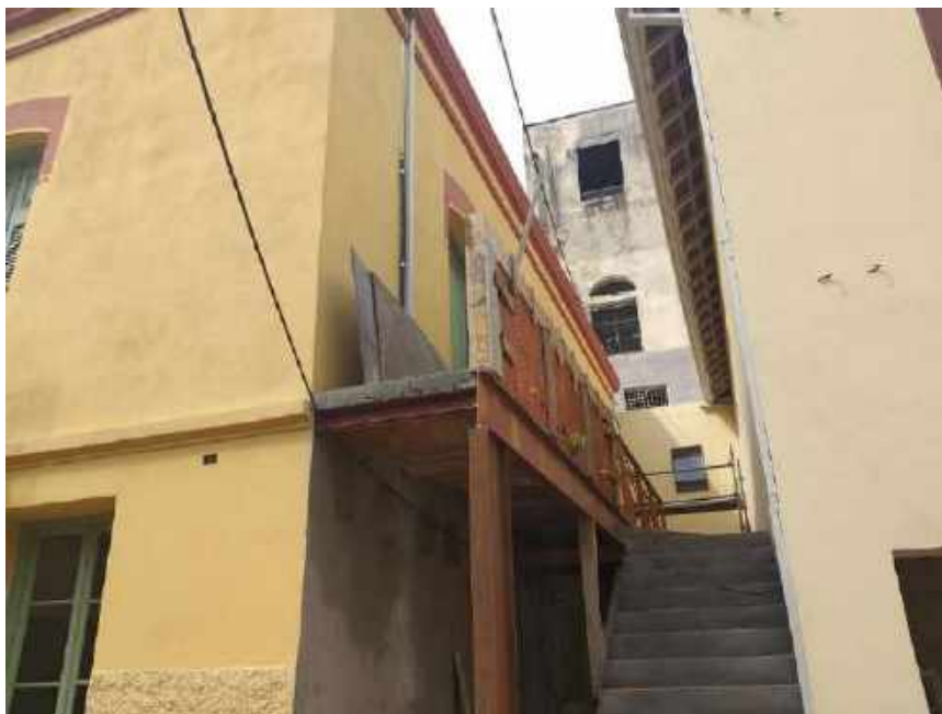
Foto 02 – Execução do guarda corpo
