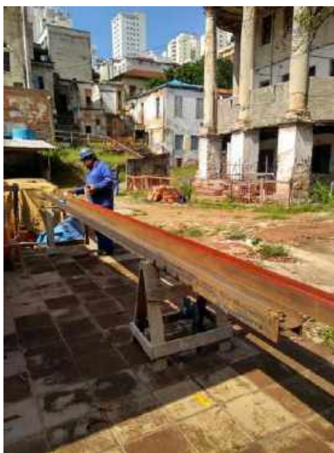
Foto 08 - Pintura lisa dos perfis metálicos da estrutura da escada – Casa 06
