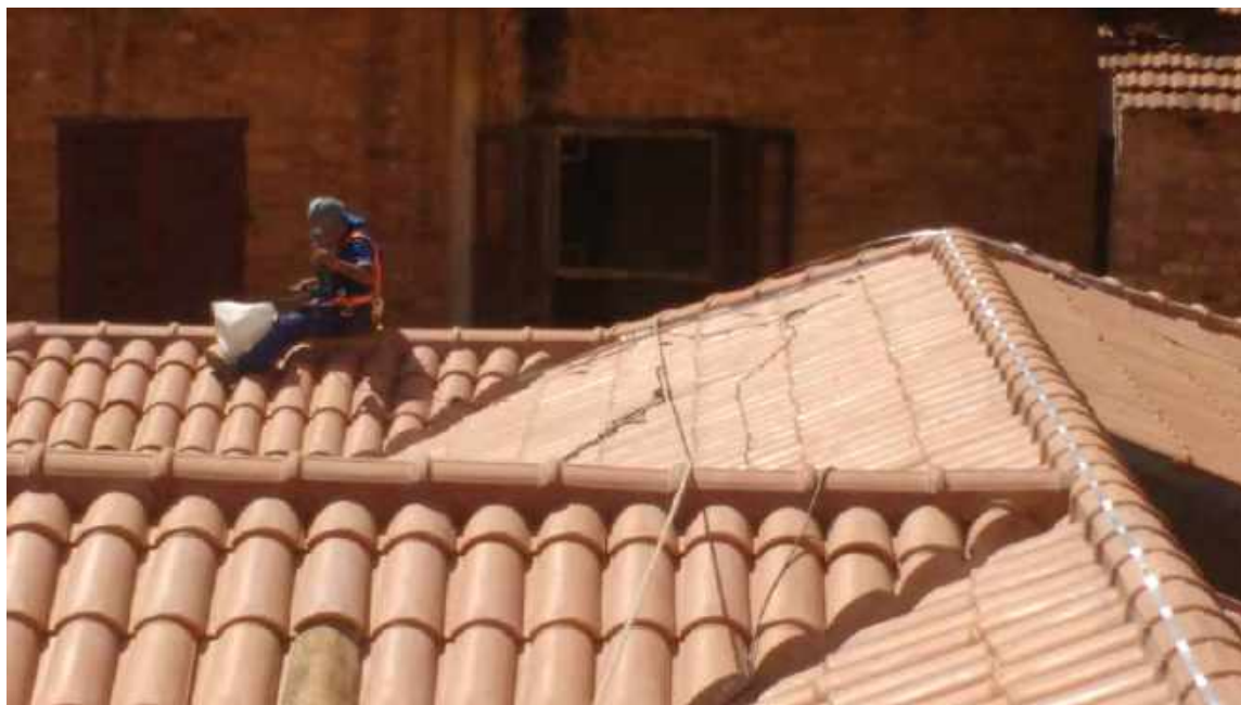
Foto 43 Instalação das fitas de SPDA na cobertura da casa 06
