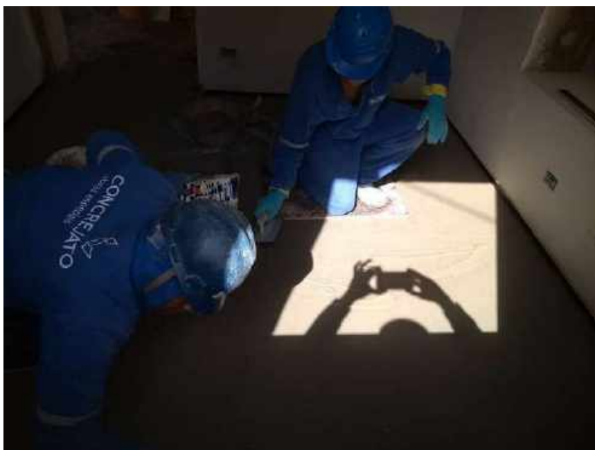
Foto 59 – Execução do piso cimentado pigmentado – Casa 06
