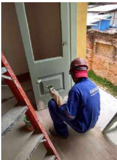
Foto 12 – Pintura lisa das portas de madeira – Casa 06
