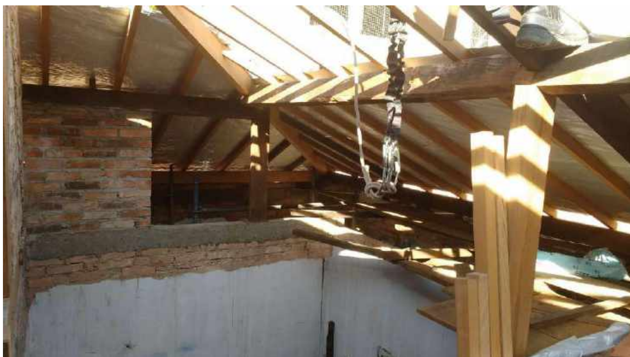
Foto 32: Instalação da manta aluminizada.
