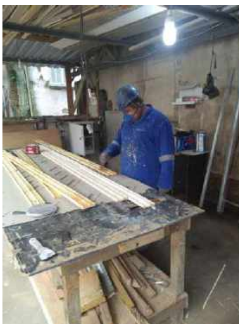
Foto 18 – Tratamento do roda - teto de madeira
