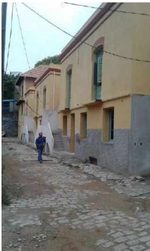
Foto 01 – Fachada frontal – Casa 06
