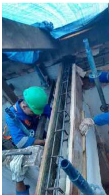
Foto 02: Execução de fôrma para cinto de concreto.
