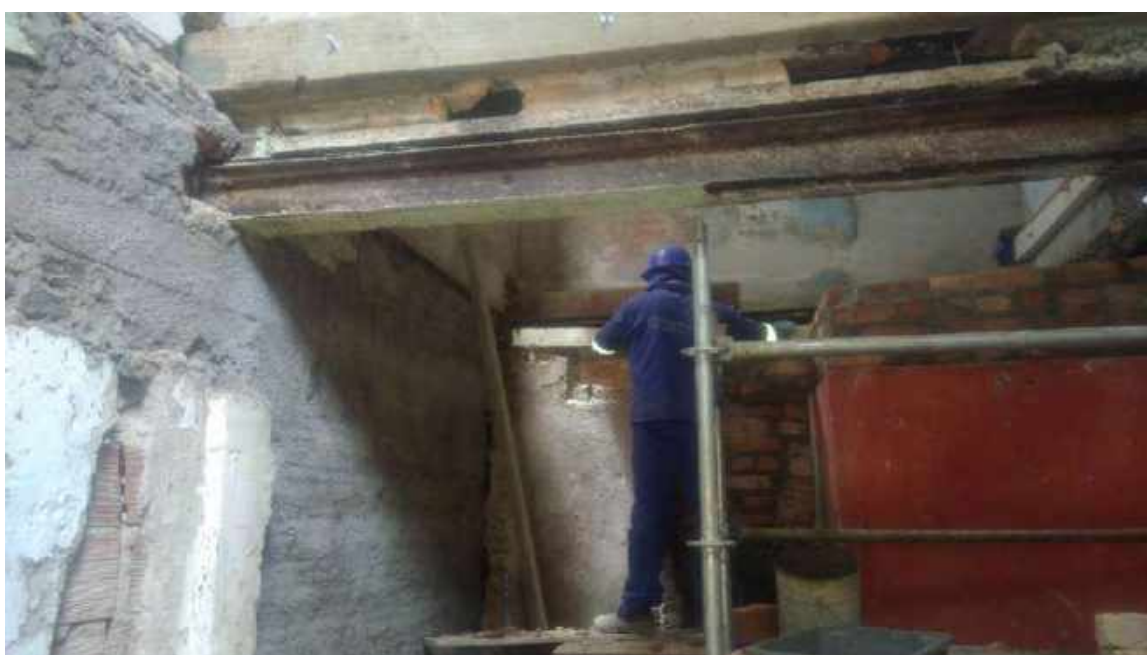
Foto 34 – Ajustes e elevação da alvenaria
