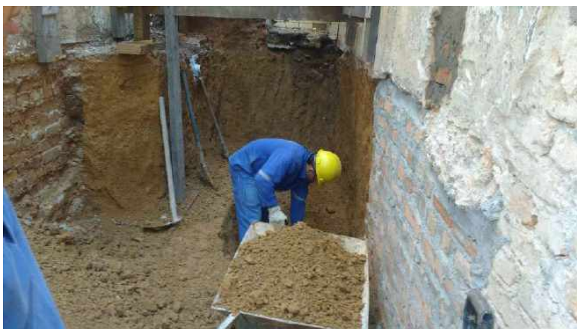
Foto 20 – Remoção de entulho – Casa 06
