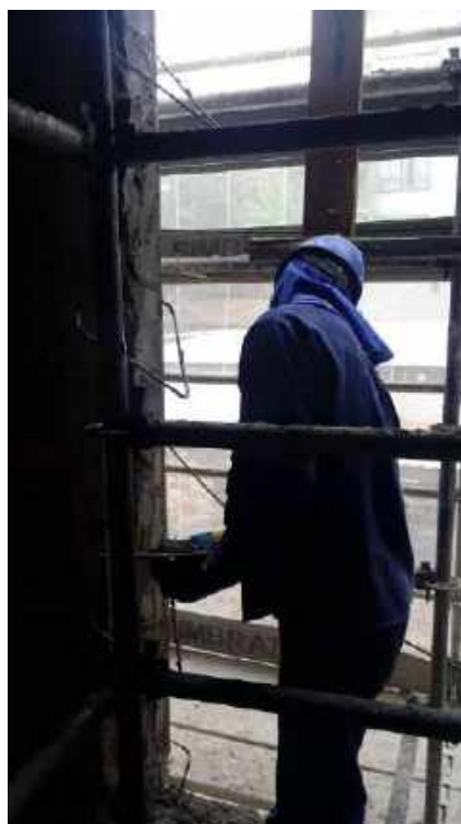
Foto 06 – Requadro dos vãos – Casa 06
