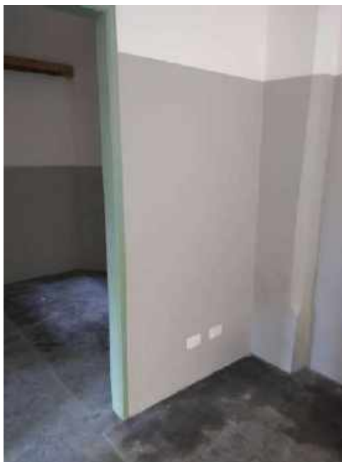
Foto 29 – Instalação dos acabamentos de elétrica – Casa 06
