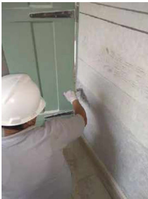
Foto 23 – Execução do envelhecimento das paredes internas – Casa 06
