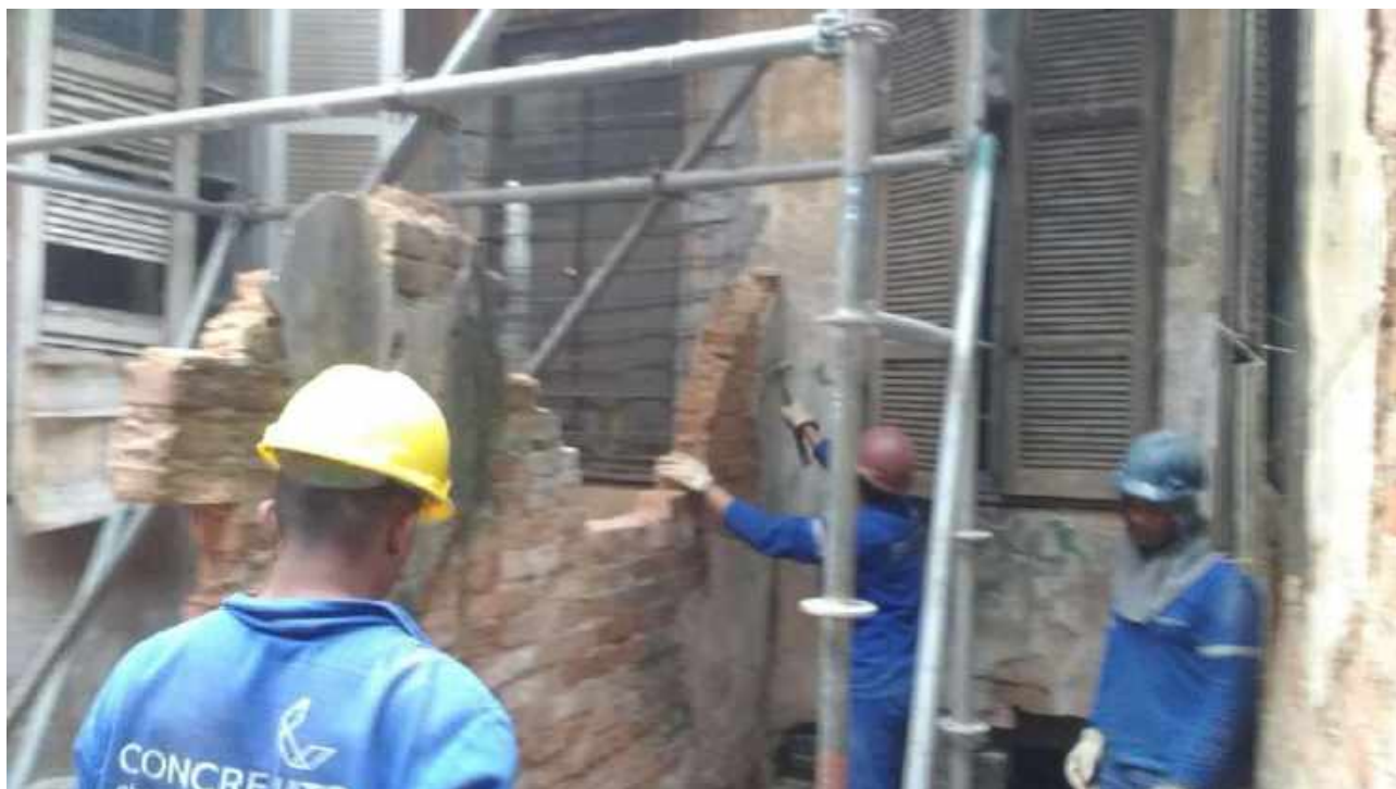
Foto 31: Demolição das alvenarias para adequação do novo uso.
