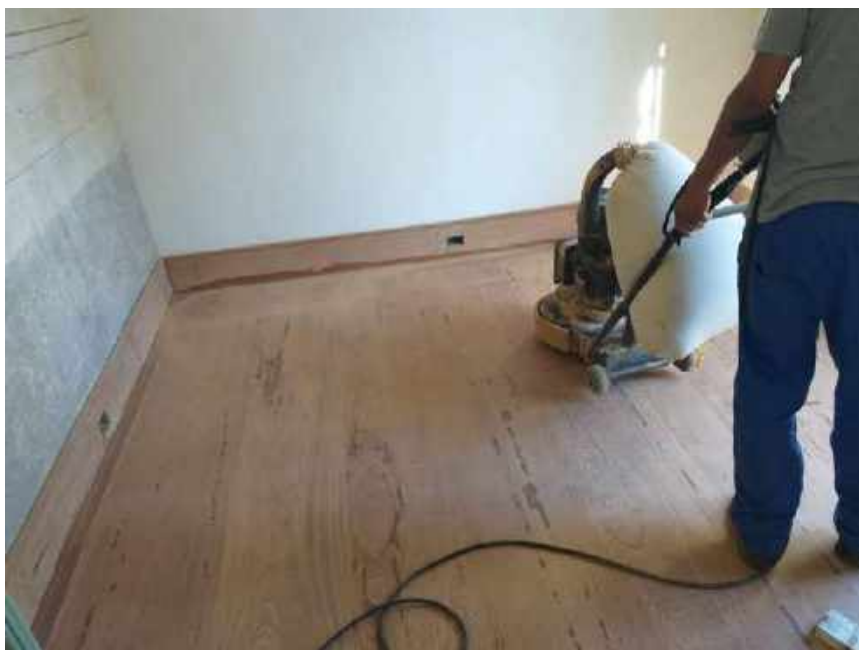
Foto 30 – Lixamento do assoalho de madeira
