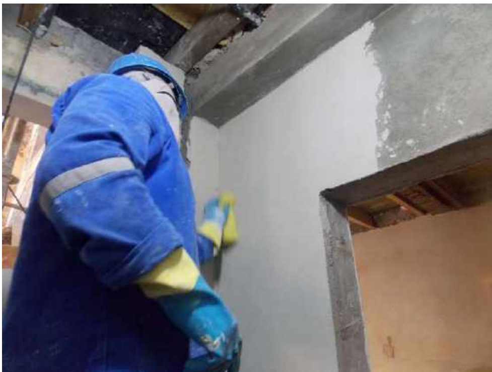
Foto 21 – Execução da argamassa de acabamento das paredes internas – Casa 05
