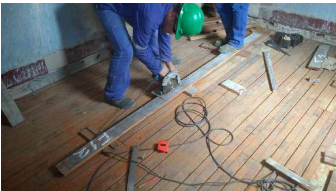
Foto 06 – Instalação dos assoalhos de madeira – Casa 05
