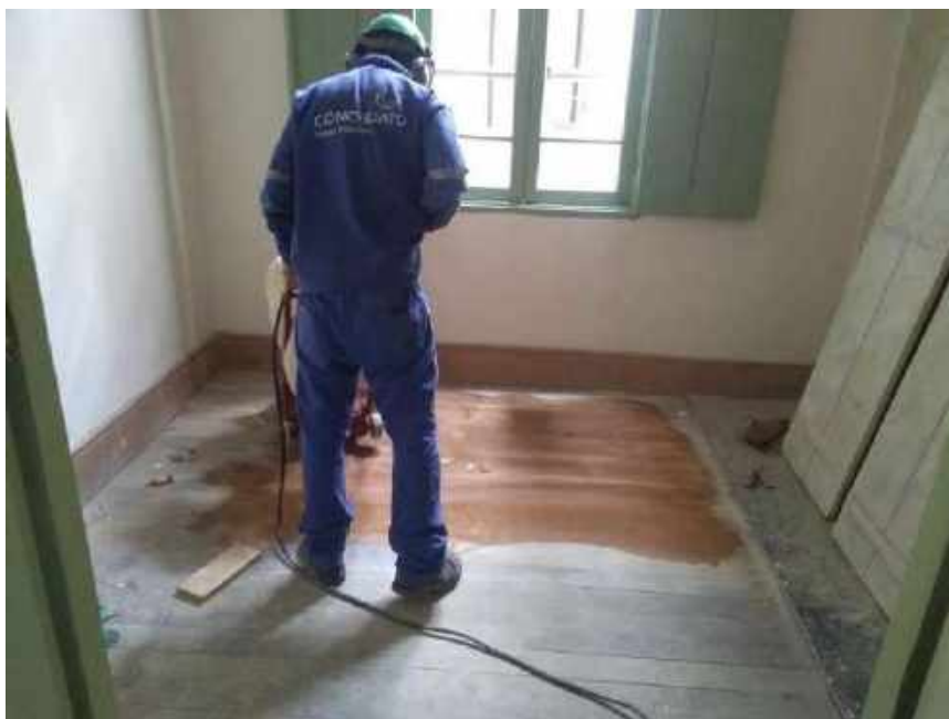
Foto 13 – Lixamento dos assoalhos de madeira – Casa 06
