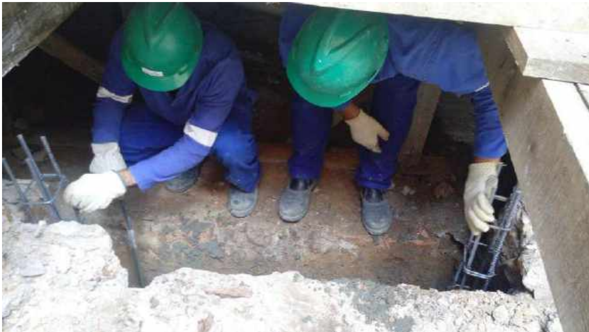
Foto 07 - Instalação da armação – Casa 06
