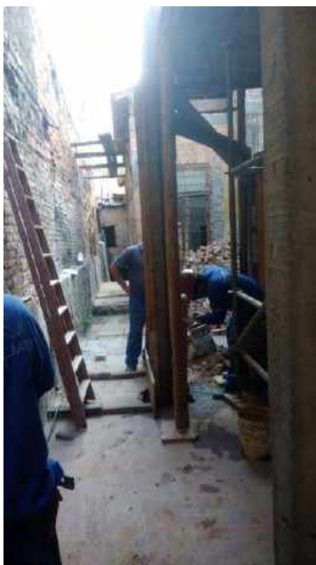
Foto 04: Execução de pilar;
