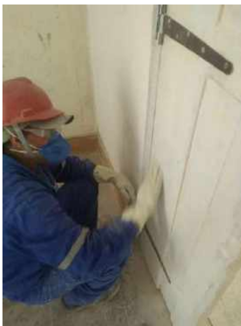
Foto 08 – Lixamento das portas de madeira – Casa 06
