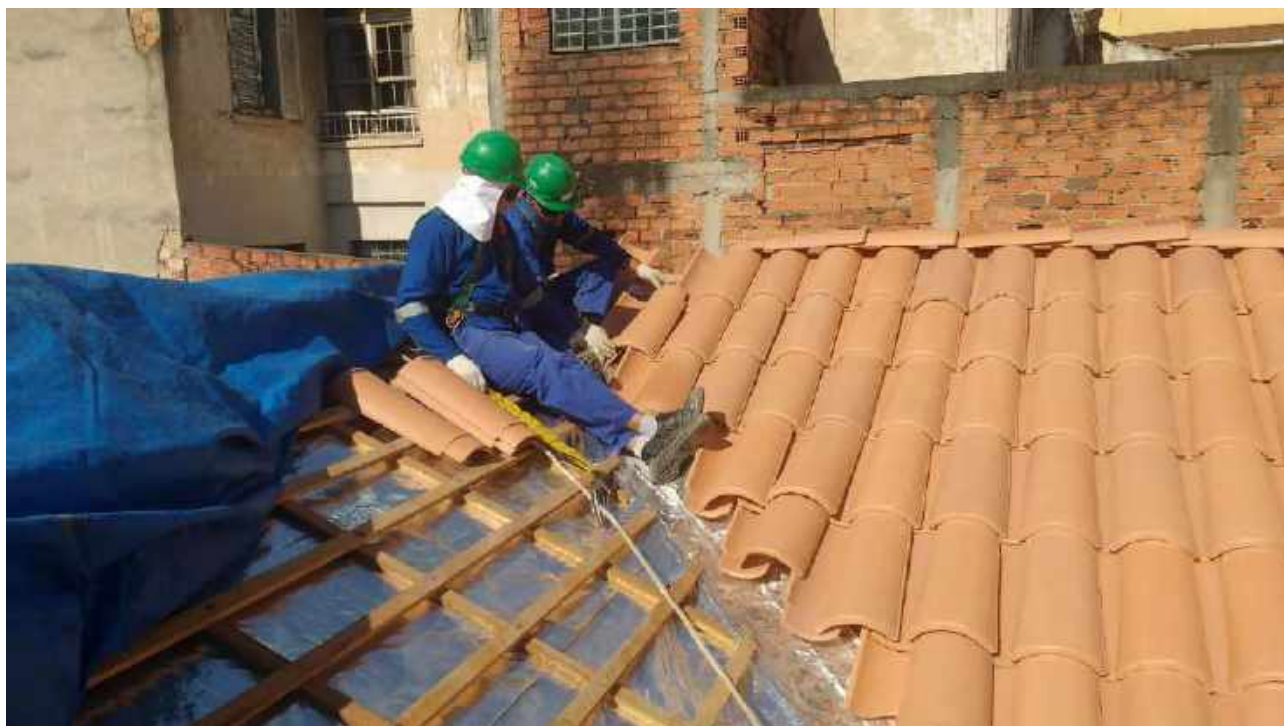
Foto 61: Instalação de telhas capa canal.
