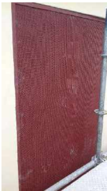
Foto 22 – Instalação da grade metálica – Casa 05
