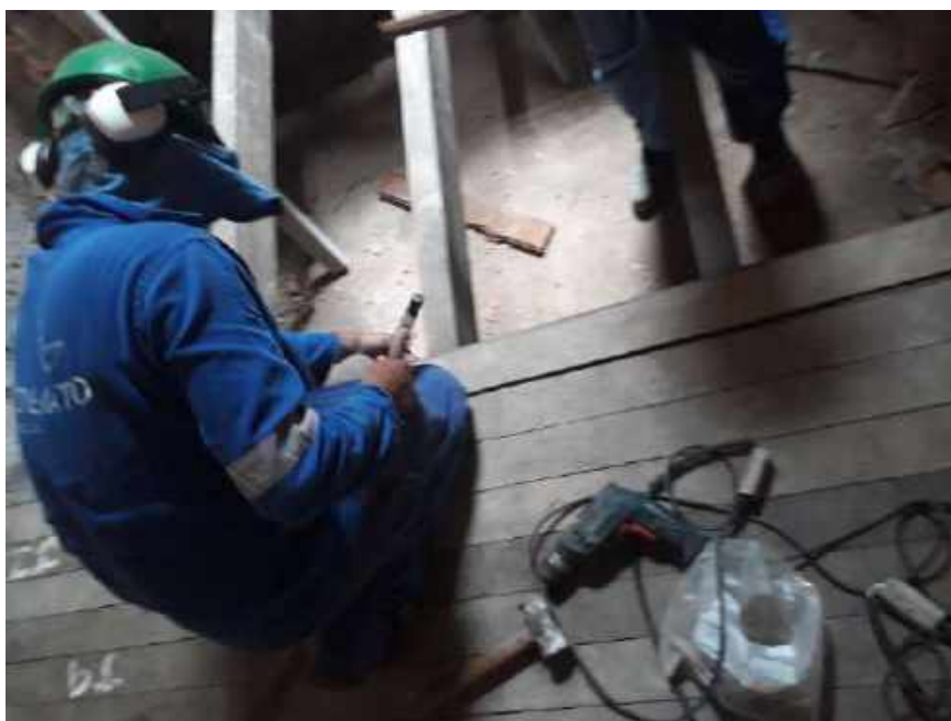
Foto 34 – Instalação dos assoalhos de madeira – Casa 06
