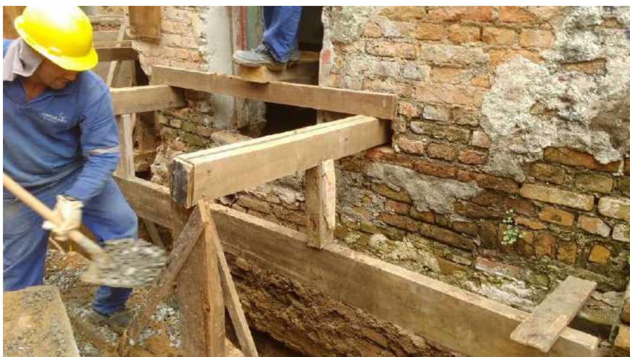
Foto 24: Execução do bloco de fundação.
