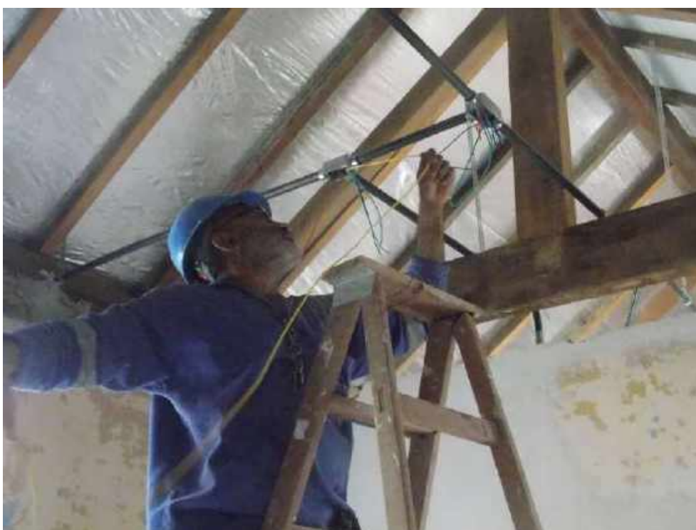
Foto 04 – Passagem dos cabos para instalação elétrica – Casa 05
