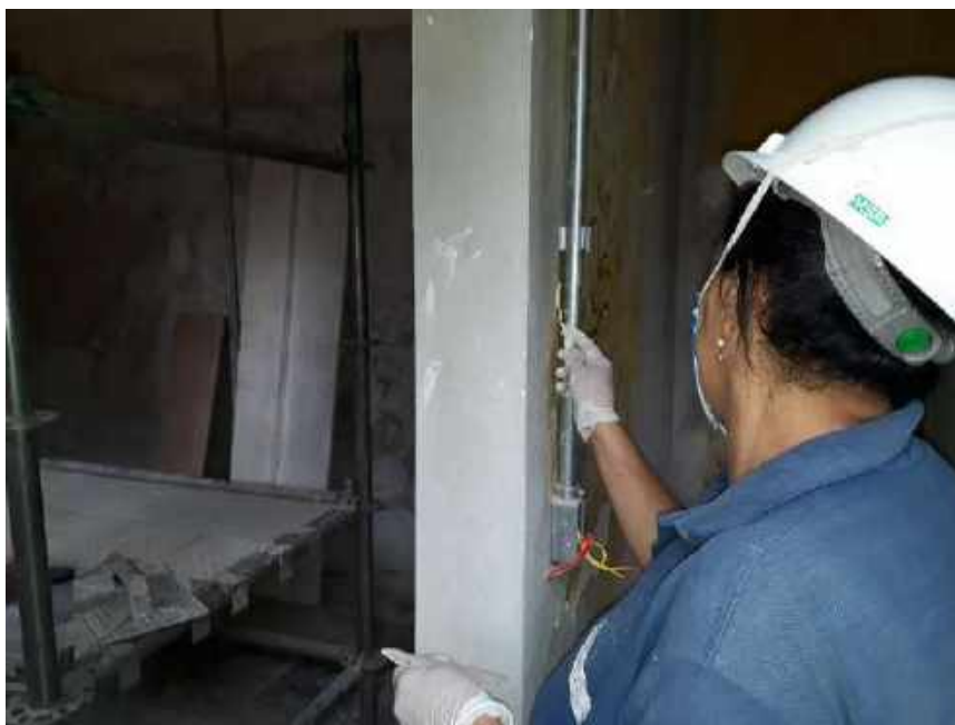
Foto 20 - Fechamento das imperfeições encontrada nas paredes internas – Casa 06
