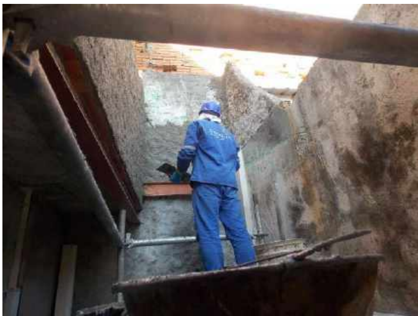
Foto 13- Execução do emboço da fachada lateral – Casa 05
