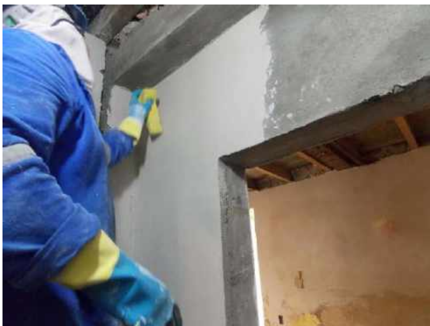
Foto 11 – Execução da argamassa de acabamento – Casa 06
