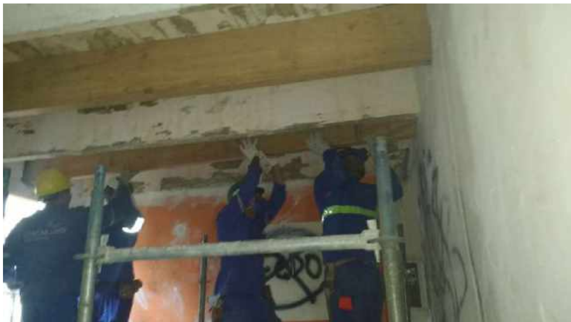
Foto 07 – Instalação dos barrotes de madeira - Casa 05
