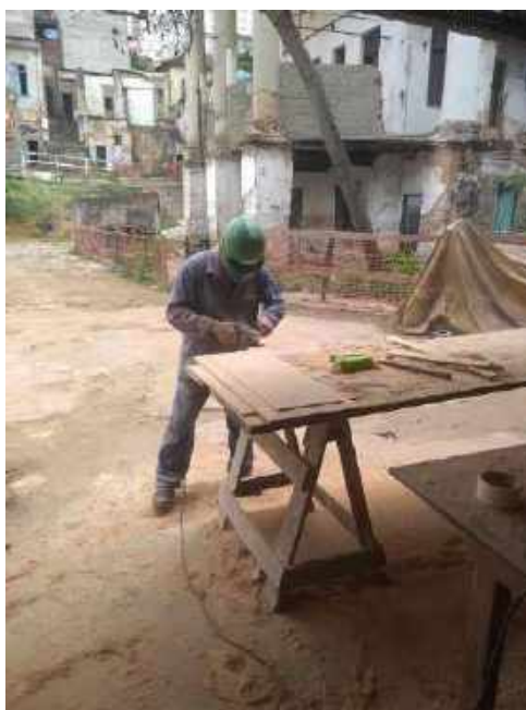
Foto 26 – Execução das almofadas das portas de madeira – Casa 06
