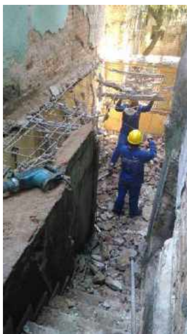
Foto 12: Demolição do anexo entre a Casa 5 e 6.
