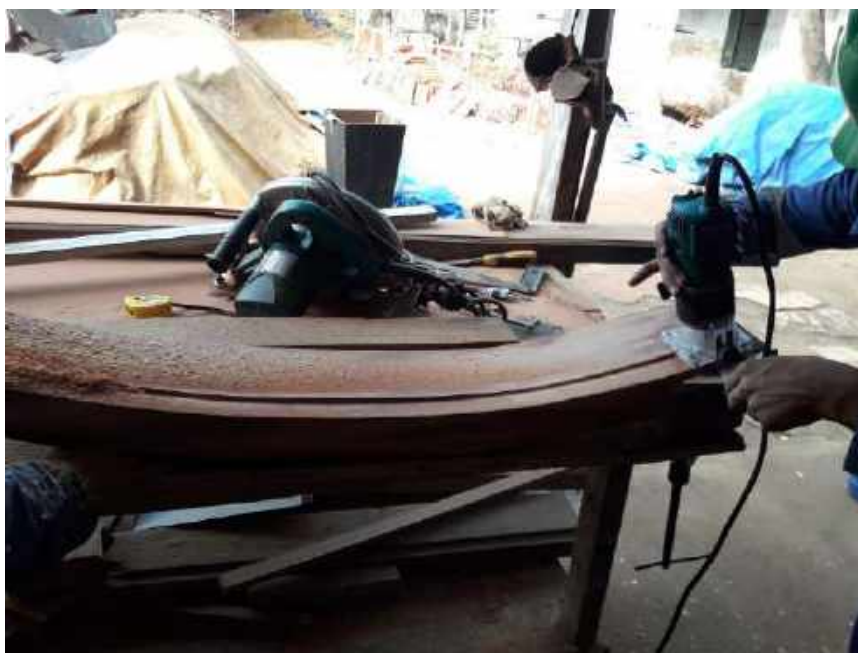
Foto 28 – Execução do arco da esquadria – Casa 06
