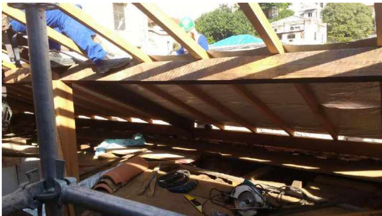
Foto 31: Instalação da manta aluminizada.
