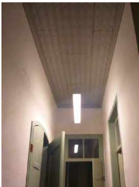
Foto 21 - Instalação da luminária para aprovação
