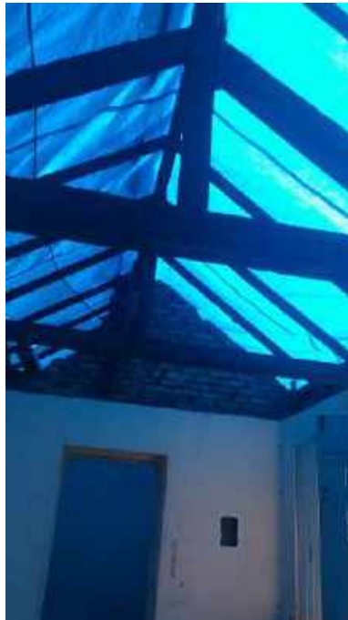
Foto 03: Remoção das telhas, caibros e ripas da Casa 5.
