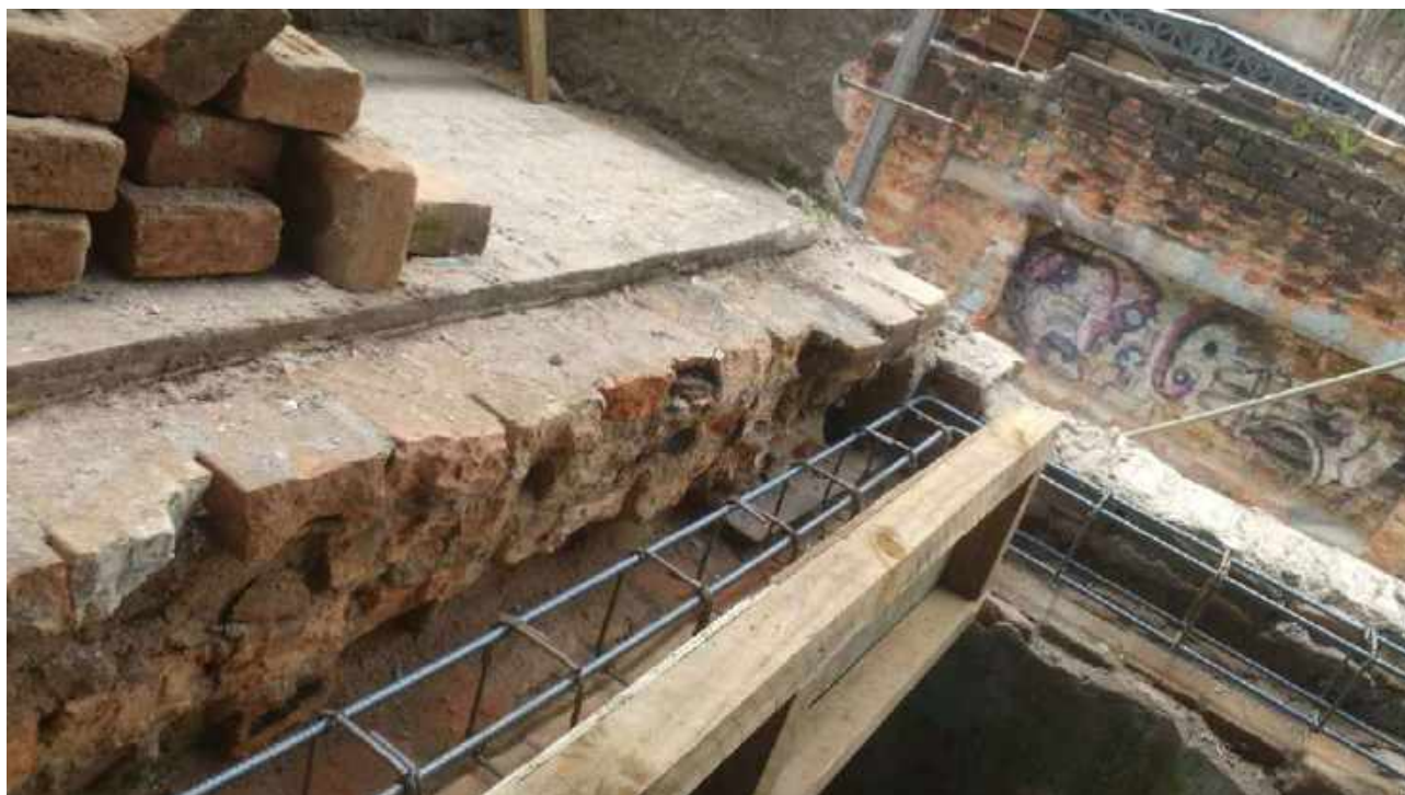
Foto 16: Execução da verga das esquadrias.
