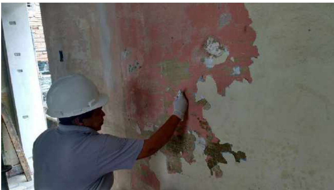
Foto 01 – Decapagem mecânica – casa 05
