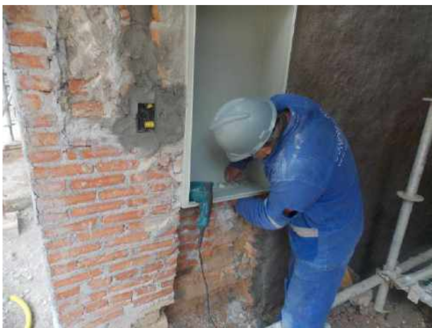
Foto 52- Instalação dos quadros elétricos – Casa 06
