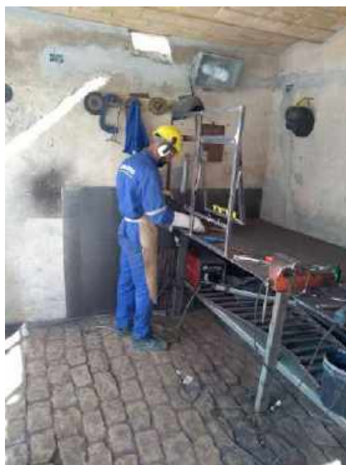
Foto 16 – Execução da esquadria metálica – Casa 05
