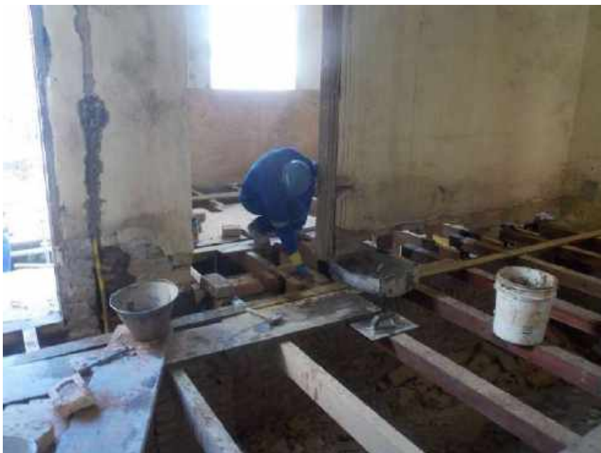
Foto 27 – Recuperação da alvenaria – Casa 06
