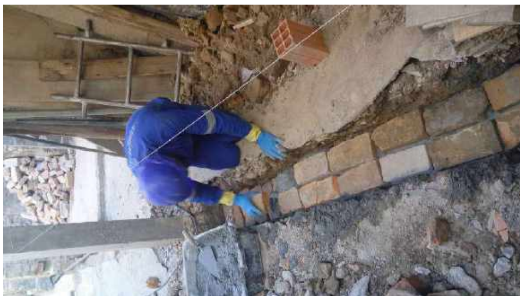
Foto 12 – Execução da alvenaria – Casa 06
