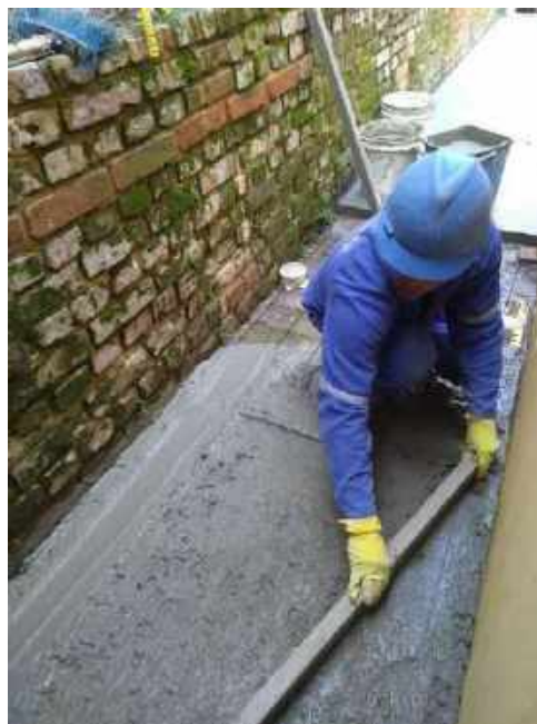
Foto 27 – Execução do piso cimentado
