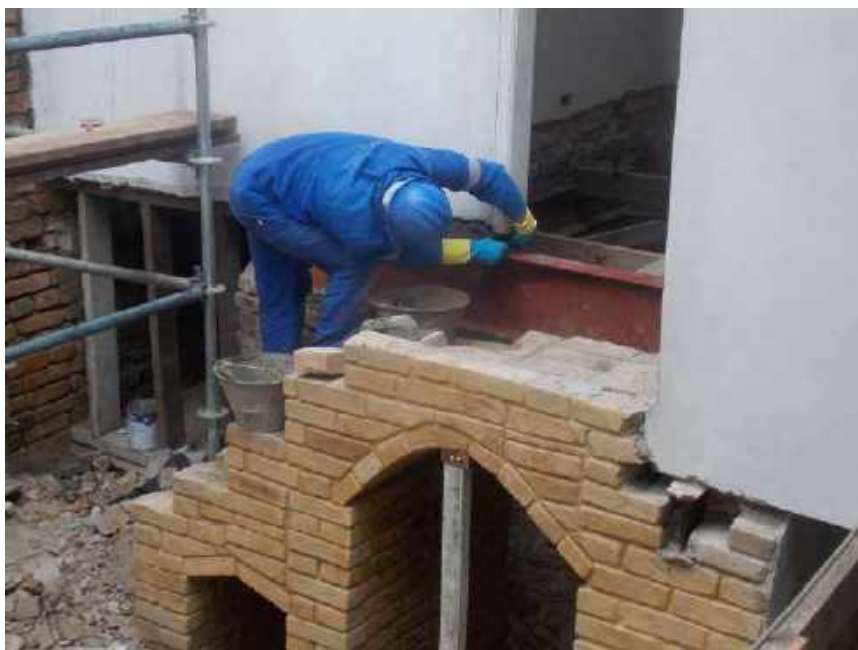
Foto 39 Fechamento da alvenaria após restauro do perfil metálico – Casa 06
