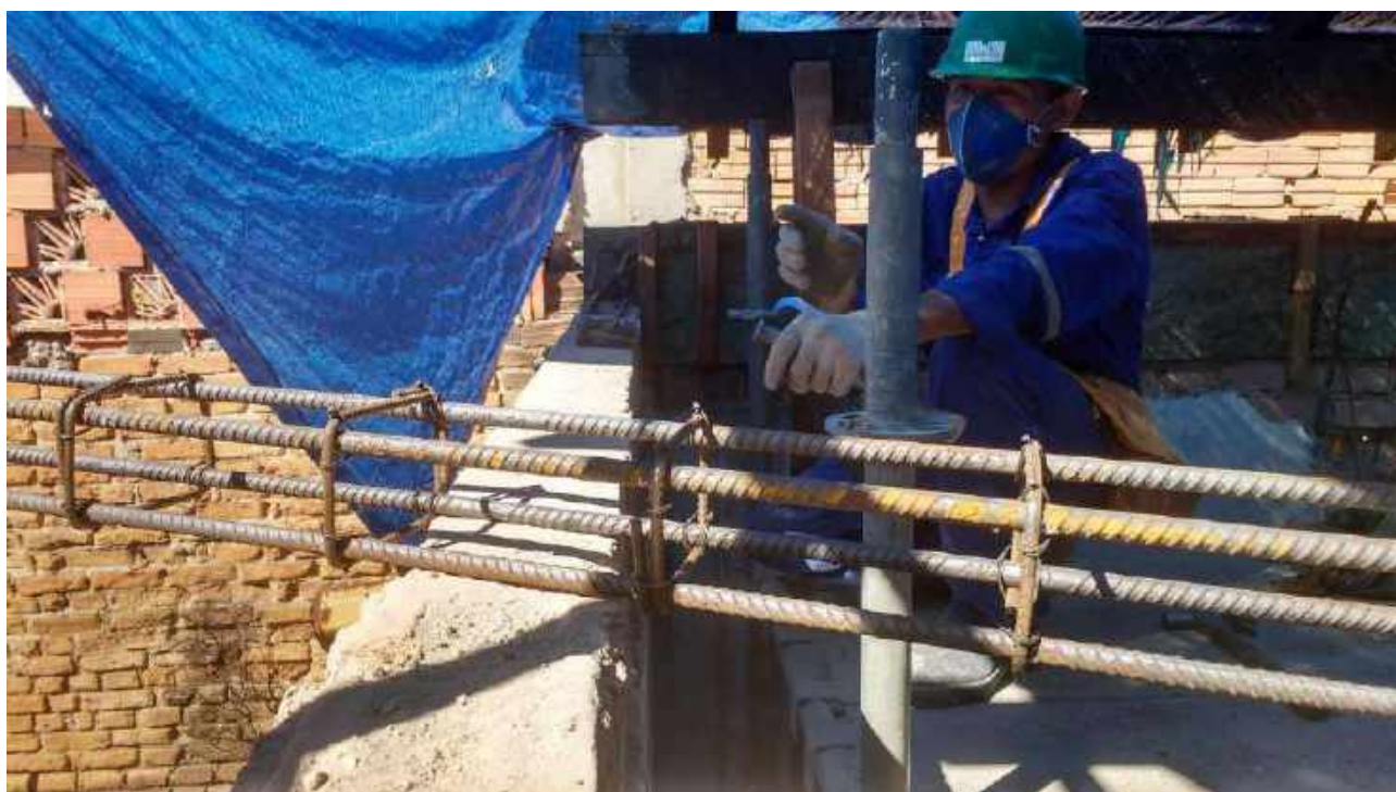
Foto 12: Armação das cintas de concreto.
