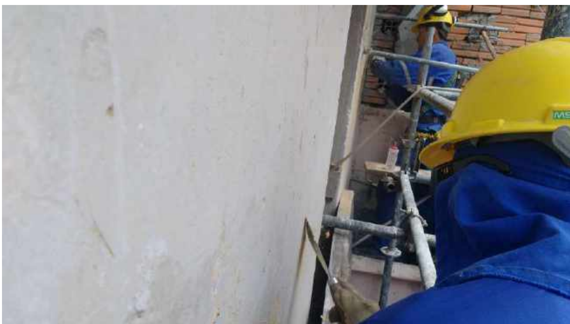
Foto 16 – Decapagem das tintas existentes – Casa 05
