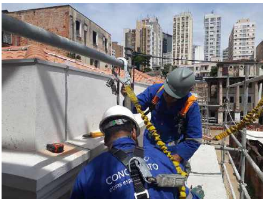
Foto 40 – Instalação das descidas de SPDA – Casa 06
