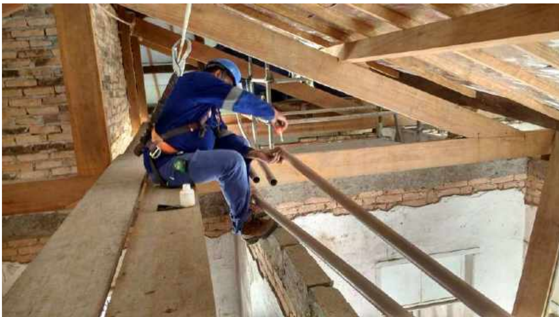
Foto 45 – instalação das tubulações para instalação da caixa d'água casa 06
