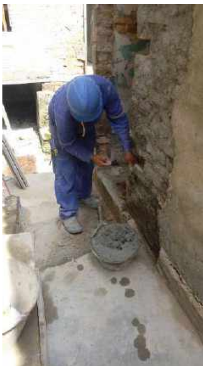
Foto 15 – Recuperação da alvenaria
