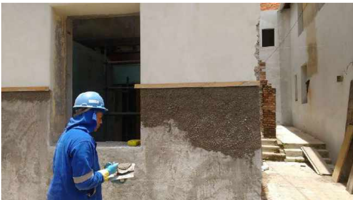
Foto 38 – Execução do emboço da fachada principal – Casa 06
