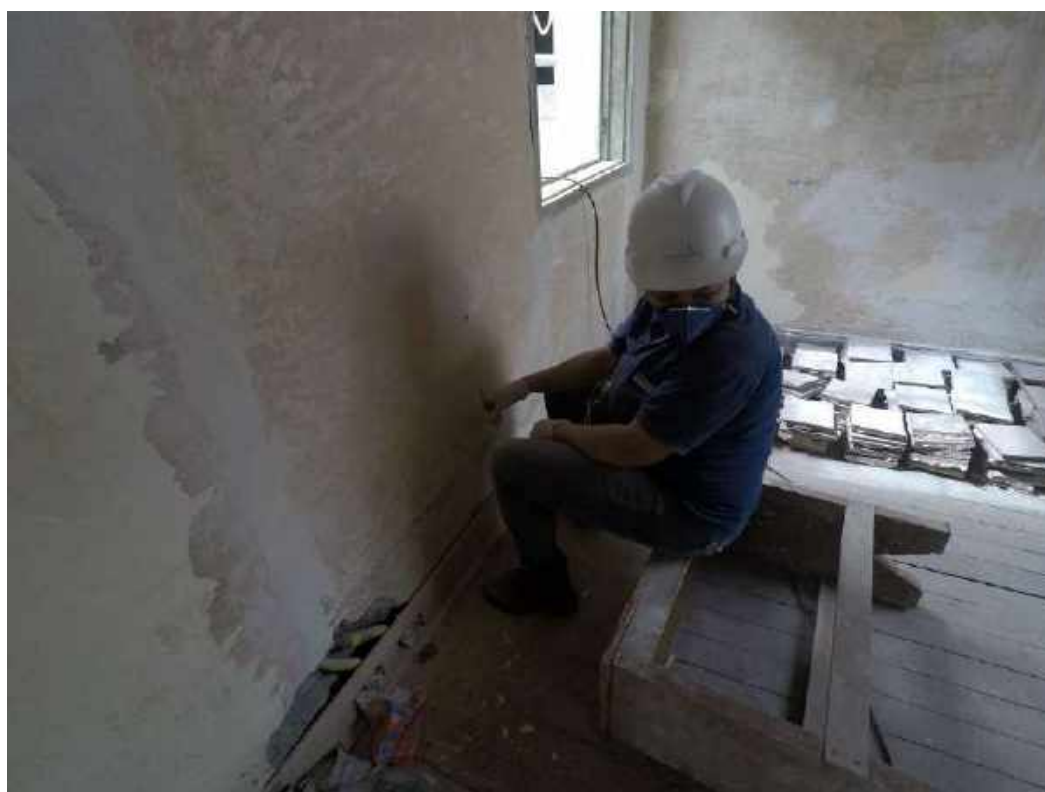
Foto 50 – Decapagem cuidadosa das tintas existentes sobre a pintura decorativa – Casa 05
