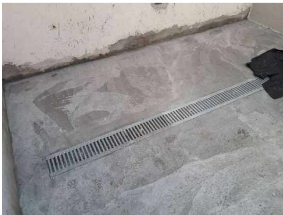
Foto 65 – Execução do piso dos fundos – Casa 06
