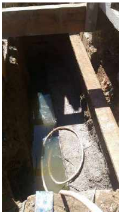
Foto 14: Concretagem do bloco e bombeamento da água do terreno.
