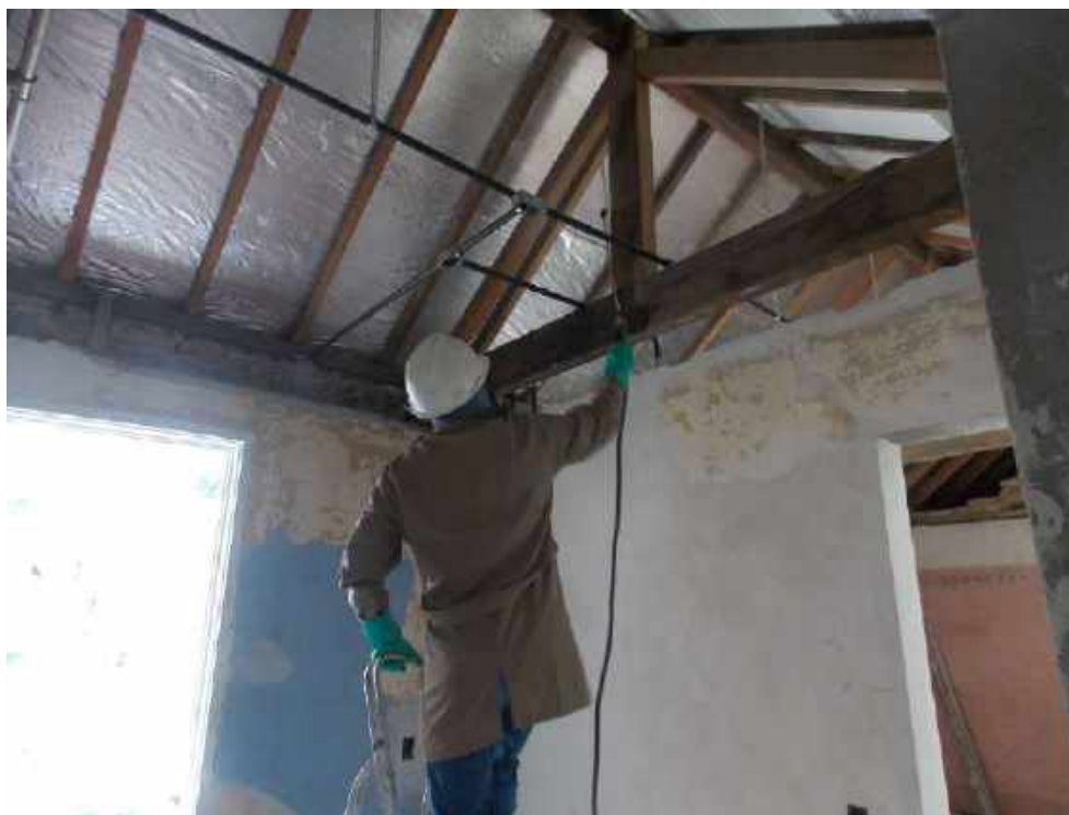
Foto 01- Execução da descupinização – Casa 05
