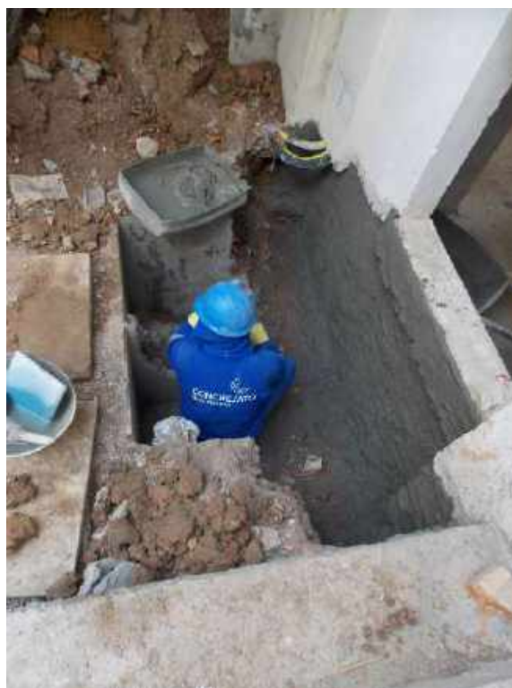
Foto 49 – Impermeabilização da alvenaria existente – Casa 0
