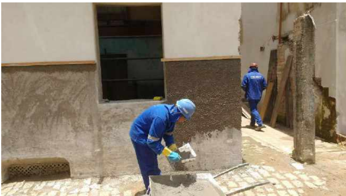
Foto 37 – Execução do emboço da fachada principal – Casa 06
