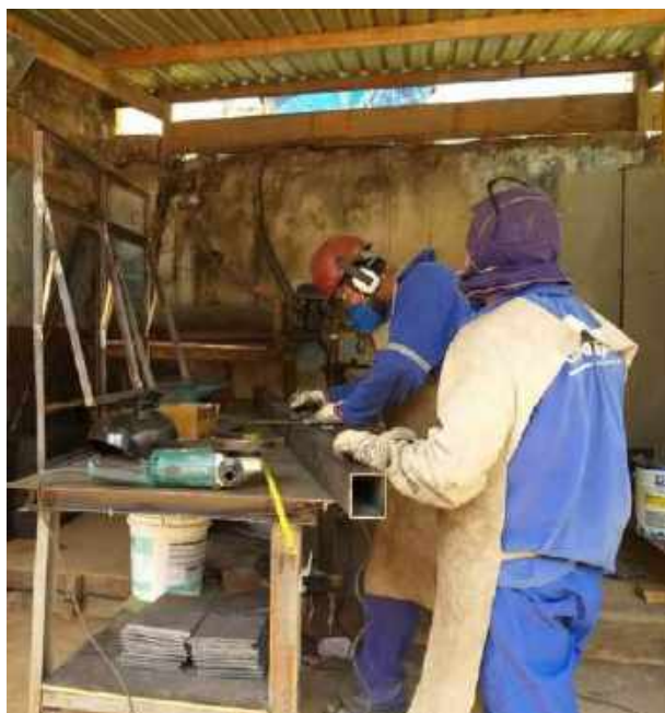
Foto 28 – Execução dos perfis metálicos para execução da cobertura
