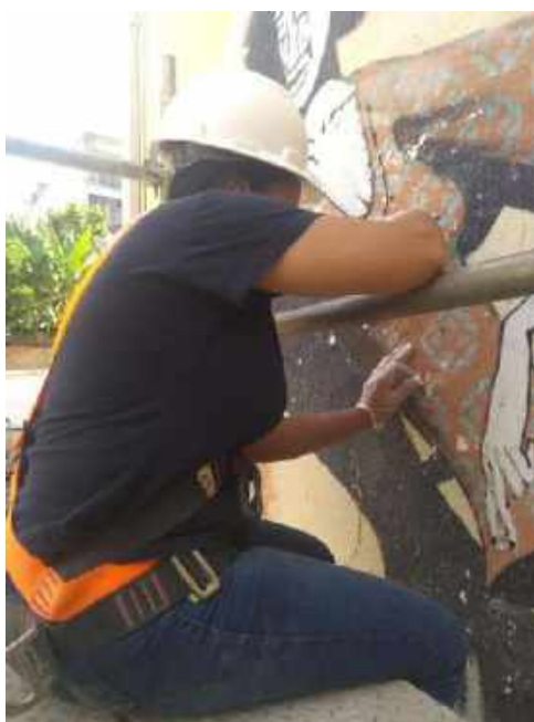
Foto 02 - Consolidação do grafite na fachada lateral – Casa 05
