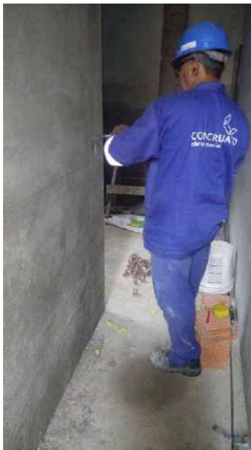
Foto 17 – Demolição manual para instalação da hidráulica
