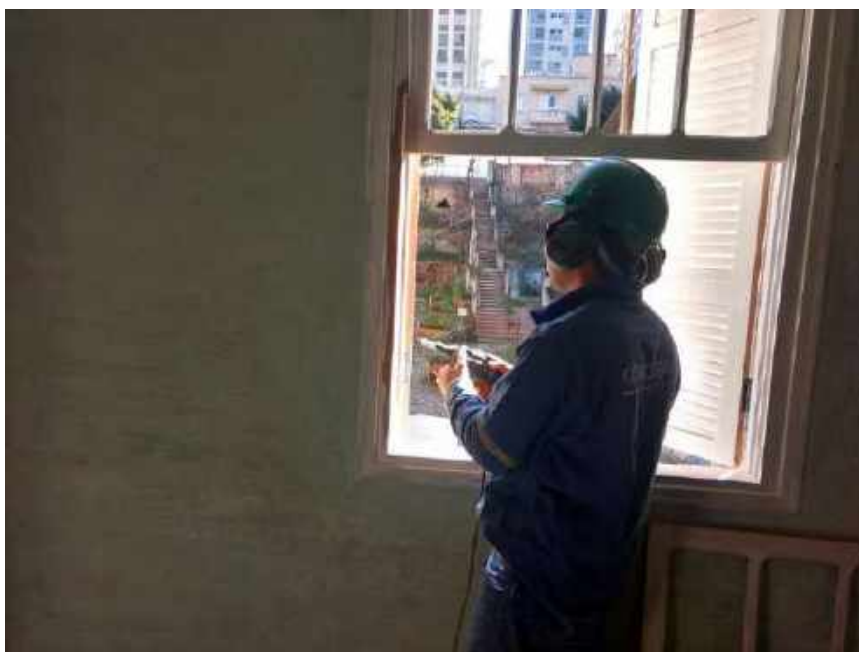
Foto 13 – Instalação das esquadrias de madeira – Casa 05
