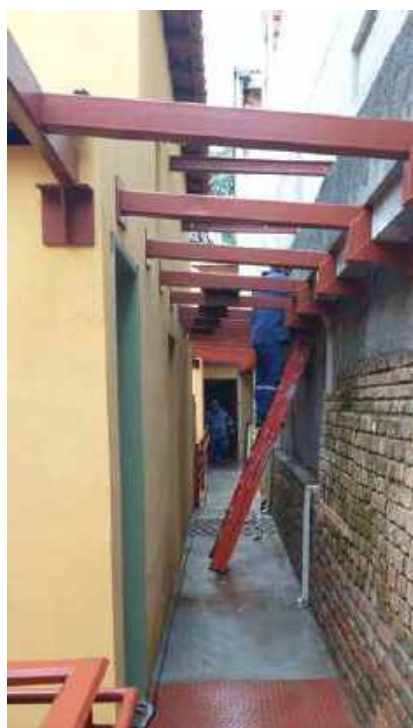
Foto 08 – Instalação do rufo – Casa 06
