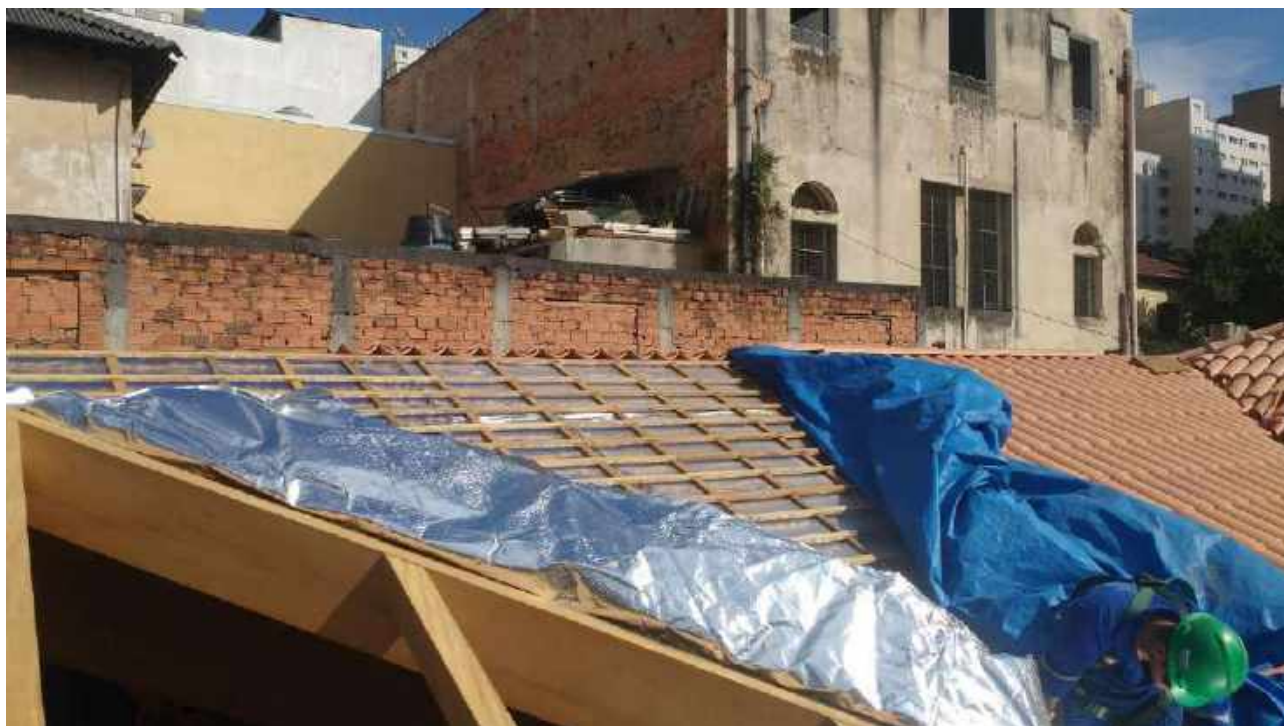
Foto 43: Instalação de manta aluminizada. Casa 06.
