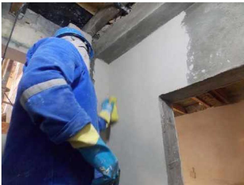
Foto 12 – Execução da argamassa de acabamento – Casa 06
