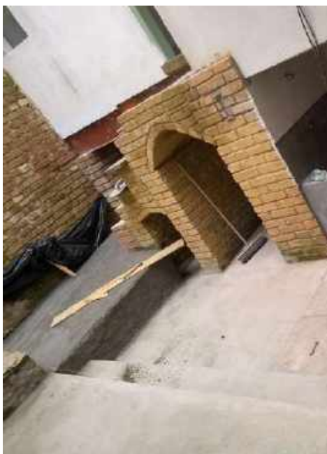
Foto 22 – Elevação da alvenaria da escada – Casa 06
