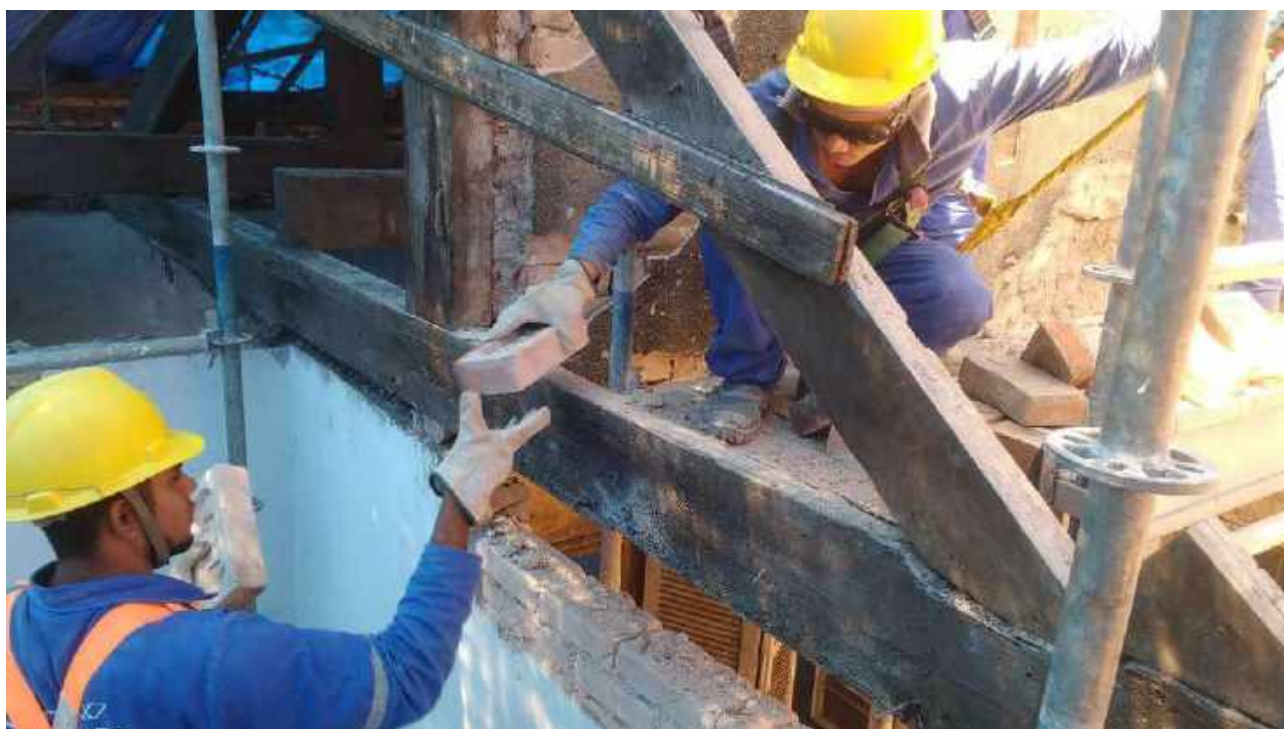
Foto 16: Remoção cuidadosa de alvenaria para execução de cinta de concreto.
