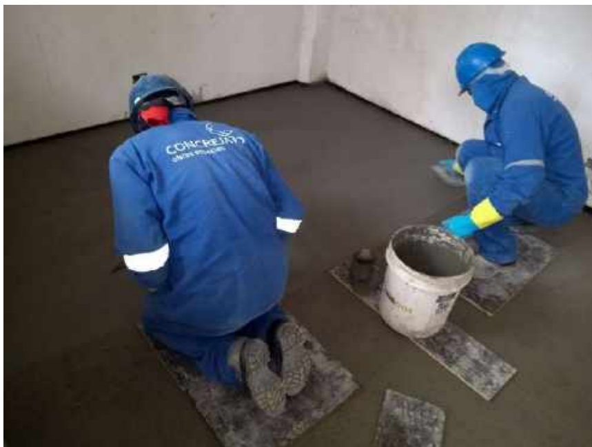
Foto 31 - Execução do piso em cimento queimado – Casa06
