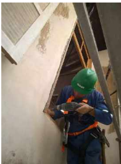
Foto 56 – Instalação das esquadrias de madeira – Casa 06
