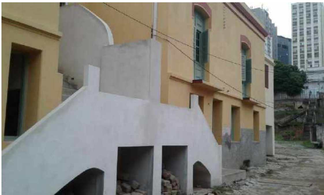
Foto 43 – Fachada frontal – Casa 06
