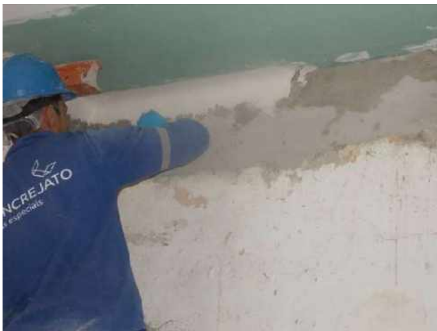
Foto 49 – Execução do acabamento do forro – Casa 06
