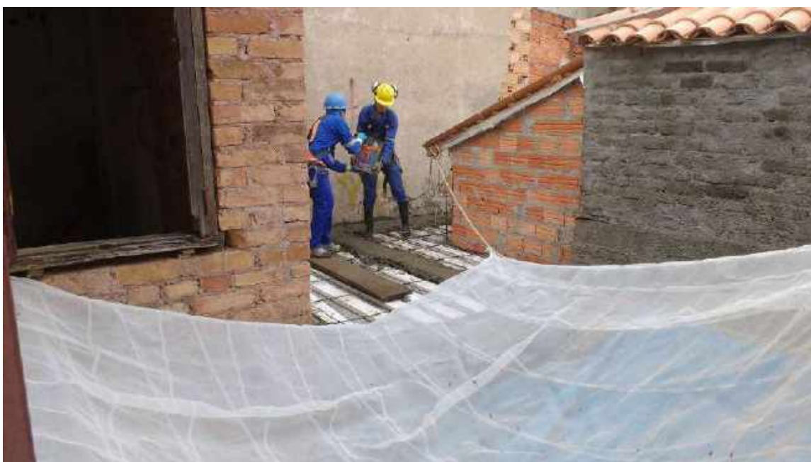
Foto 16 – Concretagem da laje – Casa 06
