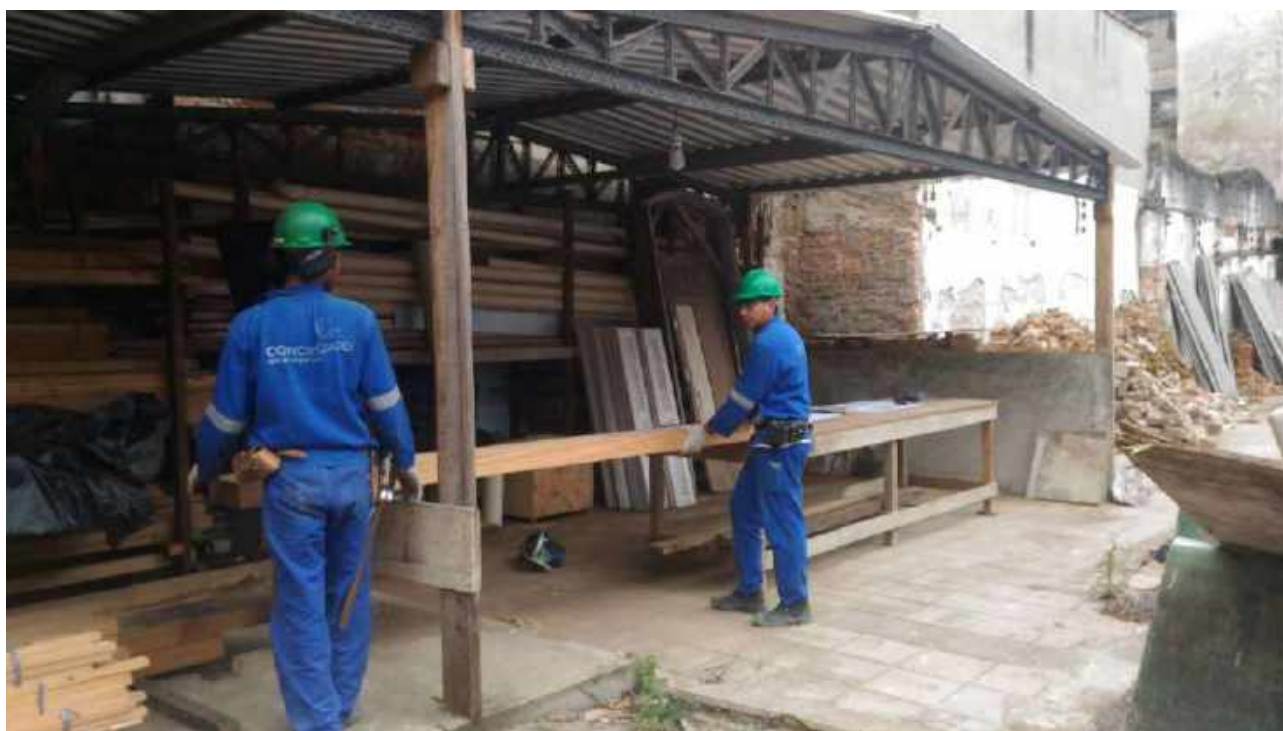
Foto 08: Execução das tesouras em madeira.
