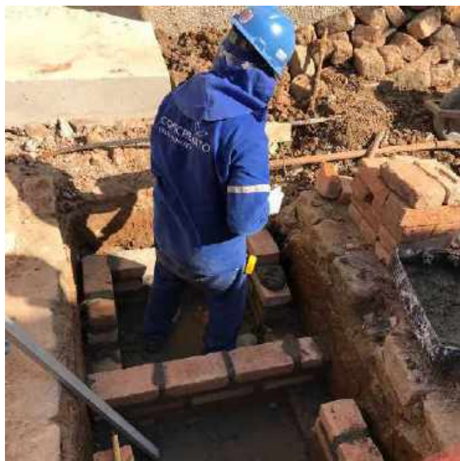
Foto 64 – Execução da caixa para passagem do esgoto e águas pluviais
