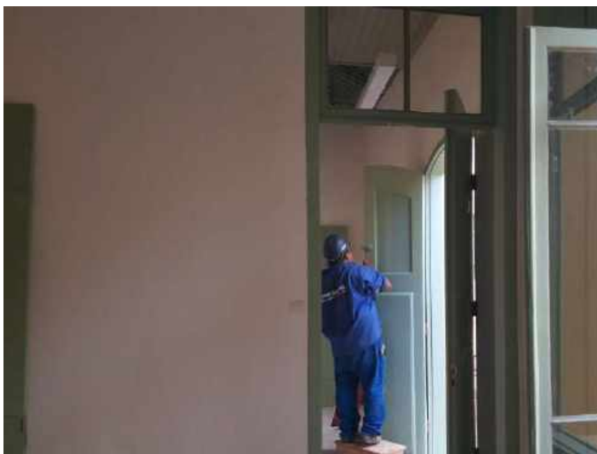
Foto 16 – Pintura lisa das portas de madeira – Casa 06
