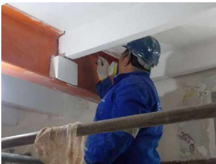
Foto 12 – Pintura lisa do perfil metálico – Casa 05
