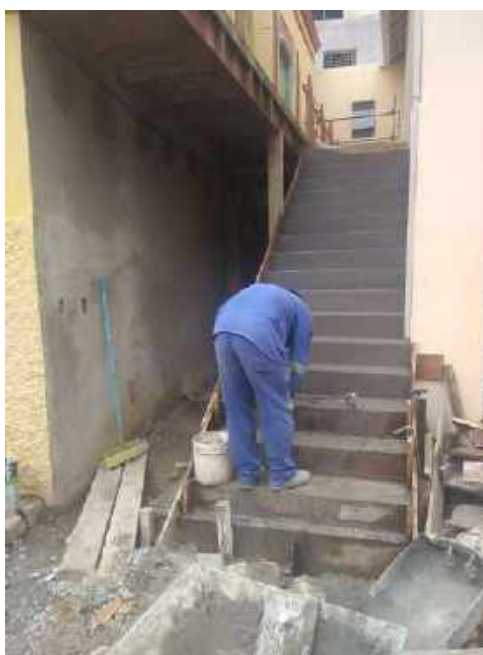
Foto 02 – Execução da argamassa de acabamento das escadas
