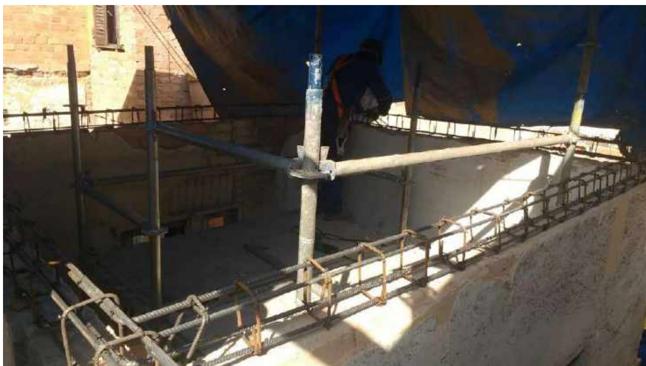
Foto 58: Armação das cintas de concreto. –Casa 06
