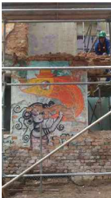
Foto 13: Desmontagem cuidadosa da alvenaria com reaproveitamento de tijolos – Casa 6.
