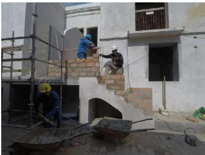
Foto 36 – Elevação da alvenaria
