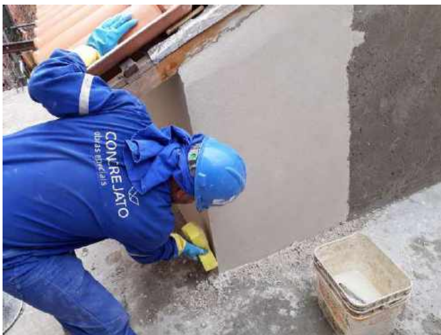
Foto 45 – Execução da argamassa de acabamento – Casa 06
