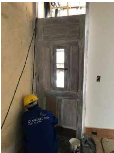
Foto 33 – Emassamento das portas de madeira – Casa 06
