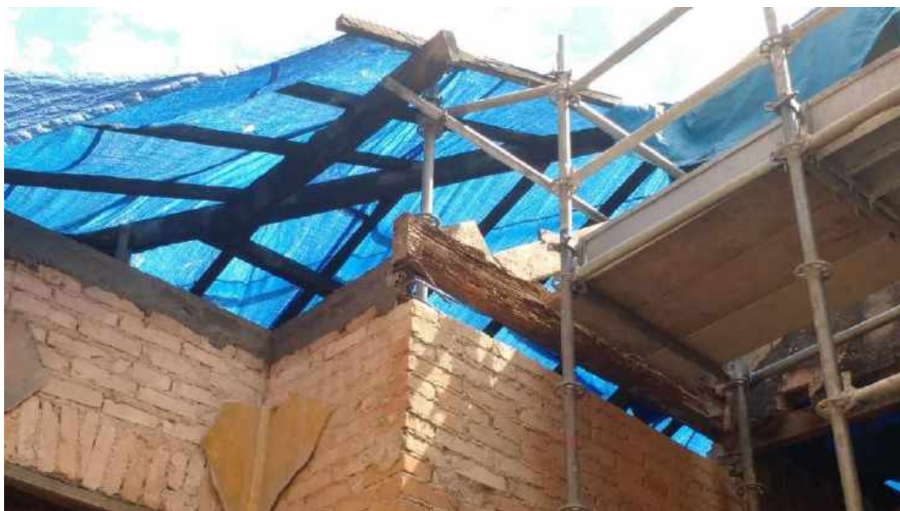
Foto 14: Substituição de peça de madeira danificada.
