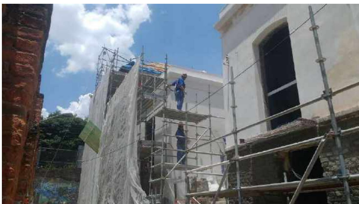
Foto 20 – Desmontagem do andaime – casa 06
