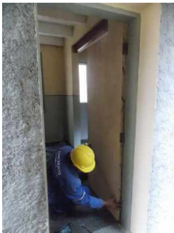
Foto 08 – Instalação das portas de madeira – Casa 05
