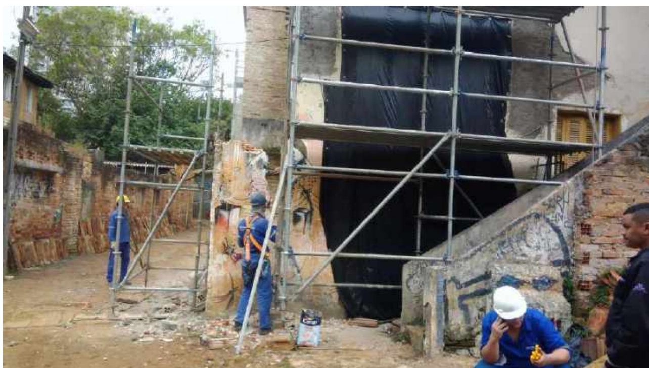
Foto 74: Substituição das peças danificadas da tesoura da Casa 6.
