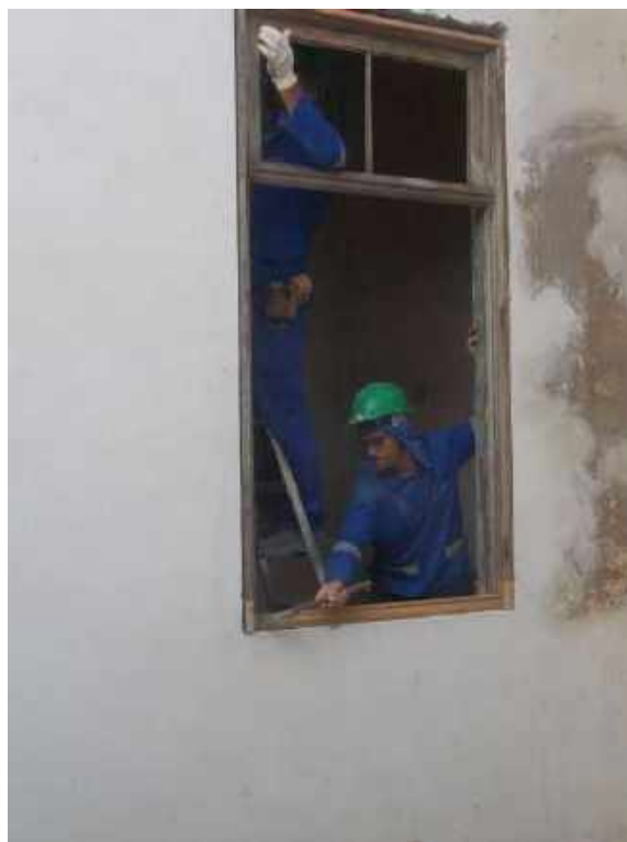
Foto 55 – Instalação da esquadria de madeira – Casa 06
