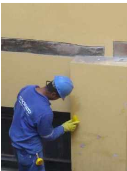
Foto 35 - Revisão da argamassa de acabamento das paredes externas
