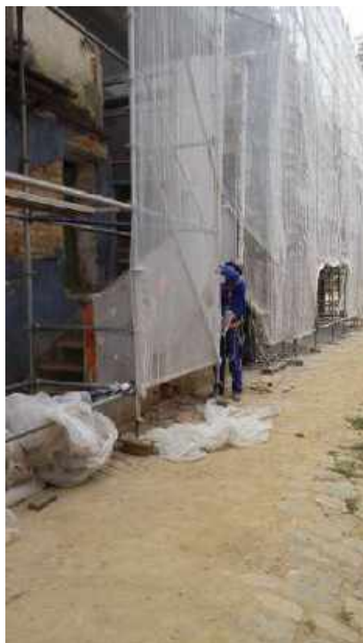
Foto 01- Instalação da tela de proteção no andaime da fachada – Casa 06
