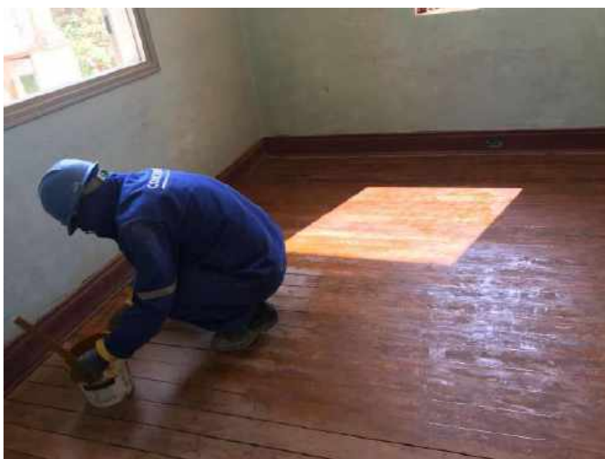
Foto 06 – Calafetação dos juntas do assoalho de madeira – Casa 05
