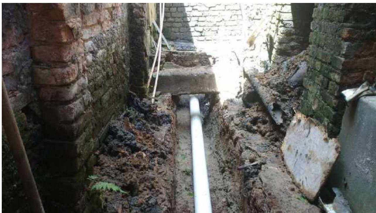
Foto 02: Novo sistema de captação de água.
