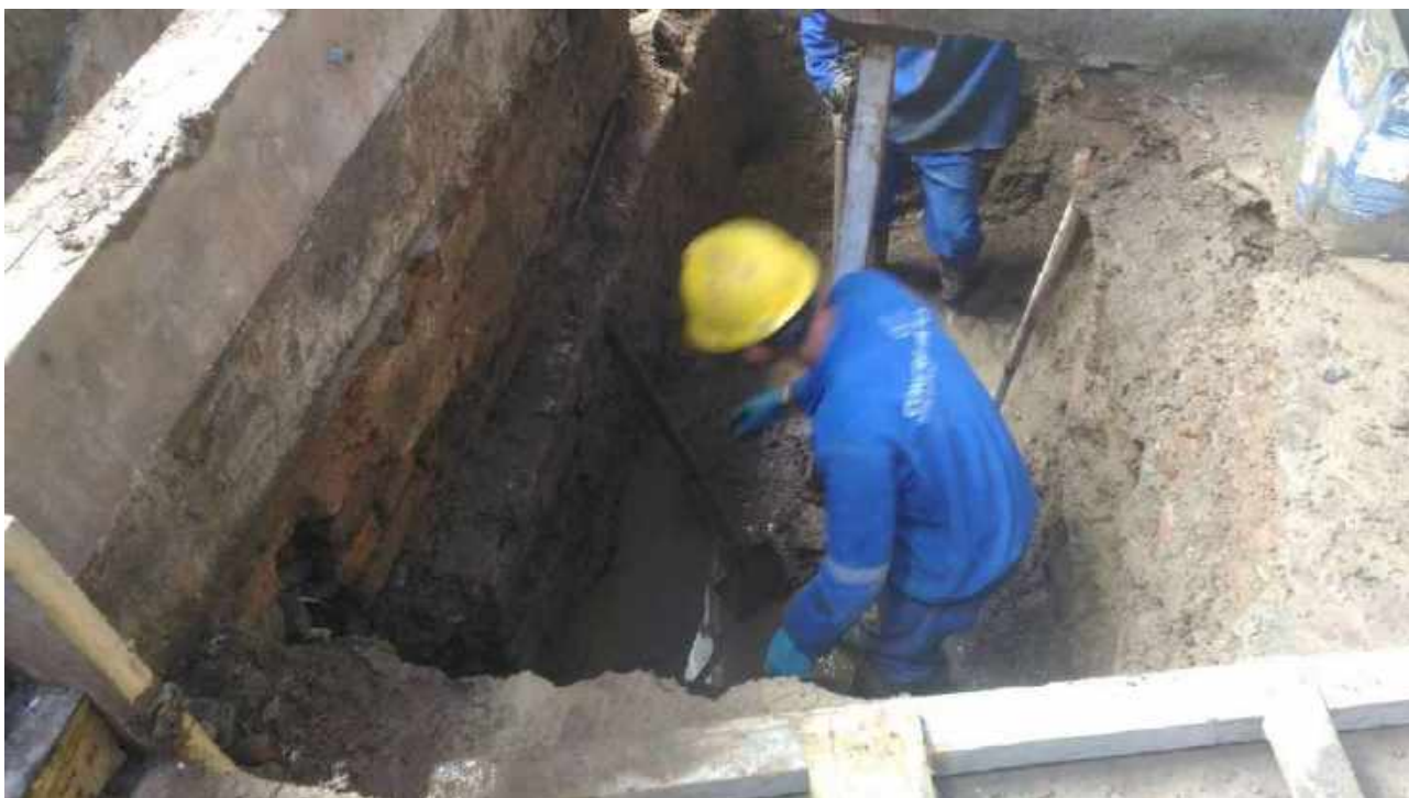
Foto 06: Abertura da vala para reforço da fundação,
