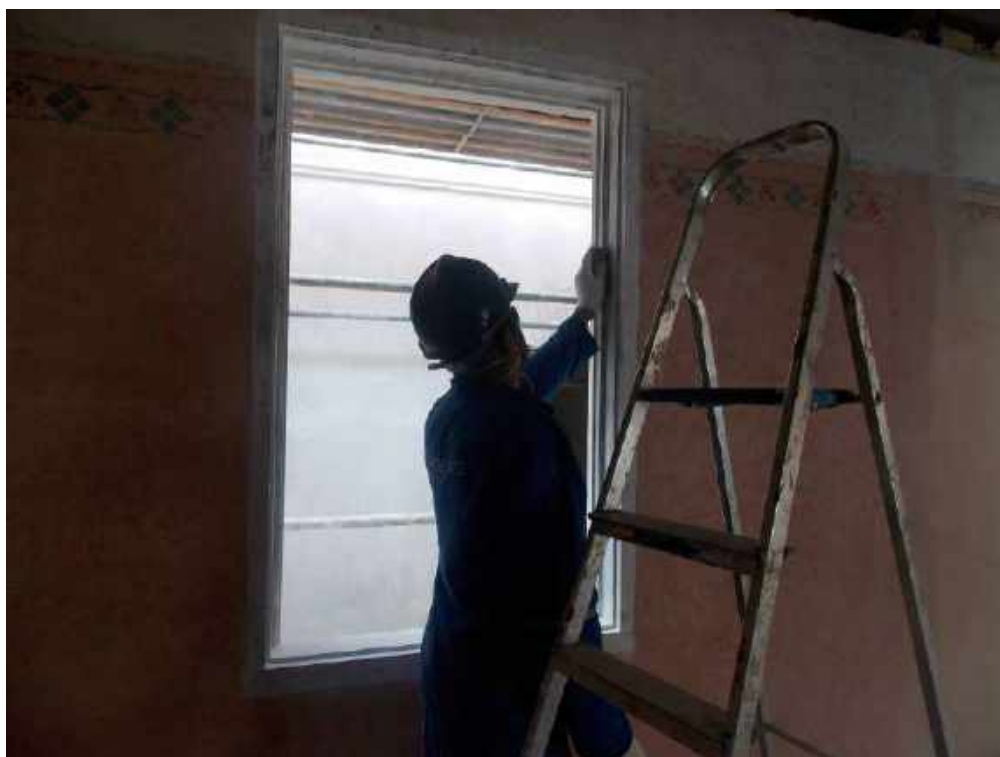
Foto 06 – Lixamento das esquadrias – Casa 05
