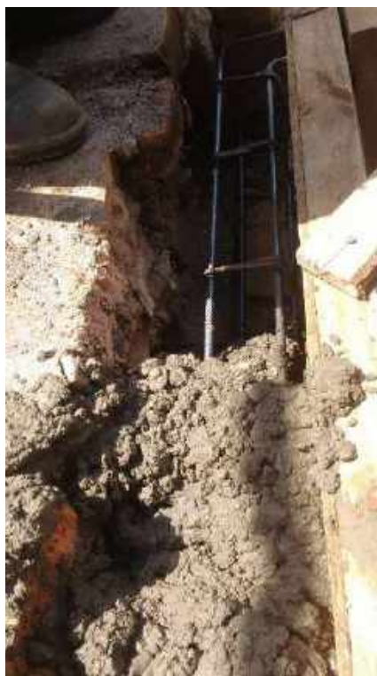
Foto 18: Execução da verga das esquadrias
