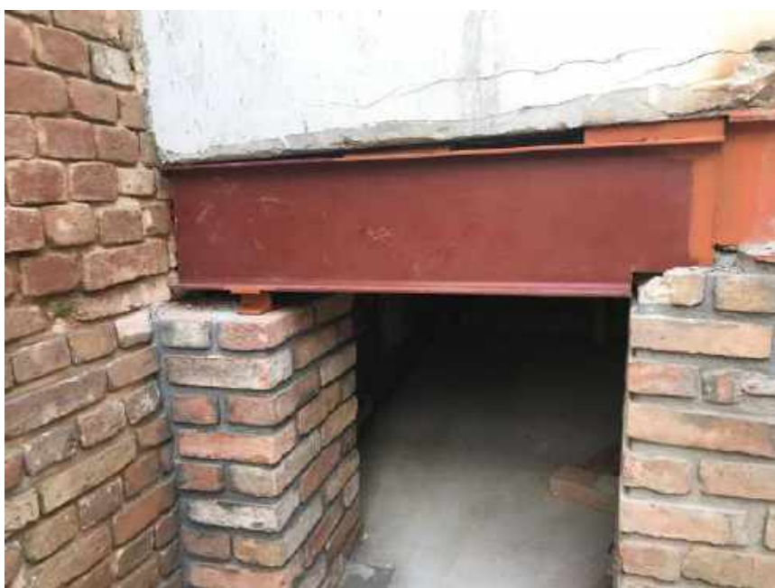
Foto 34 – Reforço estrutural – Casa 06
