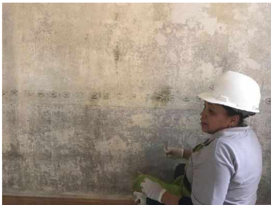
Foto 44– Fachada frontal – Casa 06
