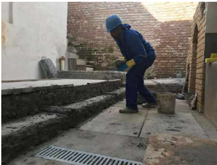
Foto 35 – Execução dos degraus dos fundos – Casa 06
