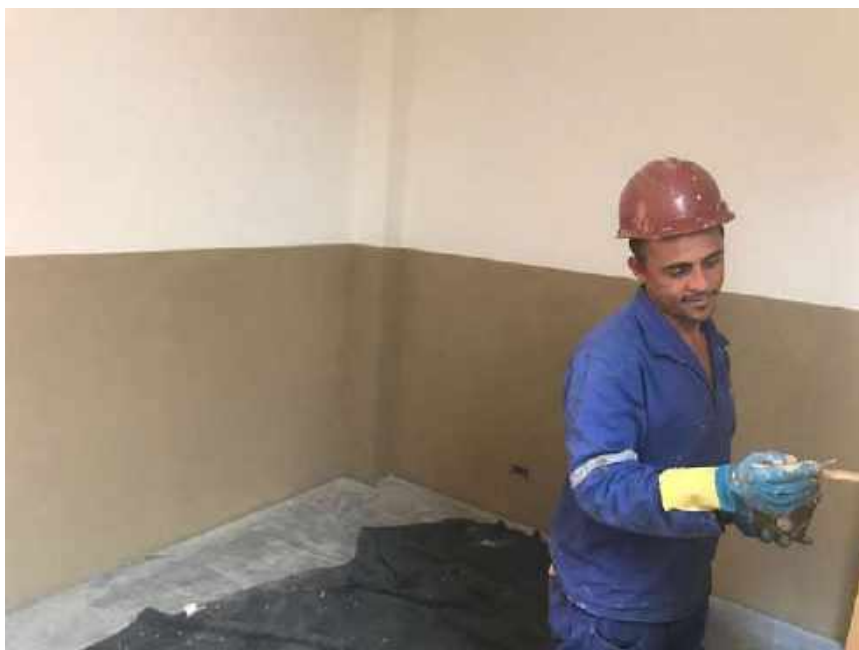
Foto 35 – Pintura lisa das paredes internas –Casa 06
