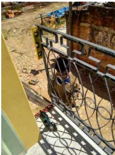
Foto 23 – Instalação do gradil na sacada
