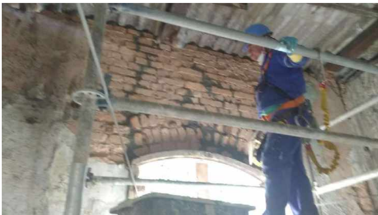
Foto 16: Consolidação das alvenarias da Casa 6.
