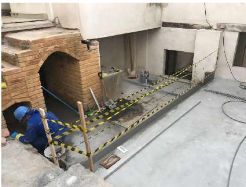
Foto 36 – Execução dos degraus dos fundos – Casa 06
