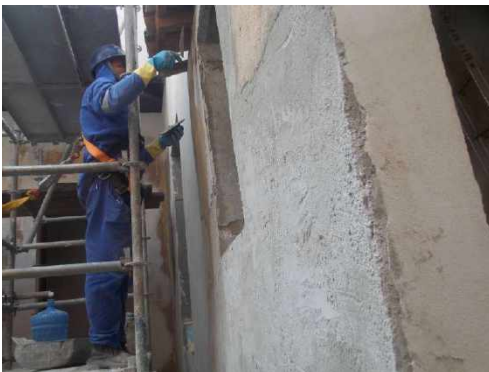
Foto 38 – Execução da argamassa de acabamento da fachada dos fundos – Casa 06
