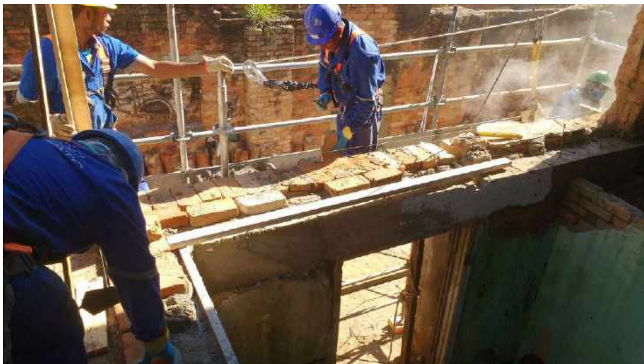
Foto 24: Remontagem da alvenaria.
