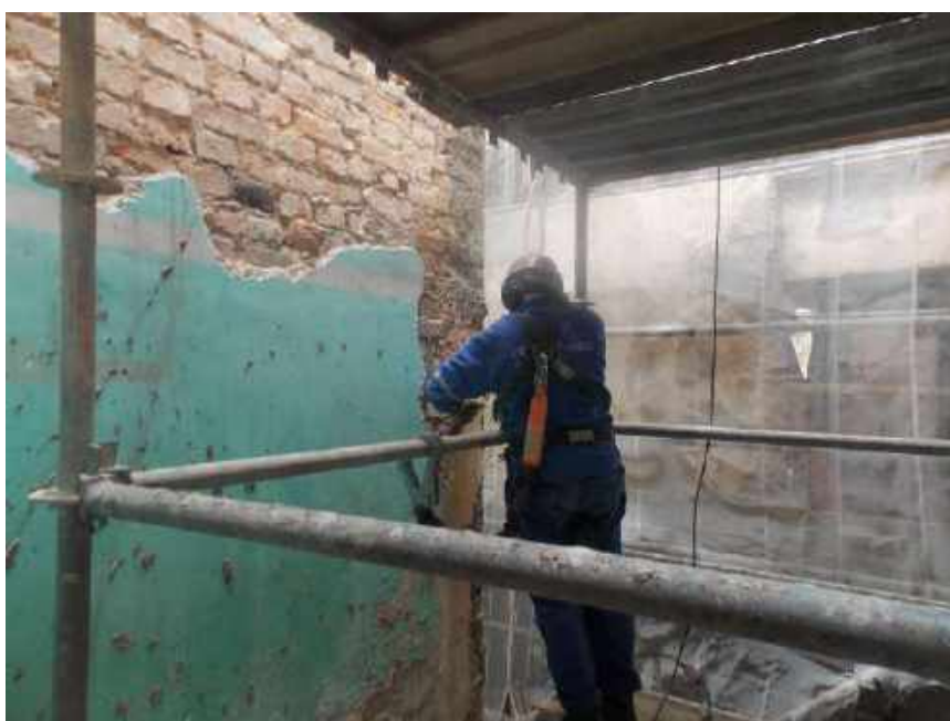
Foto 61 – Remoção da argamassa existente – Casa 06
