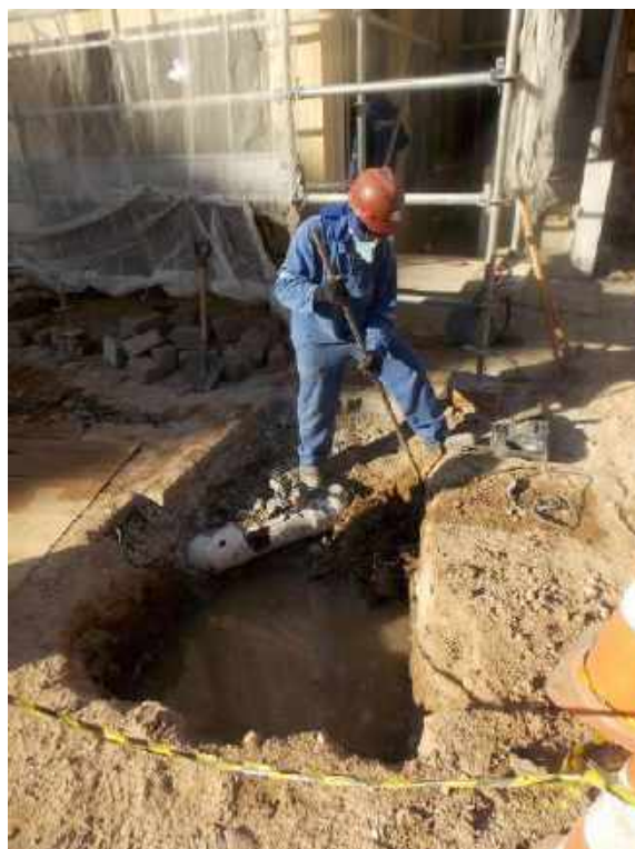
Foto 42 - Escavação manual para execução da caixa do esgoto e águas pluviais
