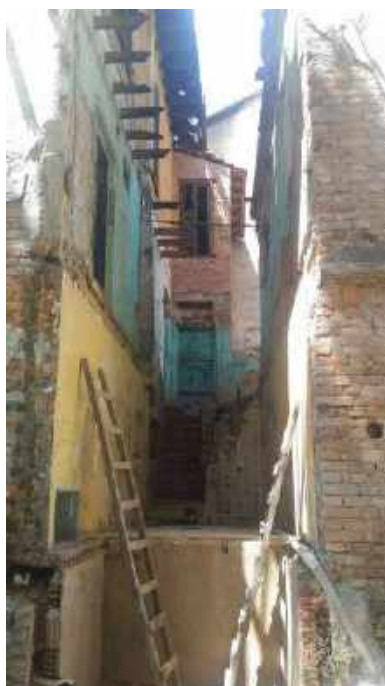
Foto 22: Cobertura provisória da Casa 7 após remontagem da alvenaria.
