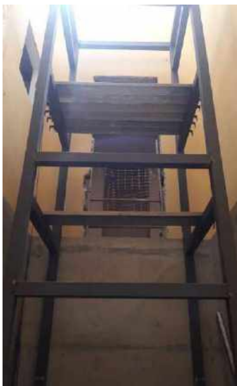
Foto 45 – Montagem da estrutura metálica da plataforma elevatória
