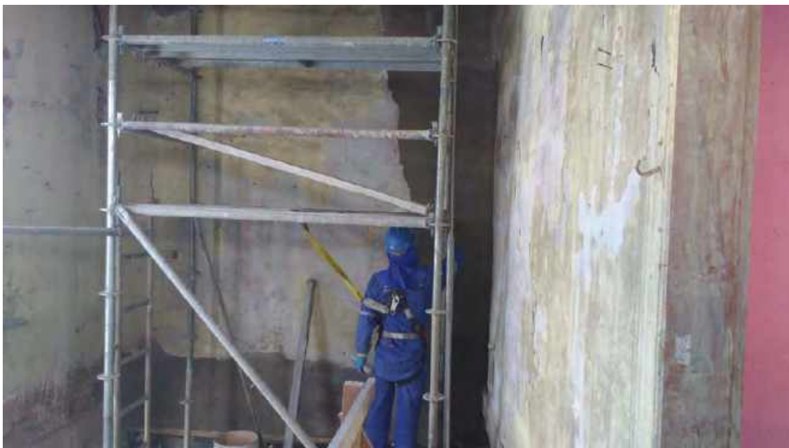
Foto 47- Execução do emboço das paredes da casa 06
