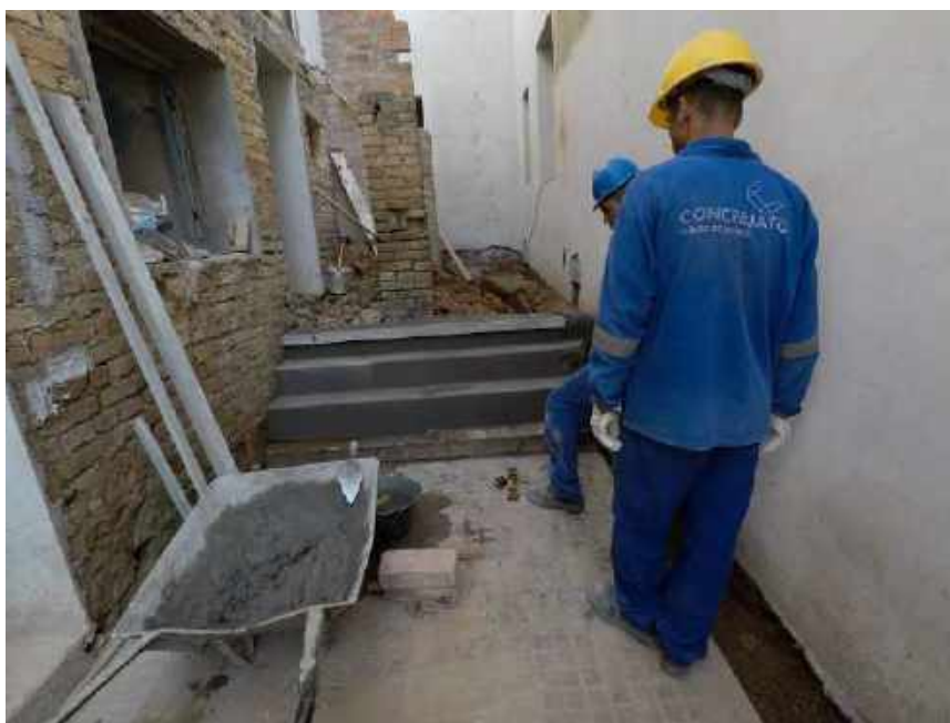
Foto 23 – Execução da argamassa de acabamento – Casa 06
