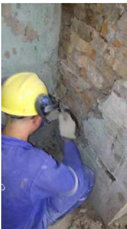
Foto 32 – Remoção do revestimento
