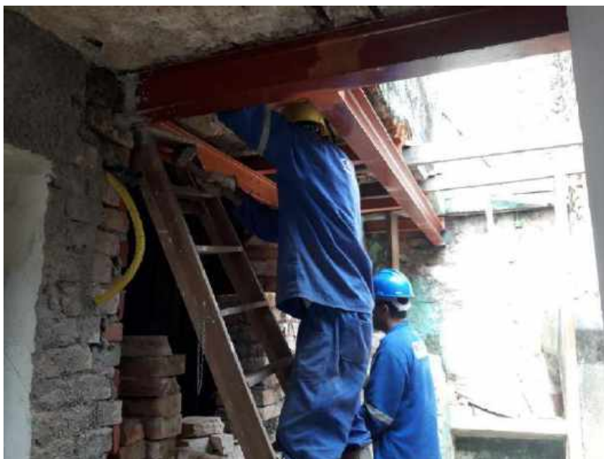
Foto 04 – Instalação do perfil metálico – Casa 05
