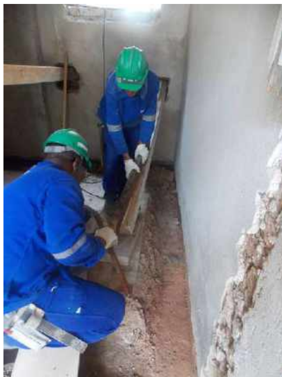
Foto 23 – Escoramento da alvenaria para execução dos serviços na base da alvenaria – Casa 06
