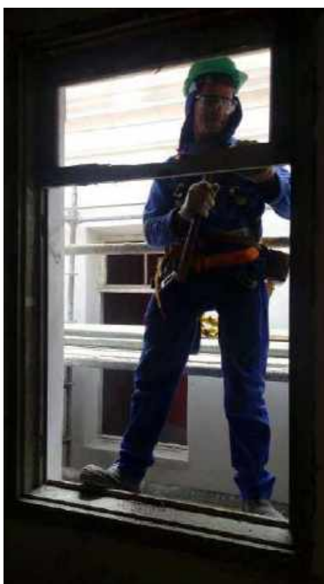
Foto 44 – Restauro dos batentes da fachada – Casa 06
