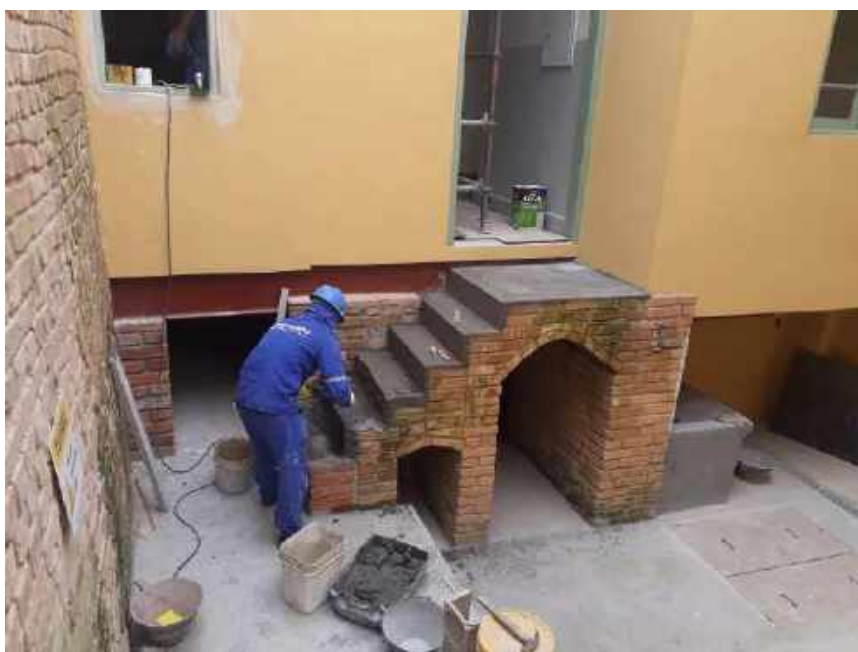
Foto 31 – Recuperação da escada de alvenaria existente – Casa 06
