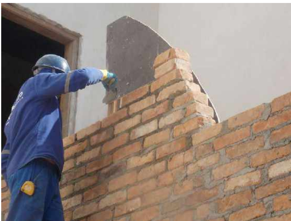
Foto 46 – Elevação da alvenaria existente – Casa 06
