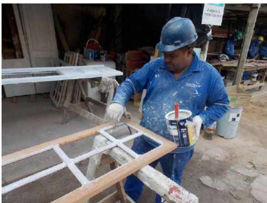
Foto 08 – Execução da proteção das esquadrias de madeira – Casa 05
