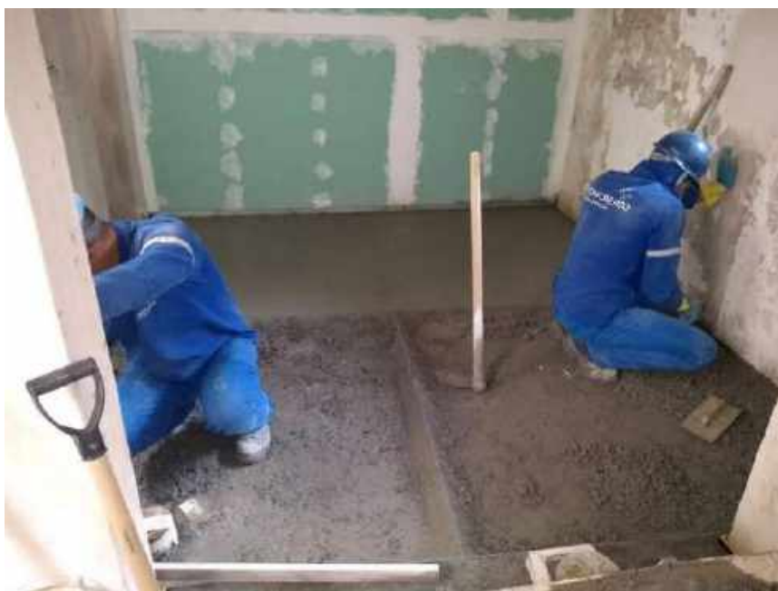
Foto 26 – Execução do piso cimentado – Casa 05
