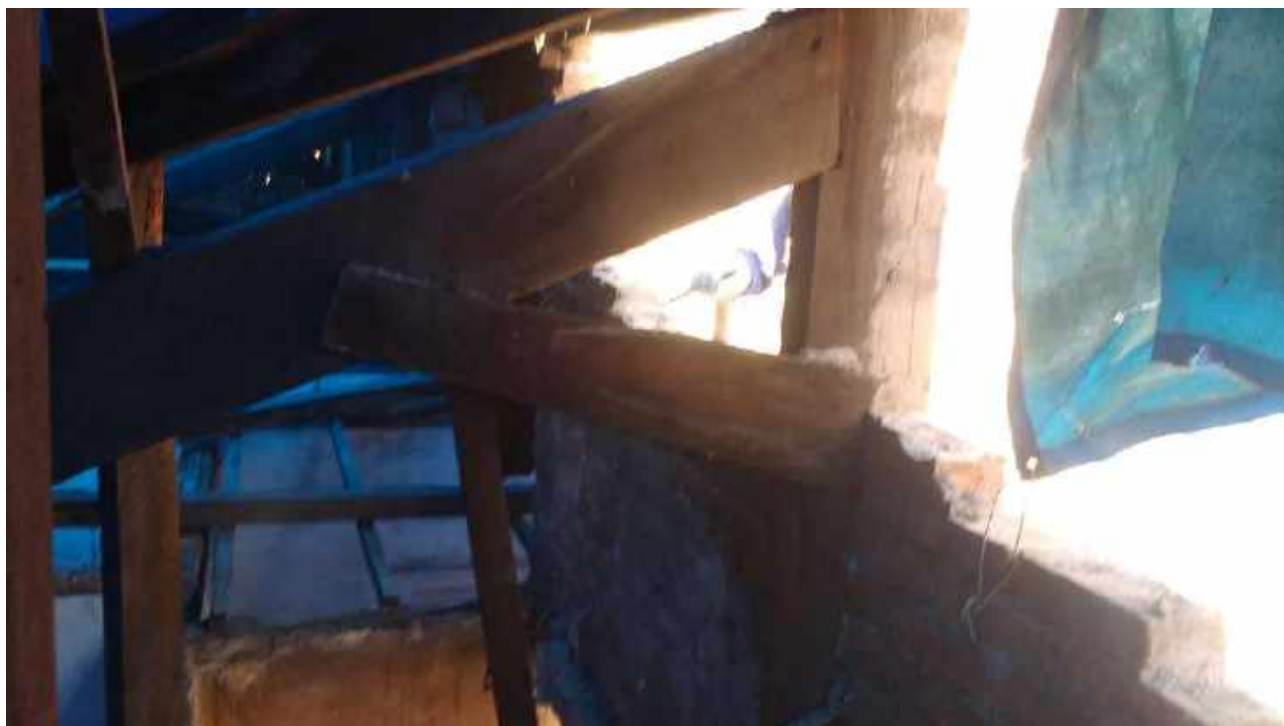
Foto 17: Substituição das peças danificadas da cobertura.
