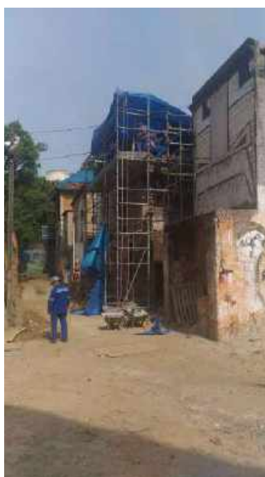
Foto 26: Remontagem da alvenaria – Casa 6.
