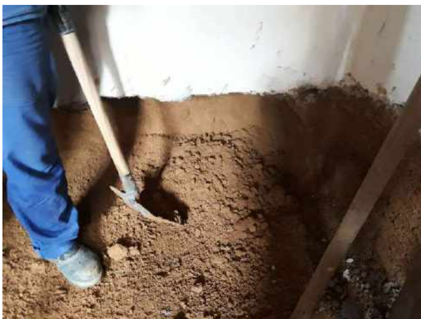
Foto 42 – Escavação manual para reforço da alvenaria – Casa 06
