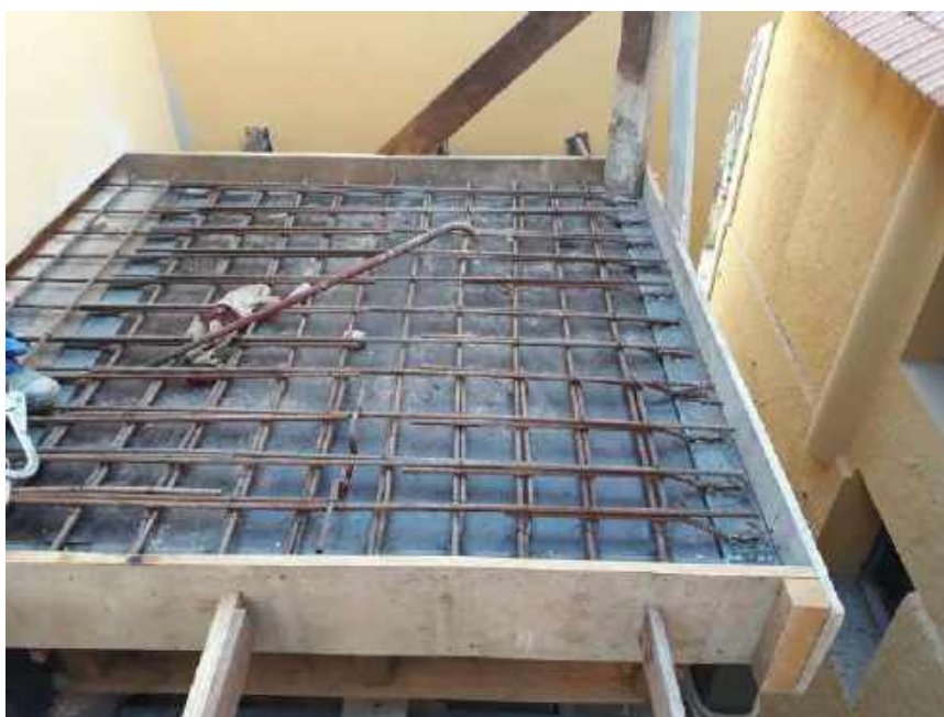
Foto 41 - Execução da armação para concretagem da cobertura do elevador – Casa 06
