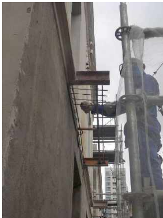
Foto 17 – Execução da armação da varanda – Casa 06
