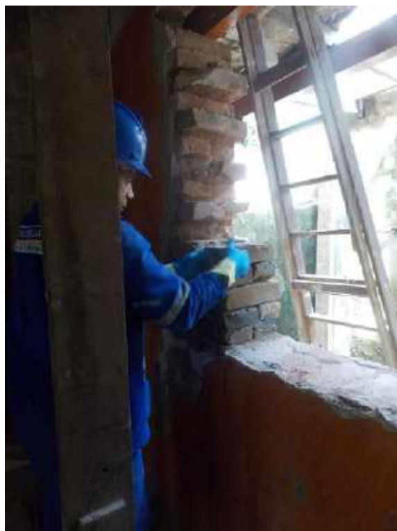
Foto 06 – Recuperação da alvenaria – Casa 05
