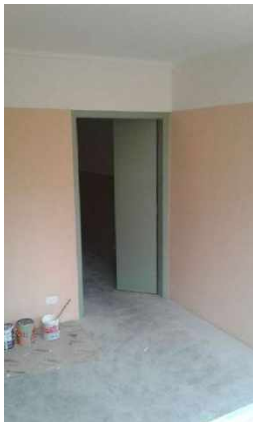
Foto 41 – Pintura de acabamento interno – Casa 06
