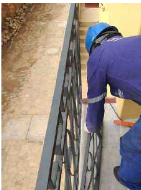
Foto 10 - Instalação do gradil metálico da sacada – Casa 06
