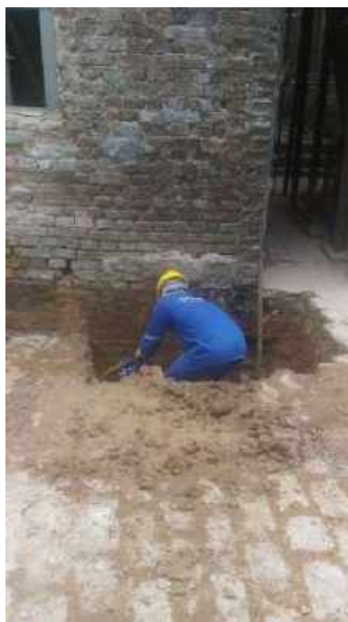
Foto 15: Abertura de vala para reforço na fundação – Casa 6.
