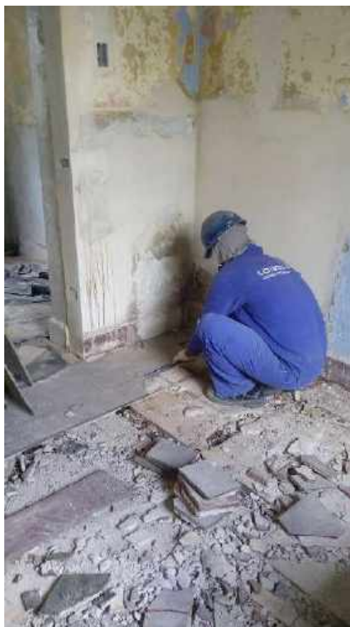
FOTO 05 – REMOÇÃO CUIDADOSA DO PISO DE LADRILHO HIDRAULICO – CASA 05
