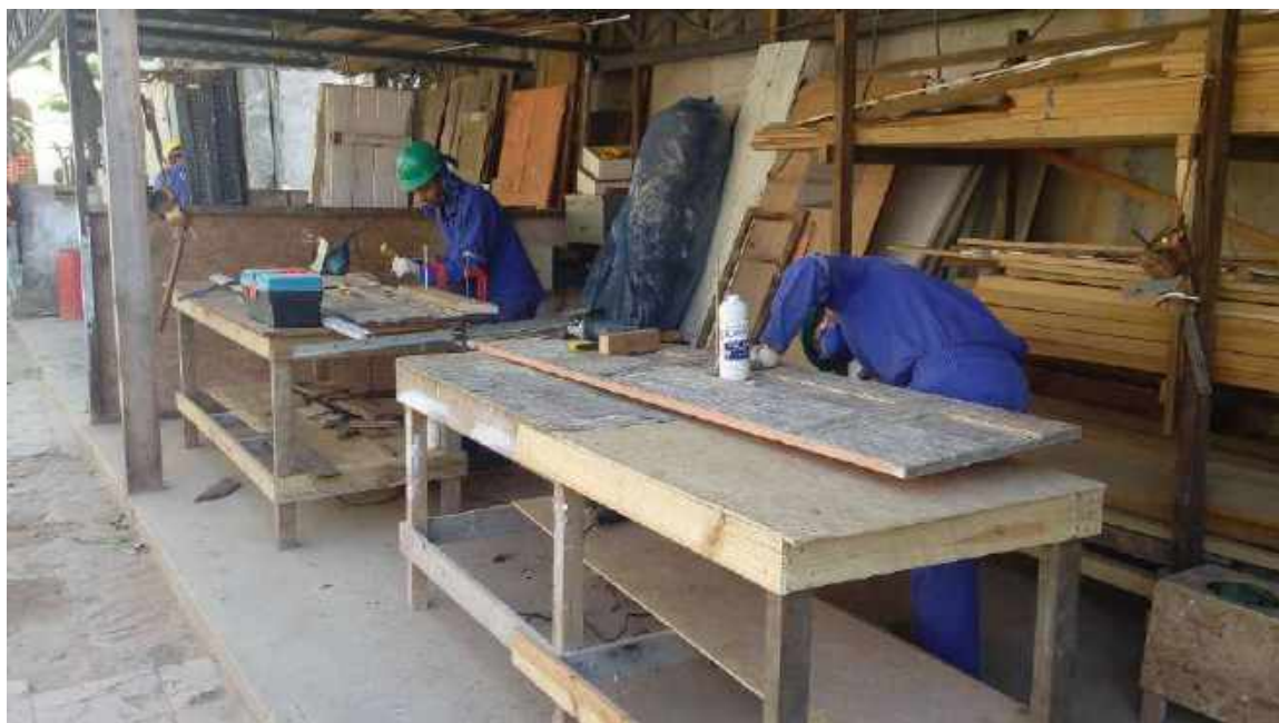
Foto 07 – Restauração das portas de madeira – Casa 06
