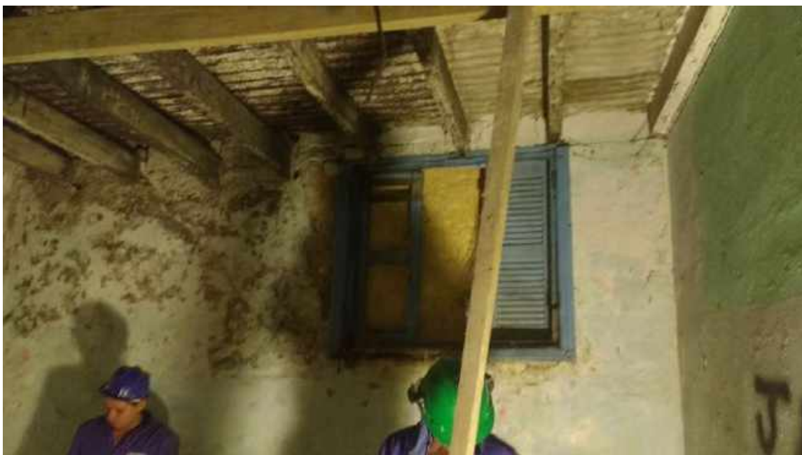
Foto 51 – Escoramento dos barrotes de madeira – Casa 05
