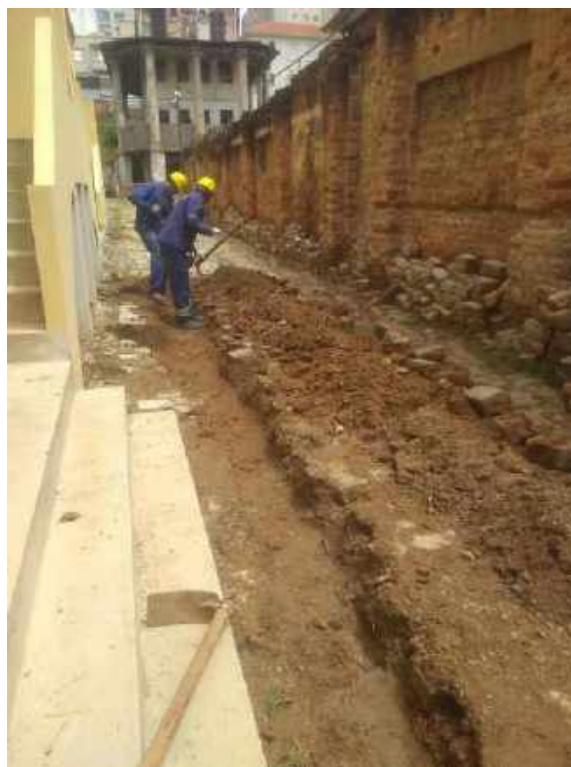
Foto 13 – Escavação manual para passagem das tubulações
