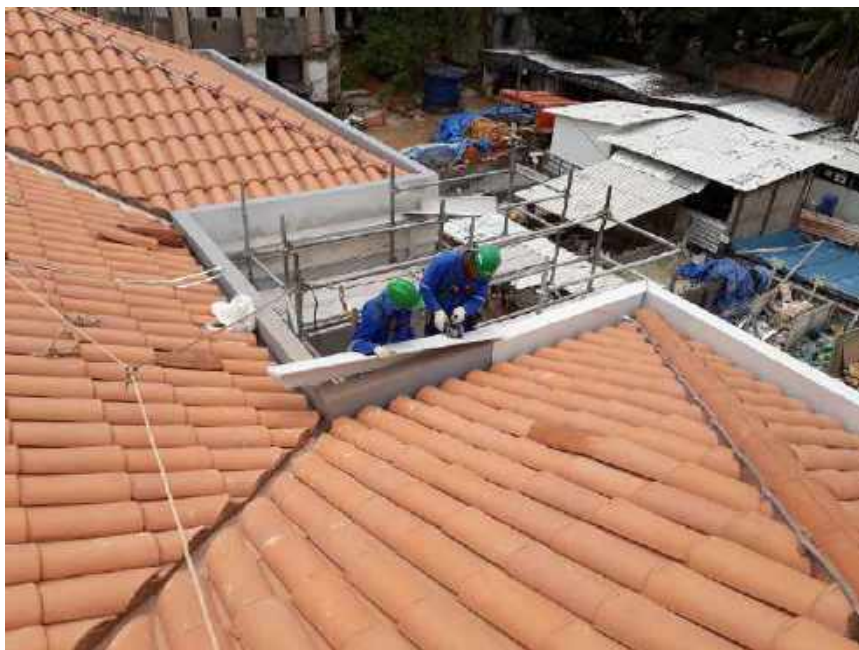
Foto 13 – Instalação dos rufos da cobertura – Casa 06
