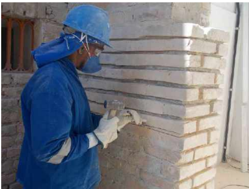
Foto 33 – Restauração dos tijolos – Casa 06
