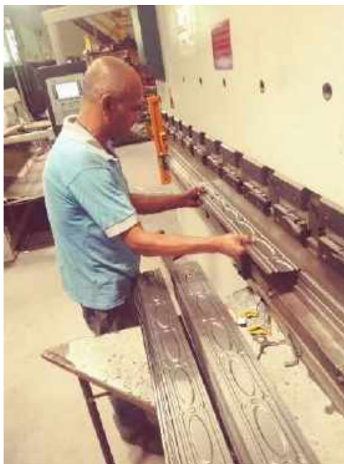
Foto 33 – Execução do forro metálico – Casa 06
