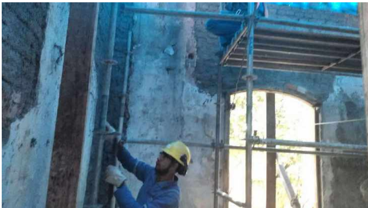
Foto 57: Consolidação das alvenarias.
