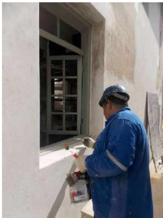
Foto 05 – Pintura lisa das esquadrias de madeira – Casa 05
