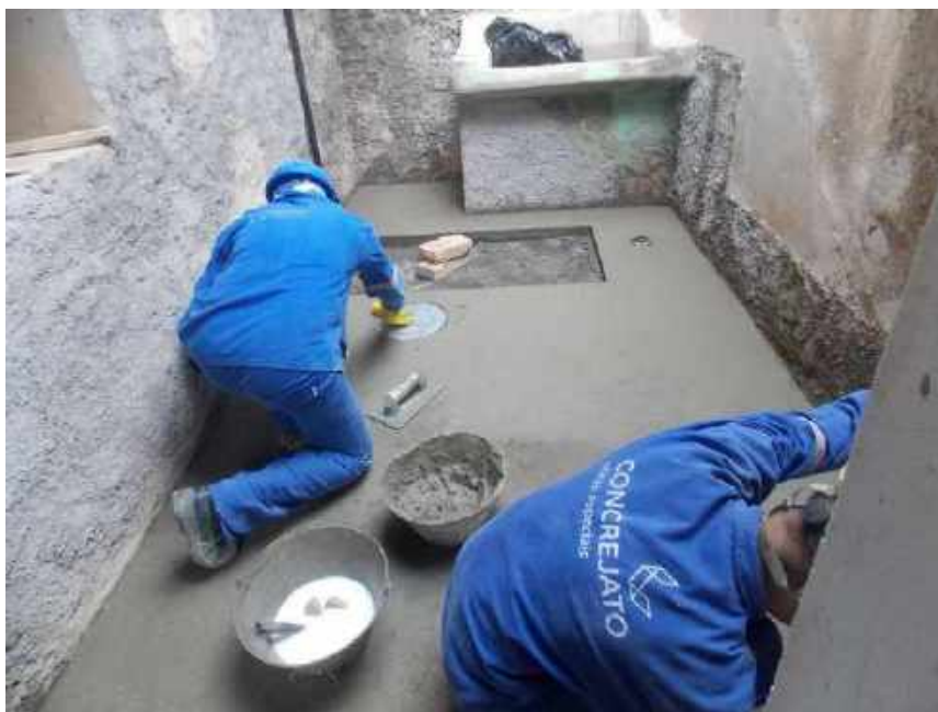
Foto 07 - Execução do piso cimentado – Casa 05
