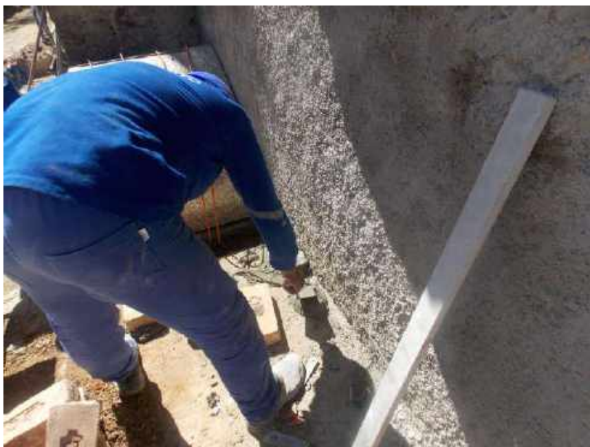
Foto 10 – Execução da alvenaria da escada – Casa 06
