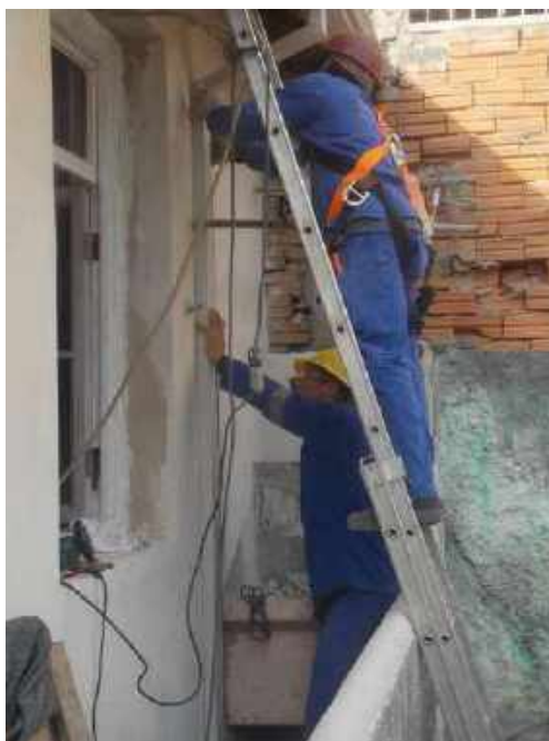
Foto 06 – Instalação das descidas de água na fachada lateral – Casa 05
