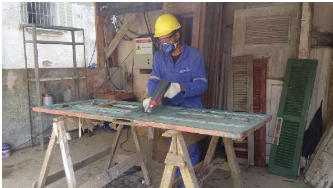
Foto 25 – Decapagem mecânica das portas e janelas de madeira – Casa 06
