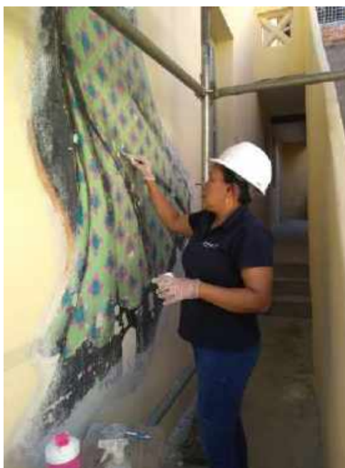
Foto 04 – Recuperação do grafite na fachada lateral – Casa 05
