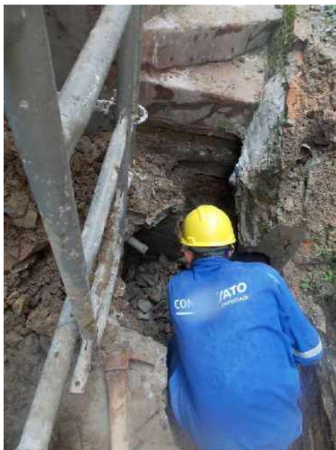
Foto 29 – Escavação manual dos fundos – Casa 06
