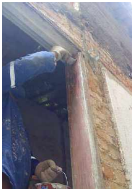
Foto 24 – Decapagem química dos batentes
