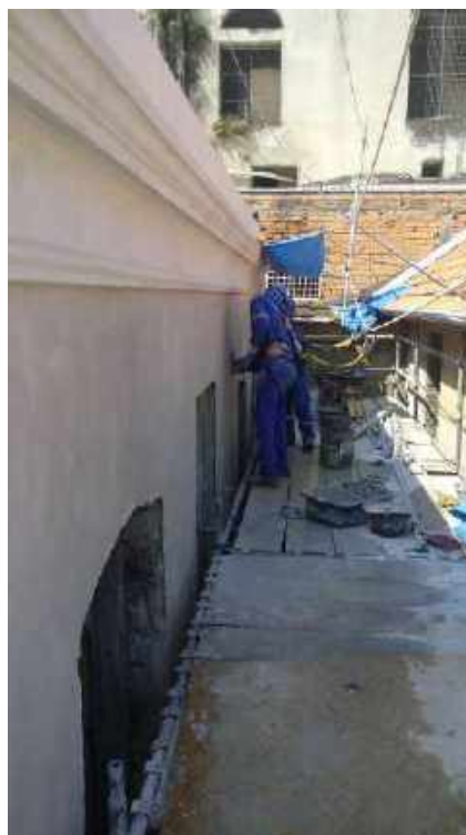
Foto 33 – Execução do Acabamento da Argamassa da fachada – Casa 06
