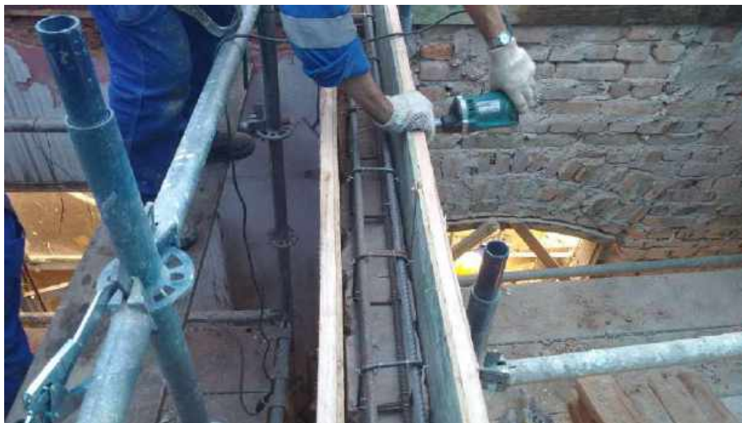
Foto 05: Fôrma e armação para cinta de concreto – Casa 6
