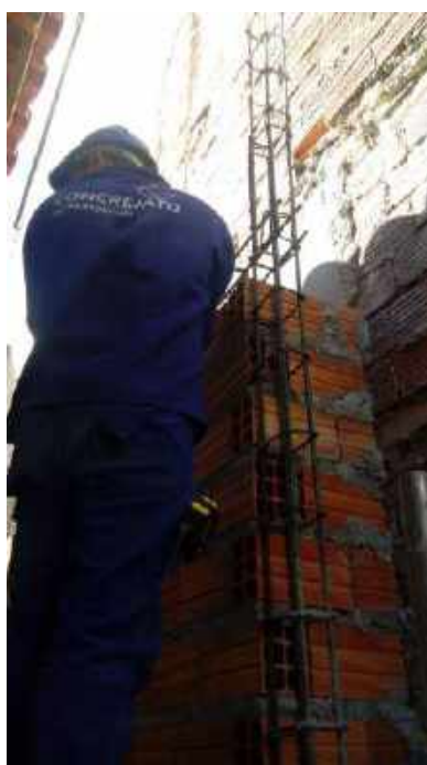
Foto 14 – execução da alvenaria ( Instalação das ferragens) Casa 06
