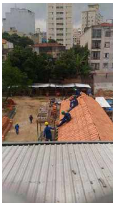
Foto 08: Instalação das telhas da Casa 5.
