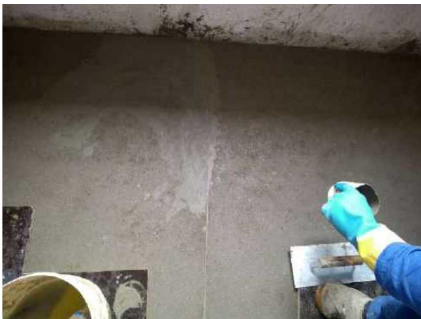
Foto 58 – Execução do piso cimentado pigmentado – Casa 06
