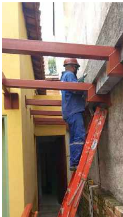
Foto 07 – Instalação do rufo – Casa 06
