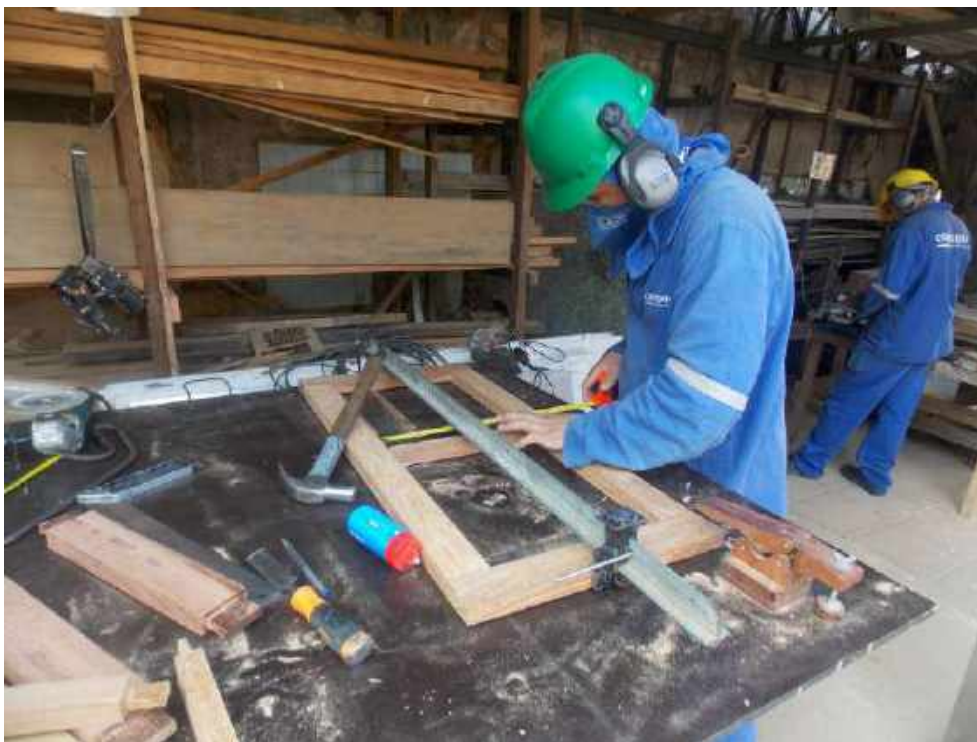
Foto 25 – Execução das esquadrias de Madeira – Casa 06
