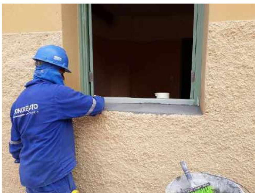
Foto 22 - Execução da argamassa de acabamento do beiral das janelas – Casa 06
