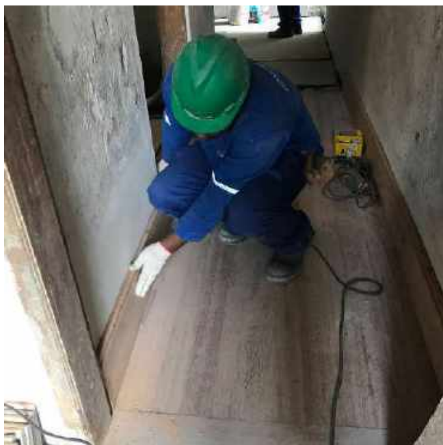
Foto 25 – Instalação do rodapé de madeira – Casa 06
