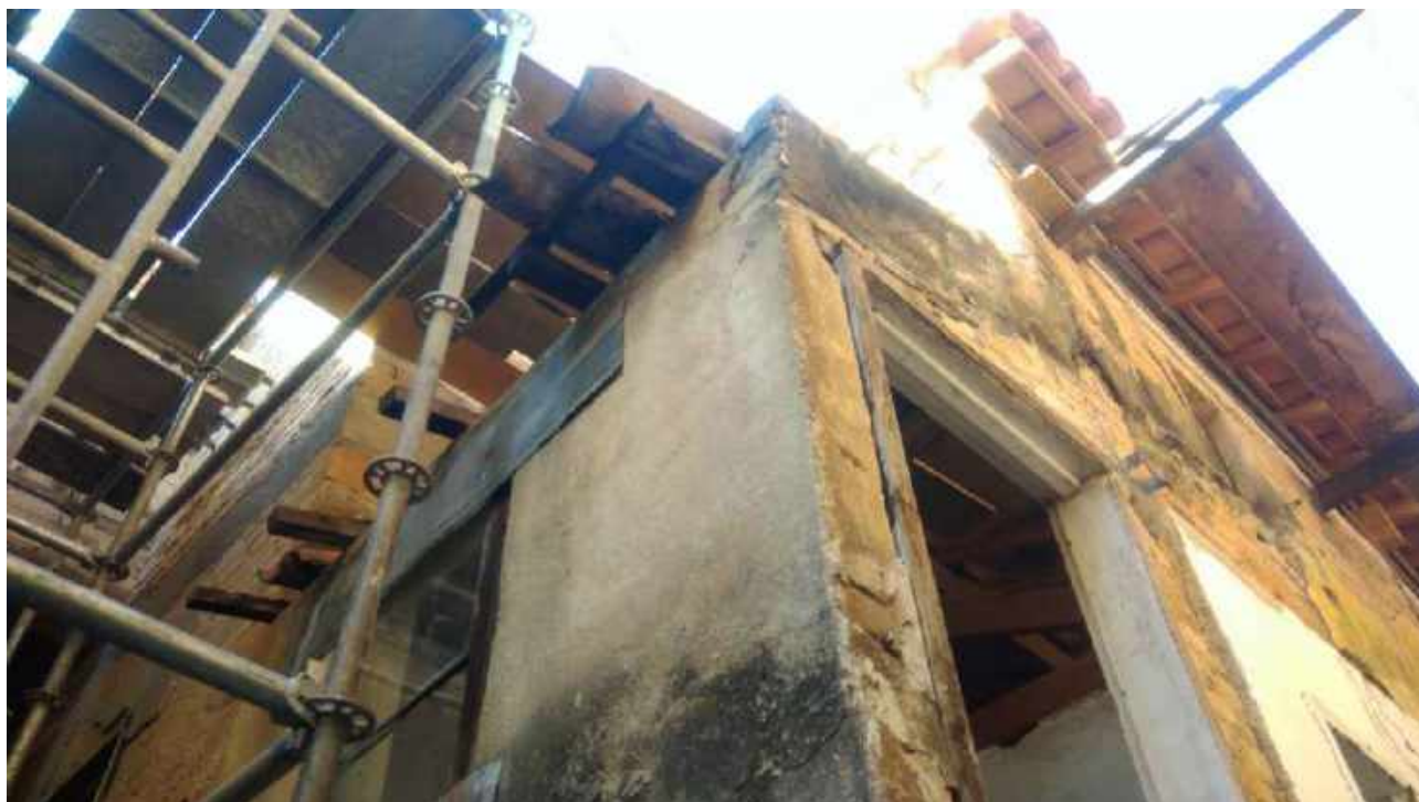
Foto 07: Vista geral da fachada dos fundos;
