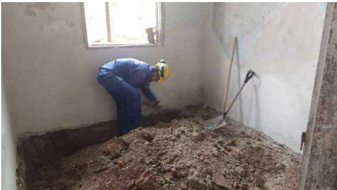
Foto 11 - Escavação manual para cristalização e Impermeabilização da alvenaria – Casa 06
