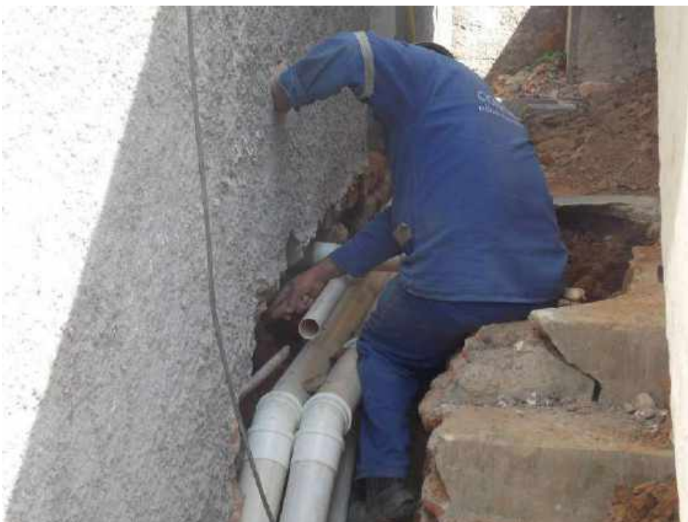
Foto 20 – Instalação das tubulações novas – Casa 05
