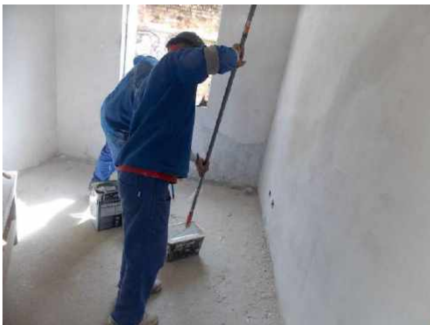
Foto 51- Aplicação de seladora nas paredes internas – Casa 06
