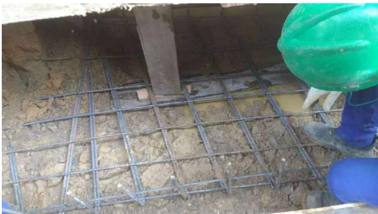
Foto 26: Execução do bloco de fundação.
