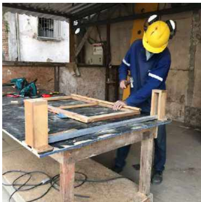
Foto 28 – Execução da esquadria de madeira – Casa 06
