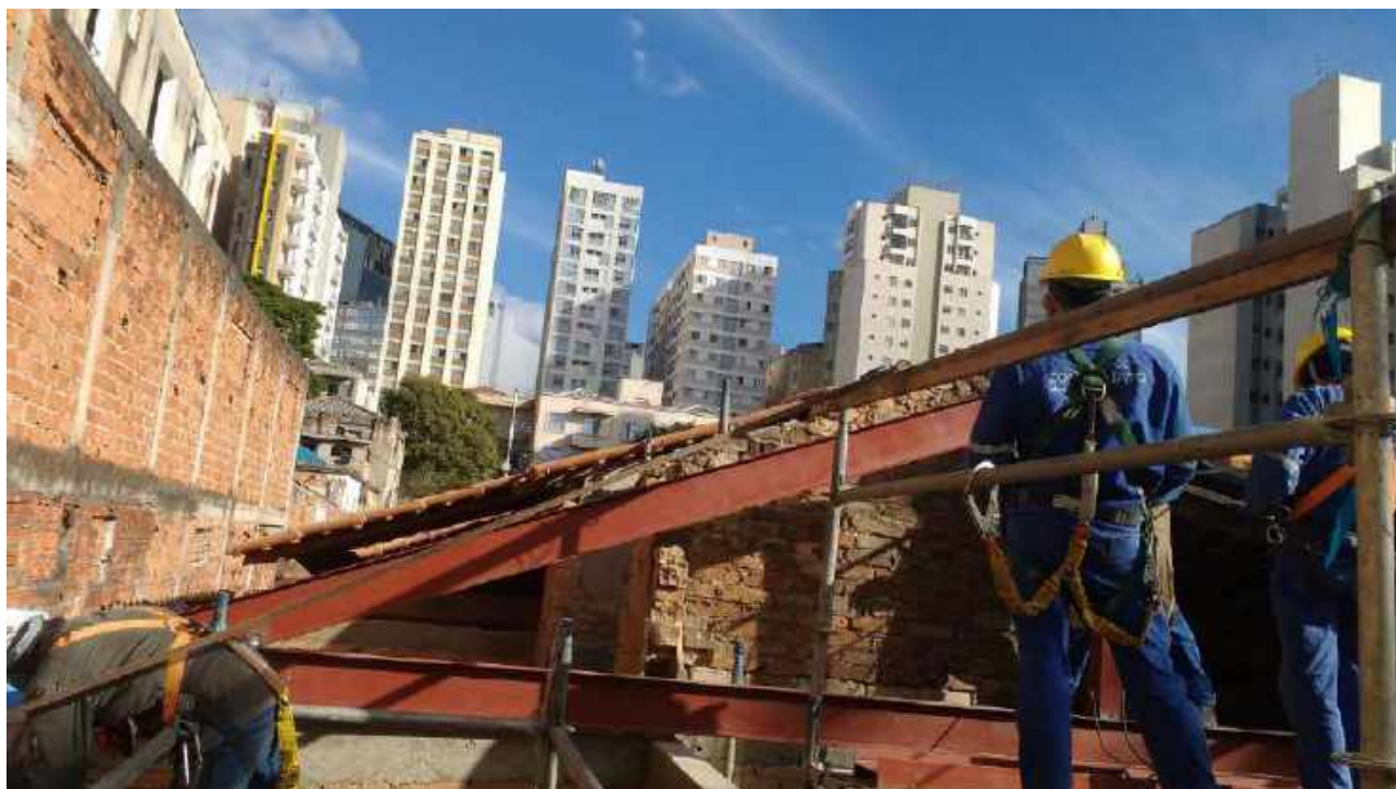
Foto 69: Execução da estrutura metálica da Casa 6
