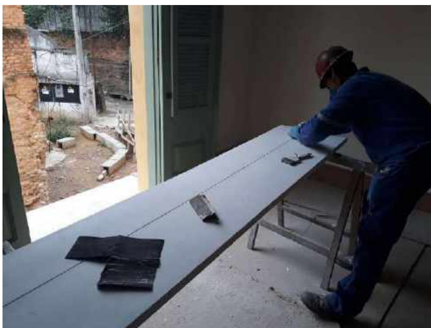
Foto 08 – Lixamento das portas de madeira – Casa 06
