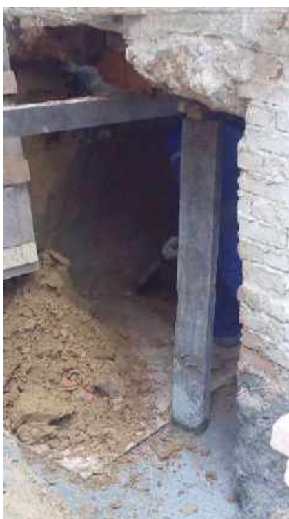
Foto 26 – Escavação manual – Casa 06
