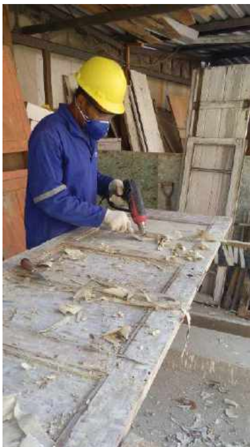
Foto 03 – Decapagem das portas – Casa 06
