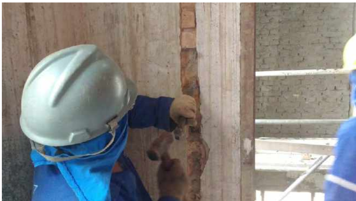
Foto 49 – Abertura para passagens das tubulações
