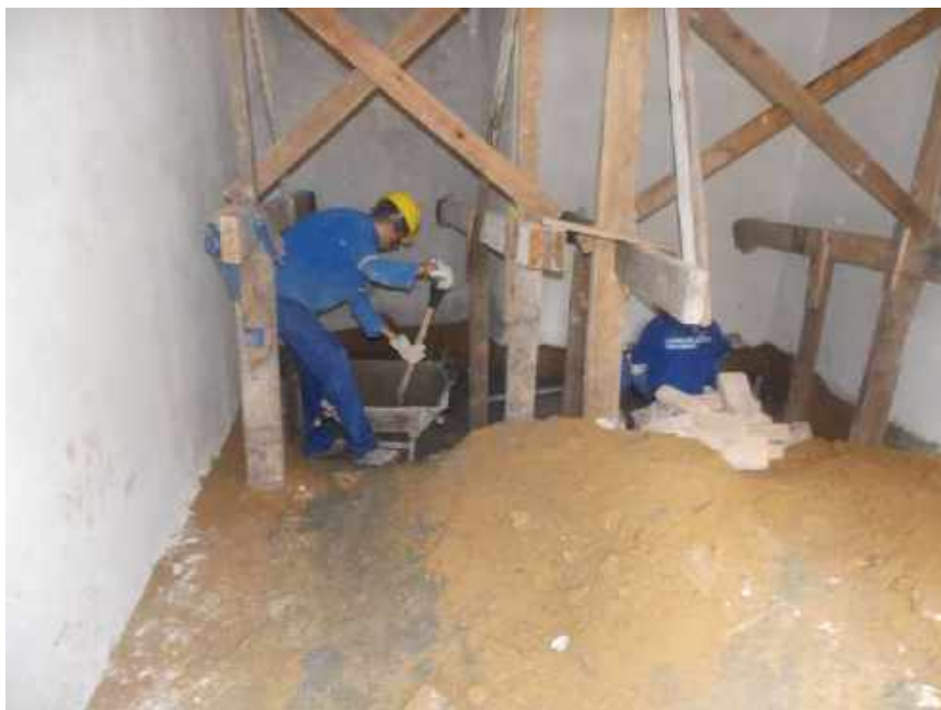
Foto 43 – Concretagem dos reforços da alvenaria – Casa 06
