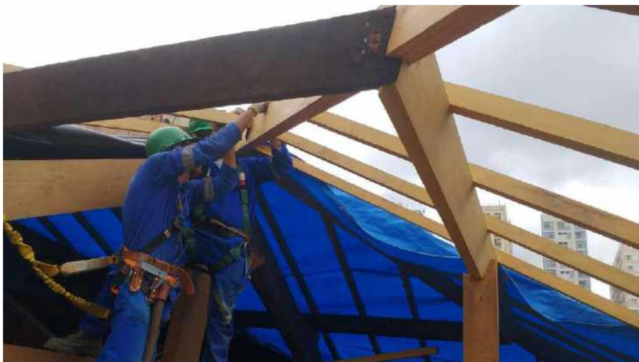
Foto 34: Substituição das peças danificadas da tesoura da Casa 6.
