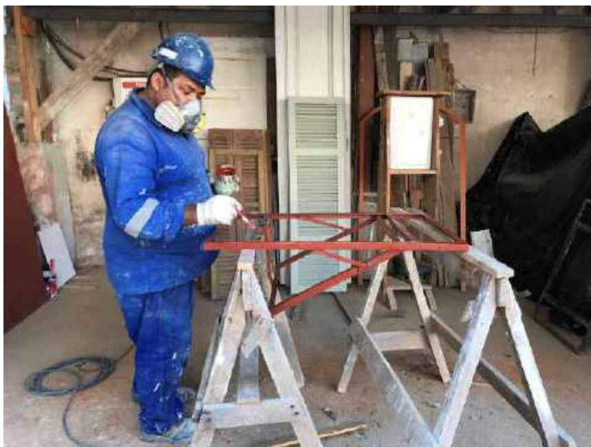
Foto 17 – Pintura lisa da esquadria metálica – Casa 05
