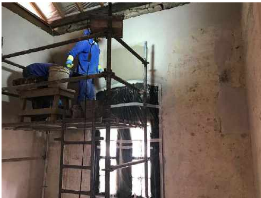
Foto 31 –Fechamento das imperfeições das paredes internas – Casa 06
