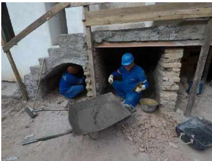
Foto 31 – Execução do emboço na alvenaria existente – Casa 06
