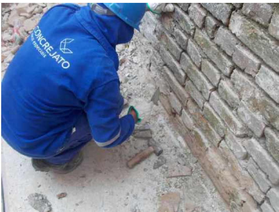
Foto 54 – Remoção da argamassa existente da fachada dos fundos - Casa 06
