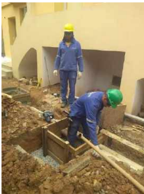
Foto 08 – Execução das caixas de passagens
