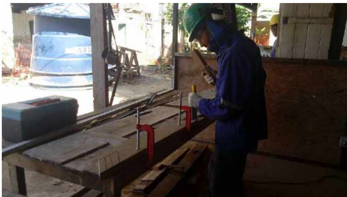
Foto 8 – Restauração das portas de madeira – Casa 06
