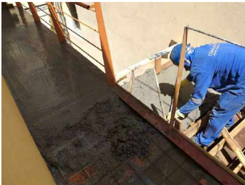
Foto 09 - Concretagem da passarela de acesso da escada lateral
