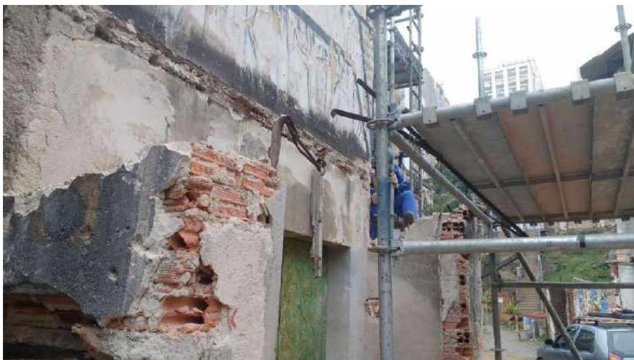
Foto 26: Demolições das alvenarias - Casa 05.
