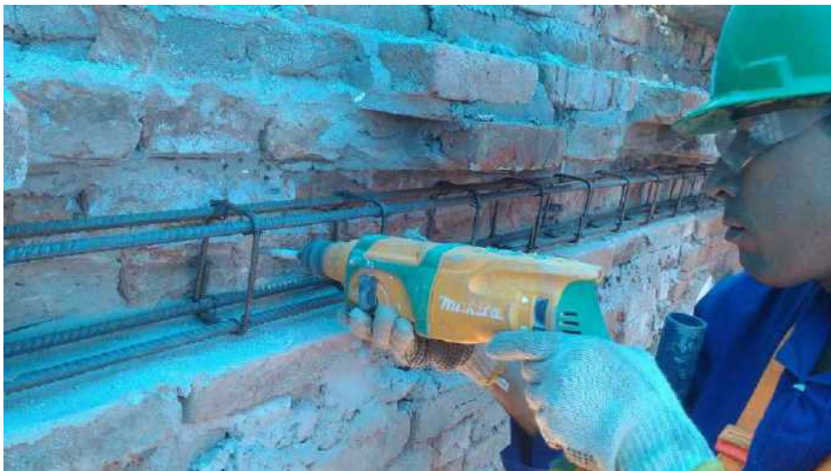
Foto 09: Fixação da armação para verga de concreto.
