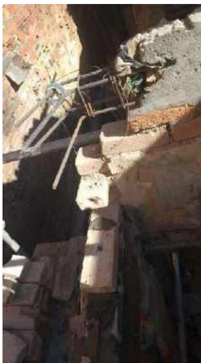
Foto 56: Concretagem da cinta da Casa 6.
