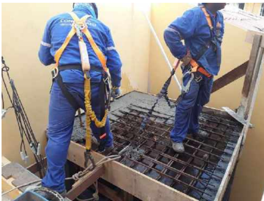
Foto 42 - Concretagem da cobertura do elevador – Casa 06
