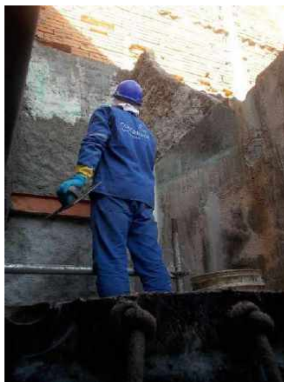
Foto 14 – Execução do emboço da fachada lateral – Casa 05
