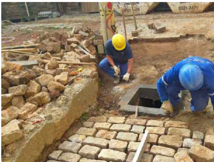
Foto 13 – Regularização do paralelepípedo no nível da rua
