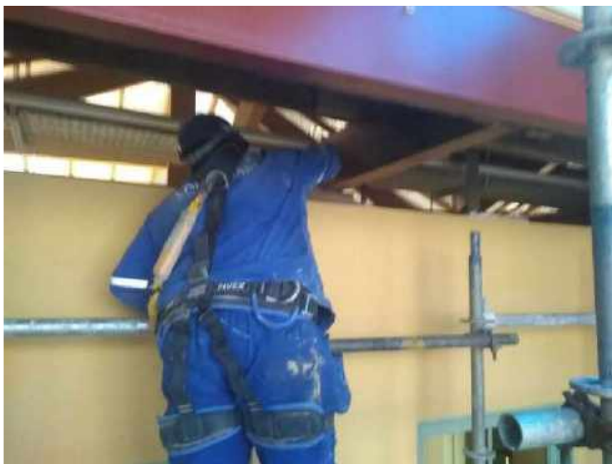
Foto 15 – Aplicação de cera nas madeiras – Casa 06
