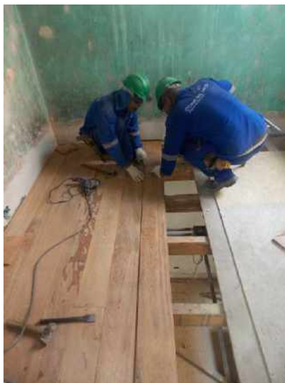
Foto 20 – Instalação dos assoalhos de madeira – Casa 06
