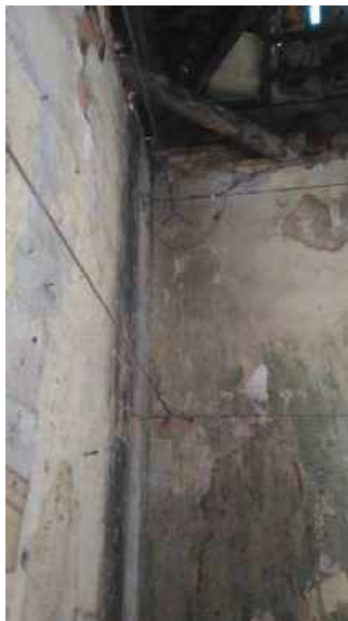
Foto 03: Escoramento com cabo de aço - Casa 6.
