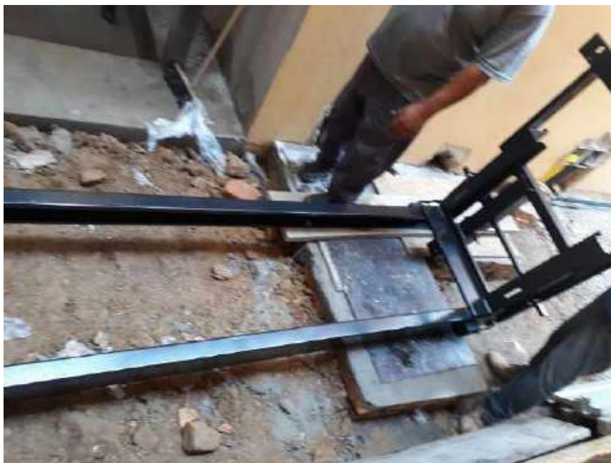
Foto 44 - Montagem da plataforma elevatória
