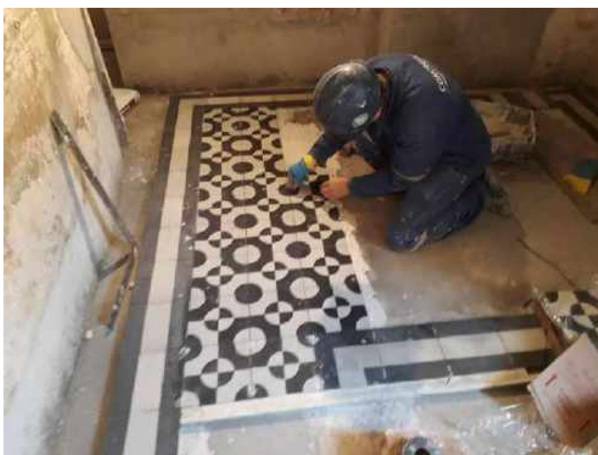
Foto 15 – Instalação dos ladrilhos hidráulicos – Casa 06
