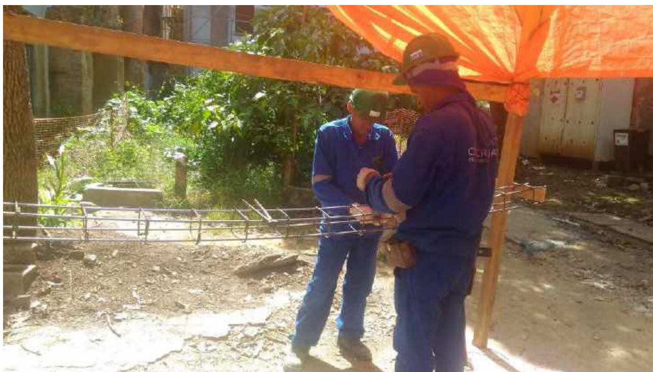
Foto 18: Dobra da armação das estruturas em concreto.
