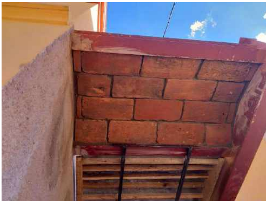
Foto 05- Reprodução da abobadilha da escada da fachada lateral
