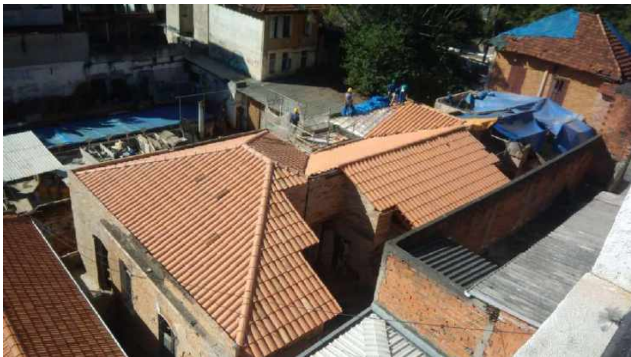
Foto 83: Instalação das telhas capa canal - Casa 06
