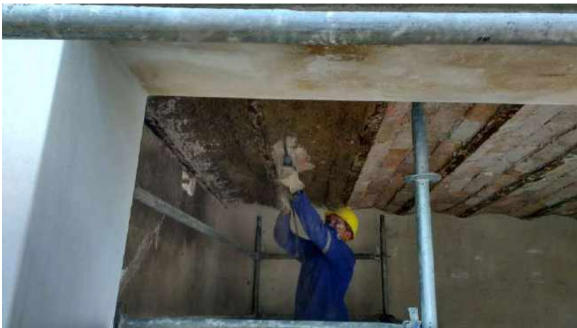
Foto 11 – Remoção do chapisco – Casa 05
