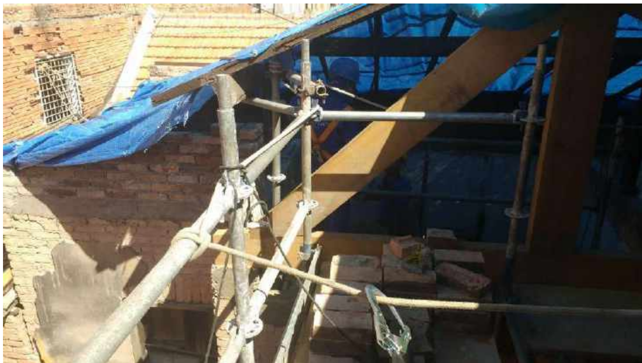
Foto 09: Substituição das peças danificadas da tesoura da Casa 6.
