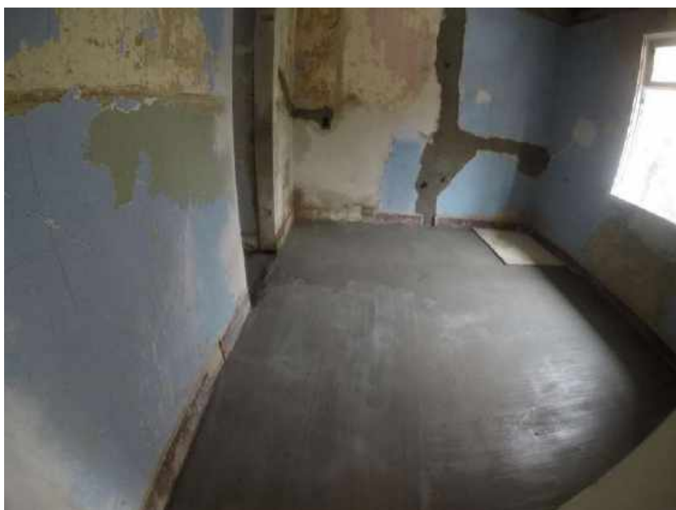
Foto 01 – Instalação dos ladrilhos hidráulicos – Casa 05
