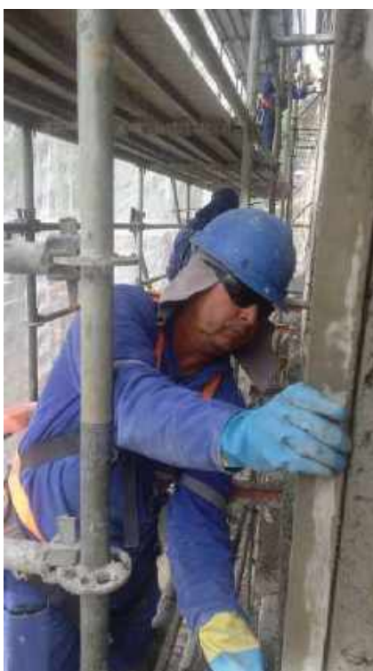
Foto 10 – Execução do emboço da fachada – Casa 06
