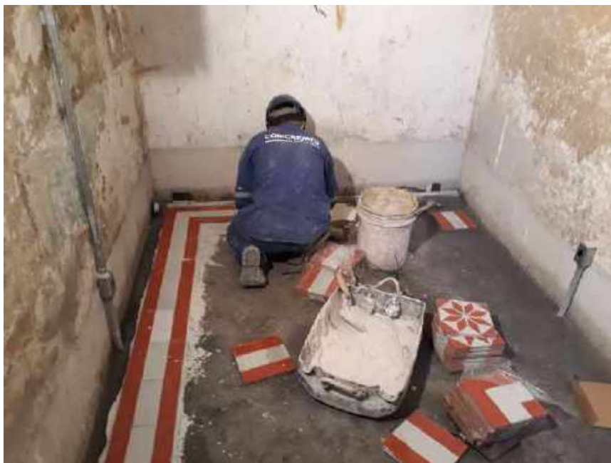
Foto 16 – Instalação dos ladrilhos hidráulicos – Casa 06
