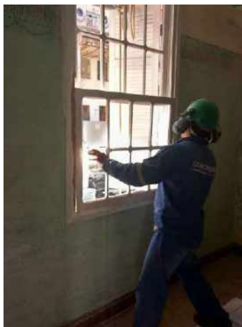
Foto 14 – Instalação das esquadrias de madeira – Casa 05
