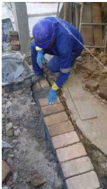
Foto 11 – Execução da alvenaria – Casa 06
