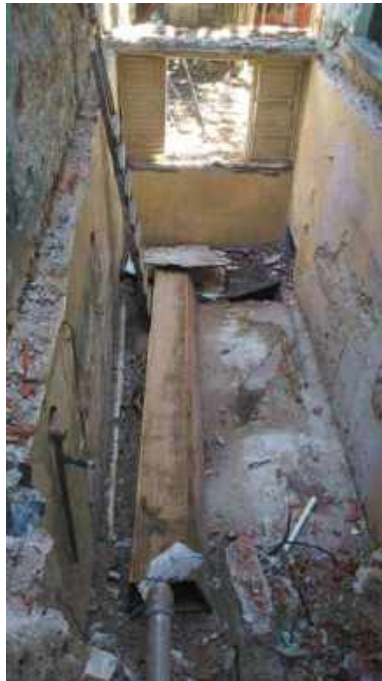
Foto 01: Demolição do anexo entre as casas 6 e 7.
