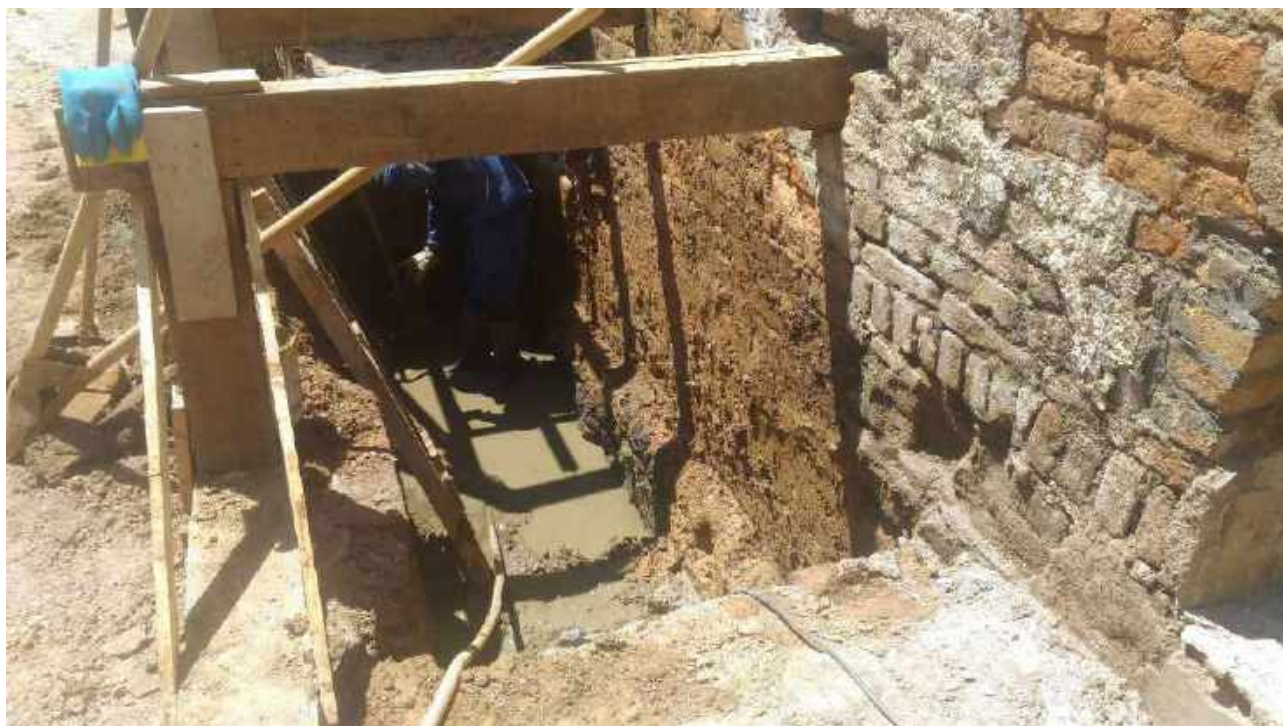
Foto 12: Compactação do solo.
