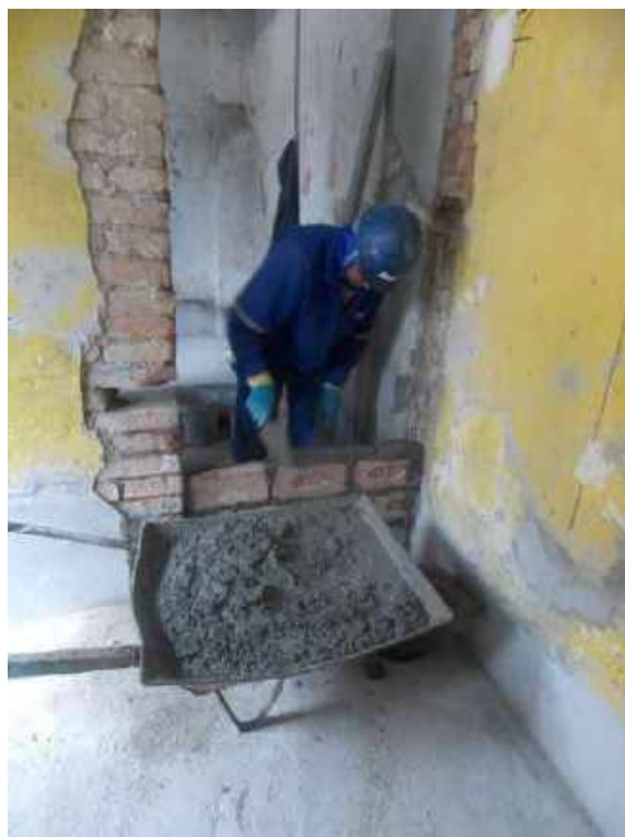
Foto 31 – Elevação da alvenaria – Casa 06
