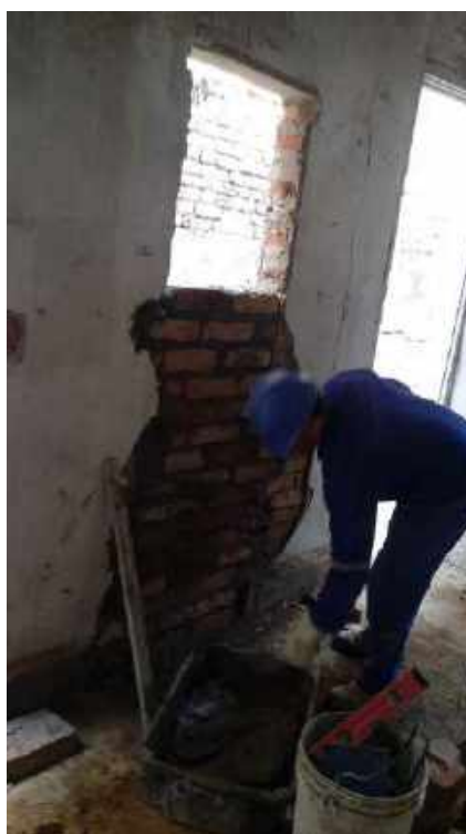
Foto 04 – Recuperação da alvenaria da Casa 06
