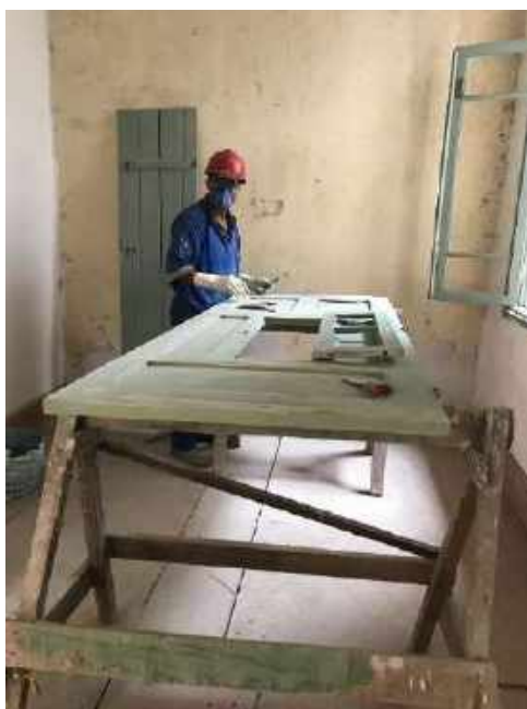
Foto 10 – Aplicação de massa para madeira nas portas de madeira – Casa 06
