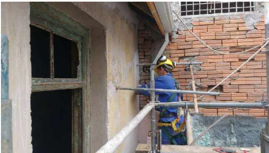
Foto 15 – Decapagem das tintas existentes – Casa 05
