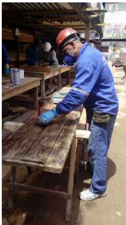
Foto 29 - Restauração das portas de madeira com aplicação de resina - Casa 06
