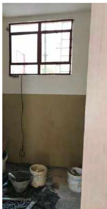
Foto 36 – Pintura lisa das paredes internas – Casa 06
