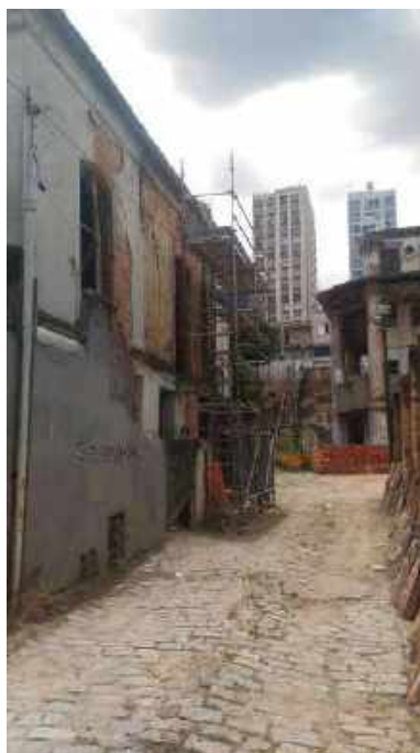
Foto 09: Desmontagem cuidadosa da alvenaria com reaproveitamento de tijolos – Casa 6..
