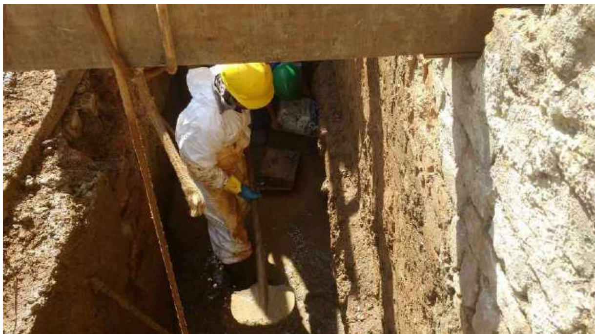
Foto 01: Escavação para fundação da Casa 6.
