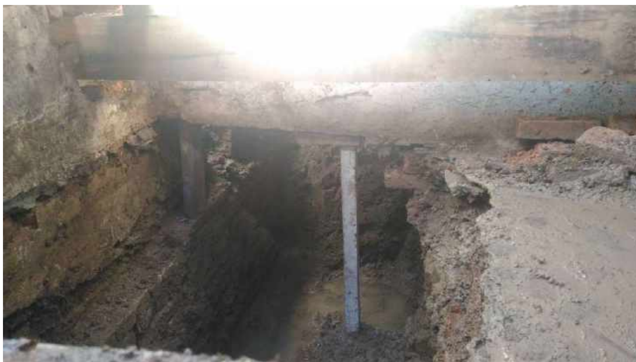
Foto 10: Escoramentos para execução dos blocos.
