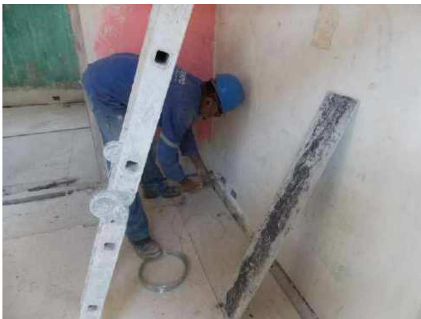
Foto 22 – Instalação dos cabos elétricos – Casa 06
