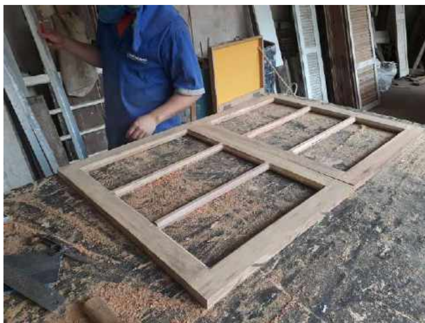
Foto 13 – Execução da esquadria de madeira – Casa 06
