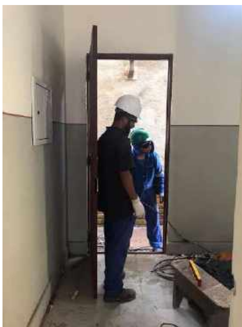
Foto 13 – Instalação da porta metálica
