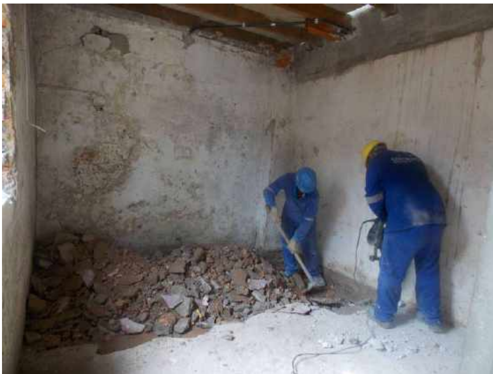
Foto 27 – Demolição mecânica do piso existente – Casa 06
