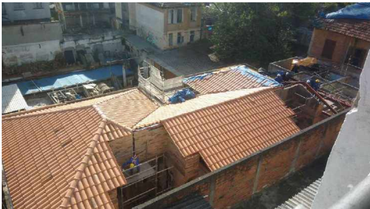
Foto 18: Instalação das tesouras metálicas;
