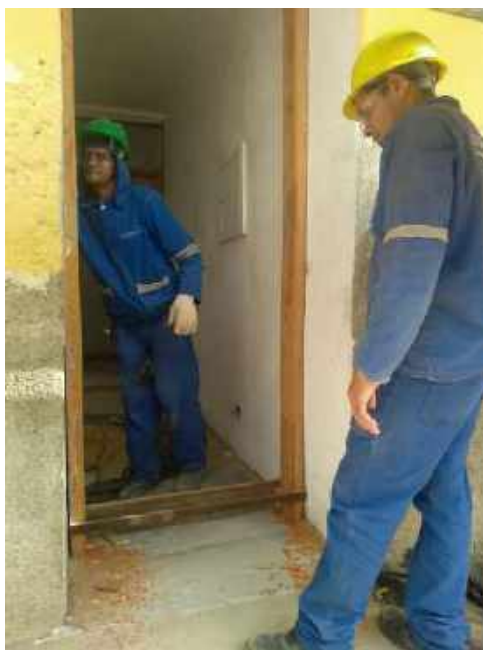
Foto 29 – Instalação dos batentes de madeira – Casa 06
