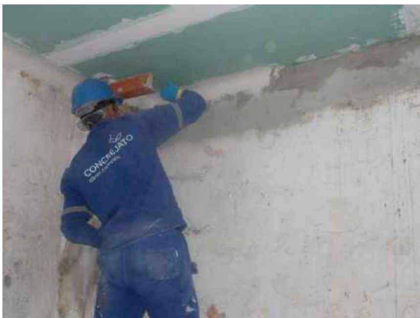
Foto 50 – Execução do acabamento do forro – Casa 06
