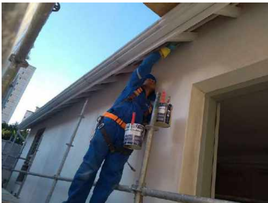
Foto 01 – Pintura lisa das calhas – Casa 05
