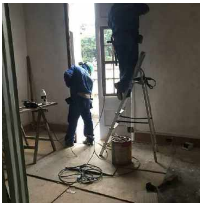
Foto 23 – Instalação das portas de madeira – Casa 06
