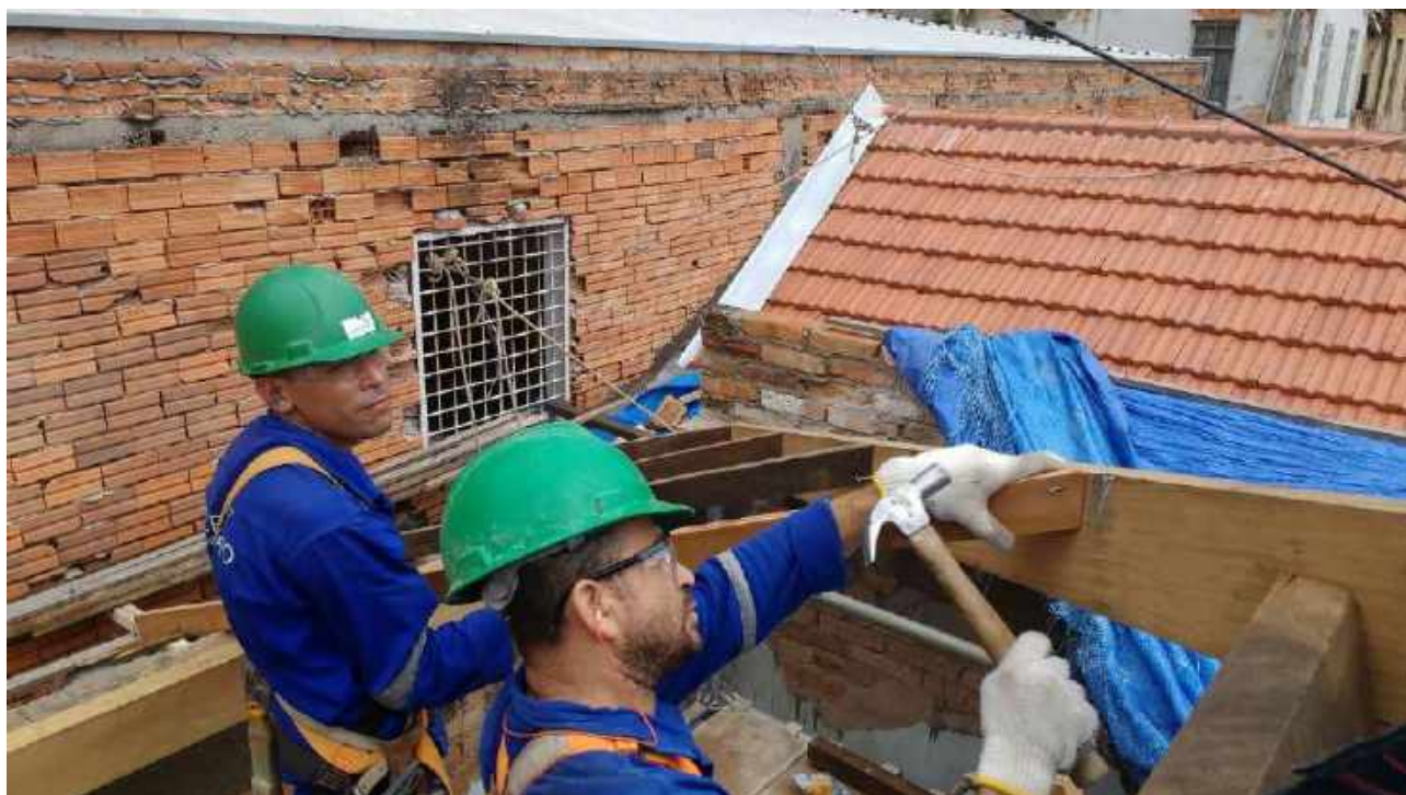
Foto 19: Instalação das terças.
