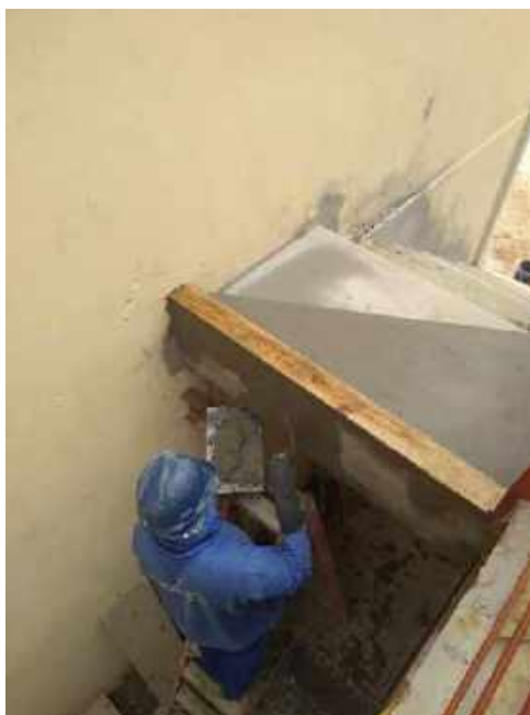
Foto 16- Execução da argamassa de acabamento da escada
