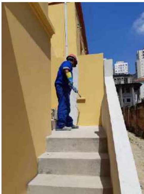
Foto 03 – Pintura com tinta mineral do guarda corpo lateral – Casa 06
