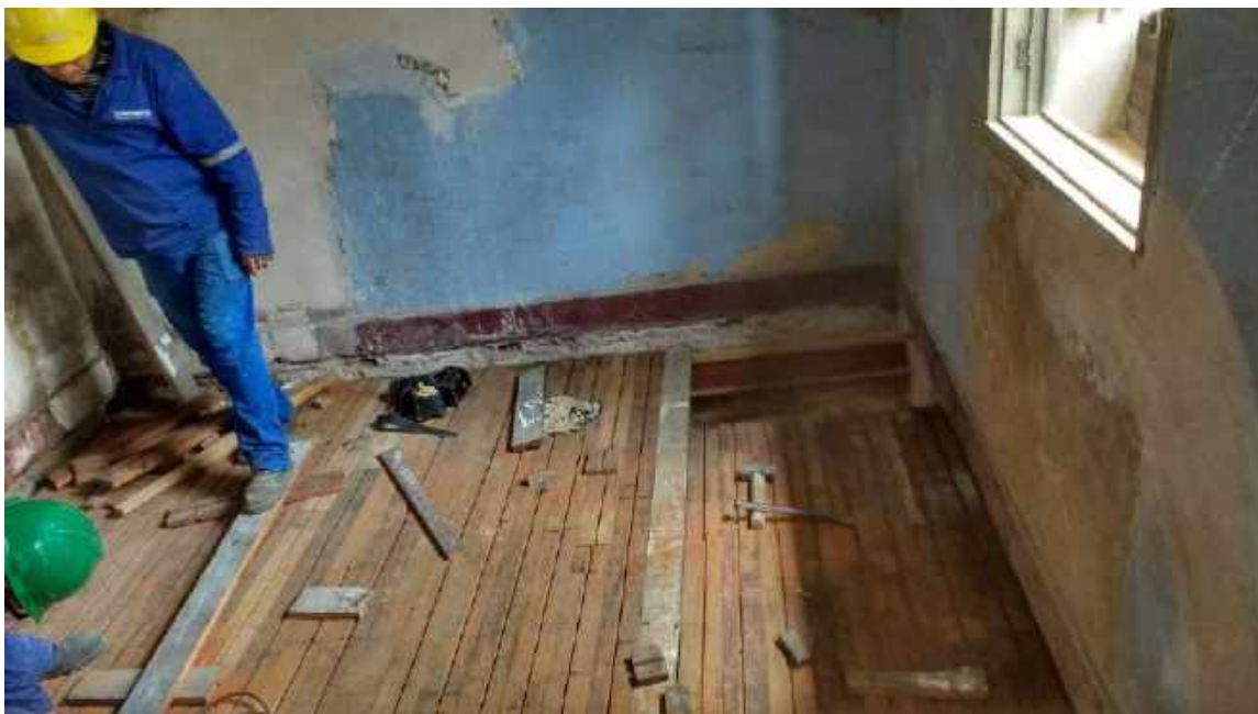
Foto 05 – Instalação dos assoalhos de madeira – Casa 05
