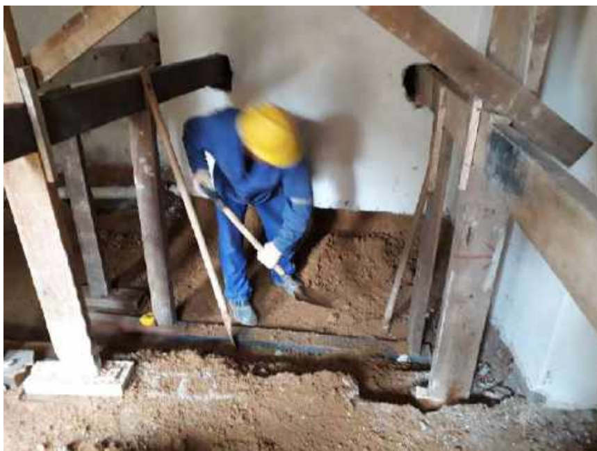
Foto 41 – Escavação manual para reforço da alvenaria – Casa 06
