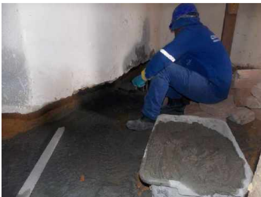
Foto 44 – Recuperação da alvenaria após reforço estrutural – Casa 06
