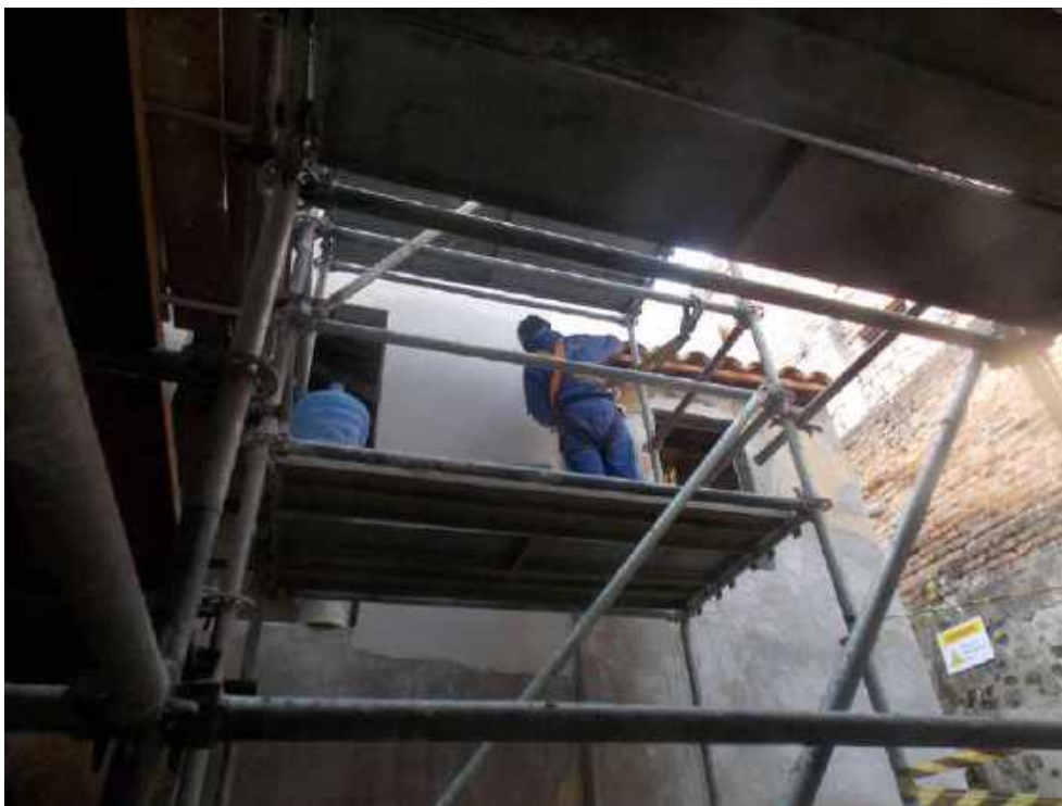
Foto 37 – Execução da argamassa de acabamento da fachada dos fundos – Casa 06
