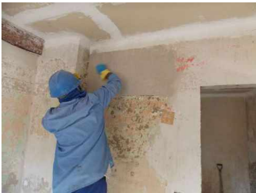
Foto 36 – Execução da argamassa de acabamento das paredes internas – Casa 06
