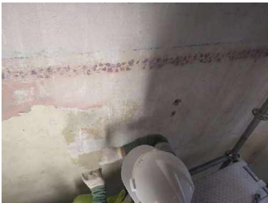
Foto 05- Decapagem manual cuidadosa das paredes internas – Casa 06
