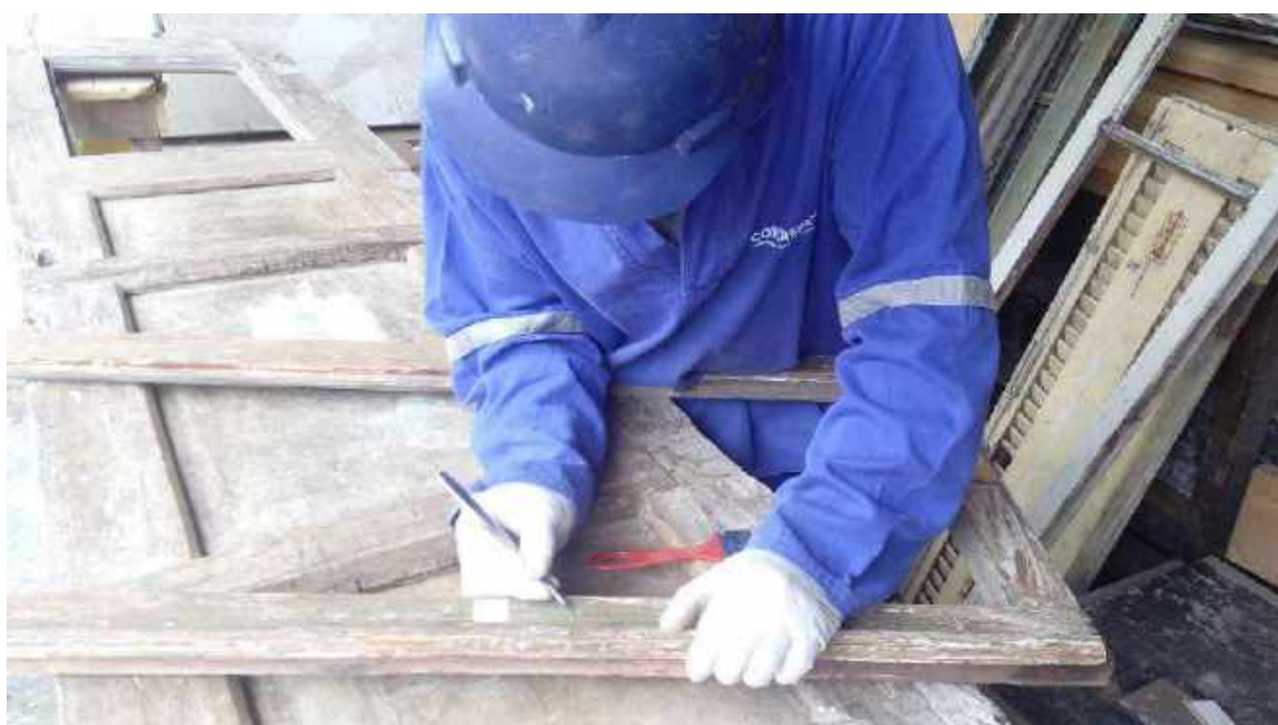
Foto 26 - Decapagem mecânica das portas e janelas de madeira – Casa 06
