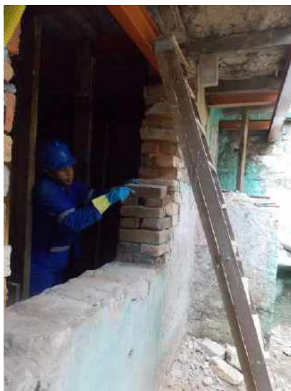
Foto 05 – Recuperação da alvenaria – Casa 05
