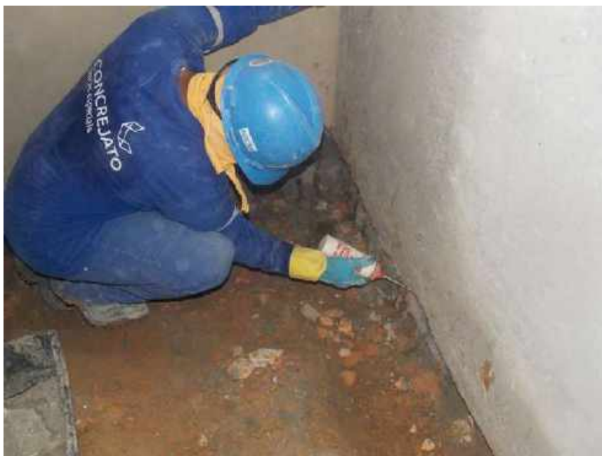
Foto 31 –Cristalização e impermeabilização dos baldrame – Casa 06
