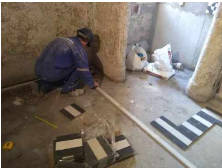
Foto 14 – Instalação do ladrilho hidráulico – Casa 06
