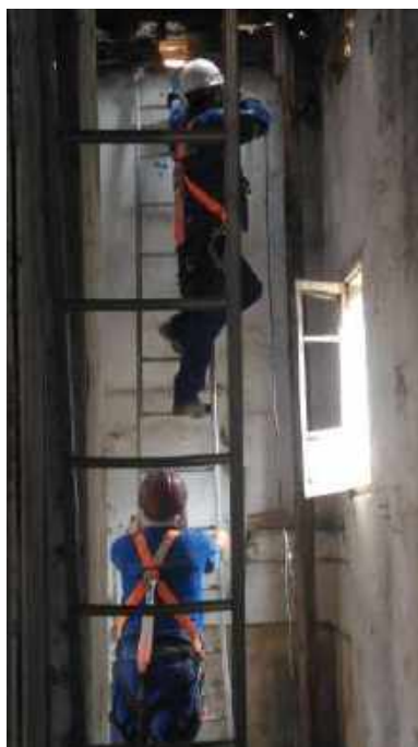
Foto 01: Escoramento com cabo de aço - Casa 6.
