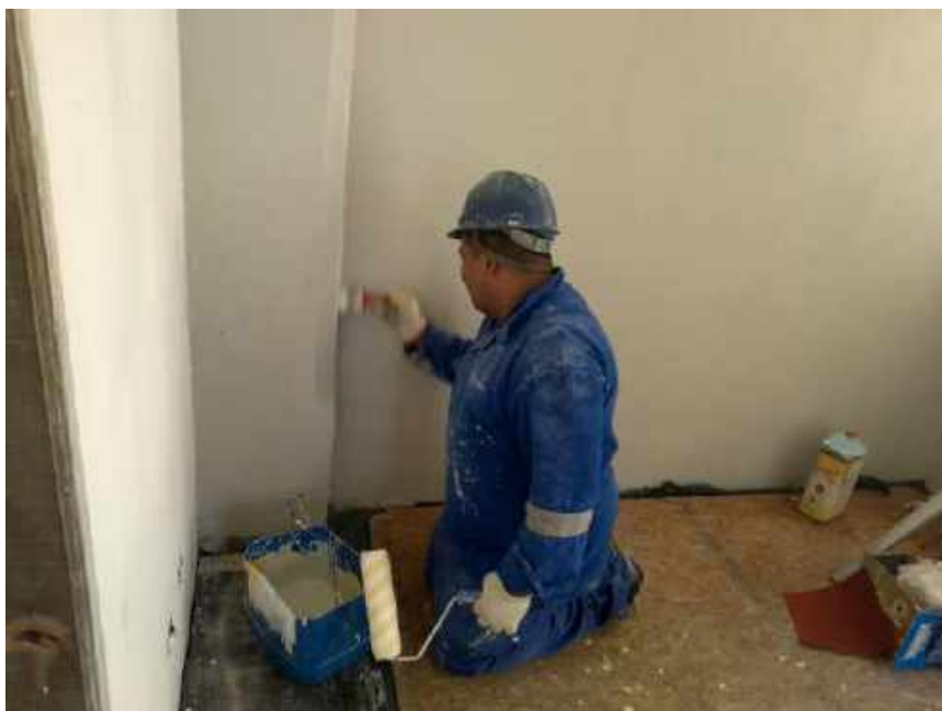
Foto 39 – Pintura lisa das paredes internas – Casa 06
