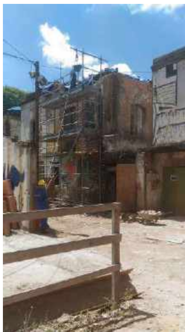
Foto 11: Desmontagem cuidadosa da alvenaria com reaproveitamento de tijolos – Casa 6.
