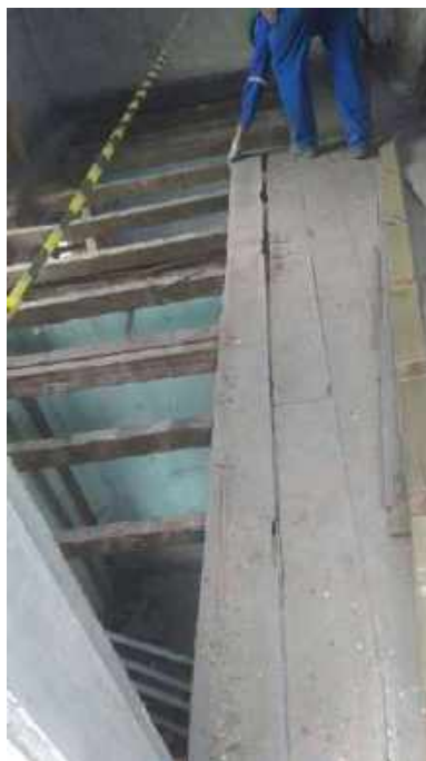
Foto 21: Remoção dos pisos de madeira para execução de escoramento metálico.
