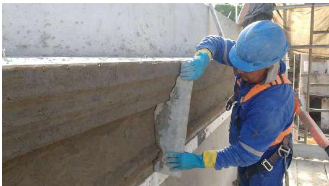
Foto 42 – Execução da argamassa de acabamento no topo da platibanda casa 06
