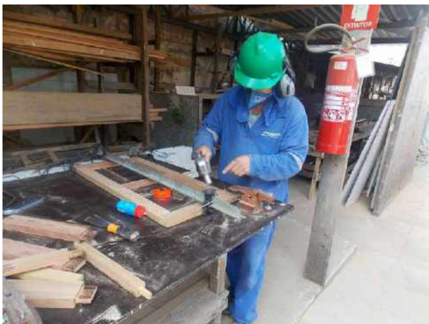
Foto 06 – Execução das esquadrias de madeira – Casa 05
