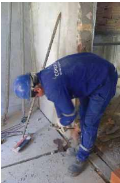
-Foto 30 – Regularização das paredes – Casa 06
