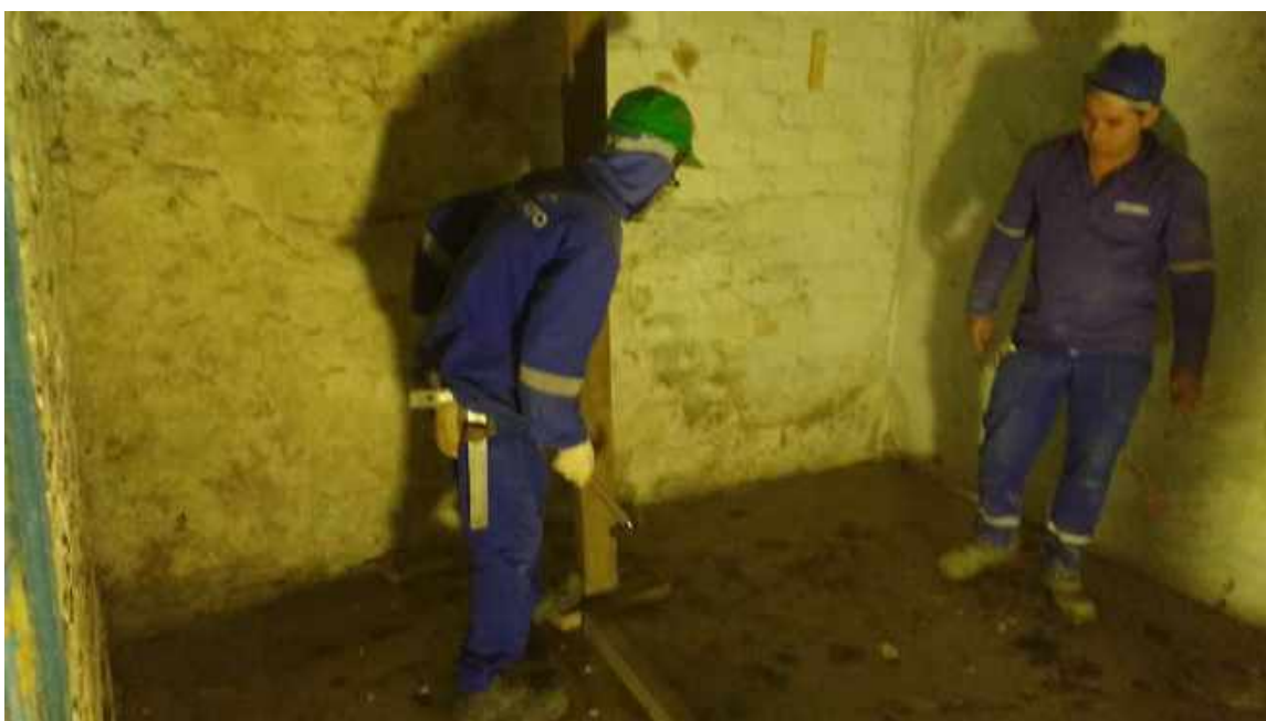
Foto 52 – Escoramento dos barrotes de madeira – Casa 05
