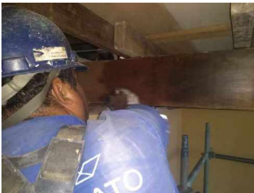
Foto 16 – Aplicação de cera nas madeiras – Casa 06
