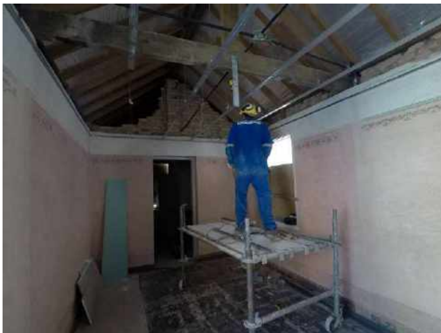
Foto 03 – Instalação do forro de drywall – Casa 05
