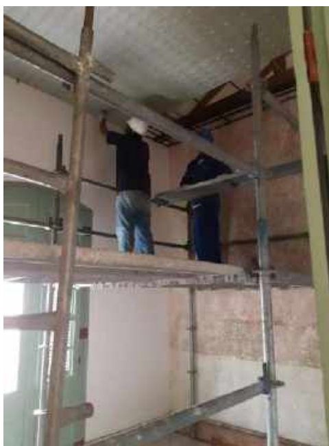
Foto 12 – Instalação do forro metálico na cobertura – Casa 06
