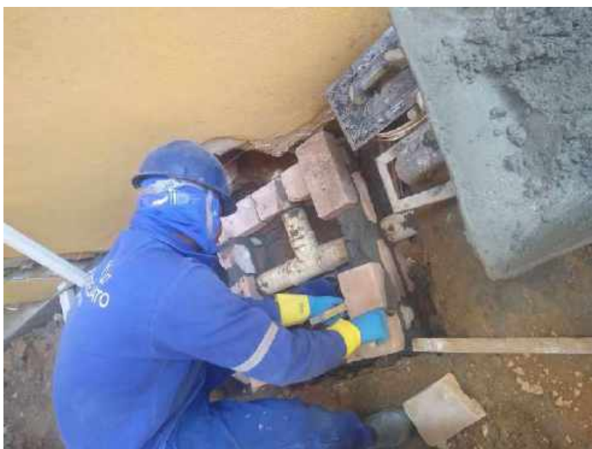
Foto 49 – Execução da caixa pluvial – Casa 06
