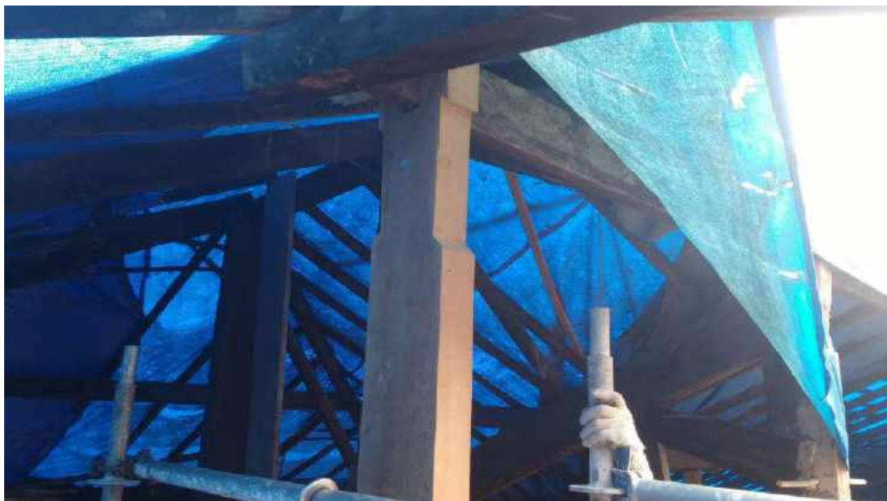
Foto 25: Substituição das peças danificadas da tesoura da Casa 6.
