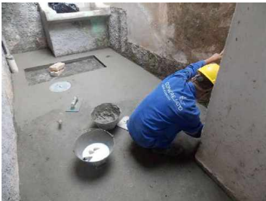
Foto 15 – Execução do piso cimentado – Casa 05
