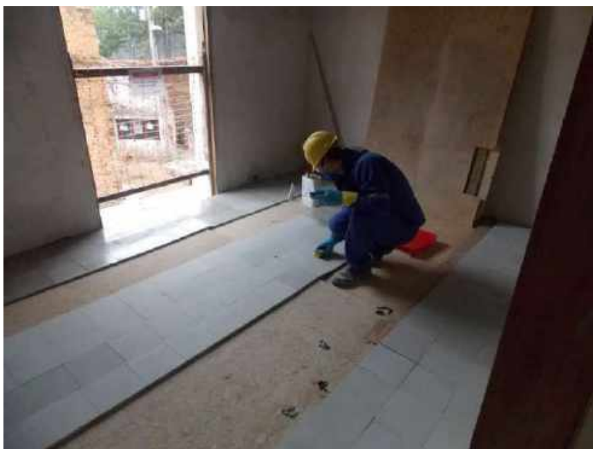
Foto 46 – Aplicação de Resina nos pisos – Casa 06
