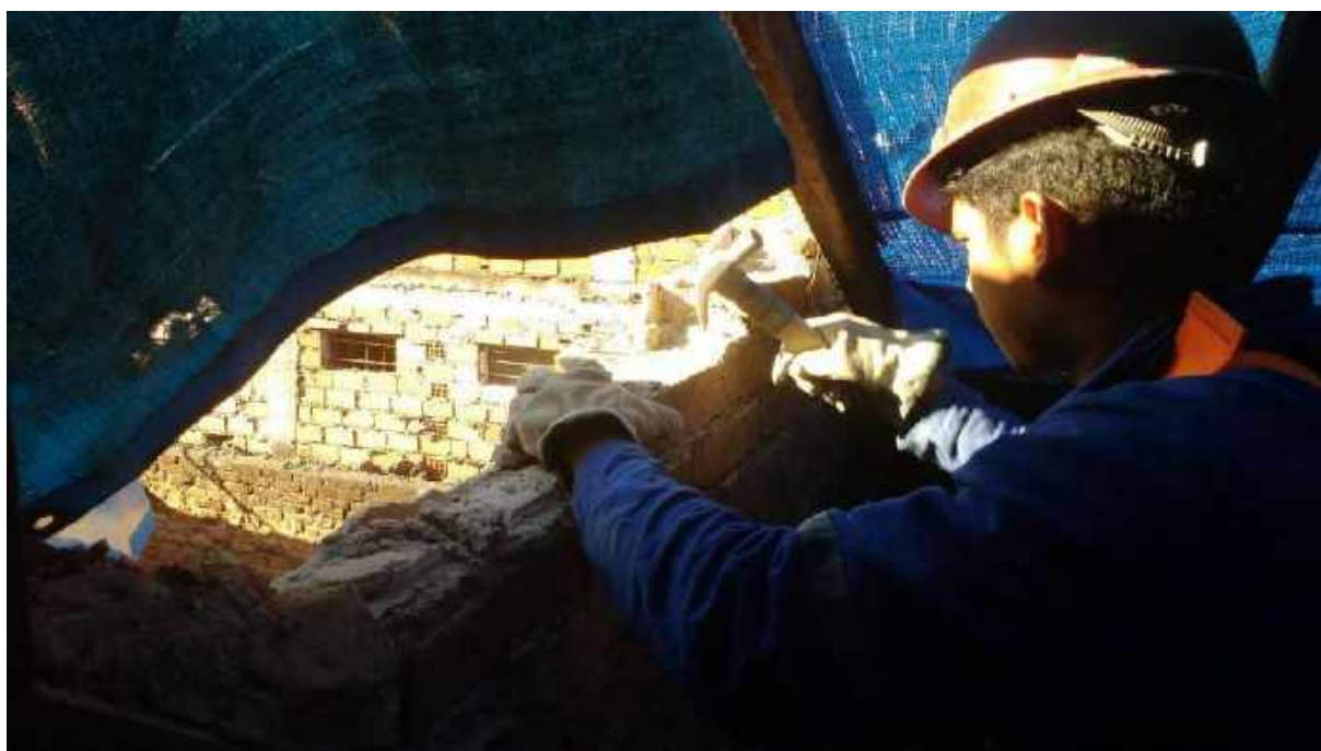
Foto 10: Remoção cuidadosa de alvenaria para execução de cinta de concreto.
