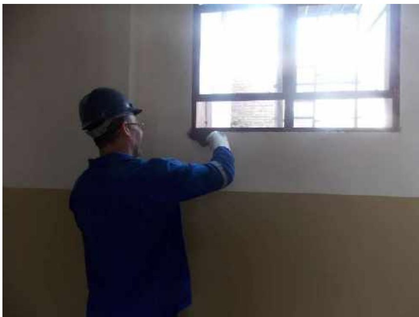
Foto 03 – Fechamentos dos vãos das janelas metálicas – Casa 06
