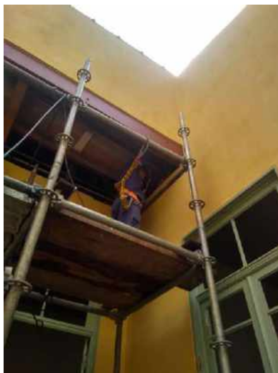
Foto 01 – Instalação da estrutura metálica para instalação do forro metálico área externa
