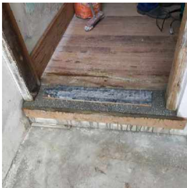
Foto 73 – Execução da soleira – Casa 06
