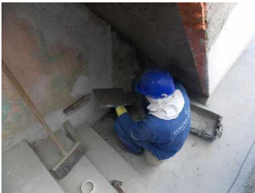
Foto 11 – Execução do emboço abaixo da escada – Casa 05
