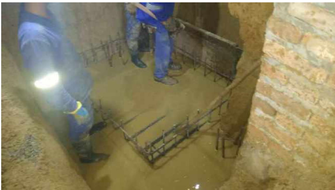
Foto 25 – Instalação da armação – Casa 06
