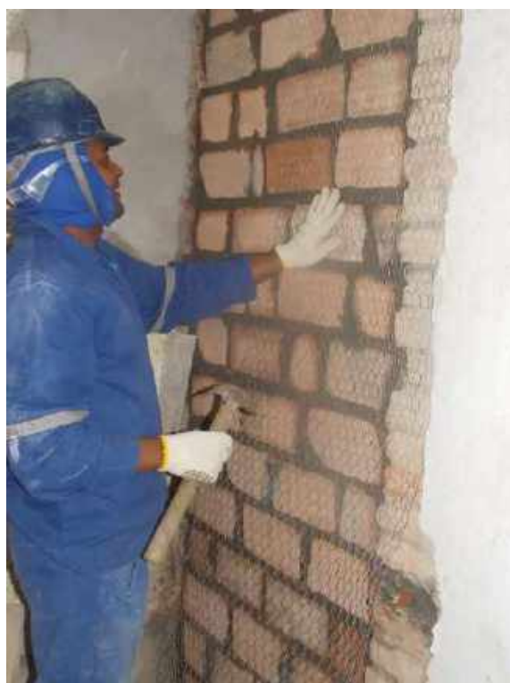
Foto 32 – Fechamento da alvenaria – Casa 06
