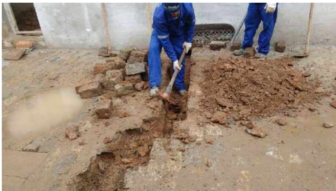
Foto 29 – Escavação manual para drenagem dos pisos – Casa 06
