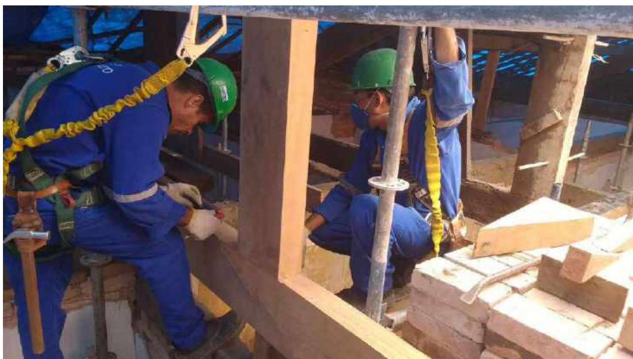
Foto 26: Substituição das peças danificadas da tesoura da Casa 6.
