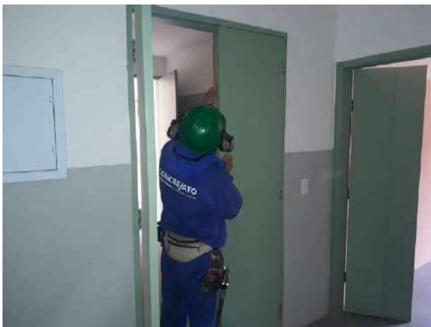
Foto 25 – Instalação das portas de madeira – Casa 06
