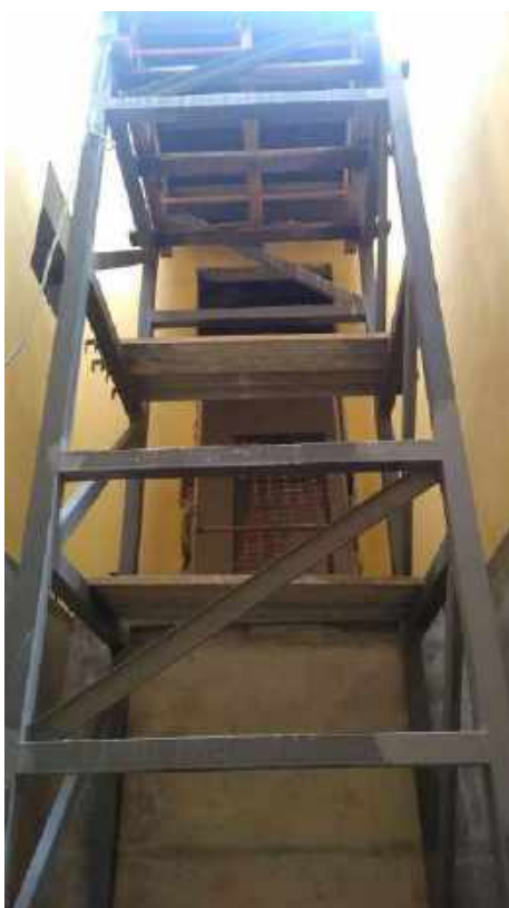
Foto 46 – Montagem da estrutura metálica da plataforma elevatória e execução da laje.
