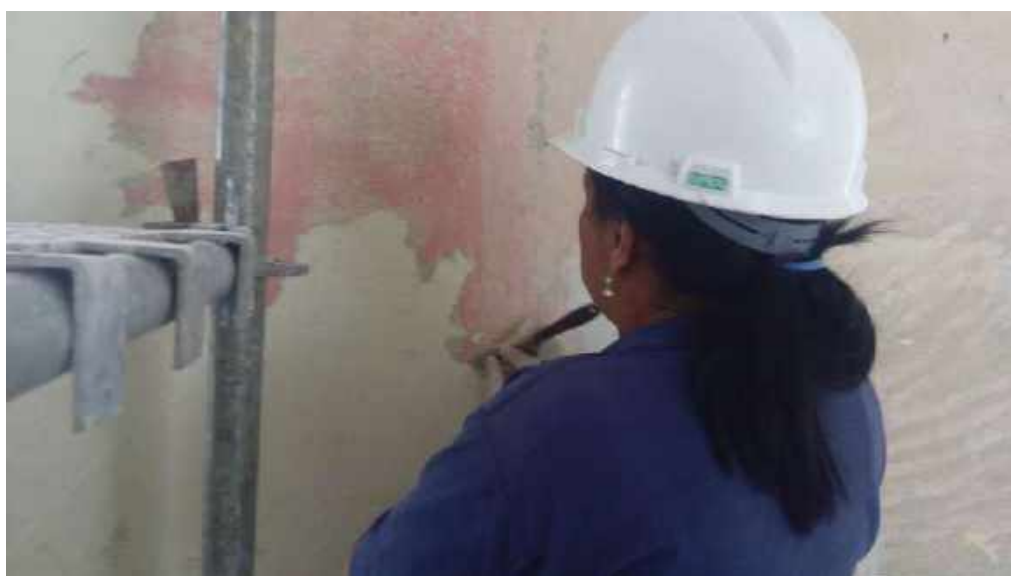
Foto 46 – Decapagem cuidadosa das tintas existentes sobre a pintura decorativa – Casa 05
