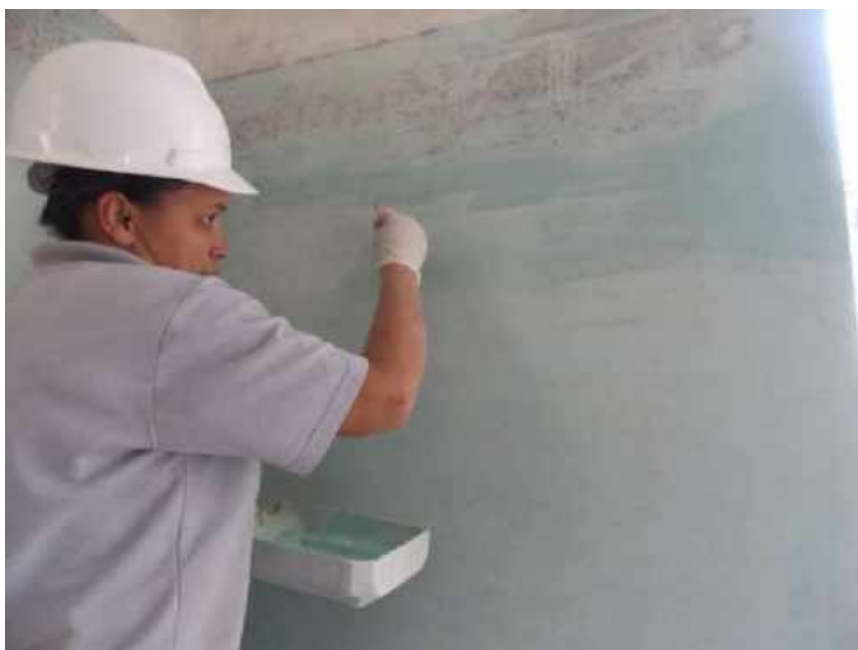
Foto 22 – Execução da reintegração da tonalidade – Casa 05
