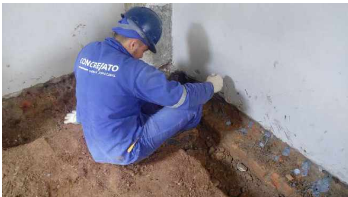
Foto 12 – Cristalização e impermeabilização da alvenaria – Casa 06
