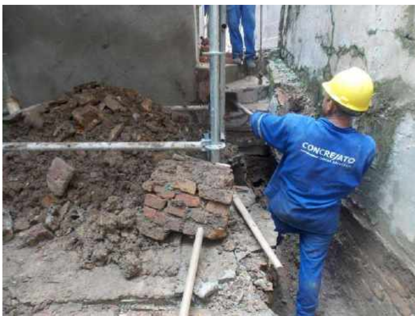
Foto 19 – Escavação manual nos fundos – Casa 06
