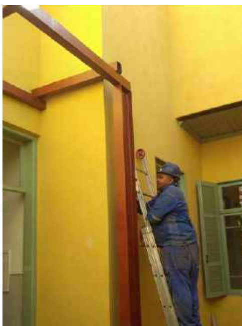
Foto 04 - Pintura lisa da estrutura metálico – Casa 06
