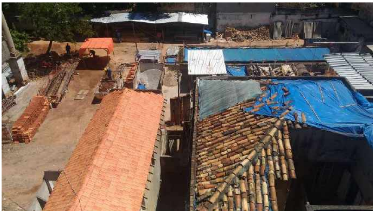
Foto 05: Proteção provisória com lona plástica.
