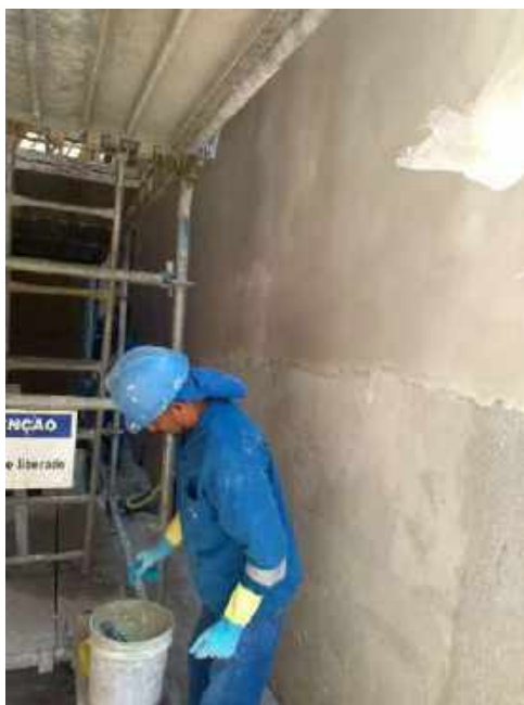
Foto 39 – Execução da argamassa de acabamento na fachada lateral – Casa 06
