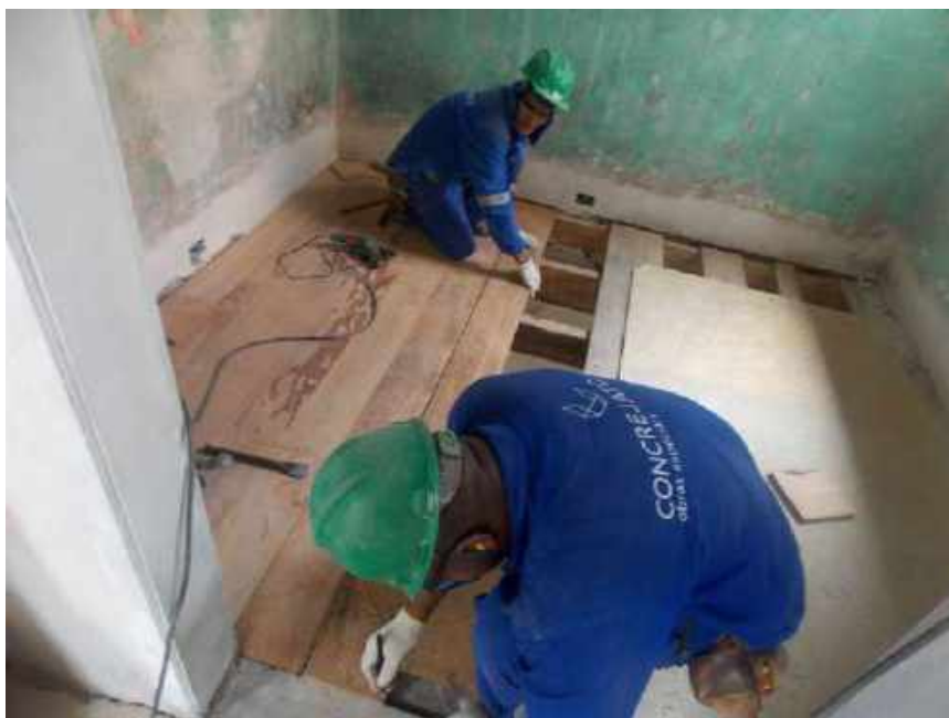
Foto 19 – Instalação dos assoalhos de madeira – Casa 06
