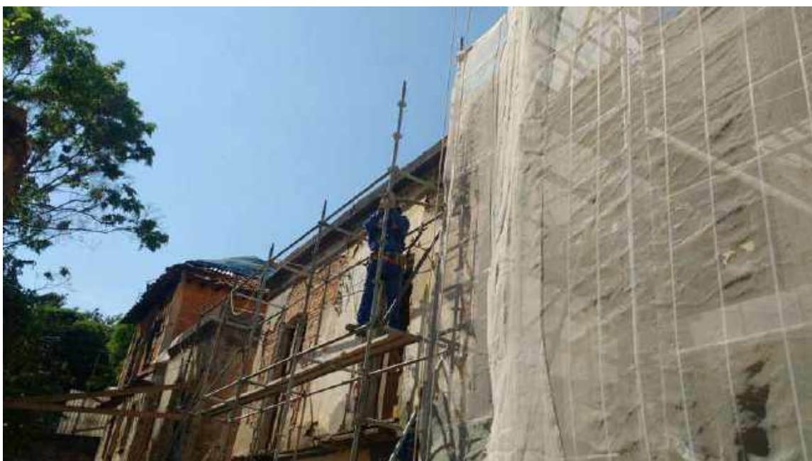
Foto 18- Montagem do andaime na fachada da casa 06
