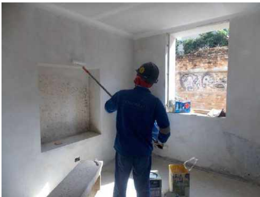
Foto 50 – Aplicação de seladora nas paredes internas – Casa 06
