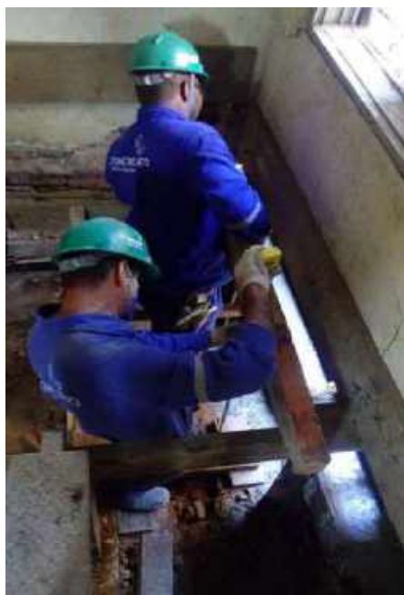
Foto 43 – Restauração dos barrotes de madeira – Casa 06
