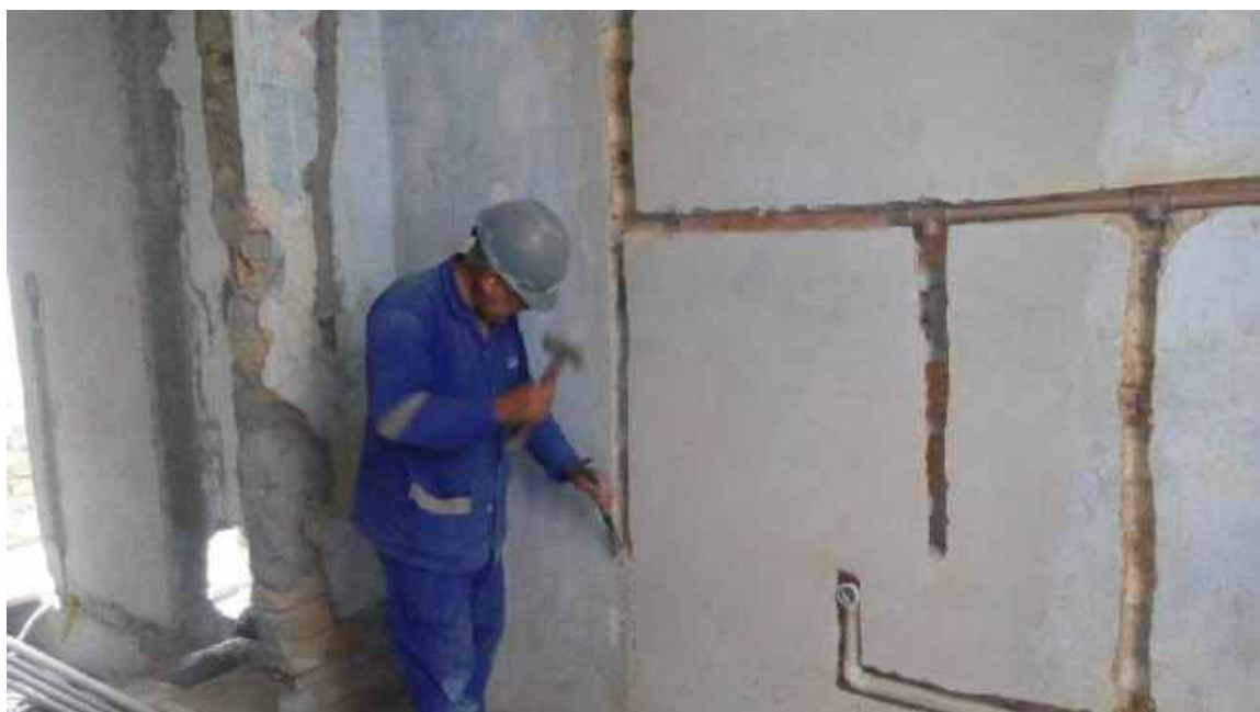
Foto 18 – Instalação da hidráulica – Casa 06
