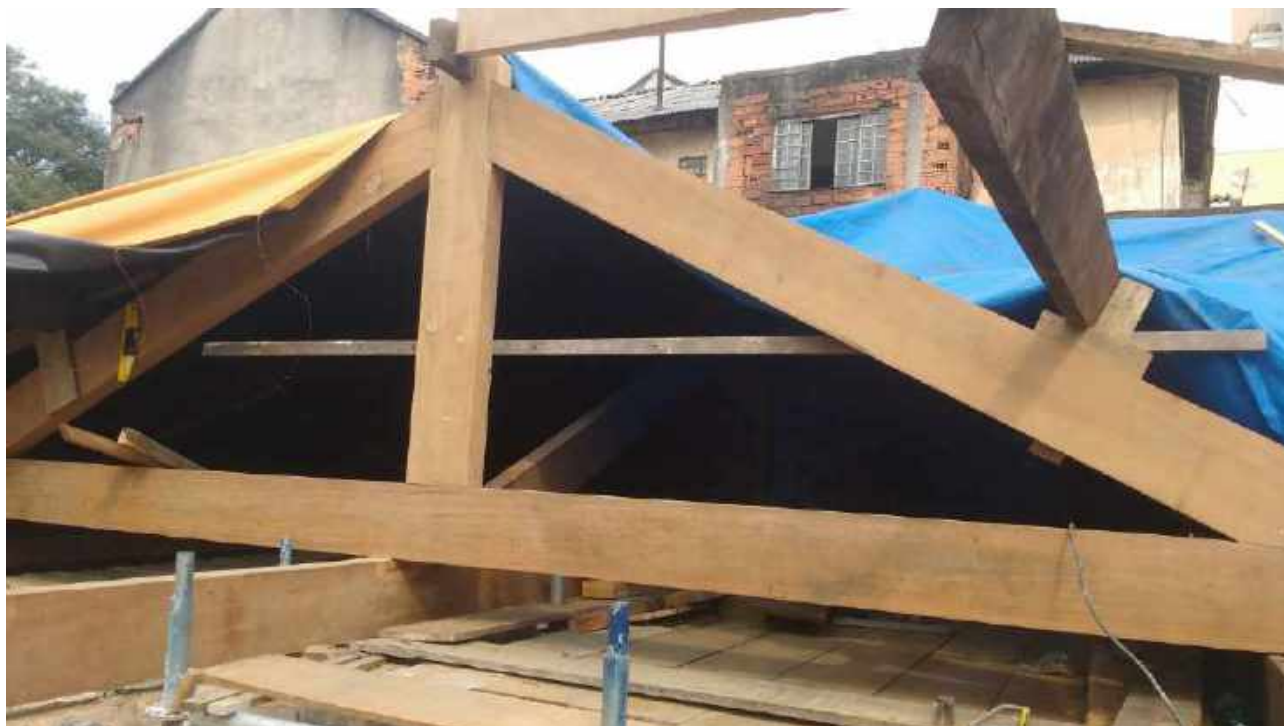
Foto 17: Substituição das peças danificadas da tesoura da Casa 6.
