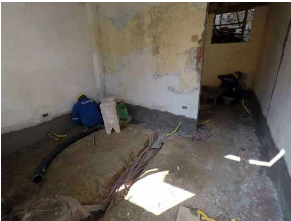
Foto 42 – Execução da drenagem do solo – Casa 06
