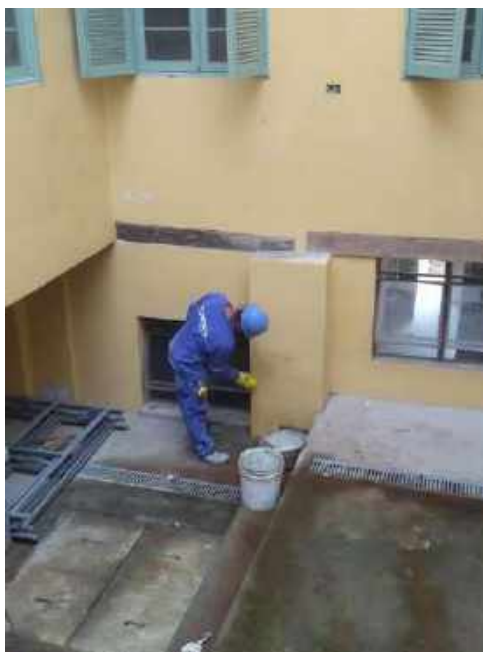
Foto 34 – Revisão da argamassa de acabamento das paredes externas
