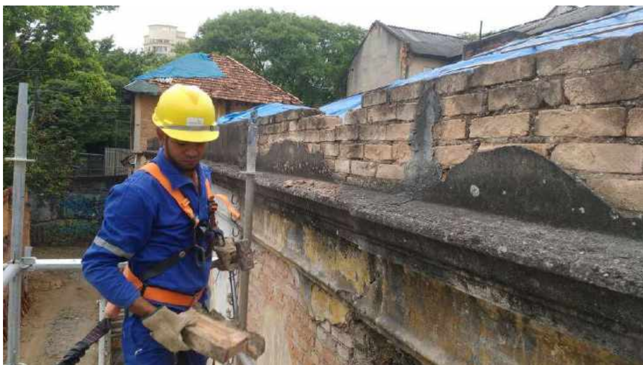
Foto 20: Desmontagem cuidadosa da alvenaria com reaproveitamento de tijolos – Casa 6.
