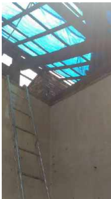
Foto 09: Remoção das telhas coloniais e retirada das ripas e caibros da Casa 6.
