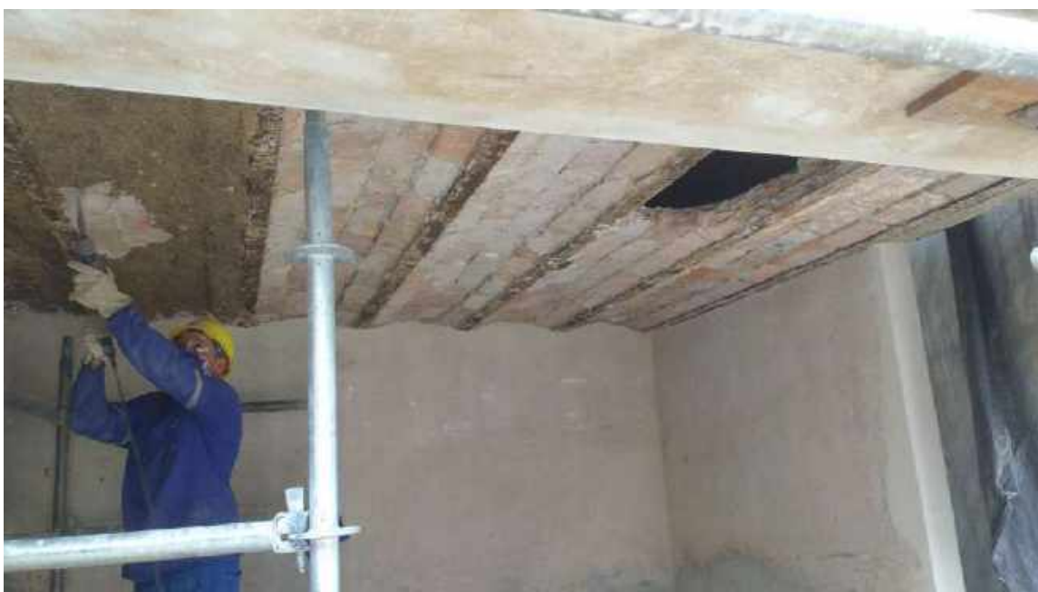
Foto 12 – Remoção do chapisco – Casa 05
