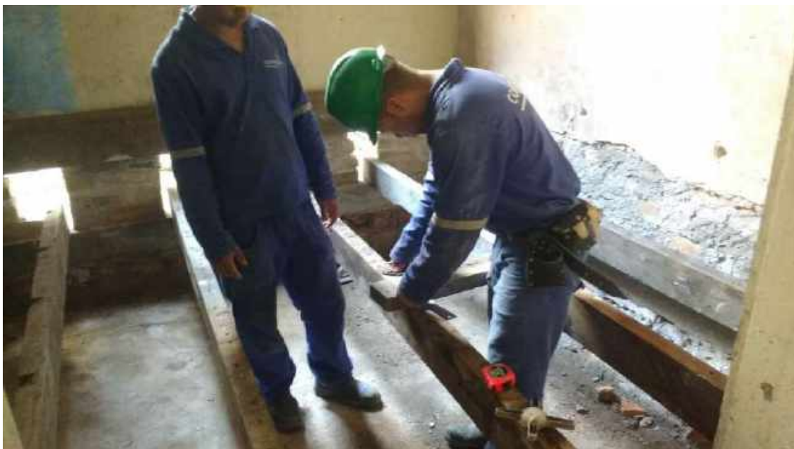
Foto 33 – Instalação dos barrotes – Casa 06
