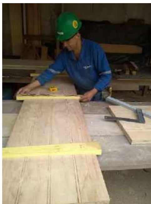
Foto 18 – Execução da porta de madeira – Casa 06
