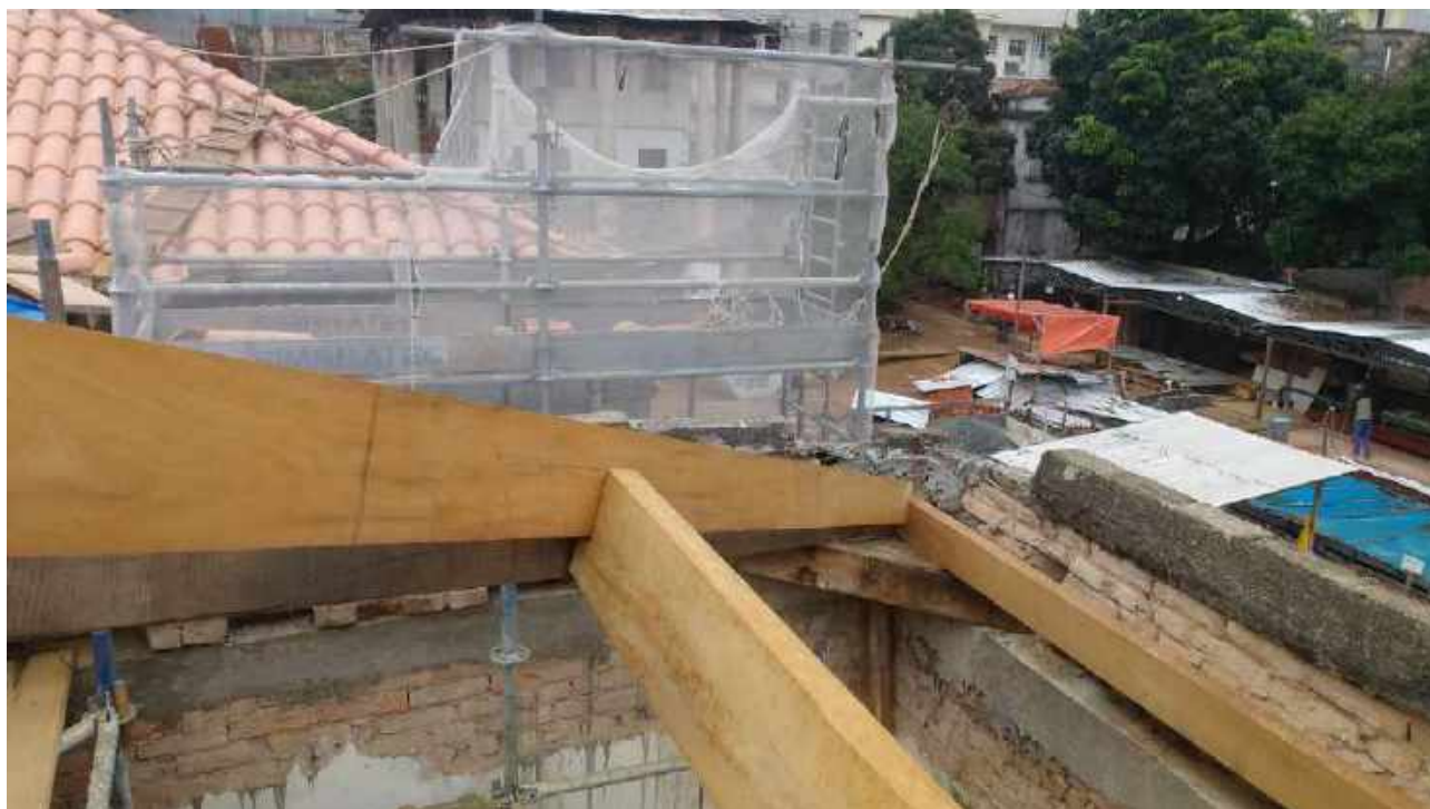
Foto 29: Substituição das peças danificadas da tesoura da Casa 6.
