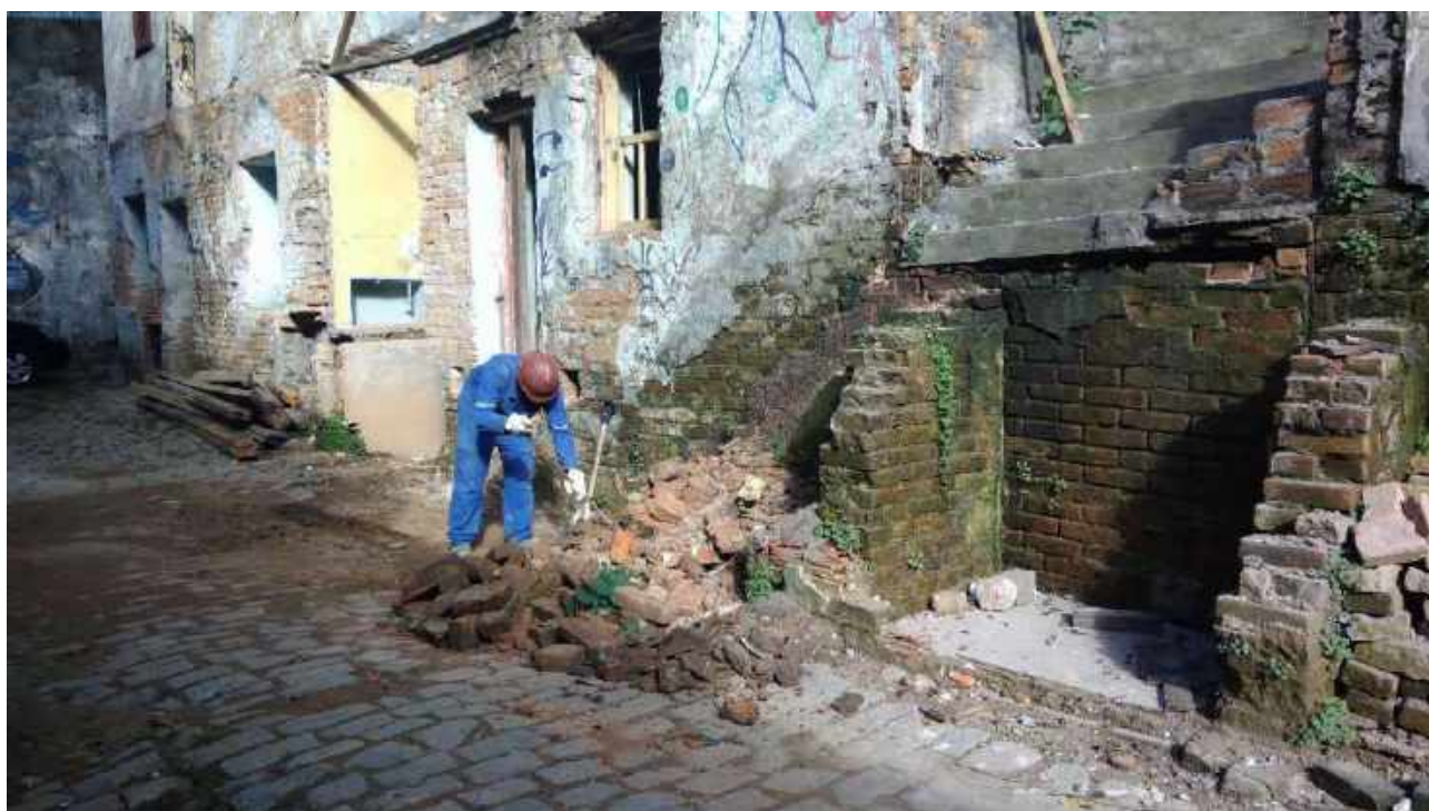
Foto 04: Desmontagem da escadaria para execução de bloco estrutural - Casa 06
