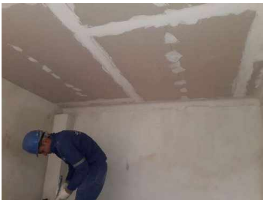
Foto 48 – Instalação do forro de drywall – Casa 06
