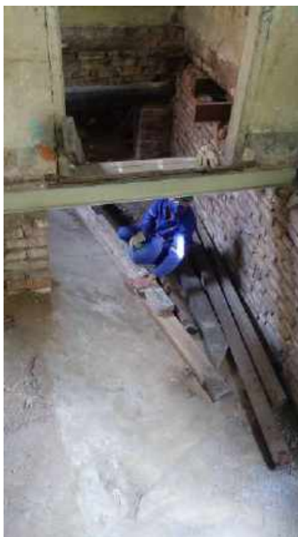
Foto 09 – Remoção dos barrotes e dos rodapés de madeira
