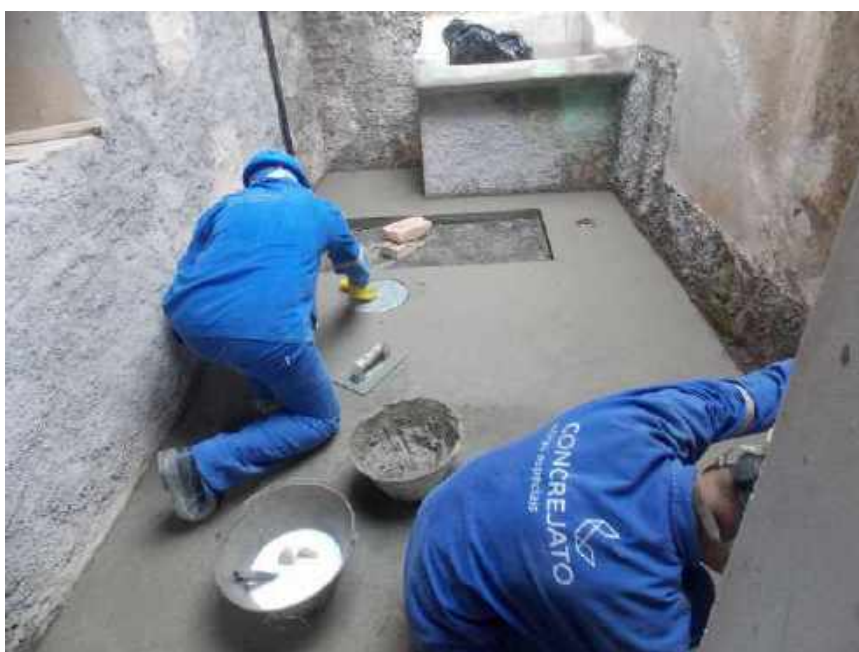
Foto 16 – Execução do piso cimentado – Casa 05
