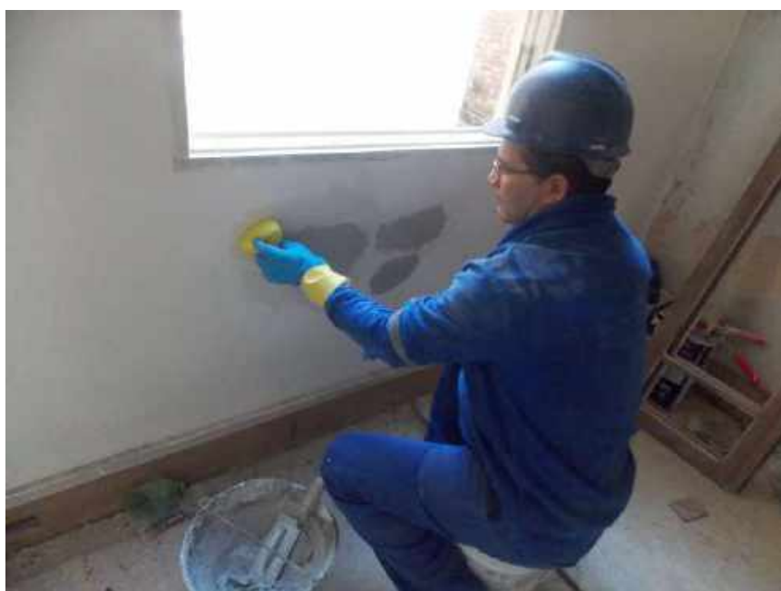
Foto 20 – Execução da argamassa de acabamento das paredes internas - Casa 06
