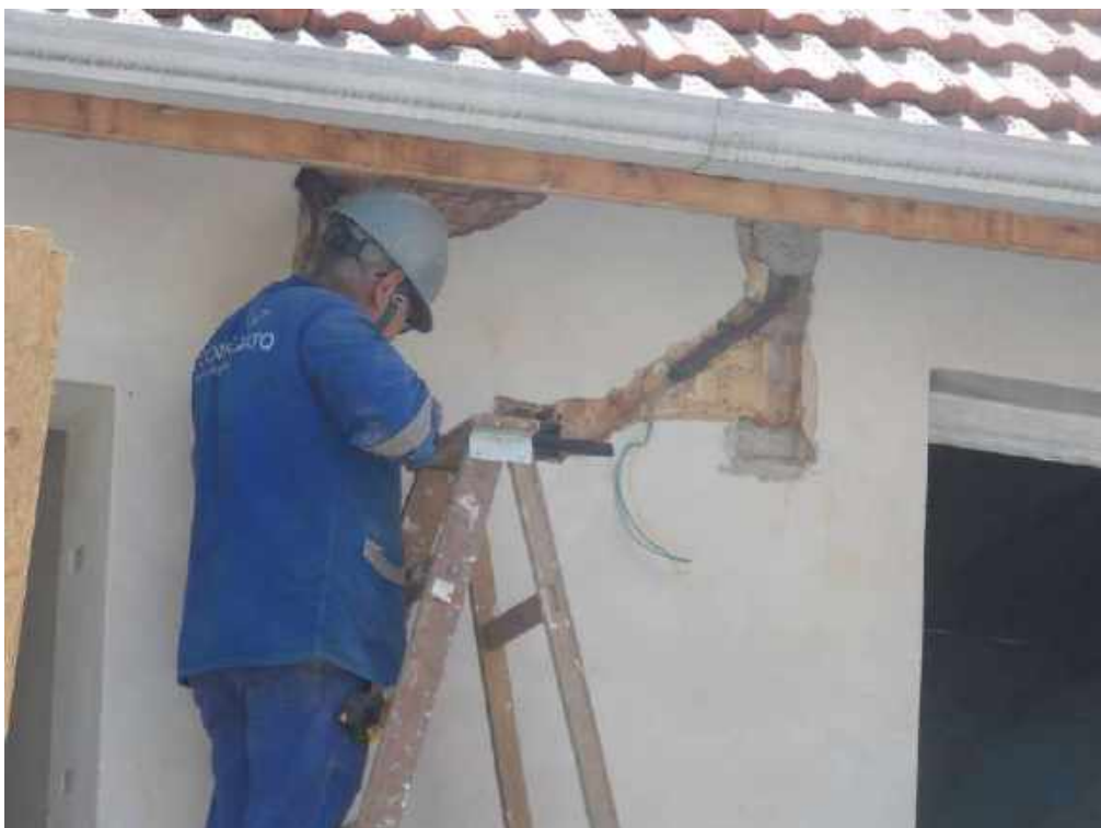
Foto 07 - Instalação dos cabos para execução da elétrica fachada lateral – Casa 05
