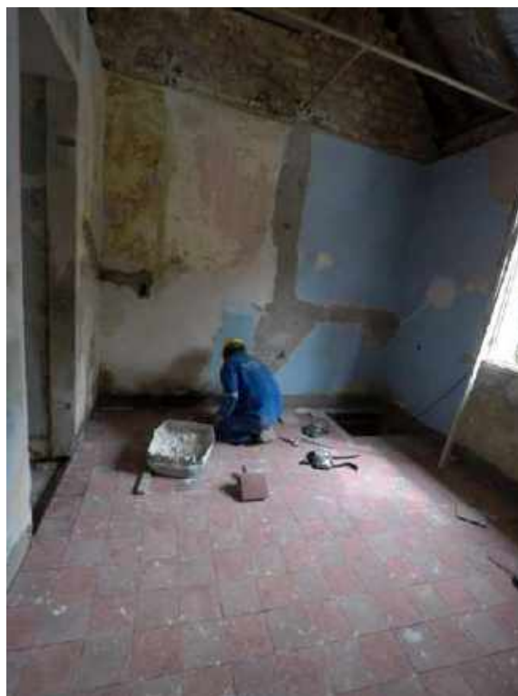
Foto 02 – Instalação dos ladrilhos hidráulicos – Casa 05
