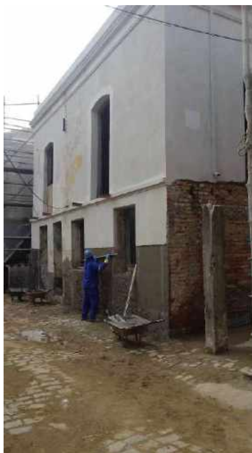
Foto 28 – Execução do revestimento chapiscado da fachada – Casa 06
