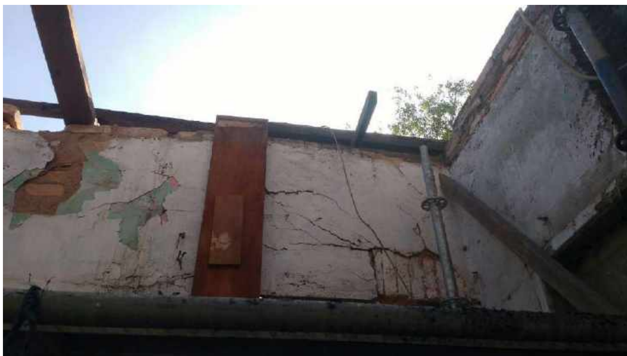
Foto 50: Escoramento e contenção das alvenarias.
