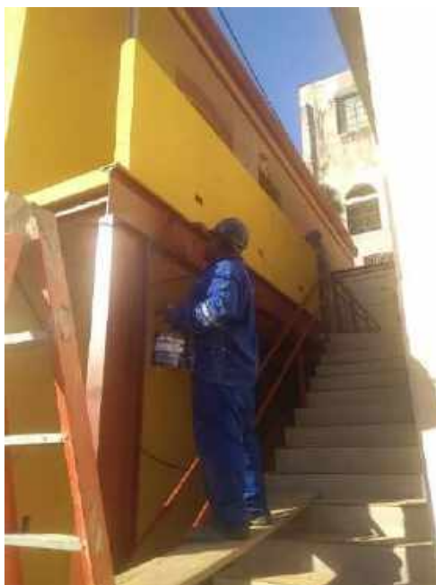
Foto 36 – Pintura lisa do perfil metálico da escada
