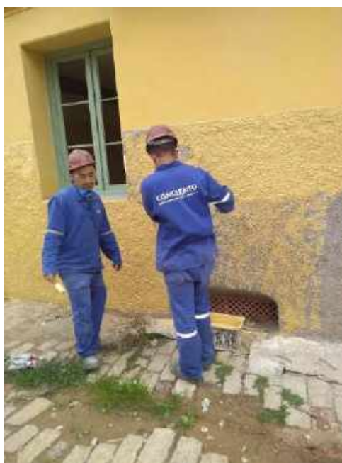
Foto 06 – Pintura lisa com tinta mineral da fachada principal – Casa 06
