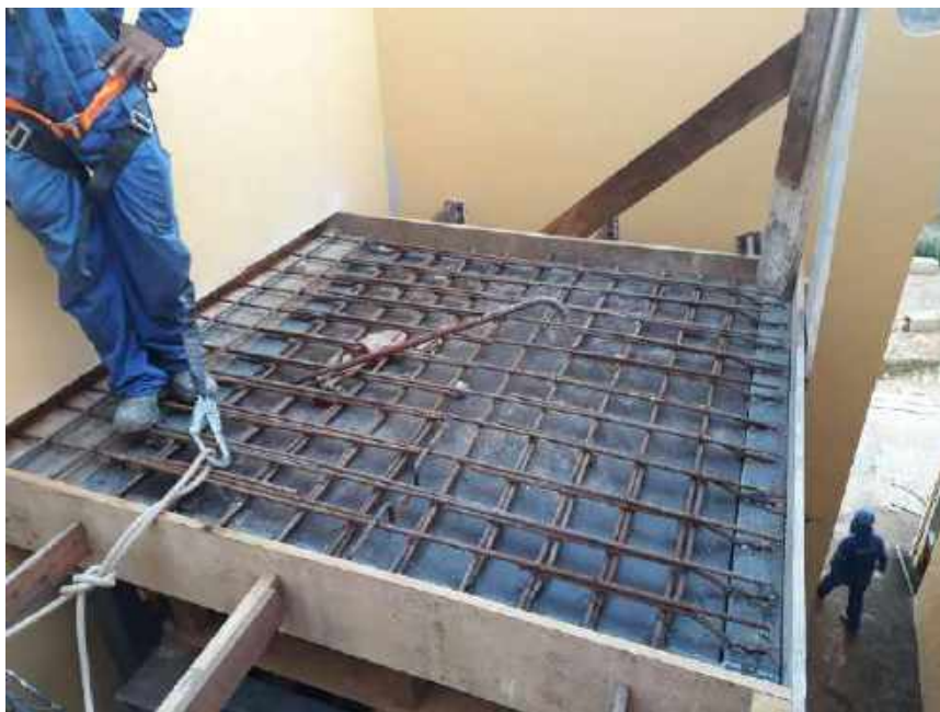
Foto 40 – Execução da armação para concretagem da cobertura do elevador – Casa 06
