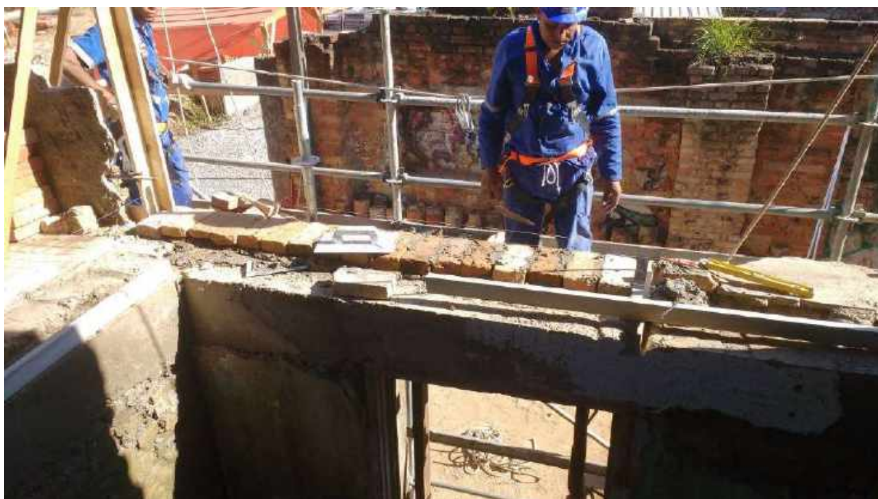
Foto 23: Remontagem da alvenaria.
