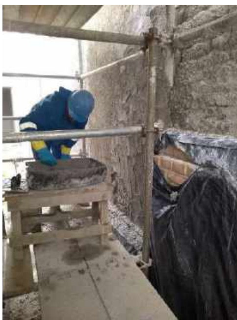
Foto 52 – Execução do chapisco do muro dos fundos – Casa 06
