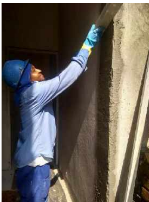
Foto 20 – Requadro dos vãos das portas metálicas – Casa 06
