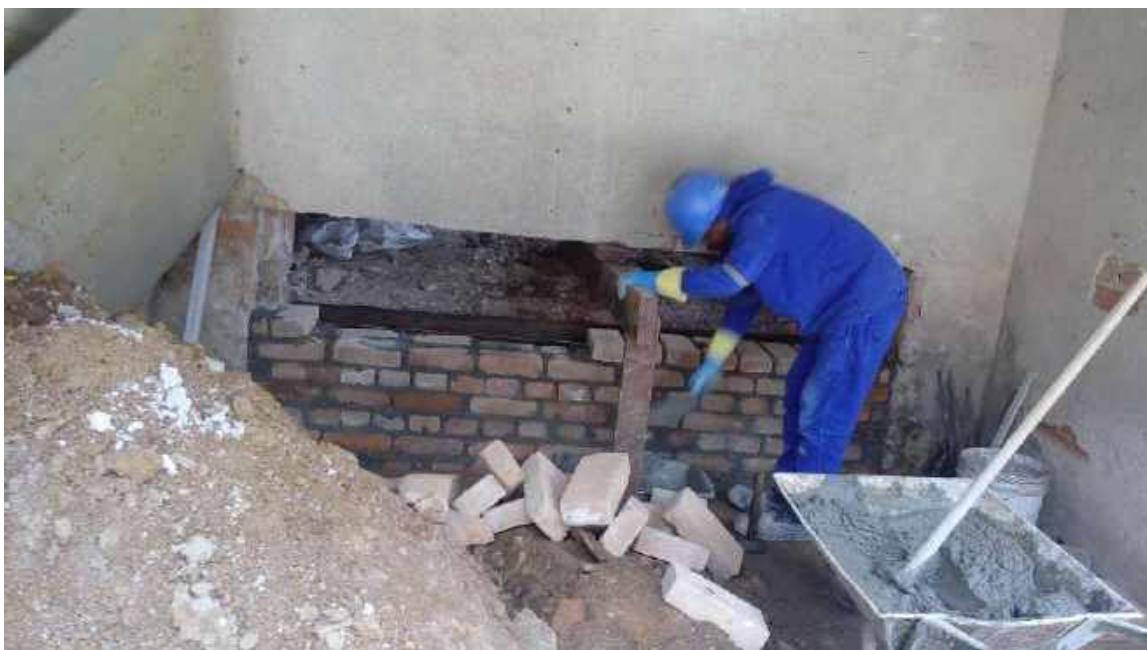
Foto 09 – Elevação da alvenaria – Casa 05
