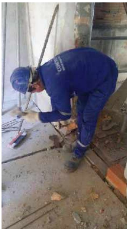
Foto 29 – Regularização das paredes – Casa 06
