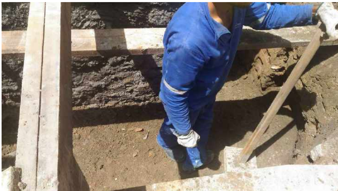
Foto 05: Compactação do solo.
