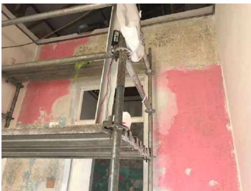
Foto 12 – Decapagem manual cuidadosa das paredes internas – Casa 06
