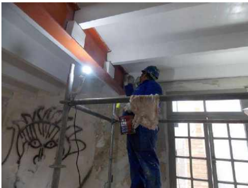
Foto 11 – Pintura lisa do perfil metálico – Casa 05
