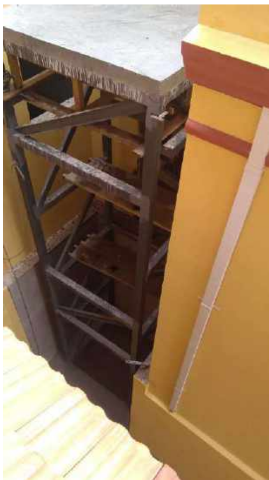
Foto 47 – Montagem da estrutura metálica da plataforma elevatória e execução da laje.
