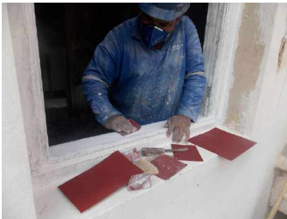
Foto 05 – Lixamento das esquadrias – Casa 05
