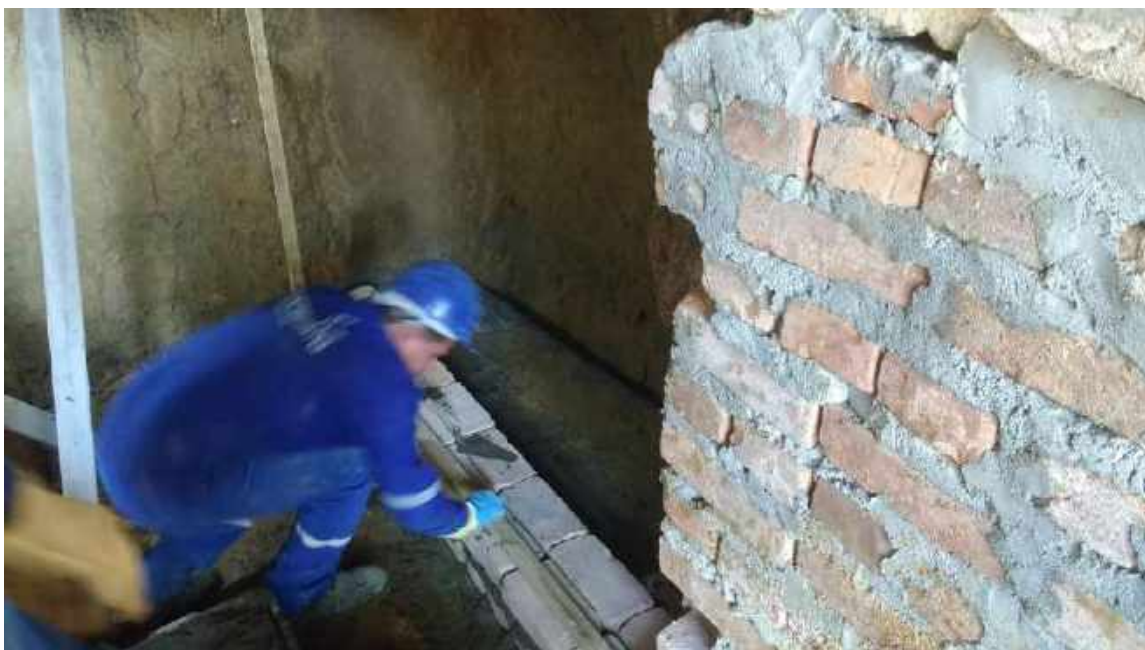
Foto 43 – Elevação da alvenaria externa após escavação do fosso do elevador – Casa 06
