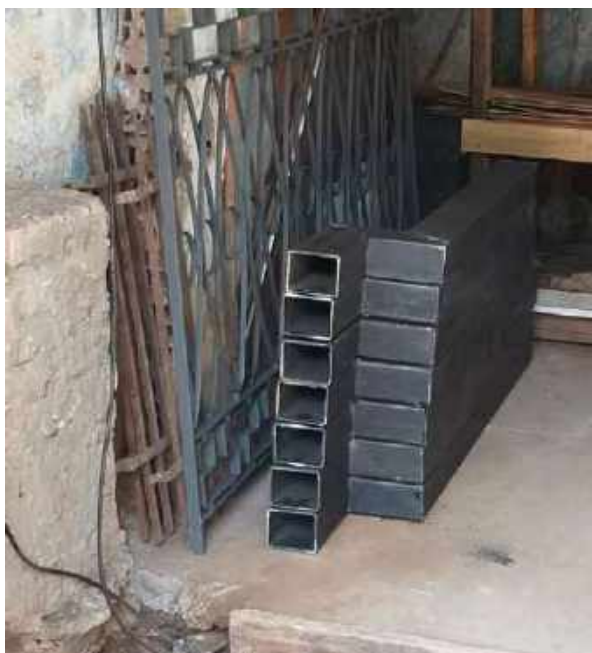
Foto 29 - Execução dos perfis metálicos para execução da cobertura
