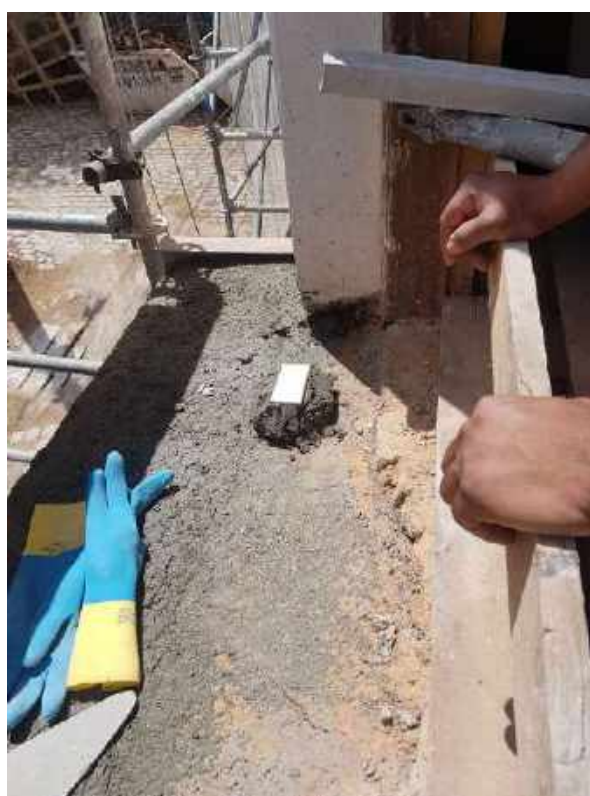
Foto 20 – Execução da varanda com a instalação de taliscas – Casa 06
