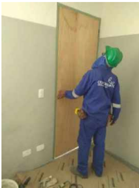
Foto 27 – Instalação das portas de madeira – Casa 06
