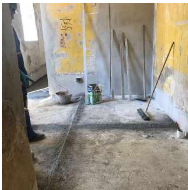
Foto 28 – Instalação da junta de dilatação – Casa 06
