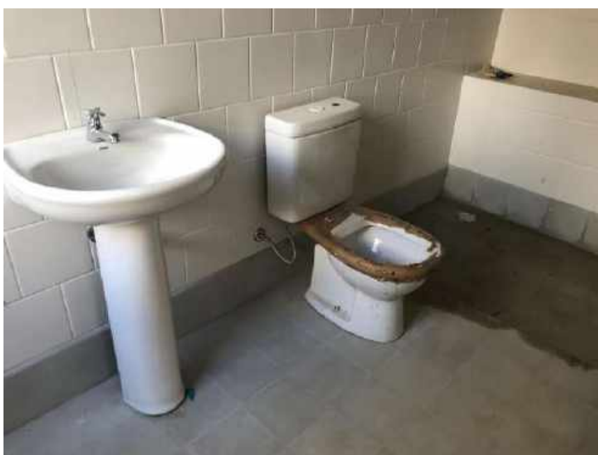
Foto 42 – Instalação das louças – Casa 06
