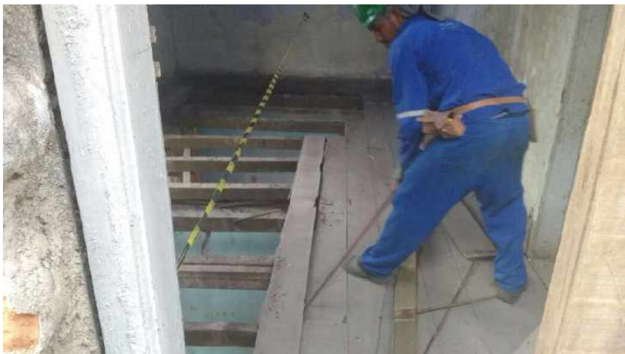
Foto 22: Remoção dos pisos de madeira para execução de escoramento metálico.
