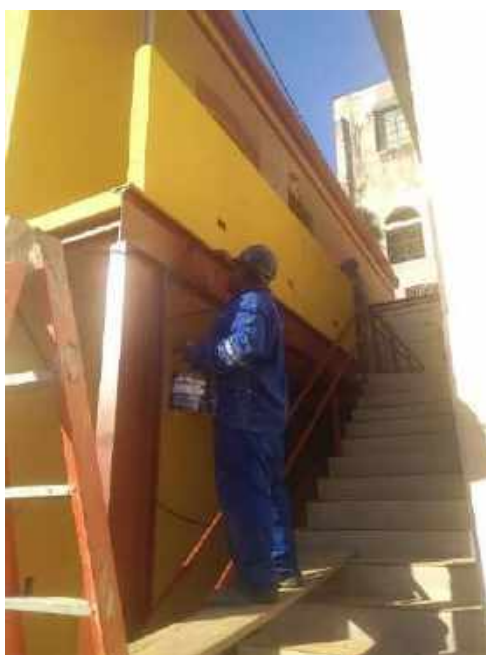
Foto 37 - Pintura lisa do perfil metálico da escada
