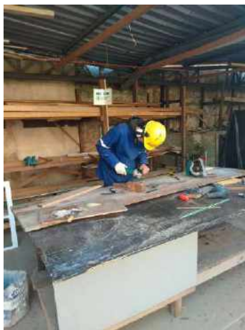
Foto 22 – Restauração das portas de madeira – Casa 06
