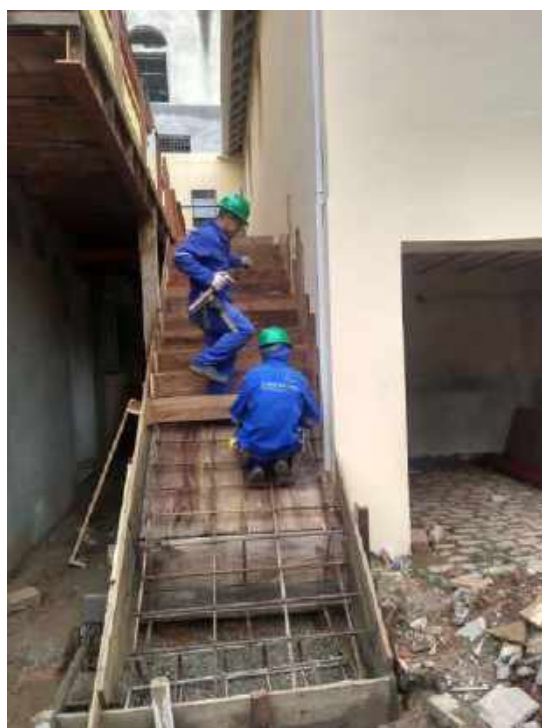
Foto 08 – Execução da forma para concretagem da escada da fachada lateral
