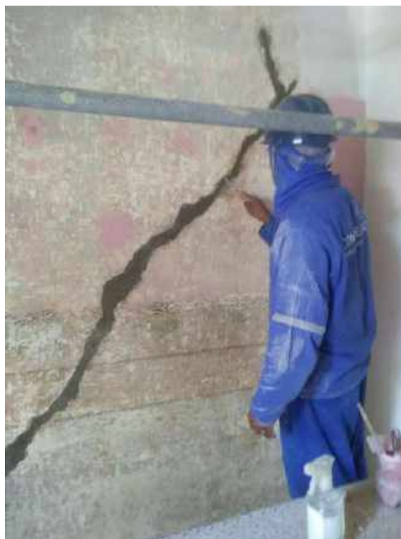
Foto 01 – Tratamento das fissuras nas alvenarias – Casa 06
