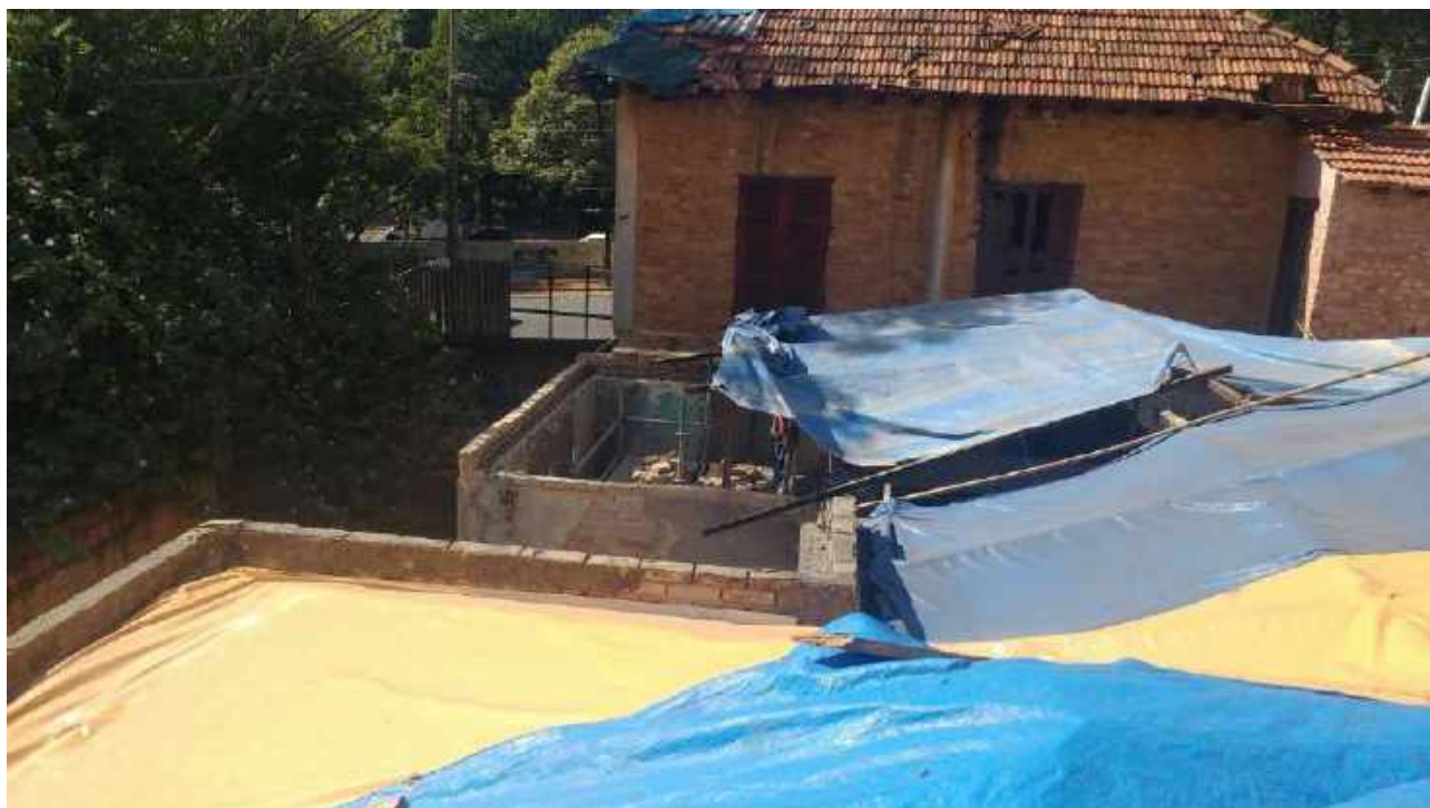
Foto 63: Proteção das telhas com lona.
