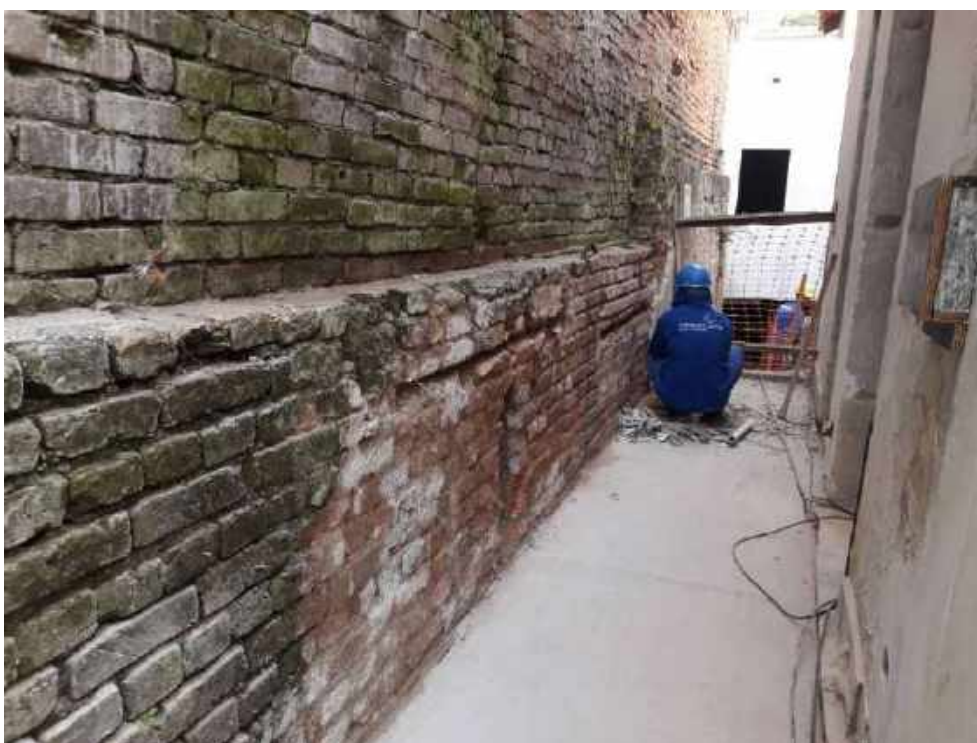
Foto 68 – Restauração dos tijolos existente nos fundos – Casa 06
