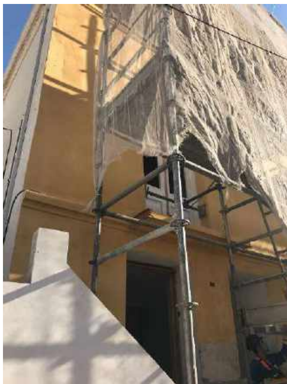
Foto 74 – Pintura da fachada – Casa 06
