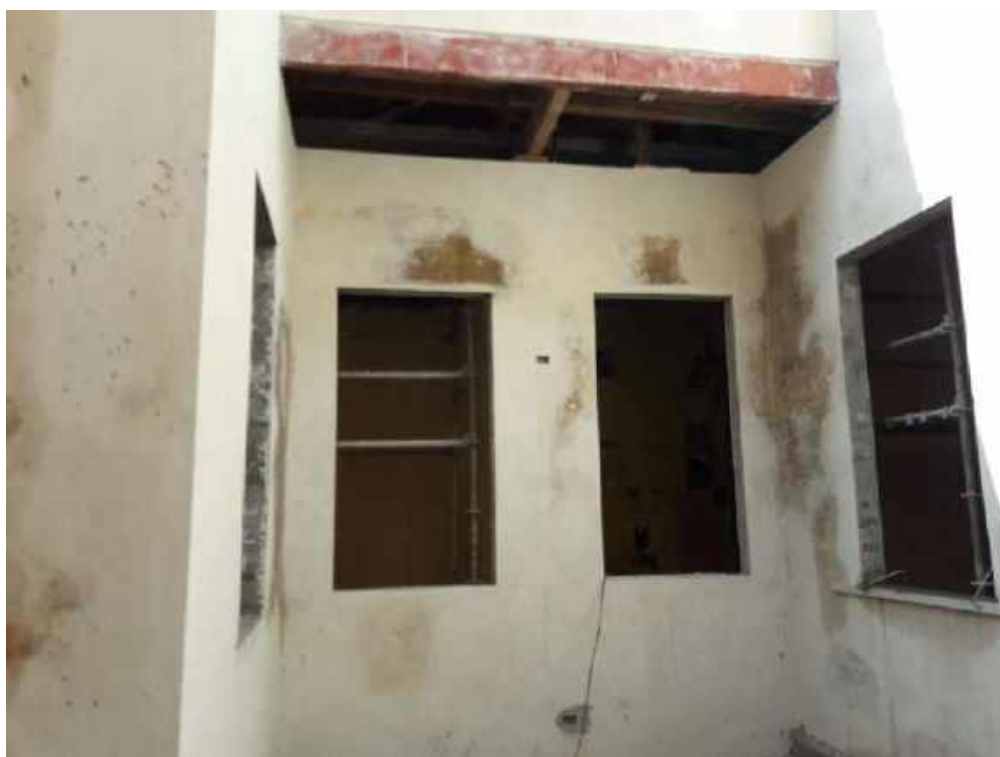
Foto 31 – Concretagem da armação, para execução do elevador – Casa 06
