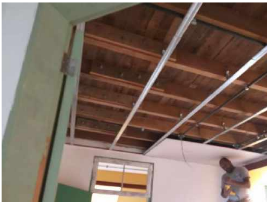
Foto 11- Instalação do forro de Drywall – casa 7
