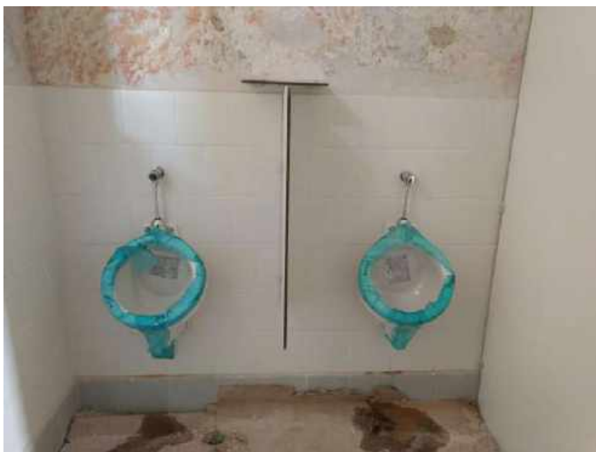
Foto 45 –Instalação dos mictórios – Casa 06
