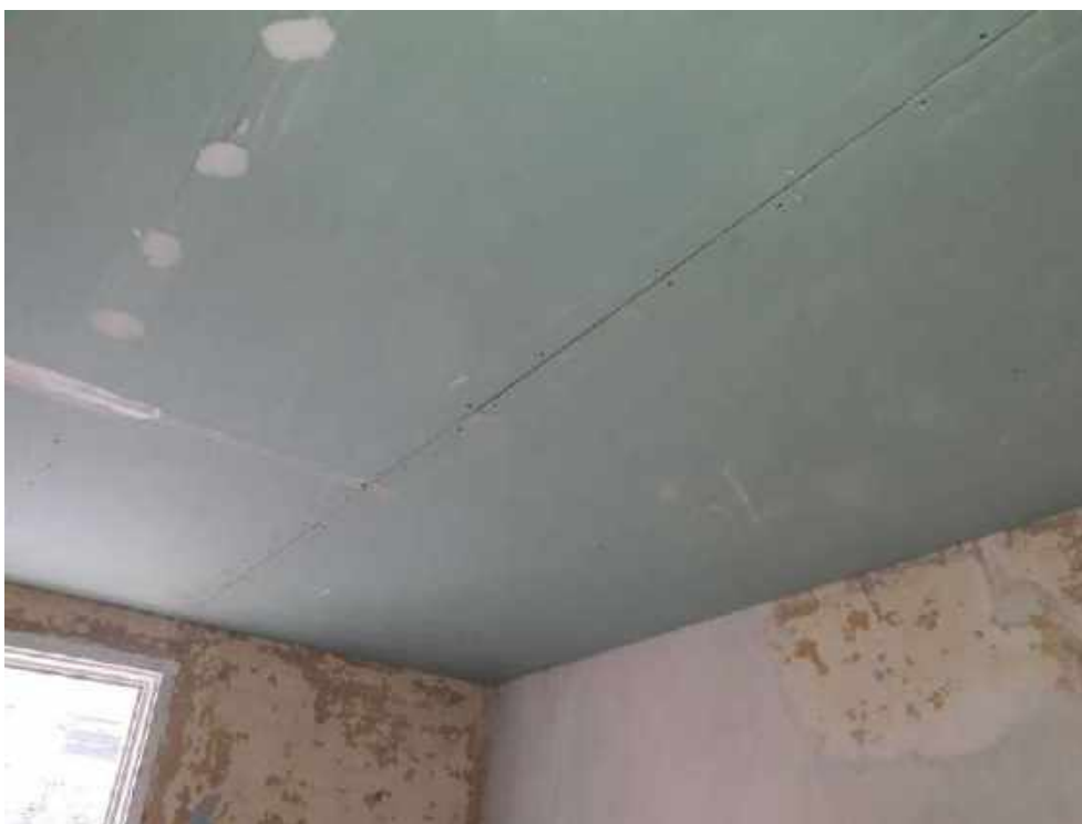
Foto 67– Instalação do forro – Casa 05
