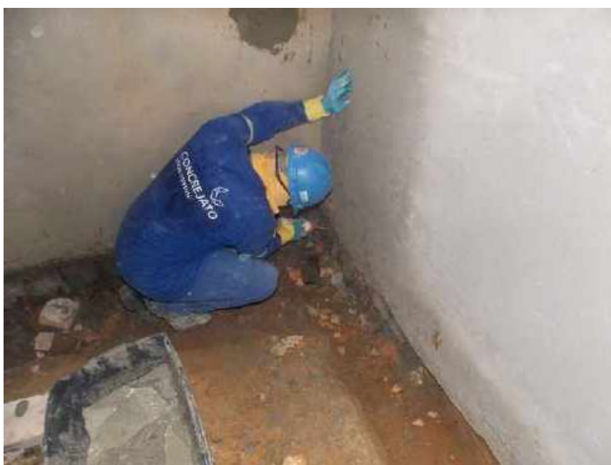
Foto 32 – Cristalização e impermeabilização dos baldrame – Casa 06
