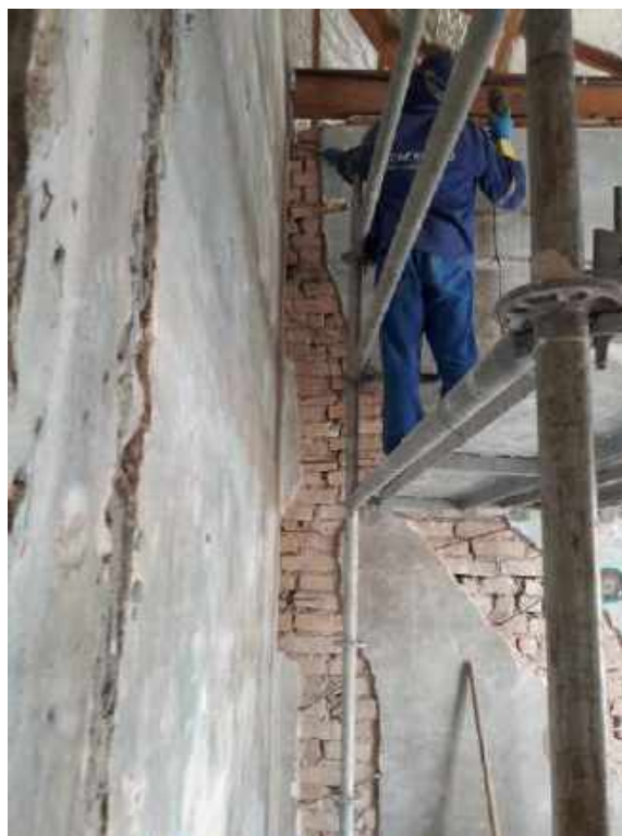
Foto 26 – Tratamento das trincas – Casa 06
