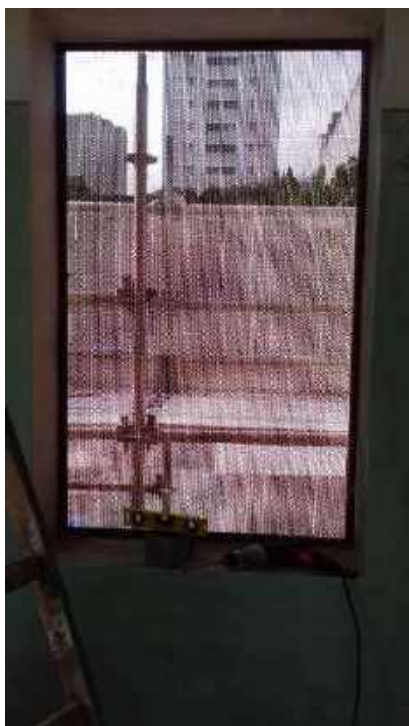
Foto 21 – Instalação da grade metálica – Casa 05
