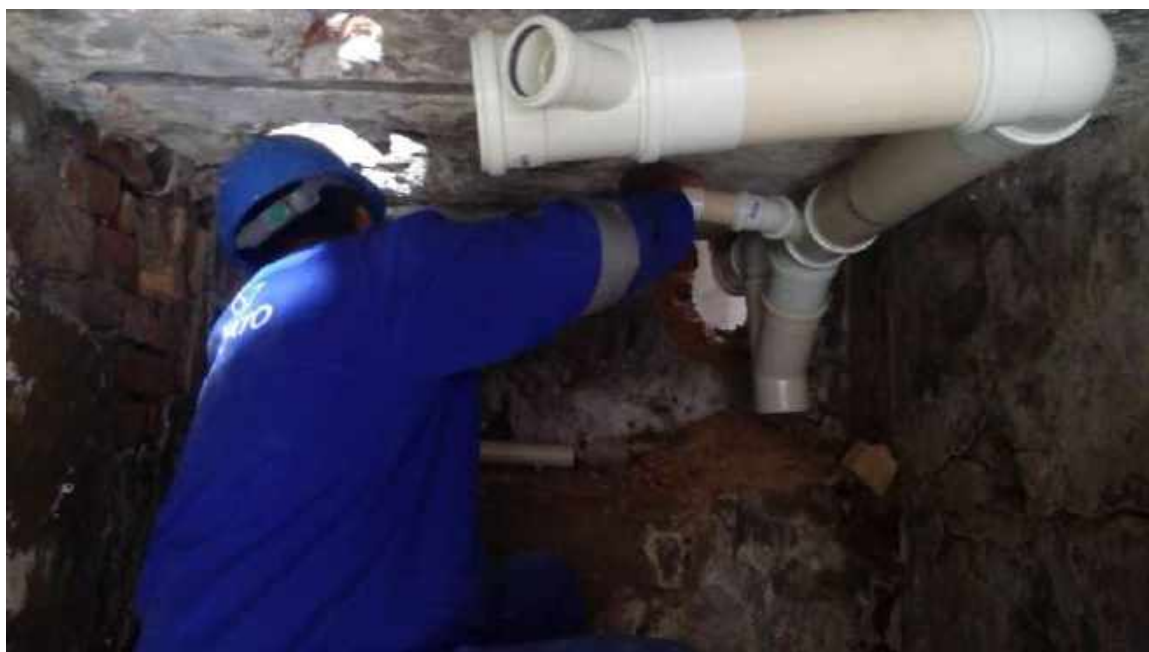
Foto 25 – Instalação da hidráulica – Casa 06
