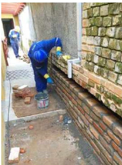
Foto 20 - Elevação da alvenaria existente, após reparos na fachada dos fundos – Casa 06
