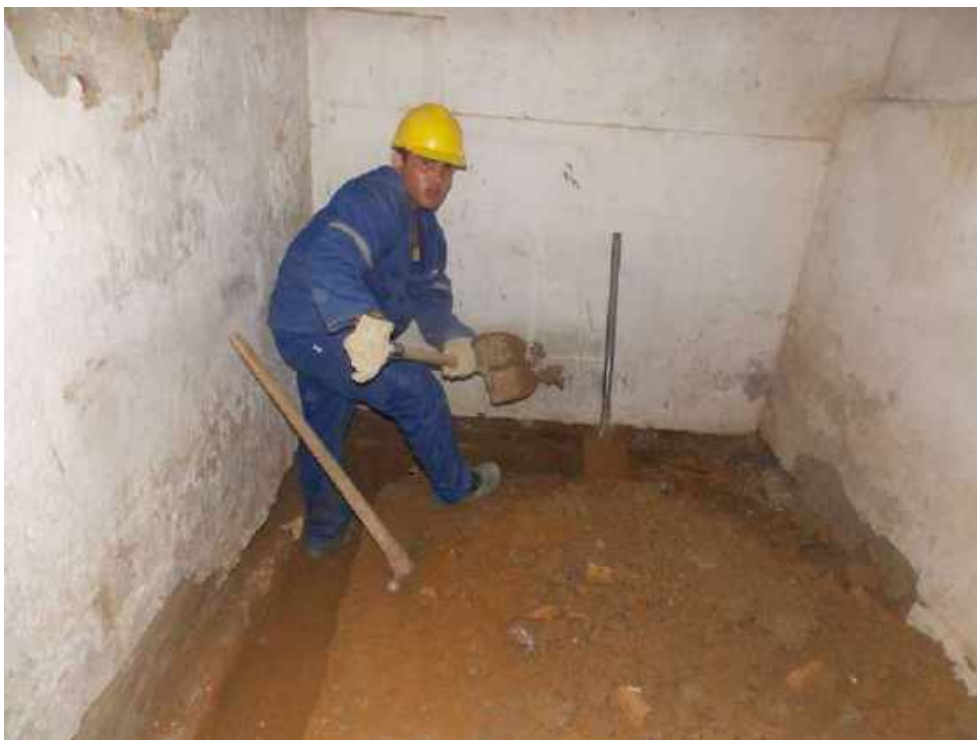
Foto 39 – Escavação manual para execução da drenagem do solo – Casa 06
