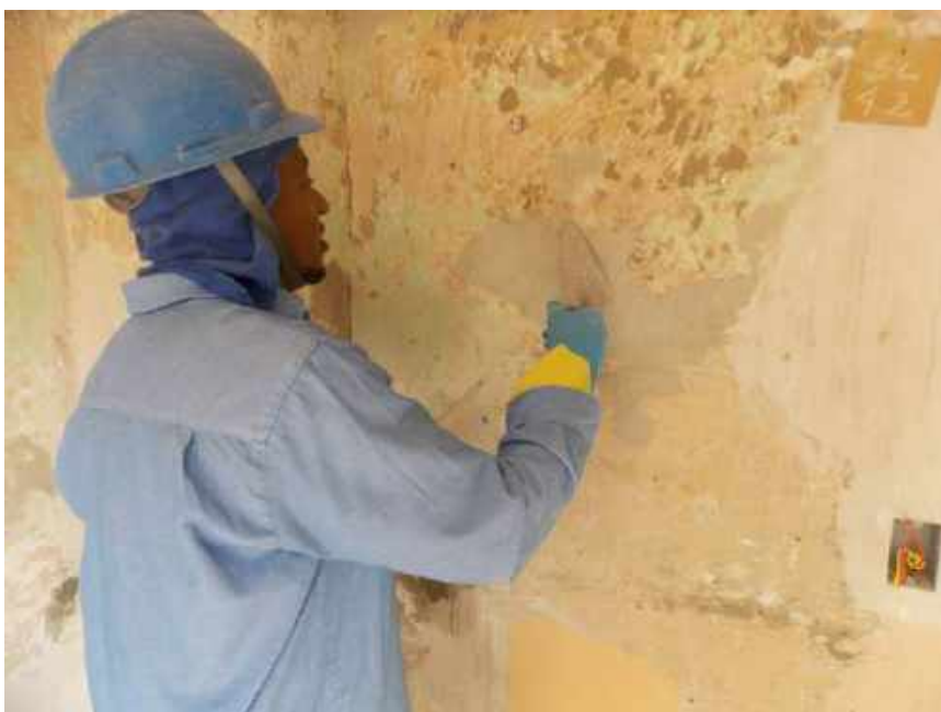
Foto 37- Execução da argamassa de acabamento das paredes internas – Casa 06
