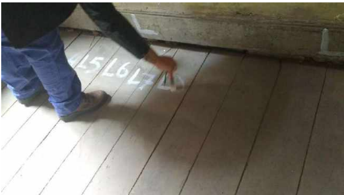
Foto 27 – Mapeamento das régua de madeira e dos rodapés de madeira – Casa 06
