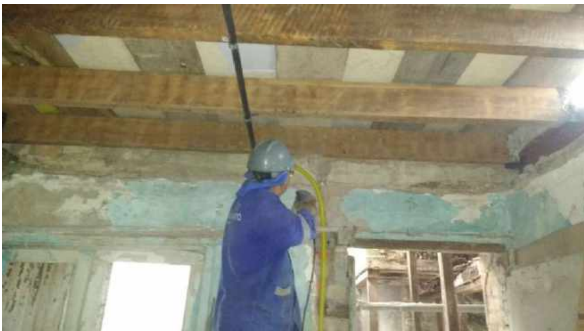
Foto 31 – Instalação dos conduites – Casa 06
