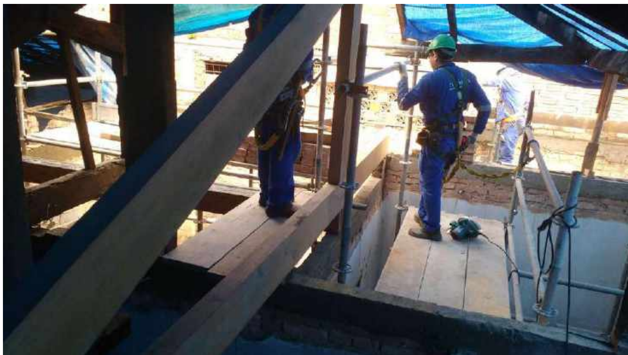
Foto 27: Substituição das peças danificadas da tesoura da Casa 6.
