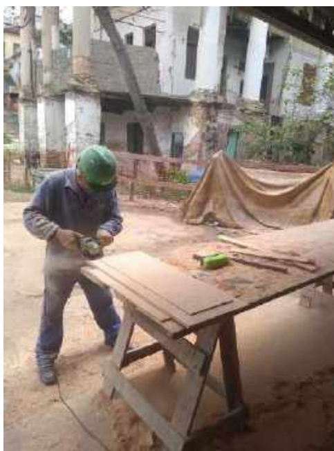
Foto 25 – Execução das almofadas das portas de madeira – Casa 06
