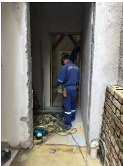
Foto 30 – instalação dos batentes de madeira – Casa 06
