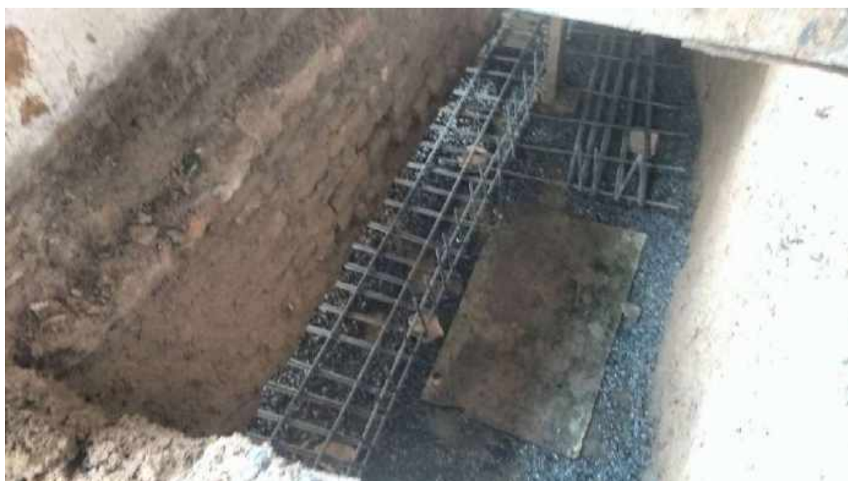
Foto 02: Armação dos blocos de fundação.
