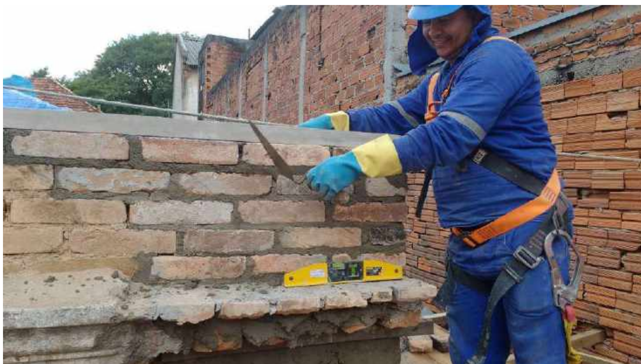
Foto 04: Correções das alvenarias das cimalha.
