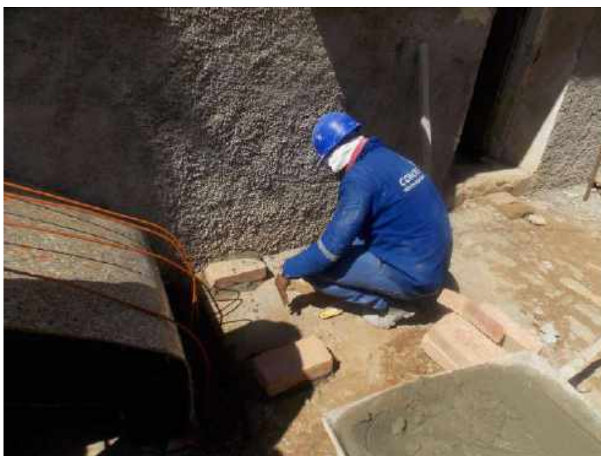
Foto 09 – Execução da alvenaria da escada – Casa 06
