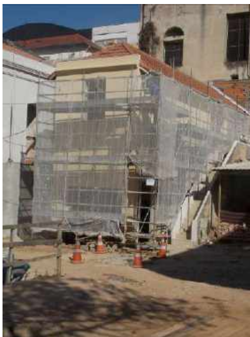
Foto 03 – Pintura lisa da fachada – Casa 05
