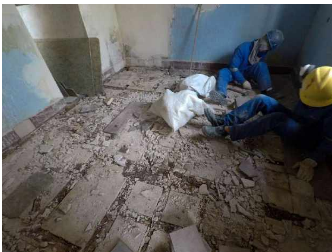
Foto 60 – Foto geral da laje existente na casa 05
