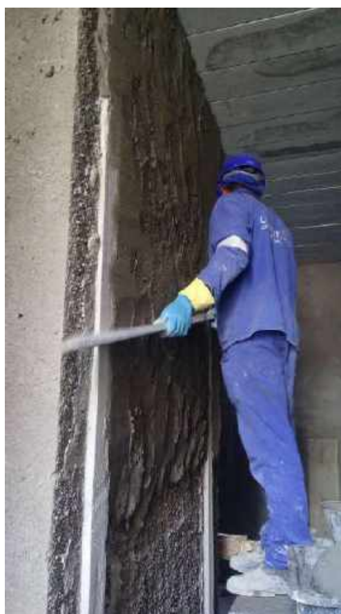
Foto 14 – Execução do emboço - casa 06
