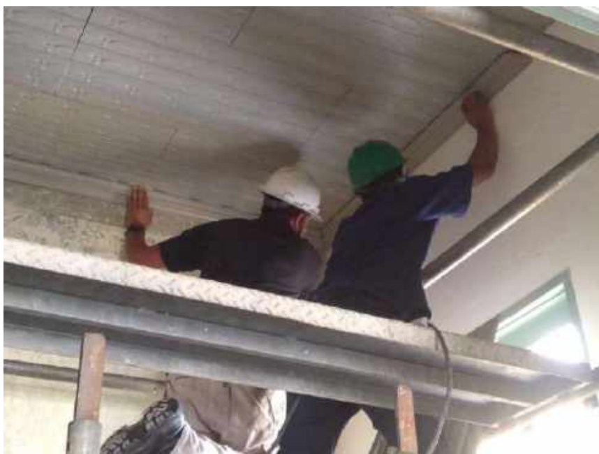
Foto 16 - Instalação da moldura de madeira no forro metálico – Casa 06
