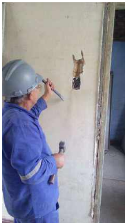
Foto 57 – Execução da infra de elétrica da casa 05
