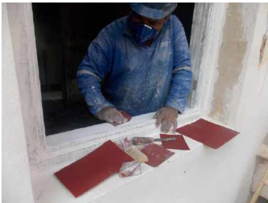
Foto 08 – Lixamento das esquadrias – Casa 05
