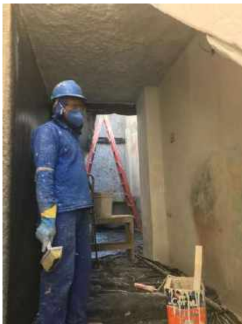
Foto 09 – Caiação no chapisco da fachada lateral – Casa 05
