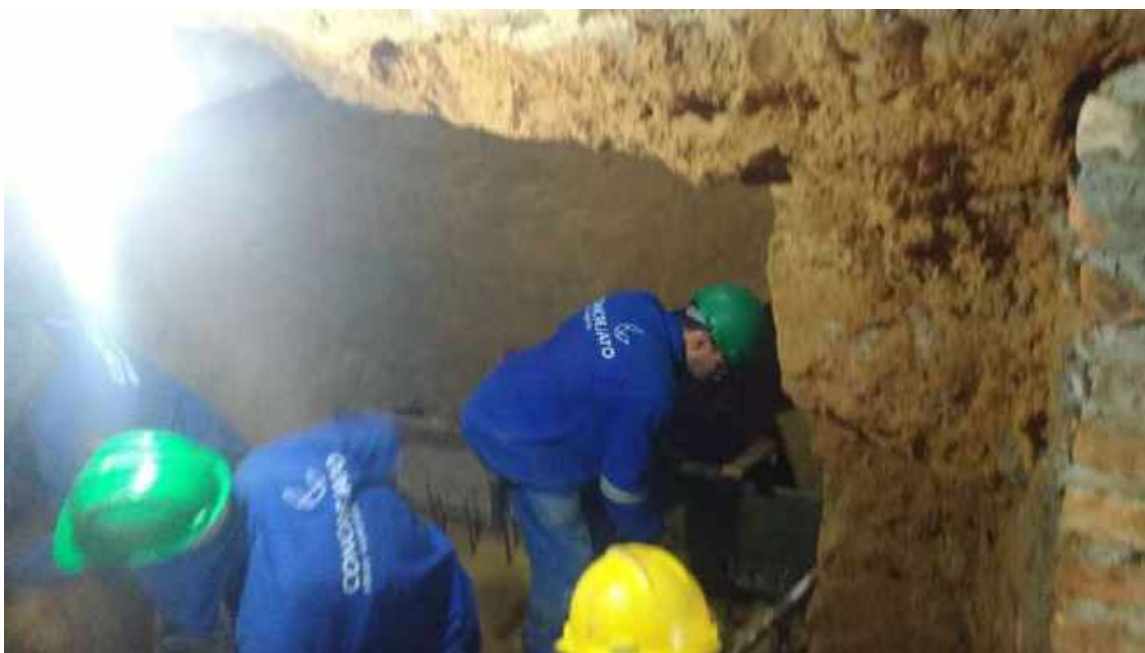
Foto 26 - Instalação da armação – Casa 06
