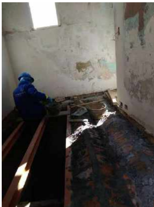
Foto 53 – Remontagem da abobadilha – Casa 06
