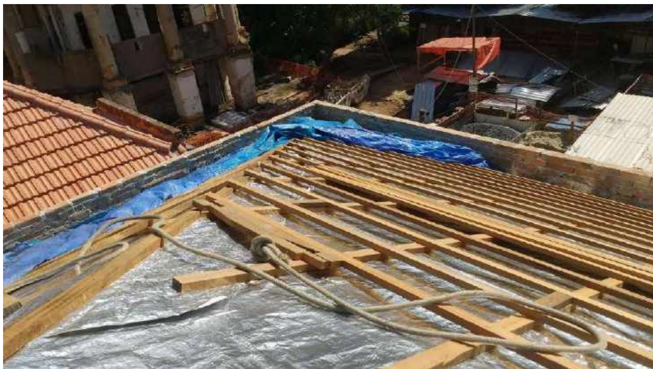
Foto 37: Instalação da manta aluminizada e ripas.
