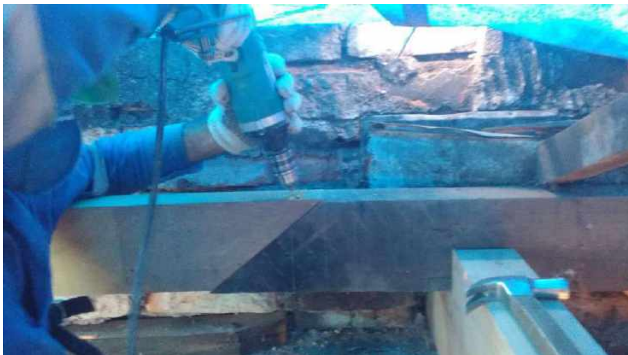
Foto 17: Detalhe do encaixe da madeira antiga com a nova
