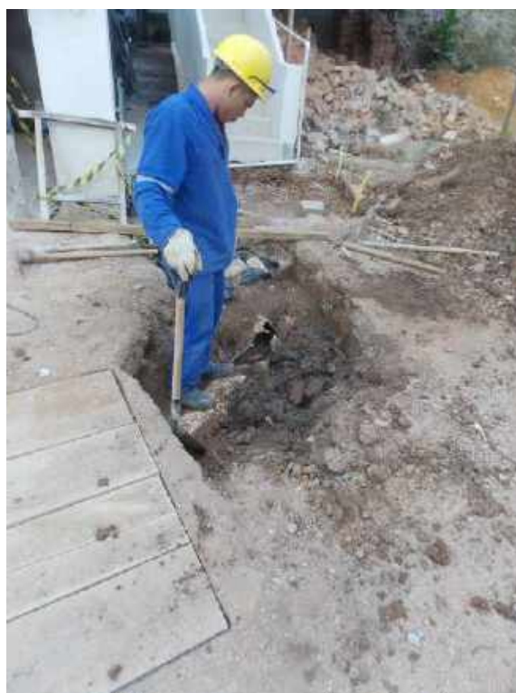
Foto 18 – Escavação manual para troca da tubulação – Casa 05
