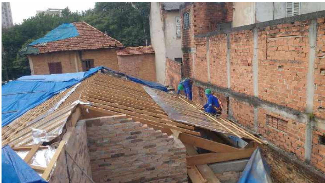
Foto 01: Instalação de manta aluminizada e contra ripa.
