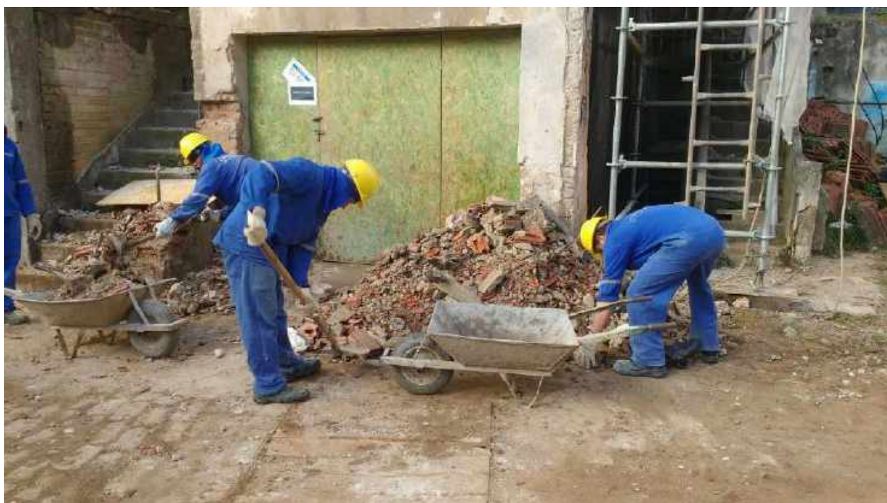
Foto 40: Demolição das alvenarias para adequação do novo uso.
