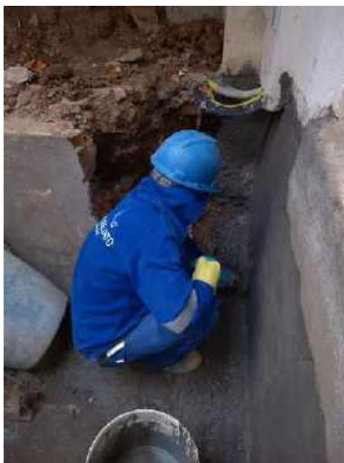
Foto 48 – Impermeabilização da alvenaria existente – Casa 06
