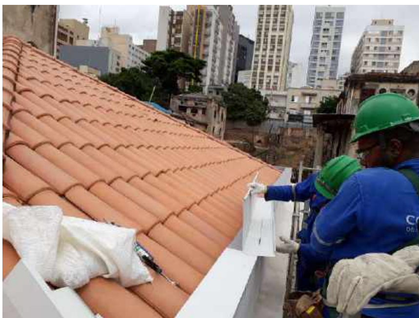
Foto 12 – Instalação dos rufos da cobertura – Casa 06
