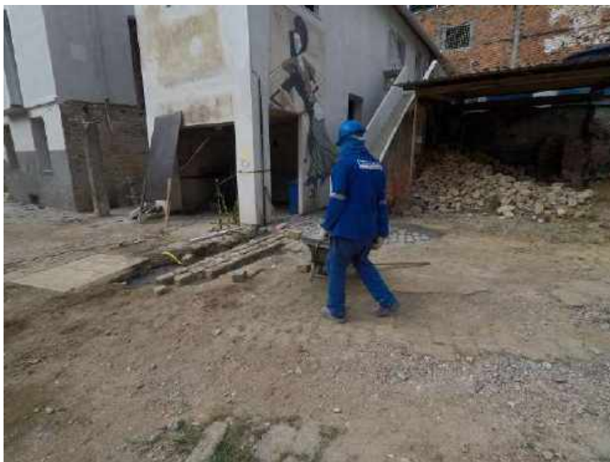
Foto 11 – Instalação do paralelepípedo – Casa 05
