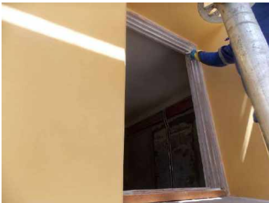
Foto 23 – Aplicação de massa para madeira nos batentes – Casa 06
