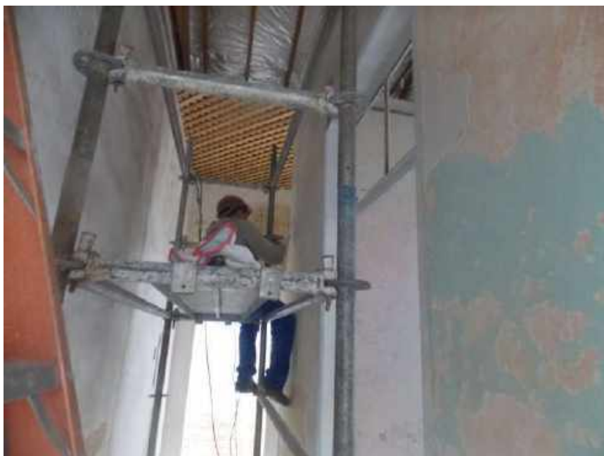
Foto 14 – Decapagem mecânica das paredes internas – Casa 06
