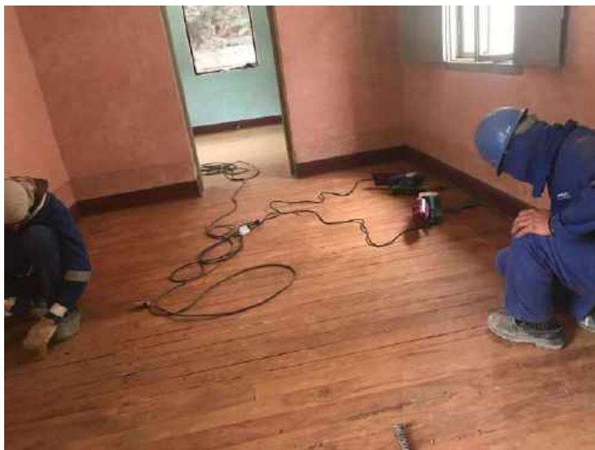
Foto 03 – Recuperação dos assoalhos de madeira – Casa 05
