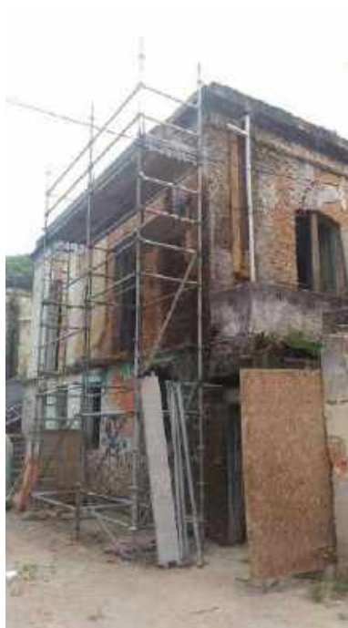
Foto 10: Desmontagem cuidadosa da alvenaria com reaproveitamento de tijolos – Casa 6..
