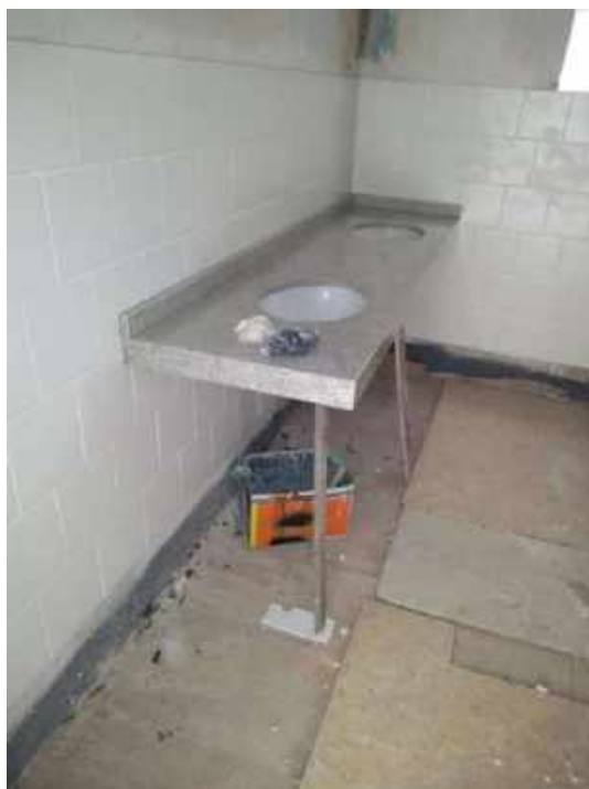
Foto 63 – Instalação das bancadas dos banheiros da Casa 6
