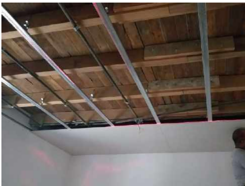
Foto 12 - Instalação do forro de Drywall – casas 7
