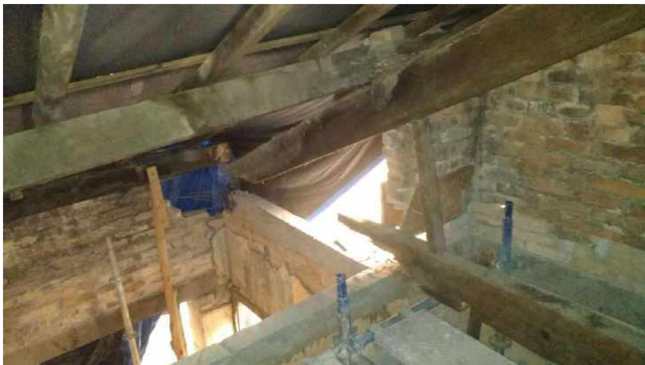
Foto 39: Substituição das peças danificadas da tesoura da Casa 6.
