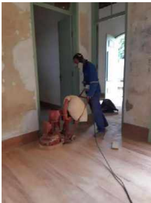
Foto 11 – Lixamento do assoalho de madeira – Casa 06
