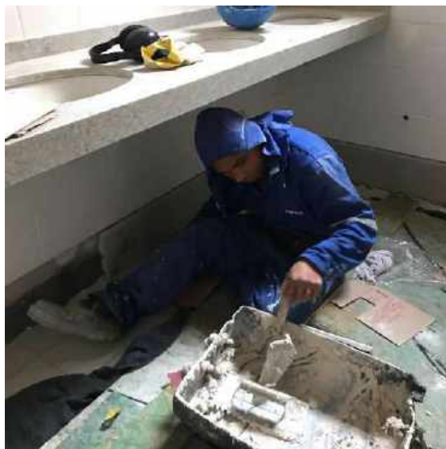
Foto 31 – Instalação dos rodapés hidráulicos – Casa 06
