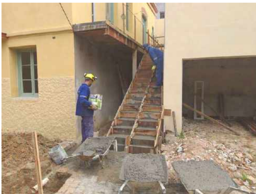
Foto 11 – Concretagem da escada da escada da fachada lateral
