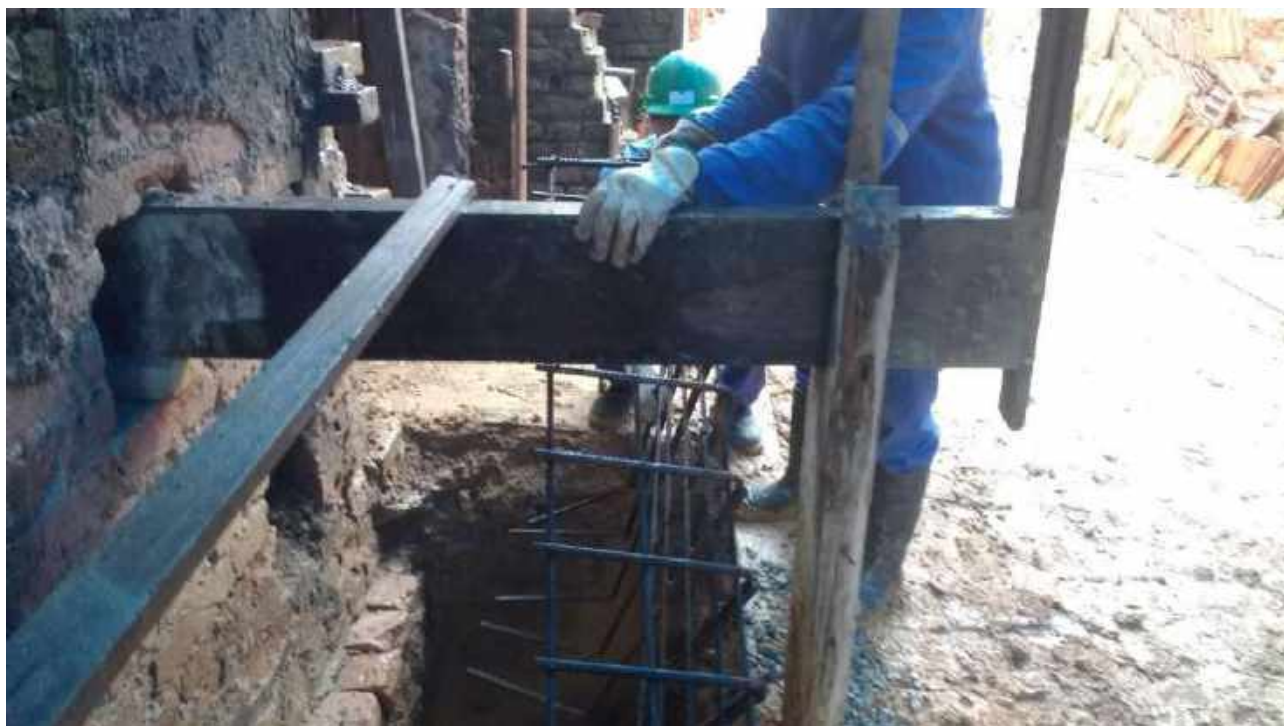
Foto 11: Execução de bloco de reforço – Casa 06.
