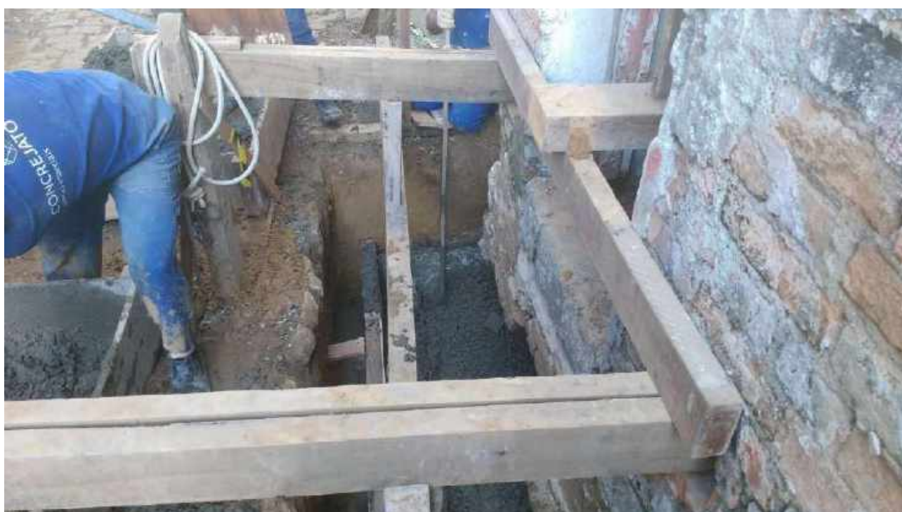
Foto 28: Execução do bloco de fundação.
