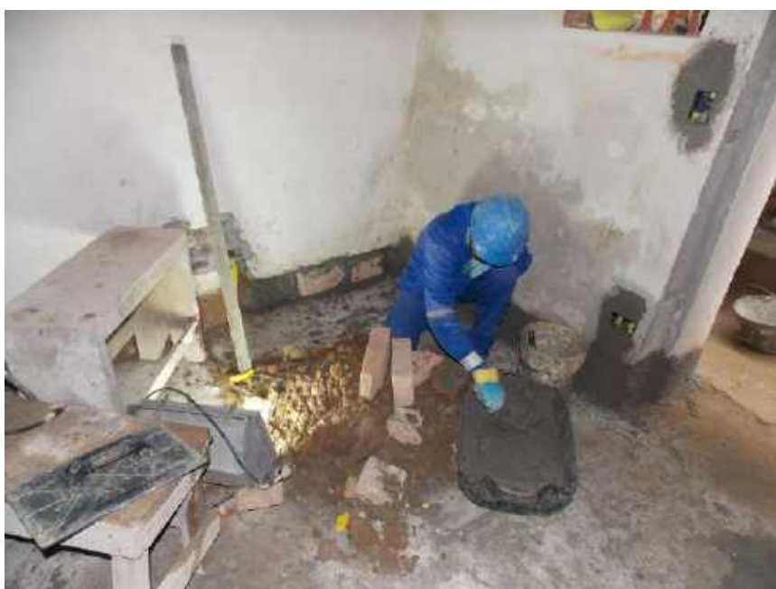
Foto 61 – Ajustes de alvenaria – Casa 06
