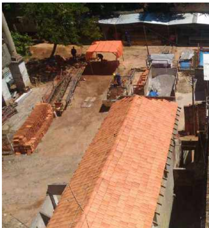
Foto 07: Instalação das telhas da Casa 5.
