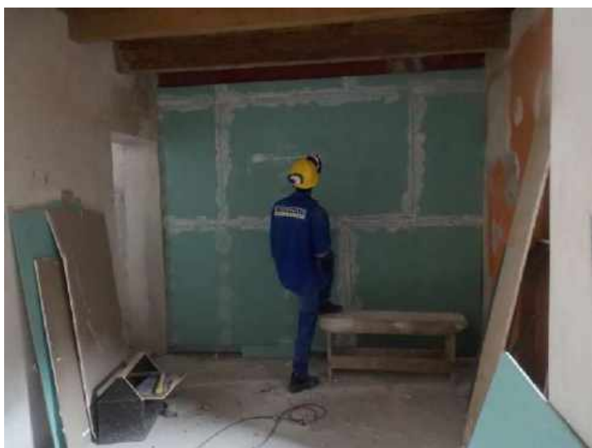
Foto 18 – Instalação do drywall – Casa 05
