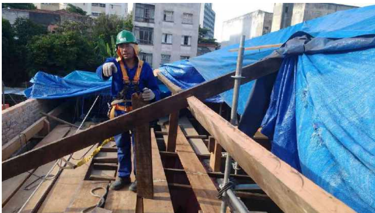
Foto 18: Instalação das terças.
