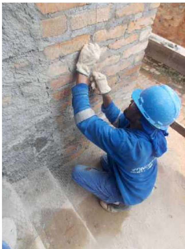
Foto 50 – Execução do acabamento da alvenaria nova – Casa 06
