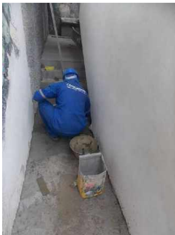
Foto 08 – Execução do piso cimentado – Casa 05
