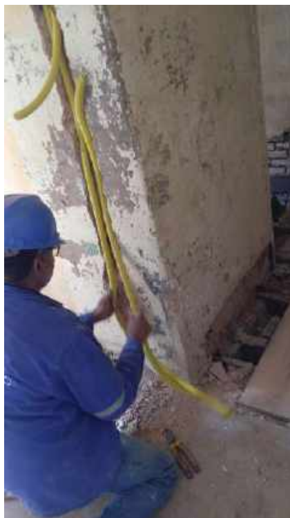
Foto 21 – Instalação dos Conduites
