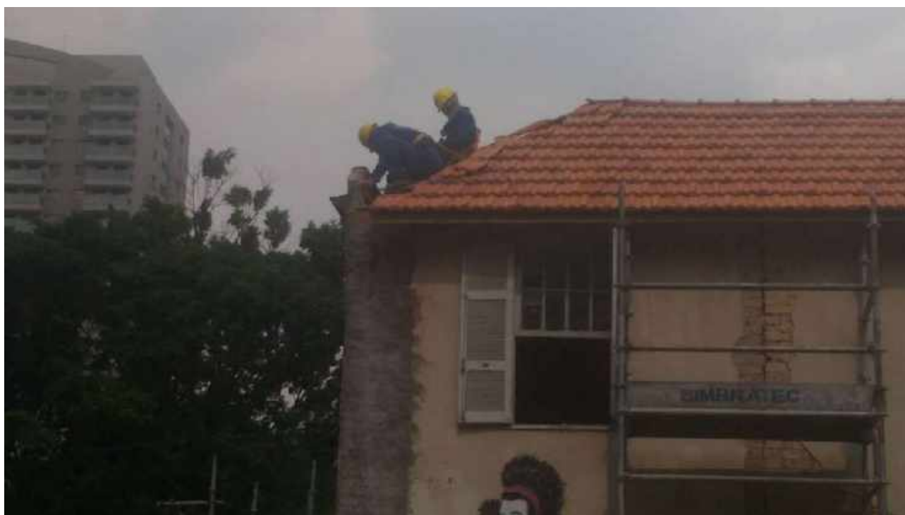
Foto 24: Instalação das calhas e rufos da Casa 5.
