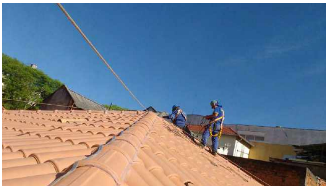
Foto 44 Instalação das Fitas de SPDA na Cobertura da casa 06
