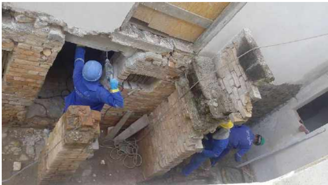
Foto 23 – Demolição manual – Casa 06
