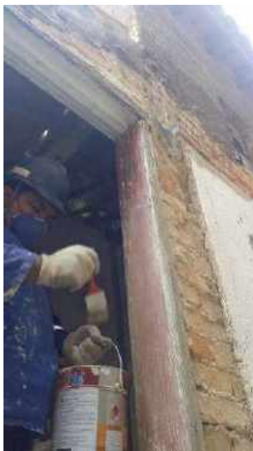
Foto 23 – Decapagem química dos batentes
