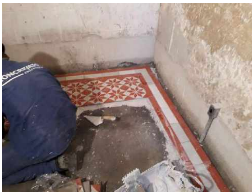
Foto 17 – Instalação dos ladrilhos hidráulicos – Casa 06
