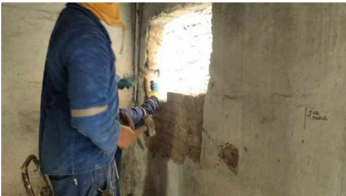
Foto 41 – Abertura do vão da janela – Casa 06
