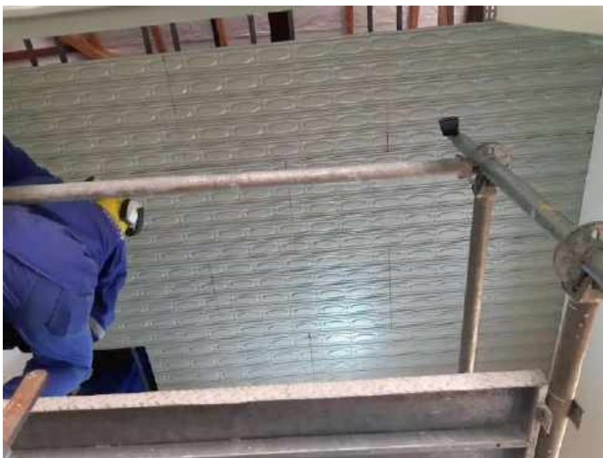
Foto 16 – Instalação do forro metálico – Casa 06
