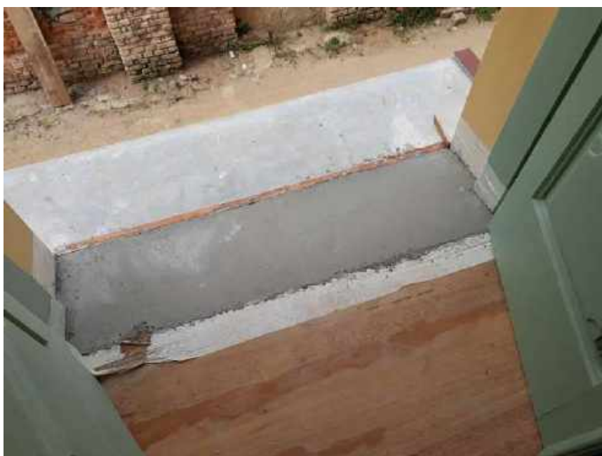
Foto 35 – Execução da soleira de granilite– – Casa 06
