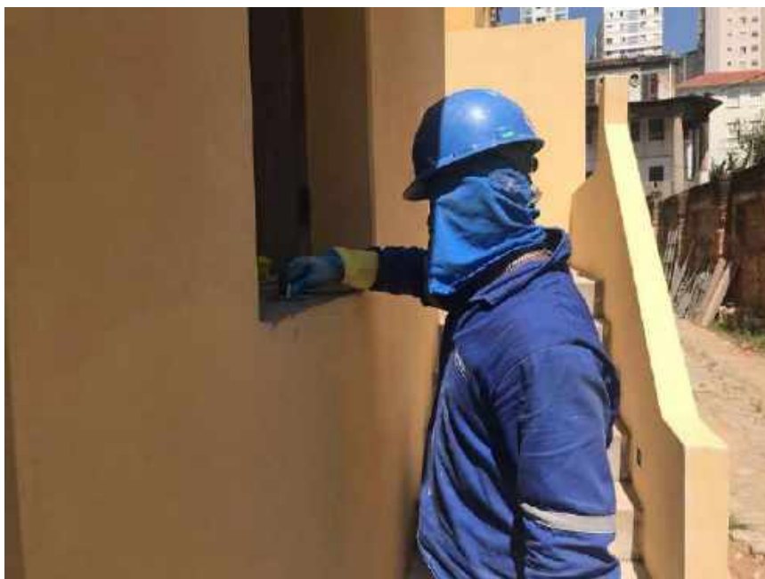
Foto 21 – Execução da argamassa de acabamento do beiral das janelas – Casa 06
