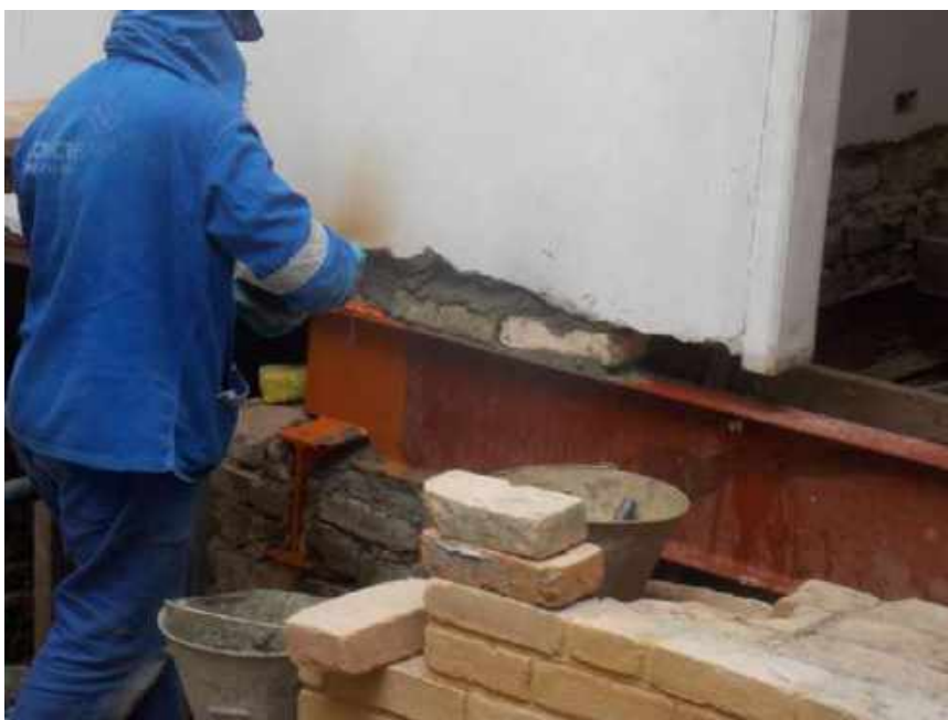
Foto 46 – Instalação do perfil metálico – Casa 06
