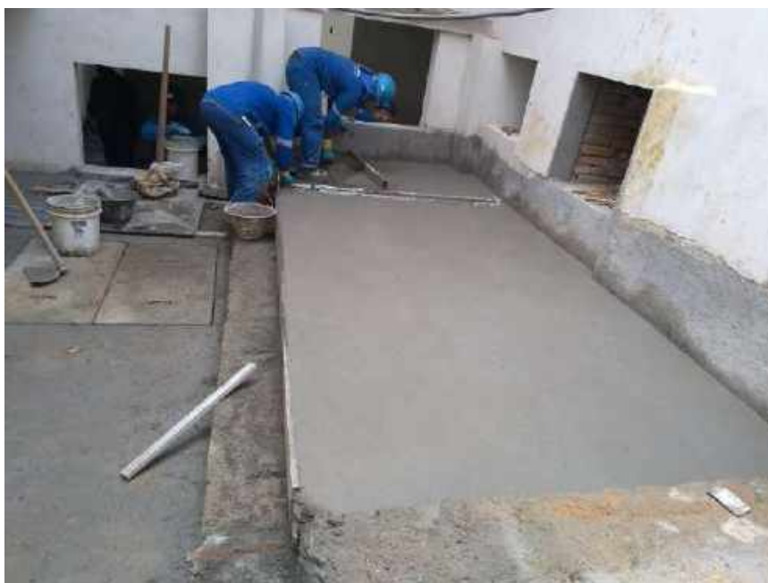
Foto 69 – Execução do piso cimentado – Casa 06
