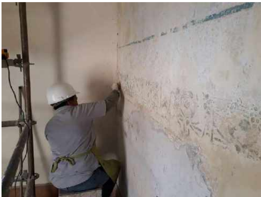
Foto 28 – Decapagem manual cuidadosa das paredes internas – Casa 06
