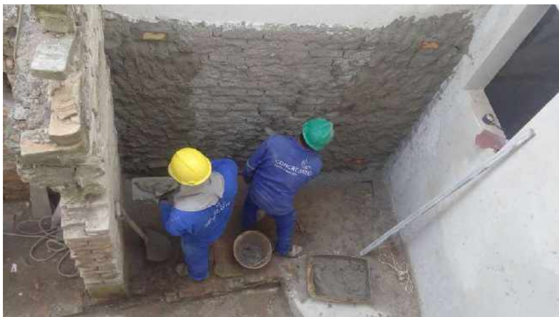
Foto 21 – Execução do chapisco da fachada lateral – Casa 06
