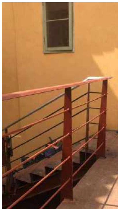
Foto 23 - Instalação do guarda corpo – Casa 06
