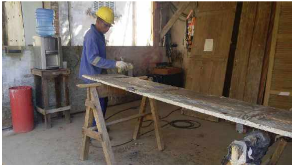
Foto 04 – Decapagem das portas – Casa 06
