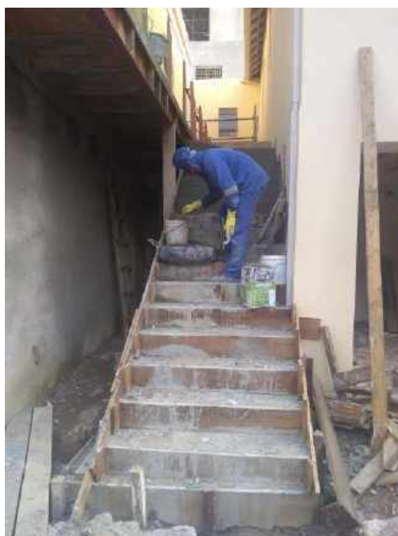
Foto 12 – Execução da argamassa de acabamento dos degraus da escada da fachada lateral
