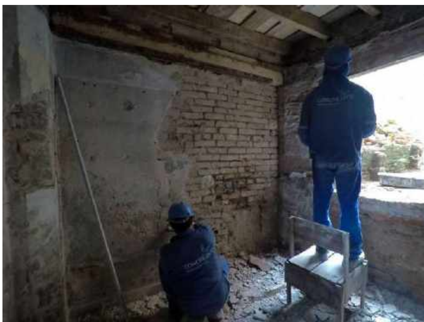
Foto 36 – Remoção do revestimento
