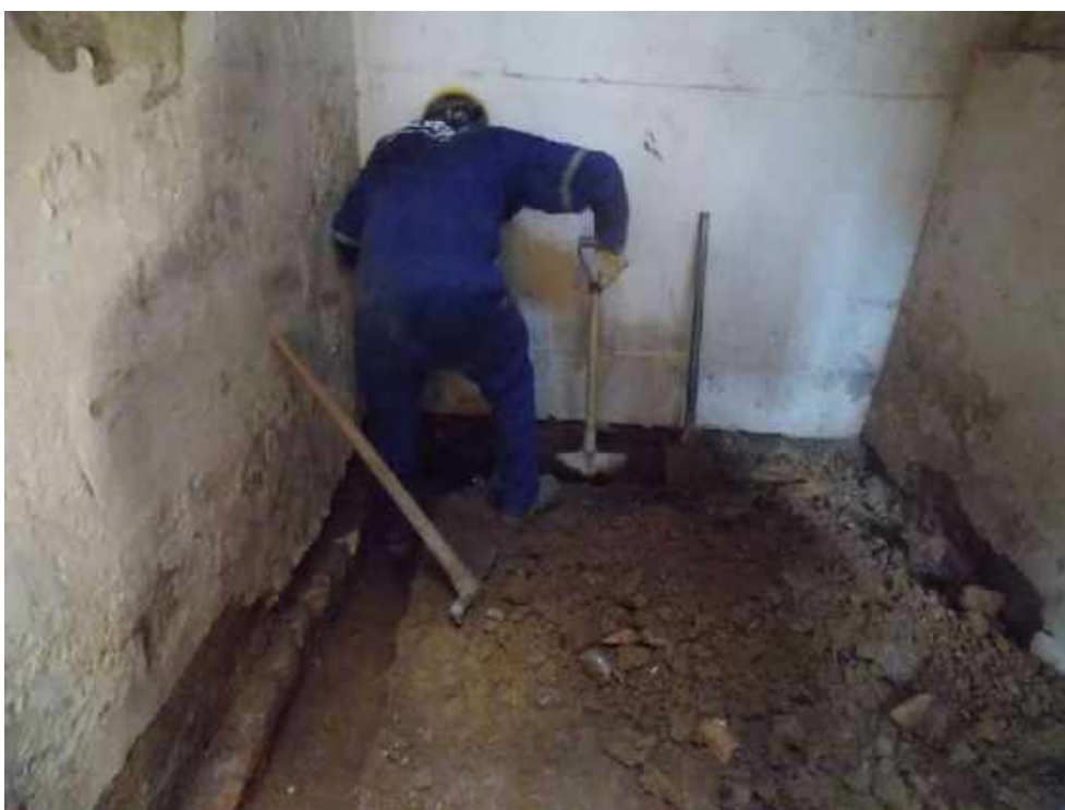
Foto 40 – Escavação manual para execução da drenagem do solo – Casa 06
