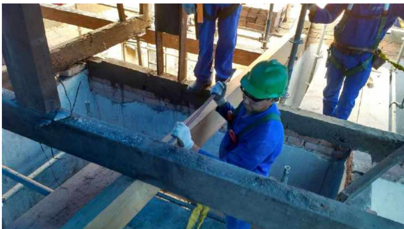
Foto 22: Substituição das peças danificadas da tesoura da Casa 6.
