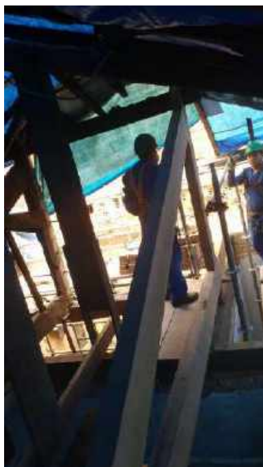
Foto 05: Substituição das peças danificadas da tesoura da Casa 6.
