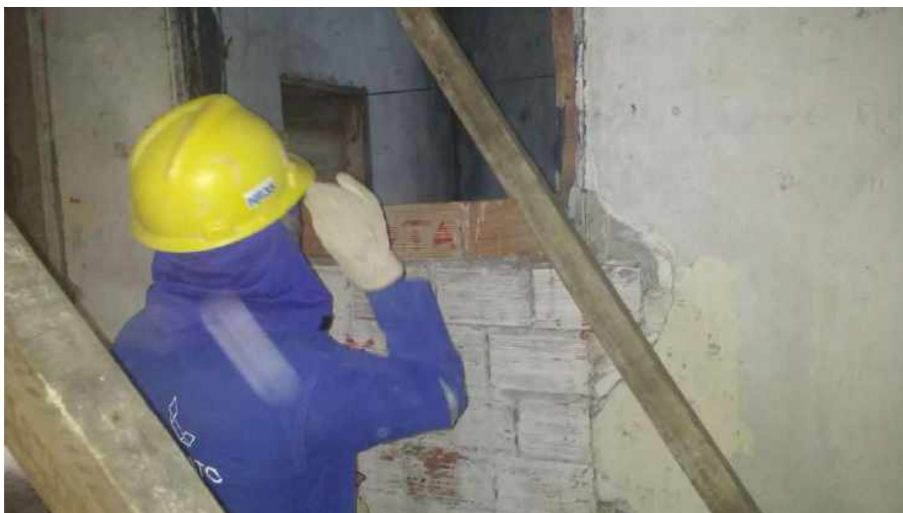
Foto 22: Abertura dos vãos de portas e janelas que foram fechados ao longo do tempo – Casa 6.
