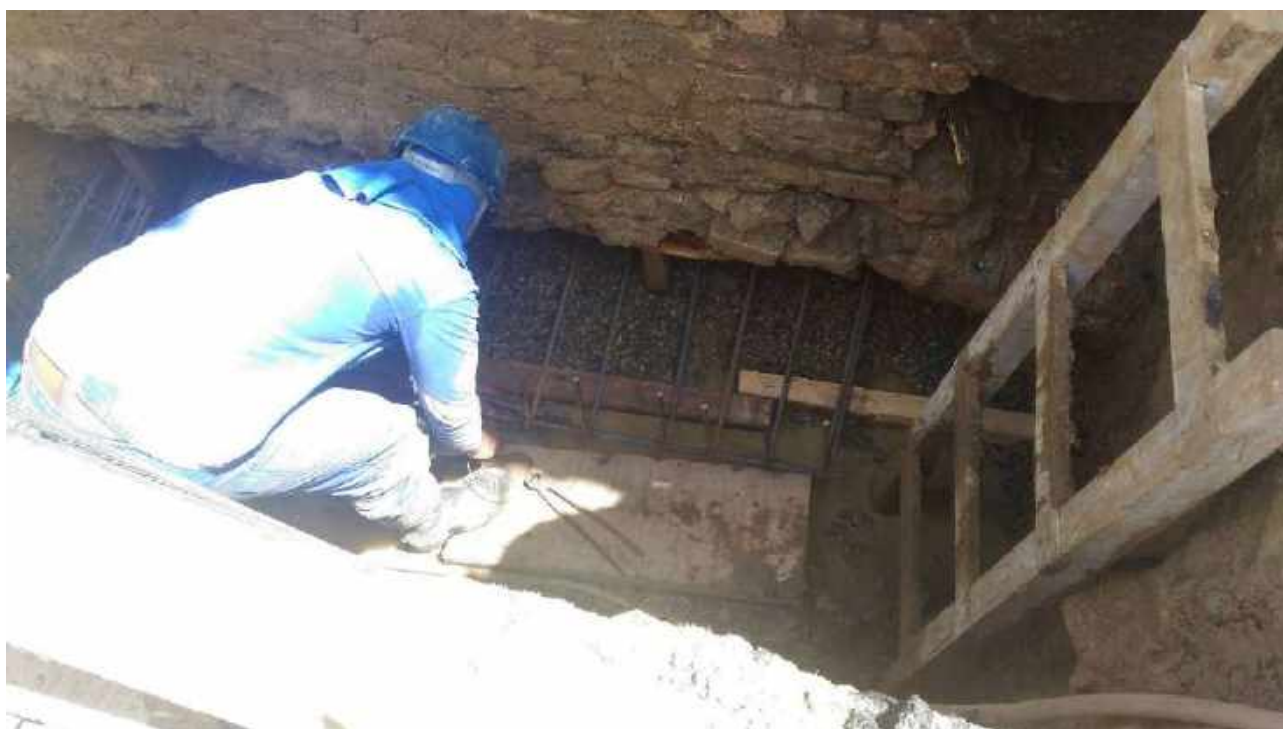
Foto 12: Armação dos blocos de fundação.
