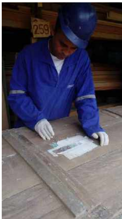
Foto 27 – Prospecção das portas e janelas – Casa 06
