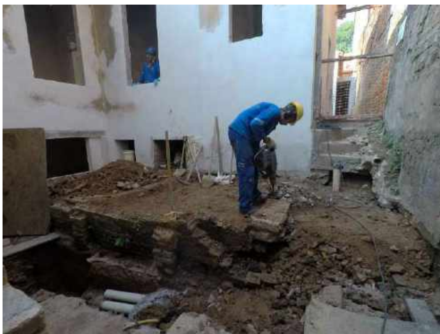
Foto 37 – Escavação mecânica – Casa 06
