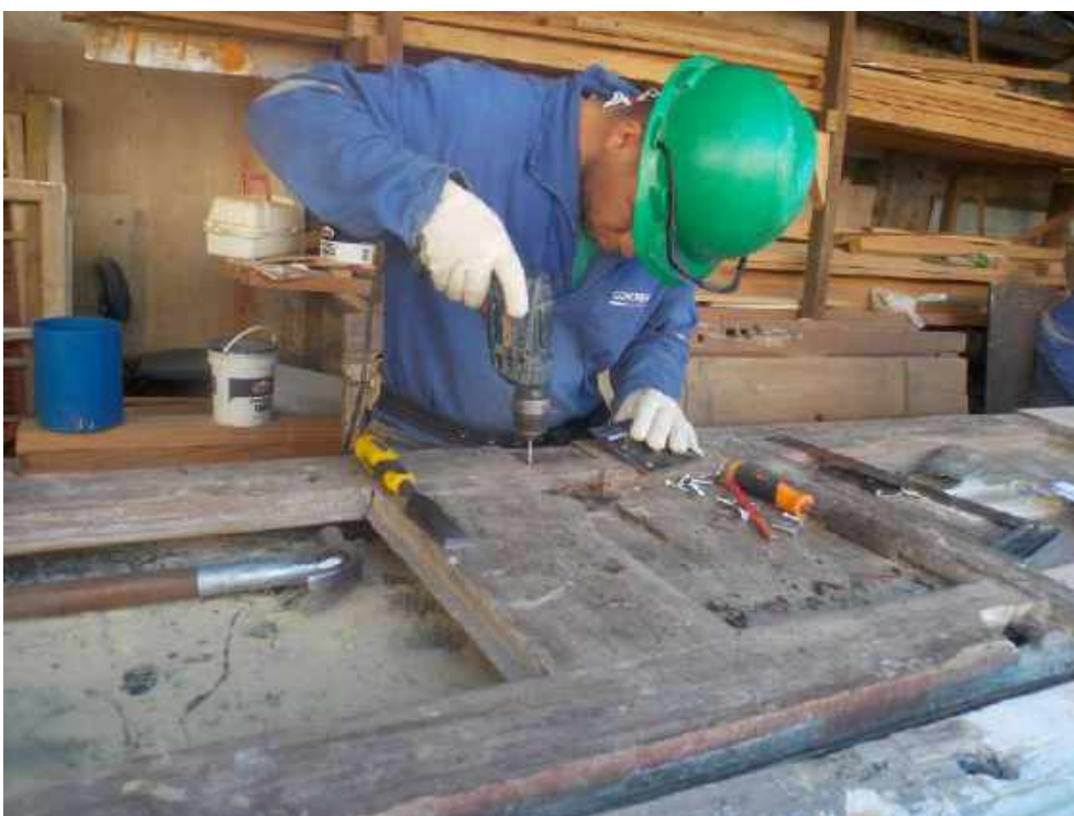
Foto 24 – Restauração das portas de madeira – Casa 06
