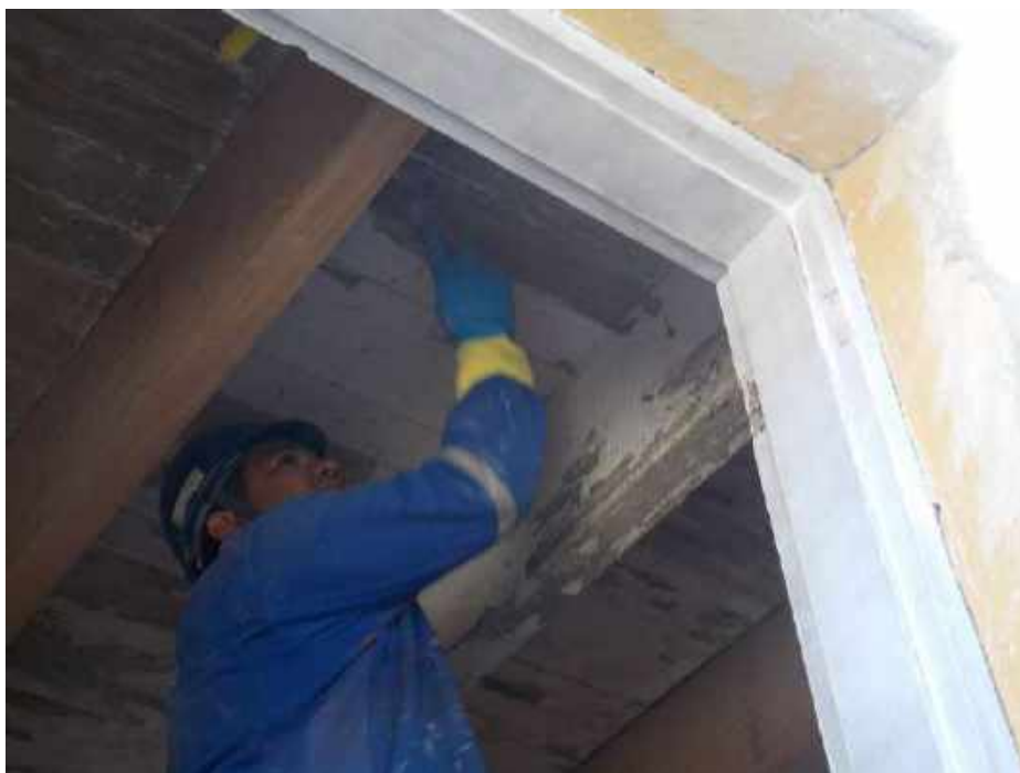
Foto 05 – Decapagem dos forros de madeira – Casa 05
