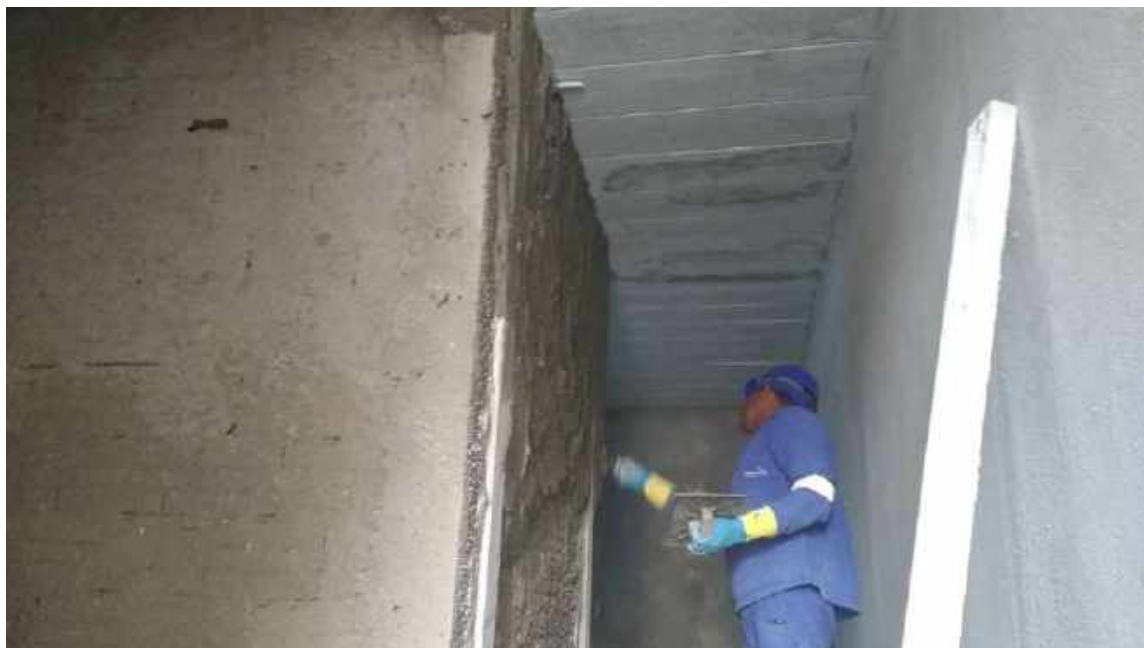
Foto 13 – Execução do emboço – Casa 06
