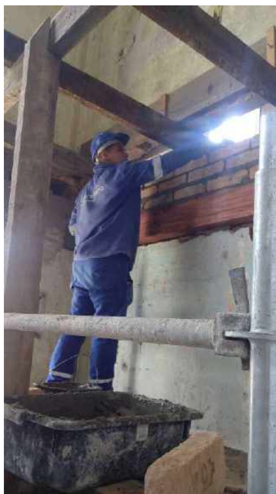
Foto 24 – Execução da alvenaria (recuperação da parede) - Casa 06
