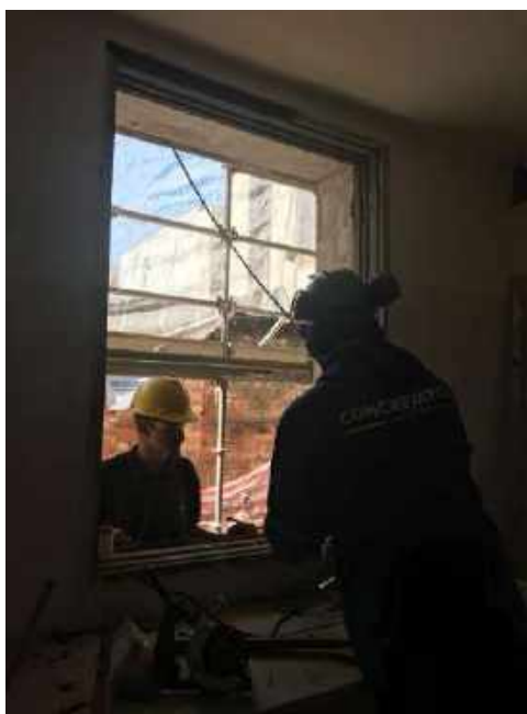
Foto 22 – Instalação dos batentes de madeira – Casa 06
