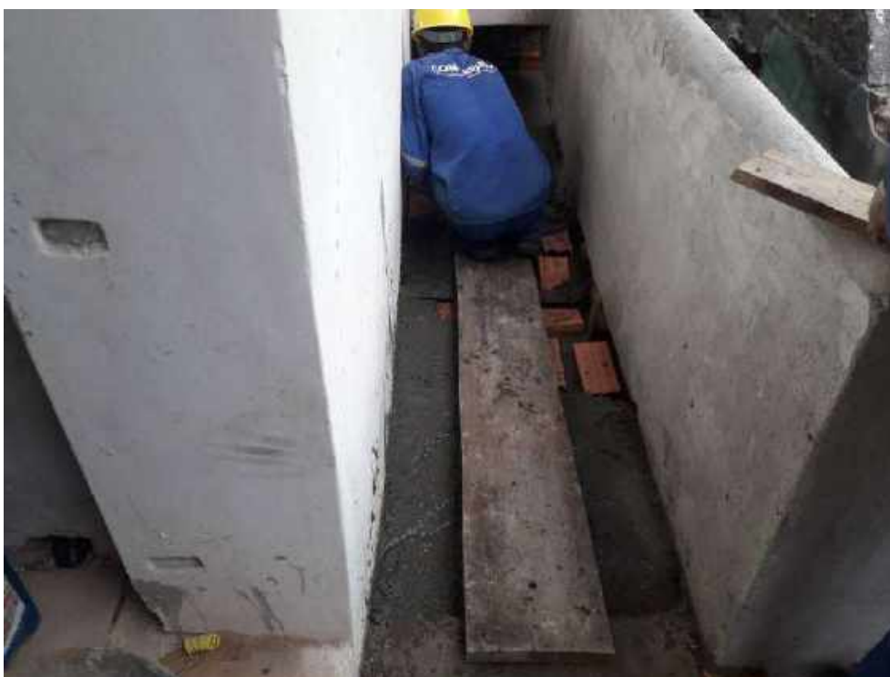
Foto 12 – Execução da nova laje da varanda – Casa 05
