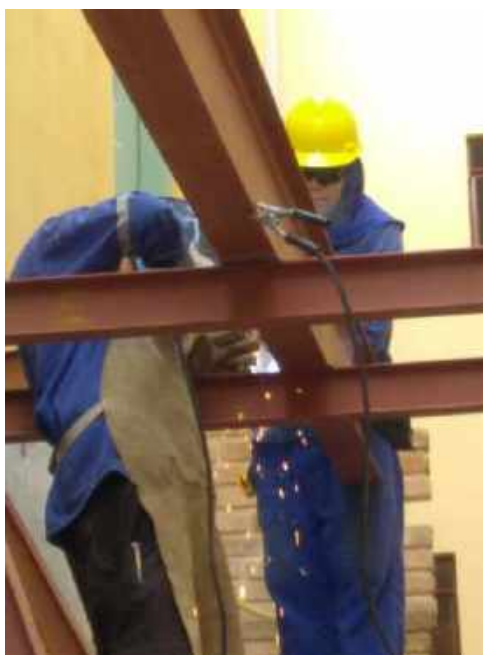
Foto 06 – Instalação dos ferros metálicos para execução da escada de alvenaria – Casa 06
