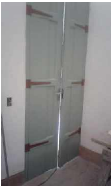
Foto 28 – Instalação das fechaduras nas portas de madeira – Casa 06
