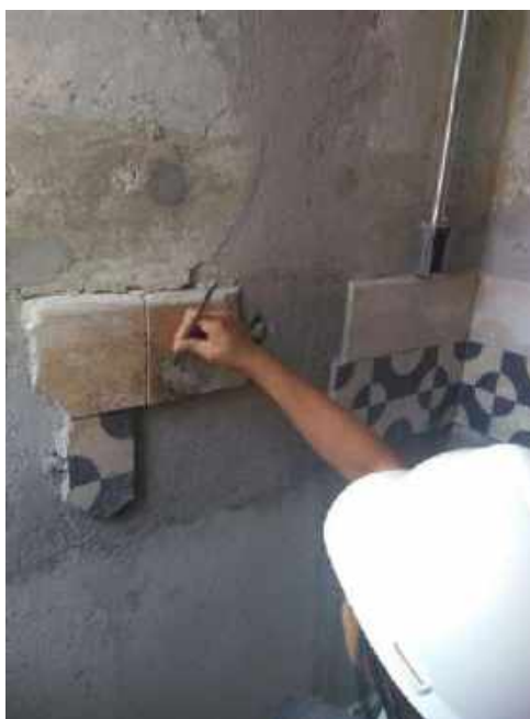
Foto 18 - Remoção de resíduo dos ladrilhos hidráulicos – Casa 06
