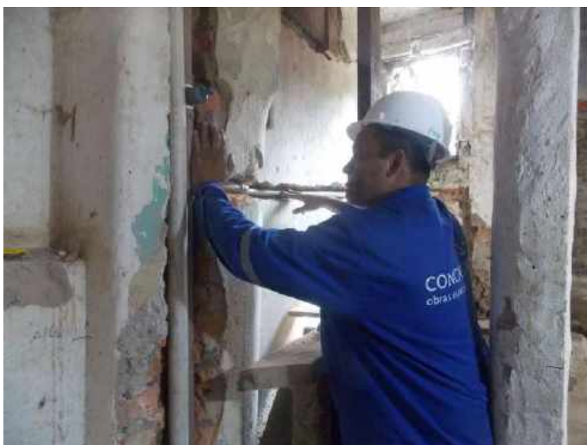
Foto 15 – Instalação da tubulação hidráulica – Casa 06
