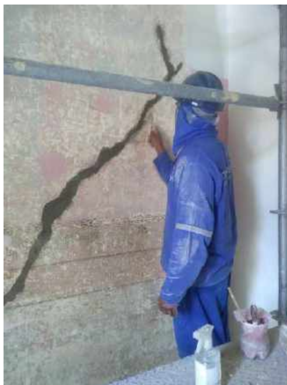
Foto 02 – Tratamento das fissuras nas alvenarias – Casa 06
