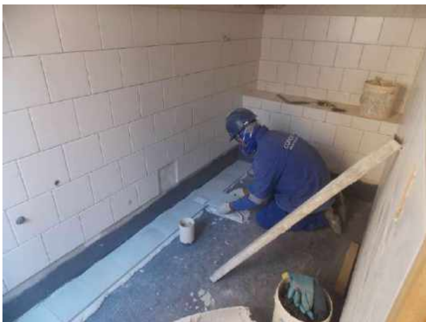
Foto 63 – Instalação dos pisos dos banheiros – Casa 06
