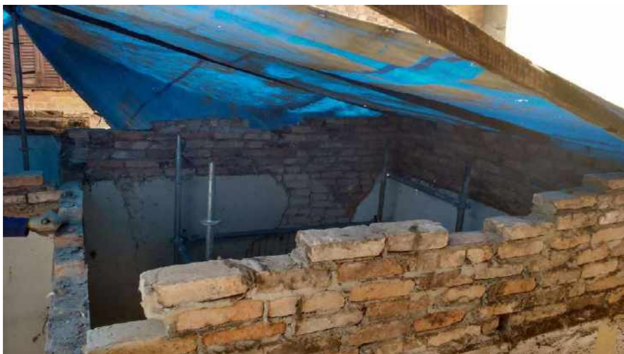
Foto 52: Substituição das peças danificadas da tesoura da Casa 6.
