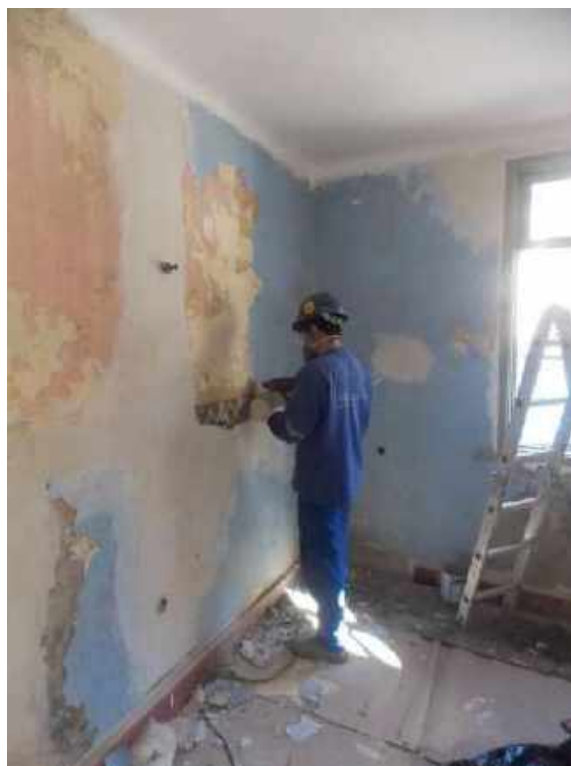
Foto 10 – Decapagem mecânica – Casa 05
