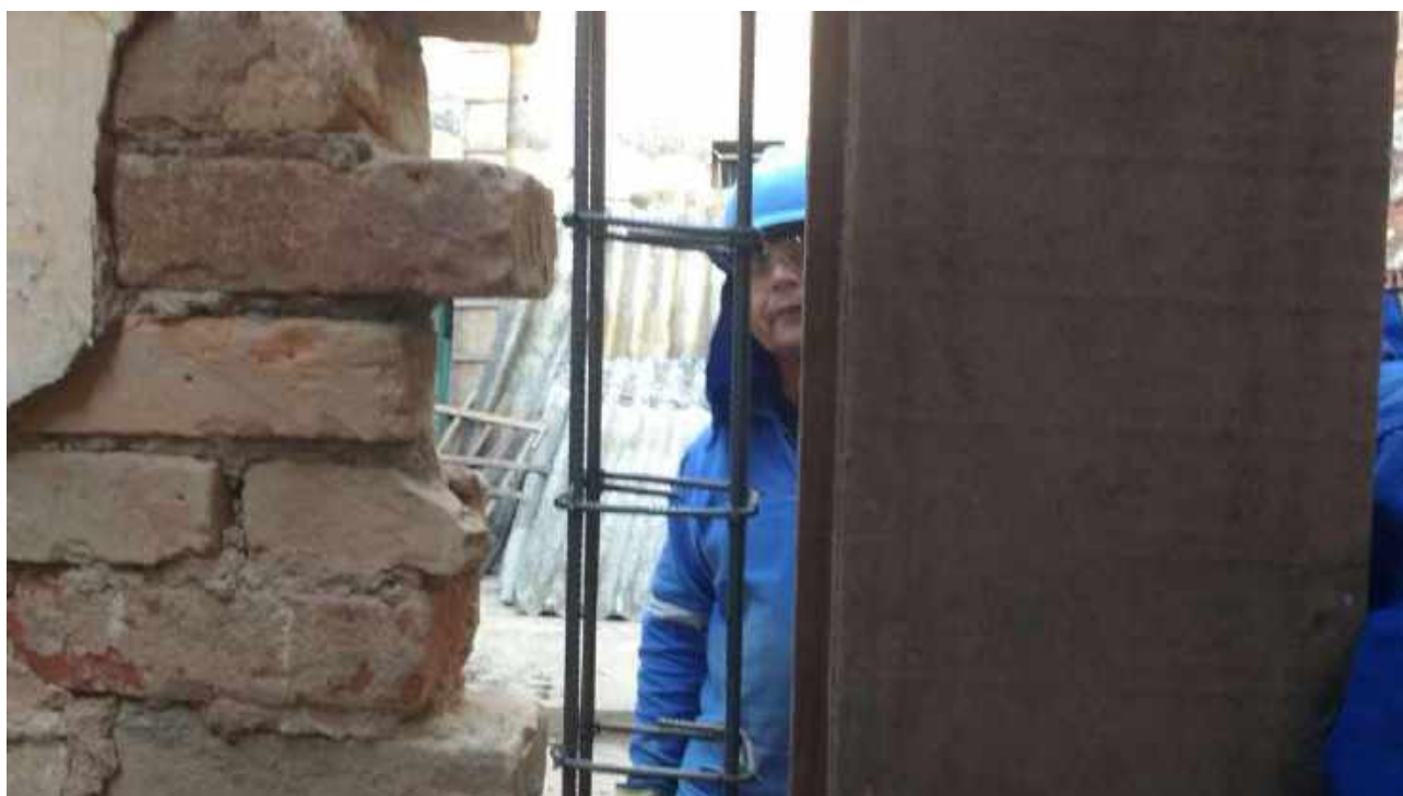
Foto 54: Execução de reforço nas alvenarias.
