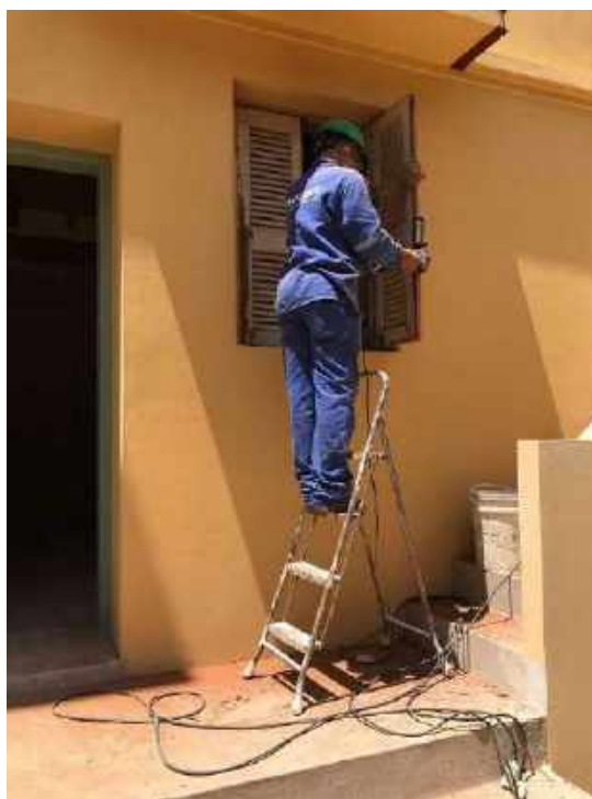
Foto 26 – Instalação das venezianas de madeira – Casa 06
