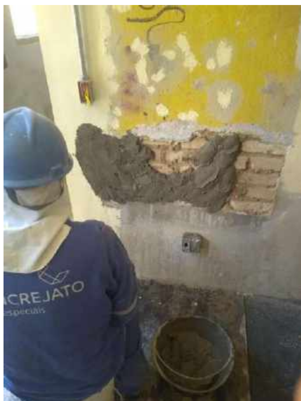
Foto 08 – Execução do emboço das paredes internas – Casa 06
