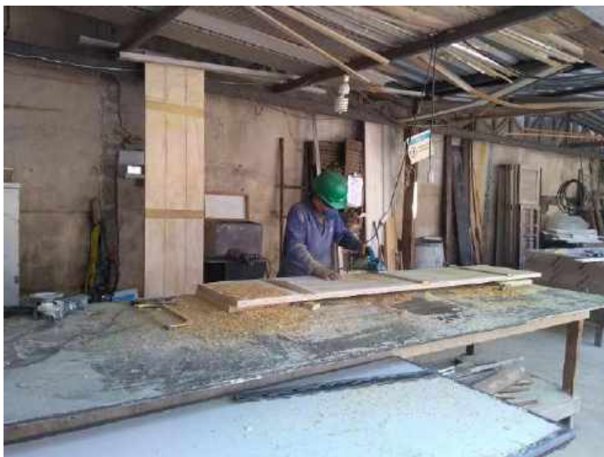
Foto 18 – Execução das portas de madeira
