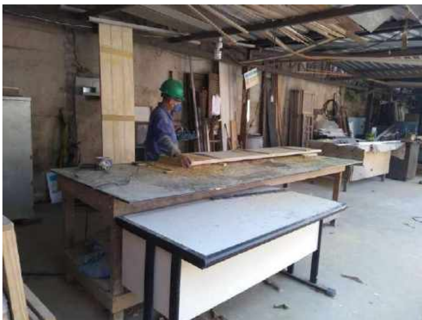
Foto 19 – Execução das portas de madeira
