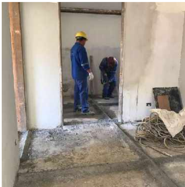
Foto 54- Instalação da junta de dilatação – Casa 06
