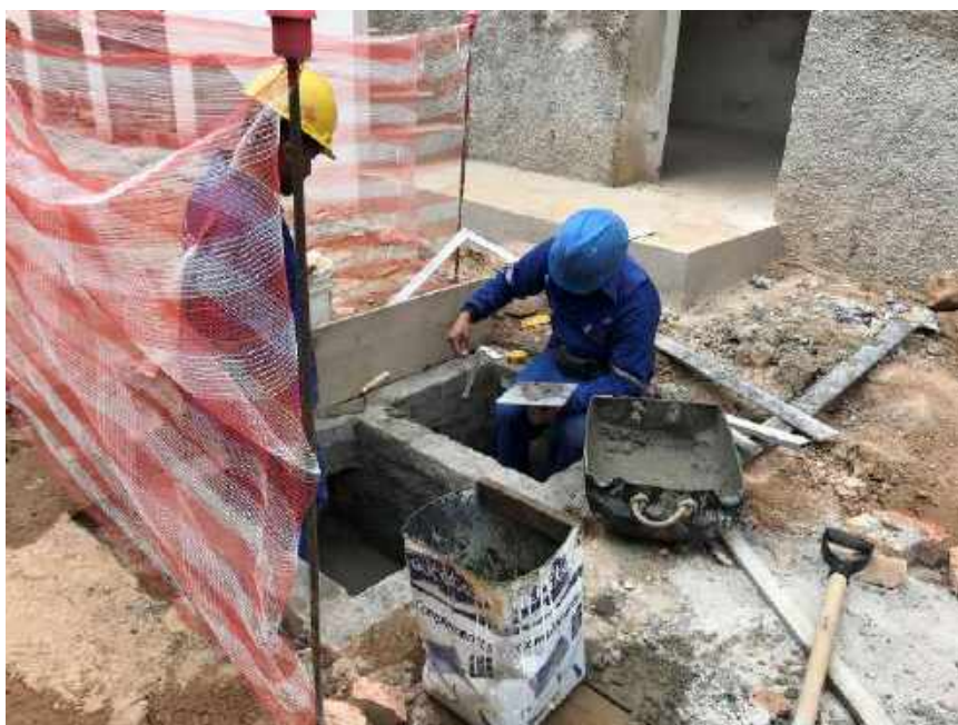
Foto 65 – Execução da caixa para passagem do esgoto e águas pluviais
