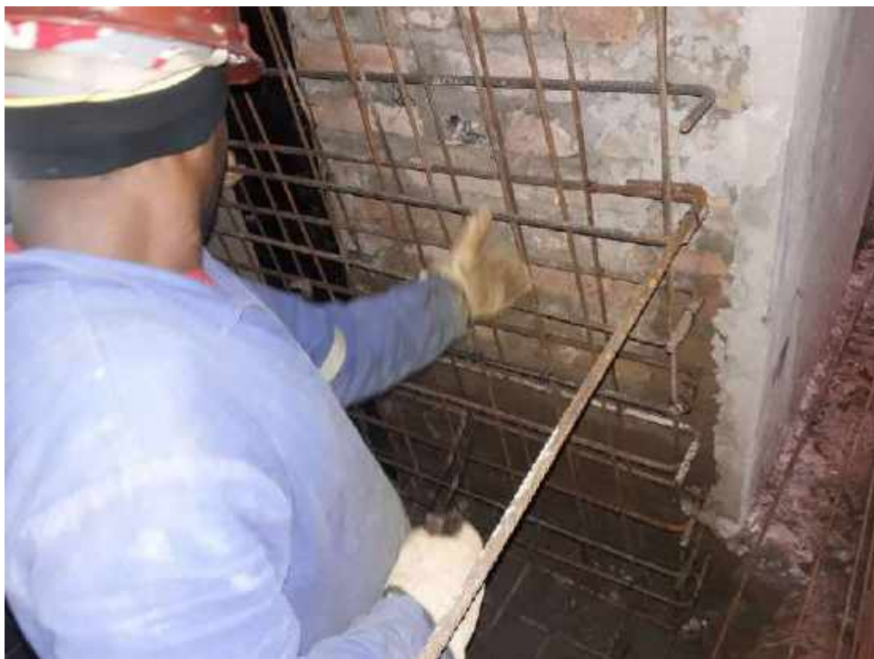
Foto 57 – Execução da armação da forma – Casa 06
