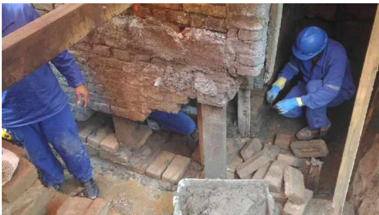
Foto 04: Remontagem da alvenaria de embasamento da Casa 6.
