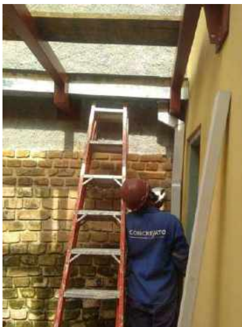
Foto 05 – Instalação das descidas de água – Casa 06
