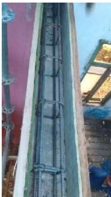
Foto 04: Fôrma e armação para cinta de concreto – Casa 6
