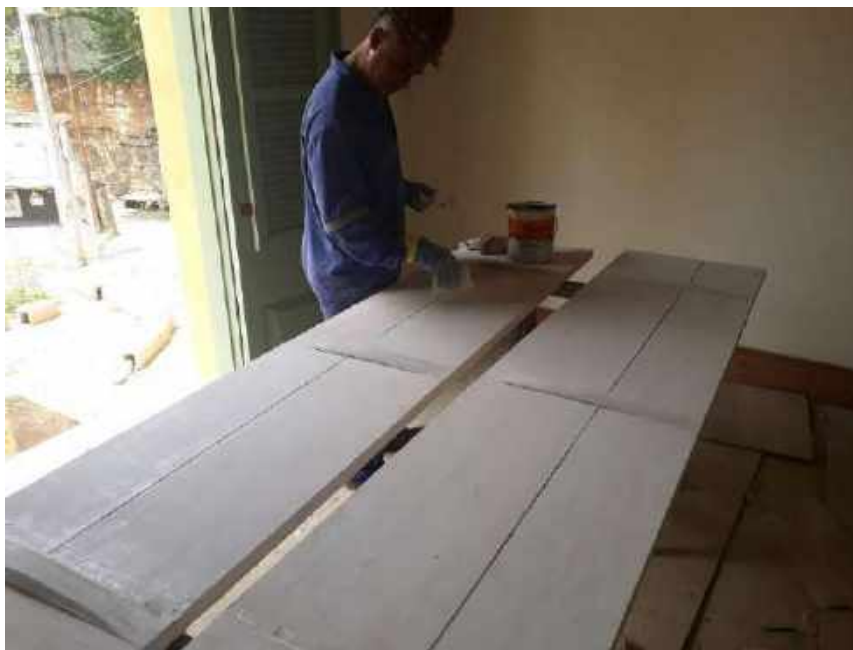
Foto 05 – Aplicação de massa para madeira nas portas – Casa 06
