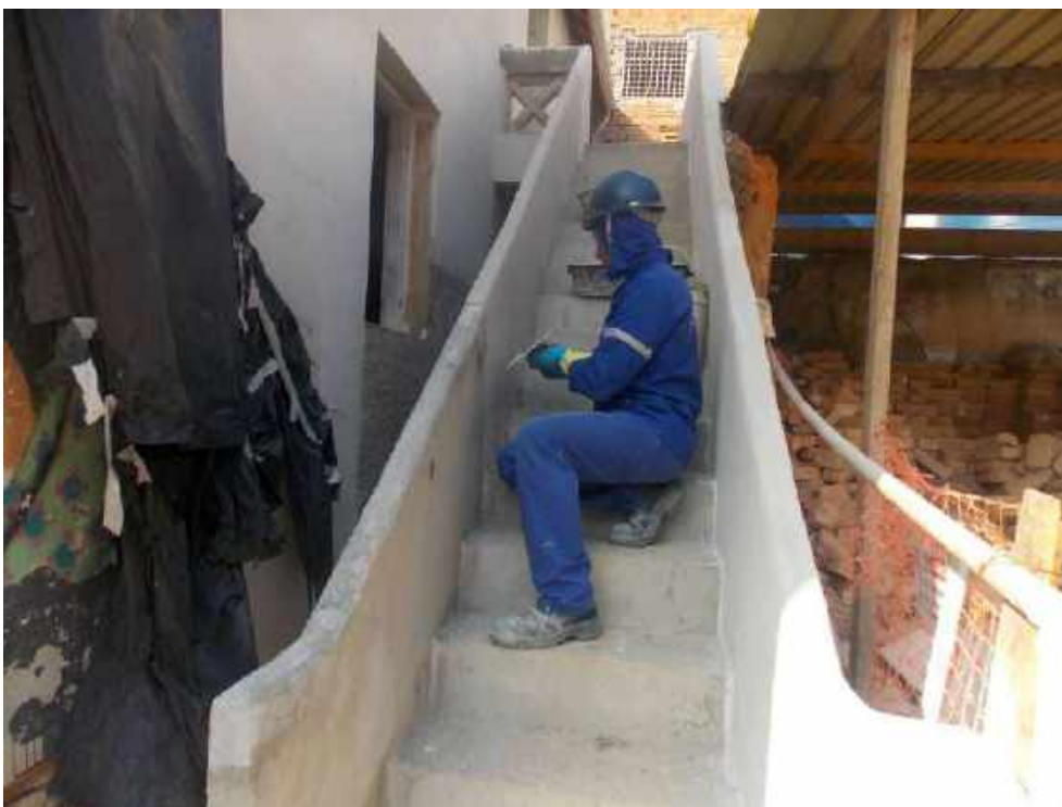
Foto 16 – Execução da argamassa de acabamento das escadas – Casa 05
