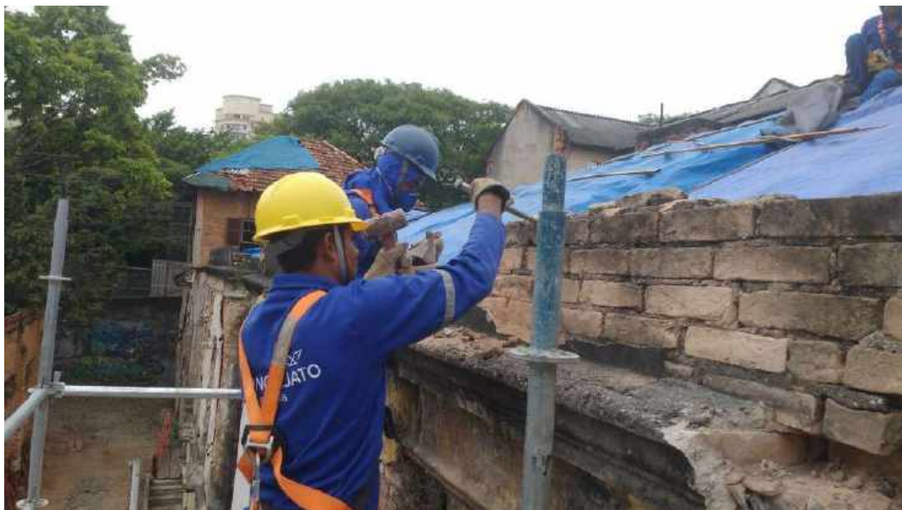
Foto 23: : Desmontagem cuidadosa da alvenaria com reaproveitamento de tijolos – Casa 6.
