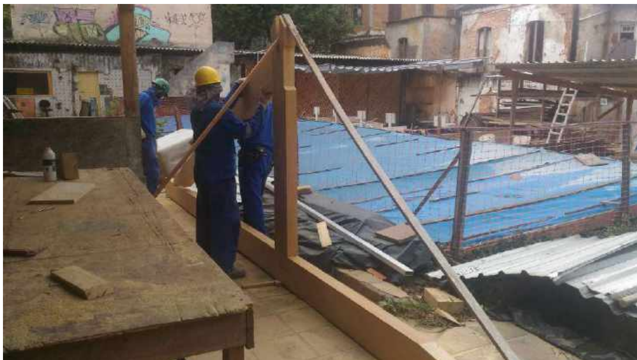
Foto 09: Execução das tesouras em madeira.
