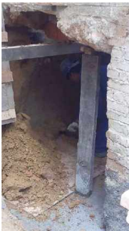
Foto 25 – Escavação manual – Casa 06
