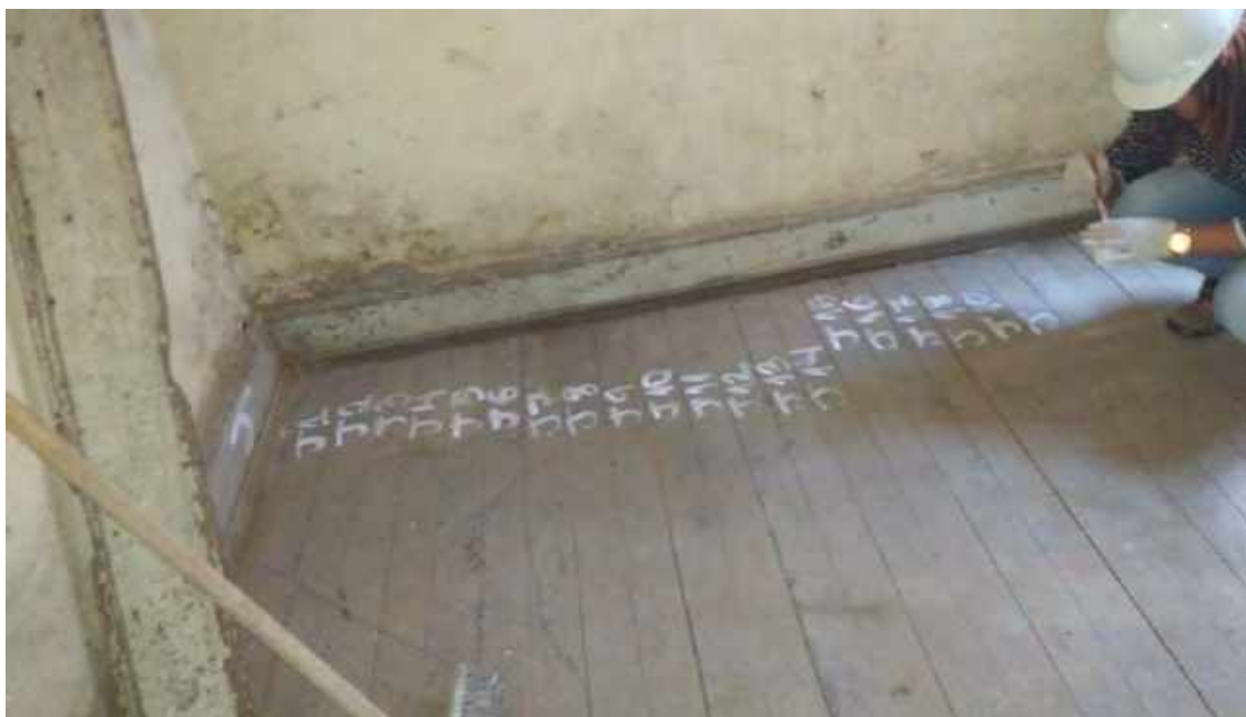
Foto 31 - Mapeamento dos tacos de madeira da casa 06
