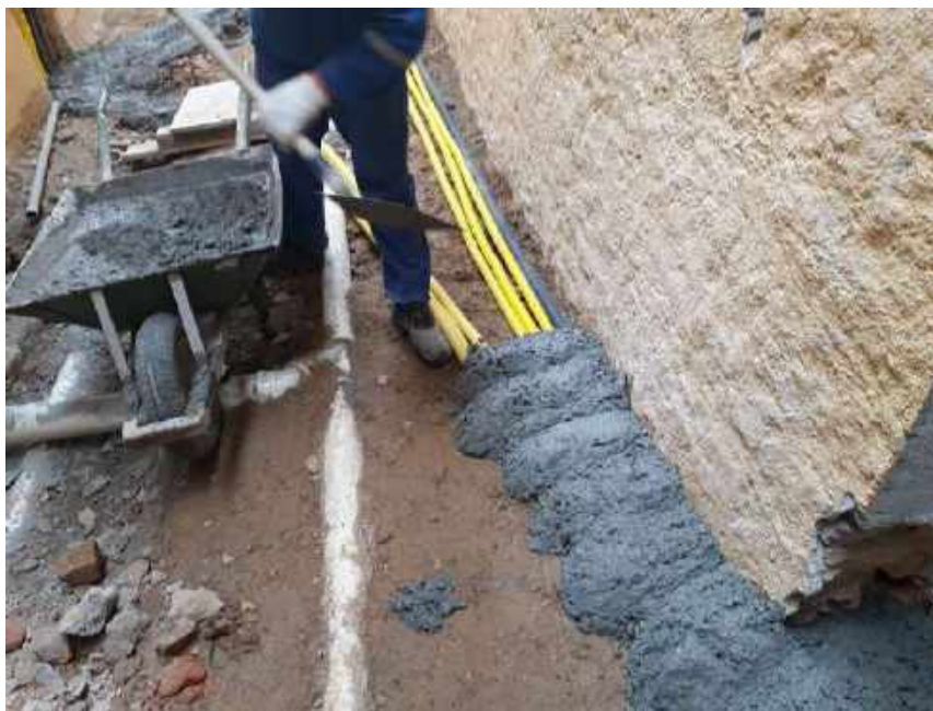
Foto 38 – Concretagem das tubulações expostas – Casa 06
