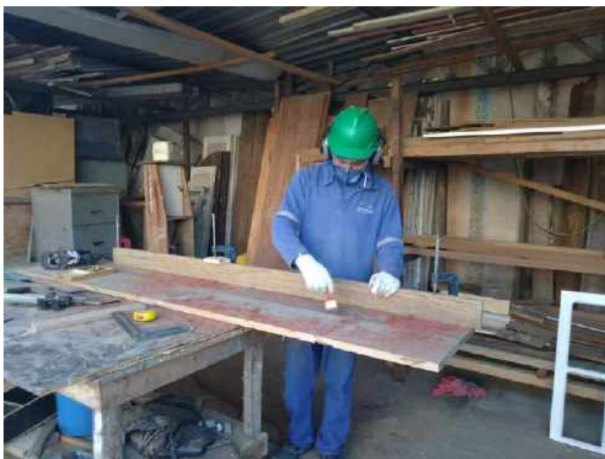
Foto 21 – Restauração das portas de madeira – Casa 06
