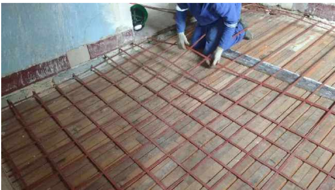
Foto 08 – Instalação da armação para concretagem – Casa 05
