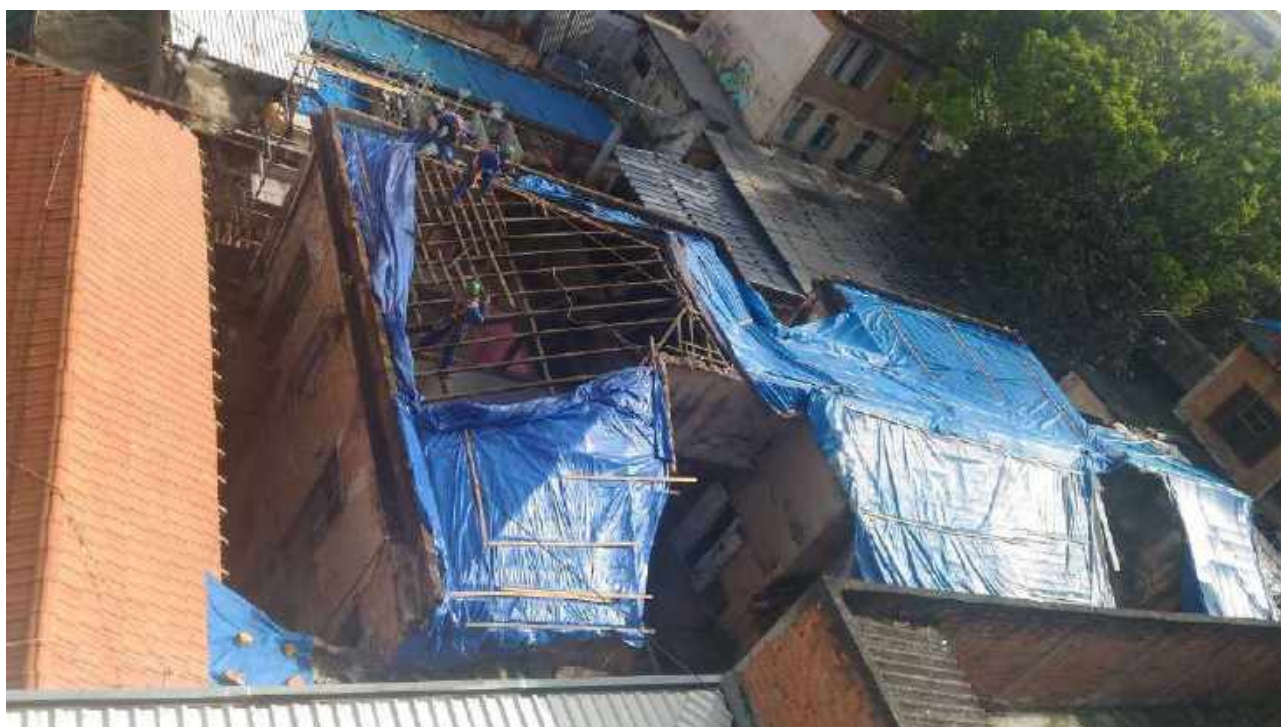
Foto 06: Remoção das ripas de madeira da Casa 6.
