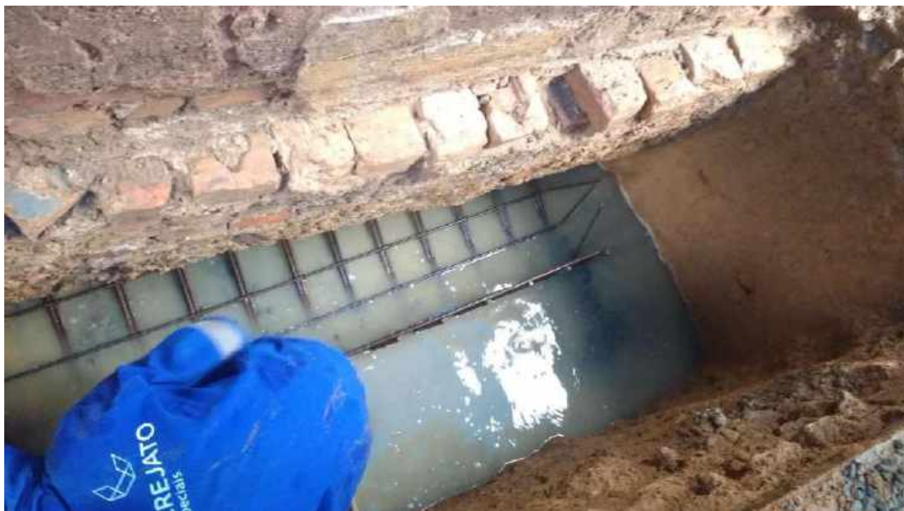
Foto 13: Execução de bloco de reforço – Casa 06.
