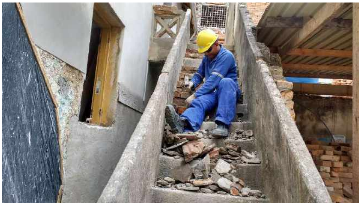
Foto 18 – Regularização da escada – Casa 05
