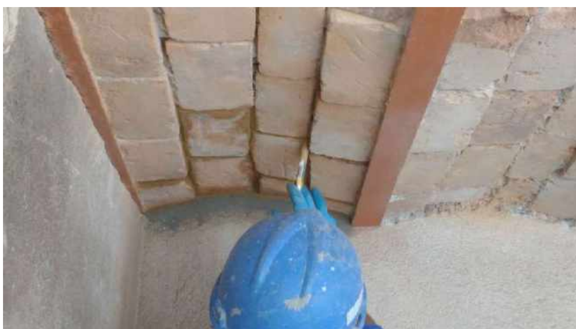
Foto 14 – Restauração dos tijolos da abobadilha – Casa 05
