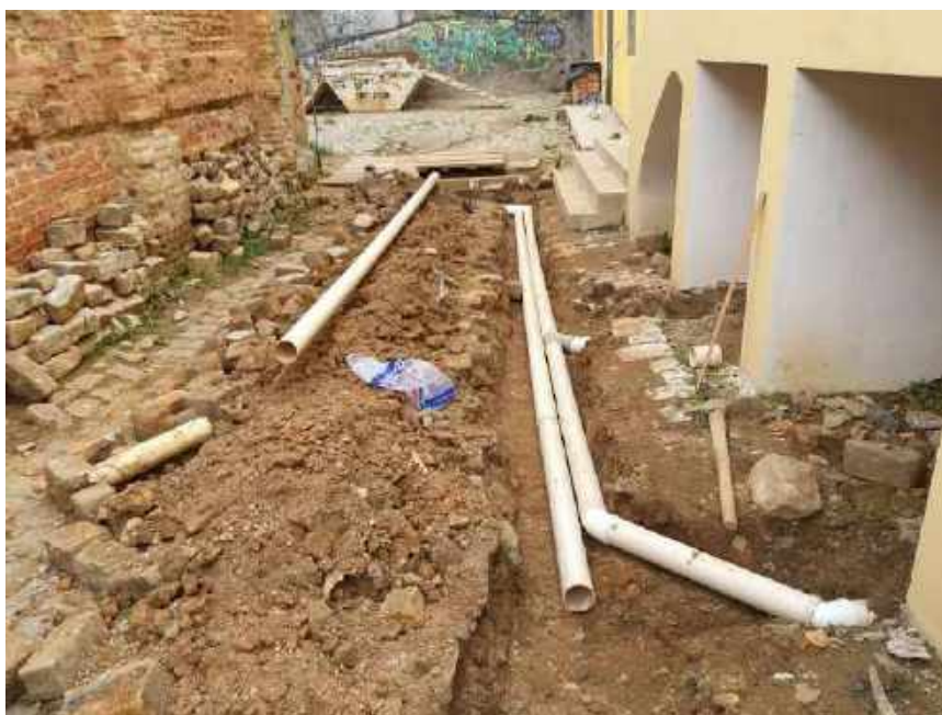
Foto 11 - Instalação da tubulação para caixa de passagem
