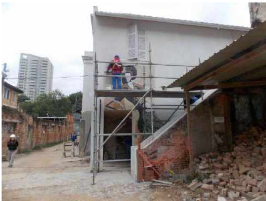
Foto 09 – Execução da argamassa de acabamento na fachada lateral – Casa 05
