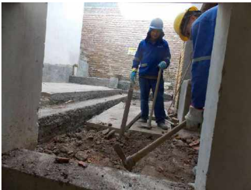
Foto 46 – Escavação manual para tratamento da alvenaria existente – Casa 06
