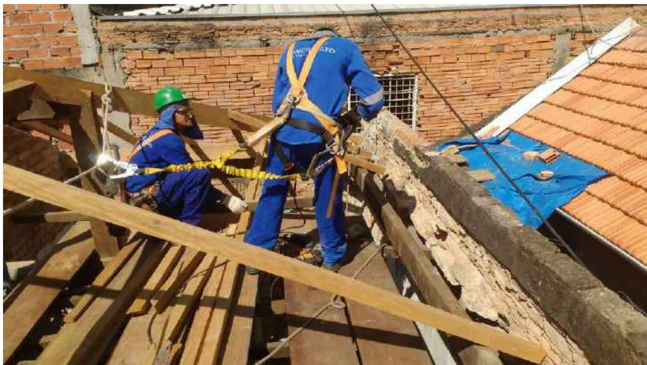
Foto 21: Instalação das terças.
