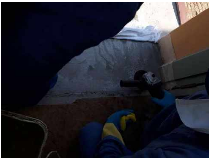
Foto 17 – Lixamento da soleira da entrada das portas – Casa 06
