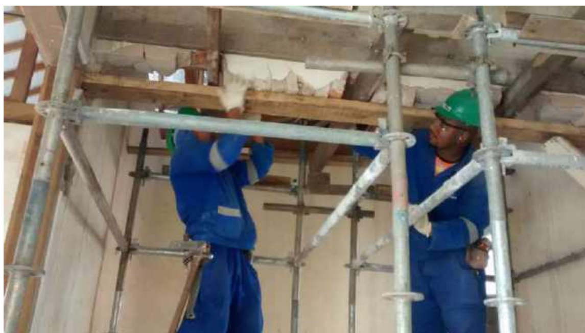
Foto 65 – Escoramento da alvenaria existente – Casa 06
