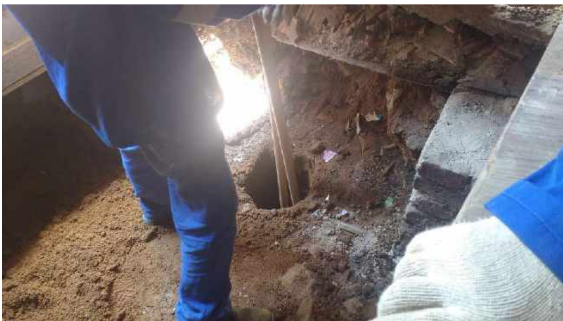
Foto 40 - Escavação manual para execução de brocas – Casa 06
