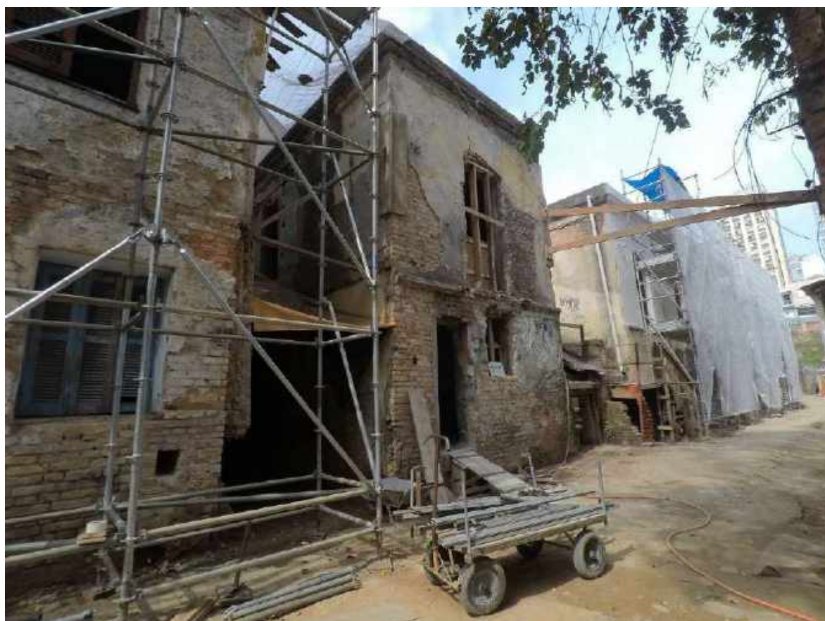
Foto 54 – Foto geral – Casa 06
