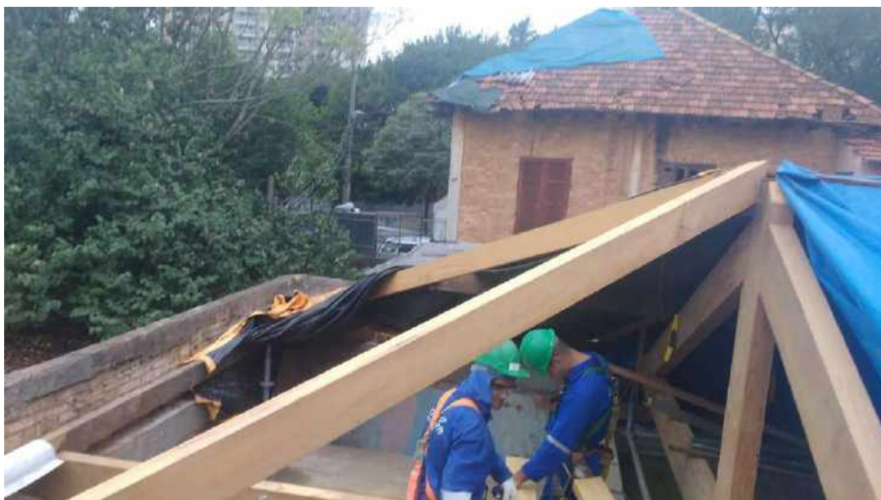
Foto 24: Substituição das peças danificadas da tesoura da Casa 6.
