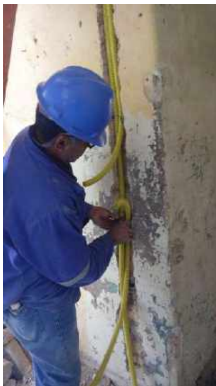
Foto 22 – Instalação dos conduites
