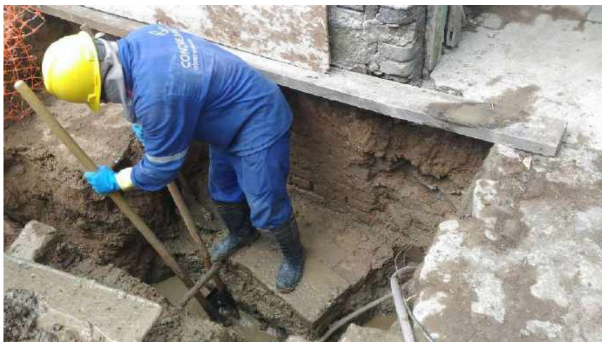
Foto 16: Abertura de vala para reforço na fundação – Casa 6.
