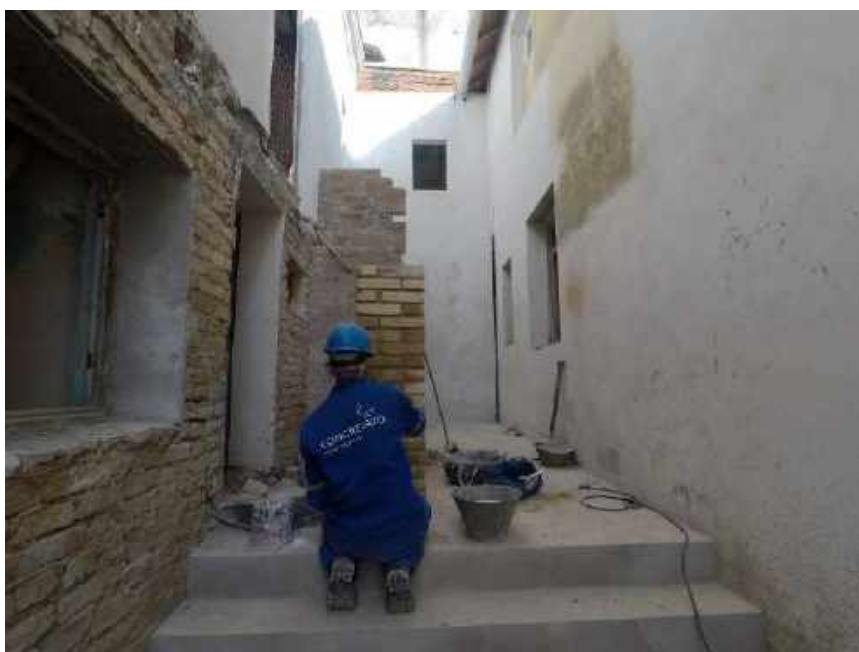
Foto 34 – Restauração dos tijolos – Casa 06
