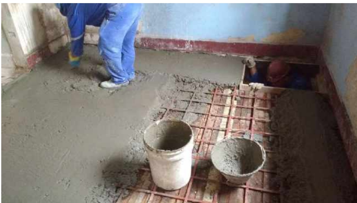
Foto 10 – Execução da concretagem – Casa 05
