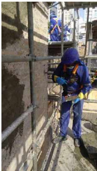
Foto 21 – Execução do embolso na fachada – Casa 06
