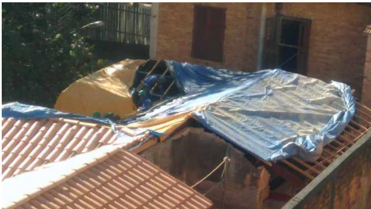
Foto 10: Instalação de caibros;
