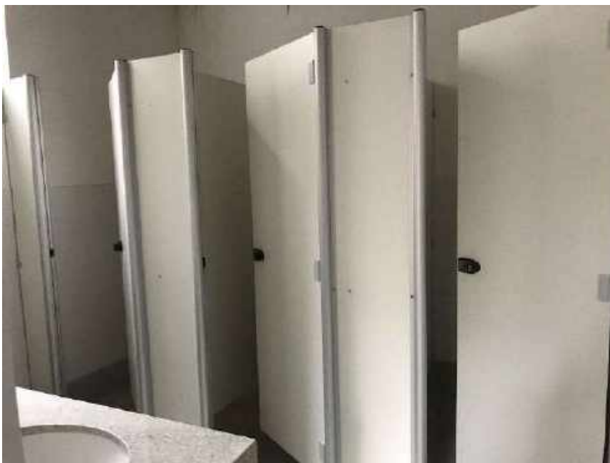
Foto 70 – Instalação das divisórias dos banheiros – Casa 06
