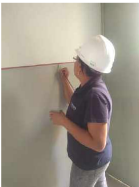
Foto 14 – Execução dos filetes – Casa 06
