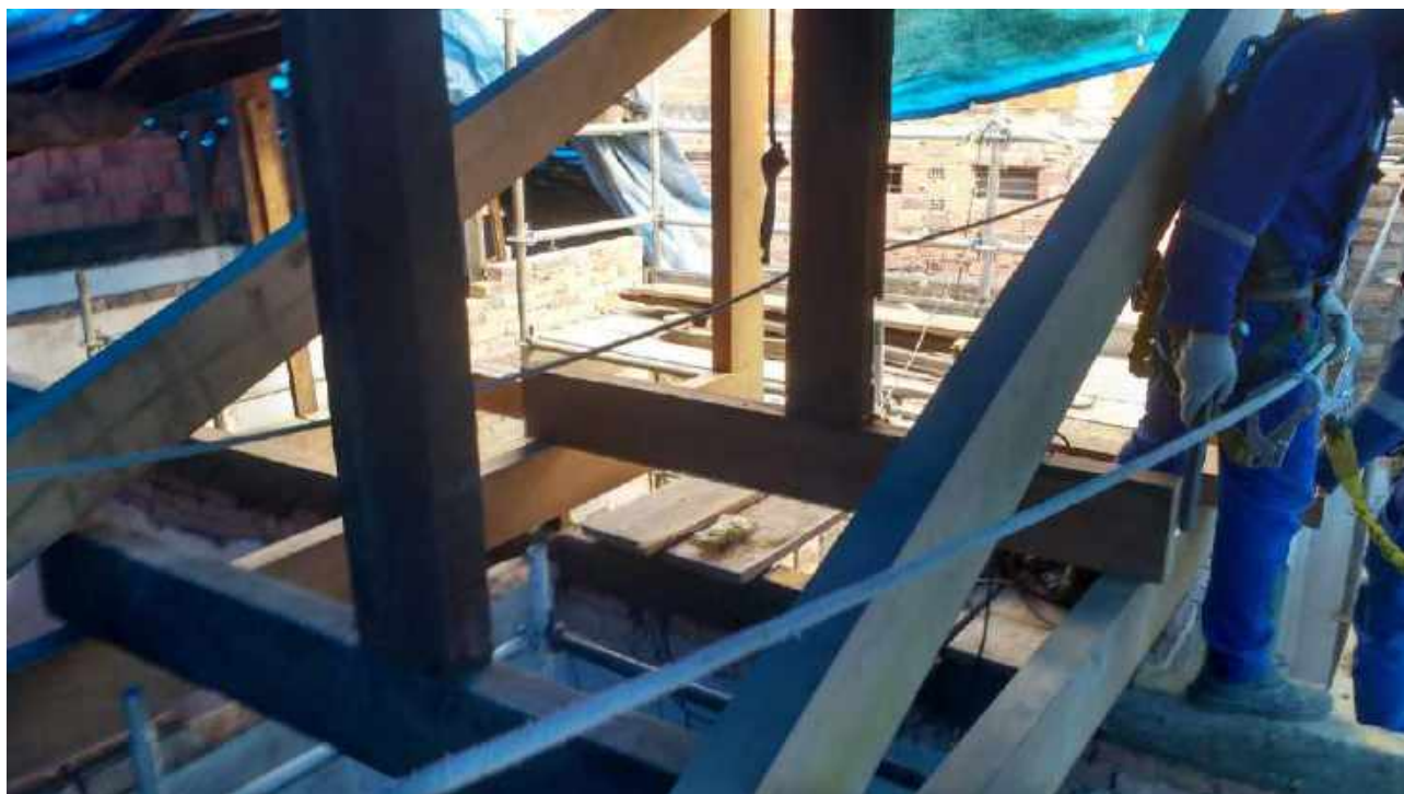
Foto 11: Substituição das peças danificadas da tesoura da Casa 6.
