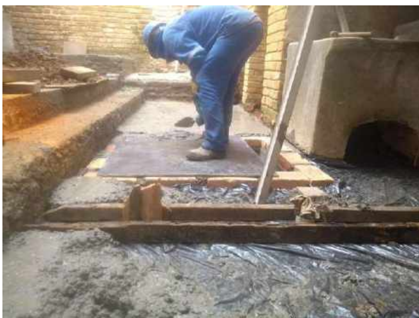
Foto 67 – Execução do piso cimentado – Casa 06
