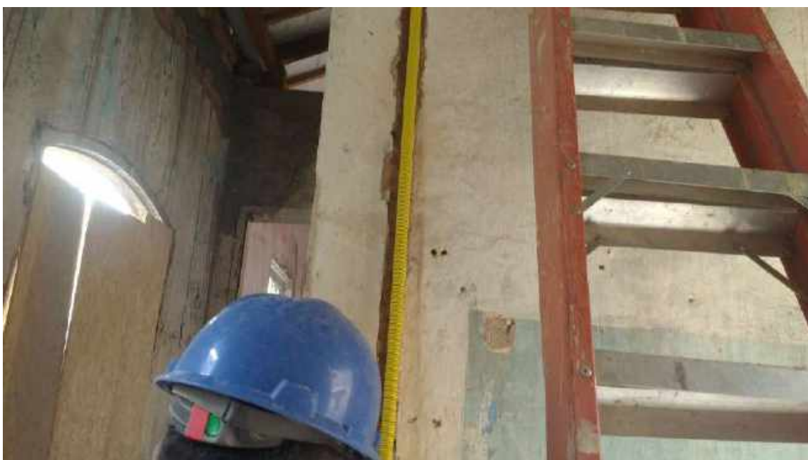
Foto 32 – Instalação dos conduites – Casa 06
