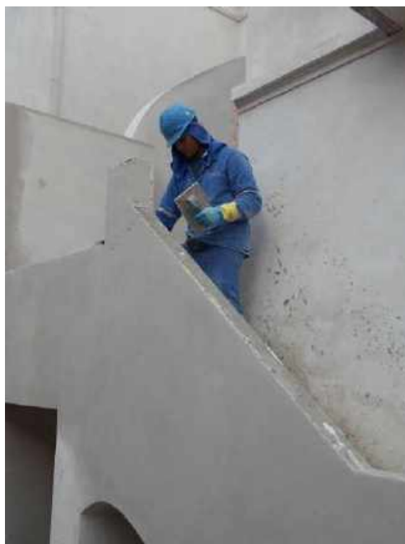
Foto 38 – Execução da argamassa de acabamento do guarda corpo da escada – Casa 06
