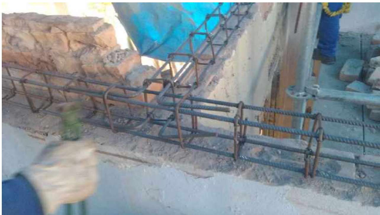
Foto 55: Armação das cintas de concreto.
