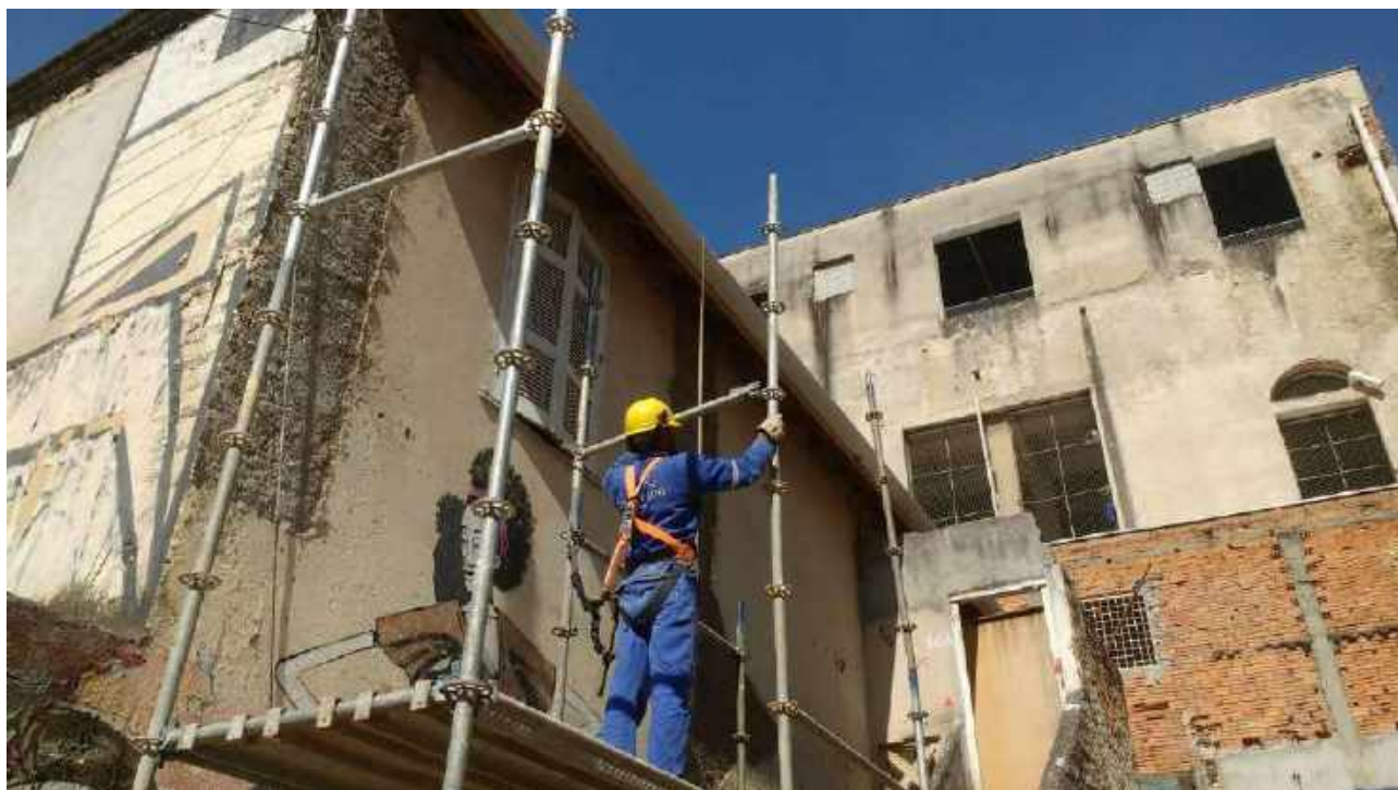
Foto 15: Montagem de acesso.
