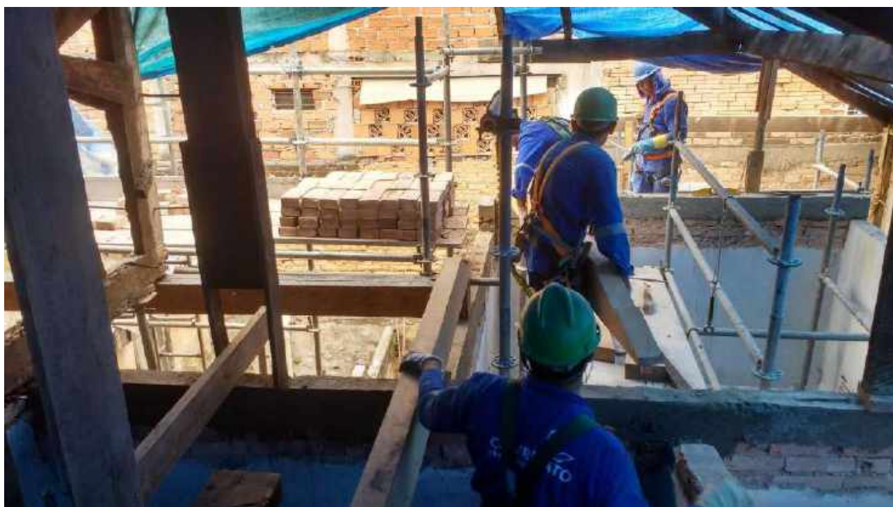
Foto 03: Substituição das peças danificadas da tesoura da Casa 6.
