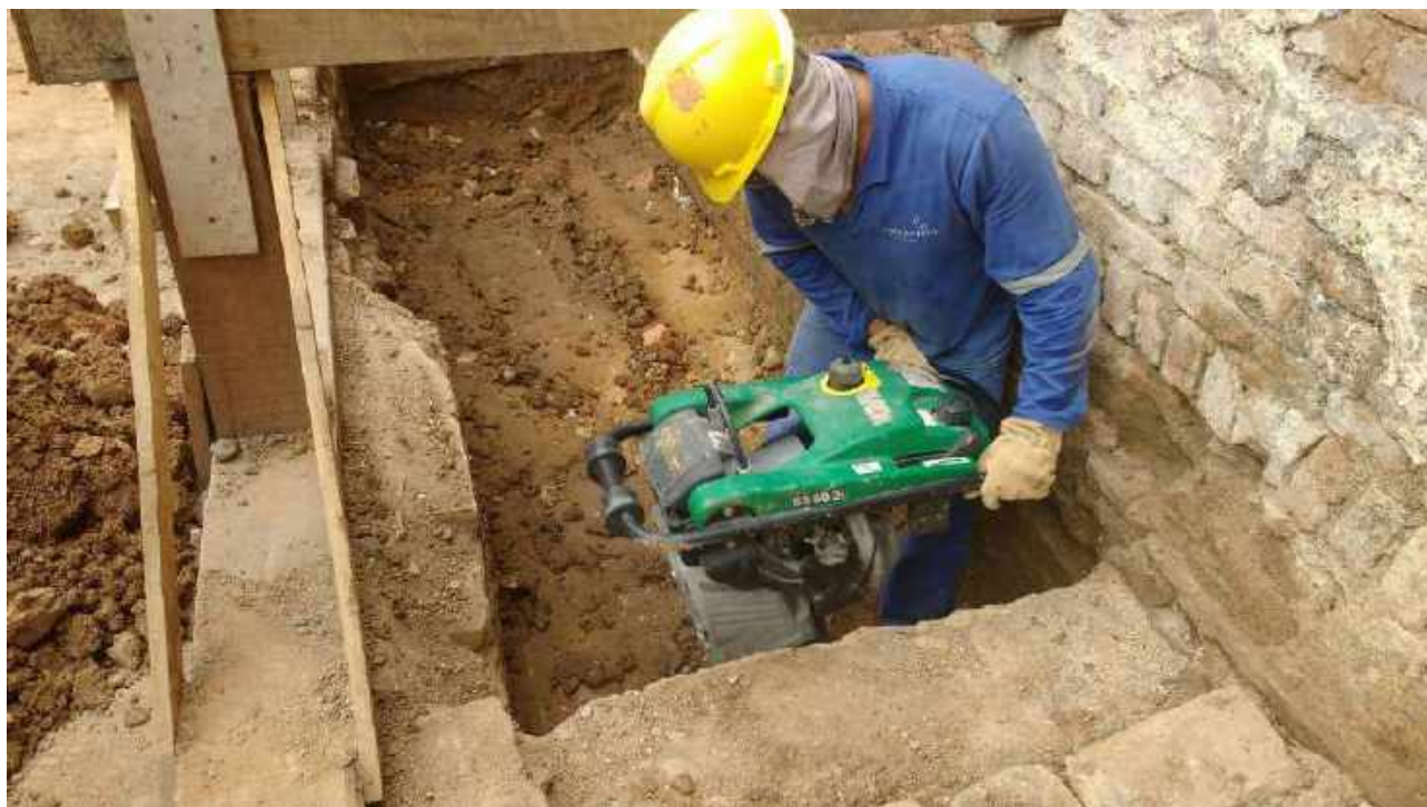
Foto 01: Compactação do solo.
