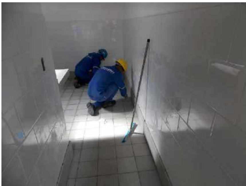
Foto 34 – Aplicação de rejunte nos pisos – Casa 06
