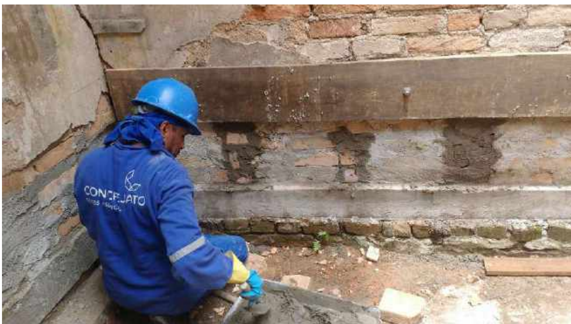
Foto 36 – Recuperação da alvenaria – Casa 06
