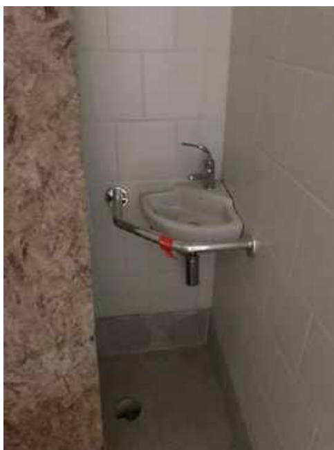
Foto 46 – Instalação das pias – Casa 06
