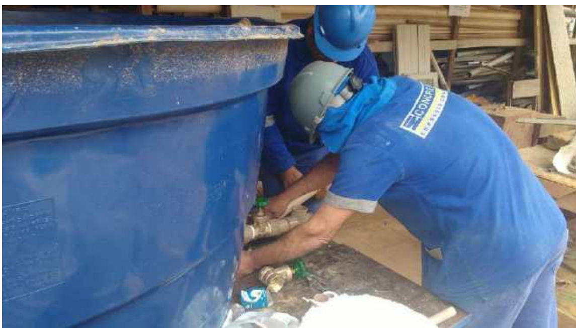
Foto 46 – Instalação do registro das caixas d'Água Casa 06
