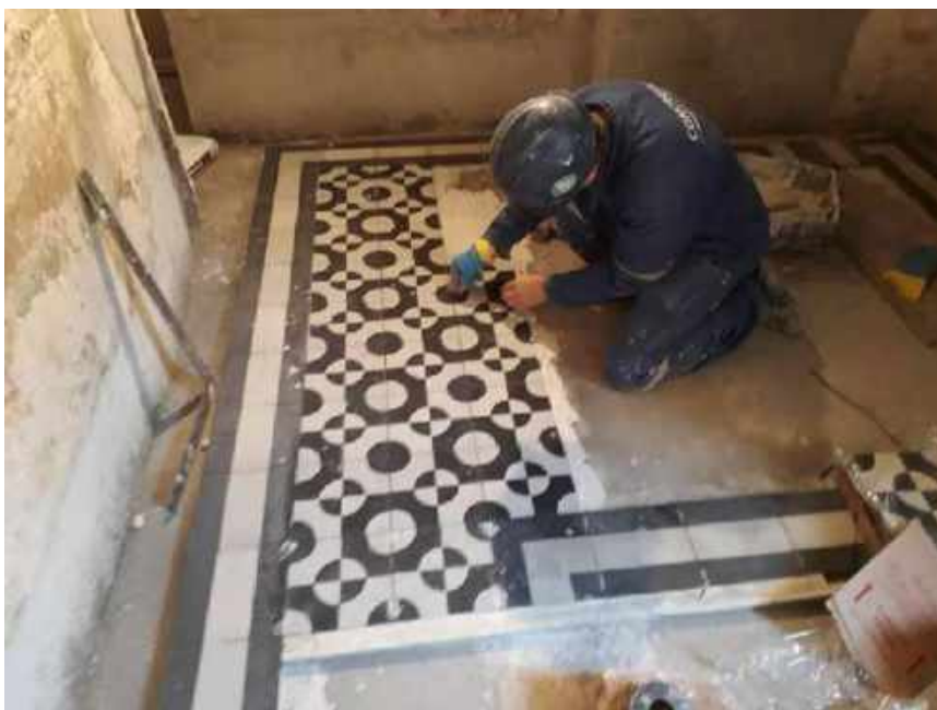
Foto 03- Instalação dos ladrilhos hidráulicos – Casa 06
