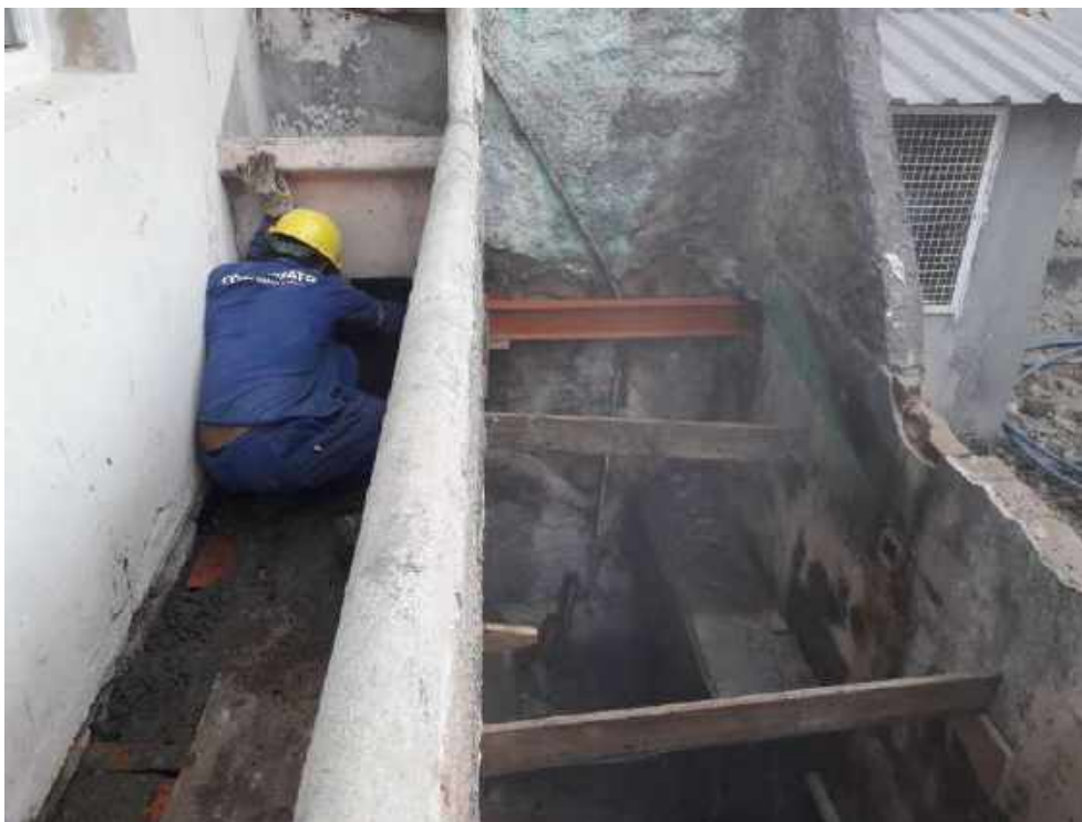
Foto 11 – Execução da nova laje da varanda – Casa 05
