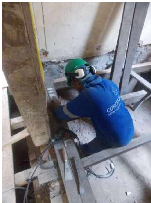
Foto 33 – Instalação dos assoalhos de madeira – Casa 06
