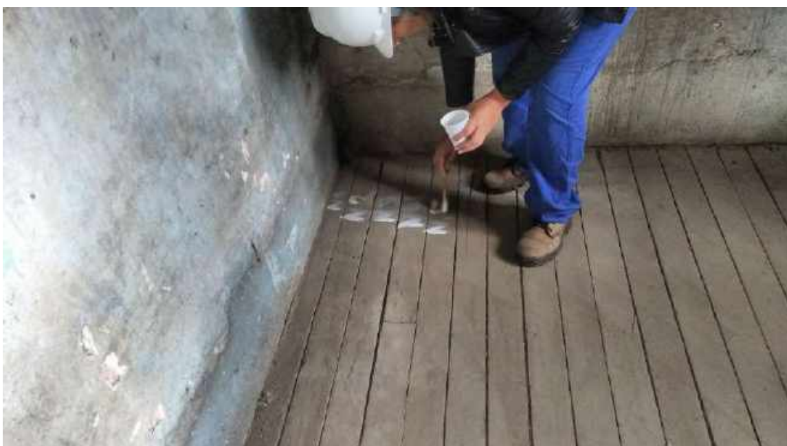
Foto 28 – Mapeamento das reguas de madeira e dos rodapés de madeira – Casa 06
