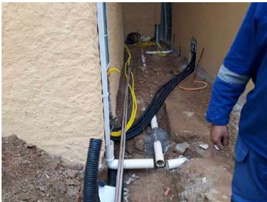
Foto 36 – Instalação da tubulação para execução das caixas pluviais – Casa 06
