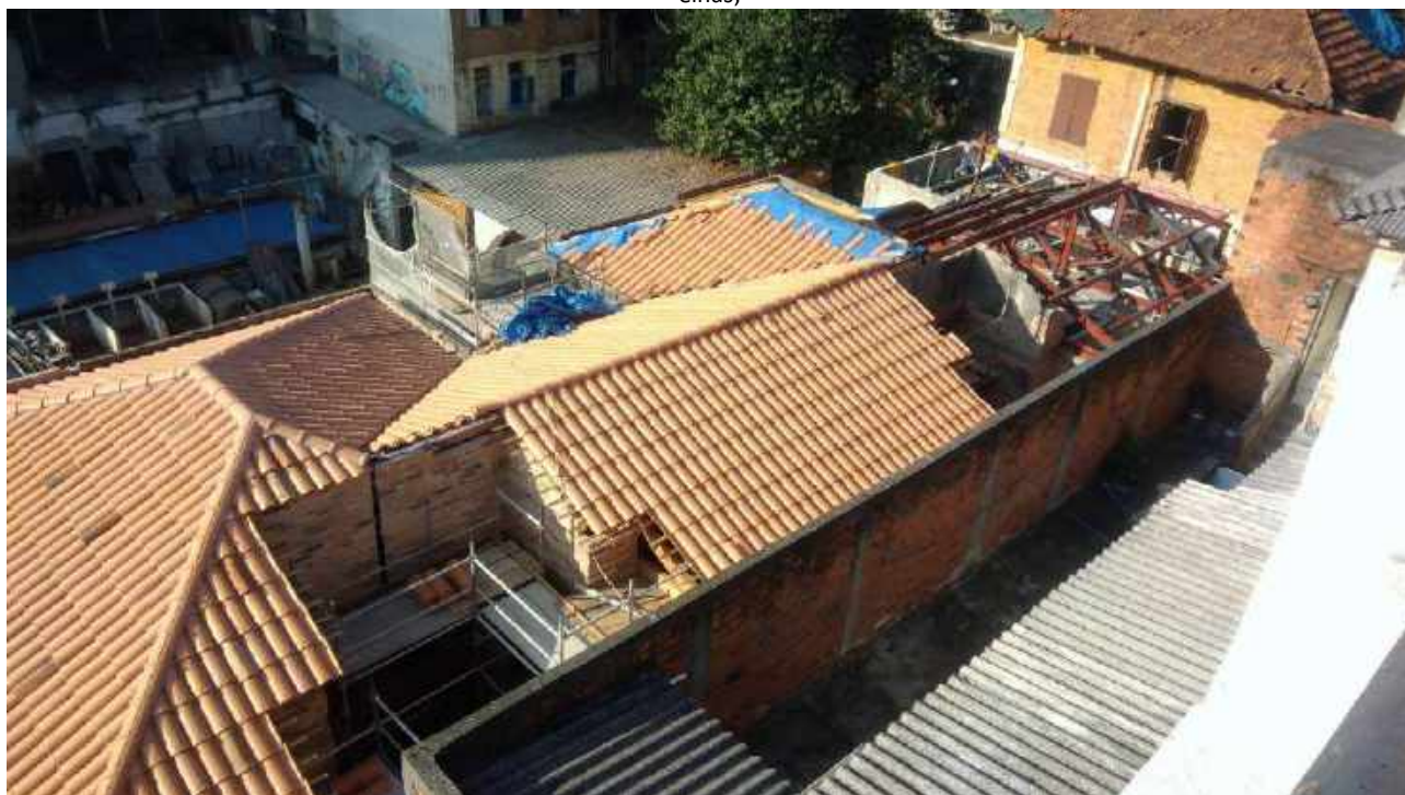
Foto 14: Instalação das terças metálicas;
