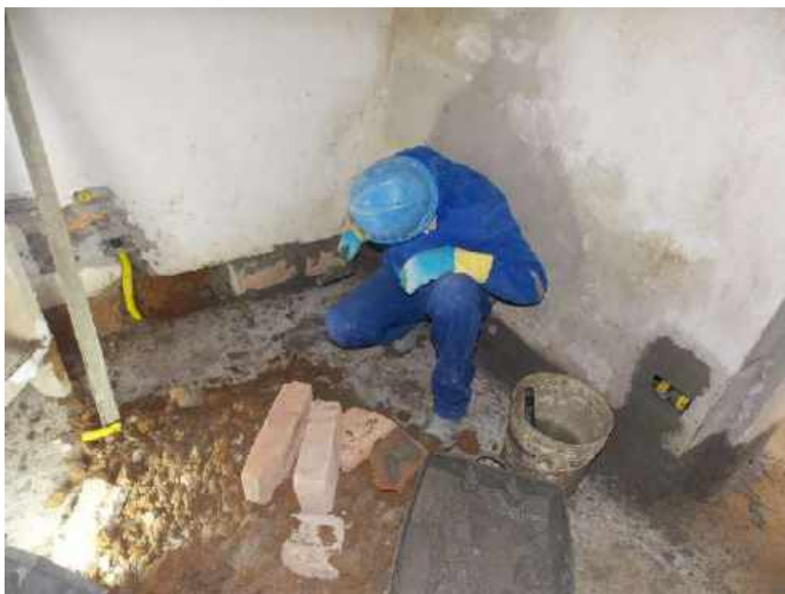
Foto 60 – Ajustes de alvenaria – Casa 06
