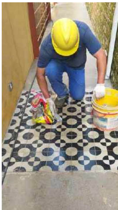
Foto 25– Aplicação de resina do ladrilho da área externa – Casa 06
