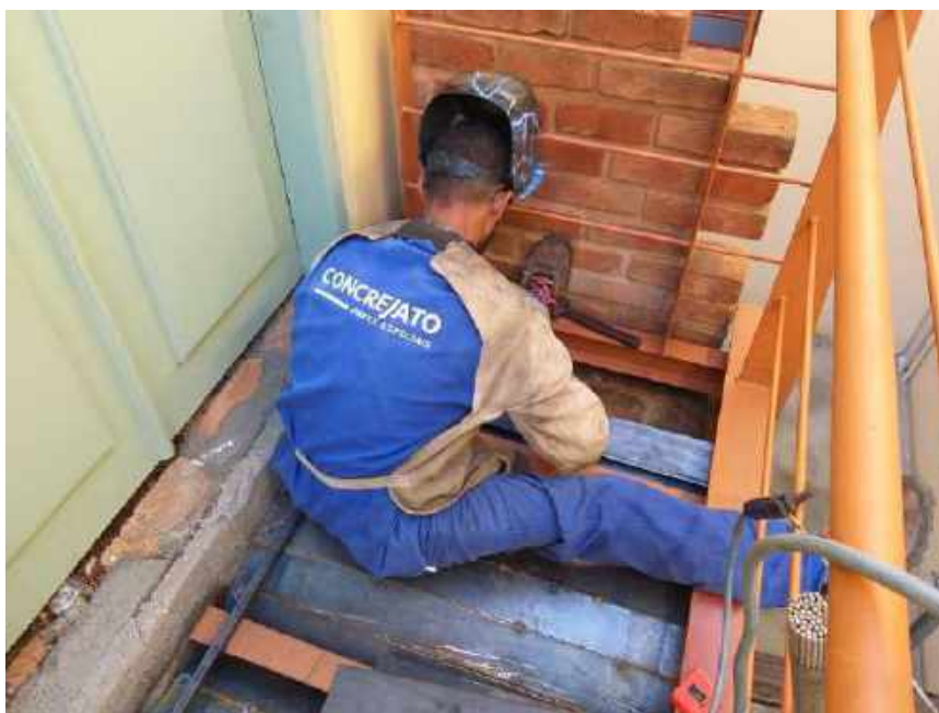
Foto 03 – Instalação do guarda corpo metálico
