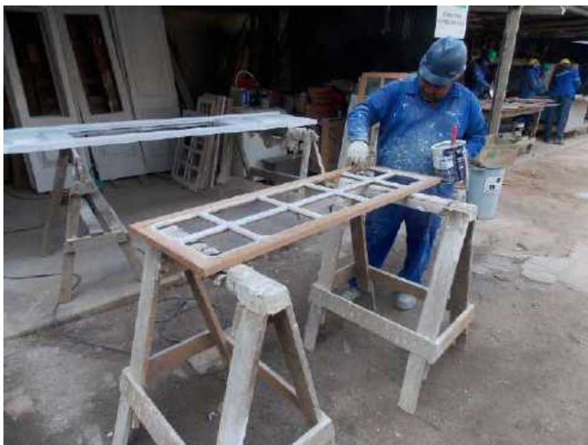
Foto 07 – Execução da proteção das esquadrias de madeira – Casa 05
