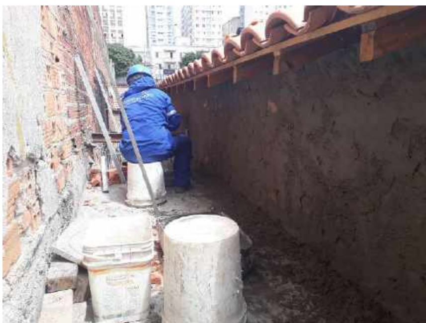
Foto 38 – Execução do revestimento – Casa 06
