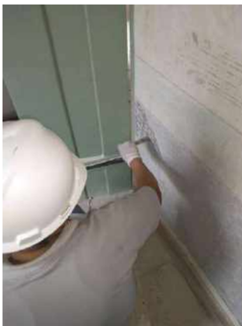
Foto 24 – Execução do envelhecimento das paredes internas – Casa 06
