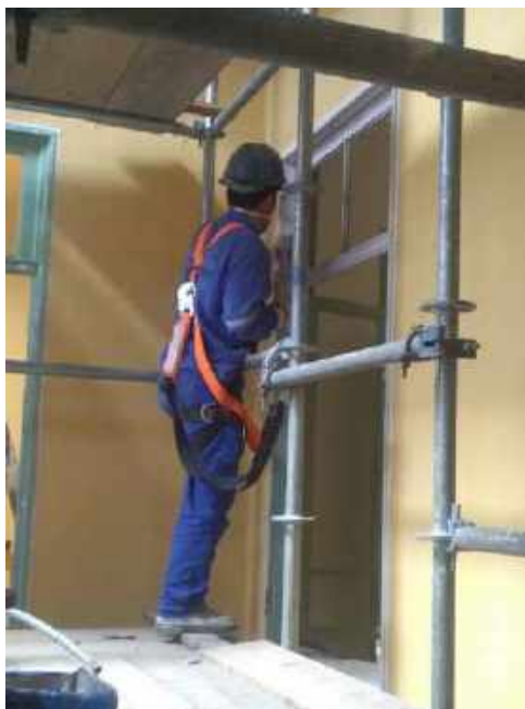
Foto 31 – Pintura lisa dos batentes de madeira – Casa 06
