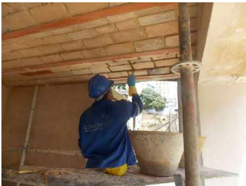
Foto 01 – Restauro dos tijolos da abobadilha – Casa 05
