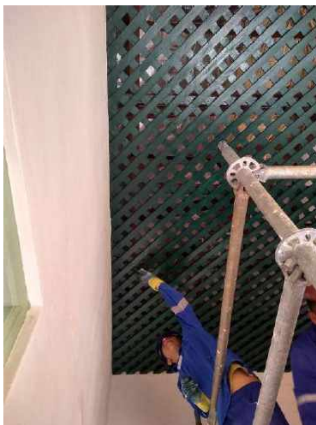
Foto 33 – Pintura lisa do forro treliçado – Casa 06
