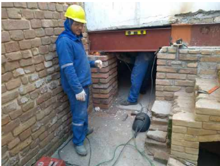
Foto 33 – Reforço estrutural – Casa 06
