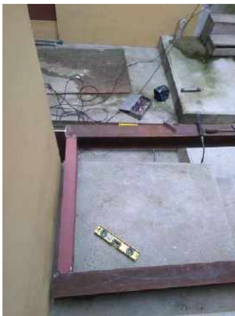
Foto 20 – Instalação do perfil metálico para execução da passarela metálica
