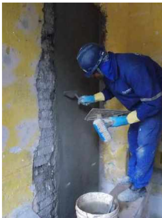
Foto 34 – Execução da argamassa de acabamento, após a elevação da alvenaria – Casa 06
