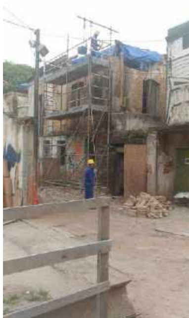
Foto 12: Desmontagem cuidadosa da alvenaria com reaproveitamento de tijolos – Casa 6.
