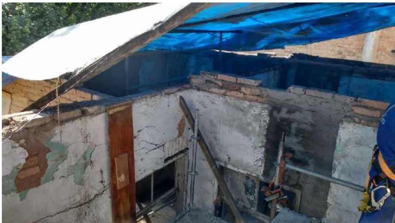
Foto 53: Preparação para execução de cinta de concreto.
