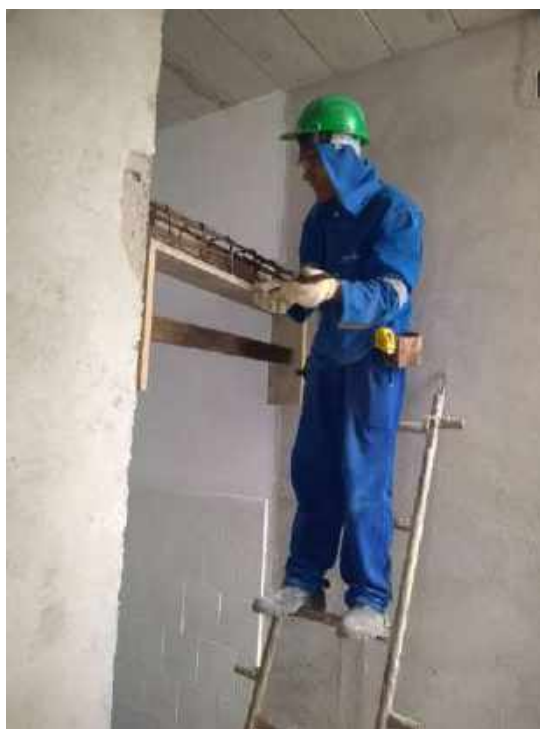
Foto 62 – Execução da forma para verga da porta – Casa 06
