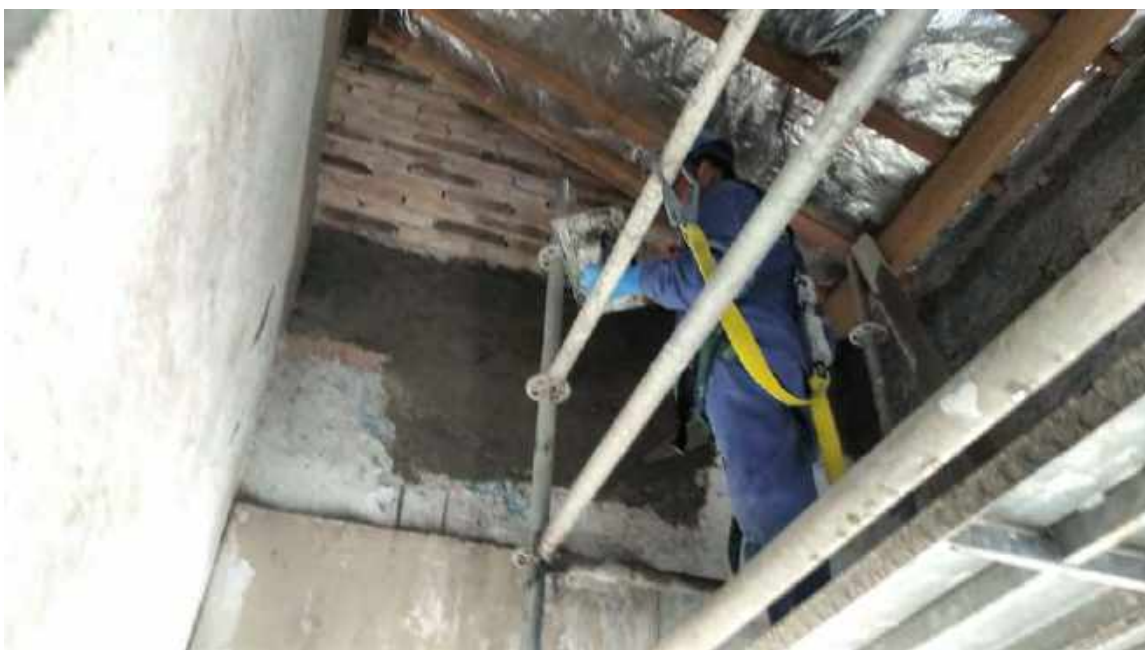
Foto 48- Execução do emboço da casa 06
