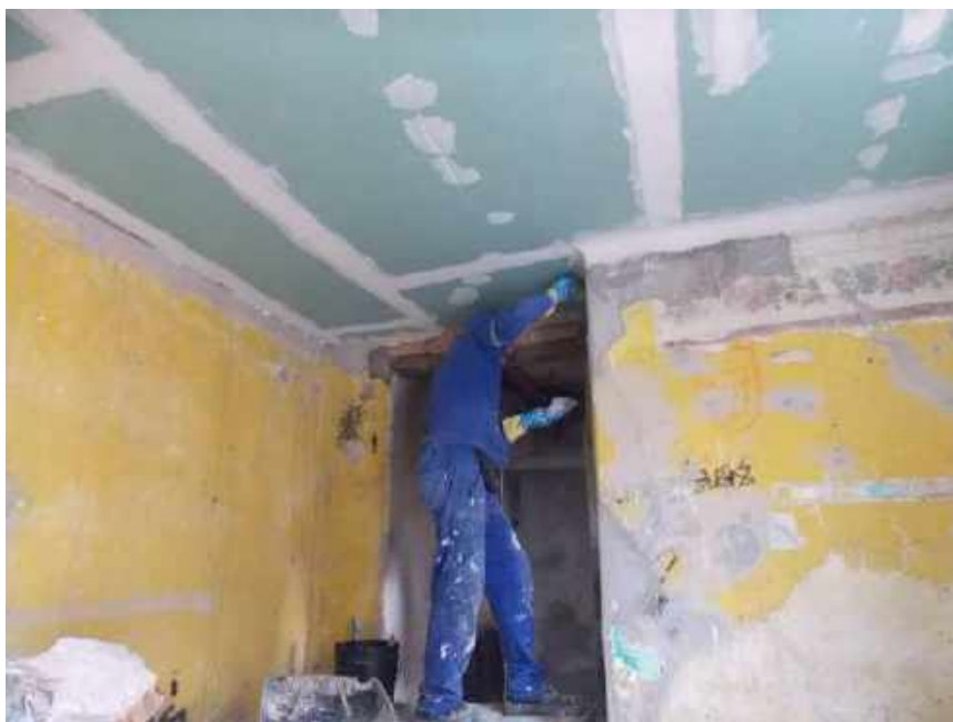
Foto 41 – Instalação do forro de drywall – Casa 06
