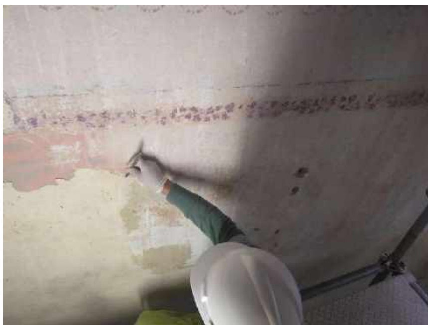
Foto 22 – Decapagem manual cuidadosa das paredes internas – Casa 06
