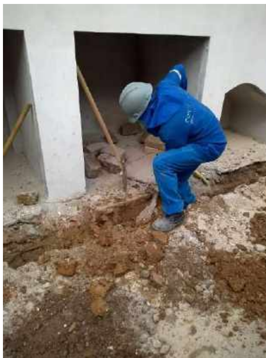
Foto 59 – Escavação manual para instalação do para- raio – Casa 06
