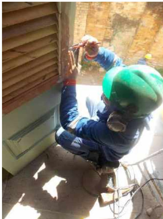
Foto 15 – Instalação das venezianas de madeira – Casa 06
