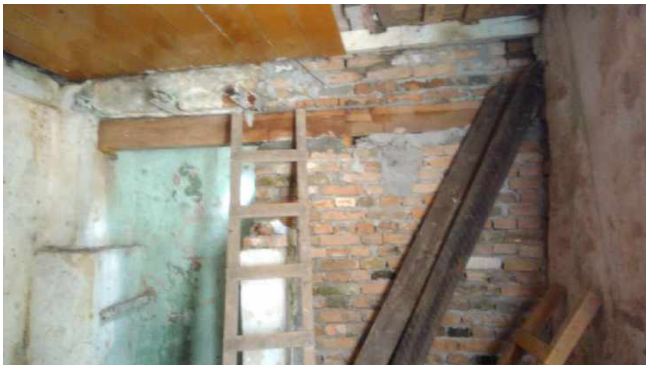
Foto 01:Substituição da viga de madeira;
