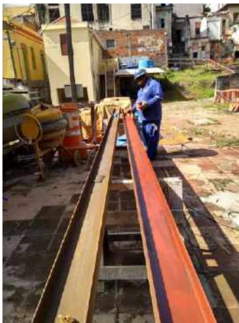
Foto 07 – Pintura lisa dos perfis metálicos da estrutura da escada – Casa 06
