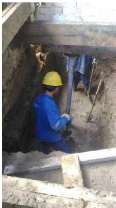
Foto 11: Escavação para execução de fundação.
