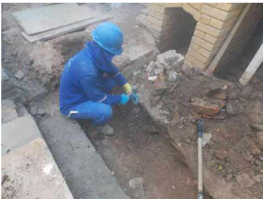
Foto 45 – Demolição manual para execução do piso cimentado – Casa 06
