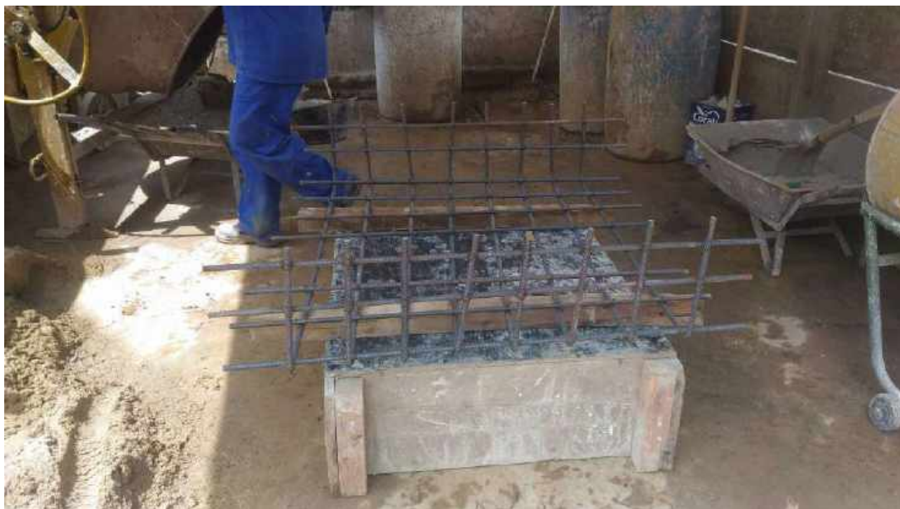
Foto 13: Escoramento com cabo de aço - Casa 6.
