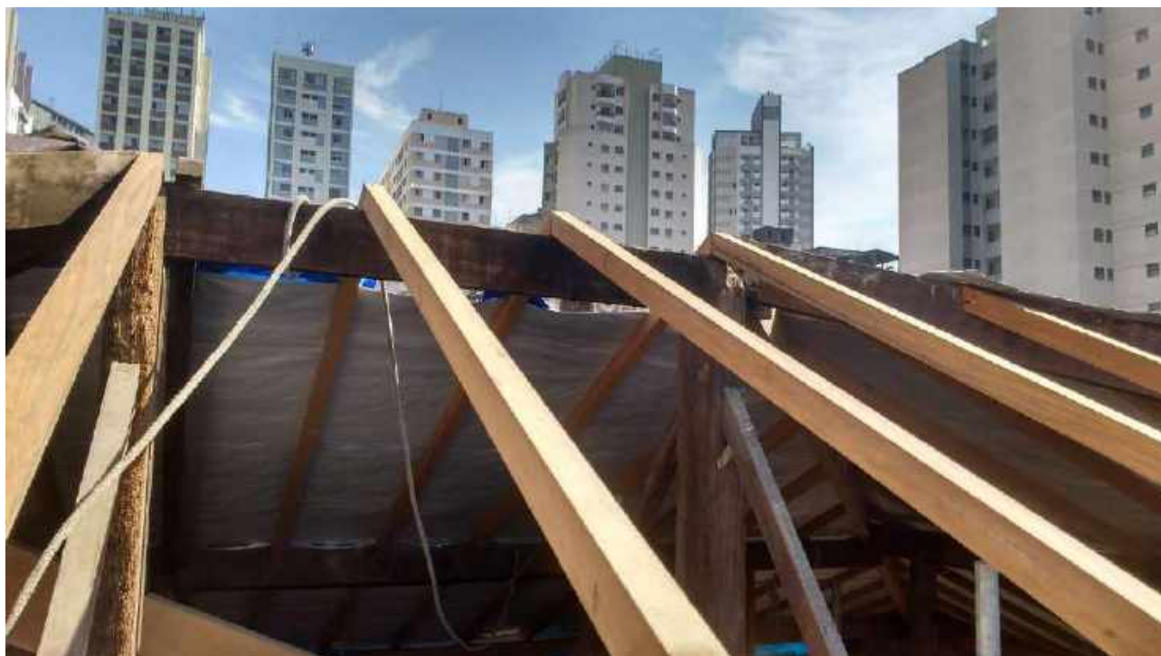
Foto 35: Instalação dos caibros.
