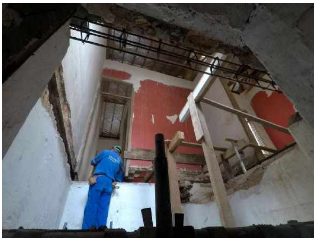
Foto 52 – Ajustes dos apoios das alvenarias – Casa 06
