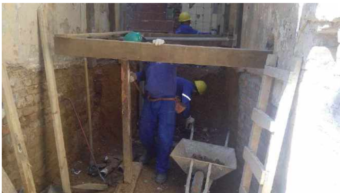
Foto 24 – Escoramento das paredes – Casa 06
