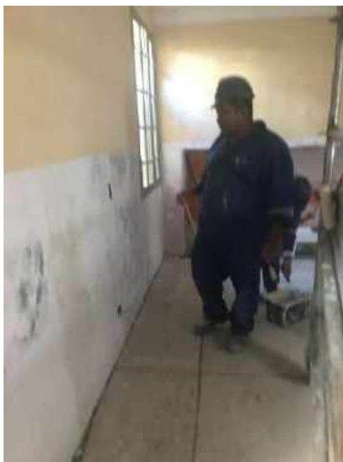
Foto 14 – Pintura lisa das paredes internas – Casa 05
