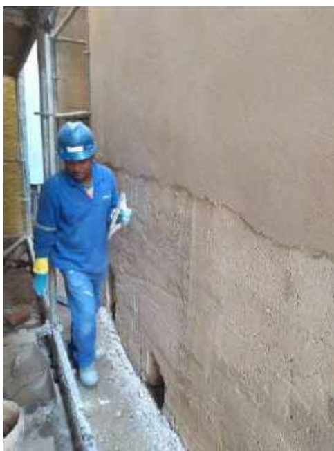
Foto 40 – Execução da argamassa de acabamento da fachada lateral – Casa 06
