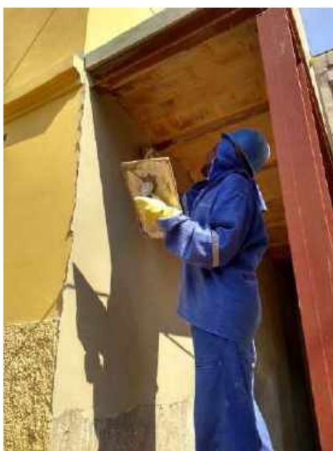
Foto 07 – Execução da argamassa de acabamento da abobadilha
