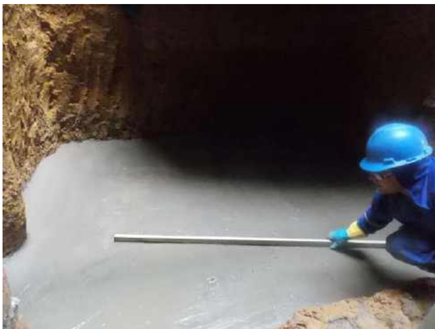
Foto 30- Concretagem da armação, para execução do elevador – Casa 06
