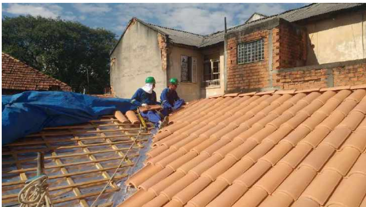
Foto 60: Instalação de telhas capa canal.
