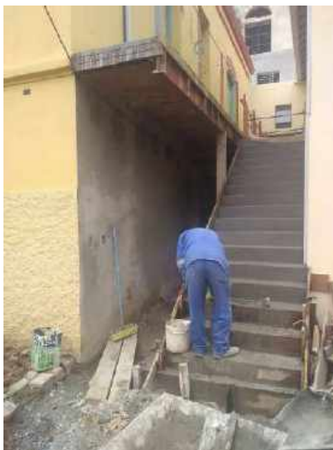
Foto 01- Execução da argamassa de acabamento da escada
