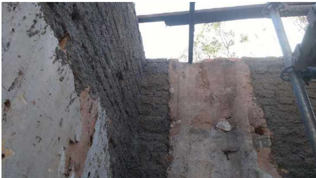
Foto 51: Substituição das peças danificadas da tesoura da Casa 6.
