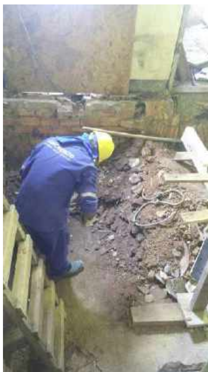
Foto 02 – Remoção de entulho
