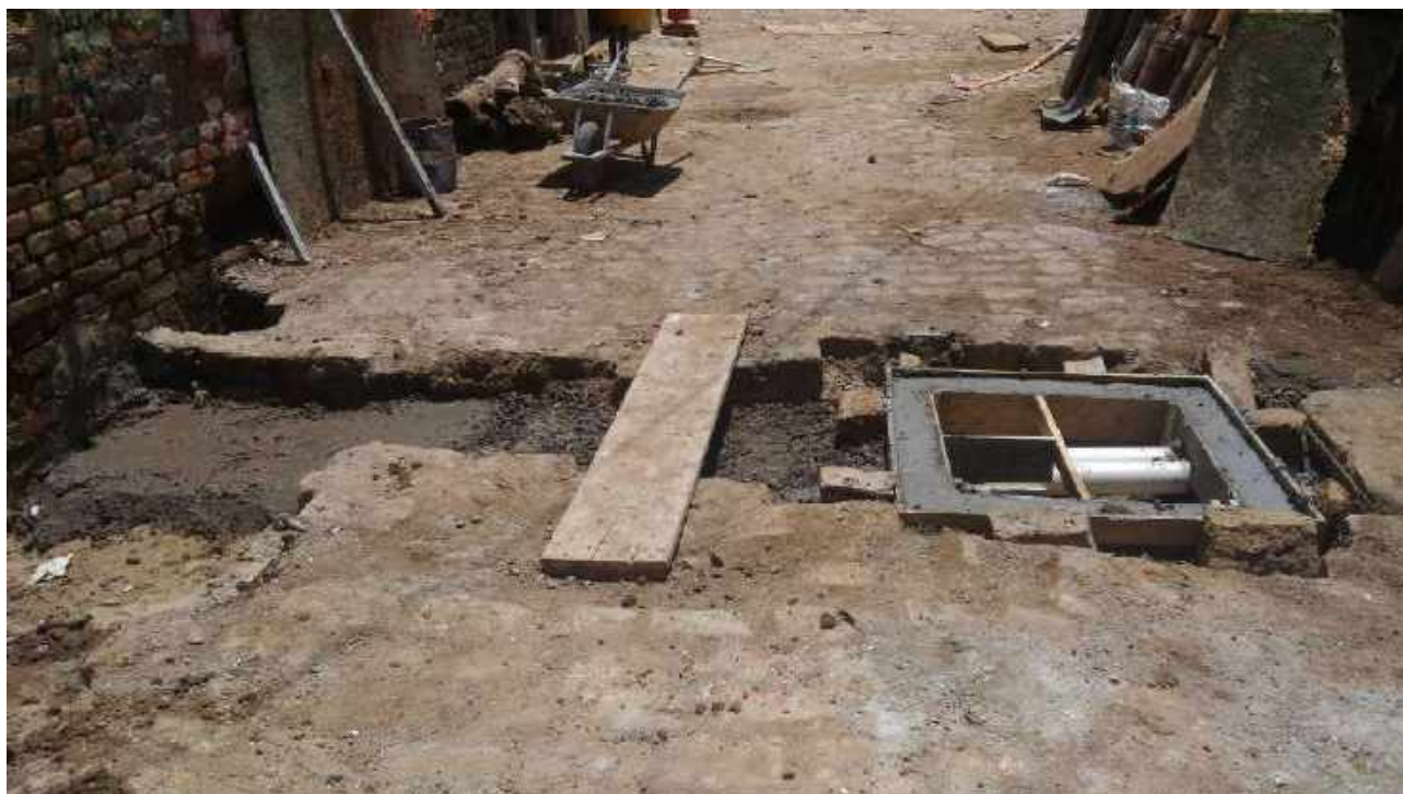
Foto 17: Execução de caixa de águas pluviais
