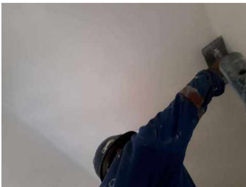
Foto 24 - Aplicação de massa no forro de drywall – Casa 06
