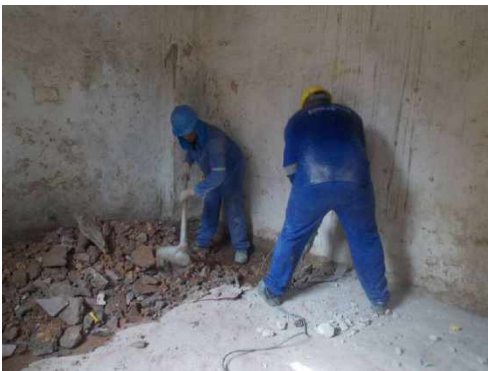
Foto 28 – Demolição mecânica do piso existente – Casa 06
