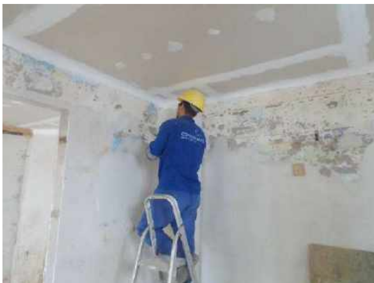
Foto 38 – Decapagem manual das paredes internas – Casa 06
