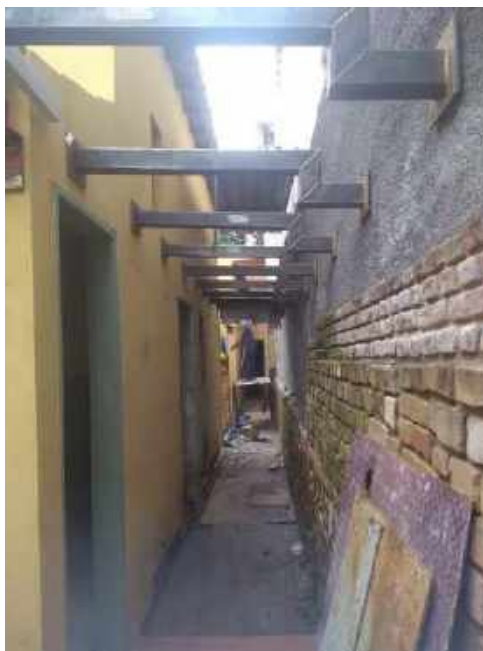
Foto 24 – Instalação da estrutura metálica para execução da cobertura
