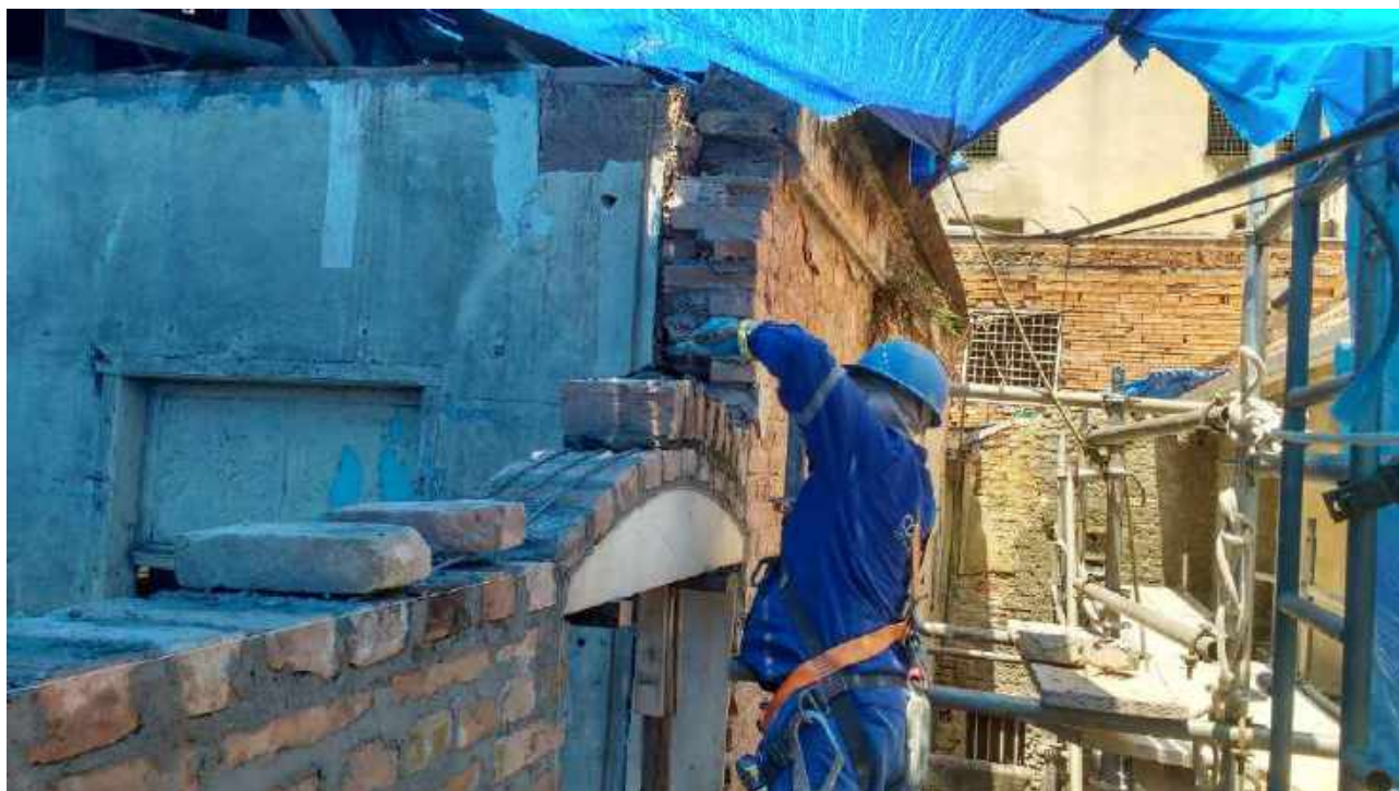
Foto 30: Remontagem da verga em arco da porta.
