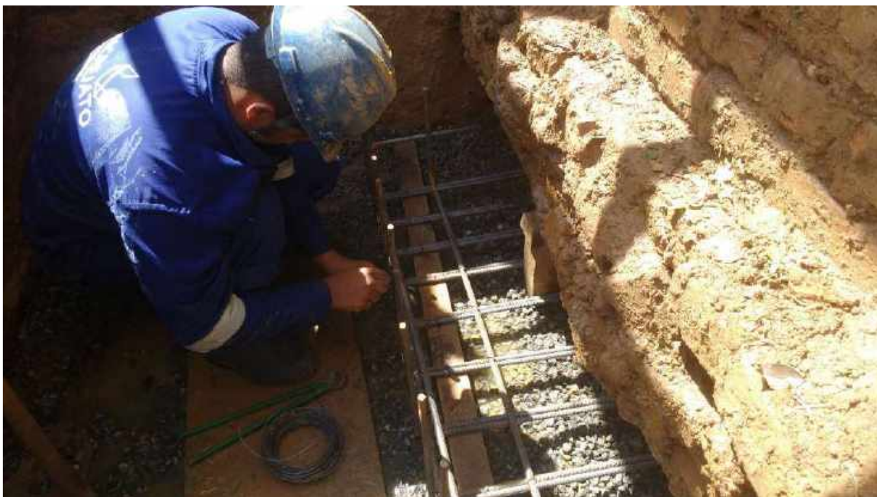
Foto 32: Armação dos blocos de fundação.
