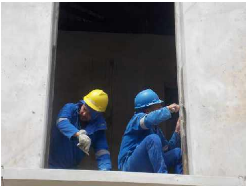
Foto 24 – Execução da argamassa de acabamento na fachada principal – Casa 06
