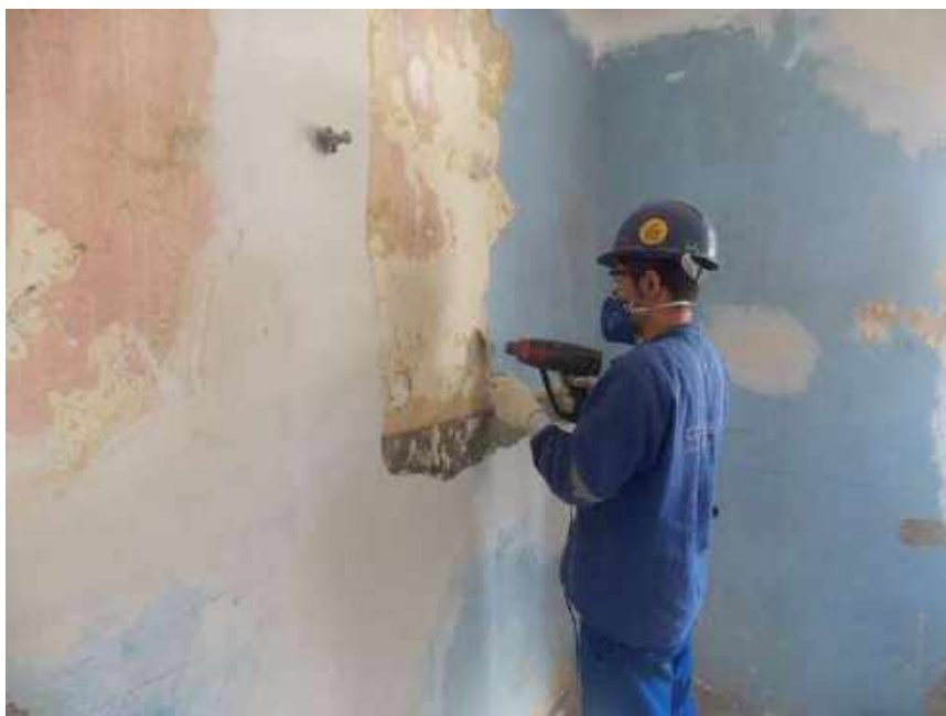
Foto 09 – Decapagem mecânica – Casa 05
