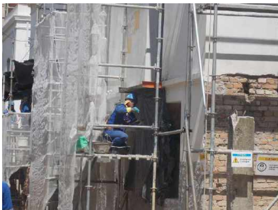
Foto 18 – Execução da varanda – Casa 06
