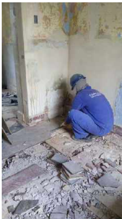
Foto 59 – Remoção dos azulejos
