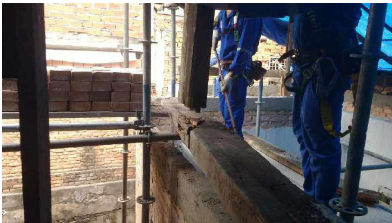
Foto 20: Remoção das peças danificadas.
