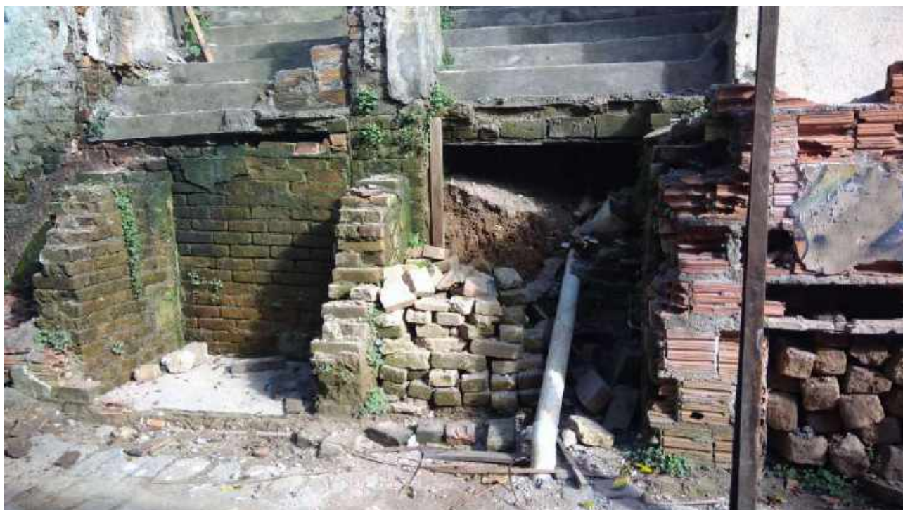
Foto 05: Desmontagem da escadaria para execução de bloco estrutural - Casa 06
