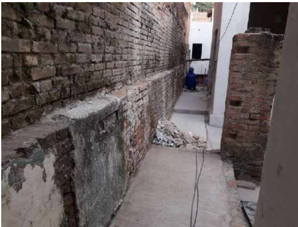
Foto 69 – Restauração dos tijolos existente nos fundos – Casa 06
