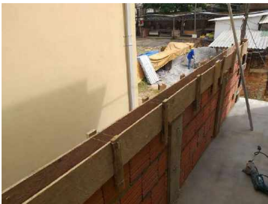
Foto 03 – Execução do guarda corpo
