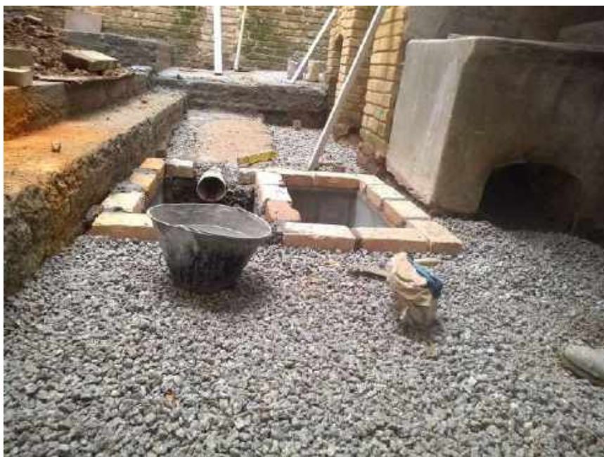
Foto 66 – Execução do piso cimentado fundos – Casa 06
