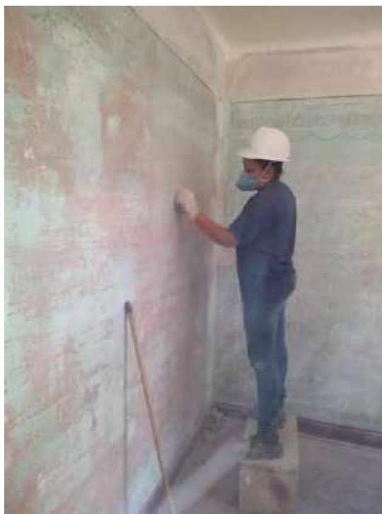
Foto 15 – Decapagem manual – Casa 05
