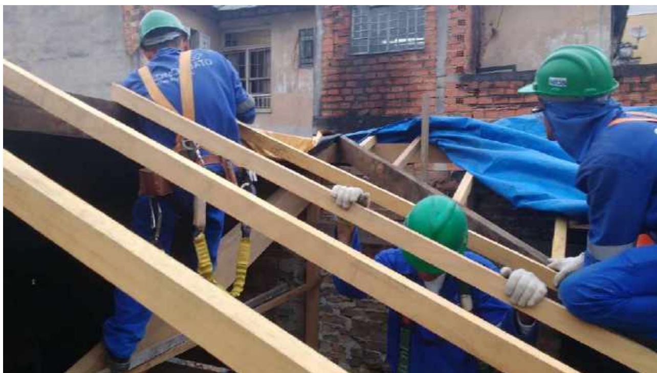
Foto 28: Instalação de caibros - Casa 06.
