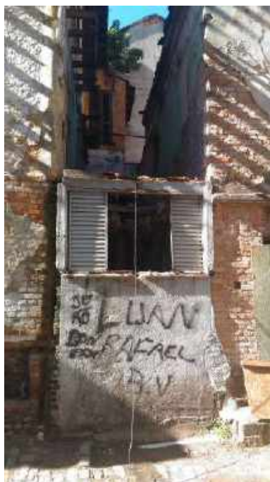
Foto 11: Demolição do anexo entre a Casa 5 e 6.
