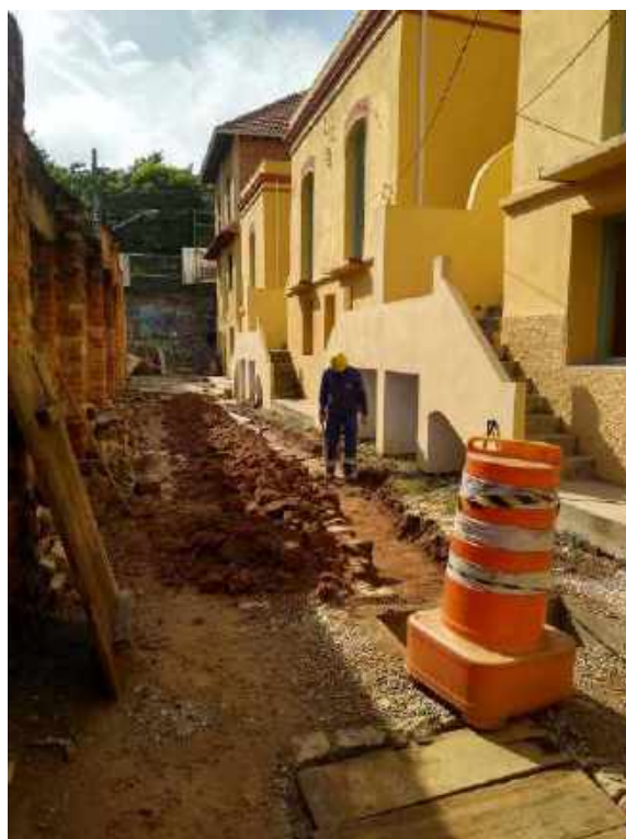
Foto 14 – Escavação manual para passagem das tubulações
