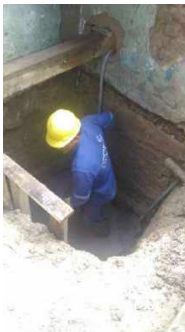
Foto 19: Abertura de vala para reforço na fundação - interno– Casa 6.
