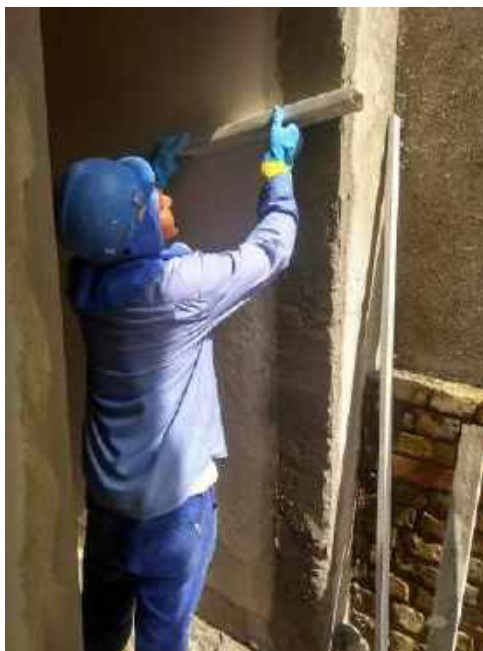
Foto 19 Requadro dos vãos das portas metálicas – Casa 06
