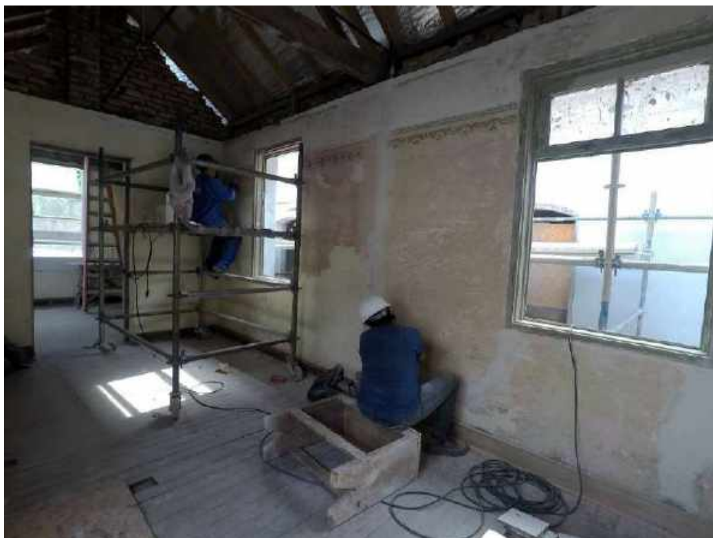
Foto 49 – Decapagem cuidadosa das tintas existentes sobre a pintura decorativa – Casa 05
