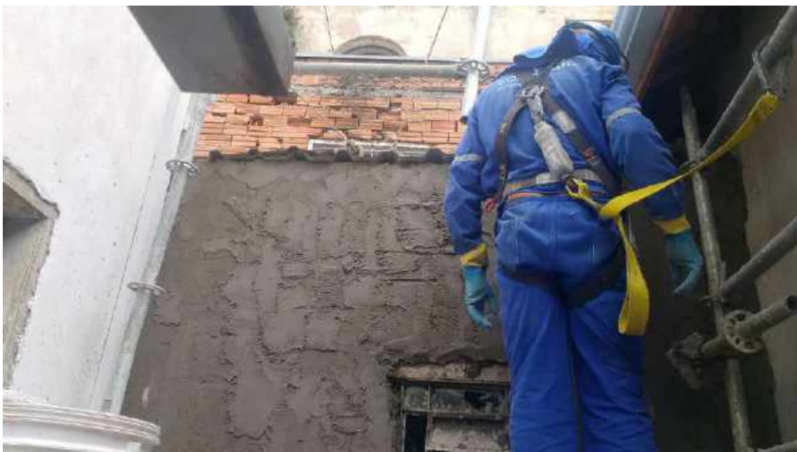
Foto 49 – Execução do chapisco na fachada – Casa 05
