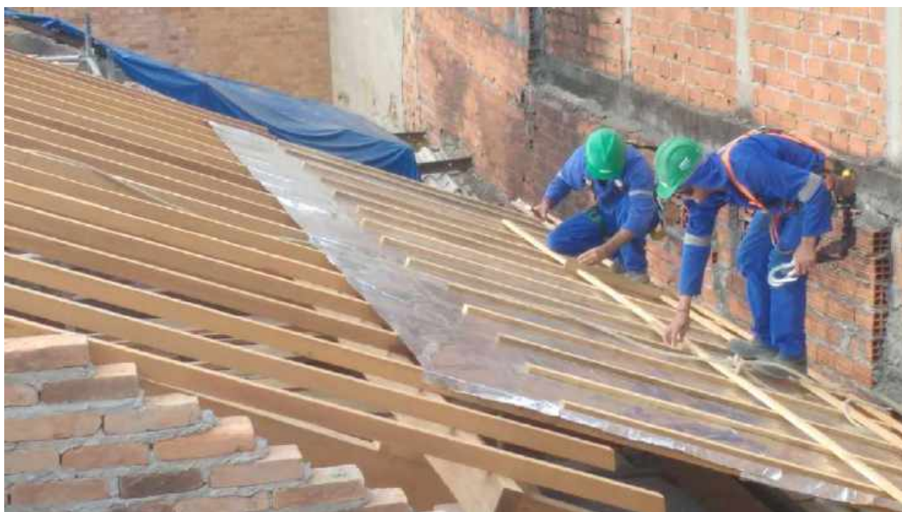
Foto 02: Instalação de manta aluminizada e contra ripa.
