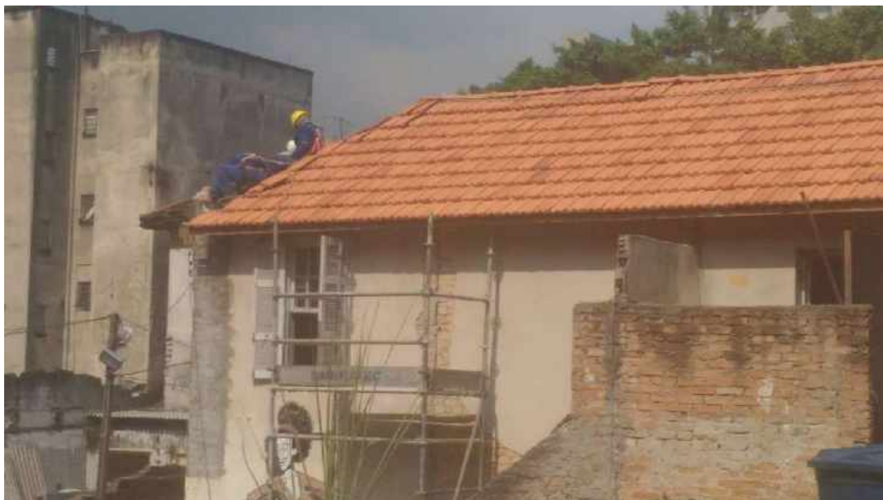
Foto 23: Instalação das calhas e rufos da Casa 5.
