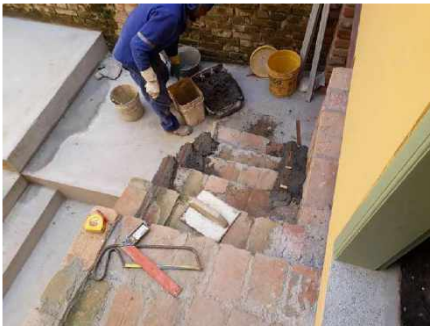
Foto 30 – Recuperação da escada de alvenaria existente – Casa 06
