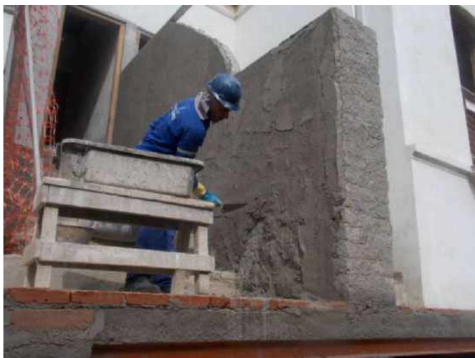
Foto 48 – Execução do emboço – Casa 06
