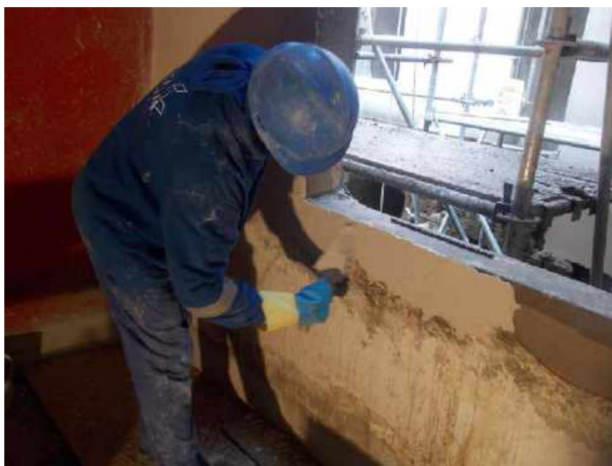
Foto 17 – Execução da argamassa de acabamento – Casa 06
