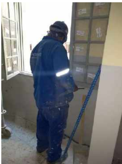
Foto 08 – Instalação dos vidros nas janelas de madeira – Casa 05
