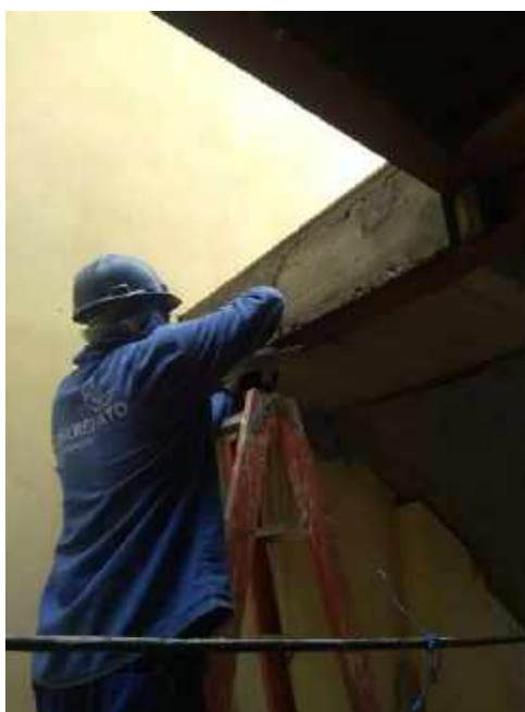
Foto 17 – Execução da argamassa de acabamento da escada
