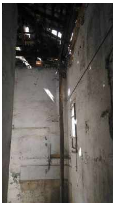
Foto 04: Escoramento com cabo de aço - Casa 6.
