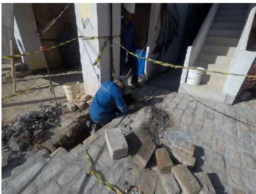
Foto 12 – Instalação do paralelepípedo – Casa 05
