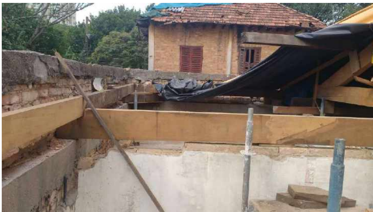
Foto 18: Substituição das peças danificadas da tesoura da Casa 6.
