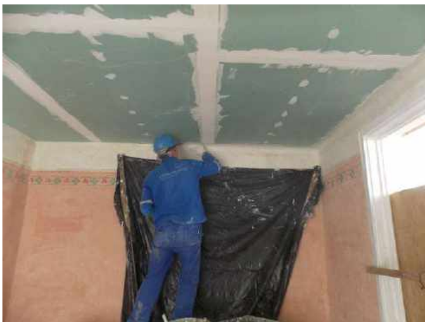
Foto 04 – Instalação do forro de drywall – Casa 05
