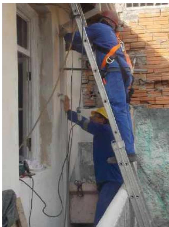
Foto 18 – Instalação das descidas de água – Casa 05
