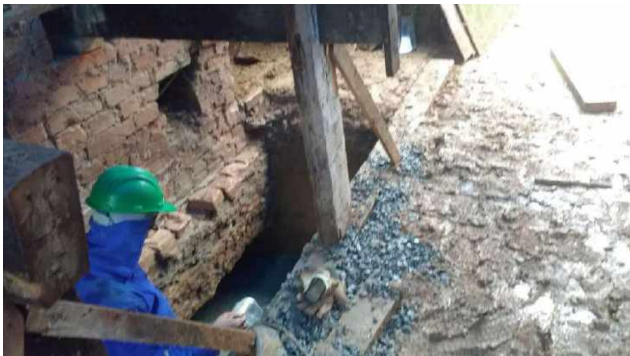
Foto 09: Execução de bloco de reforço – Casa 06.
