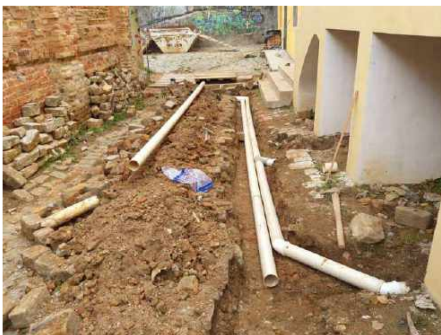
Foto 16 – Instalação das tubulações nas caixas pluviais
