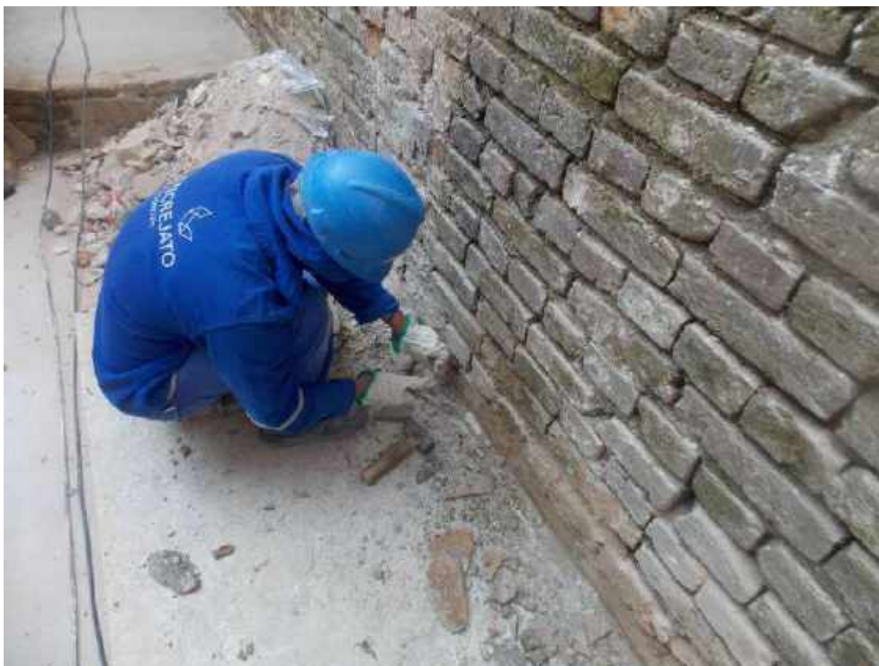
Foto 53 – Remoção da argamassa existente da fachada dos fundos – Casa 06
