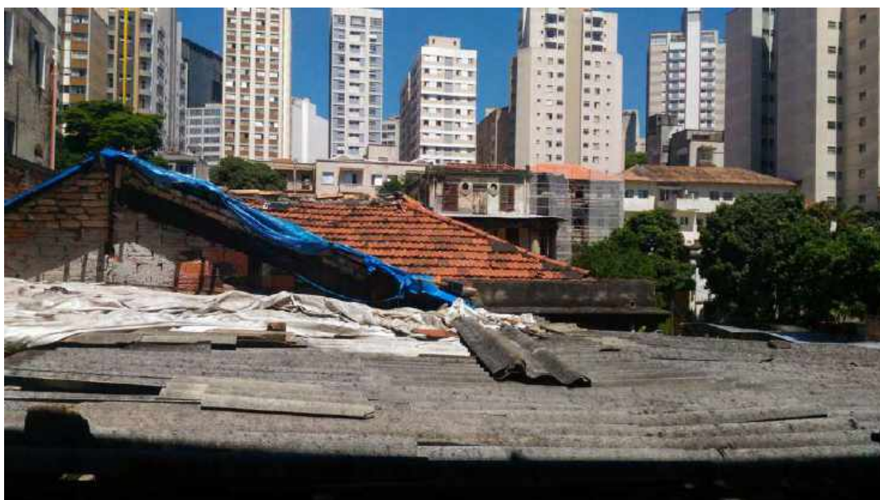
Foto 06: Remoção das telhas existentes – Casa 6.
