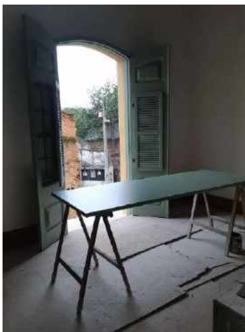
Foto 10 – Pintura lisa das portas de madeira – Casa 06
