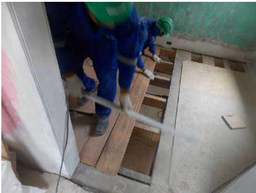
Foto 61 – Instalação dos assoalhos de madeira – Casa 06
