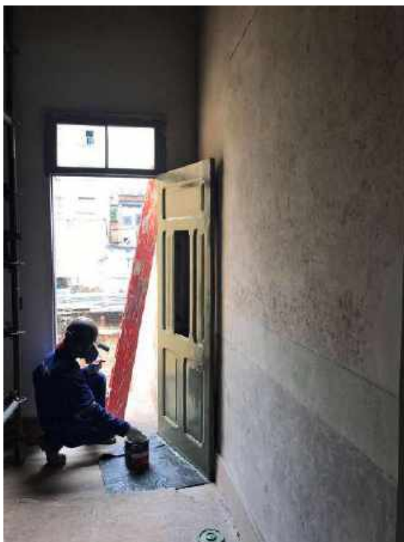
Foto 45 – Pintura das esquadrias – Casa 06
