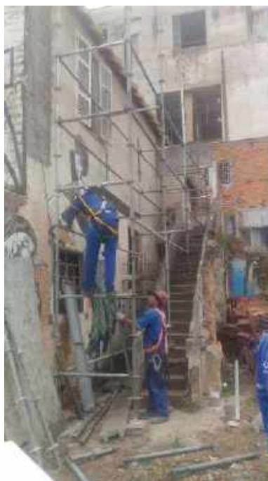
Foto 17: Montagem de andaime fachadeiro para instalação das tabeiras e calhas da Casa 5.
