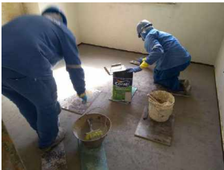
Foto 57 – Execução do piso cimentado pigmentado – Casa 06
