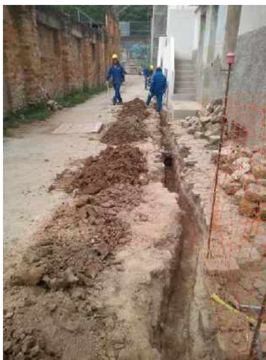
Foto 60 – Instalação cobre nu para malha de pararaio – Casa 06
