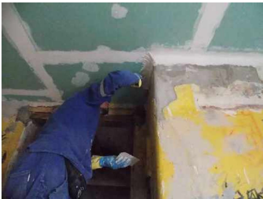
Foto 42 – Instalação do drywall e execução da curva de gesso – Casa 06
