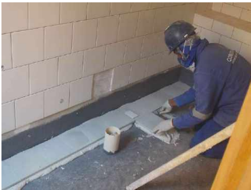
Foto 62 – Instalação dos pisos dos banheiros – Casa 06
