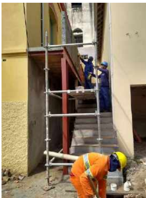
Foto 05 – Execução da argamassa de acabamento do guarda corpo
