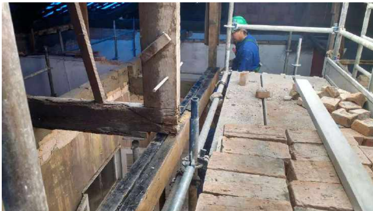
Foto 21: Restauro e instalação de viga dupla existente.
