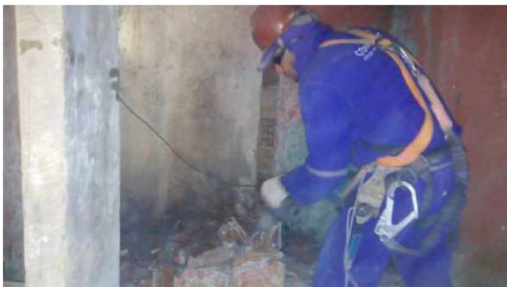
Foto 12 – Demolição manual da parede – Casa 06
