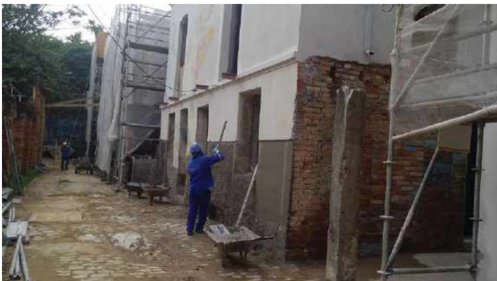
Foto 27 – Execução do revestimento chapiscado da fachada – Casa 06
