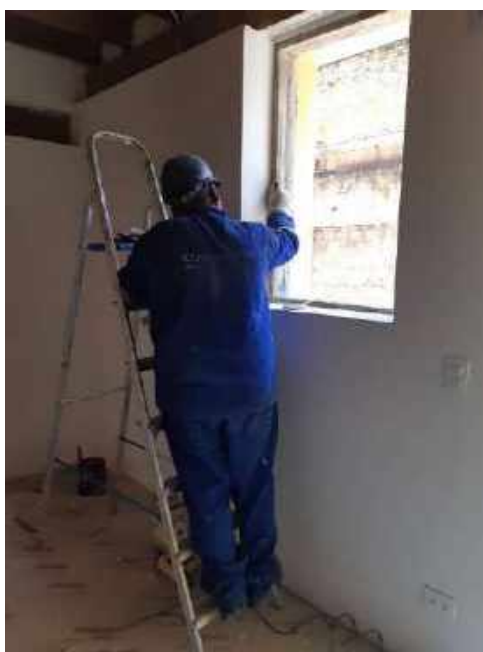
Foto 32 – Aplicação de massa para madeira nos batentes – Casa 06
