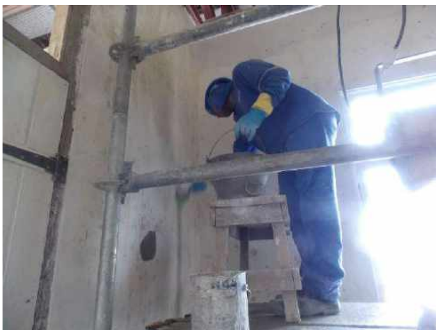
Foto 32 – Fechamento das imperfeições das paredes internas – Casa 06
