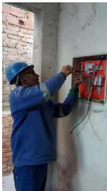
Foto 51 – Instalação dos quadros elétricos – Casa 06
