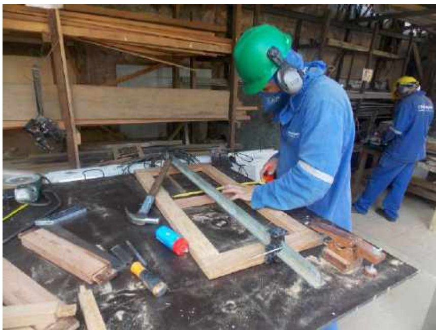
Foto 05 – Execução das esquadrias de madeira – Casa 05
