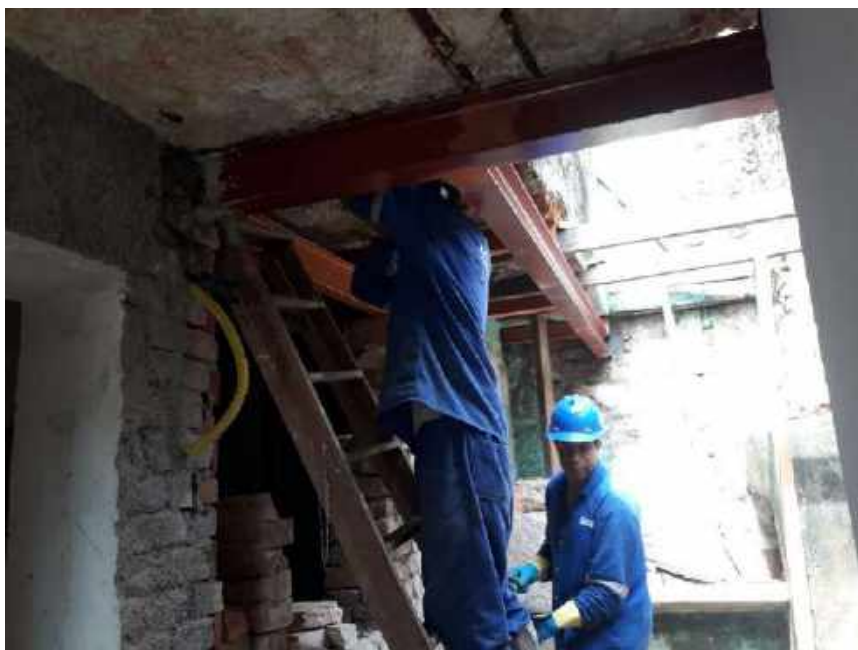
Foto 03 – Instalação do perfil metálico – Casa 05
