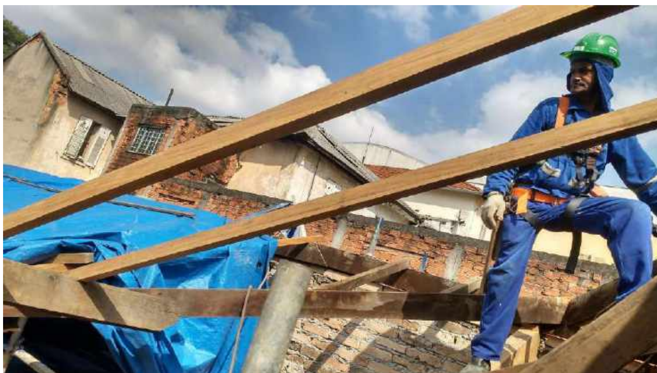
Foto 34: Instalação dos caibros.
