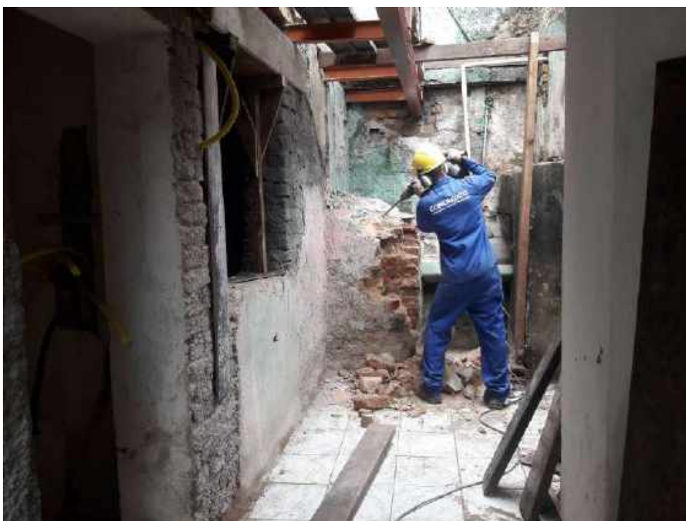
Foto 10 – Demolição manual da alvenaria existente – Casa 05
