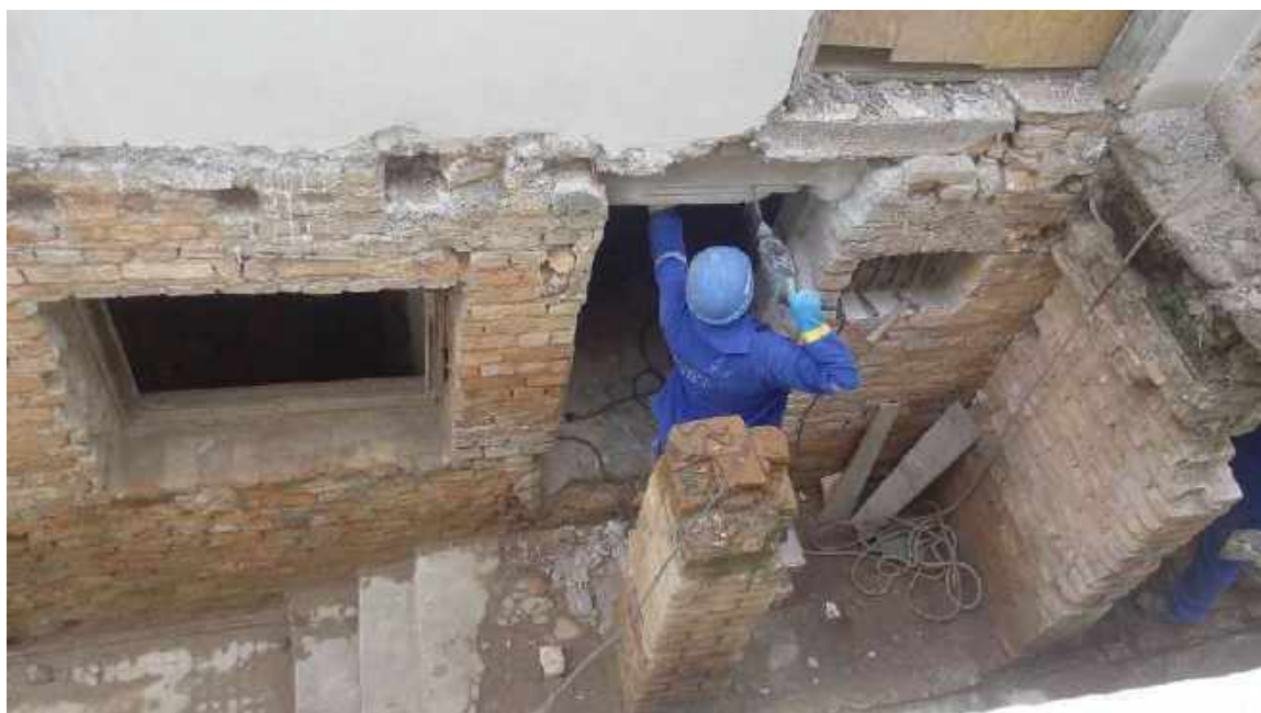
Foto 24 – Demolição manual – Casa 06
