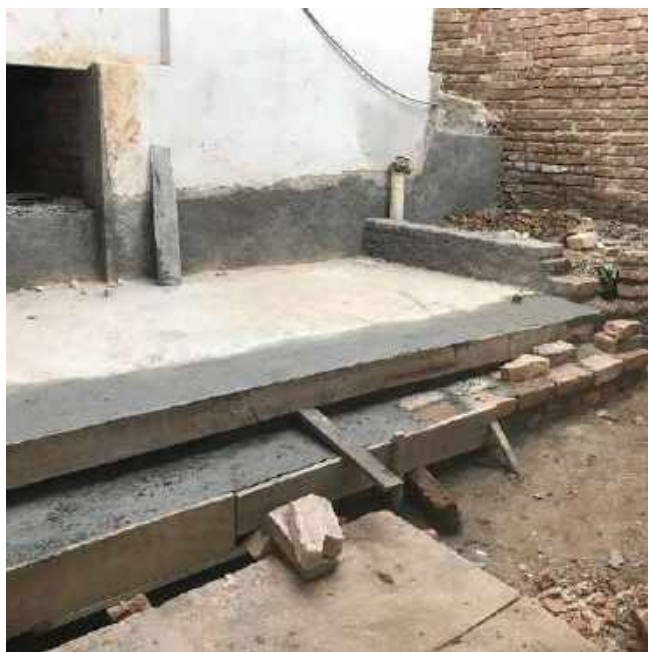
Foto 68 – Execução do degrau – Casa 06
