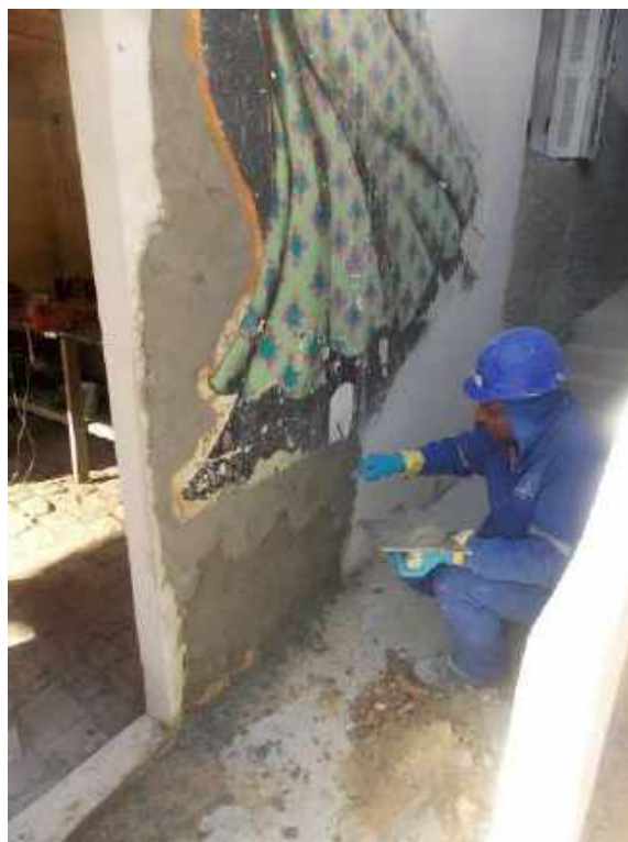
Foto 04 – Execução do emboço da fachada lateral – Casa 05
