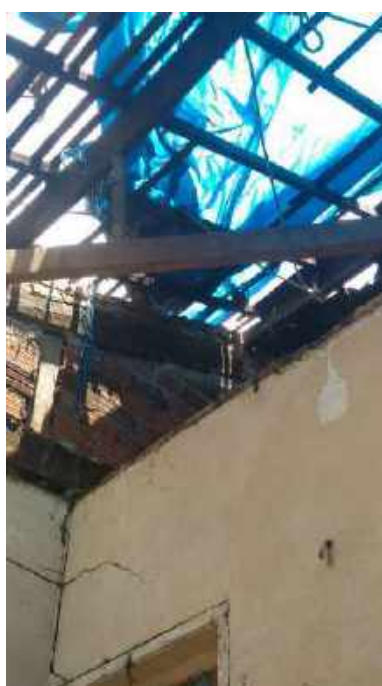
Foto 10: Remoção das telhas coloniais e retirada das ripas e caibros da Casa 6.
