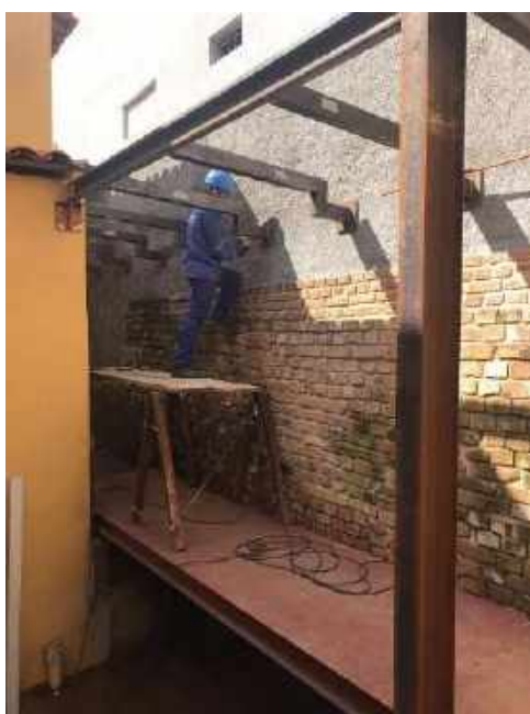
Foto 25 – Instalação da estrutura metálica para execução da cobertura
