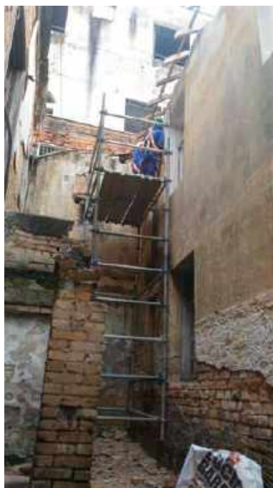
Foto 09: Tratamento das trincas da fachada – Casa 5
