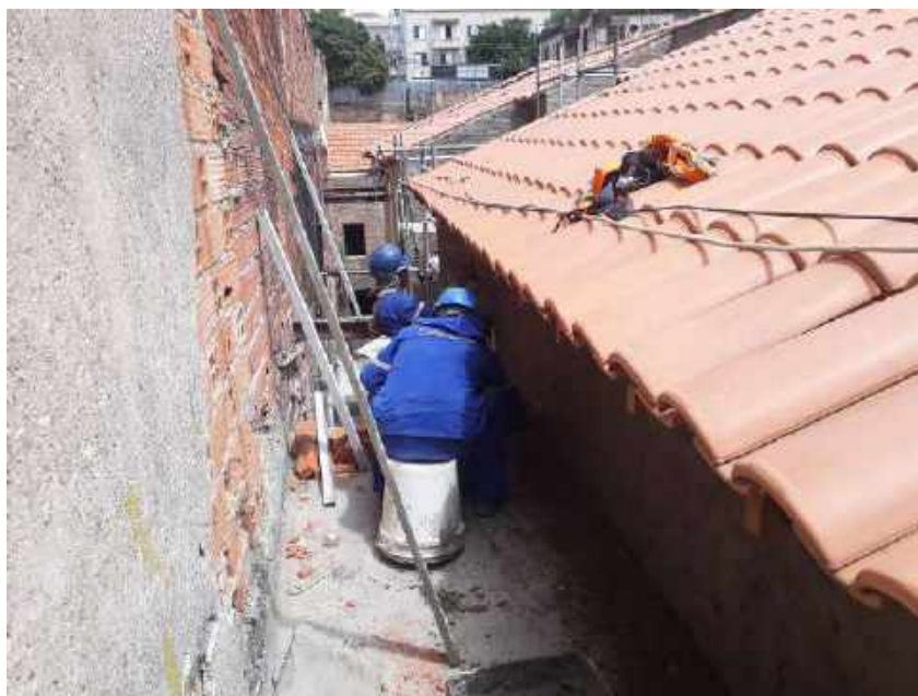
Foto 37 – Execução do revestimento – Casa 06
