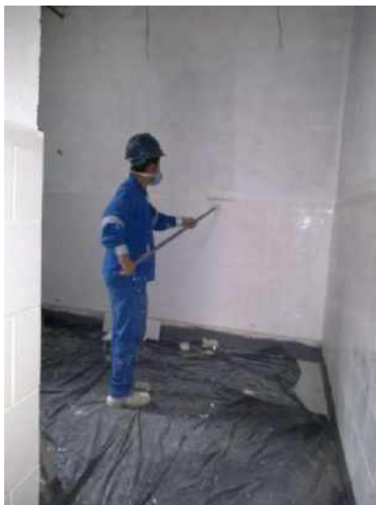
Foto 57 – Execução da pintura lisa das paredes – Casa 06
