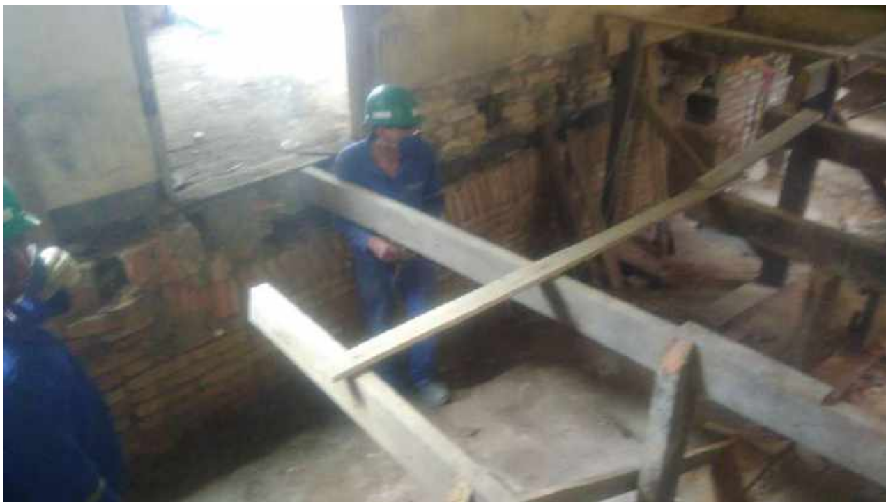
Foto 53 – Reorganização dos embasamentos após a remoção dos pisos – Casa 06
