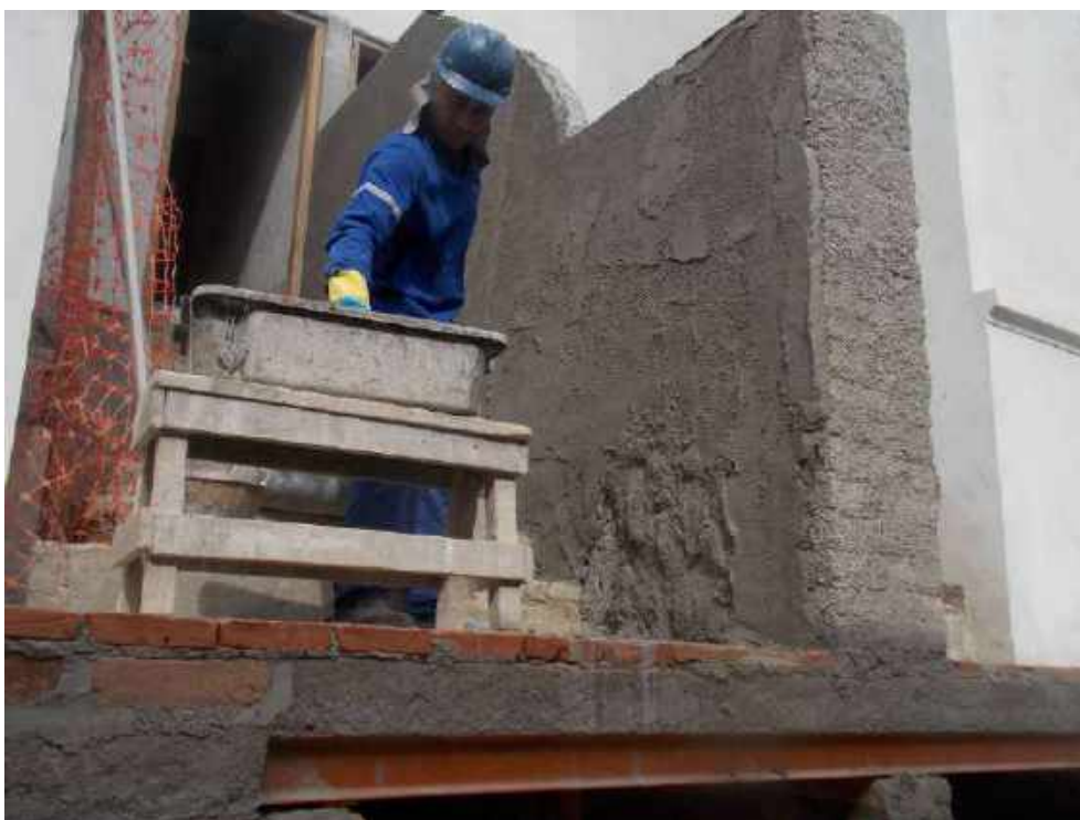
Foto 47 – Execução do emboço – Casa 06
