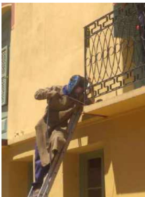
Foto 24 – Instalação do gradil na sacada
