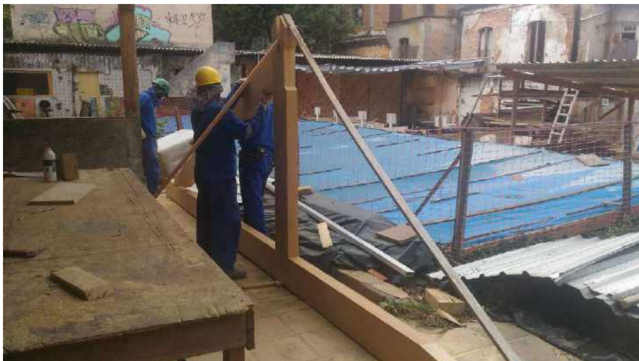
Foto 34: Execução das tesouras – Casa 6.
