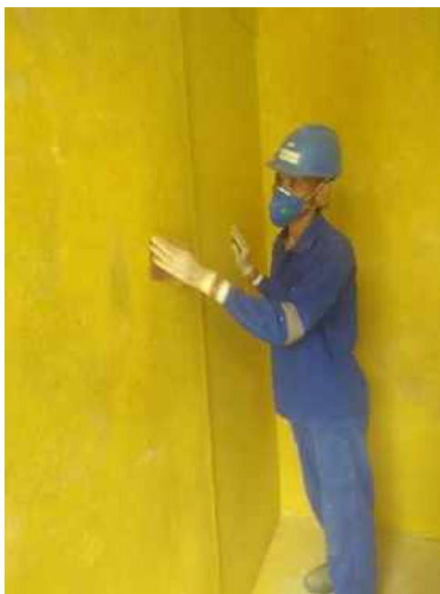
Foto 28 - Execução do processo de envelhecimento das paredes internas – Casa 06
