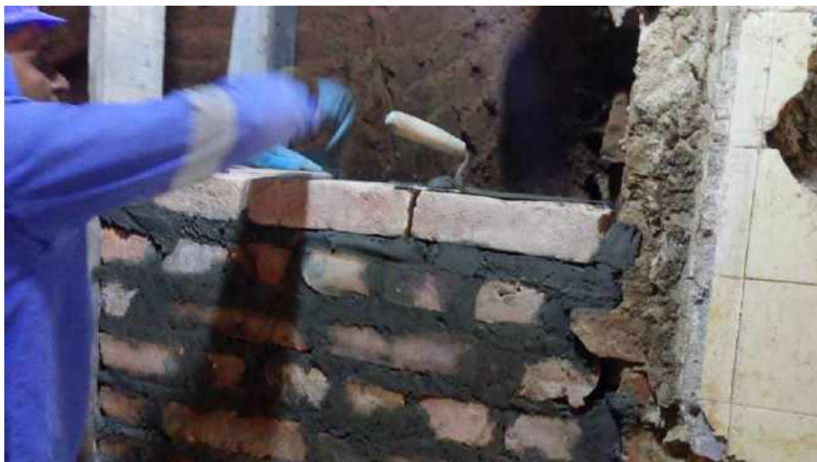
Foto 11 - Elevação da alvenaria externa após escavação do fosso do elevador
