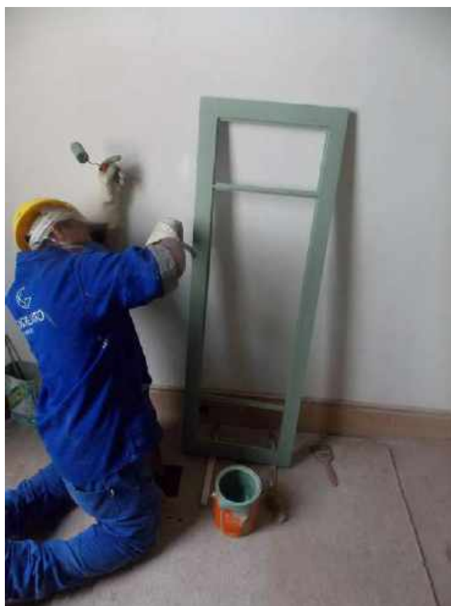
Foto 38 – Pintura lisa das esquadrias de madeira – Casa 06
