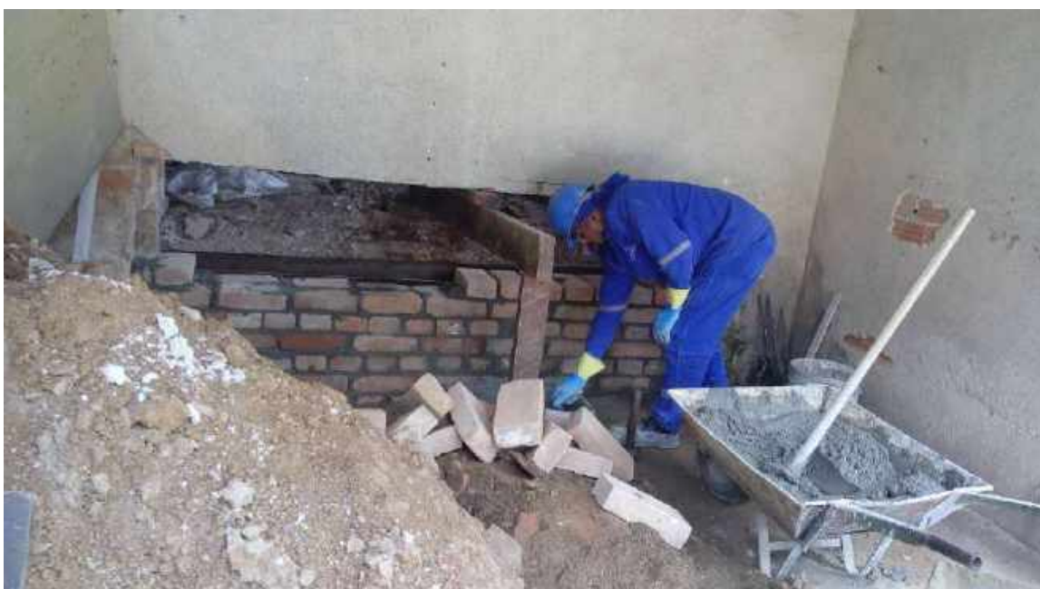
Foto 10 – Elevação da alvenaria – Casa 05
