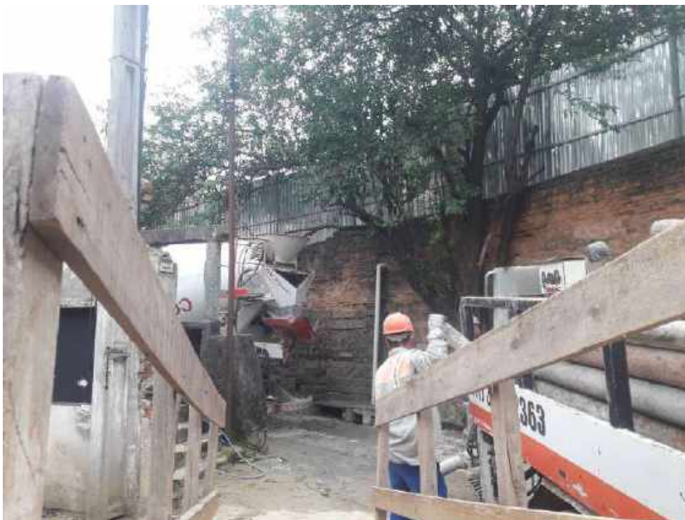
Foto 59 – Concretagem da cortina – Casa 06
