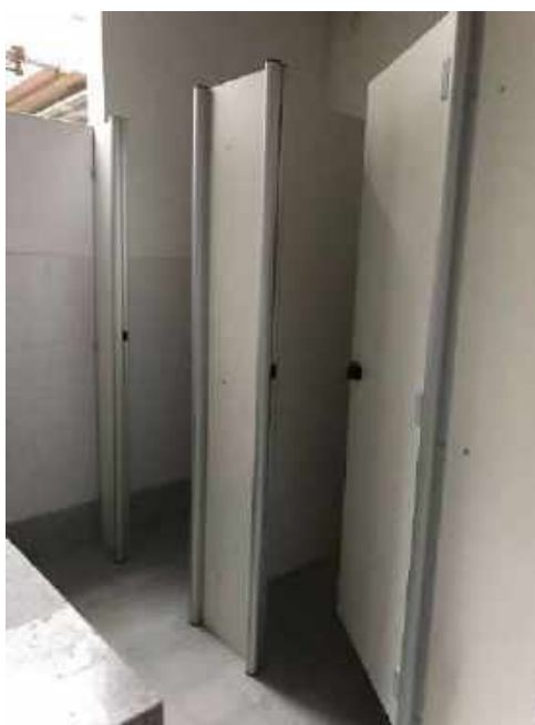
Foto 71 – Instalação das divisórias dos banheiros – Casa 06
