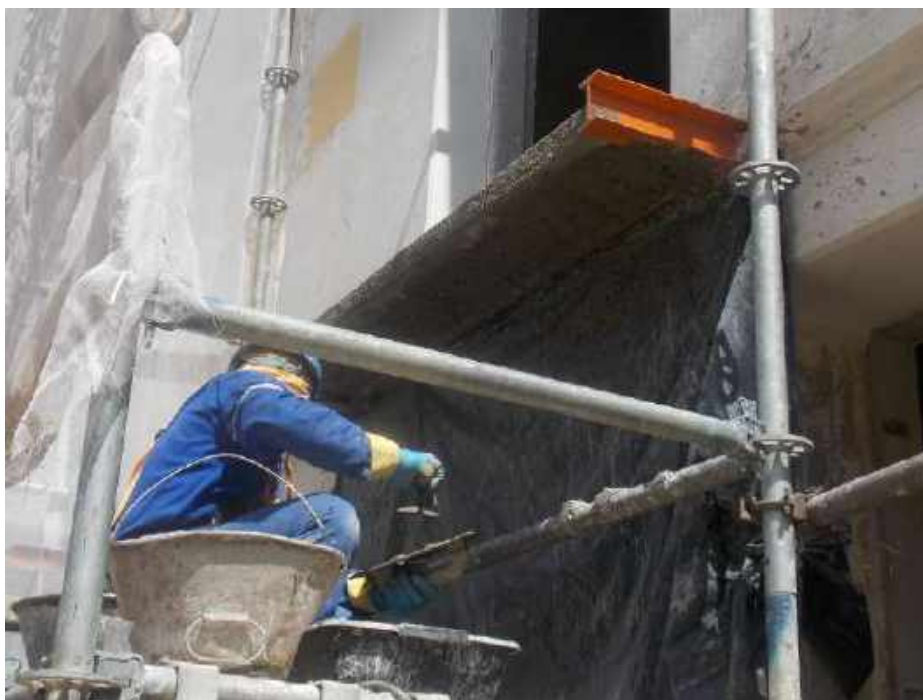
Foto 19 – Execução da varanda – Casa 06
