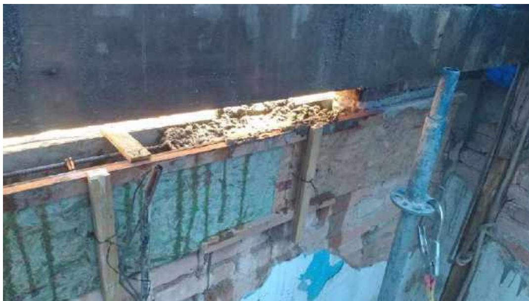
Foto 08: Concretagem da cinta de concreto – Casa 6.
