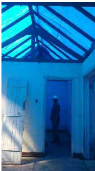
Foto 05: Remoção das telhas, caibros e ripas da Casa 5.
