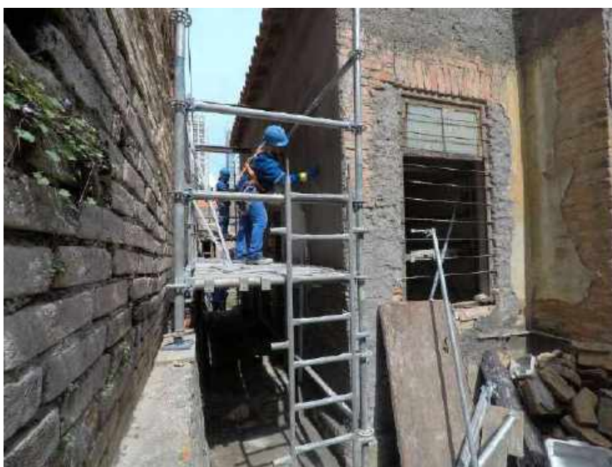
Foto 38 – Execução do emboço da fachada
