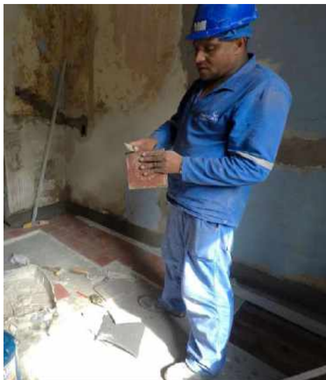
Foto 01 – Instalação dos ladrilhos hidráulicos – Casa 05
