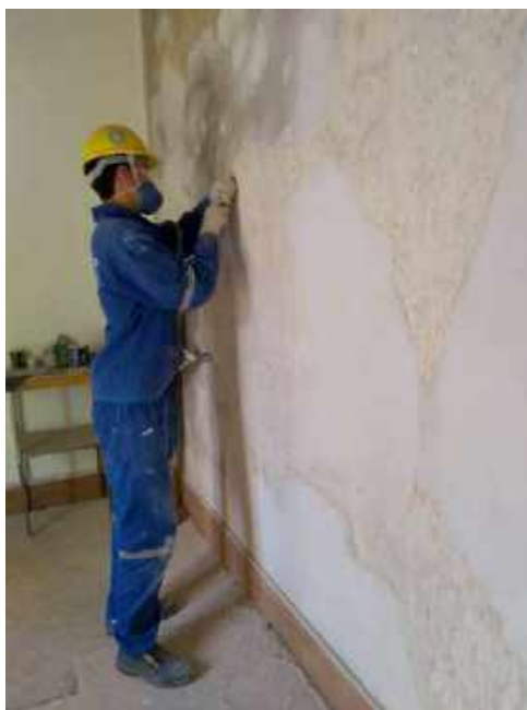
Foto 05 – Decapagem manual das paredes internas – Casa 05
