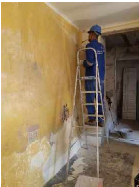
Foto 27 – Execução do processo de envelhecimento das paredes internas – Casa 06
