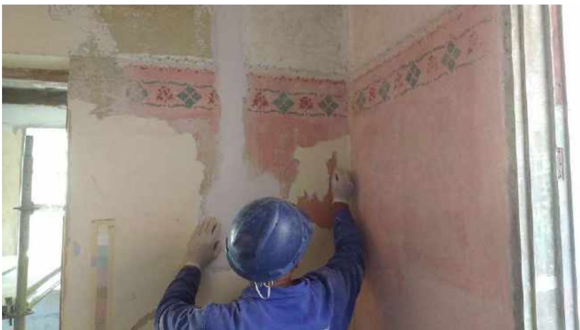
Foto 02 – Decapagem mecânica – Casa 05
