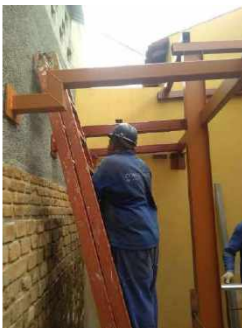
Foto 33 – Pintura lisa das estruturas metálicas
