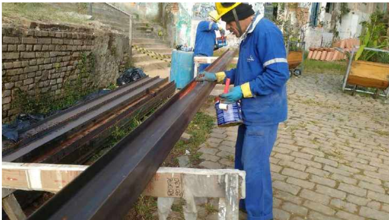
Foto 41: Pintura de proteção dos perfis metálicos da cobertura.
