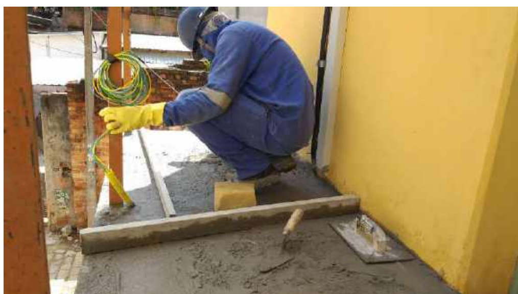
Foto 10- Concretagem da passarela de acesso da escada da fachada lateral
