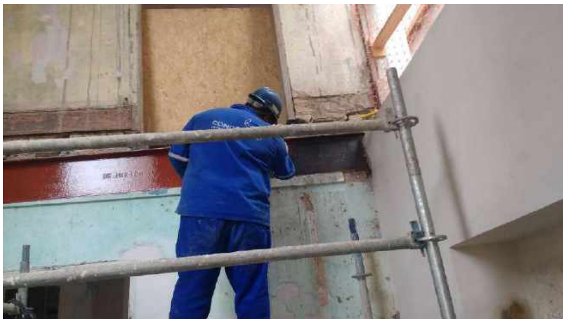
Foto 31 – Recuperação da estrutura metálica – Casa 06
