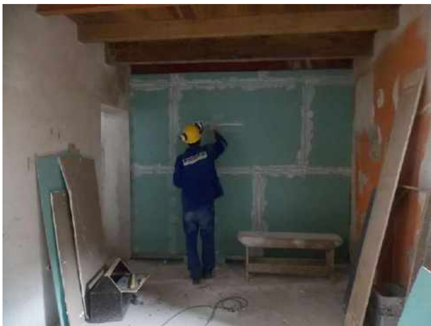
Foto 17 – Instalação do drywall – Casa 05
