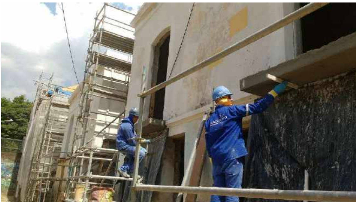
Foto 23 – Execução da varanda – Casa 06
