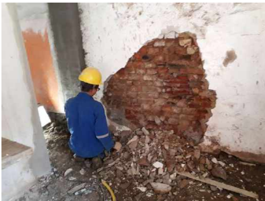
Foto 06 – Remoção do revestimento antigo – Casa 05
