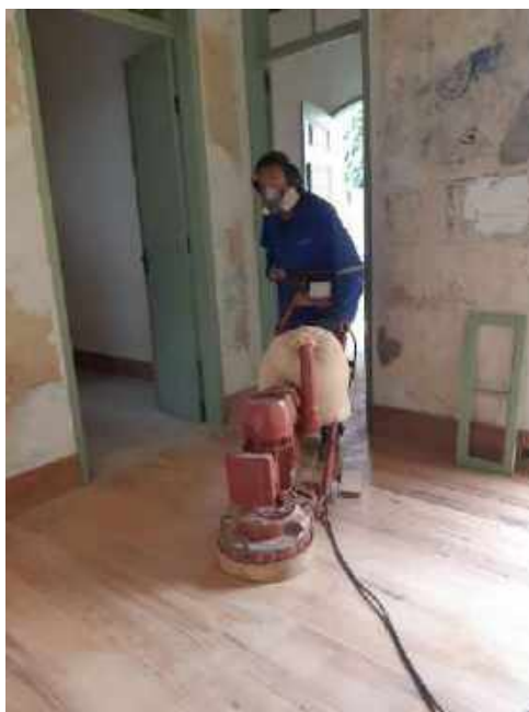
Foto 10 – Lixamento dos assoalhos de madeira – Casa 06
