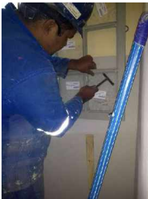
Foto 07 – Instalação dos vidros das janelas de madeira – Casa 05
