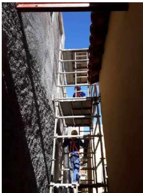
Foto 19 – Montagem do andaime nós fundos (para acesso da cobertura da casa vizinha) – Casa 06
