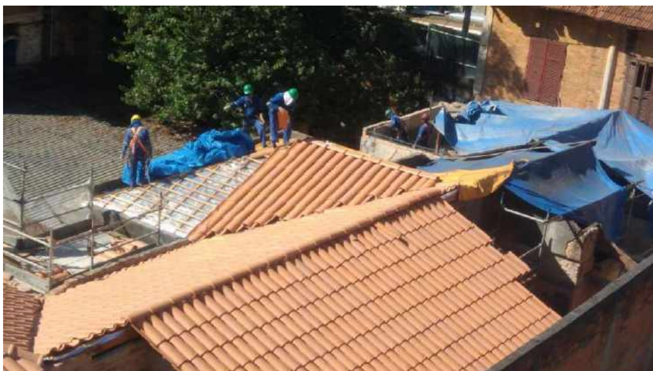
Foto 84: Instalação das telhas capa canal - Casa 06
