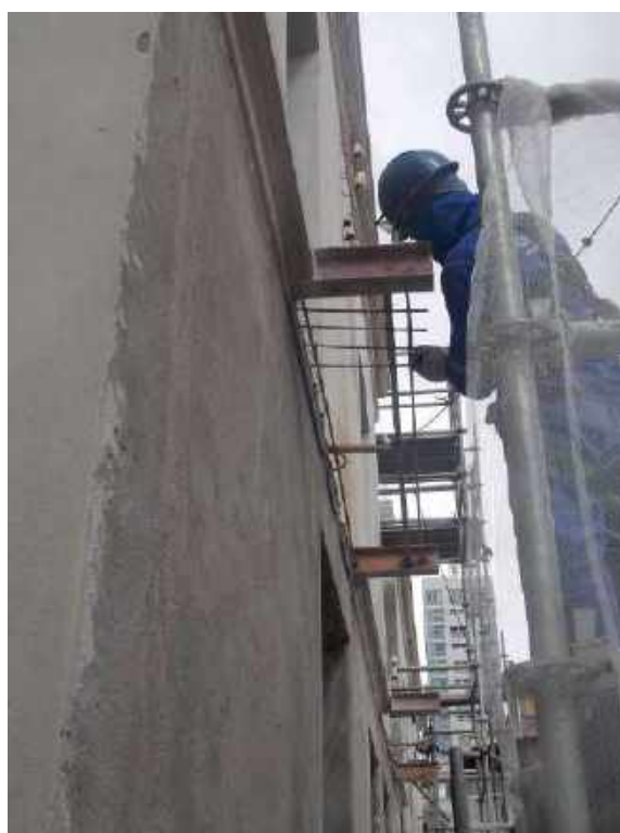
Foto 16 – Execução da armação da varanda – Casa 06
