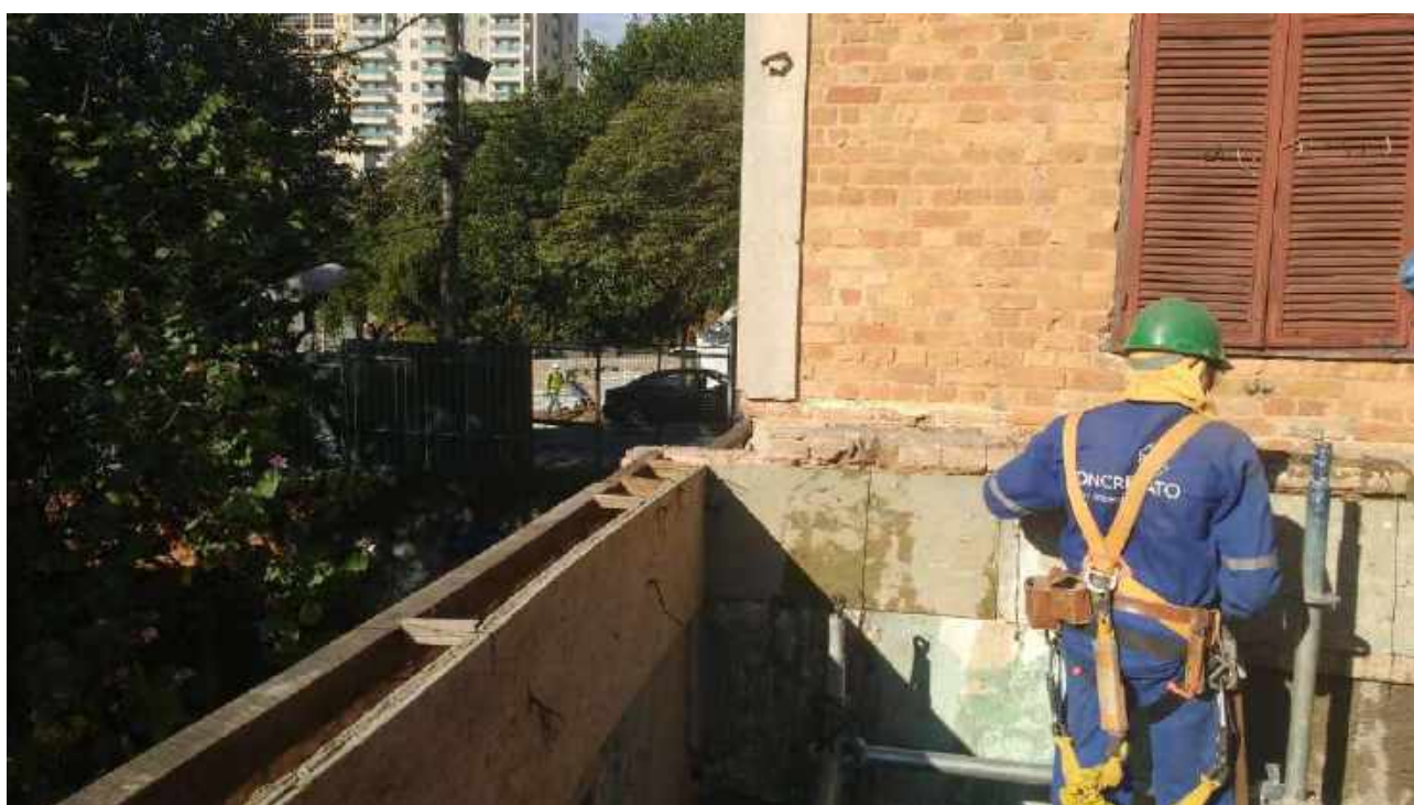
Foto 66: Concretagem da cinta – Casa 06
