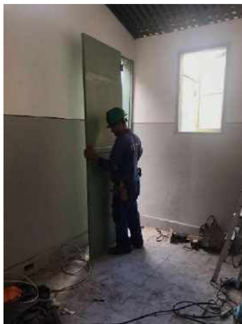
Foto 12- Instalação das portas de madeira
