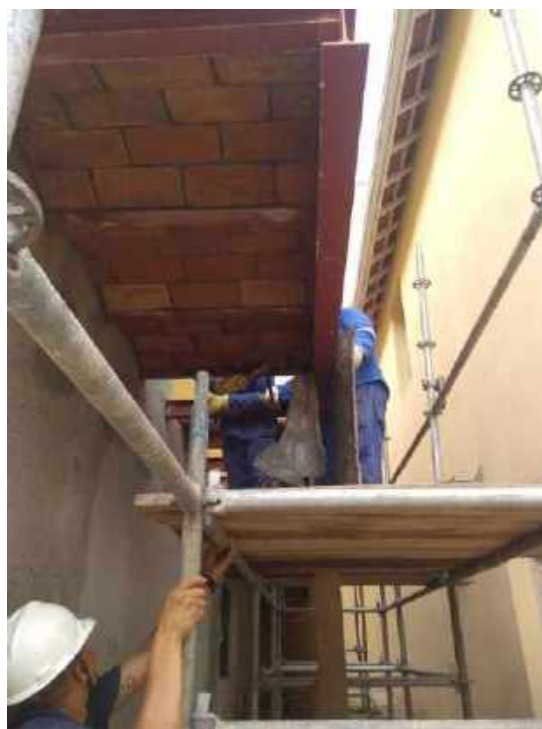
Foto 06 – Reprodução da abobadilha da escada da fachada lateral
