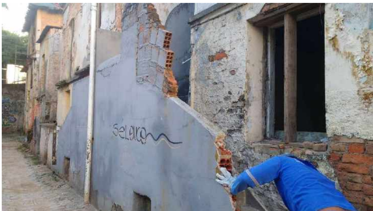
Foto 20: Desmontagem da escada.
