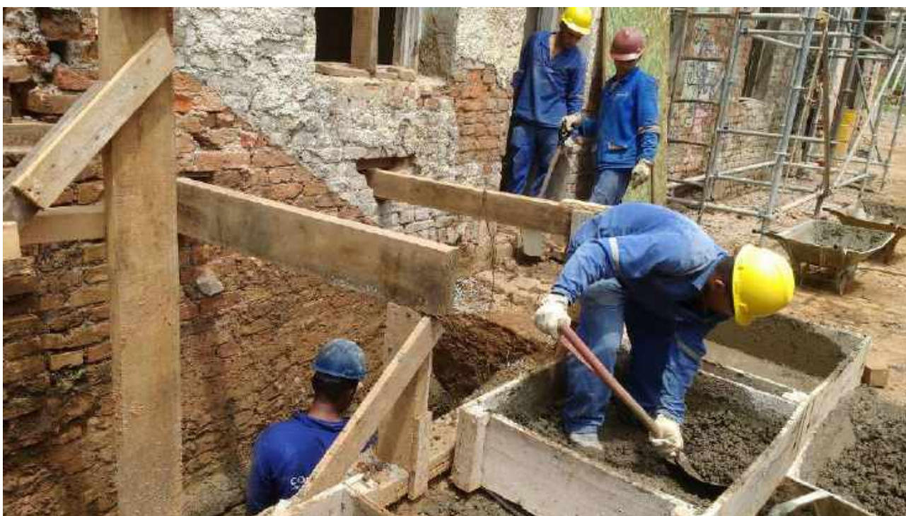
Foto 33: Concretagem do bloco de fundação.
