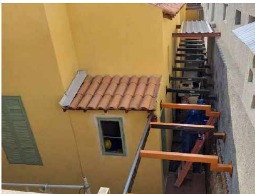
Foto 2 - Instalação da estrutura metálico para execução da cobertura de vidro– Casa 06
