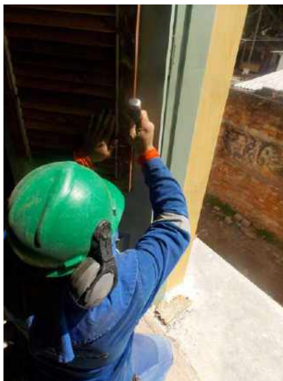
Foto 24 – Aplicação de massa para madeira nos batentes – Casa 06
