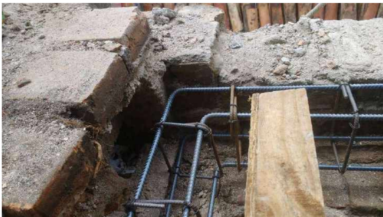
Foto 17: Execução da verga das esquadrias
