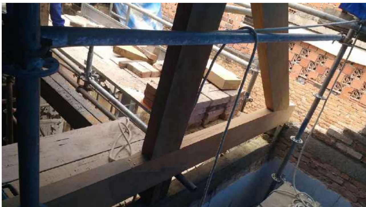
Foto 06: Substituição das peças danificadas da tesoura da Casa 6.
