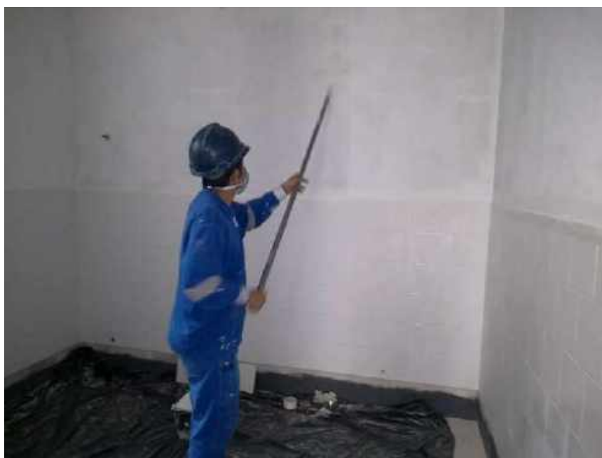
Foto 58 – Execução da pintura lisa das paredes – Casa 06
