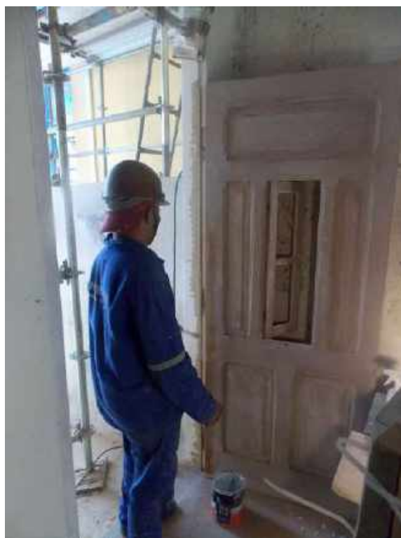
Foto 34 – Emassamento das portas de madeira – Casa 06
