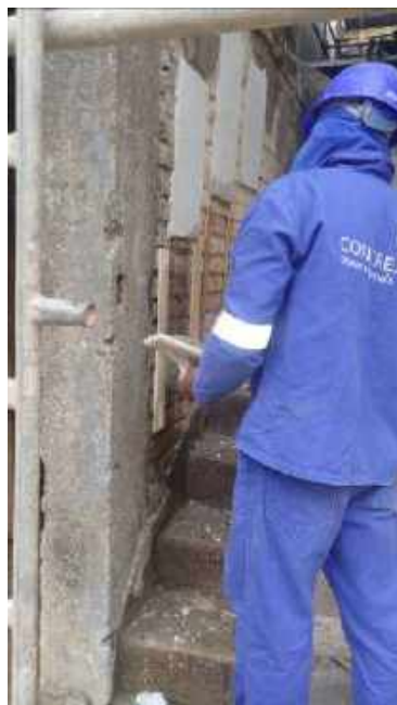
Foto 39 – Teste de revestimento na fachada – Casa 06
