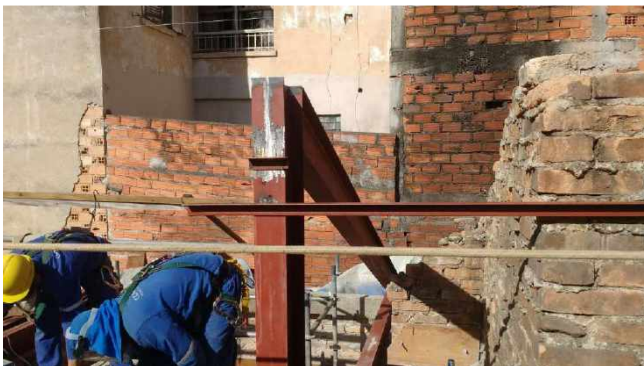
Foto 70: Execução da estrutura metálica da Casa 6
