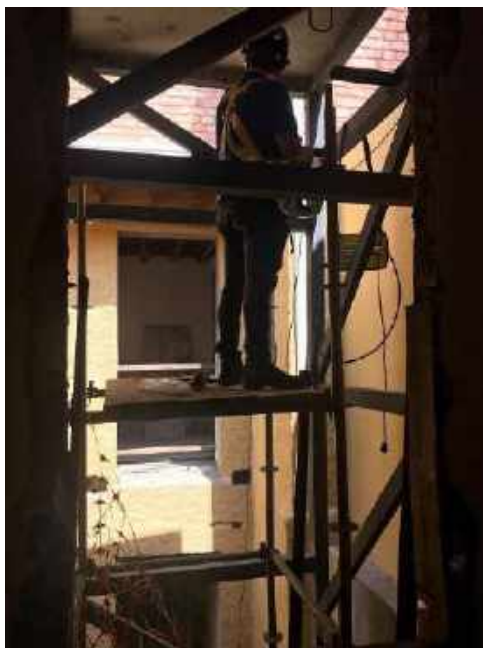
Foto 46 - Montagem da plataforma elevatória
