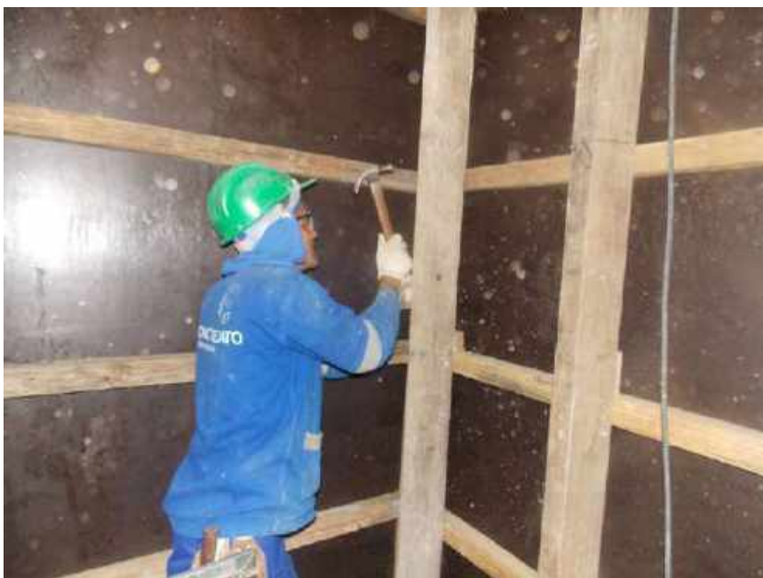
Foto 55 - Execução da forma para concretagem da cortina – Casa 06
