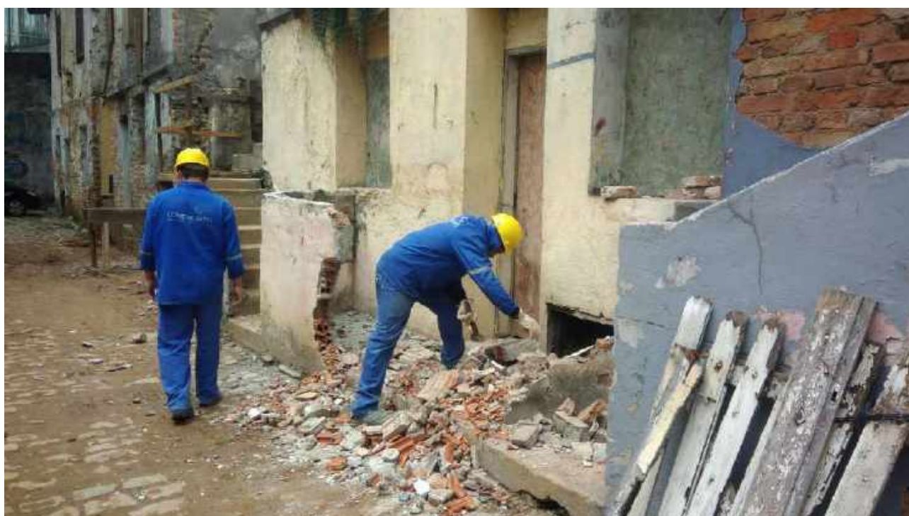
Foto 76: Substituição das peças danificadas da tesoura da Casa 6.
