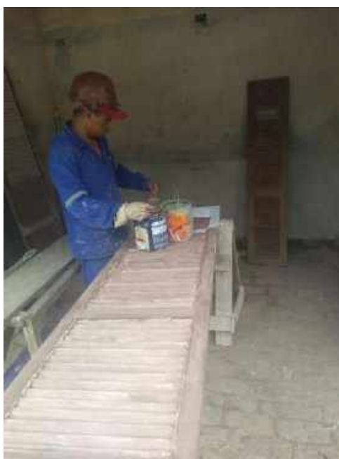
Foto 14 – Aplicação de massa de madeira nas venezianas de madeira – Casa 06
