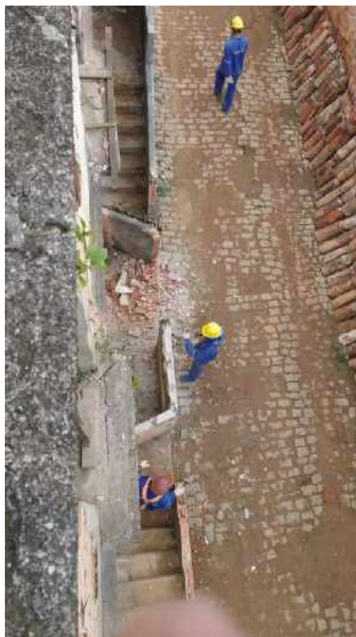
Foto 37: Demolição das alvenarias para adequação do novo uso.
