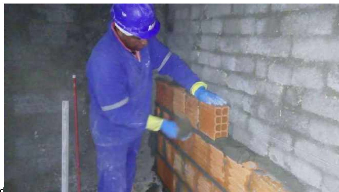
Foto 16 – Elevação da alvenaria – Casa 06
