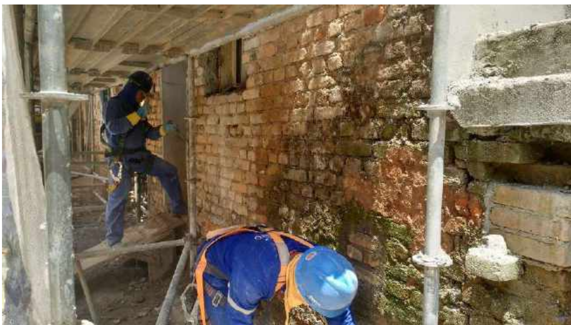
Foto 26 - Remoção do chapisco da fachada – Casa 06
