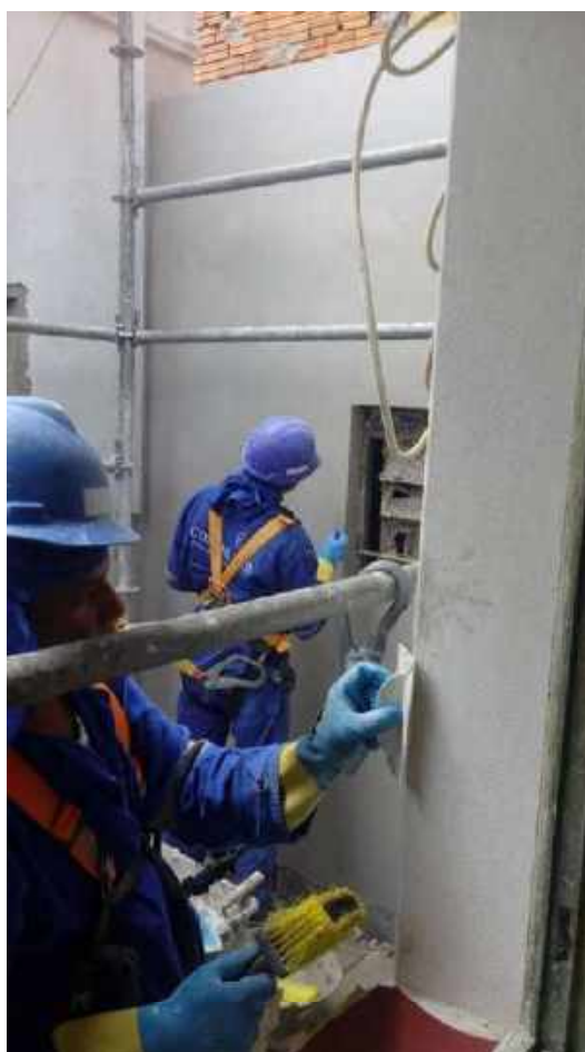
Foto 56 – Execução de reboco das fachadas internas da Casa 6
