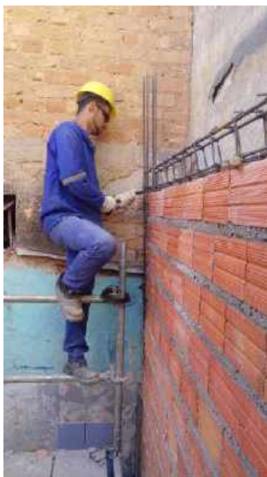
Foto 13 – Execução da alvenaria (Instalação das Ferragens) Casa 06
