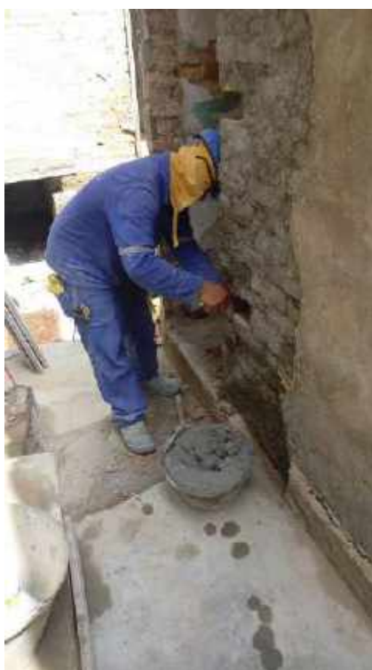
Foto 16 – Recuperação da alvenaria
