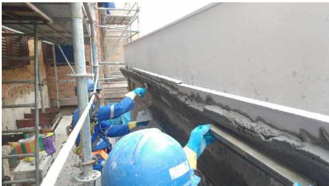
Foto 27 – Execução da argamassa de acabamento da fachada – Casa 06
