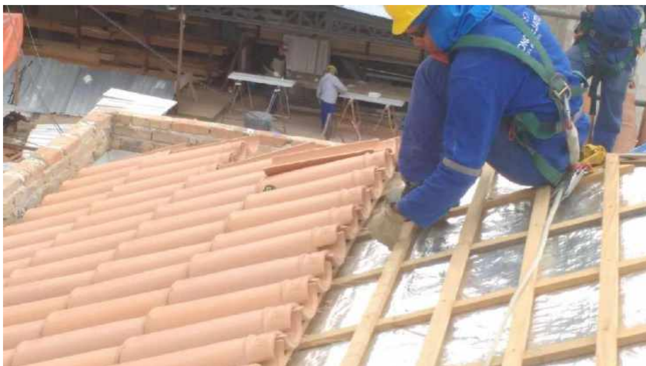
Foto 46: Instalação de telhas cerâmicas.
