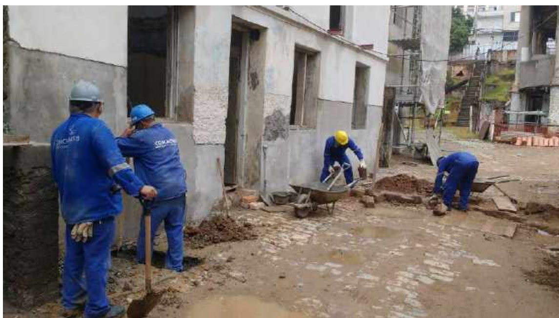
Foto 30 – Drenagem dos pisos do pavimento A – Casa 06
