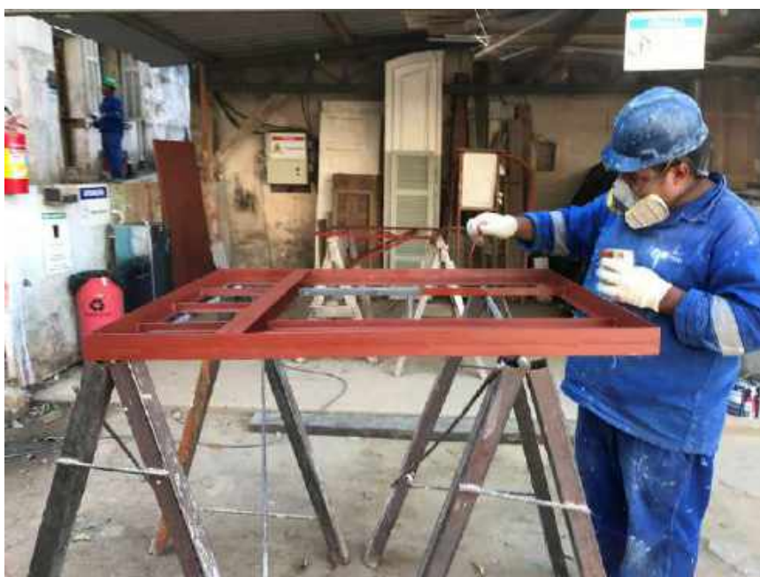
Foto 18 – Pintura lisa da esquadria metálica – Casa 05
