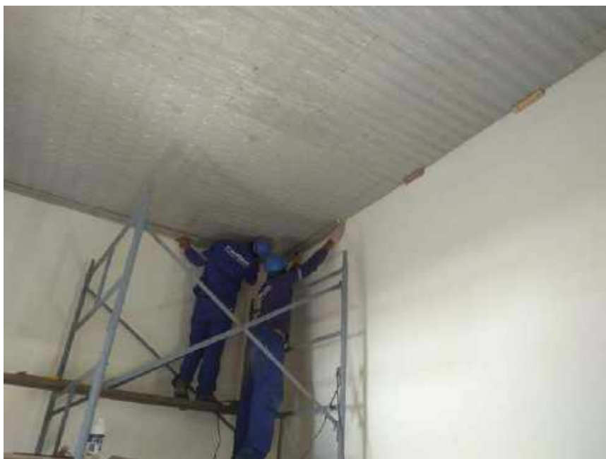
Foto 19 – Instalação do roda - teto no forro metálico
