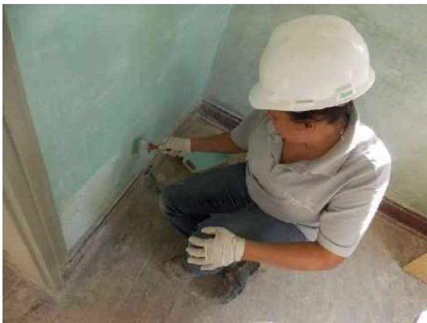
Foto 21 – Execução da reintegração da tonalidade – Casa 05
