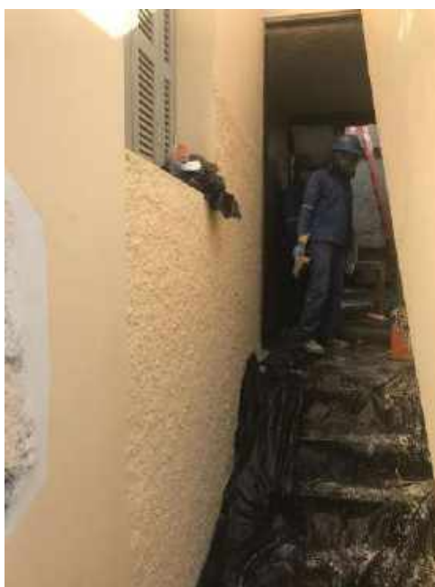
Foto 10 – Caiação no chapisco da fachada lateral – Casa 05
