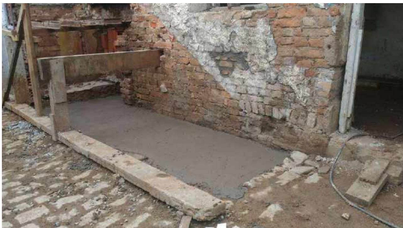
Foto 15: Concretagem do bloco no local da escadaria.
