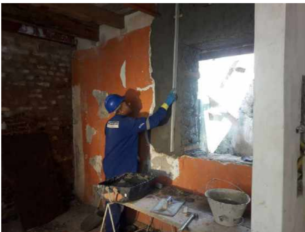
Foto 14 – Execução do emboço das paredes internas – Casa 05
