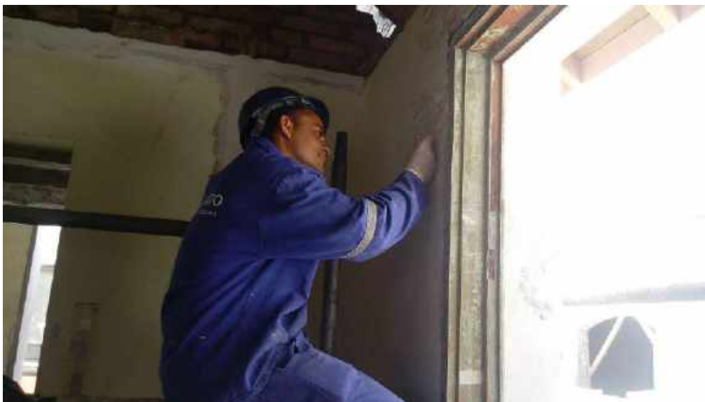
Foto 45 – Decapagem cuidadosa das tintas existentes sobre a pintura decorativa – Casa 05
