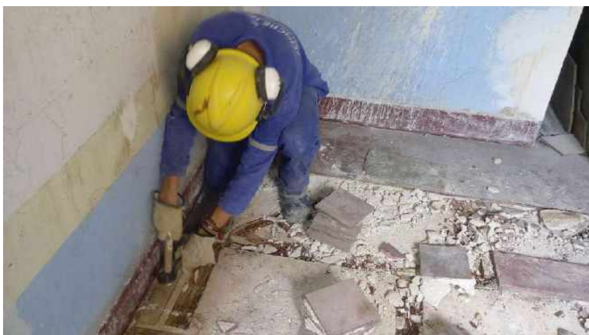
Foto 58 – Remoção dos pisos de ladrilho hidráulico
