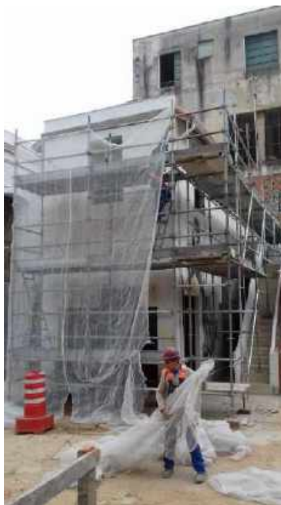
Foto 30 – Instalação da tela fachadeira – Casa 05
