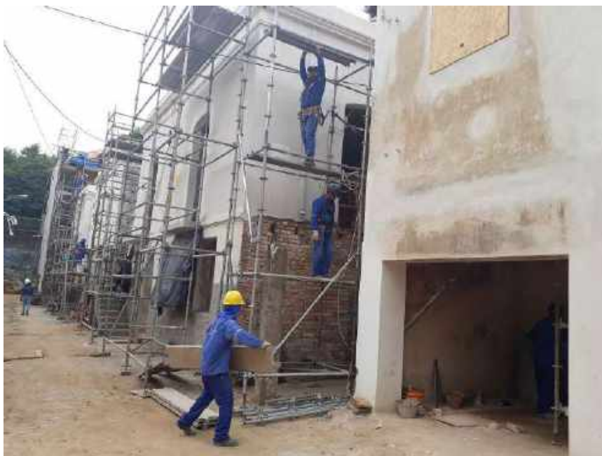
Foto 11 – Montagem do andaime da fachada lateral – Casa 06
