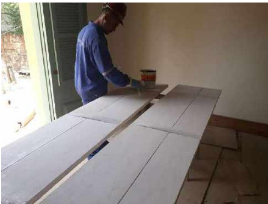
Foto 06 – Aplicação de massa nas portas de madeira – Casa 06
