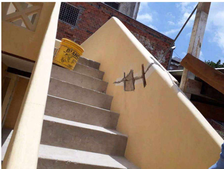
Foto 54 – Tratamento das trincas no guarda corpo da escada - Casa 05
