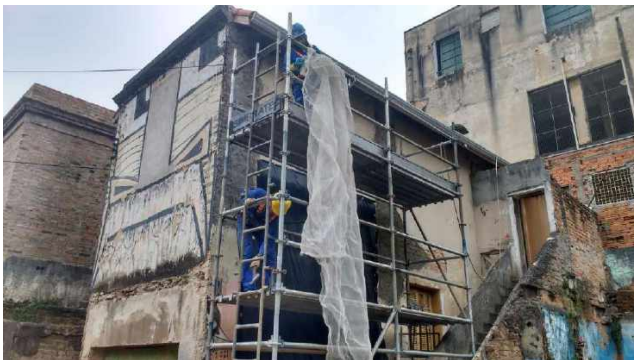
Foto 32: Montagem de andaimes.
