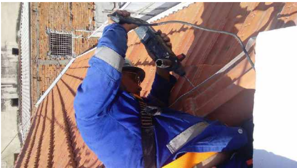
Foto 35 – Instalação das fitas de SPDA na cobertura – Casa 06
