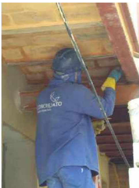
Foto 06 – Execução da argamassa de acabamento da abobadilha
