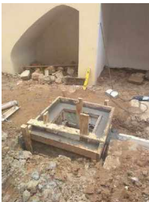
Foto 09 - Execução das caixas de passagens
