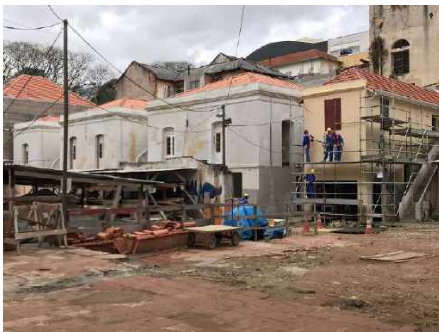
Foto 24 – Desmontagem do andaime da fachada principal – Casa 05
