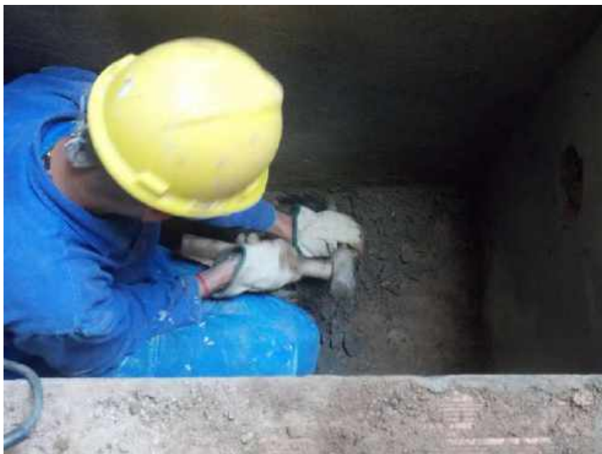
Foto 43 –Instalação da tubulação nas caixas pluviais – Casa 06
