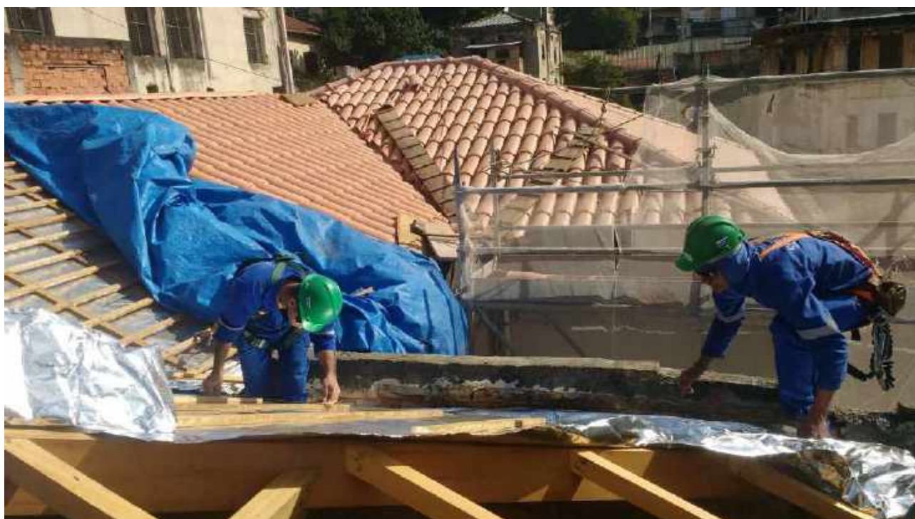
Foto 44: Instalação de manta aluminizada. Casa 06.
