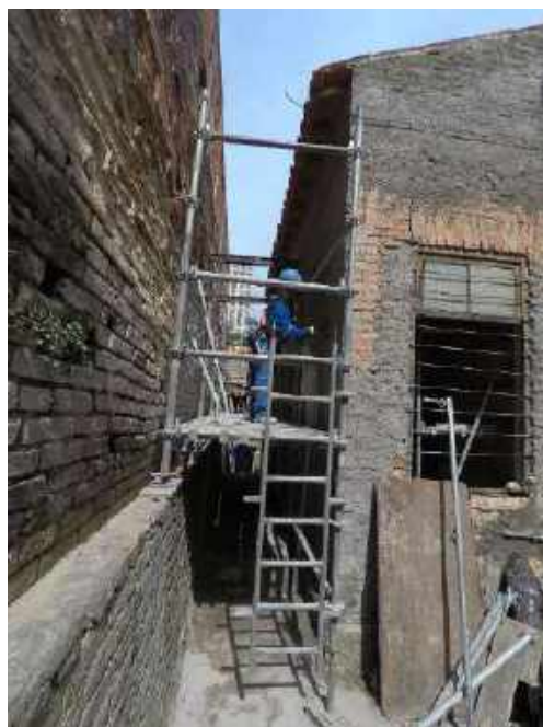
Foto 37 – Execução do emboço da fachada
