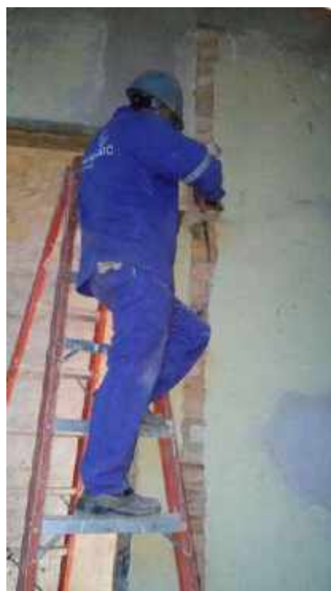
Foto 19 – Instalação de infra estrutura de elétrica.
