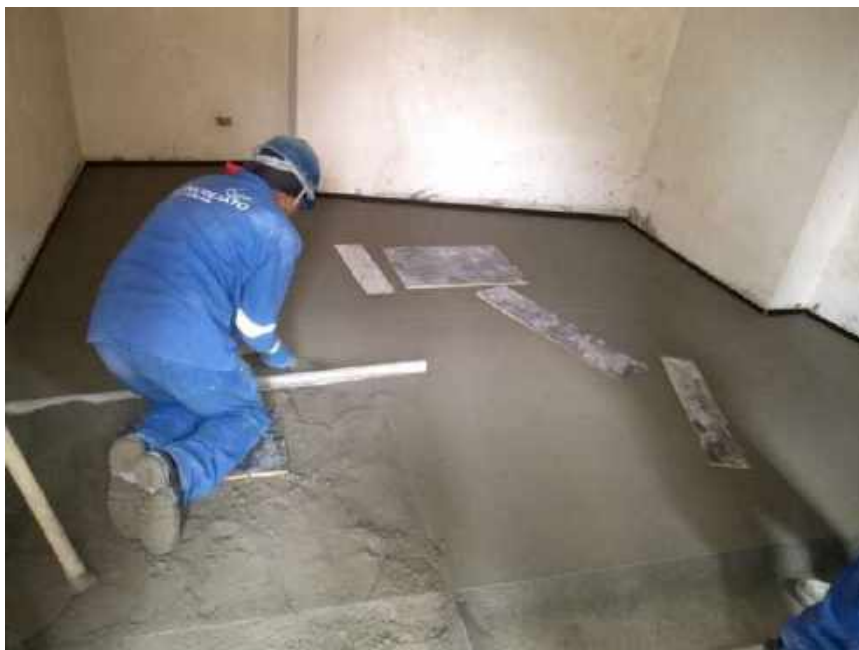
Foto 29 – Execução do piso cimentado – Casa 06
