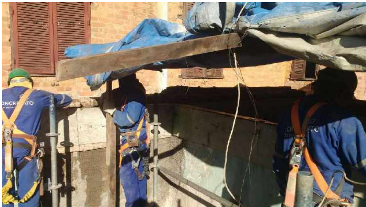
Foto 65: Concretagem da cinta – Casa 06
