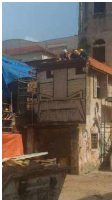
Foto 25: Instalação das calhas e rufos da Casa 5.
