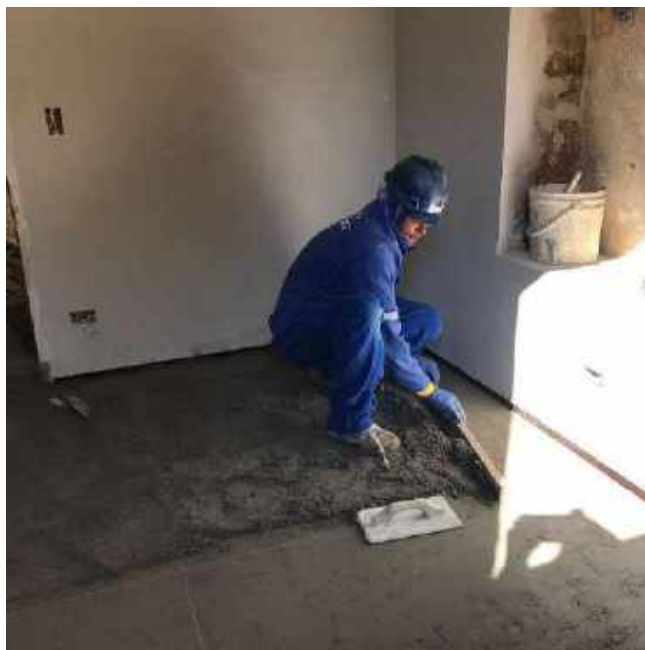
Foto 56 – Execução do piso cimentado pigmentado– Casa 06
