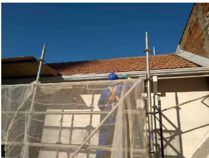
Foto 02 – Pintura lisa das calhas – Casa 05
