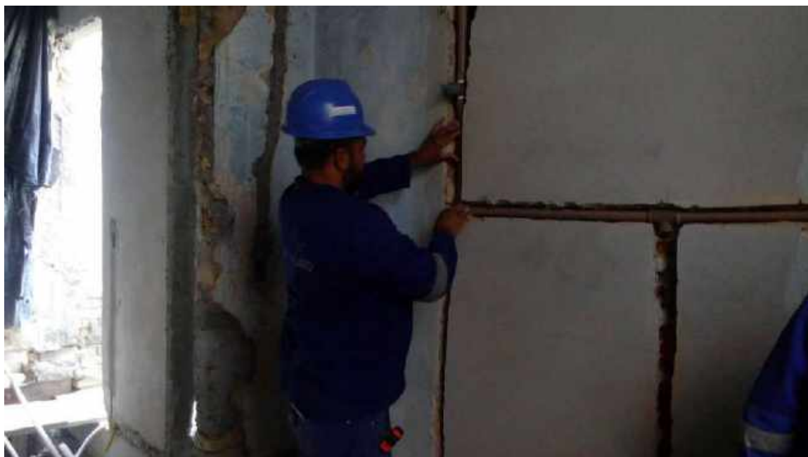
Foto 19 – Instalação da hidráulica – Casa 06
