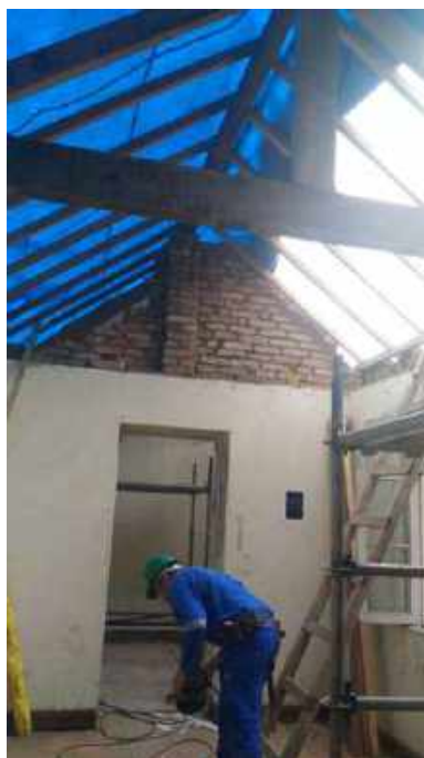
Foto 05: Substituição dos caibros danificados – restauração da cobertura – Casa 5.
