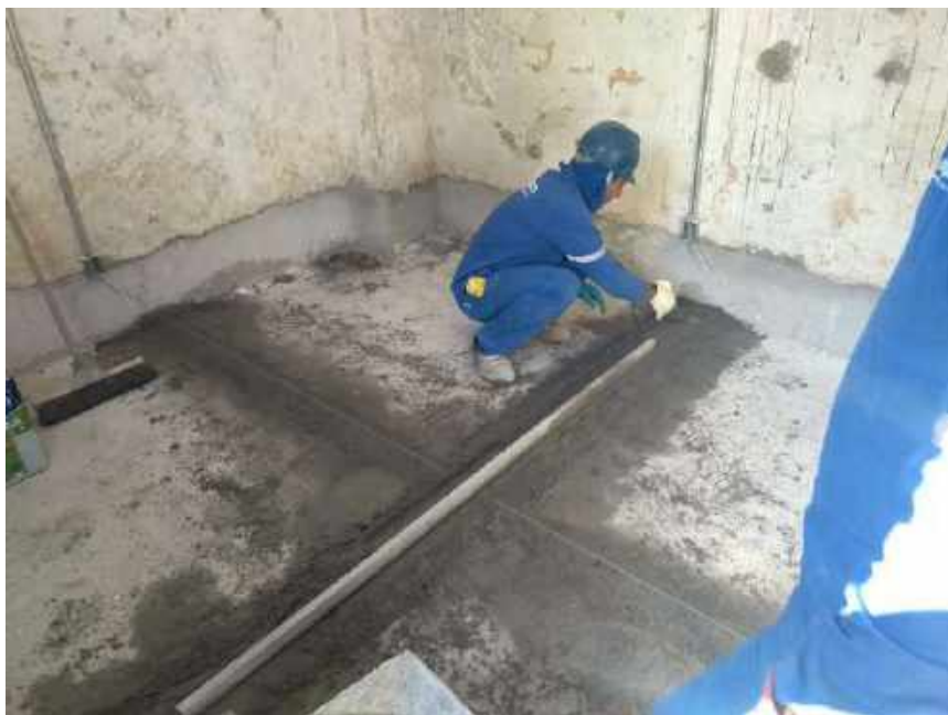
Foto 27 – Instalação da junta de dilatação – Casa 06
