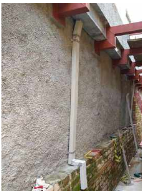
Foto 06 – Instalação das descidas de água – Casa 06
