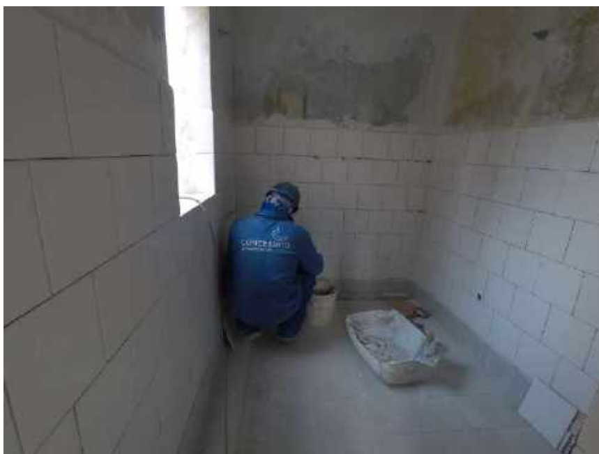
Foto 01 – Instalação dos azulejos do banheiro – Casa 05
