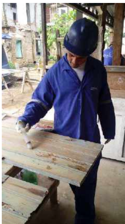
Foto 30 – Restauração das portas de madeira com aplicação de resina - Casa 06
