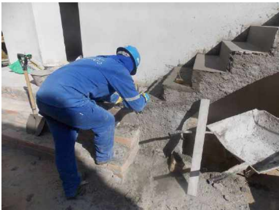
Foto 51 – Regularização da escada – Casa 06
