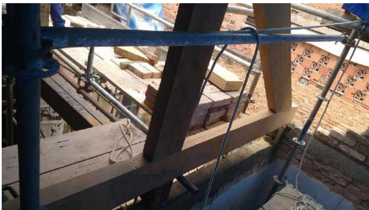
Foto 28: Substituição das peças danificadas da tesoura da Casa 6.
