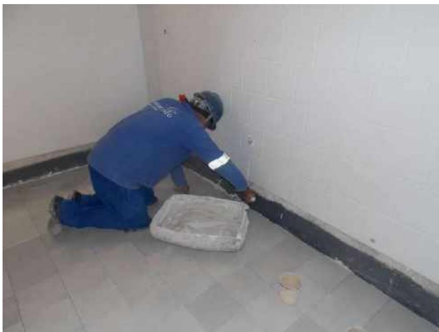
Foto 43 – Instalação dos pisos em ladrilho hidráulico – Casa 06
