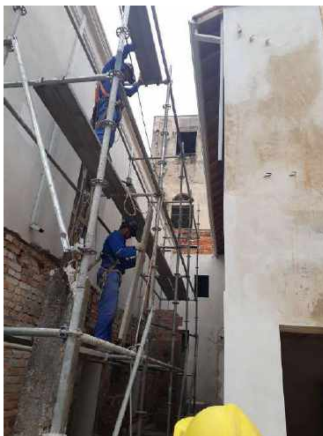
Foto 10 – Montagem do andaime da fachada lateral – Casa 06
