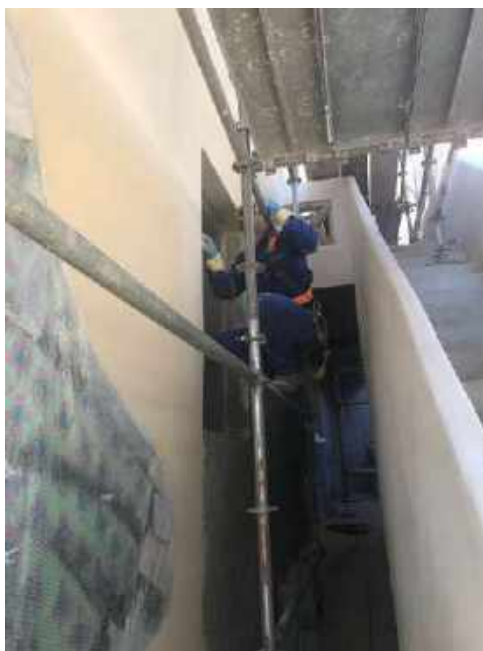
Foto 04 – Pintura lisa da fachada – Casa 05
