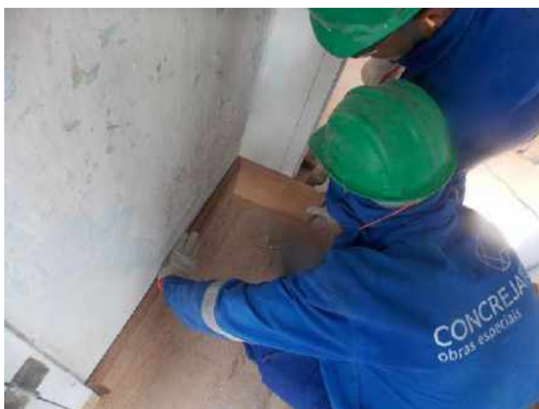
Foto 26 – Instalação do rodapé de madeira – Casa 06
