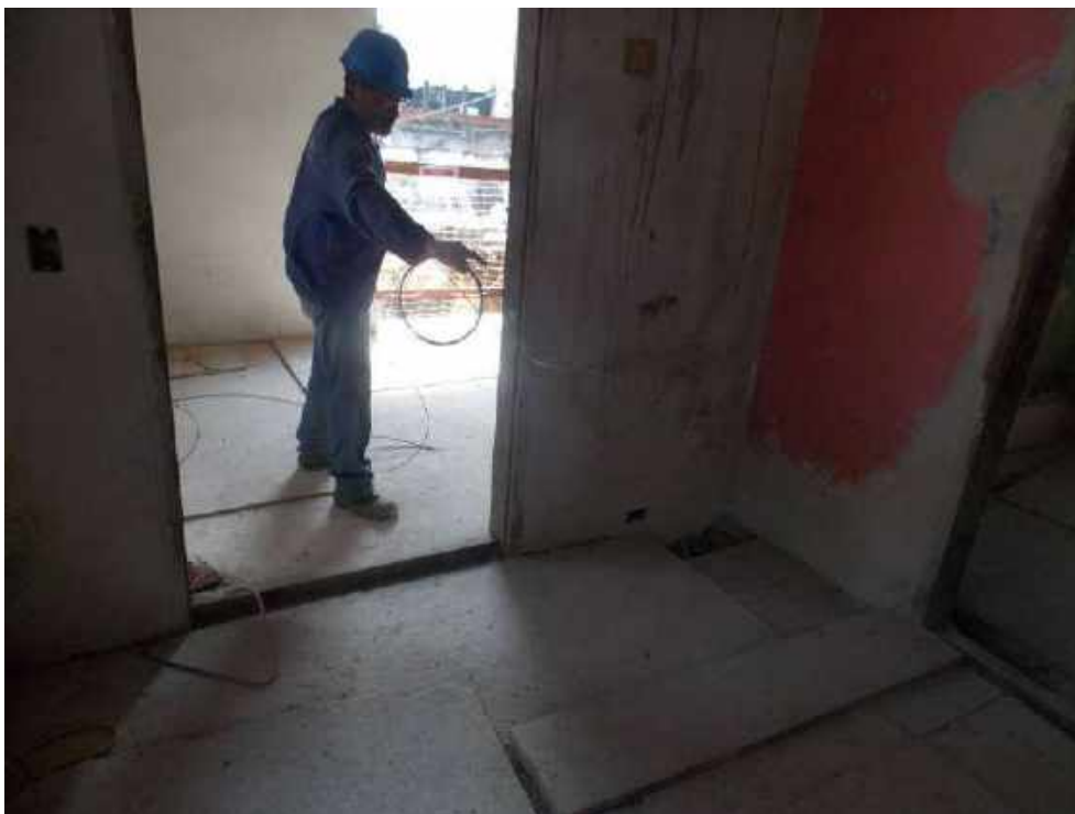
Foto 35 – Passagem dos cabos para instalação elétrica – Casa 06
