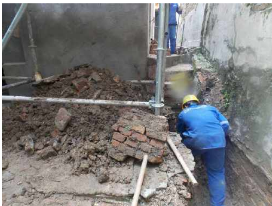
Foto 30 – Escavação manual dos fundos – Casa 06
