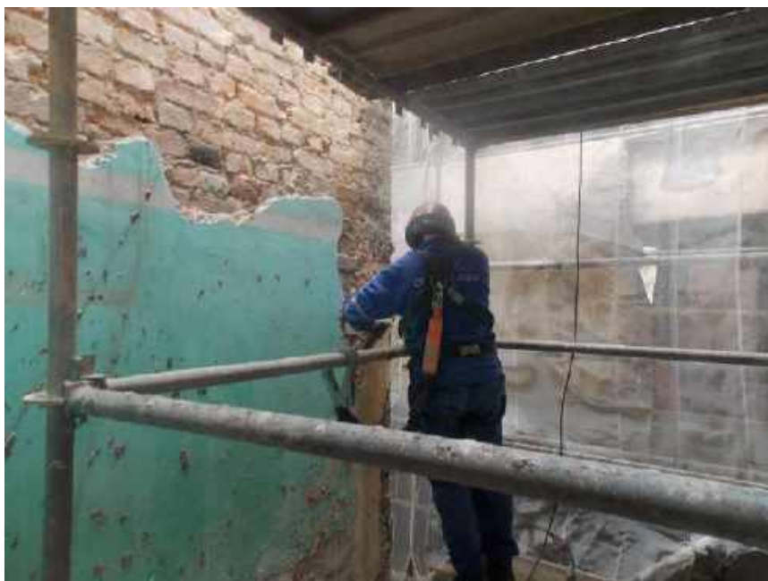
Foto 35 – Remoção da argamassa existentes fachada lateral – Casa 06
