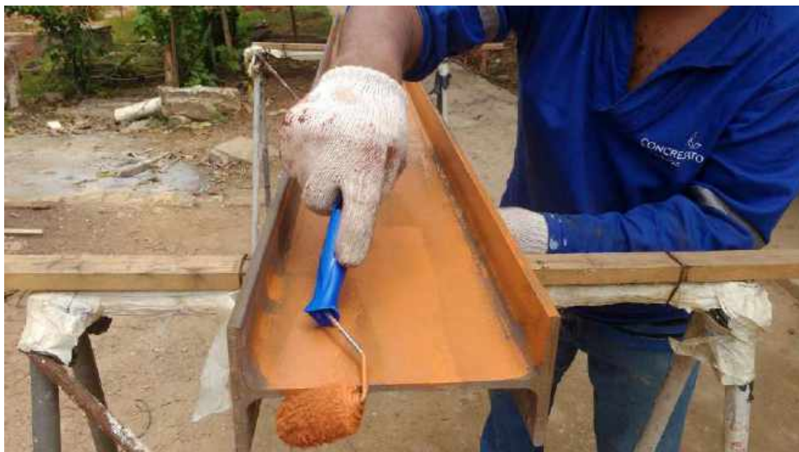
Foto 53 – Tratamento do perfil metálico
