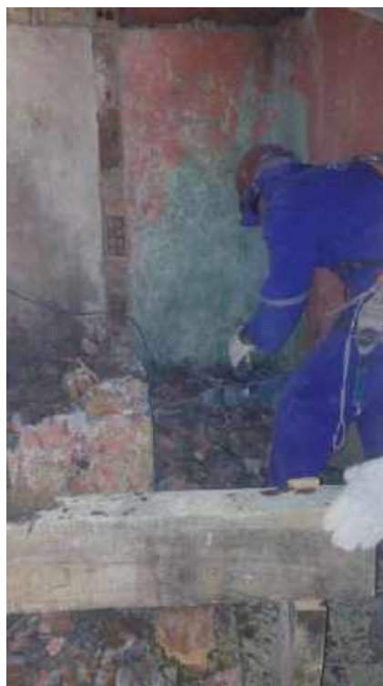
Foto 11 – Demolição manual da parede – Casa 06
