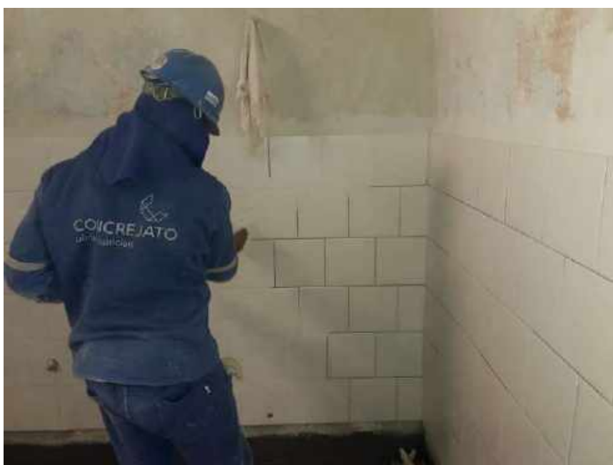
Foto 02 – Rejuntamento dos azulejos – Casa 05
