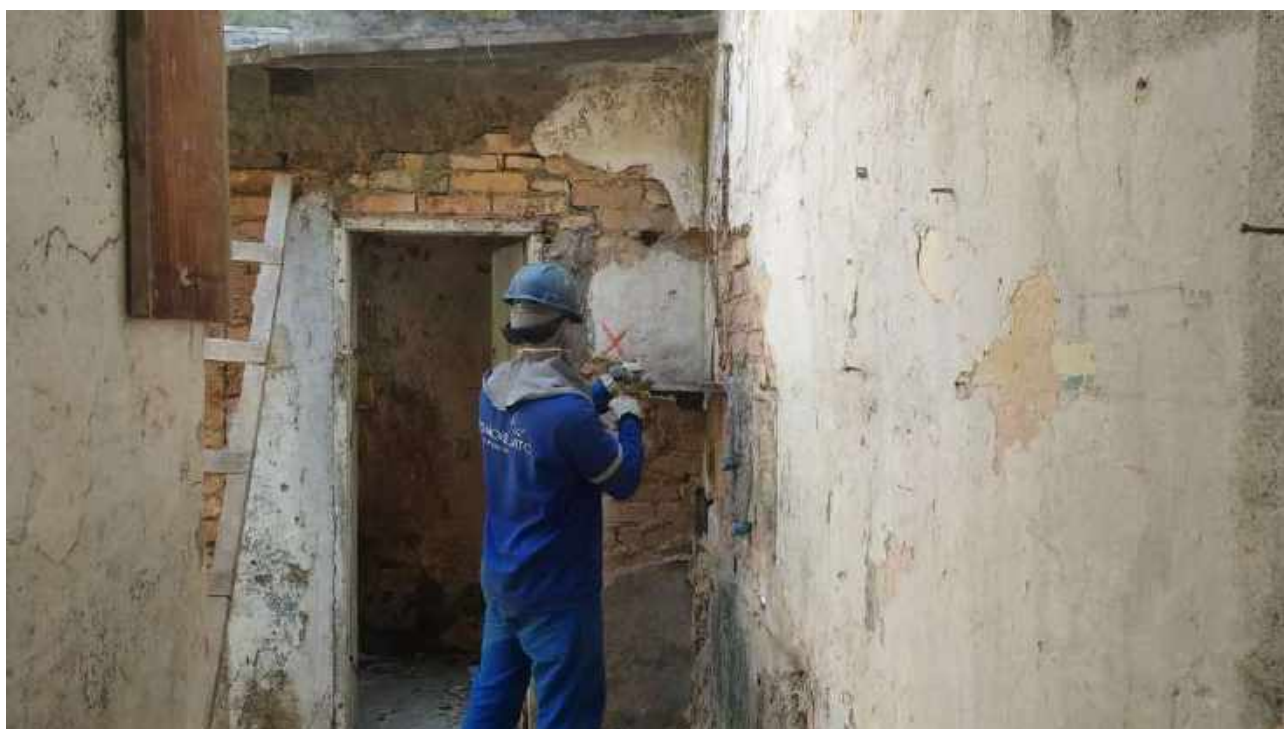
Foto 20: Remoção de revestimento.
