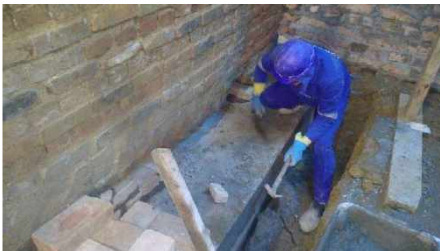
Foto 14 – Execução do acabamento da alvenaria após o reforço de fundação
