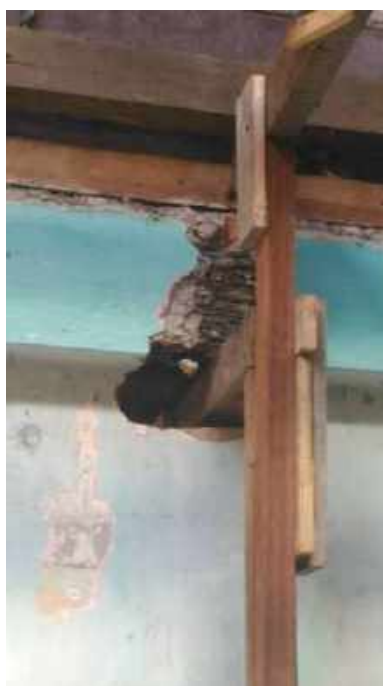
Foto 35: Escoramentos internos da casa.
