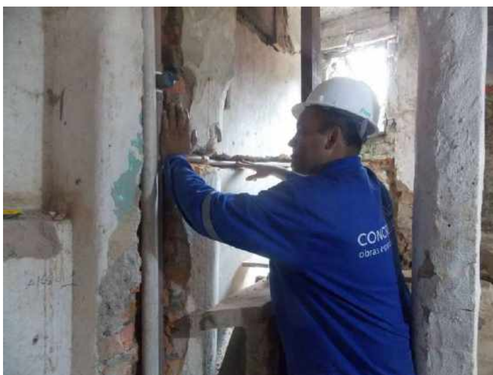
Foto 44 – Instalação das tubulações – Casa 06
