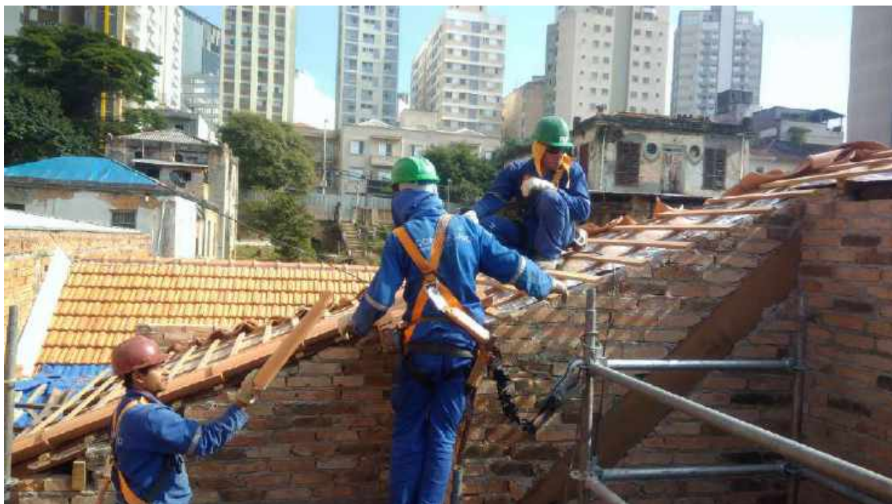
Foto 12:Instalação de telhas;
