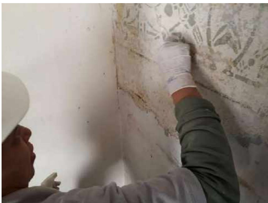
Foto 29 – Decapagem manual das paredes internas – Casa 06
