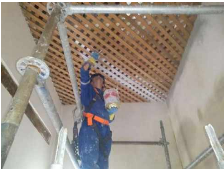
Foto 17- Aplicação de fundo nivelador no forro treliçado de madeira – Casa 06
