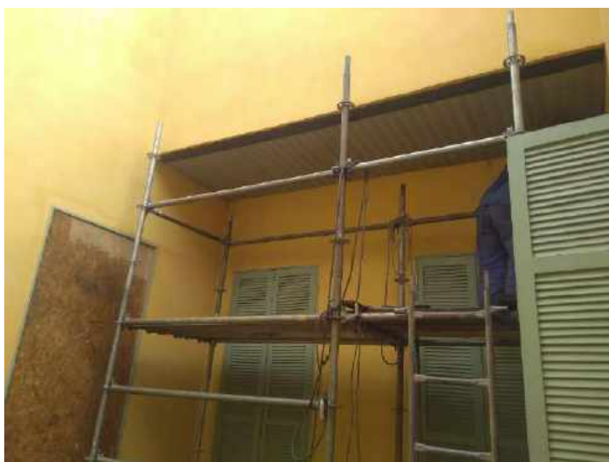
Foto 02 – Instalação do forro metálico área externa
