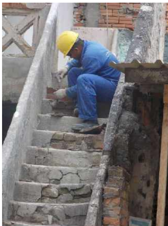
Foto 17 – Regularização da escada – Casa 05
