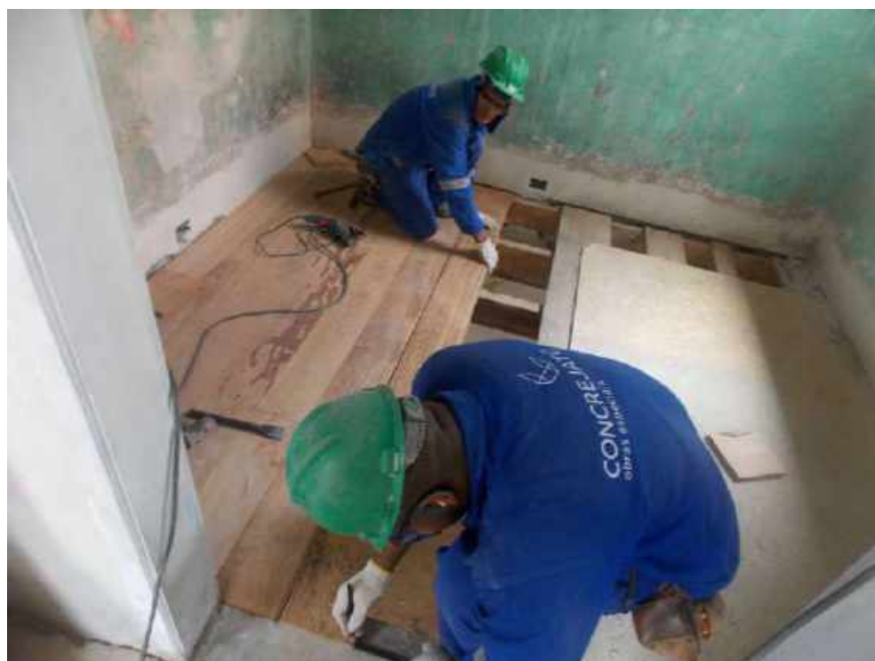
Foto 62 – Instalação dos assoalhos de madeira – Casa 06
