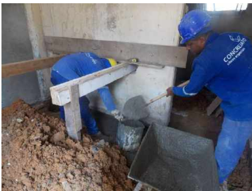
Foto 26 – Concretagem dos reforços da alvenaria – Casa 06
