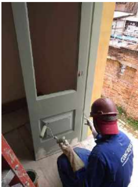
Foto 11 – Pintura lisa das portas de madeira – Casa 06
