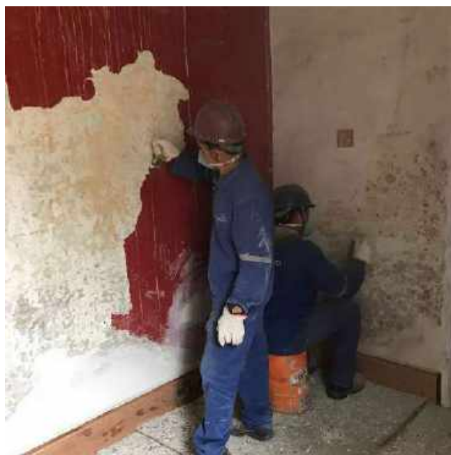
Foto 39- Decapagem manual das paredes internas – Casa 06
