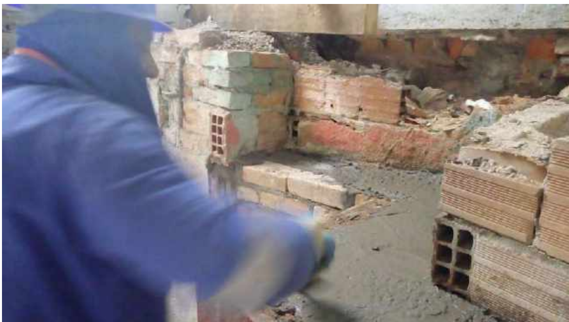
Foto 33 – Elevação da alvenaria
