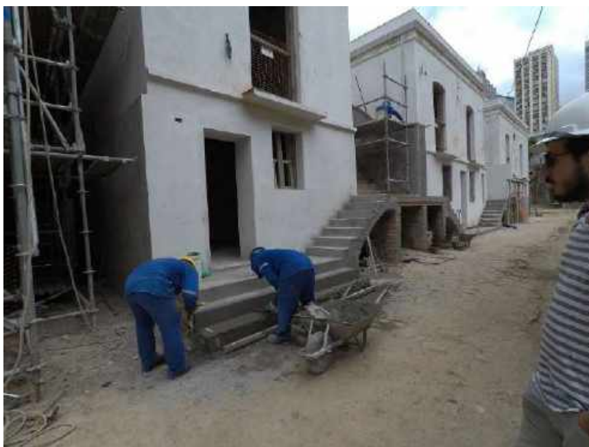
Foto 27 – Execução da argamassa de acabamento – Casa 06
