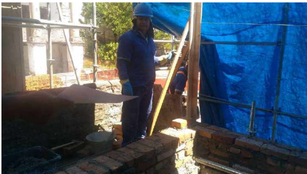
Foto 11: Remontagem da alvenaria – Casa 6.
