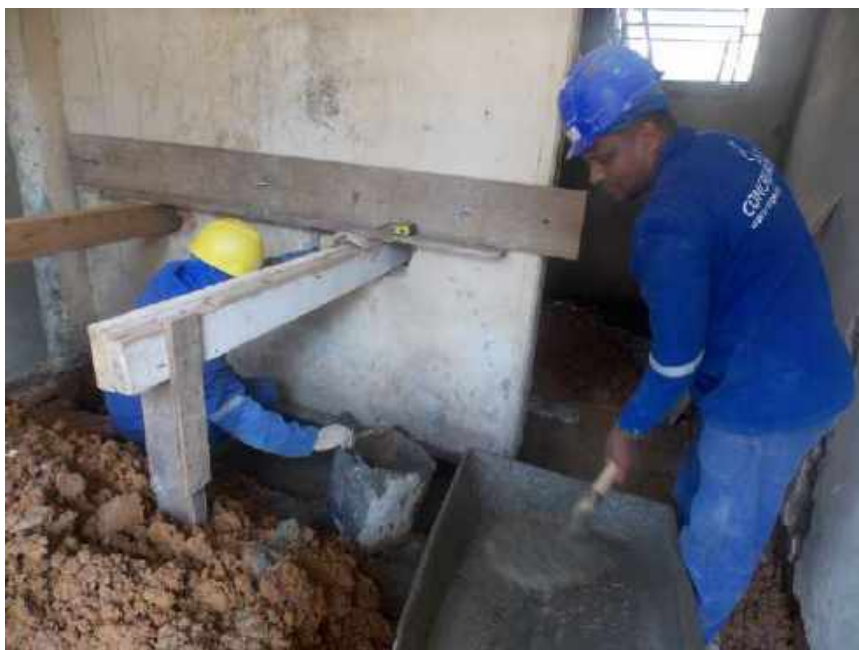
Foto 25 – Concretagem dos reforços da alvenaria – Casa 06
