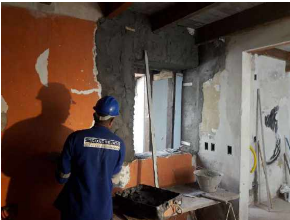
Foto 13 – Execução do emboço das paredes internas – Casa 05
