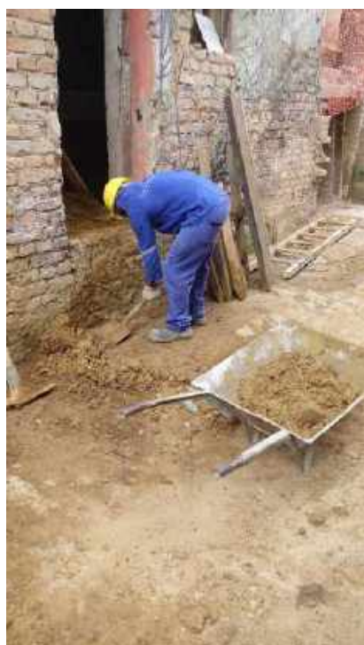
Foto 28 – Remoção dos entulhos – Casa 06
