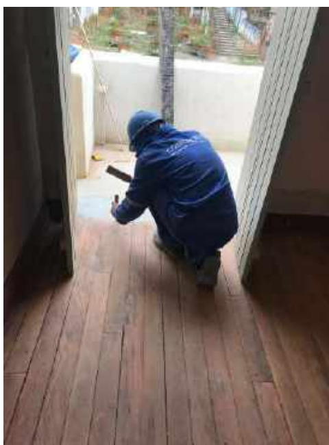
Foto 04 – Recuperação dos assoalhos de madeira – Casa 05
