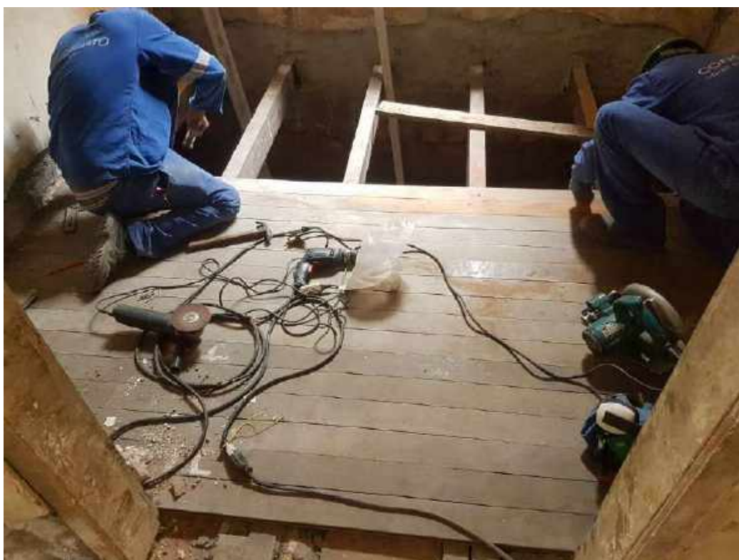
Foto 36 – Instalação dos assoalhos de madeira – Casa 06
