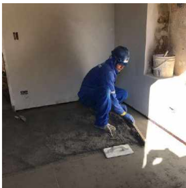
Foto 30 – Execução do piso cimentado – Casa 06
