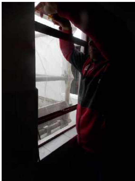
Foto 19* - Instalação da esquadria metálica – Casa 05
