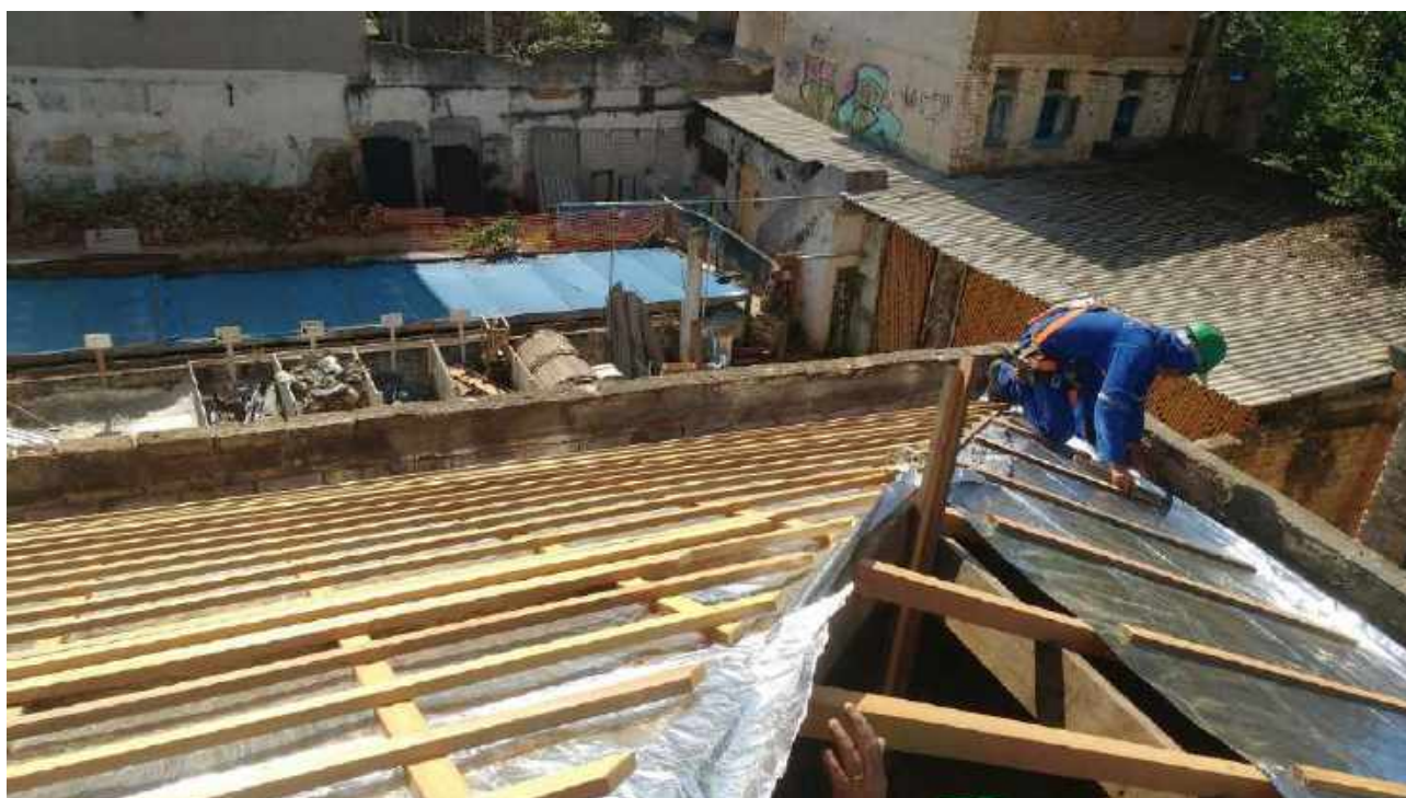
Foto 35: Instalação dos caibros.
