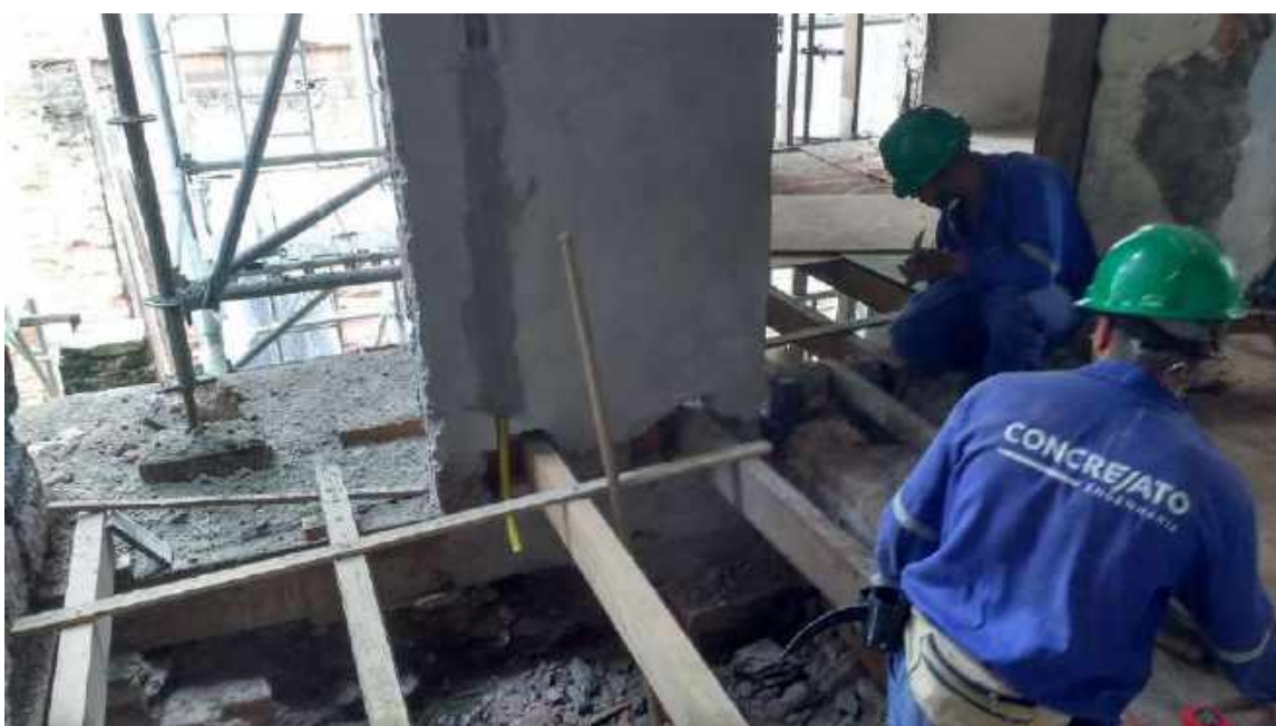
Foto 34 – Instalação dos barrotes – Casa 06
