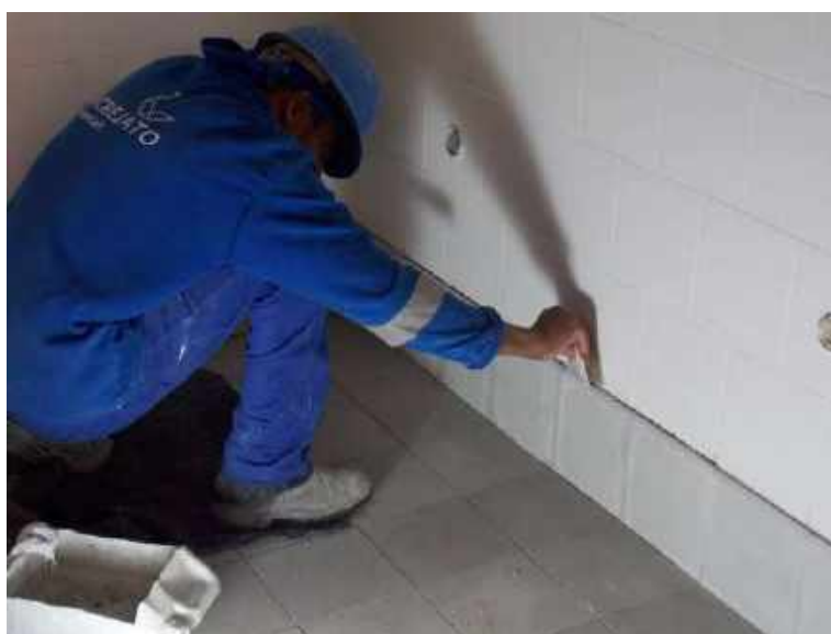
Foto 32 – Instalação dos rodapés hidráulicos – Casa 06
