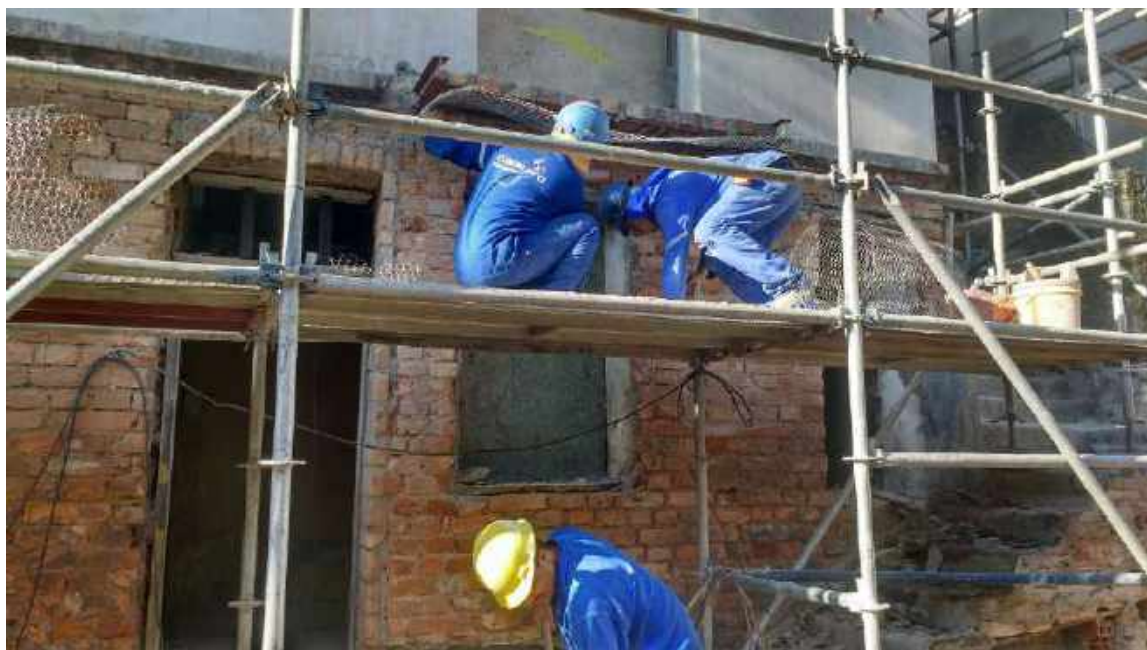
Foto 21 – Execução da varanda – casa 06
