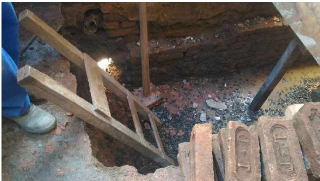
Foto 15: Bombeamento da água do terreno.
