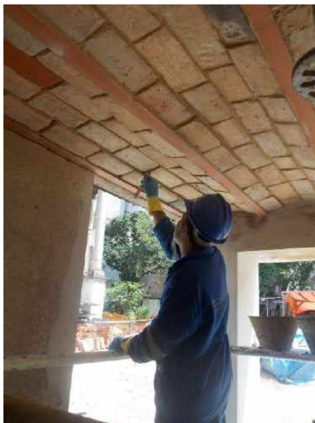
Foto 02 – Restauro dos tijolos da abobadilha – Casa 05
