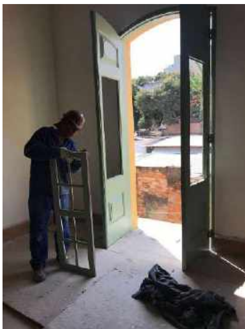
Foto 37 – Pintura lisa das esquadrias de madeira – Casa 06
