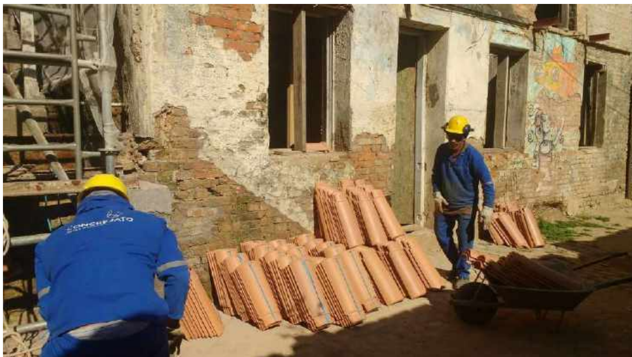
Foto 59: Içamento das telhas de cerâmica,
