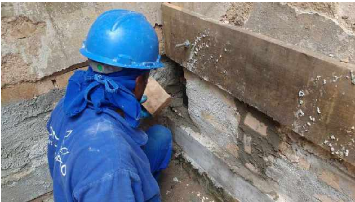
Foto 35 – Recuperação da alvenaria – Casa 06
