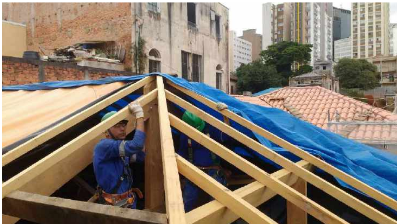
Foto 35: Substituição das peças danificadas da tesoura da Casa 6.
