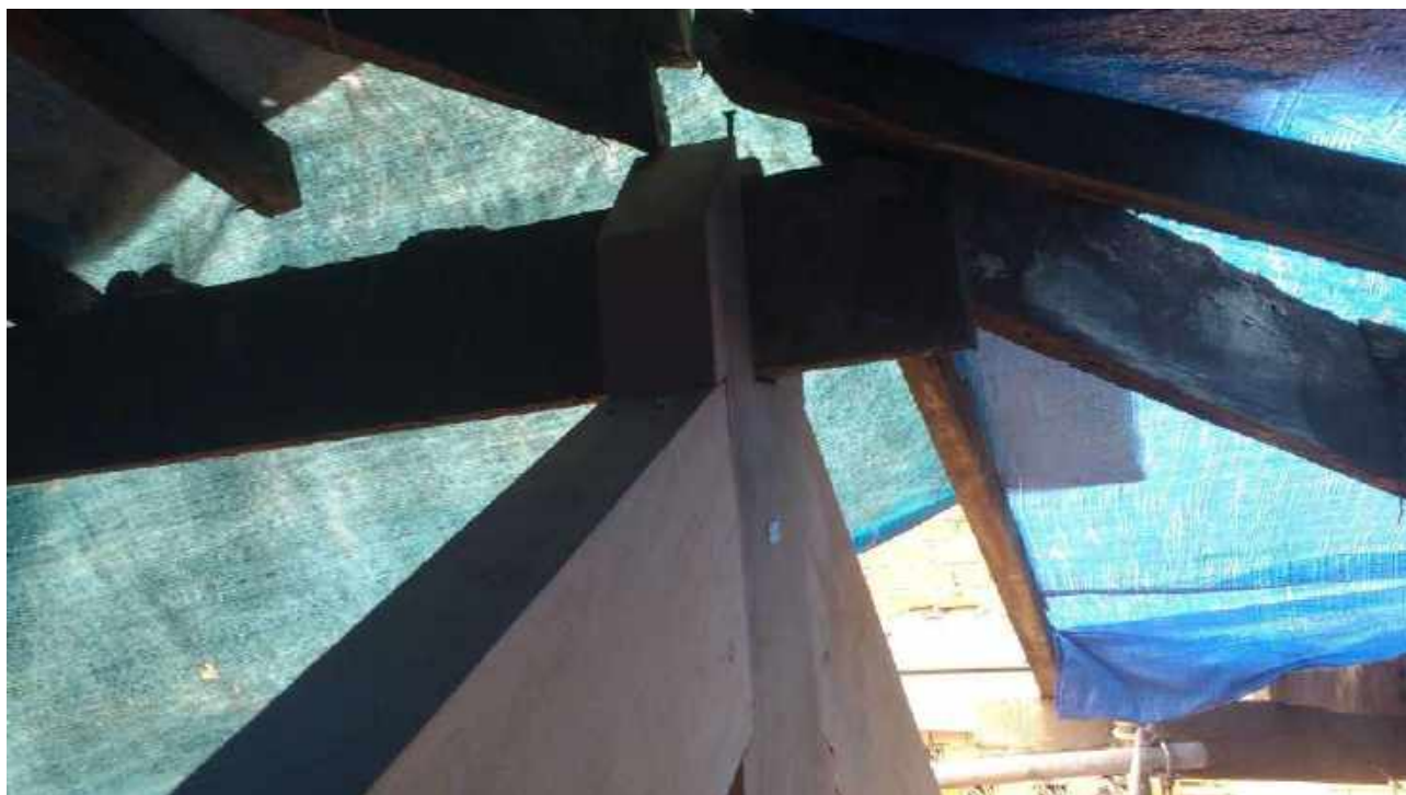
Foto 07: Detalhe do encaixe da cobertura.
