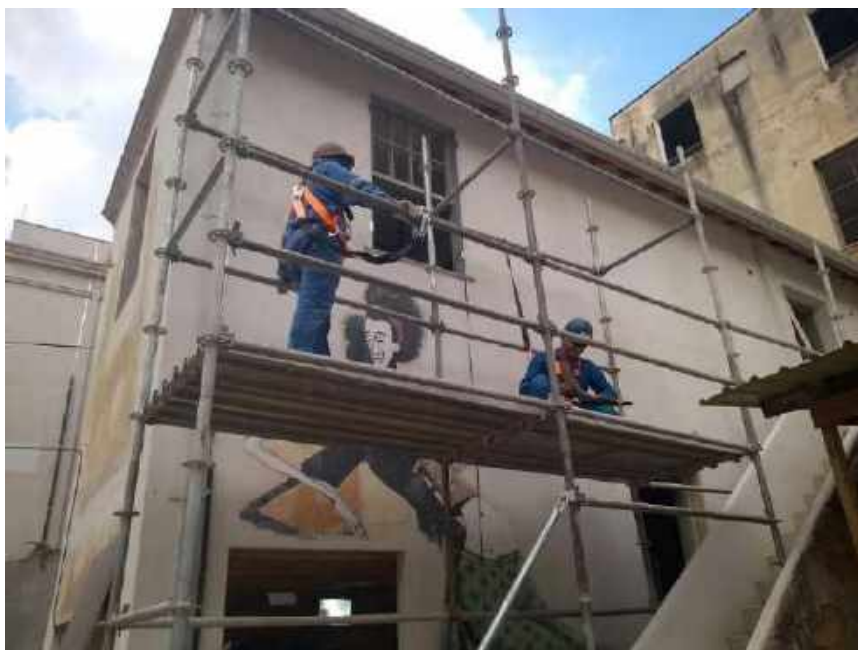
Foto 29 – Montagem do andaime da fachada lateral – Casa 05
