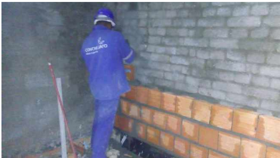
Foto 15 – Elevação da alvenaria – Casa 06
