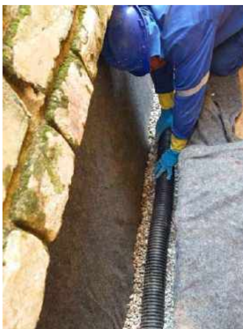
Foto 18 - Execução da drenagem na fachada dos fundos da casa 06
