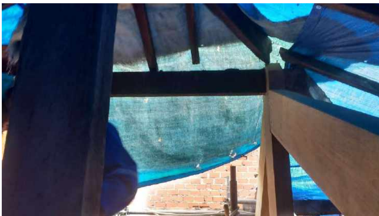
Foto 09: Substituição das peças danificadas da tesoura da Casa 6.
