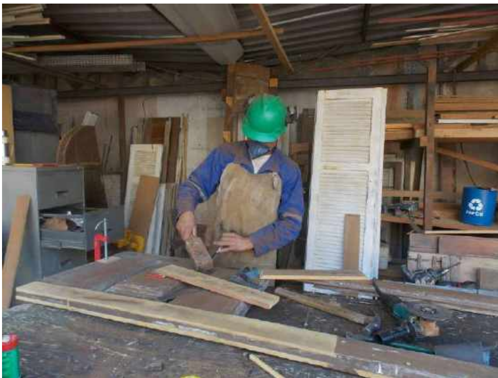
Foto 23 – Restauração das portas de madeira – Casa 06
