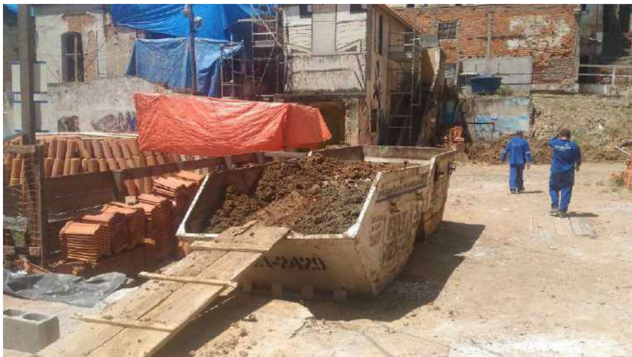
Foto 21: Envio de entulho bota-fora.
