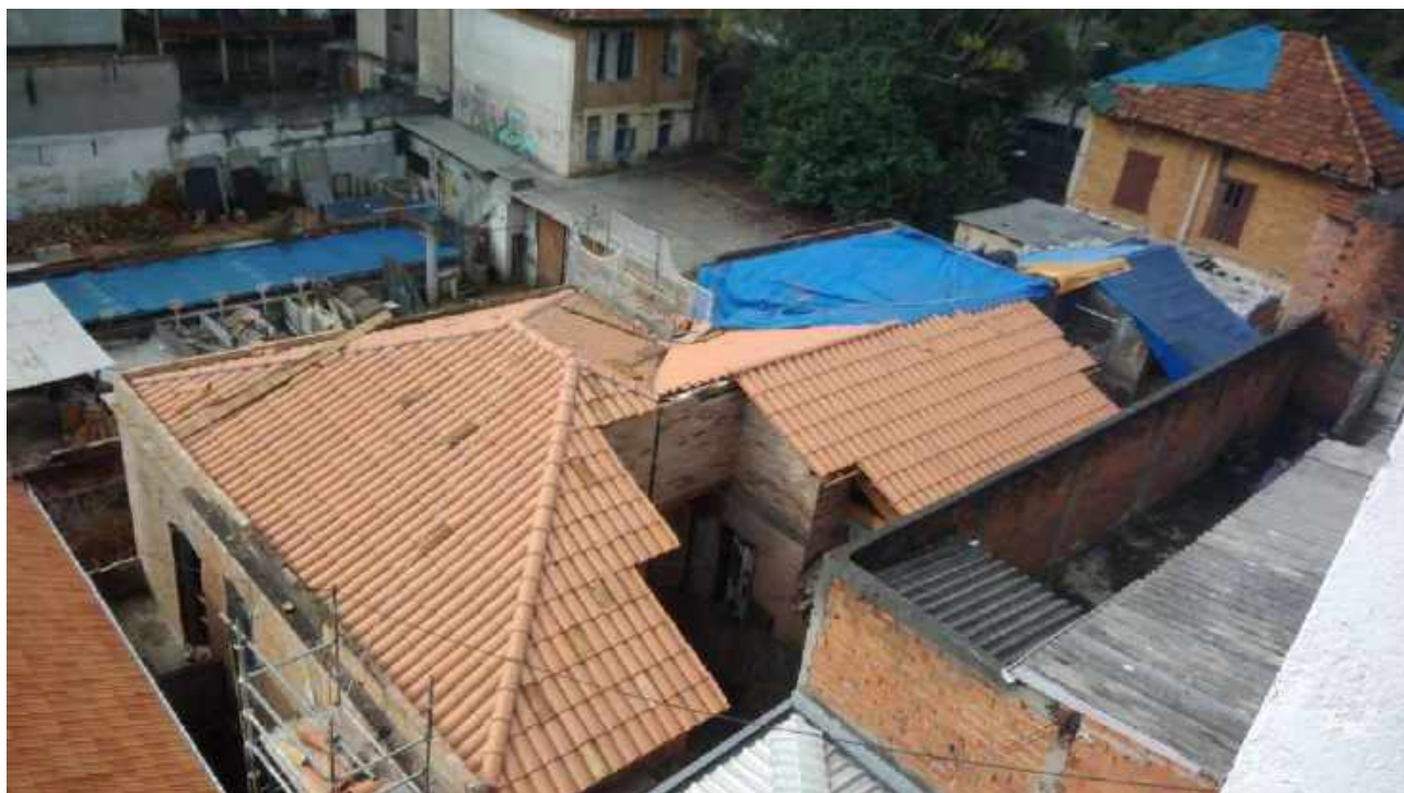
Foto 77: Substituição das peças danificadas da tesoura da Casa 6.
