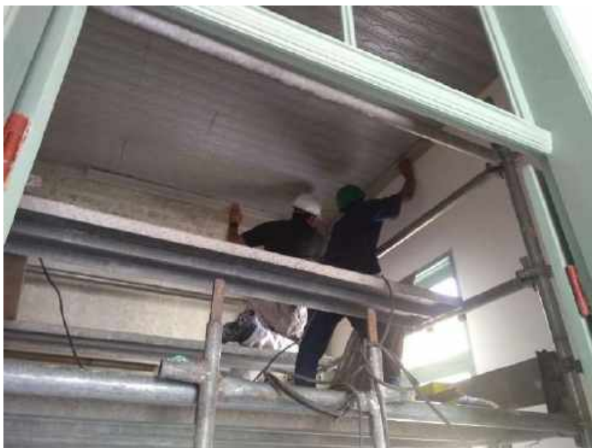
Foto 15 – Instalação da moldura de madeira no forro metálico – Casa 06
