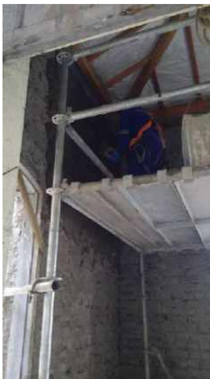
Foto 07 – Execução do emboço interno – Casa 06
