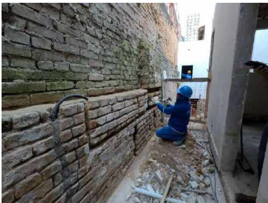
Foto 29 – Restauração dos tijolos da fachada atrás – Casa 06
