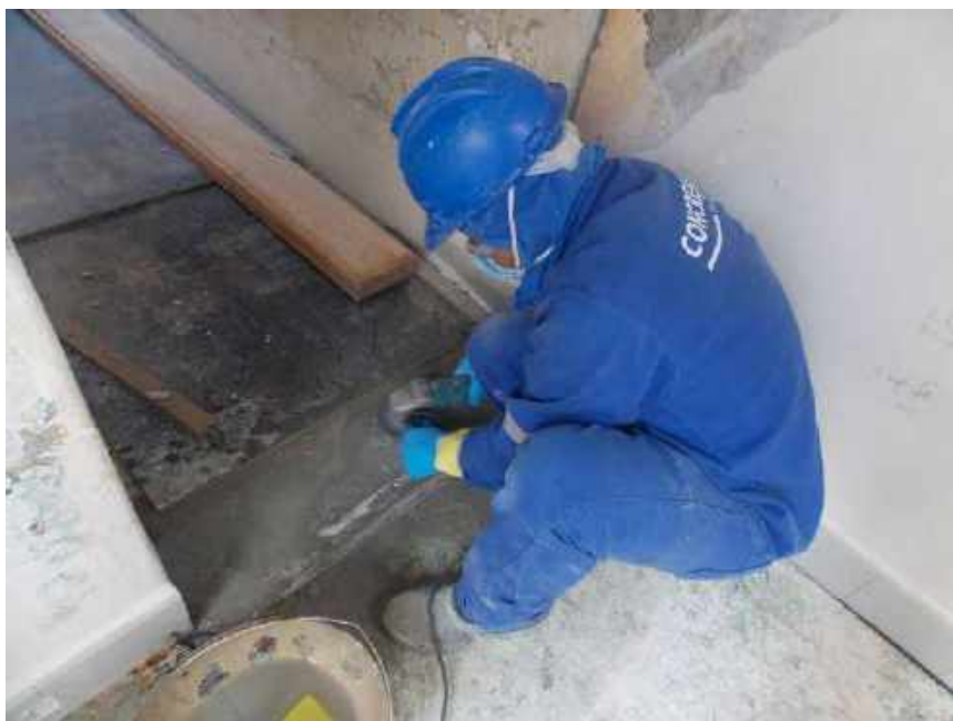
Foto 72 – Execução da soleira – Casa 06
