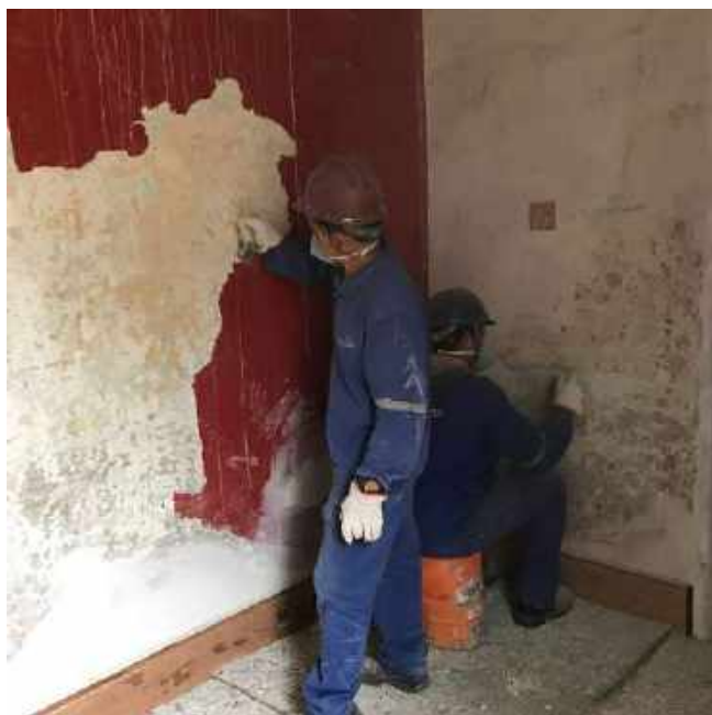
Foto 13 – Decapagem manual das paredes internas – Casa 06
