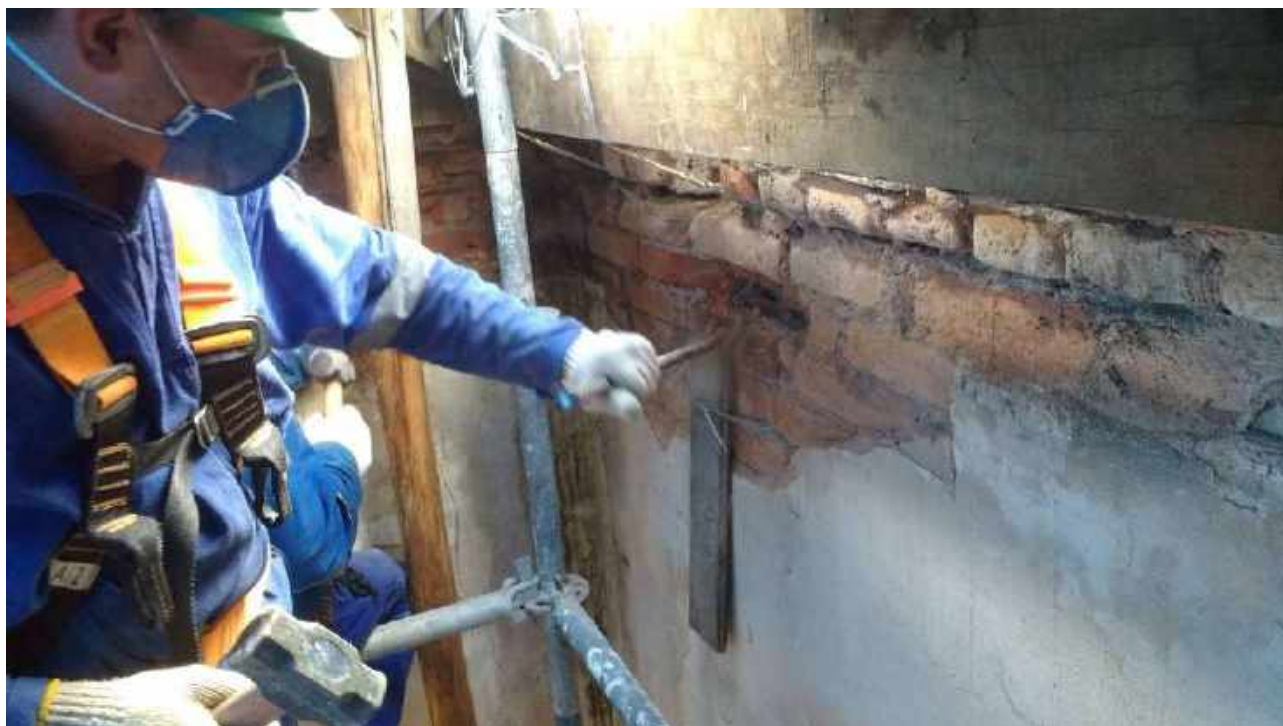
Foto 05: Abertura para execução da cinta.
