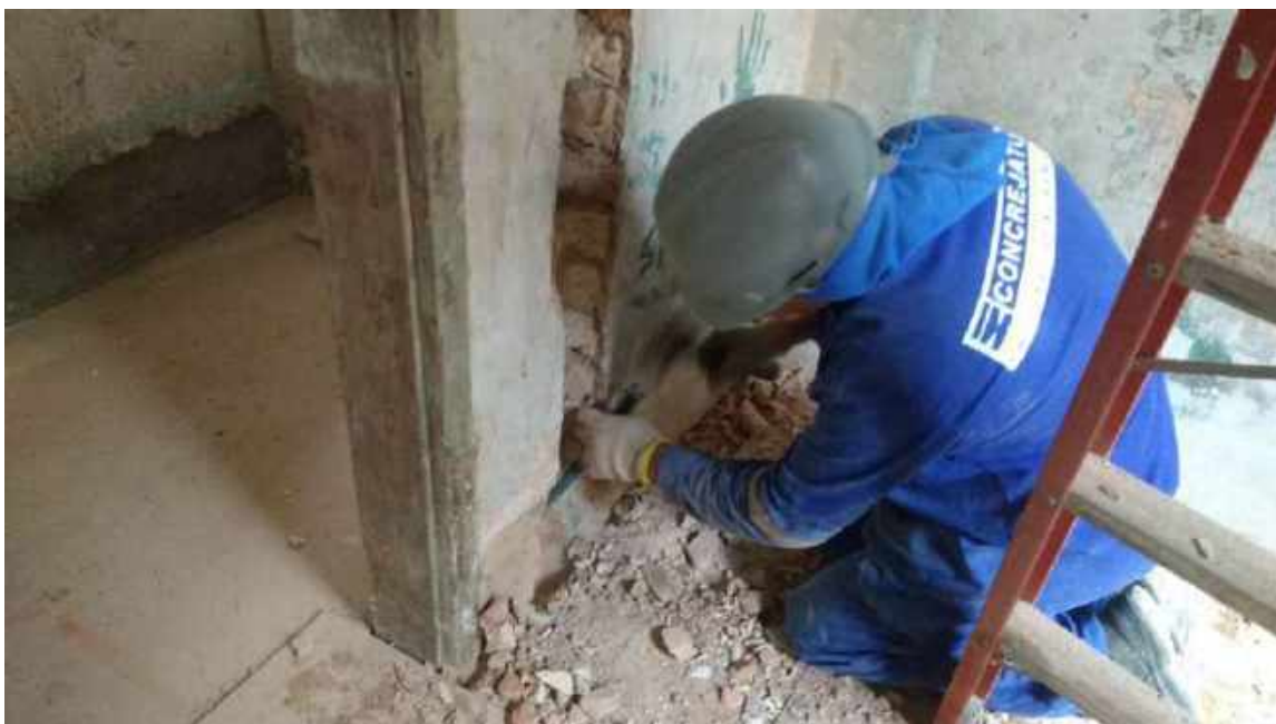
Foto 29 –Abertura para passagem de infra de eletrica – Casa 06
