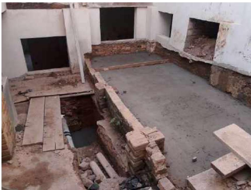
Foto 39 - Passagem das tubulações – Casa 06
