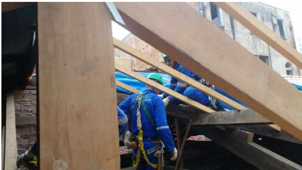
Foto 27: Instalação de caibros - Casa 06.
