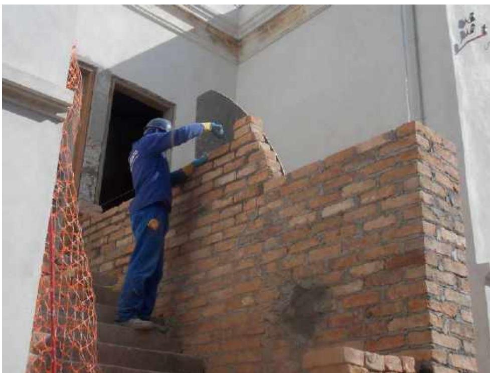
Foto 45 – Elevação da alvenaria existente – Casa 06
