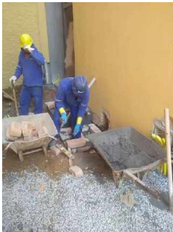
Foto 48 – Execução da caixa pluvial – Casa 06
