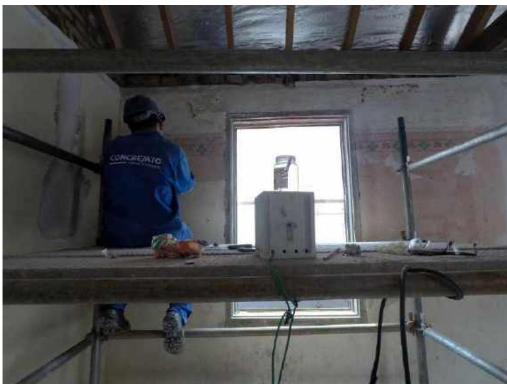
Foto 48 – Decapagem cuidadosa das tintas existentes sobre a pintura decorativa – Casa 05
