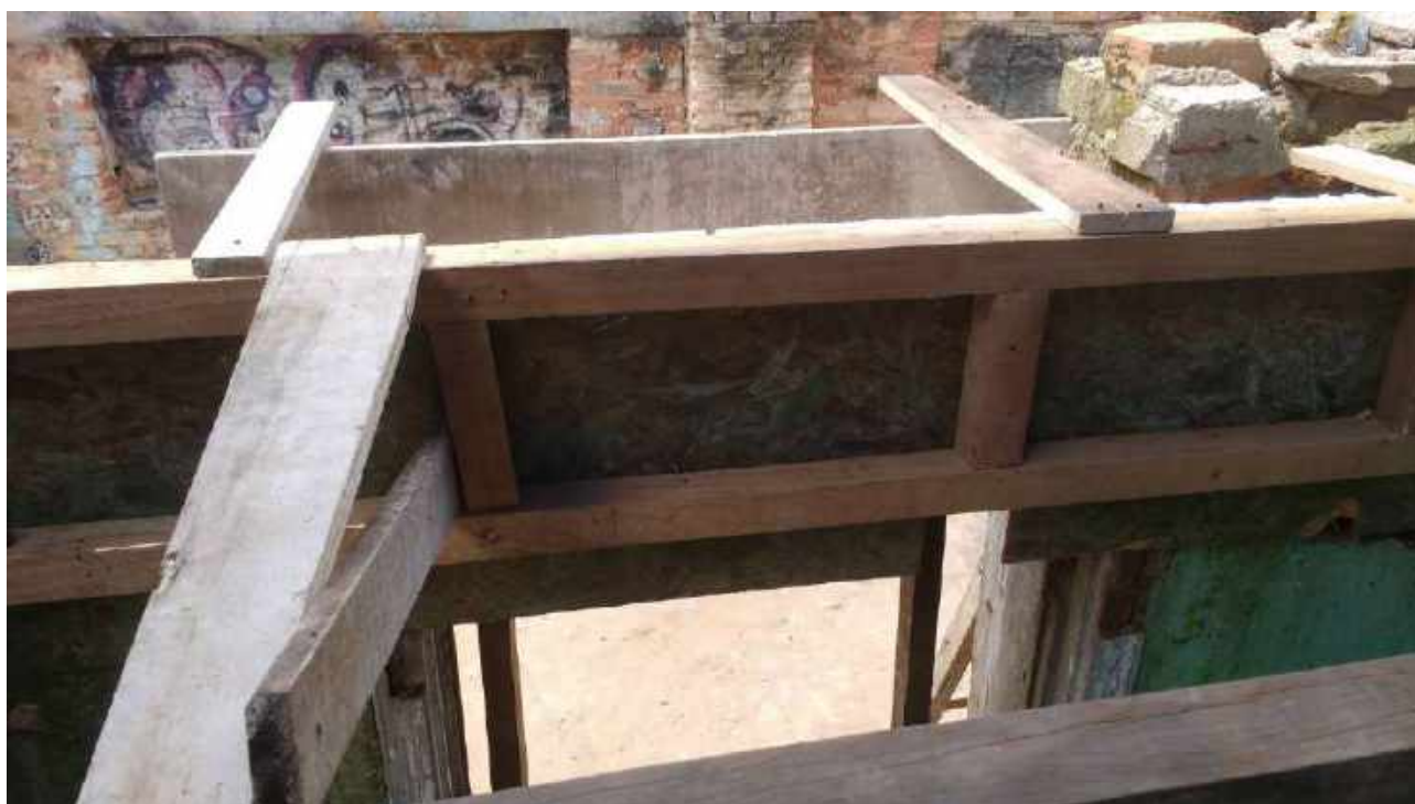
Foto 19: Forma para concretagem da verga da esquadria.
