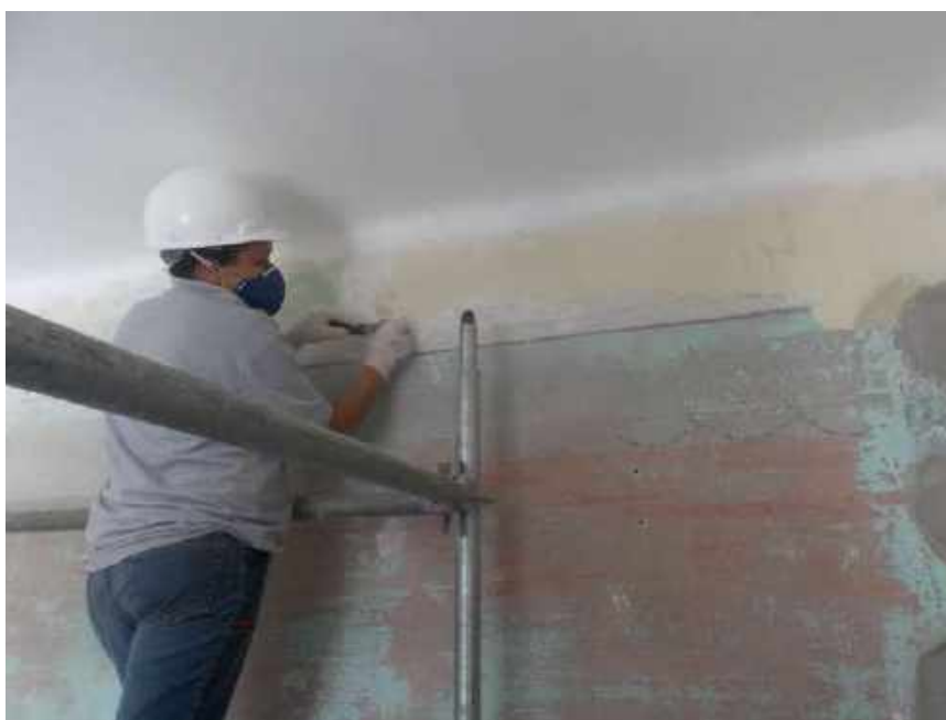
Foto 16 – Decapagem manual – Casa 05
