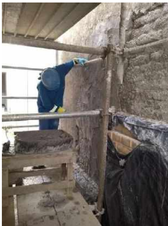
Foto 51 – Execução do chapisco do muro dos fundos – Casa 06
