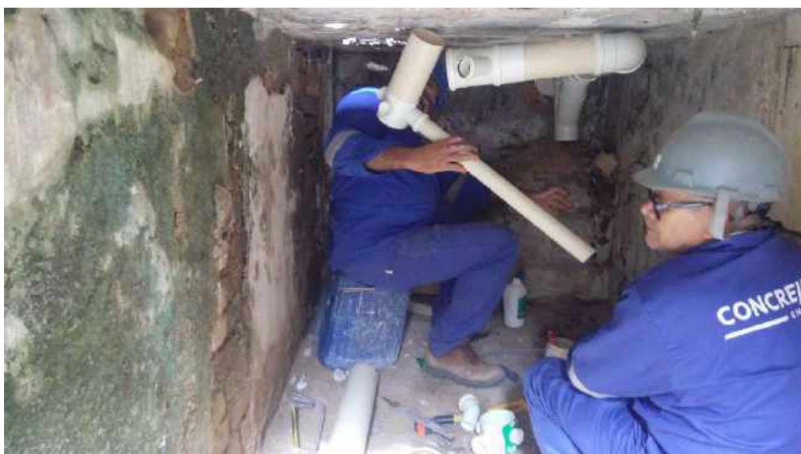
Foto 26 – Instalação da hidráulica – Casa 06
