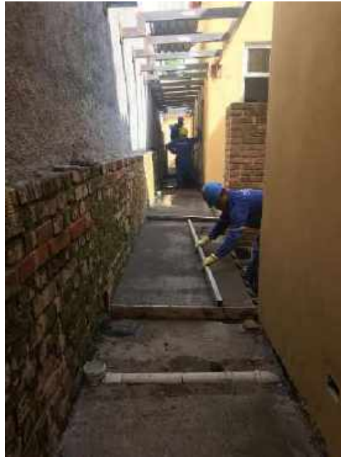
Foto 26 – Execução do piso cimentado
