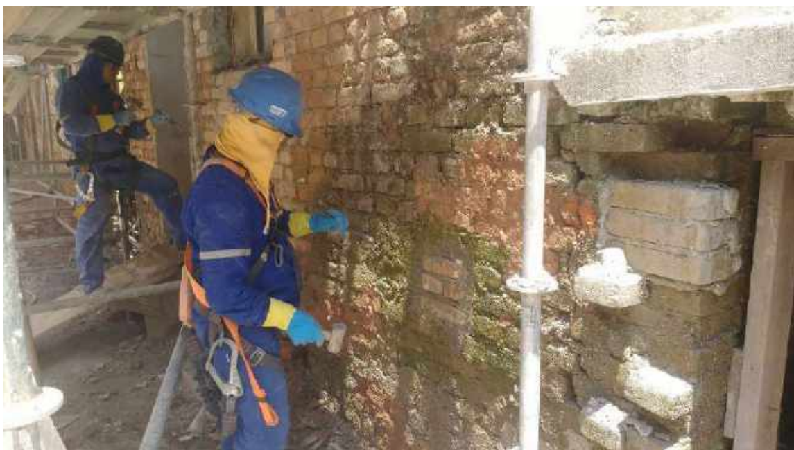
Foto 25 – Remoção do chapisco da fachada – Casa 06
