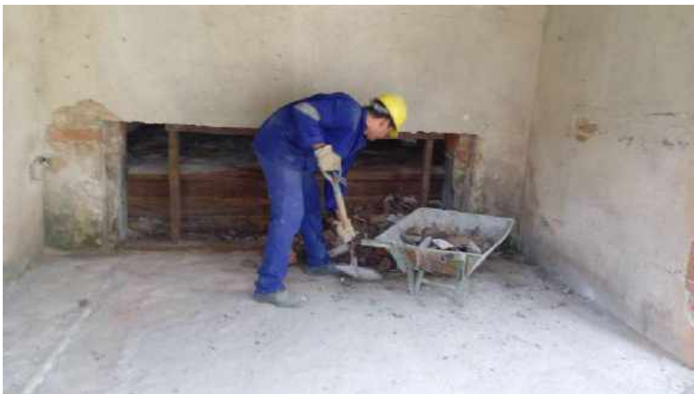
Foto 61 Remoção dos entulhos
