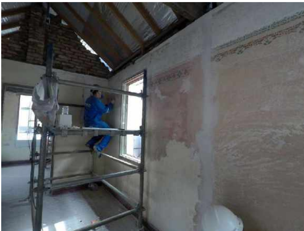
Foto 47 – Decapagem cuidadosa das tintas existentes sobre a pintura decorativa – Casa 05
