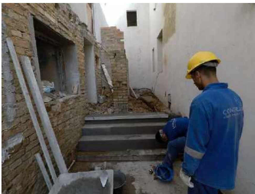
Foto 24 – Execução da argamassa de acabamento – Casa 06
