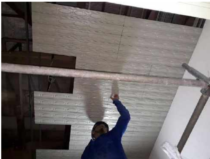
Foto 15 – Instalação do forro metálico – Casa 06
