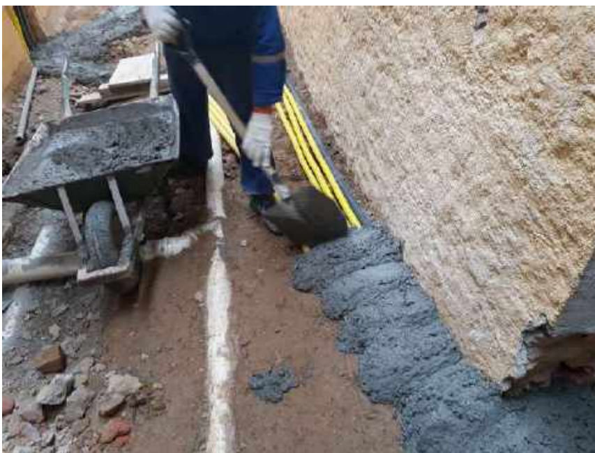
Foto 39 – Concretagem das tubulações expostas – Casa 06
