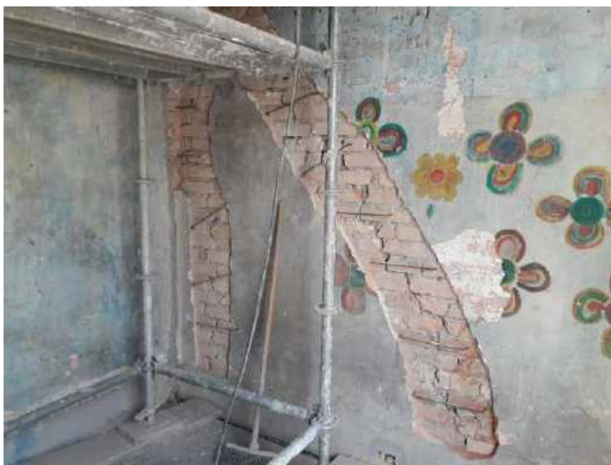
Foto 25 – Tratamento de trincas – Casa 06
