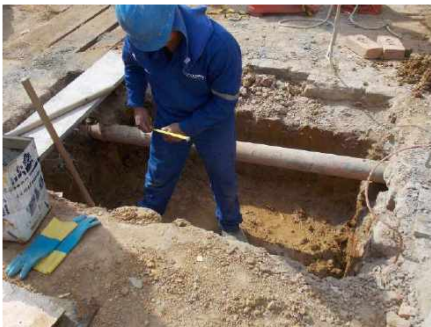
Foto 43 – Escavação manual para execução da caixa do esgoto e águas pluviais
