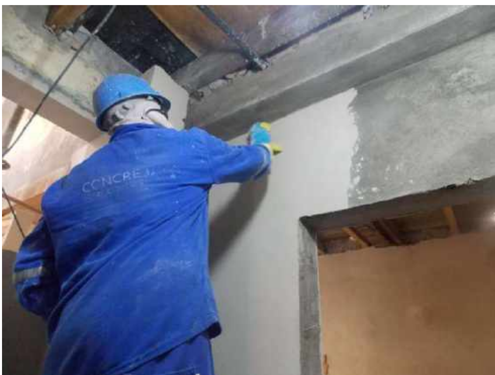
Foto 22 – Execução da argamassa de acabamento das paredes internas – Casa 05
