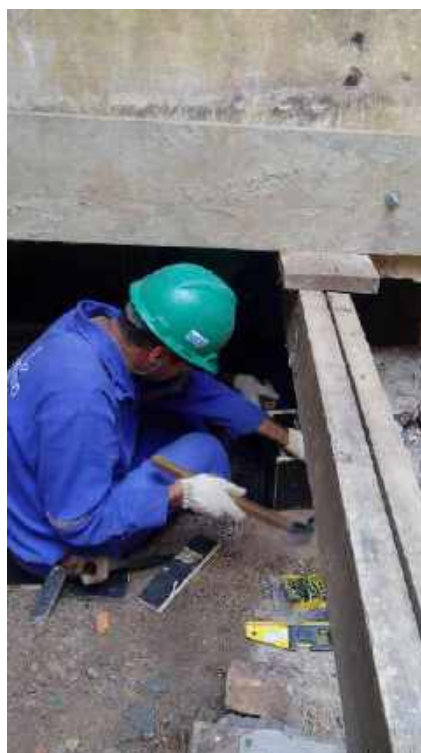
foto 06– execução de fôrma para concretagem das bases
