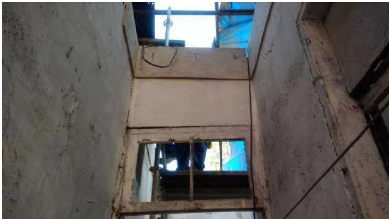
Foto 80: Substituição das peças danificadas da tesoura da Casa 6.
