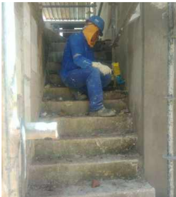
Foto 40 – Execução da argamassa de acabamento da fachada
