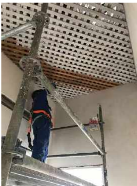
Foto 18 – Aplicação de fundo nivelador no forro treliçado de madeira – Casa 06
