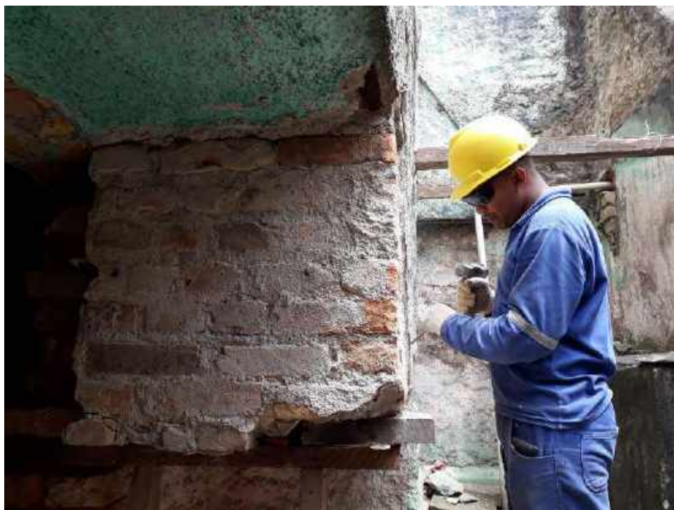
Foto 09 – Remoção do revestimento – Casa 05
