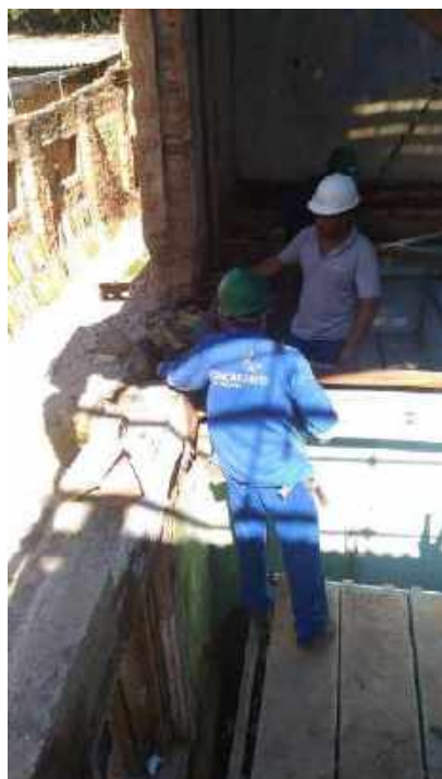
Foto 19: Remontagem da alvenaria
