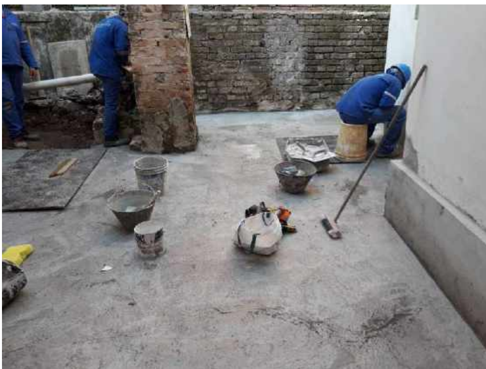
Foto 64 – Execução do piso dos fundos – Casa 06
