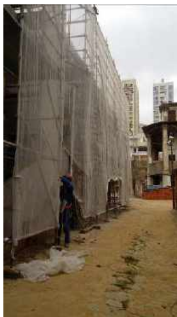
Foto 02 – Instalação da tela de proteção no andaime da fachada Casa 06
