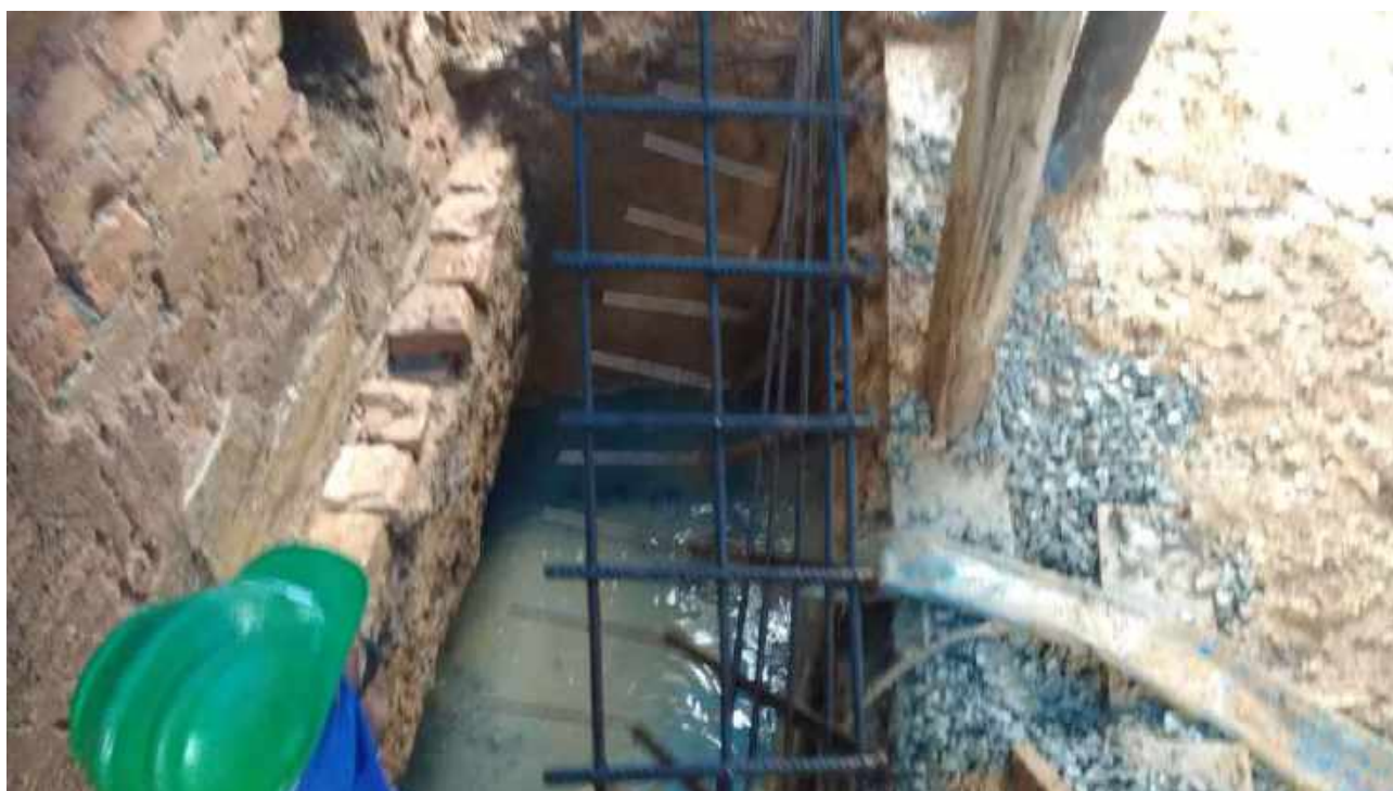
Foto 10: Execução de bloco de reforço – Casa 06.
