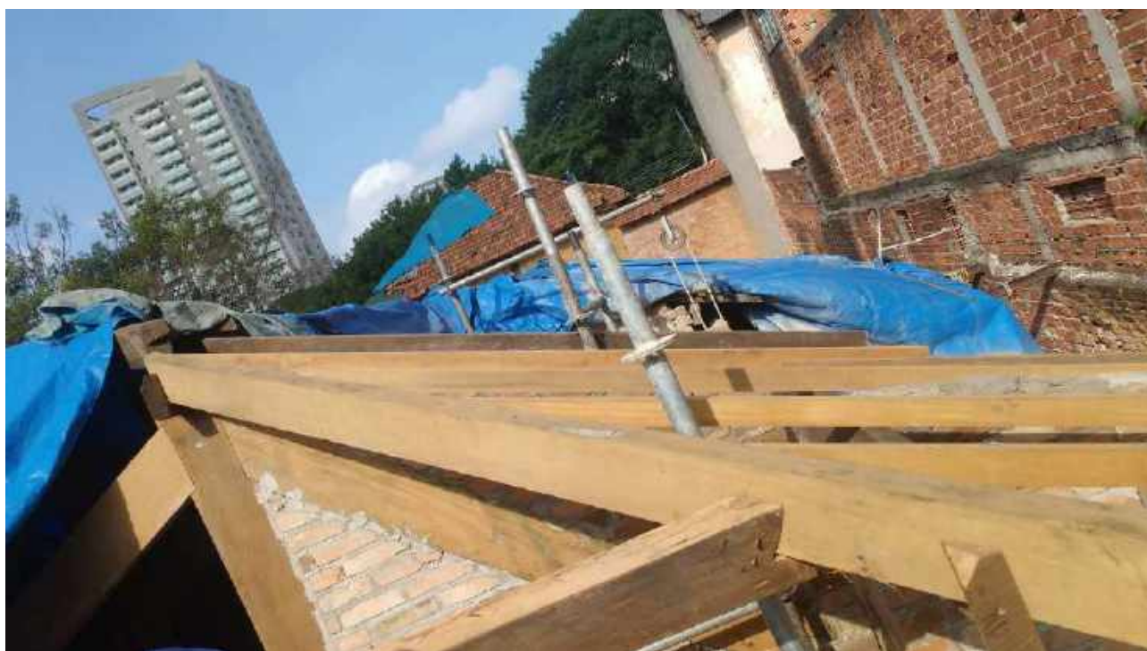
Foto 19: Instalação das terças.
