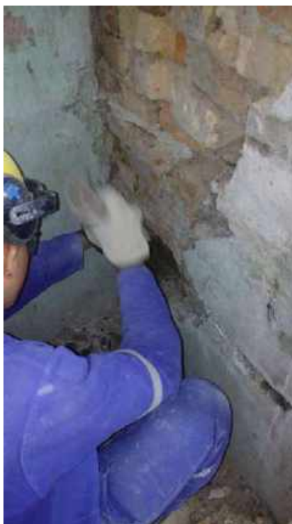
Foto 31 – Remoção do revestimento
