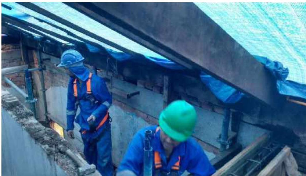
Foto 03: Execução de fôrma para cinto de concreto.
