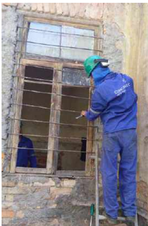
Foto 2 – Remoção das esquadrias e das portas – Casa 06
