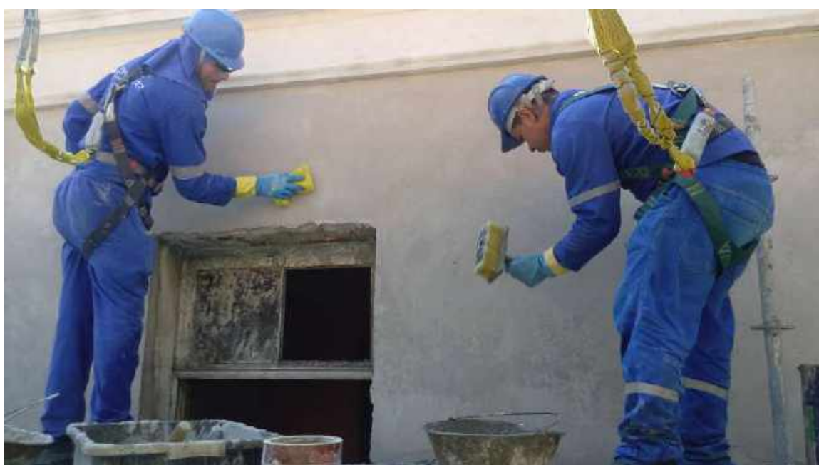
Foto 34 - Execução do Acabamento da Argamassa da fachada – Casa 06
