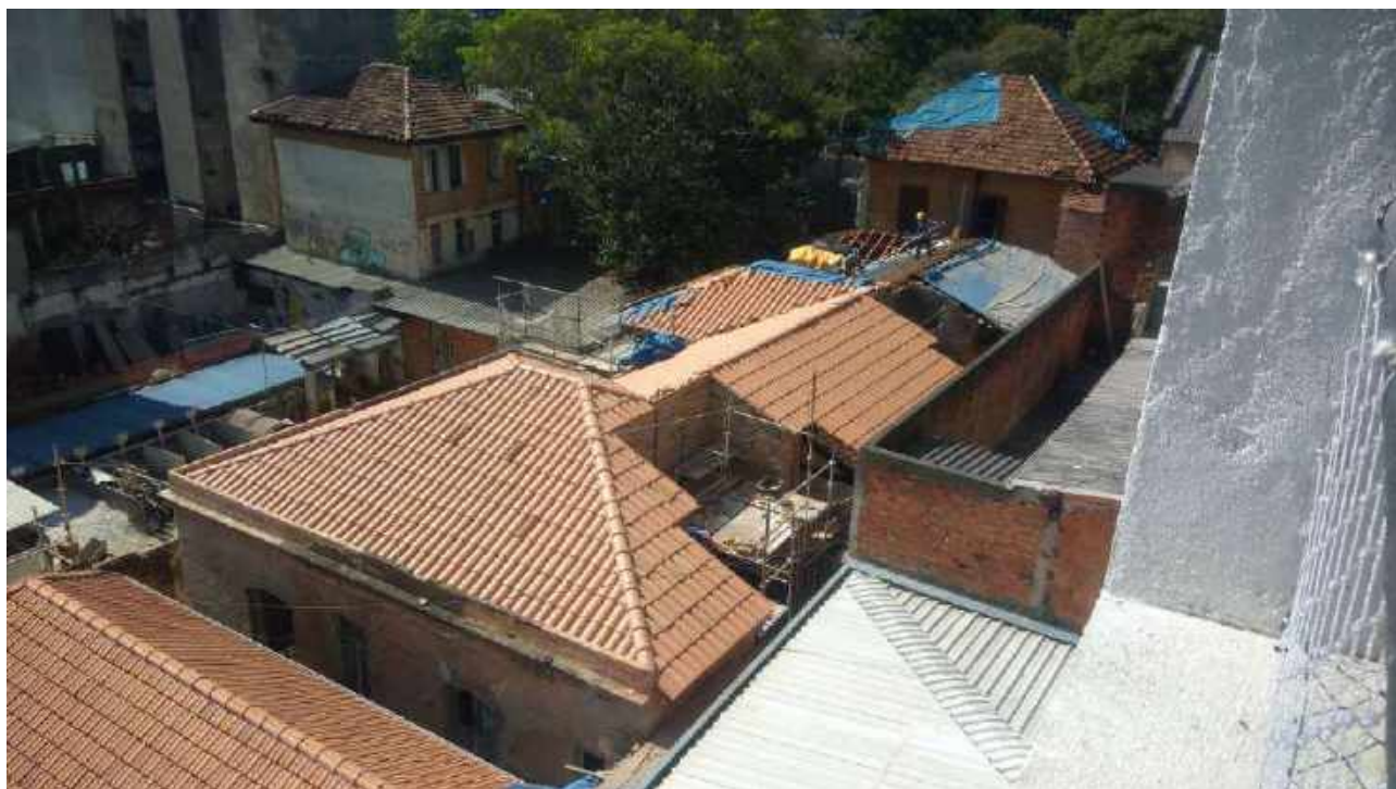
Foto 05: Instalação de caibros;
