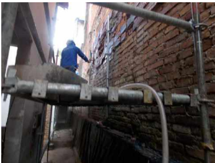
Foto 50 – Limpeza dos tijolos do muro dos fundos – Casa 06
