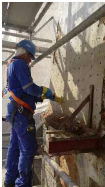
Foto 19 – Consolidação da fachada – Casa 06
