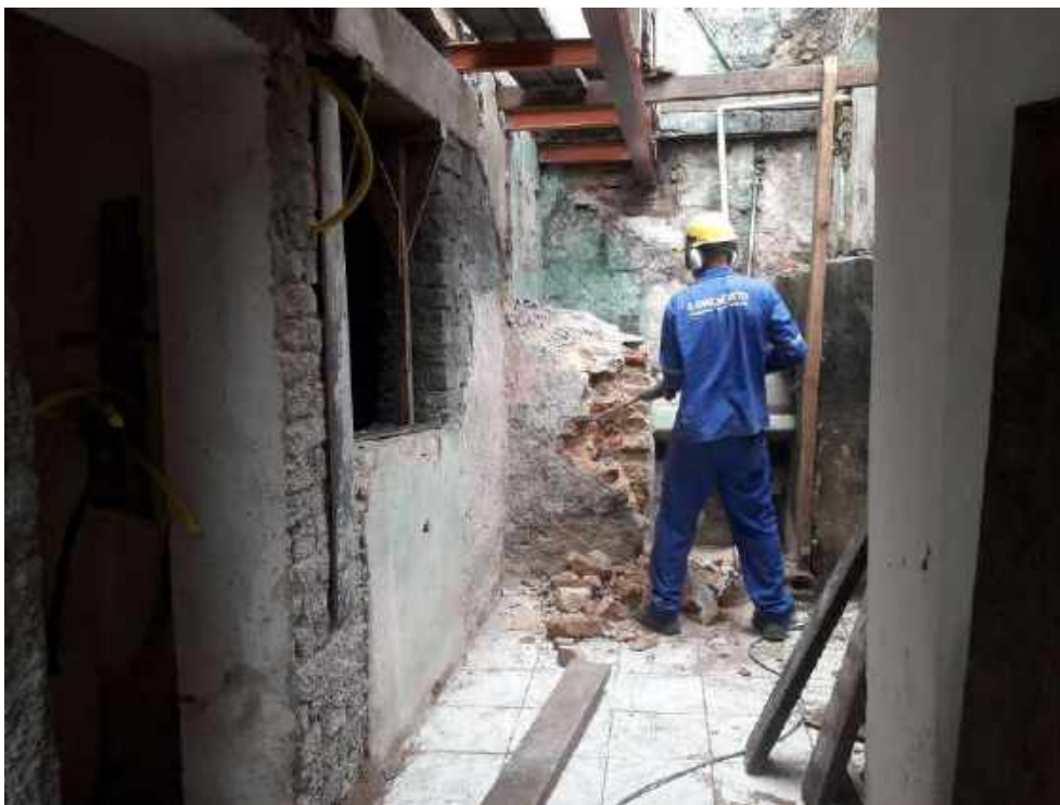
Foto 09 - Demolição manual da alvenaria existente – Casa 05
