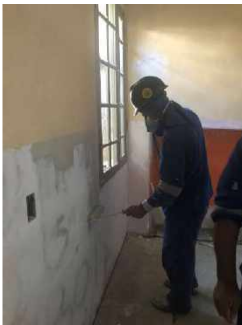
Foto 13- Pintura lisa das paredes internas – Casa 05
