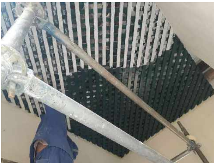
Foto 11 – Execução da pintura lisa do forro treliçado de madeira – Casa 06
