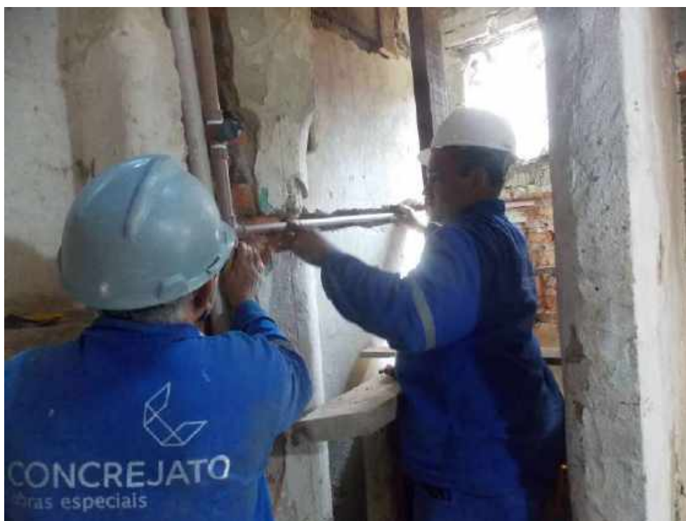
Foto 43 – Passagem das tubulações – Casa 06
