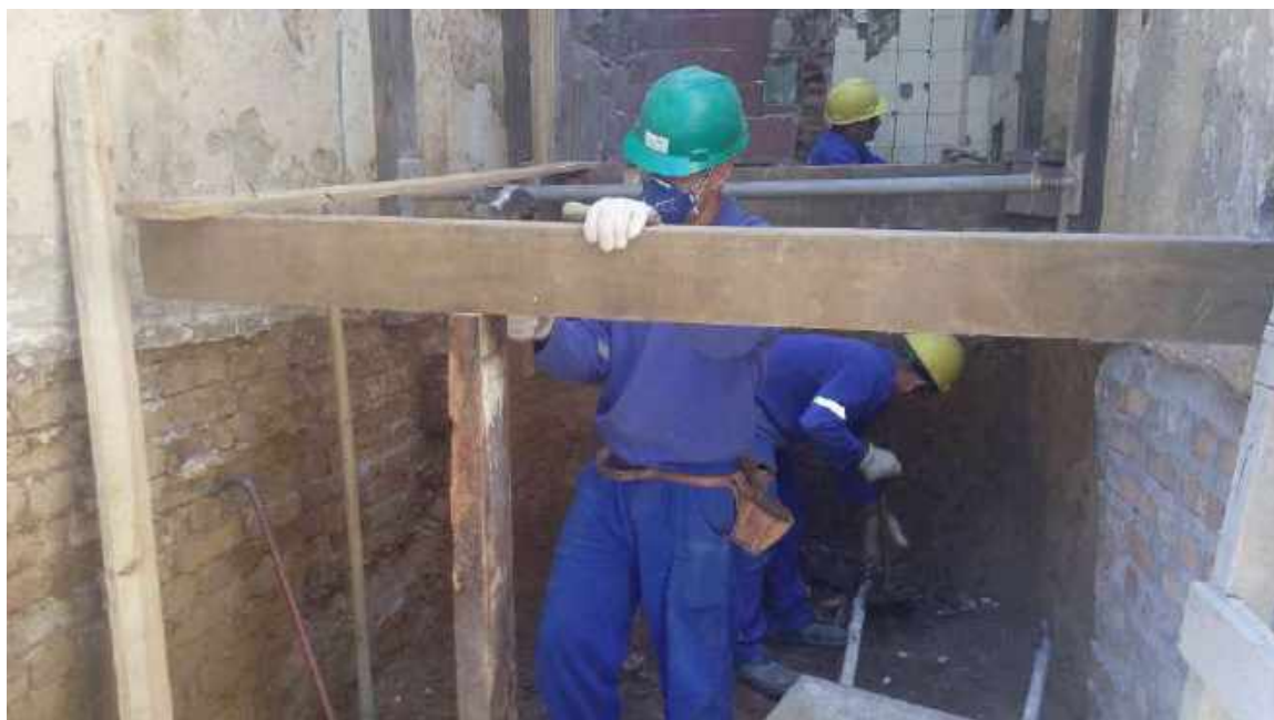
Foto 23 – Escoramento das paredes – Casa 06
