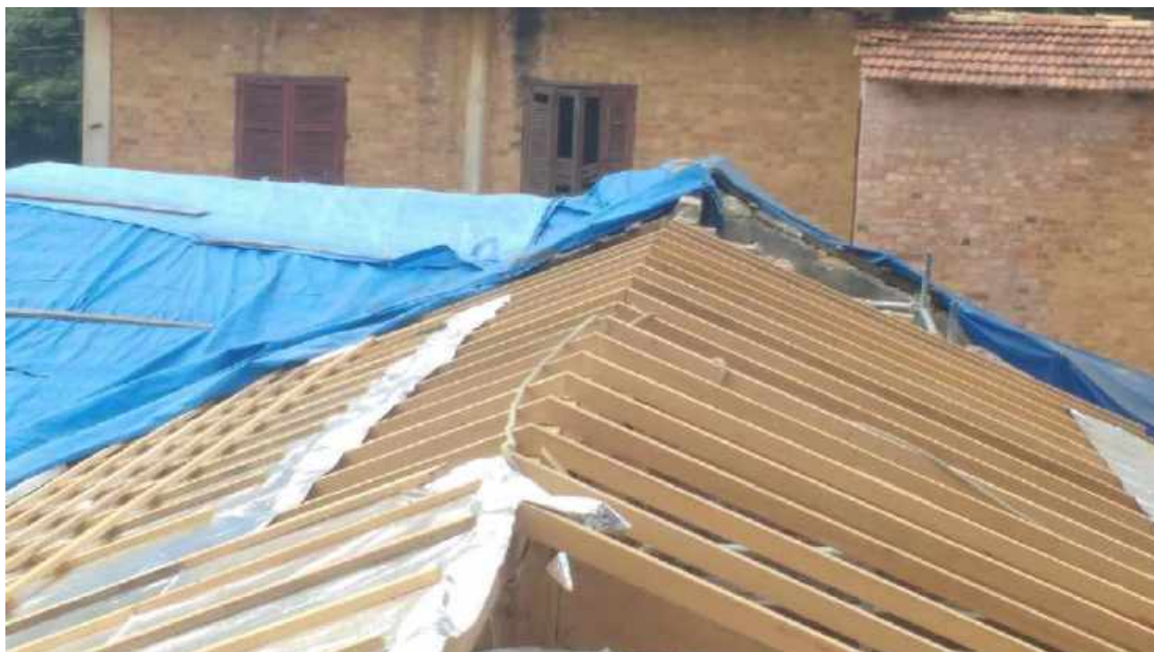
Foto 03: Instalação de manta aluminizada e contra ripa.
