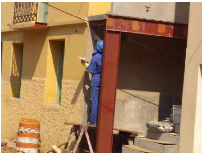
Foto 04 – Execução da argamassa de acabamento das paredes externas
