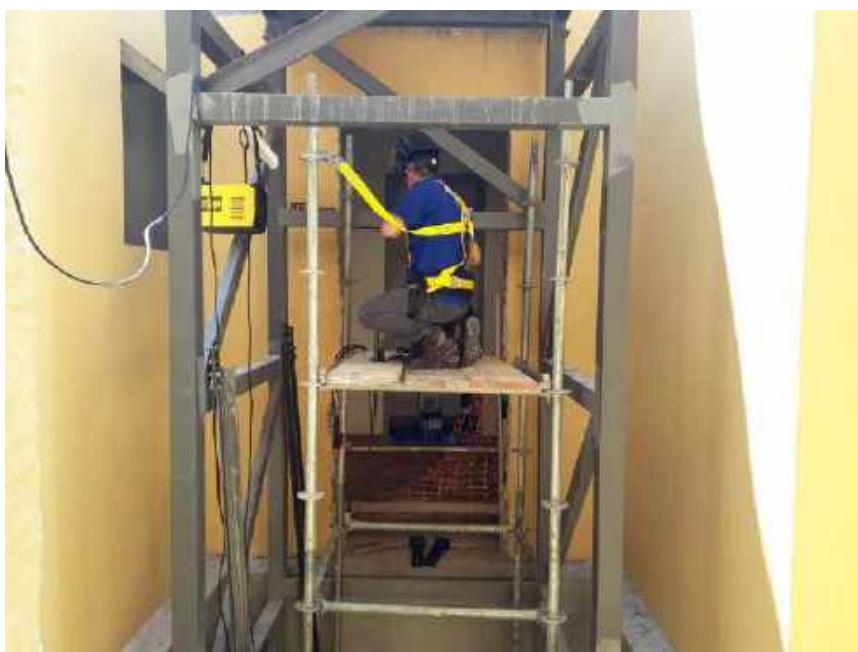
Foto 45 - Montagem da plataforma elevatória
