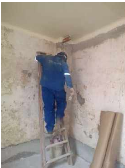
Foto 37 - Pintura lisa do forro – Casa 06
