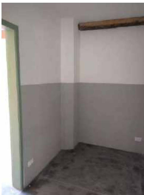
Foto 30 – Instalação dos acabamentos de elétrica – Casa 06
