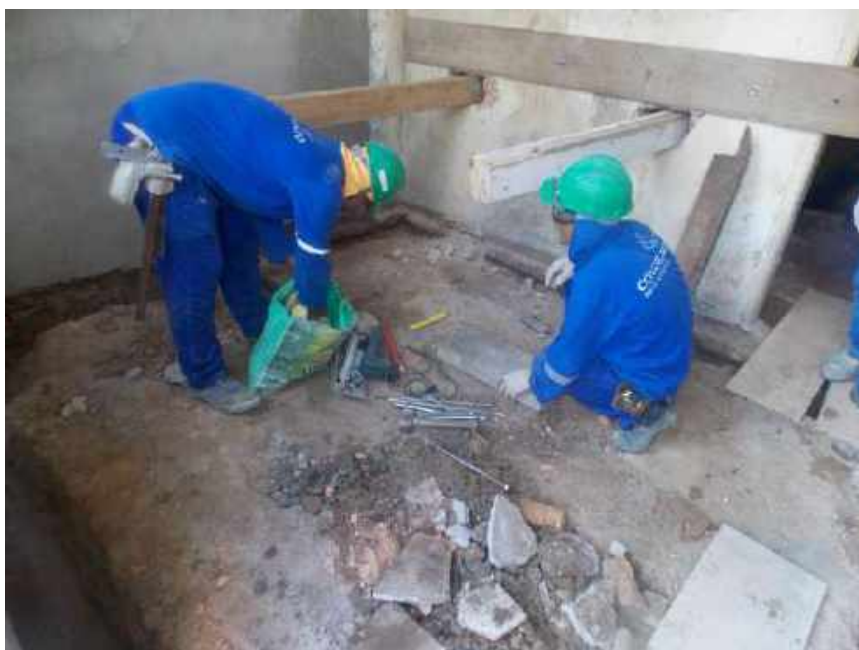
Foto 24 – Escoramento da alvenaria para execução dos serviços na base da alvenaria – Casa 06
