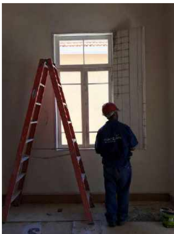
Foto 75 – Pintura das esquadrias – Casa 06
