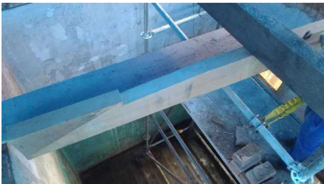
Foto 01: Substituição das peças danificadas da tesoura da Casa 6.
