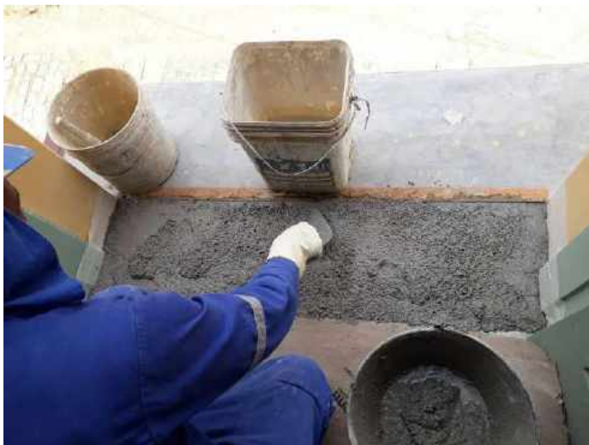
Foto 34 – Execução da soleira de granilite– Casa 06
