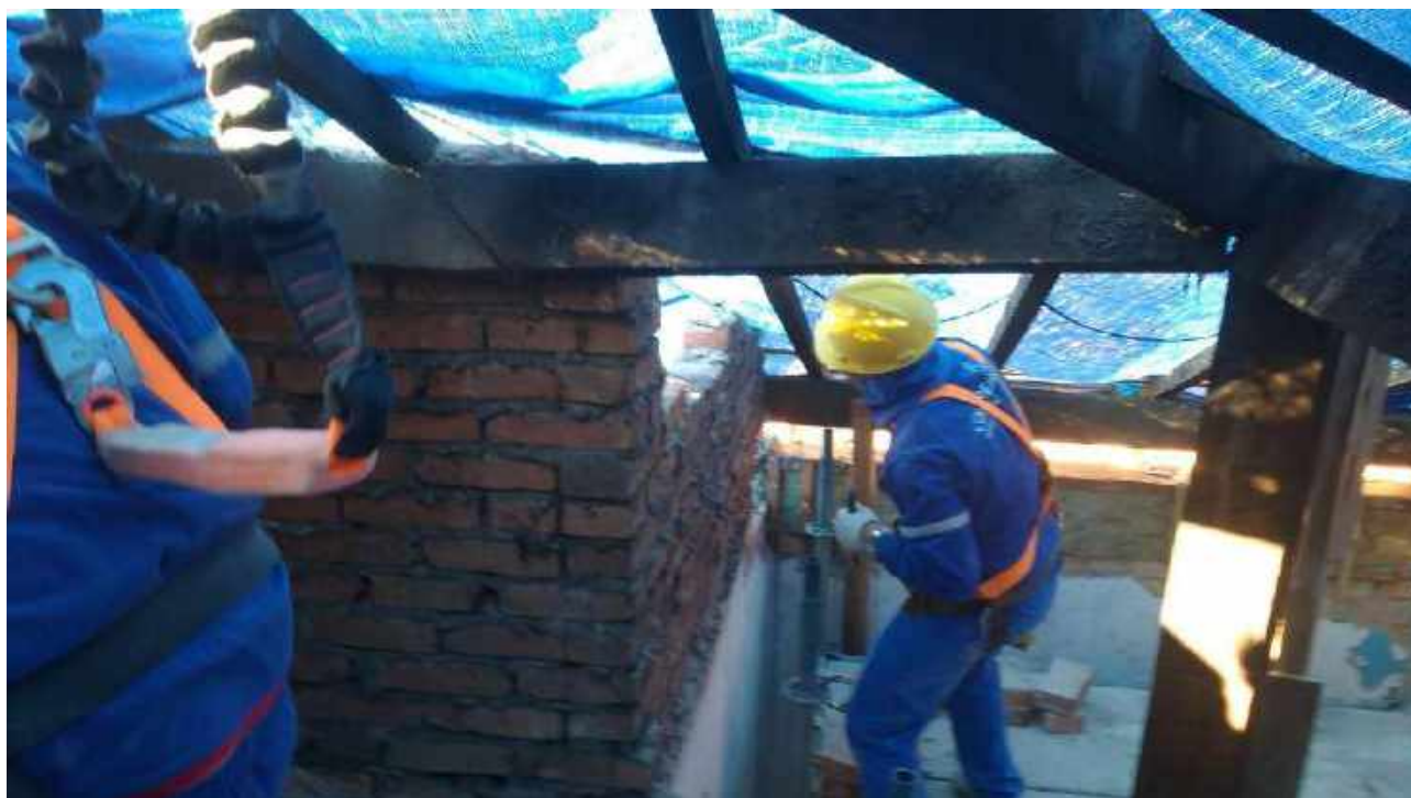
Foto 11: Remontagem da alvenaria – Casa 6
