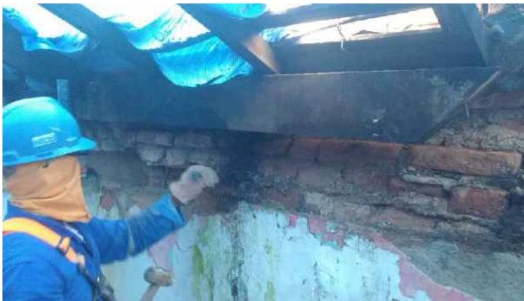
Foto 01: Abertura para execução de cinta de concreto
