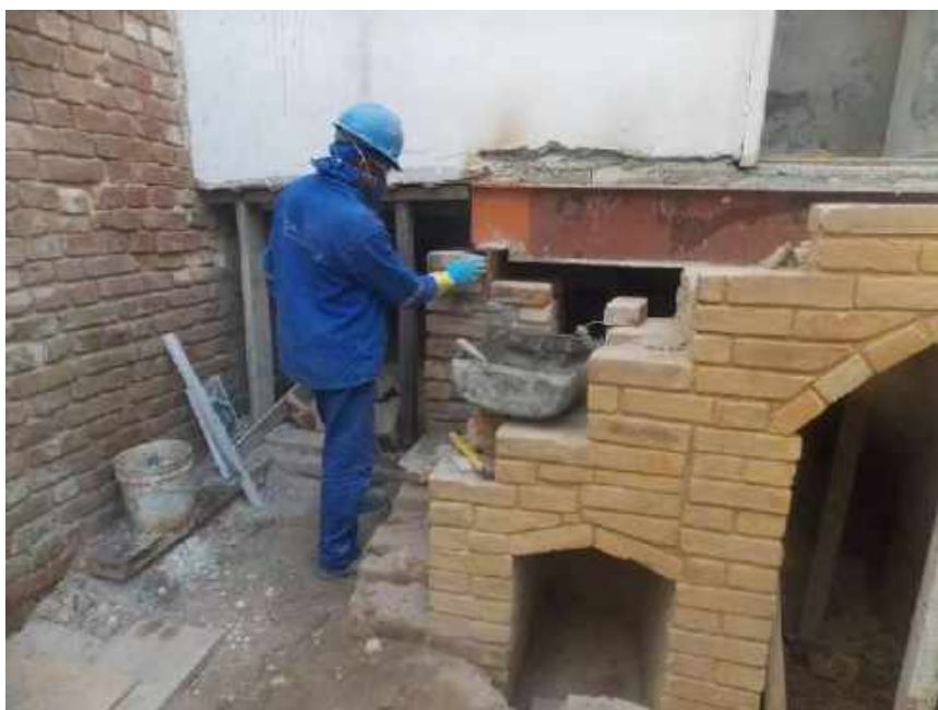
Foto 41- Execução de reforço estrutural – Casa 06
