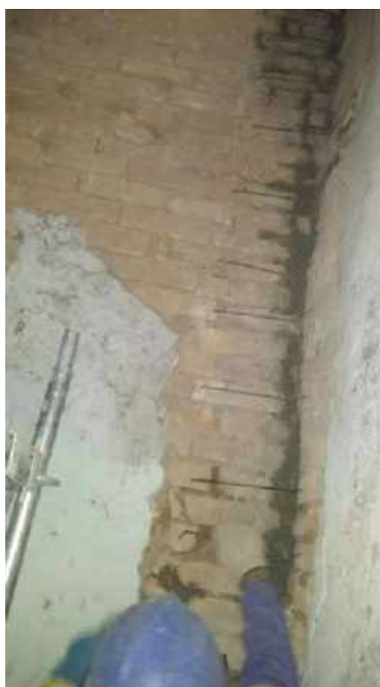
Foto 30: Consolidação das alvenarias – Casa 06.
