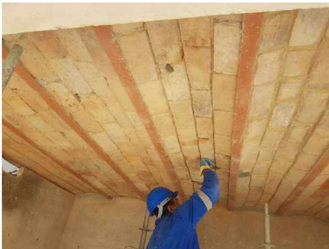
Foto 03 – Restauro dos tijolos da abobadilha – Casa 05
