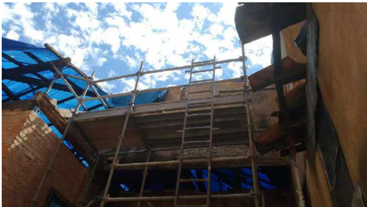
Foto 13: Escoramento das alvenarias para execução de cinta.
