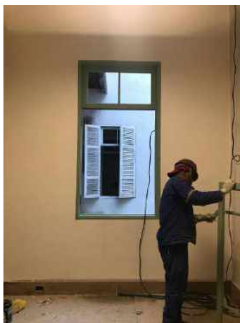
Foto 26 – Execução da pintura lisa das esquadrias de madeira – Casa 06
