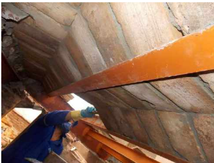
Foto 54 – Remontagem da abobadilha – Casa 06
