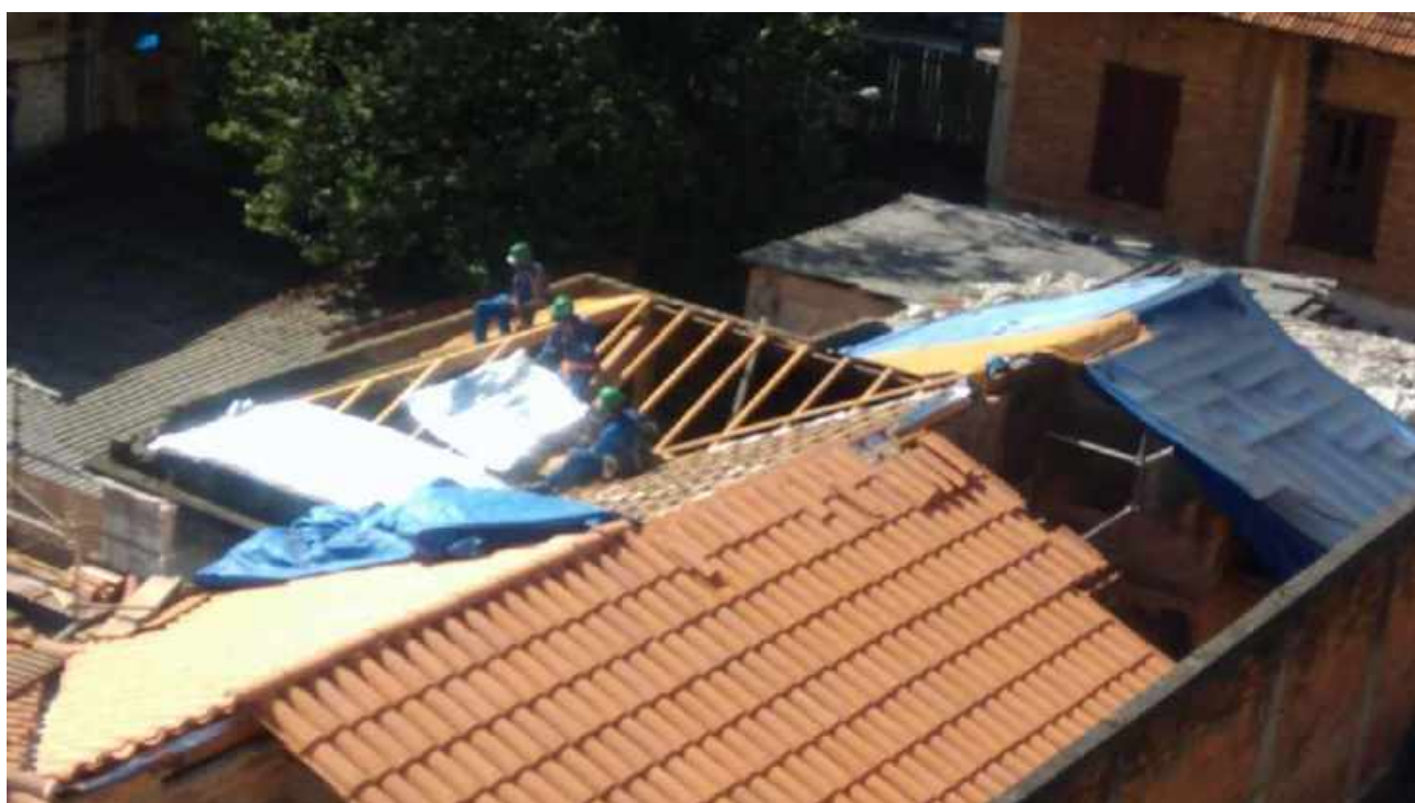
Foto 78: Substituição das peças danificadas da tesoura da Casa 6.
