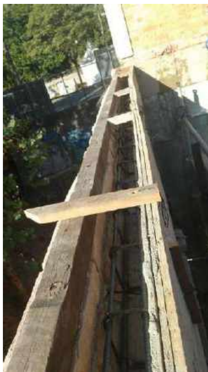
Foto 67: Concretagem da cinta – Casa 06
