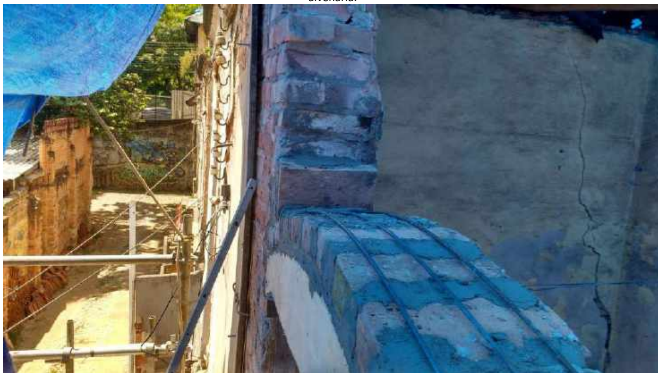
Foto 29: Remontagem da verga em arco da porta.
