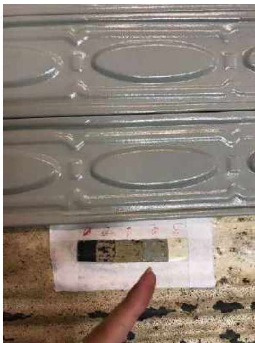
Foto 76 – Prospecção do forro metálico – Casa 06
