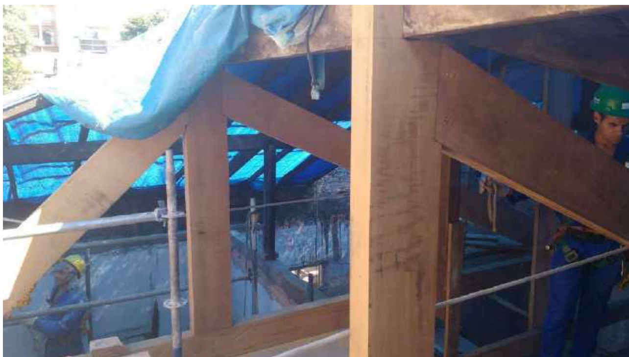
Foto 08: Substituição das peças danificadas da tesoura da Casa
