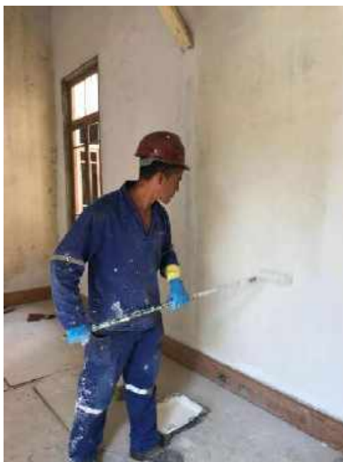
Foto 19 – Aplicação de seladora nas paredes internas – Casa 06
