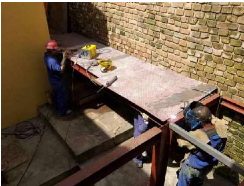
Foto 22 – Instalação da passarela metálica
