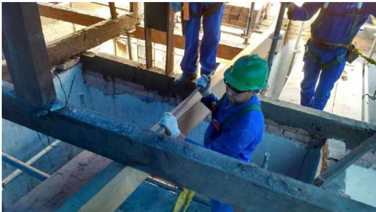
Foto 01: Substituição das peças danificadas da tesoura da Casa 6.
