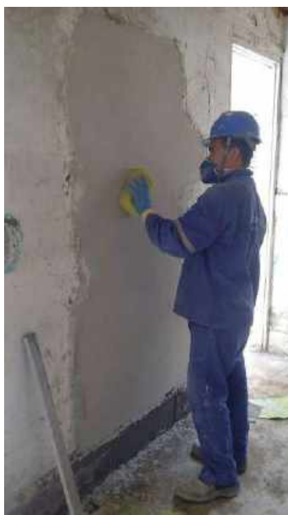
Foto 18 – Execução do emboço
