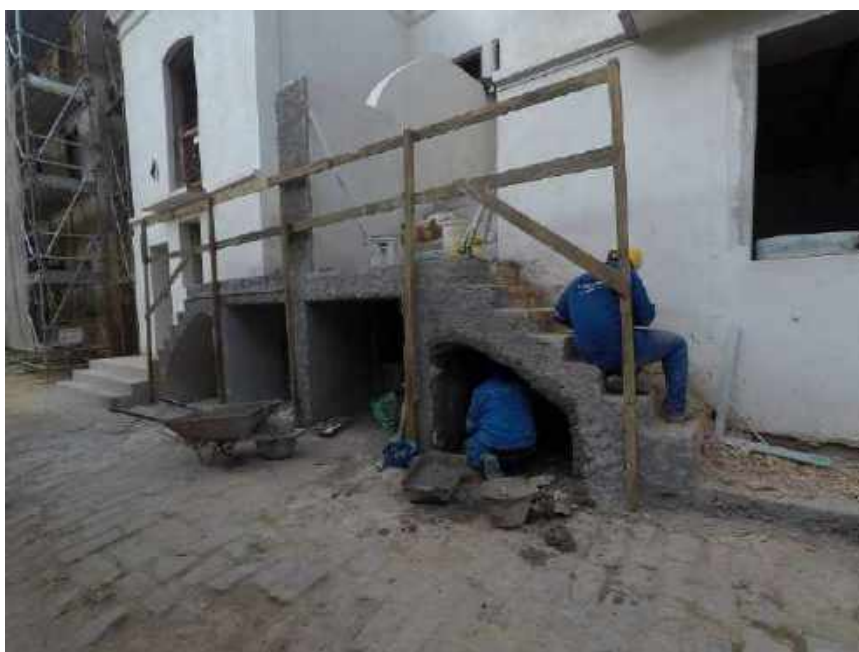
Foto 32 – Execução do emboço na alvenaria existente – Casa 06
