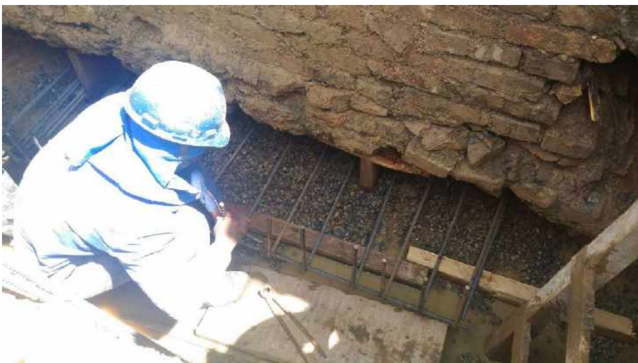
Foto 07: Armação dos blocos de fundação.
