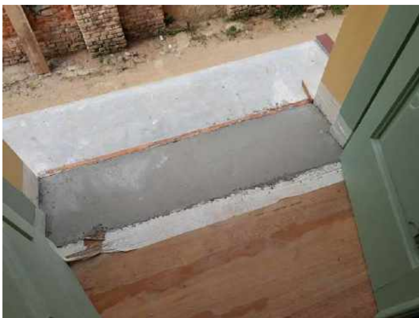
Foto 10 – Execução das soleiras das portas – Casa 06
