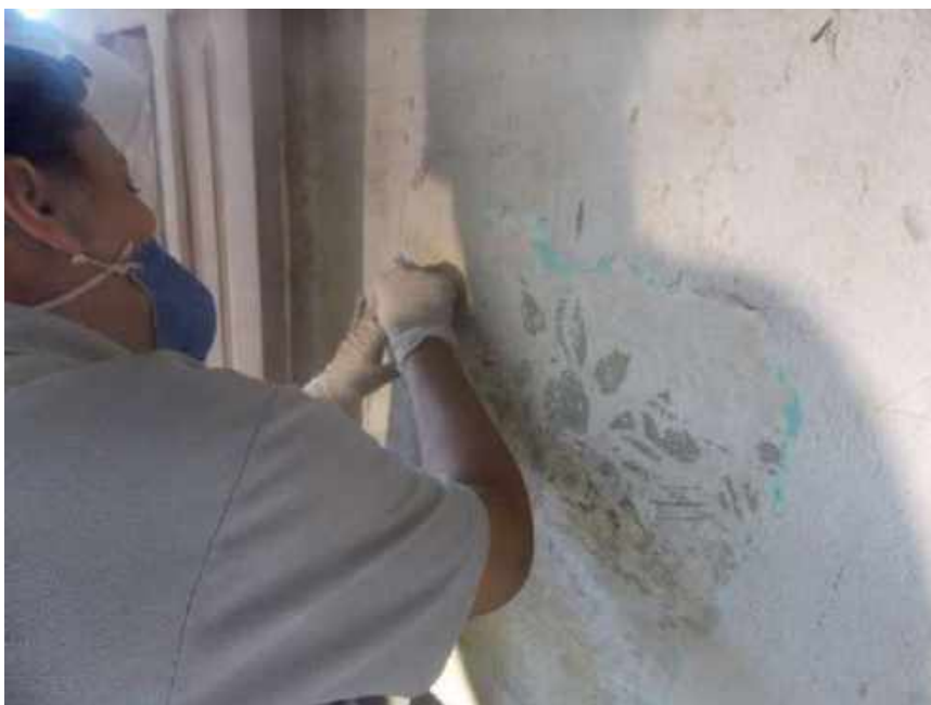
Foto 07 – Decapagem manual cuidadosa das paredes internas – Casa 06
