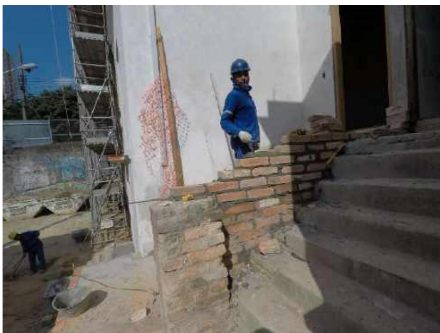
Foto 26 – Elevação da alvenaria – Casa 06
