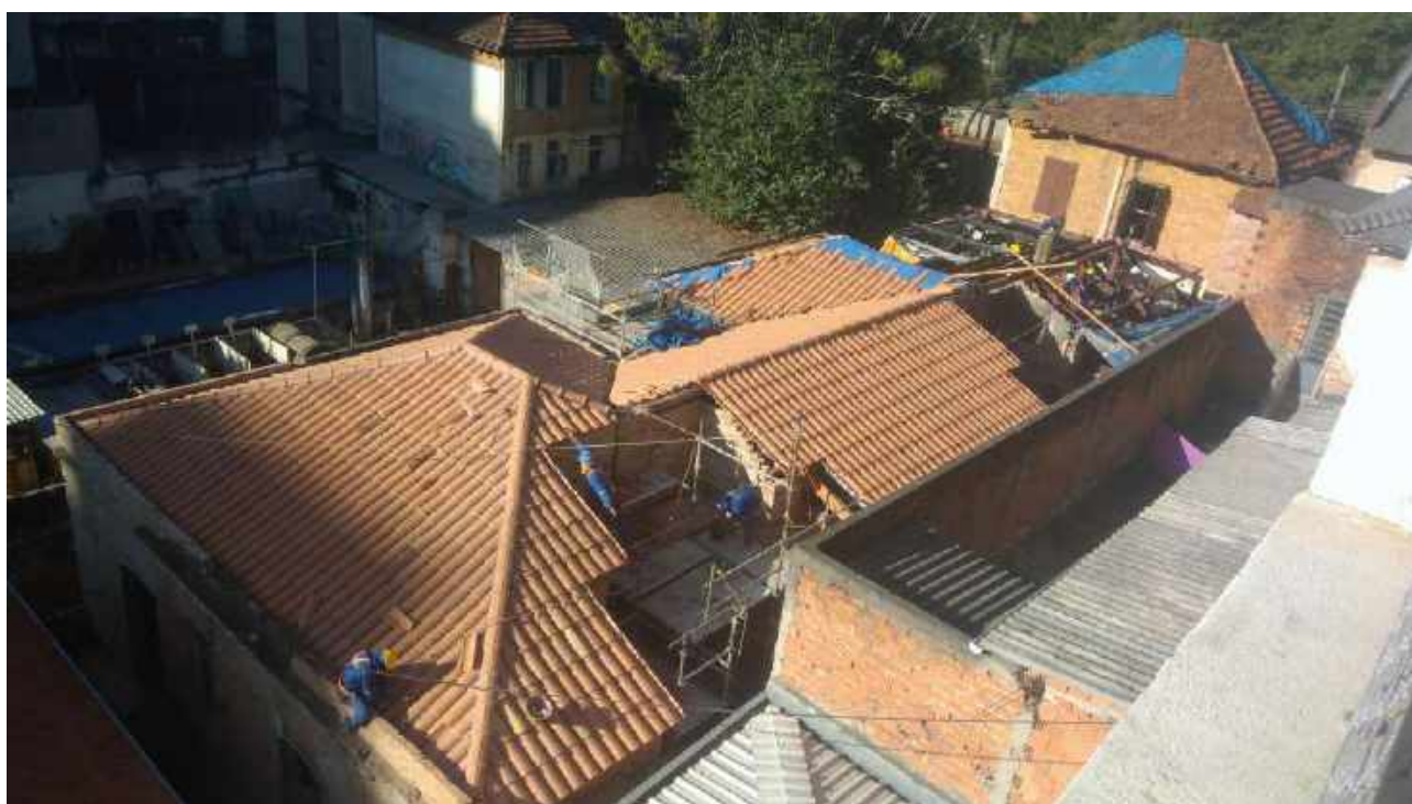
Foto 11: Instalação de caibros;
