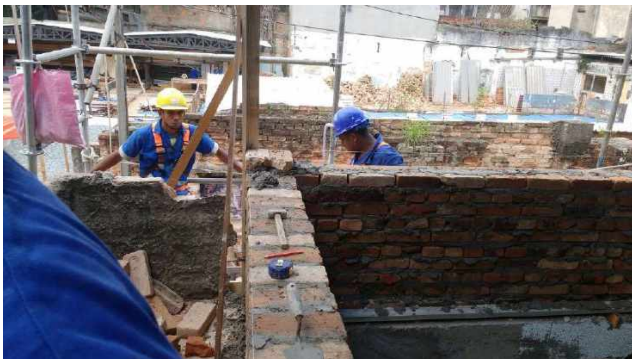
Foto 27: Remontagem da alvenaria.
