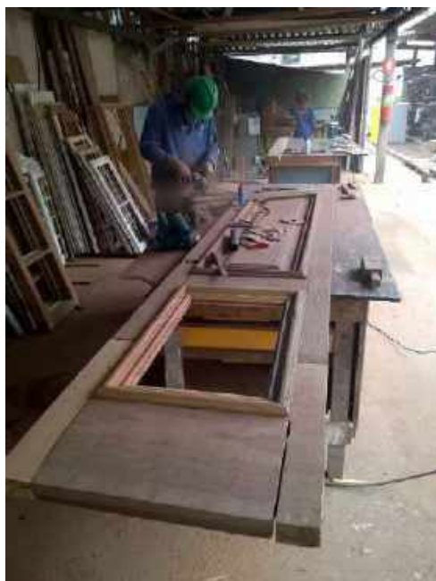
Foto 27- Restauração das portas de madeira – Casa 06
