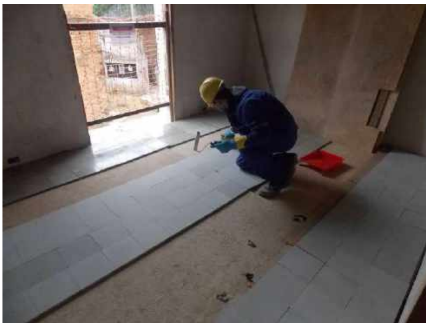
Foto 45 – Aplicação de resina nos pisos – Casa 06
