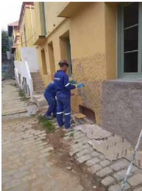
Foto 05 – Pintura com tinta mineral da fachada principal – Casa 06
