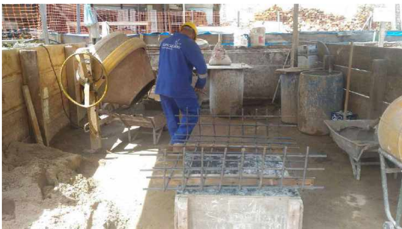
Foto 09: Armação dos blocos de fundação.
