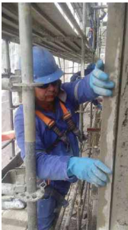
Foto 09 – Execução do emboço da fachada – Casa 06
