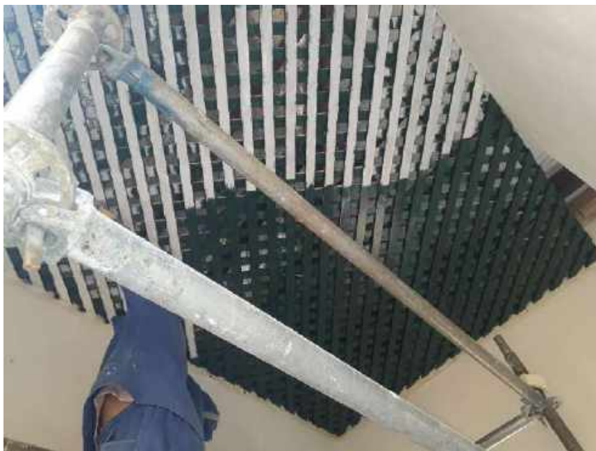
Foto 32 – Pintura lisa do forro treliçado de madeira – Casa 06
