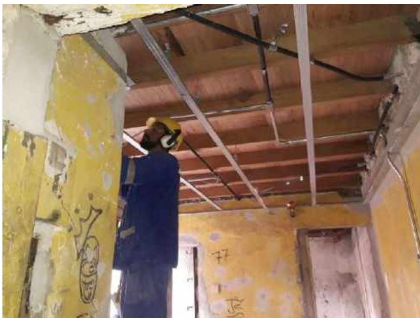
Foto 47 – Instalação do forro de drywall – Casa 06
