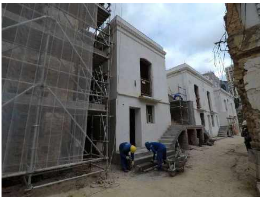
Foto 28 – Execução da argamassa de acabamento – Casa 06
