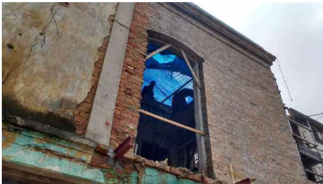
Foto 07: Instalação de perfis metálicos das varandas.
