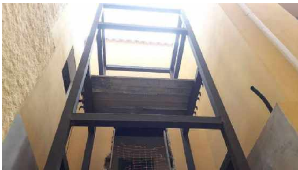
Foto 44 – Montagem da estrutura metálica da plataforma elevatória
