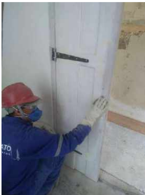
Foto 07 - Lixamento das portas de madeira – Casa 06
