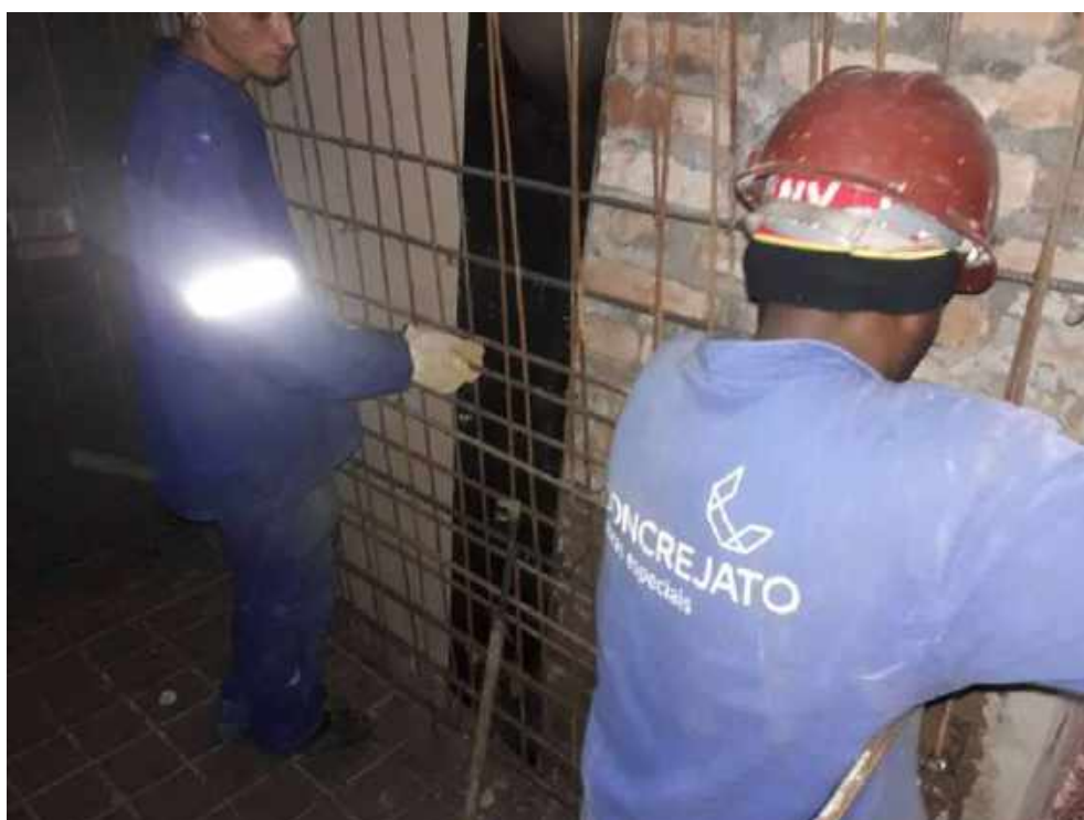
Foto 58 – Execução da armação da forma – Casa 06
