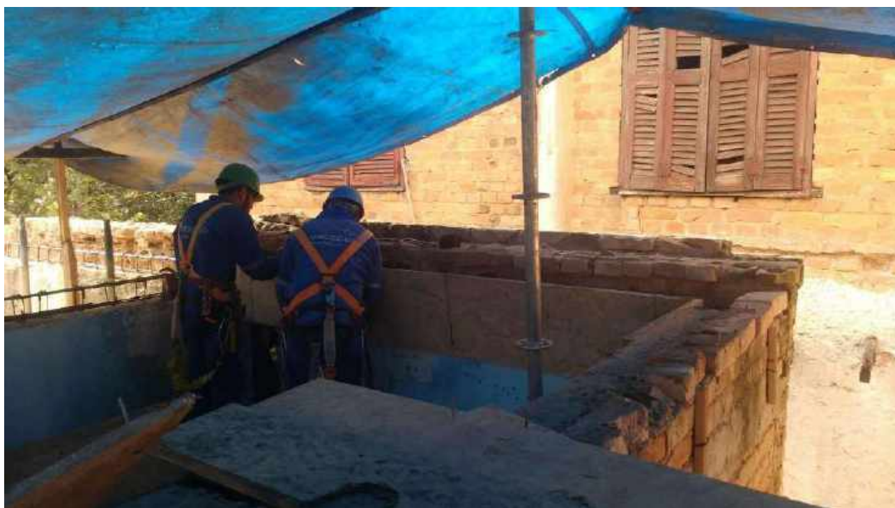
Foto 64: Remontagem da alvenaria.
