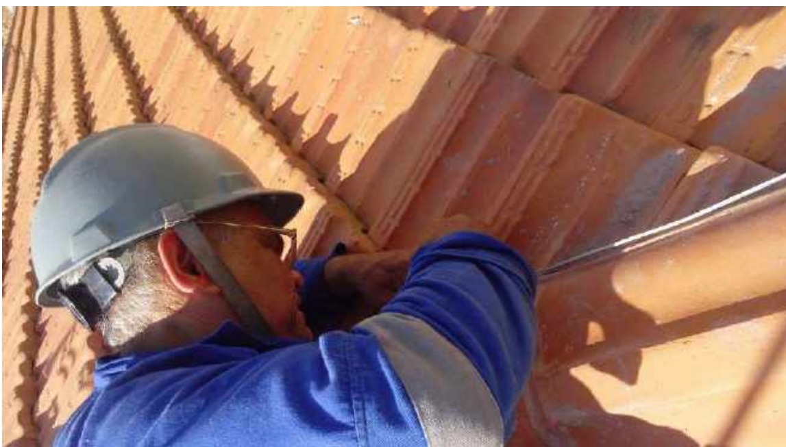
Foto 36 – Instalação das fitas de SPDA na cobertura – Casa 06
