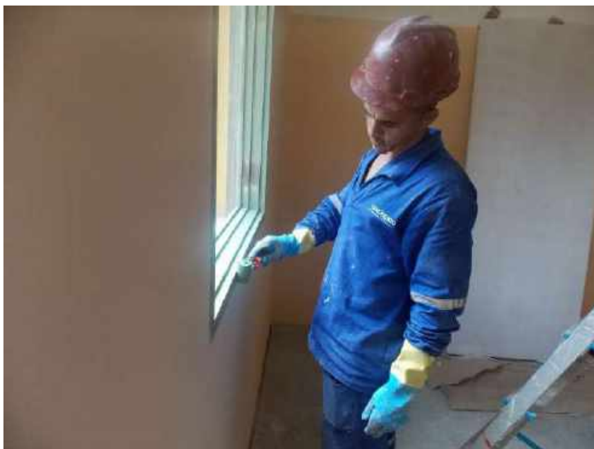
Foto 13 – Pintura lisa dos batentes de madeira – Casa 06
