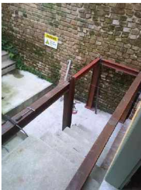
Foto 21 – Instalação do perfil metálico para execução da passarela metálica
