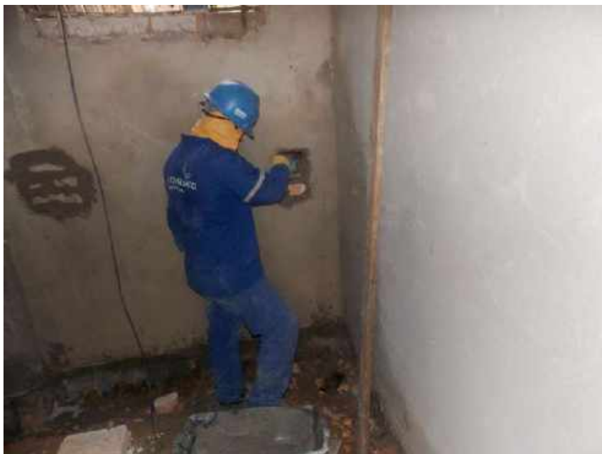
Foto 29 – Recuperação da alvenaria – Casa 06
