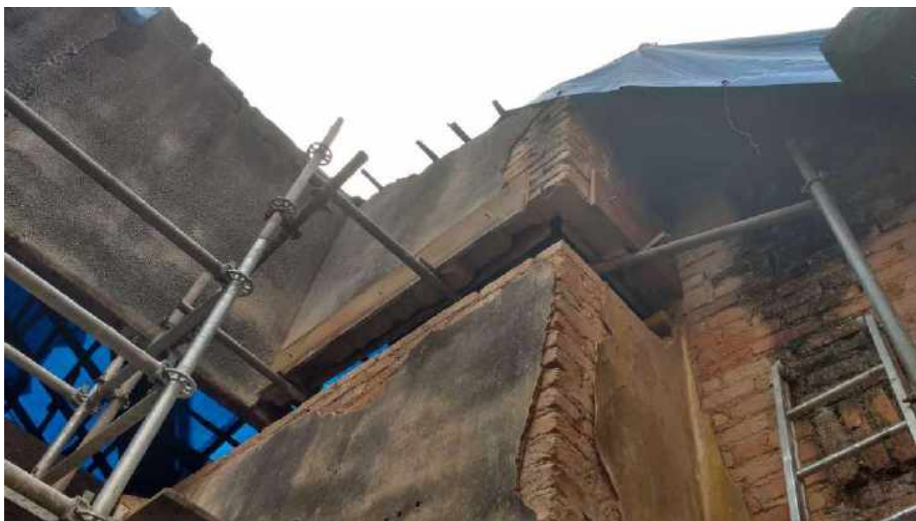
Foto 30: Escoramento das alvenarias para execução de cinta de concreto.
