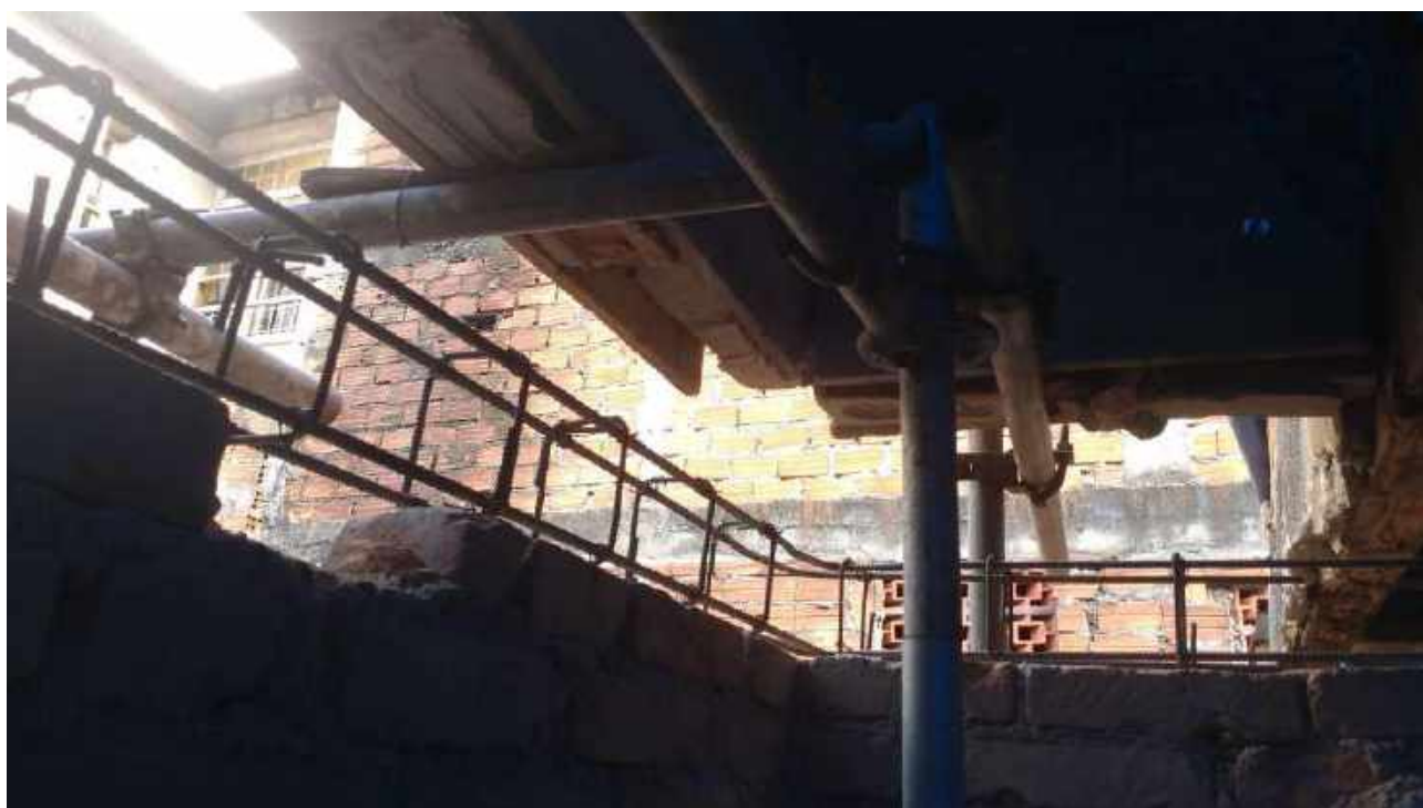
Foto 22: Execução de cinta de concreto.
