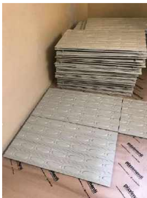
Foto 51 - Armazenamento das peças metálicas do forro – Casa 06
