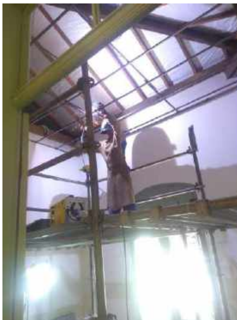
Foto 09 – Instalação da barra metálica para instalação do forro metálico – Casa 06
