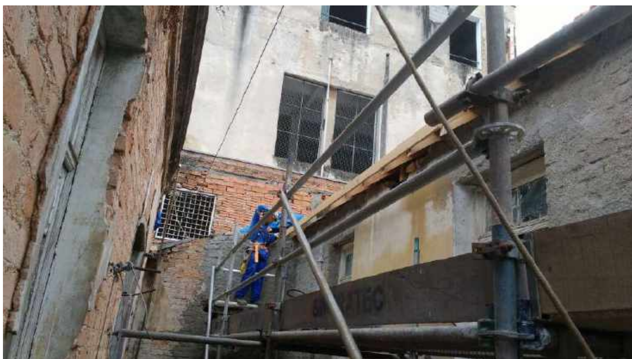
Foto 26: Instalação da tabeira de suporte da calha da Casa 5.
