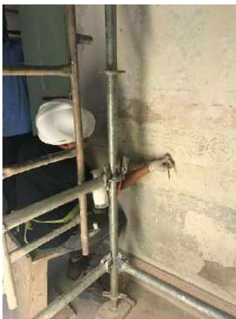
Foto 08 – Decapagem manual cuidadosa das paredes internas – Casa 06
