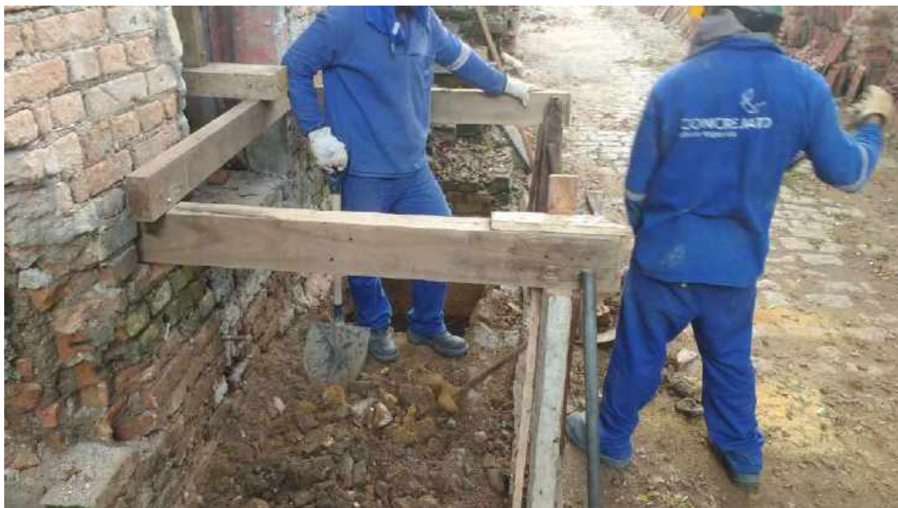
Foto 23: Execução do bloco de fundação.
