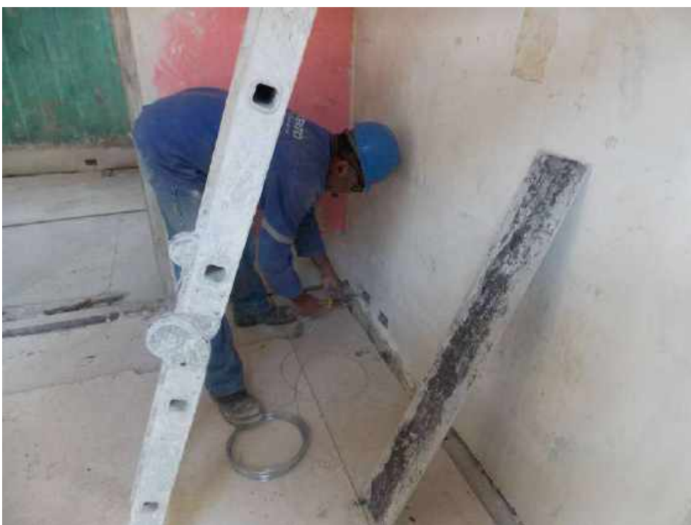
Foto 36 - Passagem dos cabos para instalação elétrica – Casa 06
