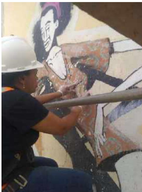
Foto 01 – Consolidação do grafite na fachada lateral – Casa 05
