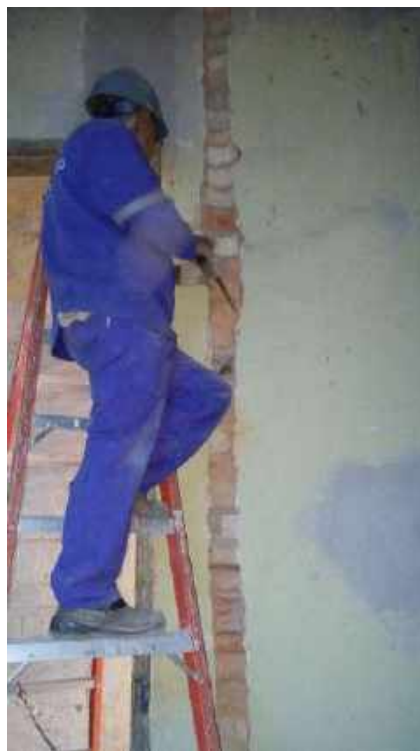
Foto 20 – Instalação de infra estrutura de elétrica.
