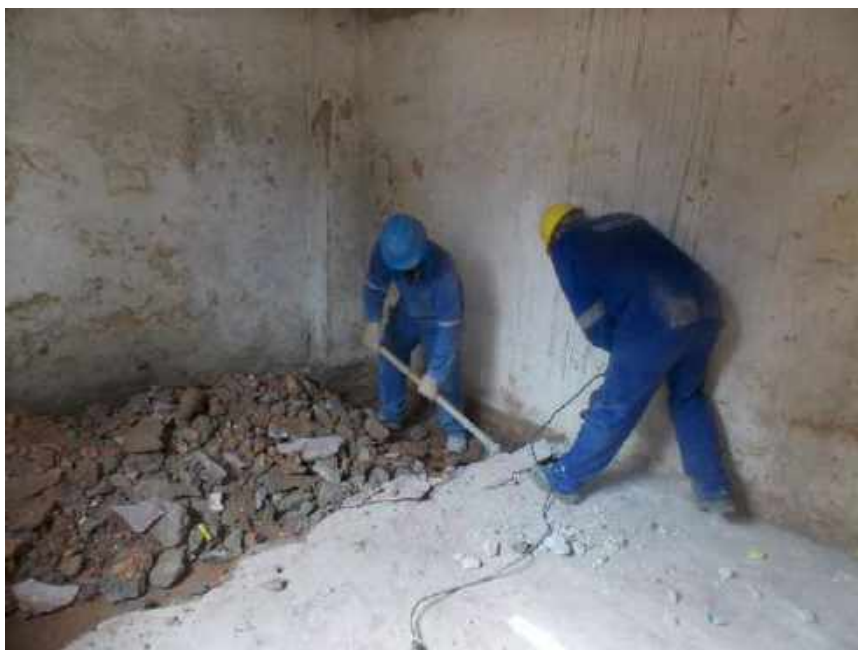
Foto 14 – Execução da escavação mecânica – Casa 06
