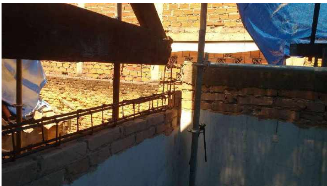
Foto 18: Execução da cinta de trabamento.
