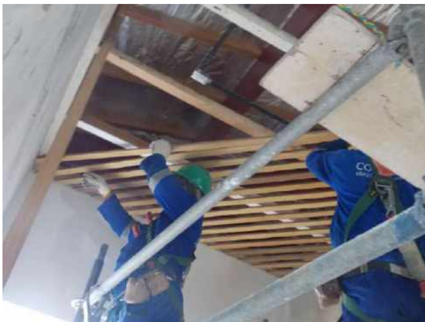
Foto 29- Execução do forro treliçado de madeira – Casa 06
