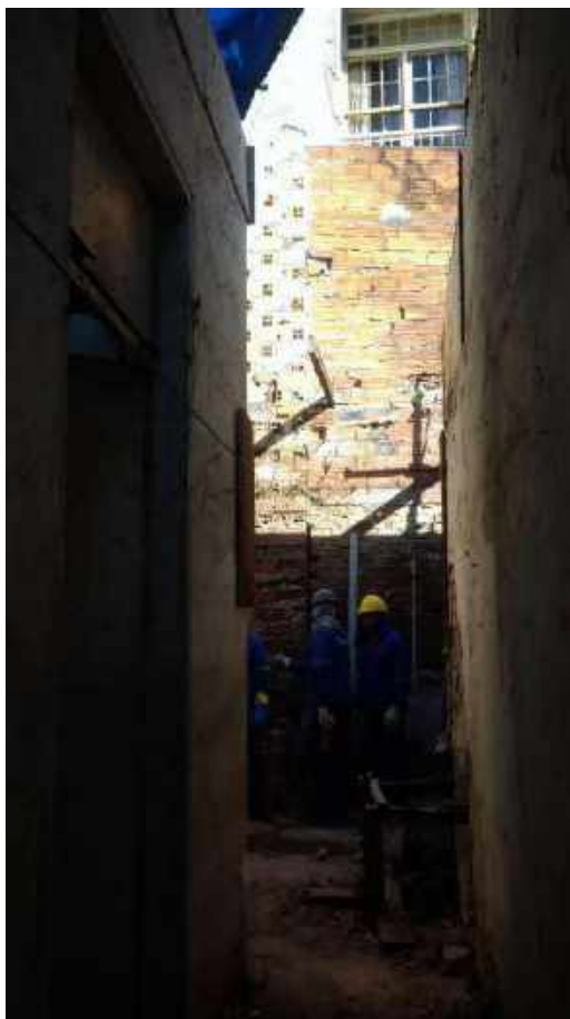
Foto 79: Substituição das peças danificadas da tesoura da Casa 6.
