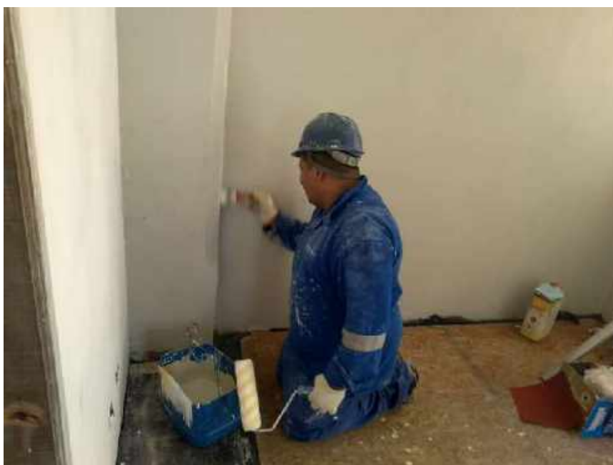
Foto 20 – Aplicação de seladora nas paredes internas – Casa 06
