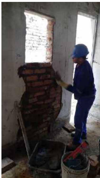
Foto 03 Recuperação da alvenaria - Casa 06
