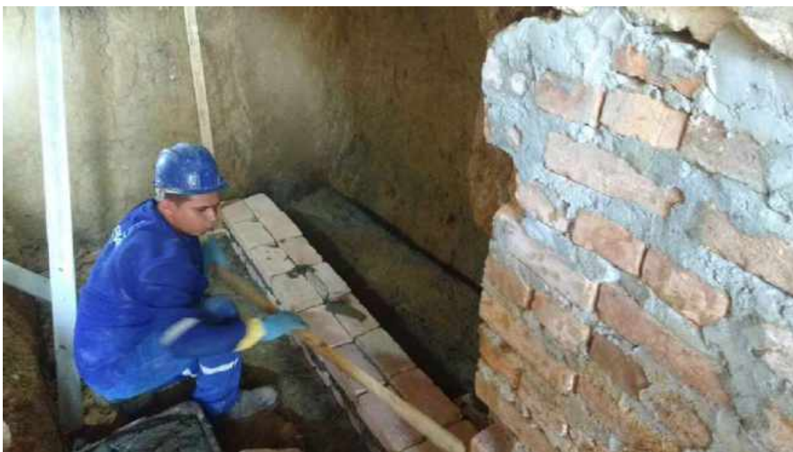
Foto 44 – Elevação da alvenaria externa após escavação do fosso do elevador – Casa 06
