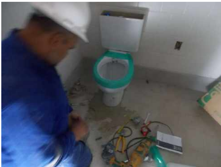
Foto 41 – Instalação dos vasos sanitários – Casa 06
