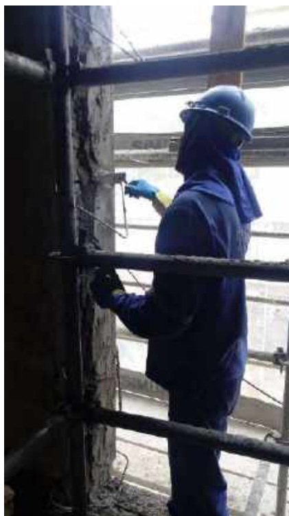
Foto 05 – Requadro dos vãos – Casa 06
