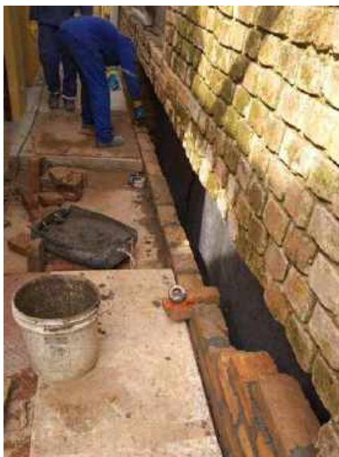
Foto 19 – Elevação da alvenaria existente, após reparos na fachada dos fundos – Casa 06
