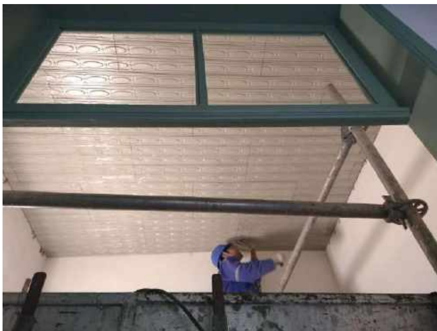
Foto 11 – Instalação do forro metálico na cobertura – Casa 06
