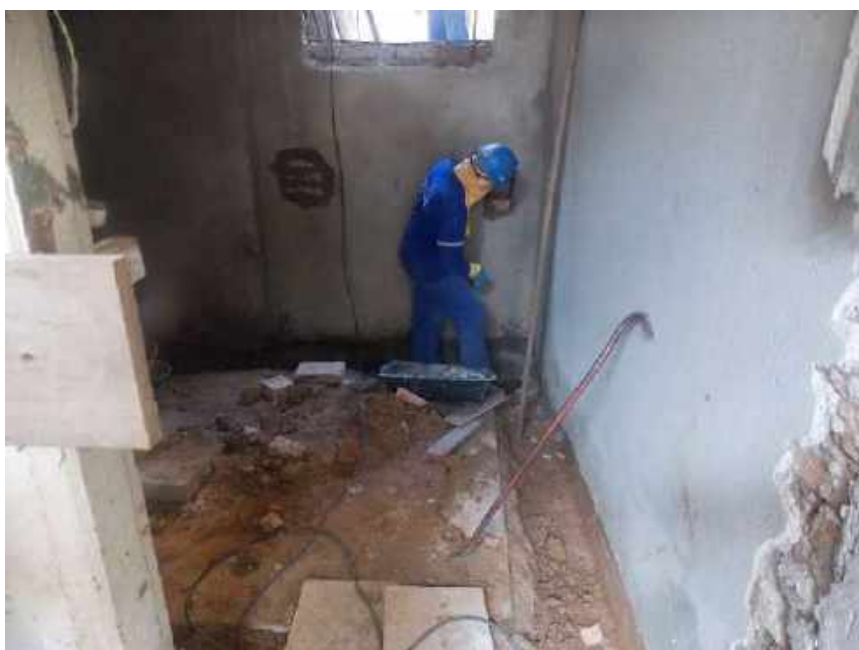
Foto 30 – Recuperação da alvenaria – Casa 06
