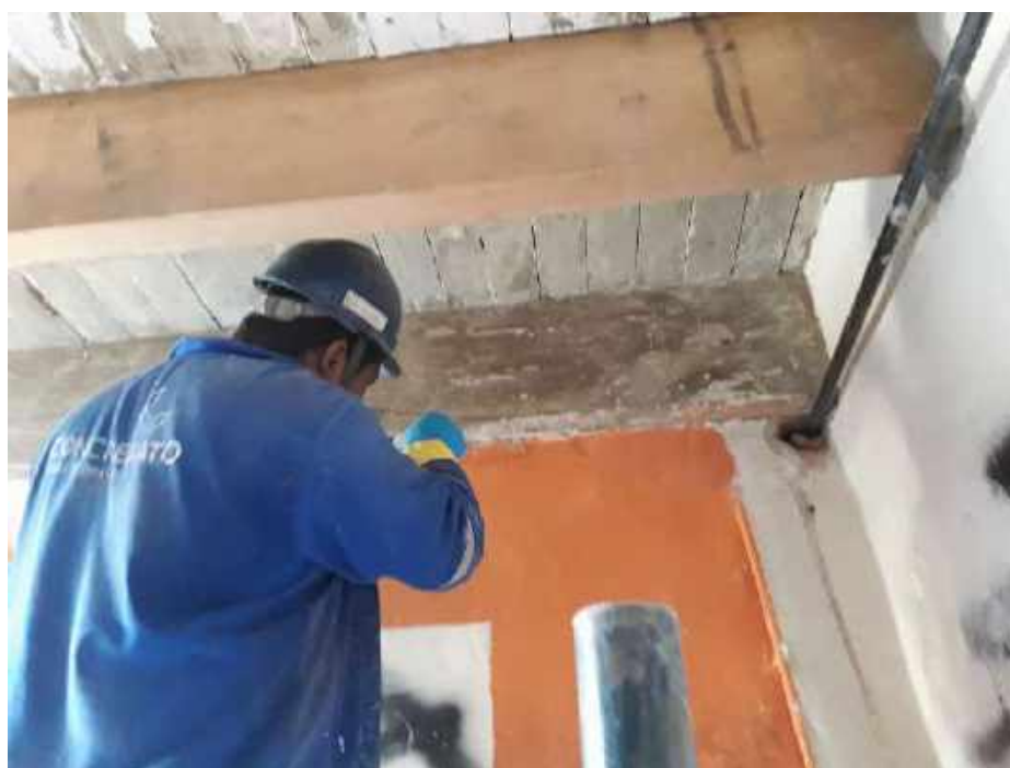
Foto 04 - Decapagem dos forros de madeira – Casa 05
