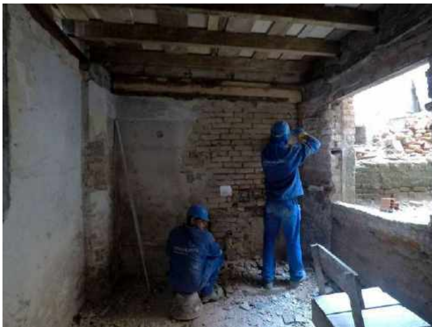
Foto 35 – Remoção do revestimento
