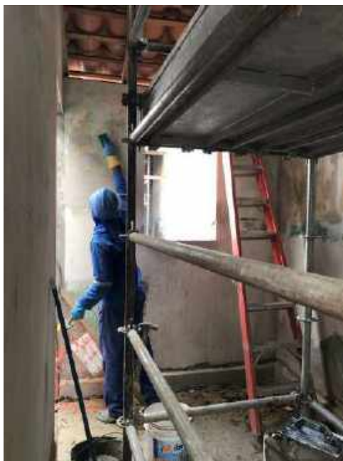
Foto 19 – Execução da argamassa de acabamento das paredes internas – Casa 06
