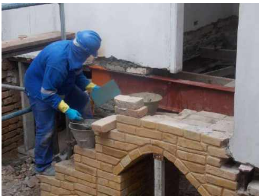
Foto 40 – Fechamento da alvenaria após restauro do perfil metálico – Casa 06
