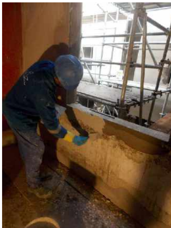
Foto 18 – Execução da argamassa de acabamento – Casa 06
