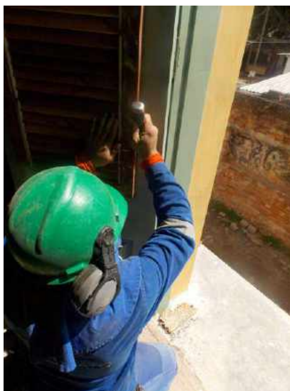
Foto 16 – Instalação da veneziana de madeira – Casa 06
