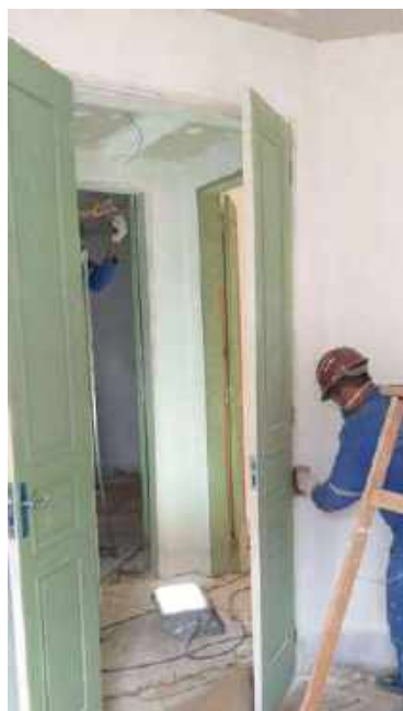
Foto 15 – Pintura lisa das portas de madeira – Casa 06
