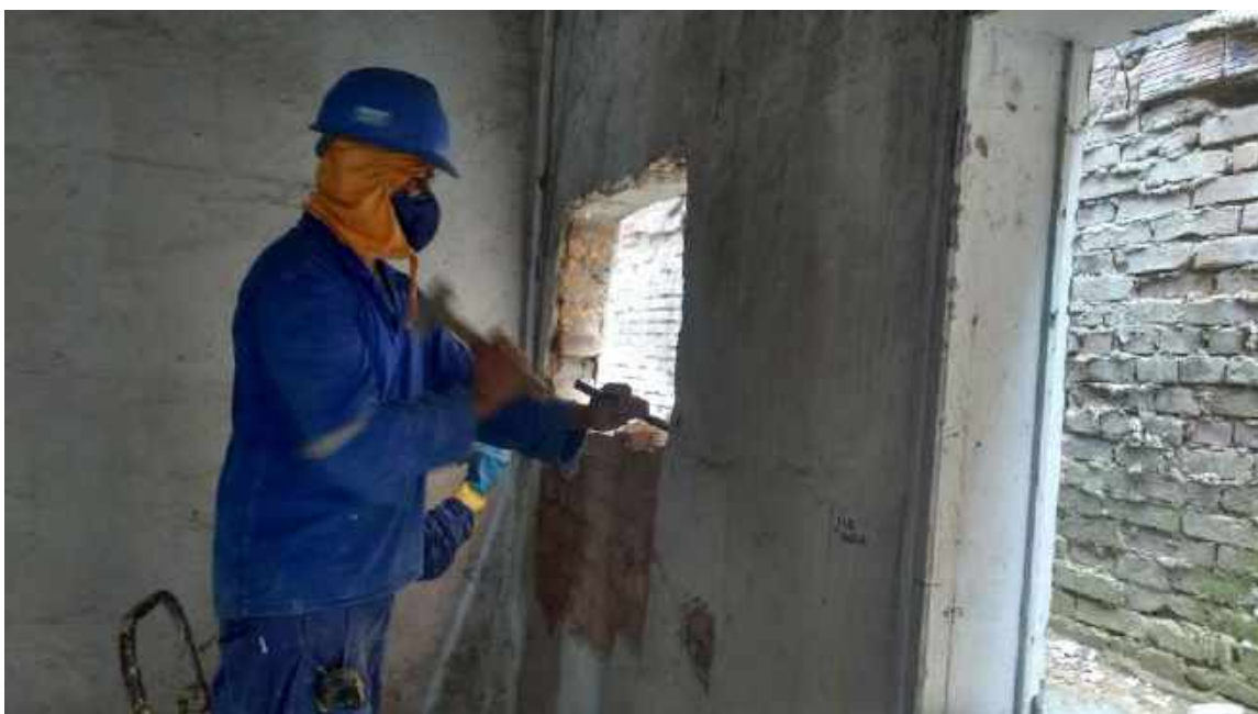
Foto 42 – Abertura do vão da janela – Casa 06
