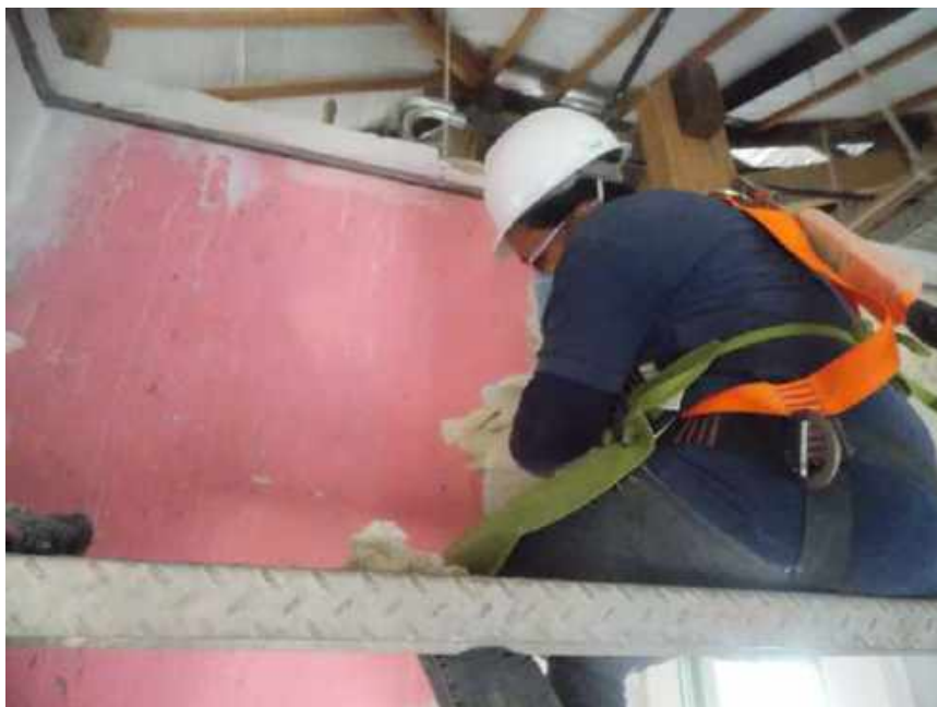
Foto 11 – Decapagem manual cuidadosa das paredes internas – Casa 06
