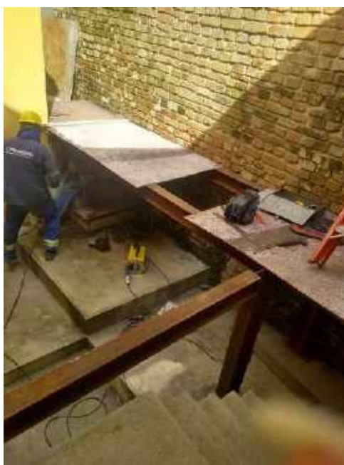
Foto 23 - Instalação da passarela metálica
