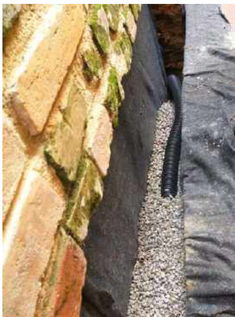
Foto 17 – Execução da drenagem na fachada dos fundos da casa 06
