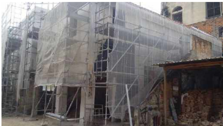
Foto 55: Foto geral – Casa 05
