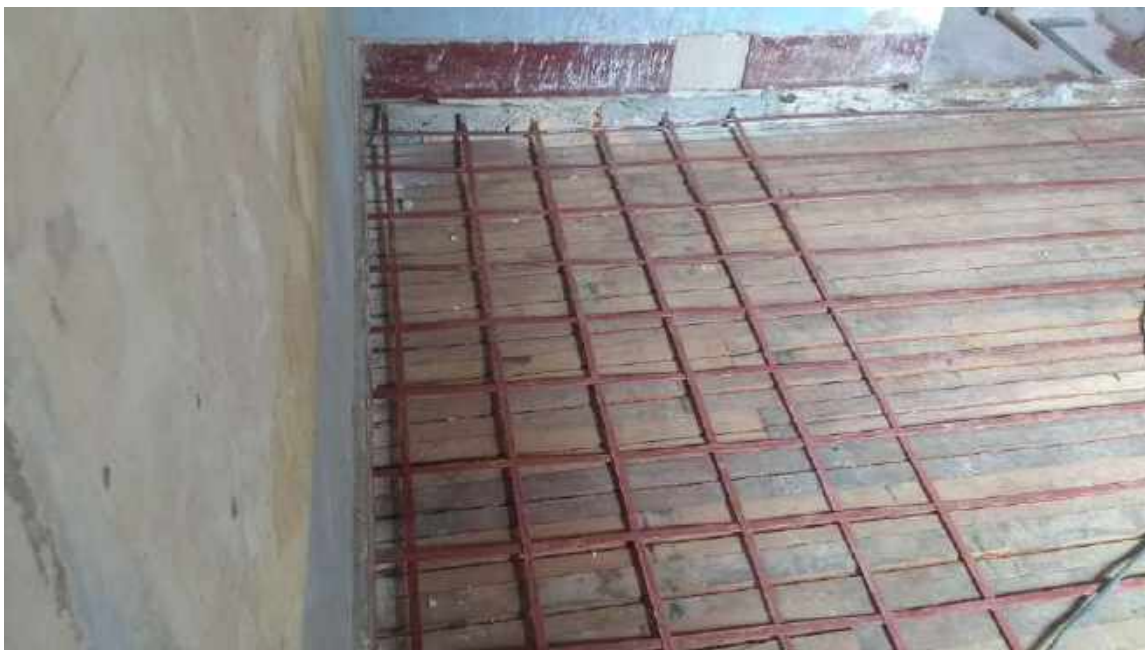
Foto 07 – Instalação da armação para concretagem – Casa 05
