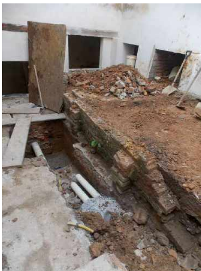
Foto 40 – Passagem das tubulações – Casa 06
