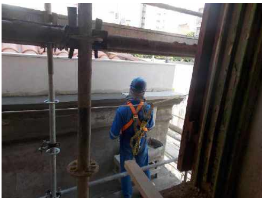
Foto 28 – Execução da argamassa de acabamento da fachada – Casa 06
