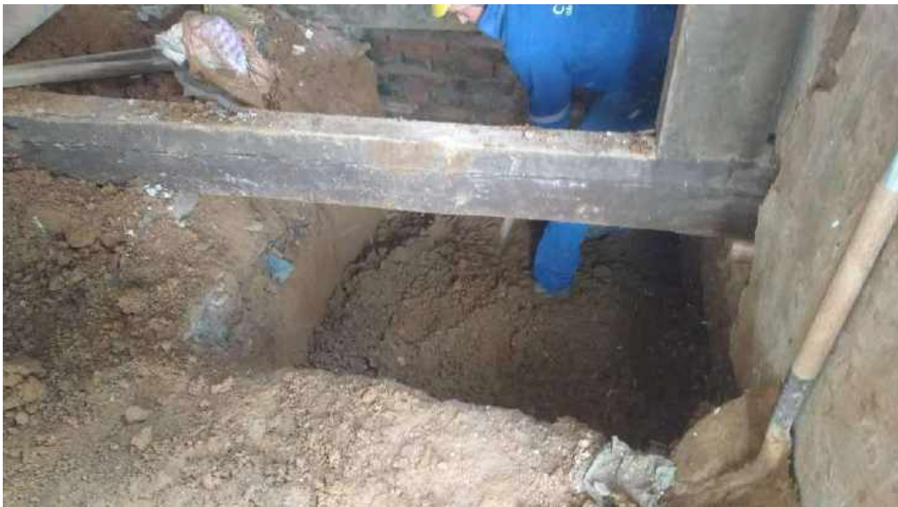
Foto 07: Escoramento e abertura de vala para reforço estrutura.
