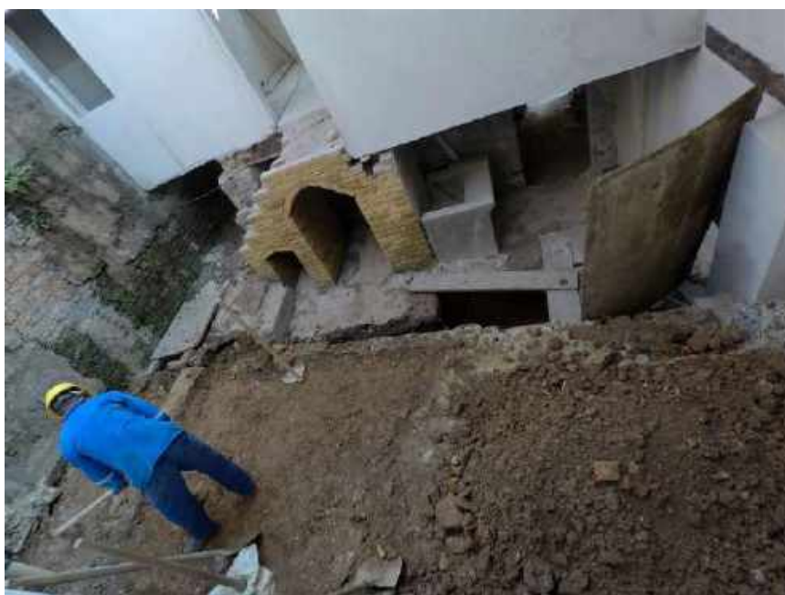
Foto 38 - Escavação manual nós fundos – Casa 06
