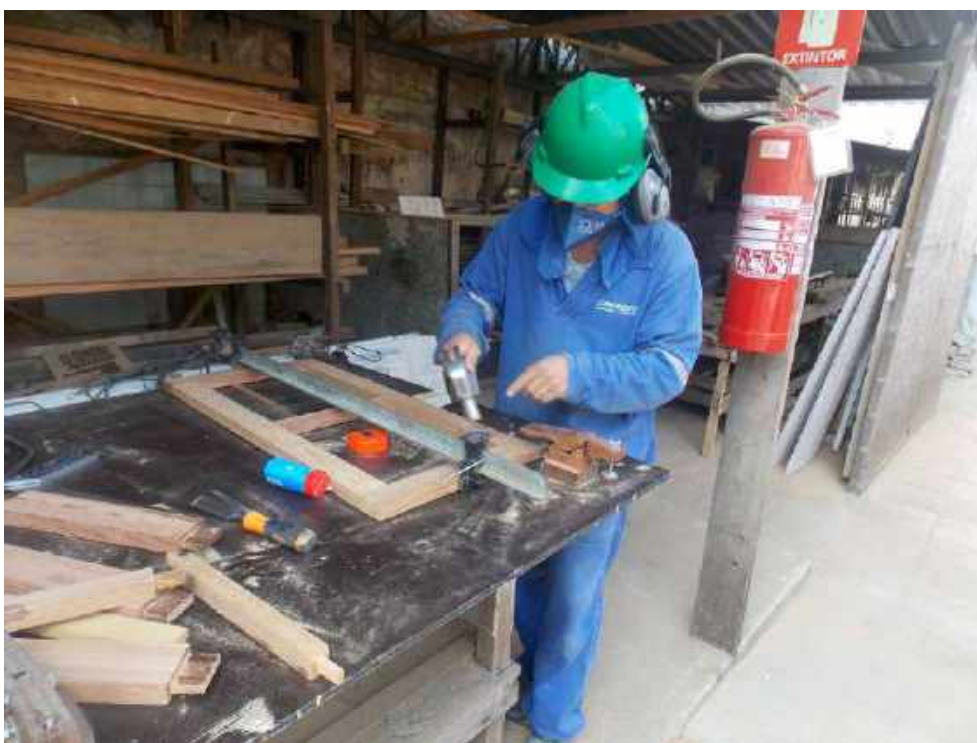
Foto 26 – Execução das esquadrias de madeira – Casa 06
