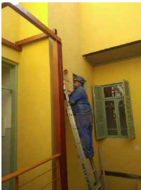
Foto 32 – Pintura lisa das estruturas metálicas
