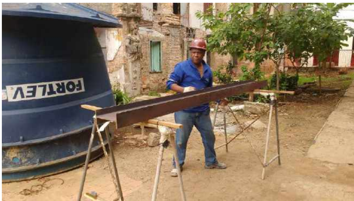
Foto 54 – Tratamento do perfil metálico
