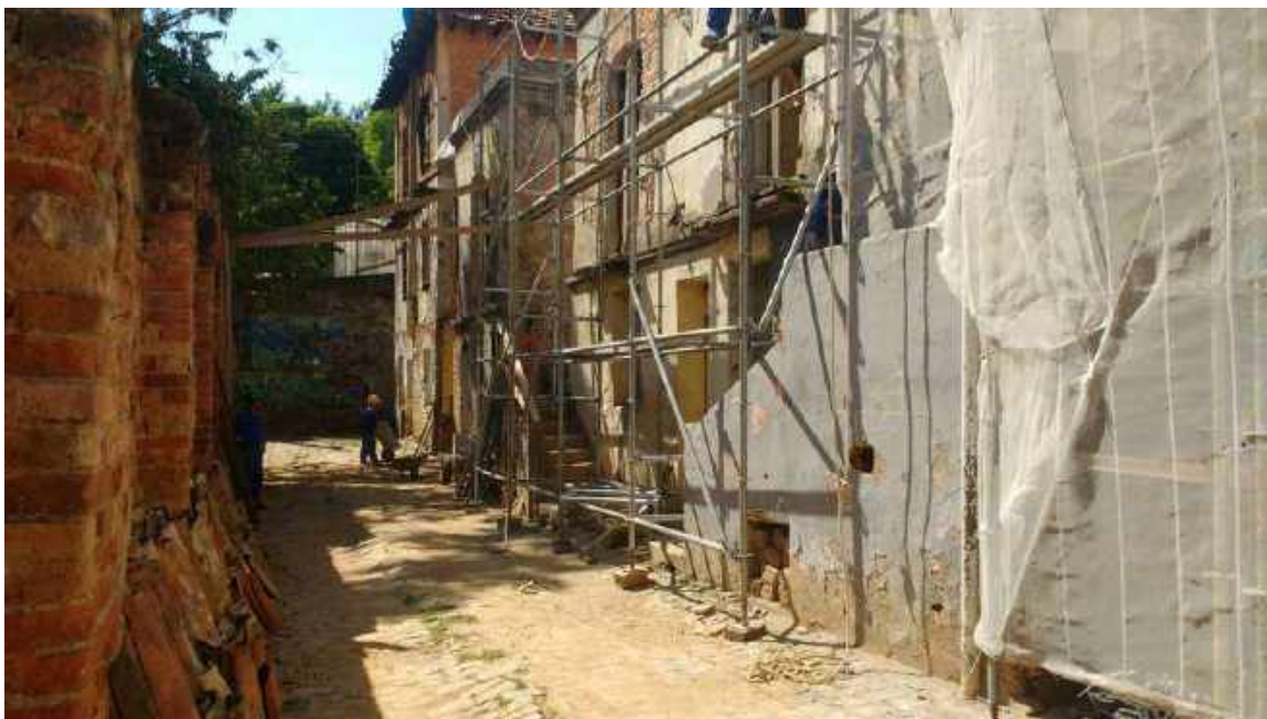
Foto 17 - Montagem do andaime na fachada da casa 06
