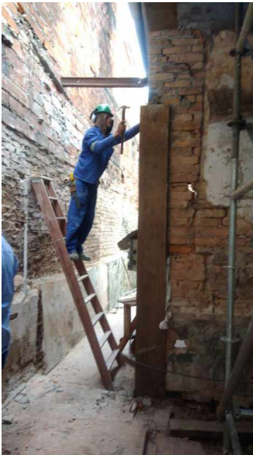
Foto 09: Retirada da fôrma do pilar;
