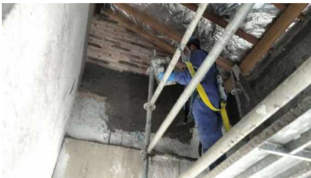
Foto 08- Execução do emboço interno – Casa 07
