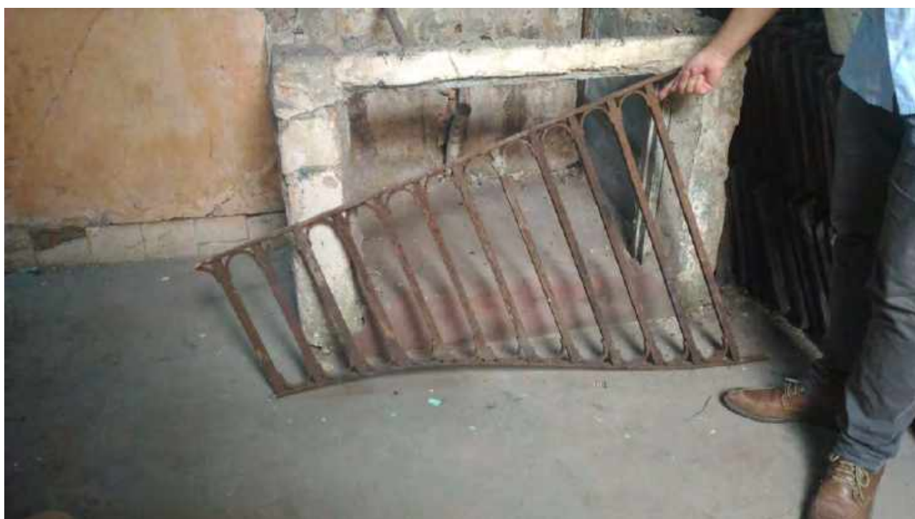
Foto 10: Guarda corpo decorado original da fachada frontal decorado no forro da Casa 6.
