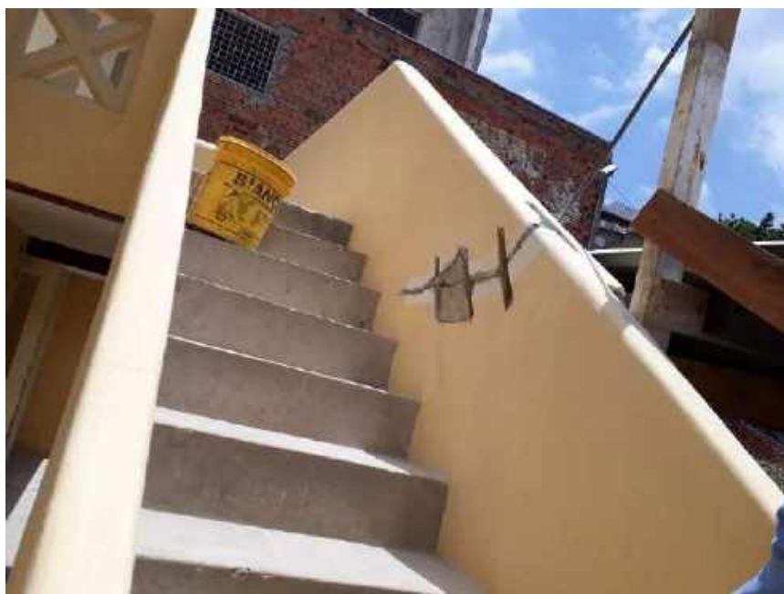
Foto 53– Tratamento das trincas existentes do guarda corpo da escada – Casa 05
