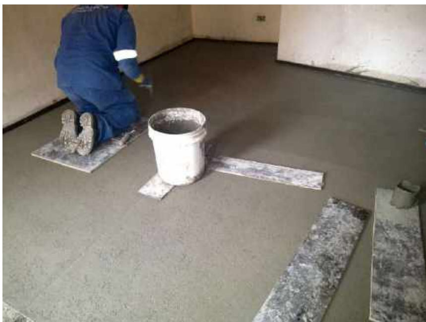
Foto 32 – Execução do piso em cimento queimado – Casa 06
