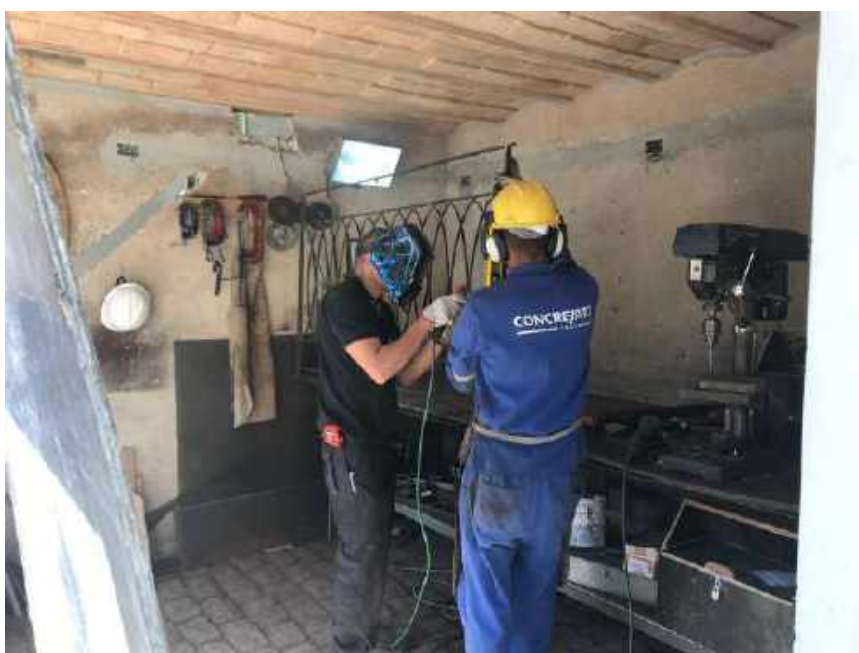
Foto 44 – Execução do gradil metálico – Casa 06
