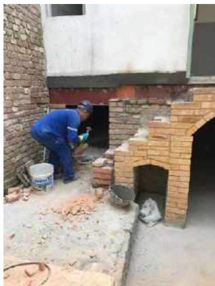
Foto 21 – Elevação da alvenaria da escada – Casa 06
