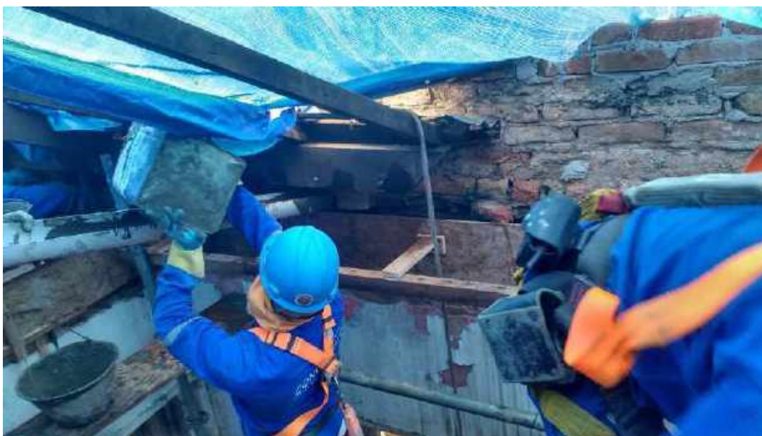
Foto 06: Concretagem da cinta de concreto – Casa 6.
