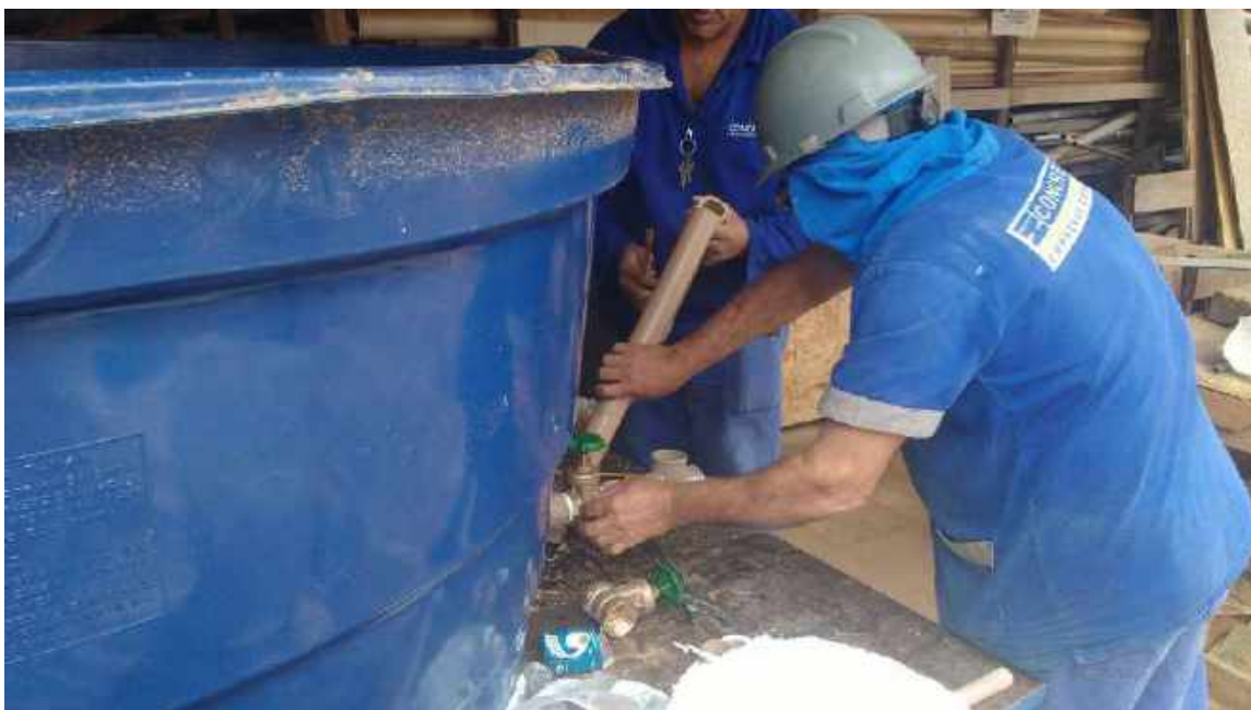
Foto 45 – Instalação do registro das caixas d'Água – Casa 06
