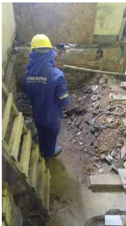
Foto 01 – Remoção de entulho
