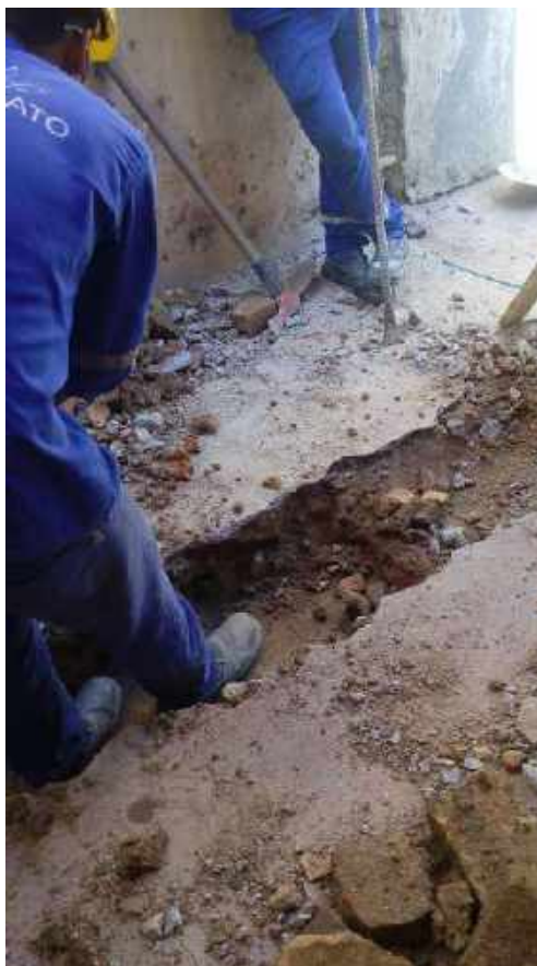
Foto 10 – Escavação manual para execução da alvenaria – Casa 06
