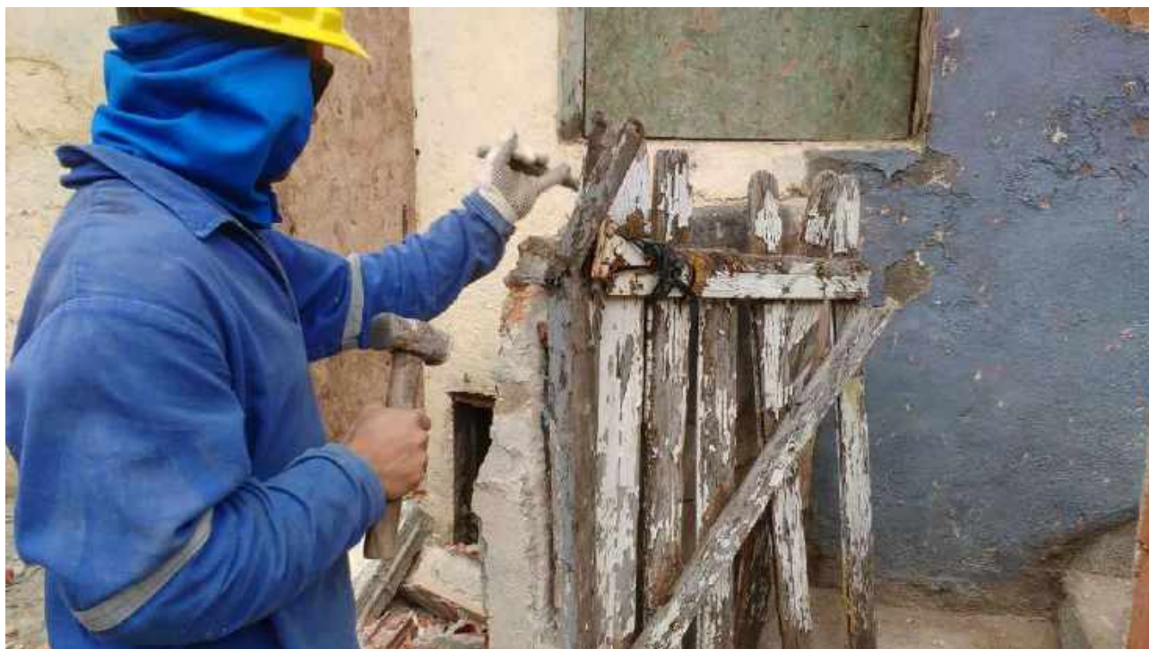
Foto 38: Demolição das alvenarias para adequação do novo uso.
