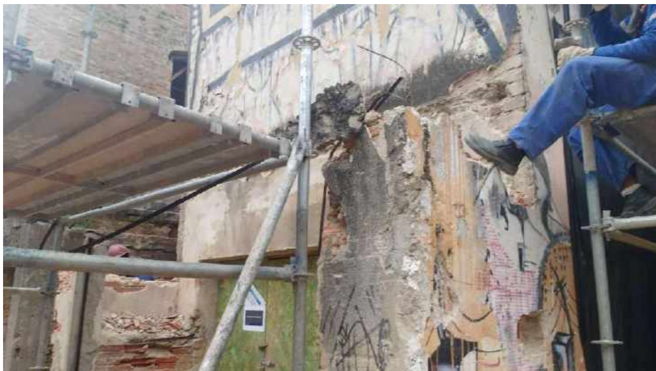
Foto 25: Demolições das alvenarias - Casa 05.
