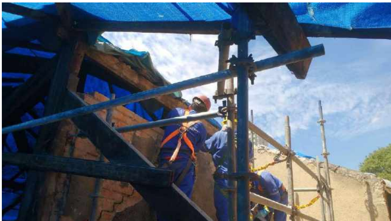
Foto 15: Escoramento das alvenarias para execução de cinta.
