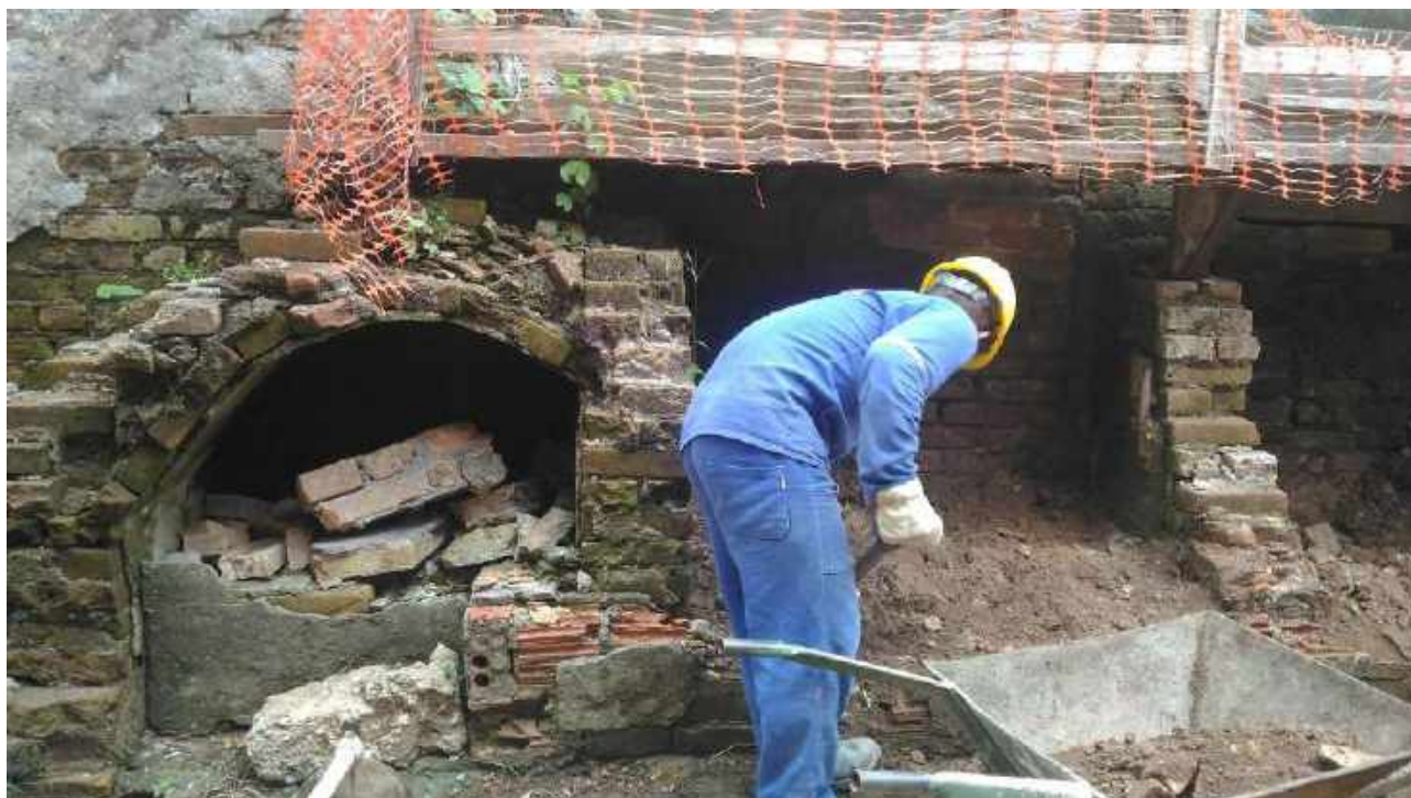
Foto 14: Limpeza dos porões da casa 6.
