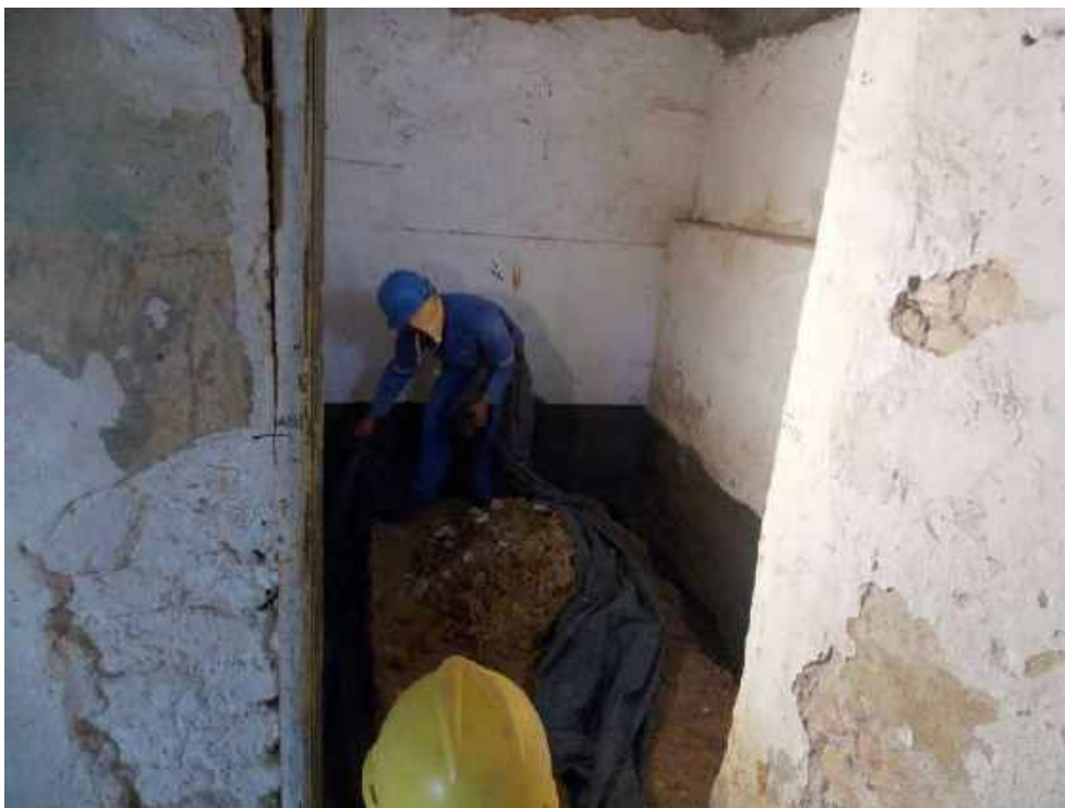
Foto 41 – Execução da drenagem do solo – Casa 06
