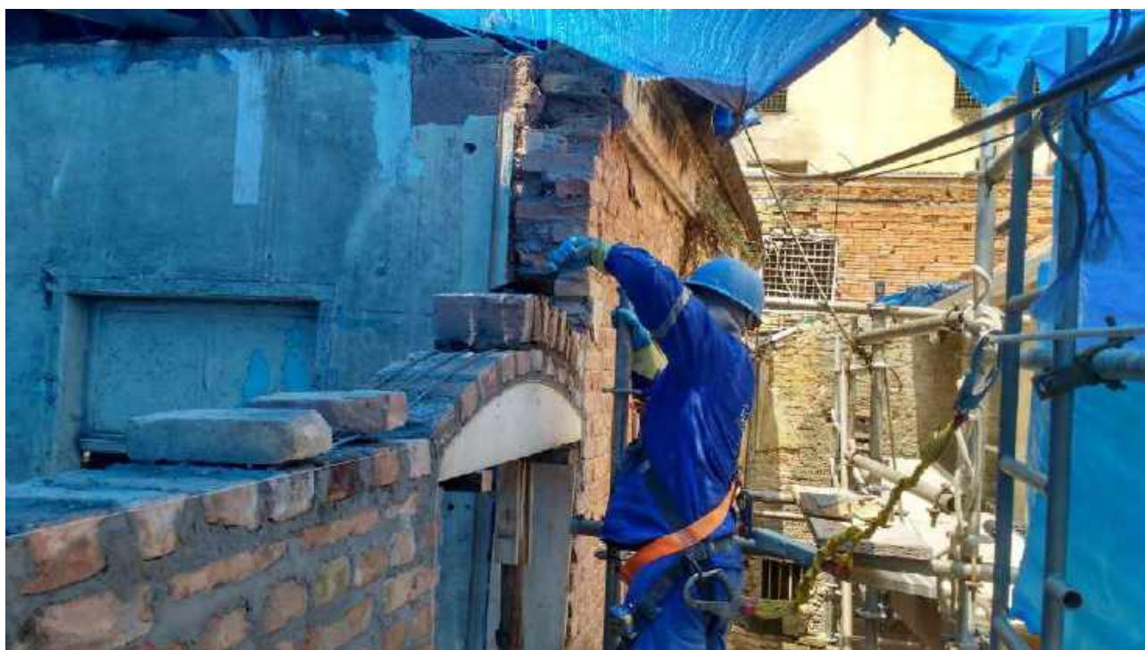
Foto 31: Remontagem da verga em arco da porta.
