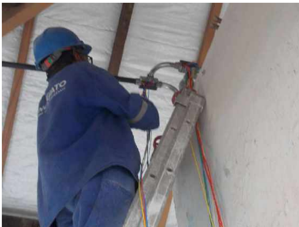
Foto 03 – Passagem dos cabos para instalação elétrica – Casa 05
