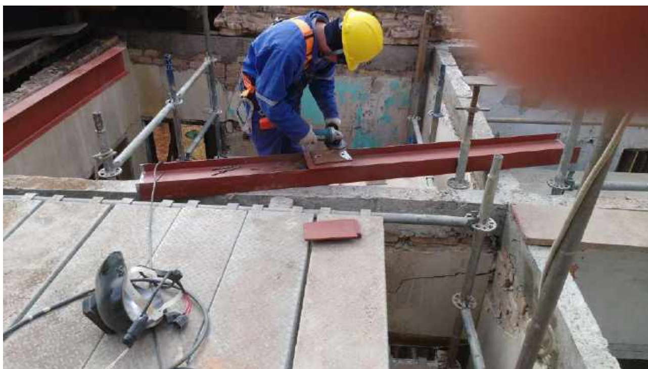
Foto 68: Execução da estrutura metálica da Casa 6
