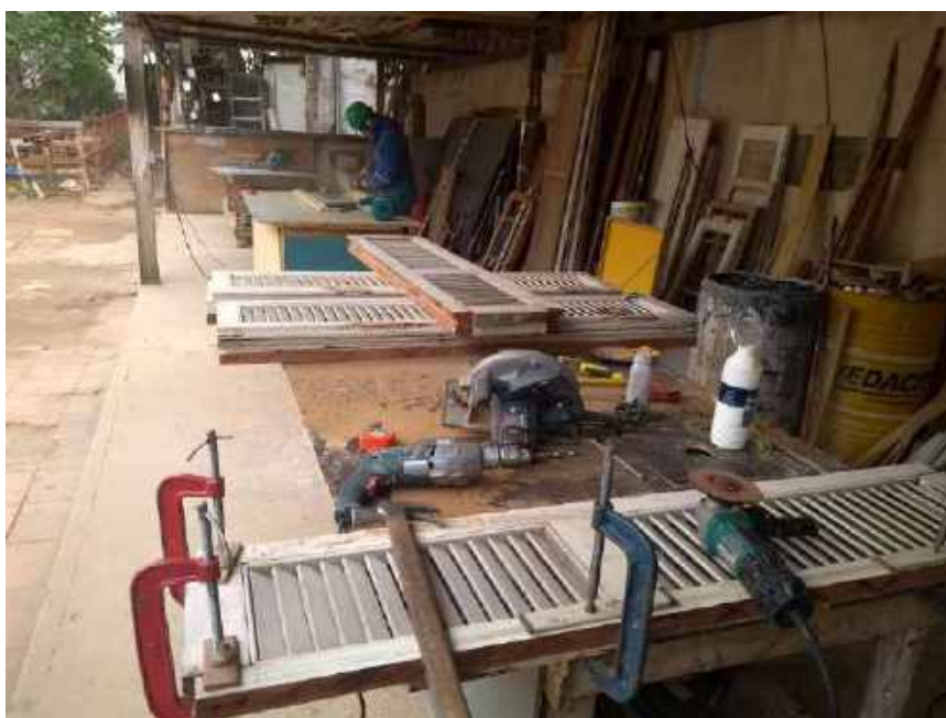
Foto 12 – Execução das venezianas de madeira – Casa 06
