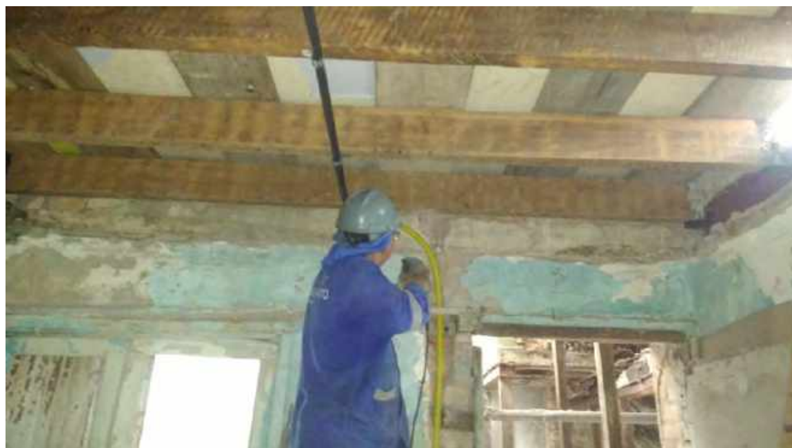
Foto 50 – Passagens das tubulações para instalação elétrica
