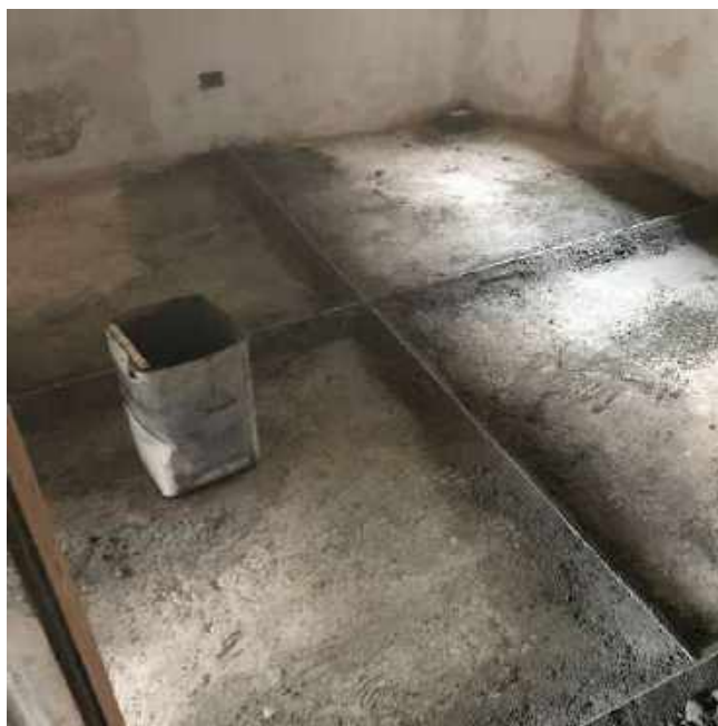
Foto 55- Instalação da junta de dilatação – Casa 06
