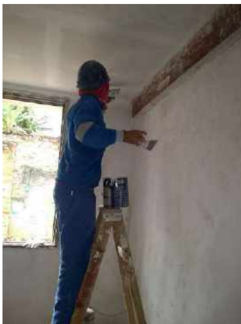
Foto 52 – Aplicação de massa corrida no forro – Casa 06
