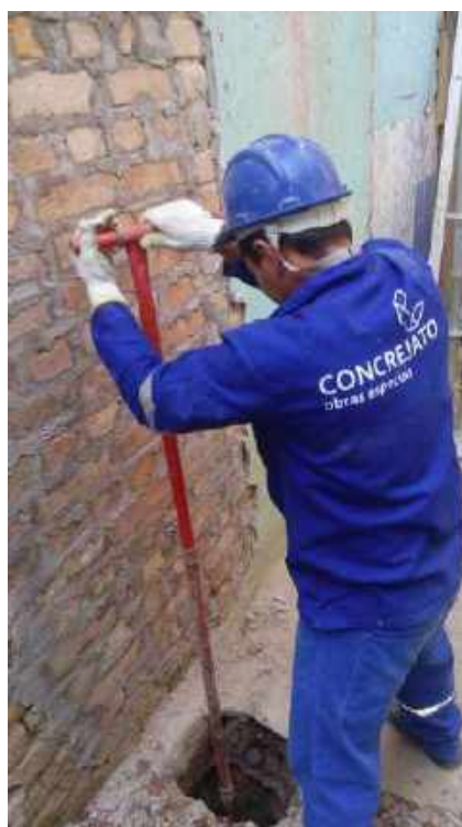
Foto 16 – Escavação manual para regularização do solo – Casa 06
