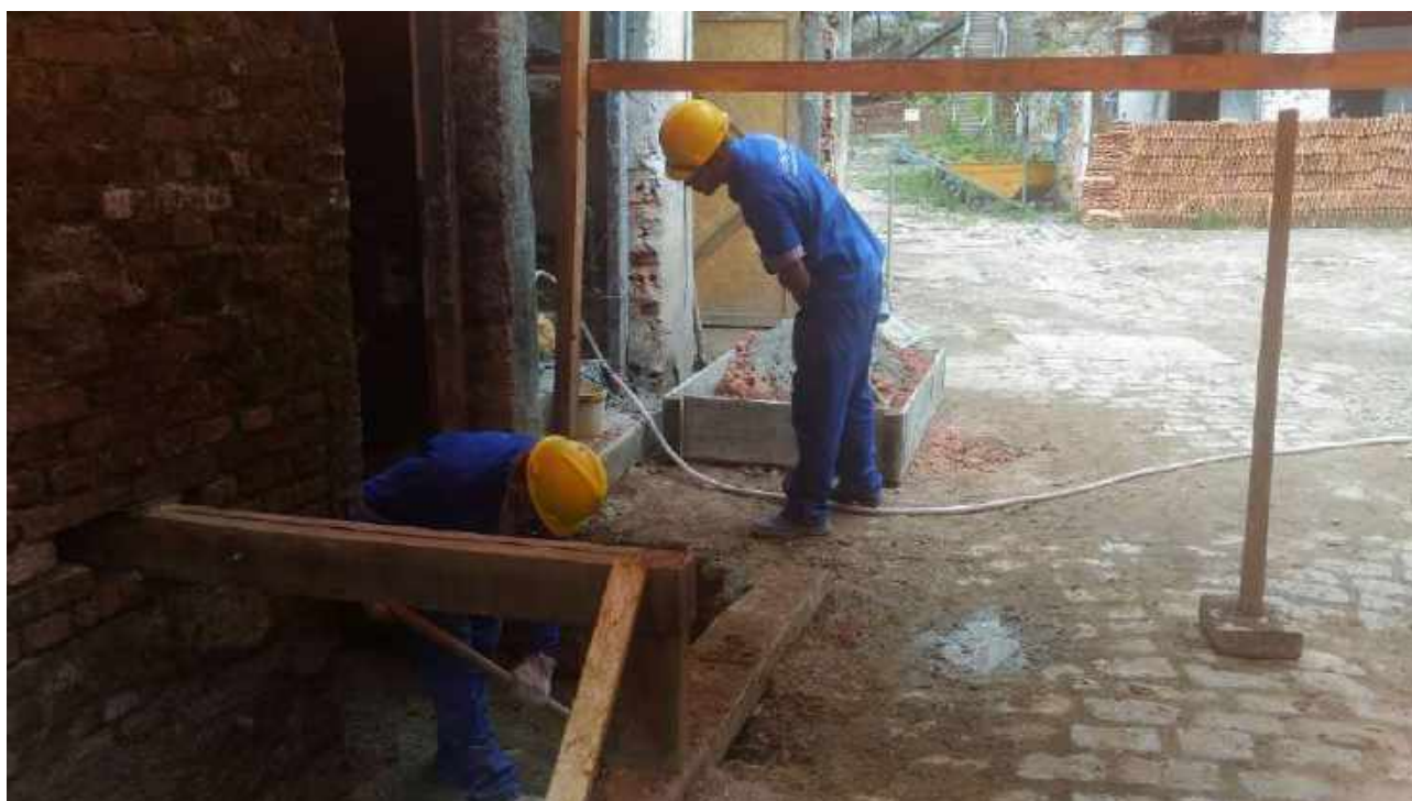
Foto 06: Compactação com solocimento.
