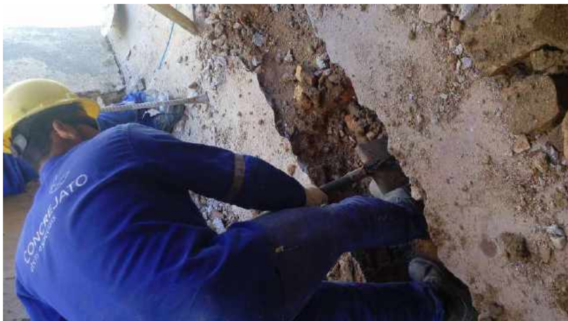
Foto 09 – Escavação manual para execução da alvenaria – Casa 06
