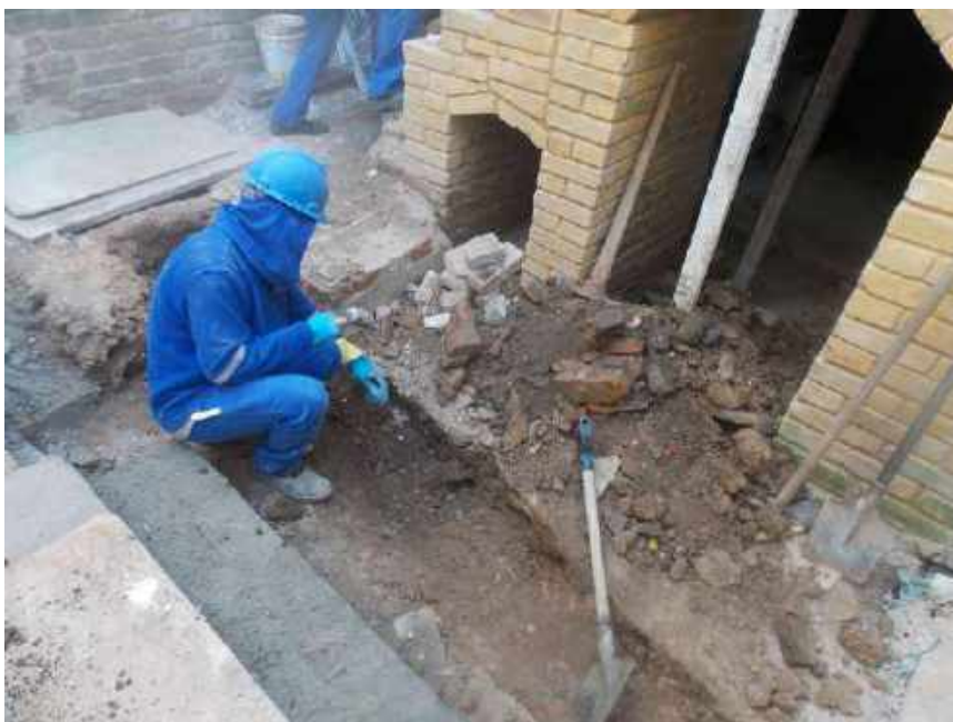
Foto 44 – Demolição manual para execução do piso cimentado – Casa 06
