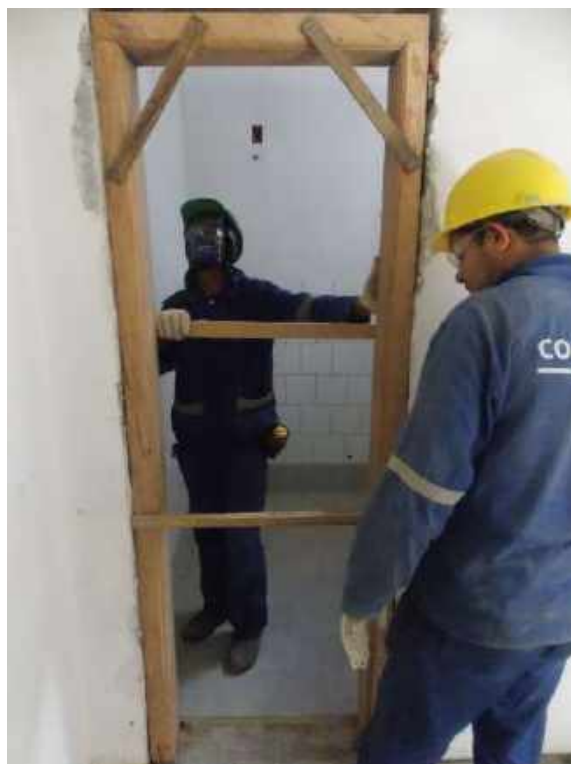
Foto 21 – Instalação dos batentes de madeira – Casa 06
