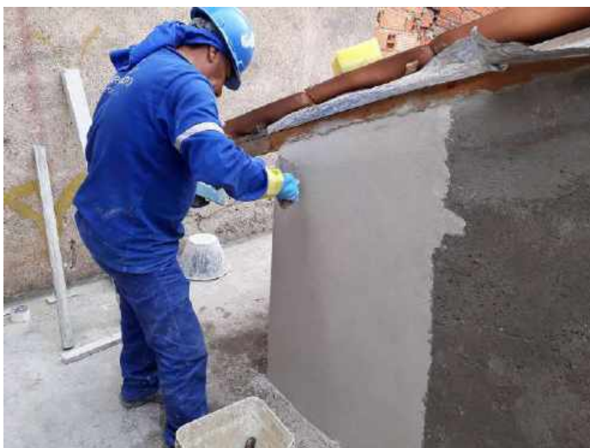
Foto 46 – execução da argamassa de acabamento – Casa 06
