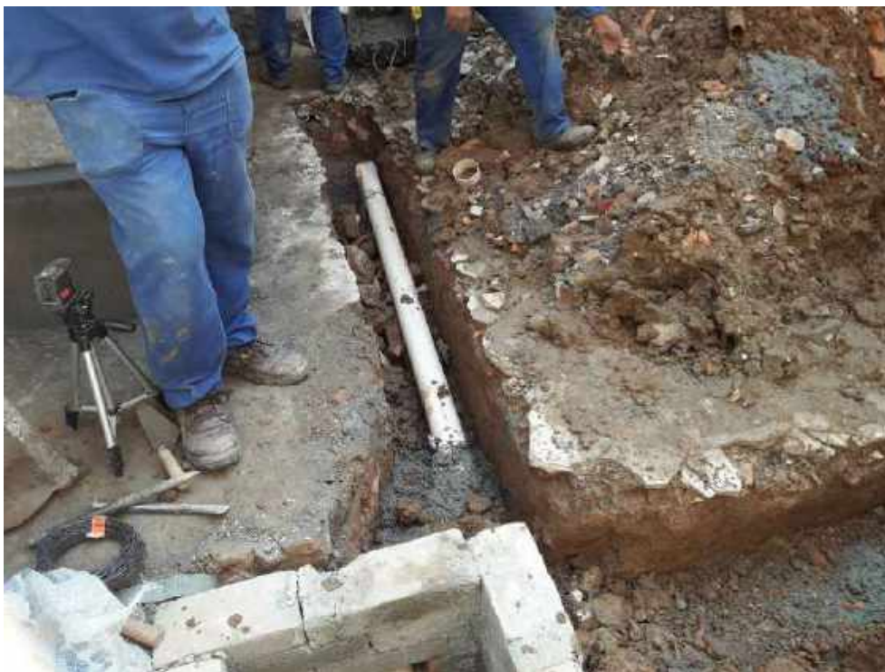
Foto 31 – Instalação das tubulações dos fundos – Casa 06
