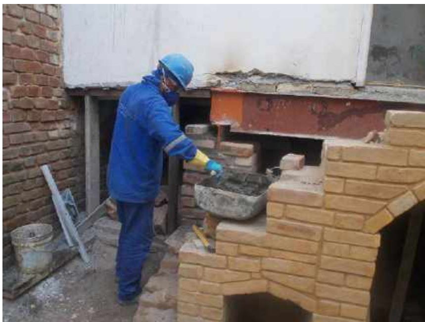
Foto 40 – Execução de reforço estrutural – Casa 06
