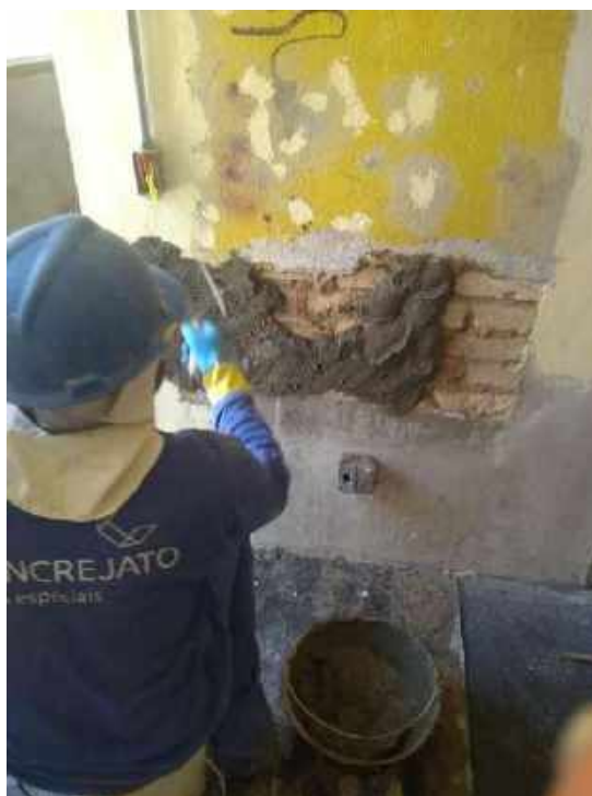
Foto 07 – Execução do emboço nas paredes internas – Casa 06
