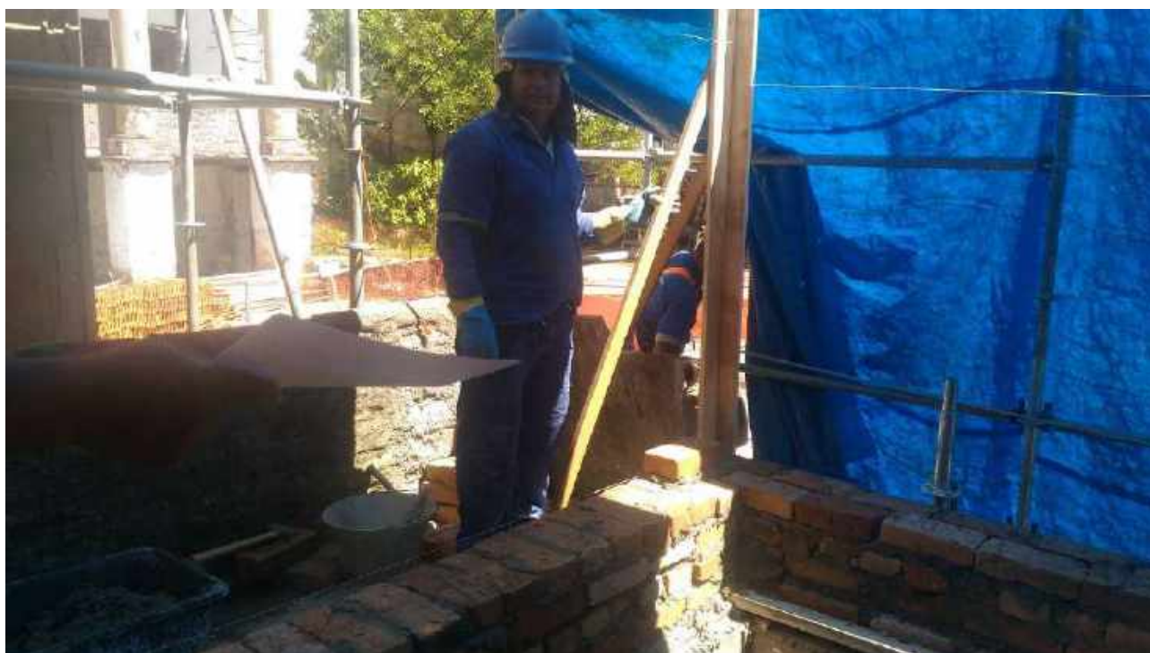
Foto 20: Remontagem da alvenaria
