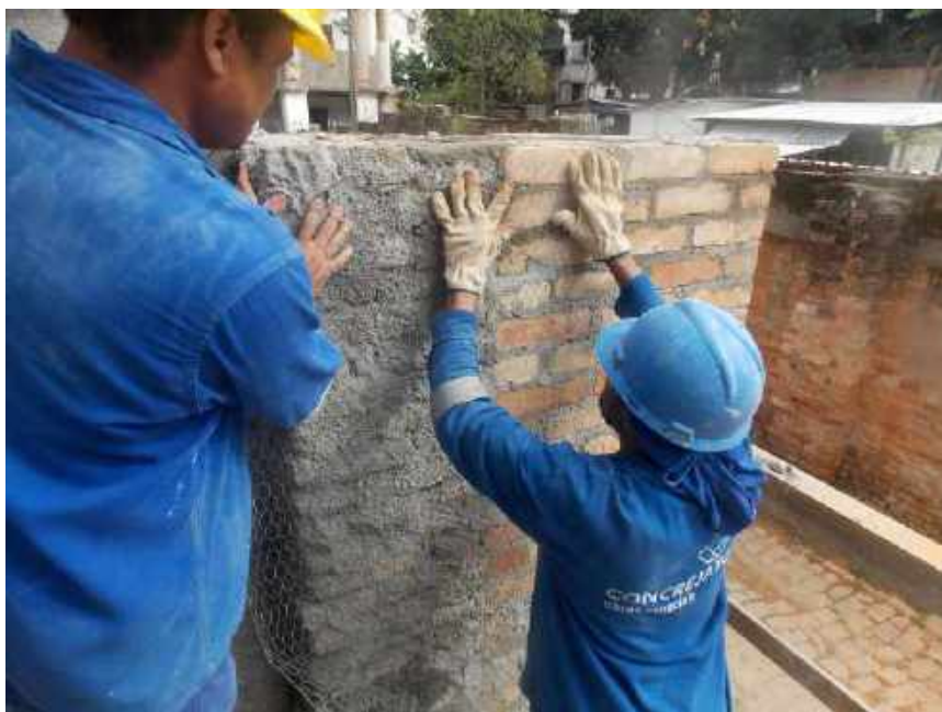
Foto 49 - Execução do acabamento na alvenaria nova – Casa 06
