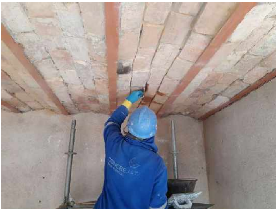
Foto 13 – Restauração dos tijolos da abobadilha – Casa 05
