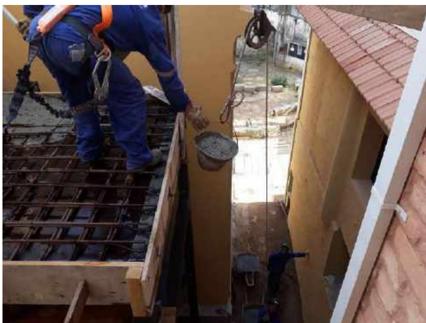
Foto 43 – Concretagem da cobertura do elevador – Casa 06
