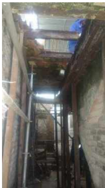
Foto 41 – Desmontagem da abobadilha – Casa 06
