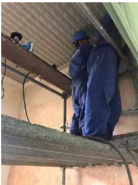
Foto 14- Instalação do roda-teto
