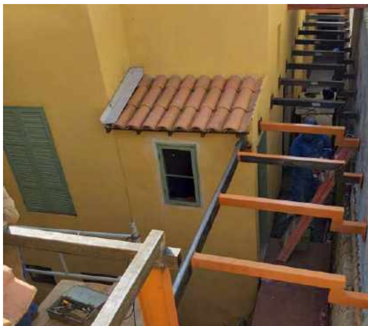
Foto 01 – Instalação da estrutura metálico para execução da cobertura de vidro – Casa 06
