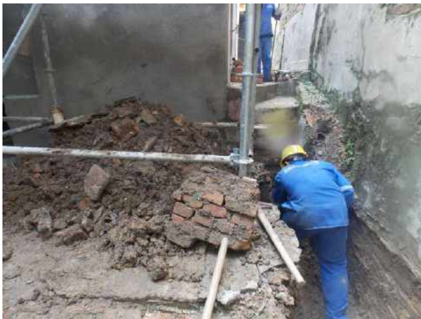
Foto 20 – Escavação manual nos fundos – Casa 06
