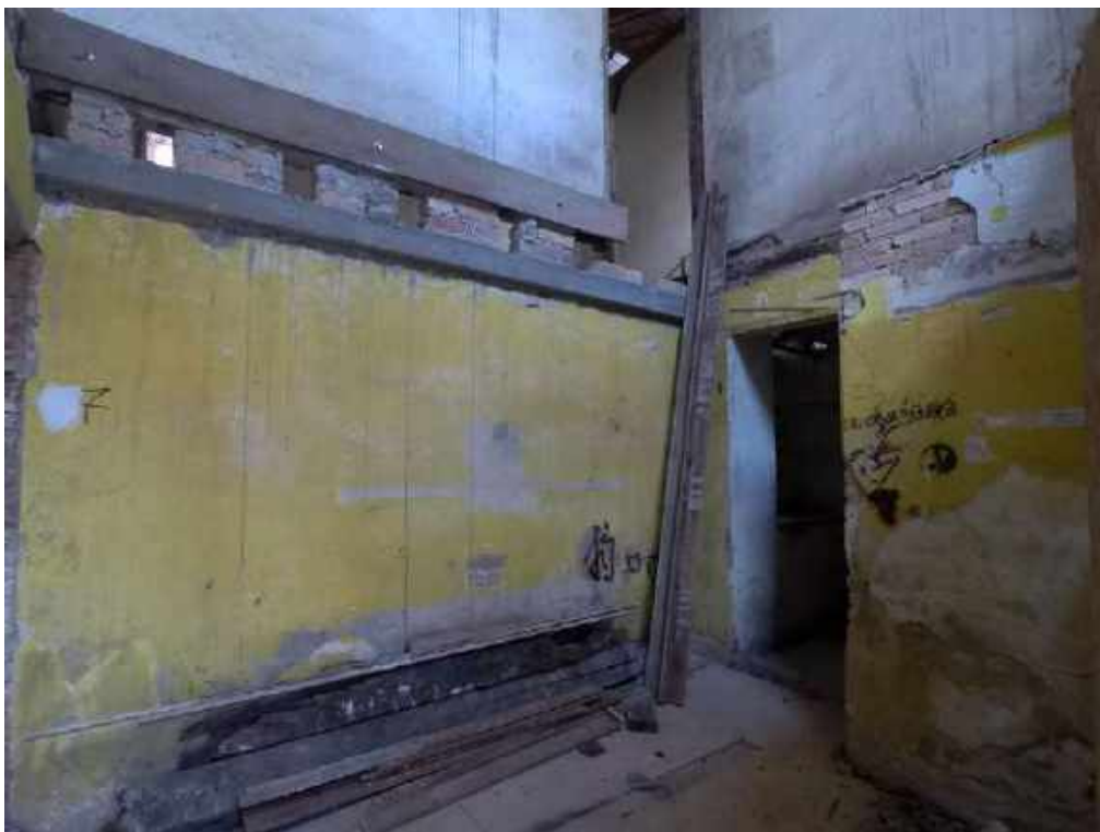
Foto 51 – Ajustes dos apoios das alvenarias – Casa 06
