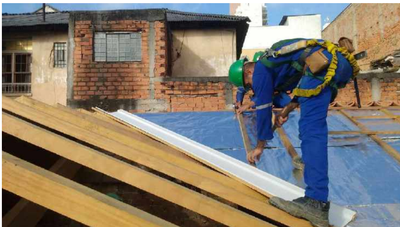
Foto 42: Instalação de manta aluminizada. Casa 06.
