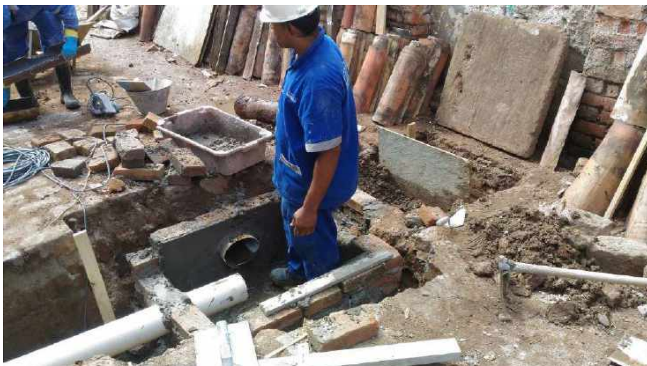
Foto 16: Execução de caixa de águas pluviais
