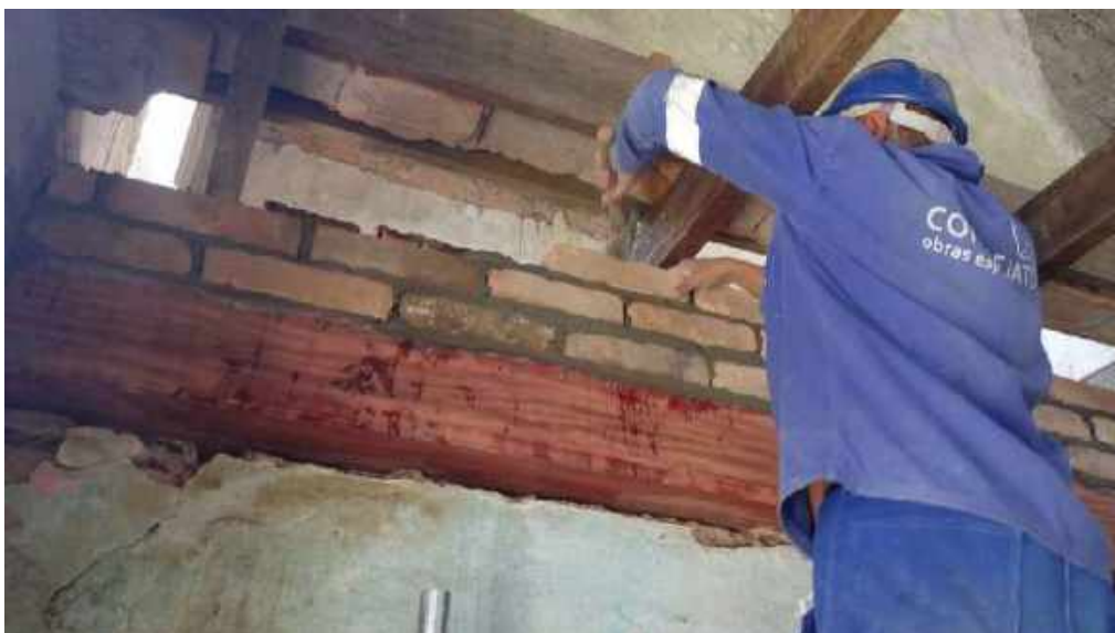
Foto 23 – Execução da alvenaria (recuperação da parede) – Casa 06
