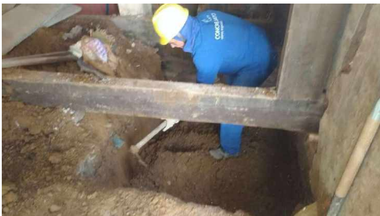
Foto 06: Escoramento e abertura de vala para reforço estrutura.
