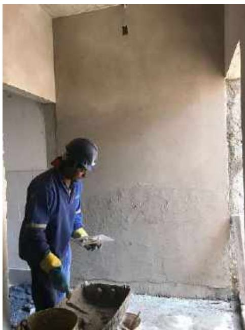
Foto 27 – Execução da argamassa de acabamento das paredes internas – Casa 06
