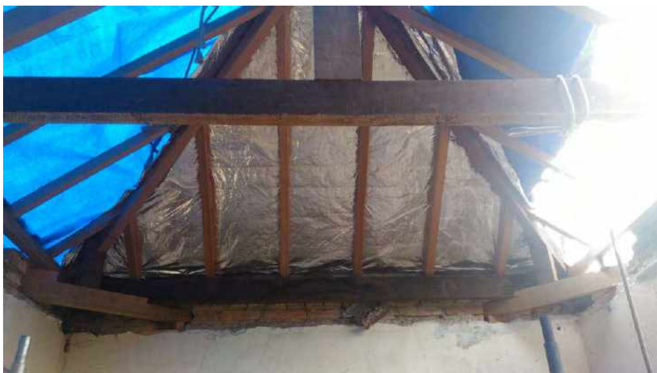
Foto 04: Instalação de manta aluminizada.
