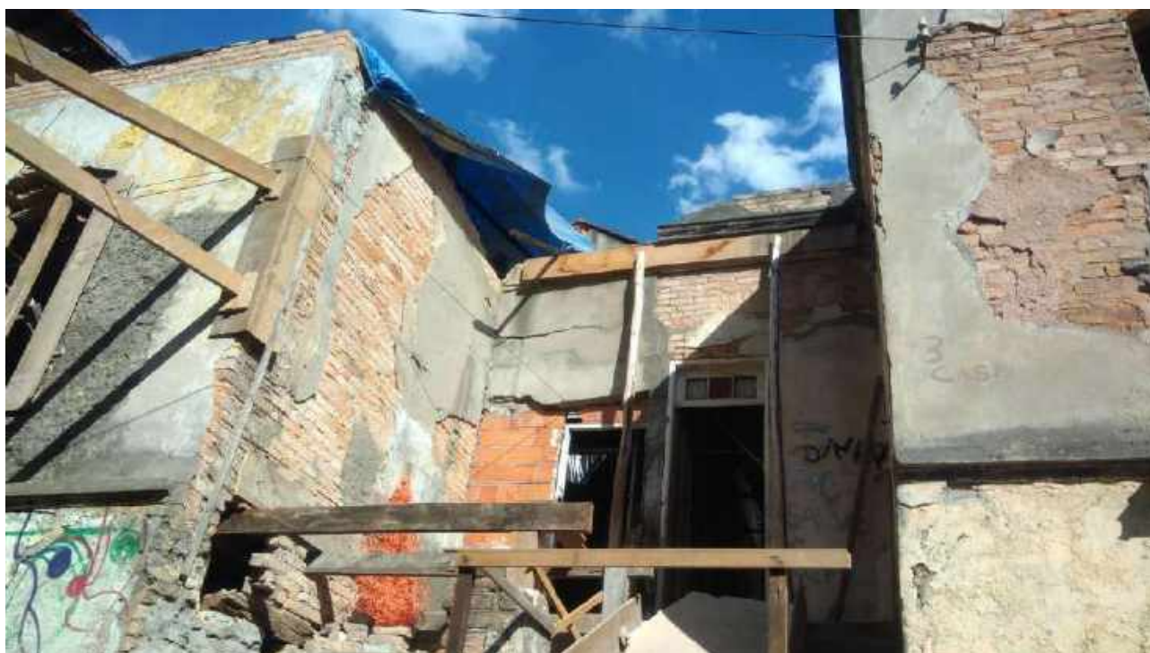
Foto 82: Substituição das peças danificadas da tesoura da Casa 6.
