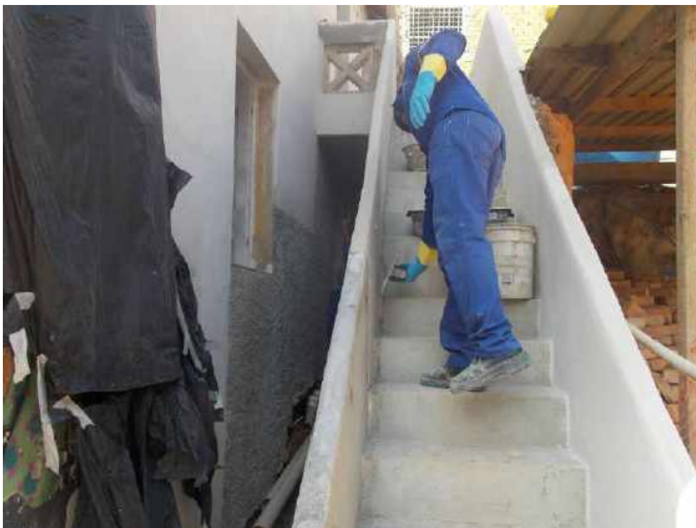
Foto 15 – Execução da argamassa de acabamento das escadas – Casa 05
