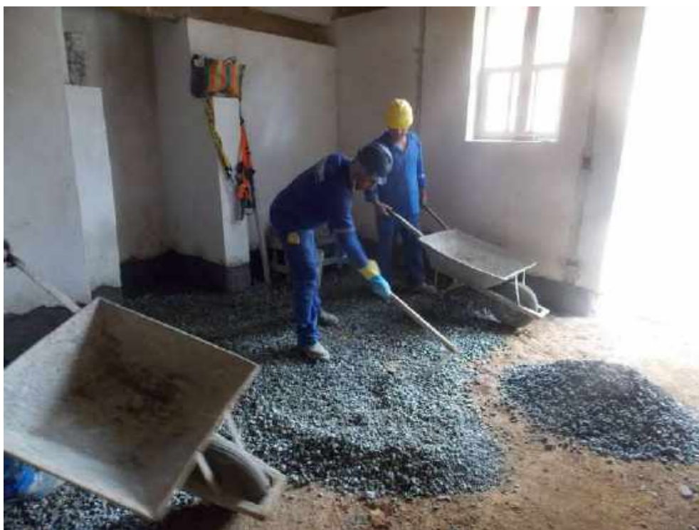
Foto 33 – Execução do contra piso – Casa 06
