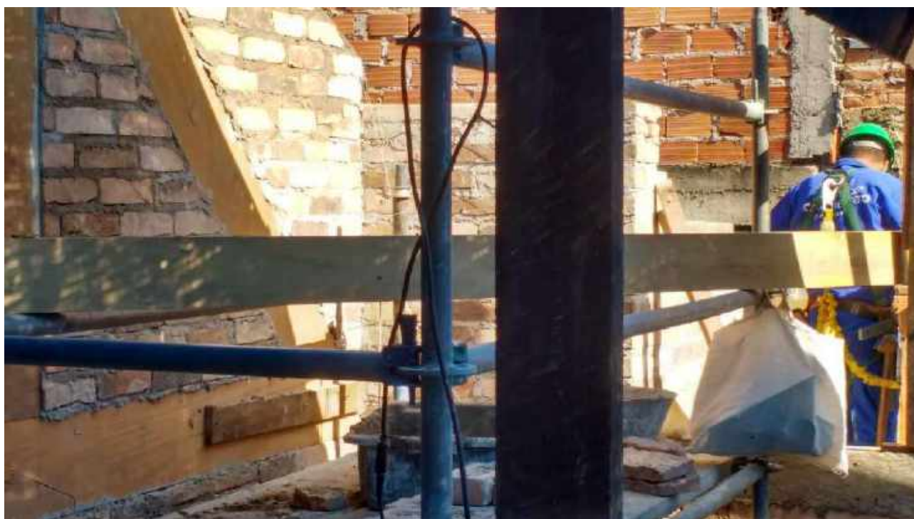
Foto 11: Substituição das peças danificadas da tesoura da Casa 6.
