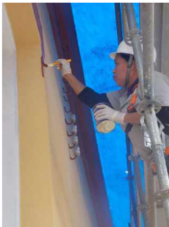
Foto 18 – Pintura lisa dos tijolos e molduras da fachada – Casa 06
