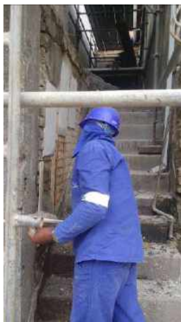
Foto 40 - Teste de revestimento na fachada – Casa 06
