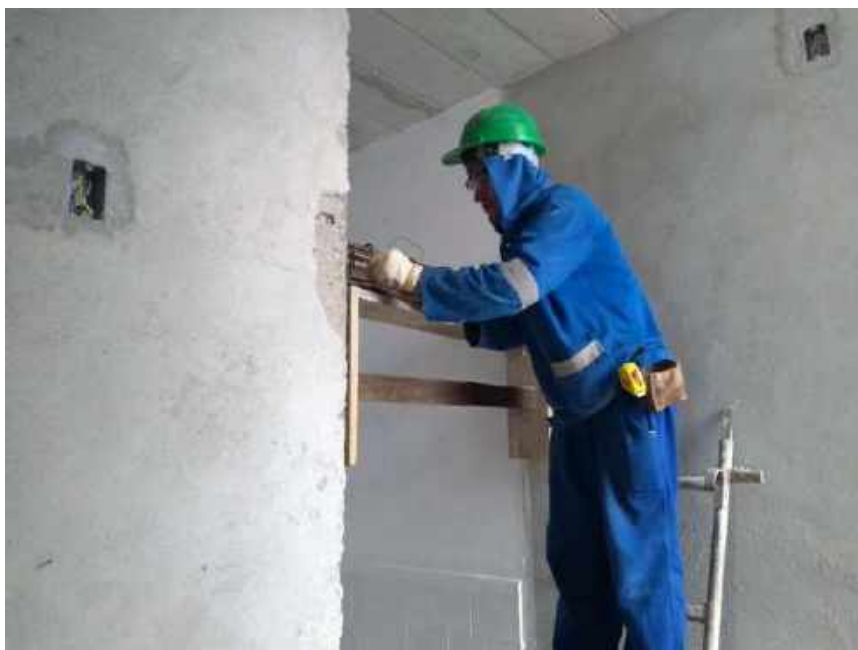
Foto 61 – Execução da forma para verga da porta – Casa 06
