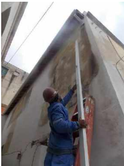
Foto 05 – Instalação das descidas de água fachada lateral – Casa 05
