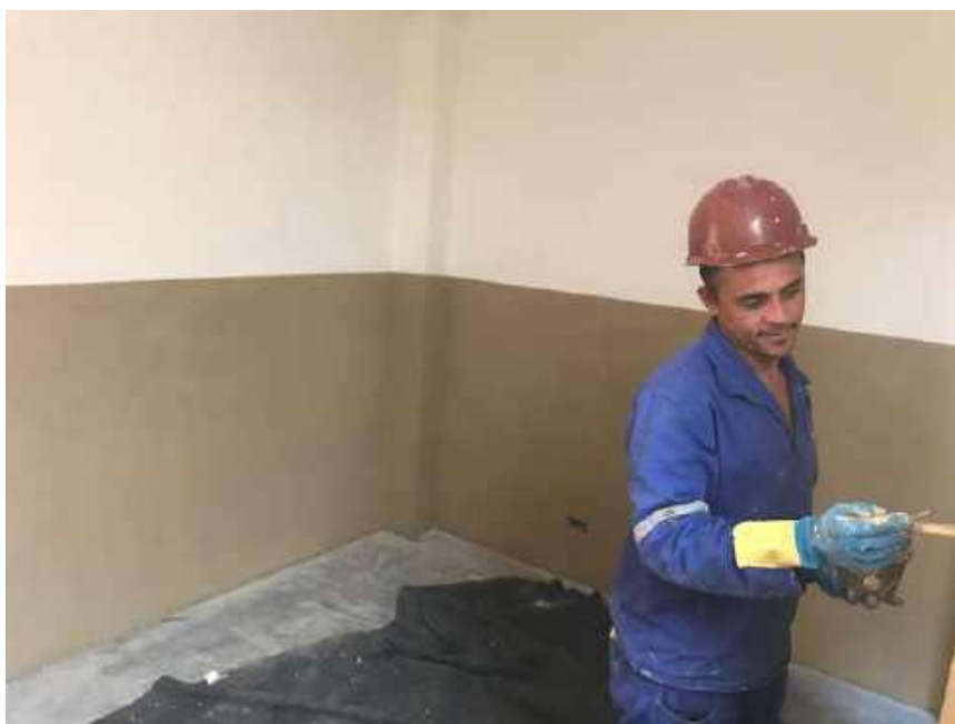
Foto 40 – Pintura lisa das paredes internas – Casa 06
