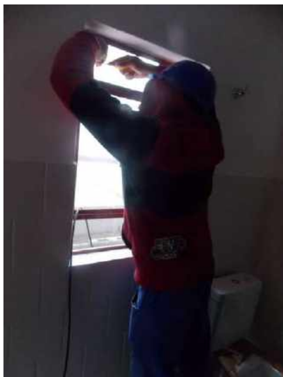
Foto 20 – Instalação da esquadria metálica – Casa 05
