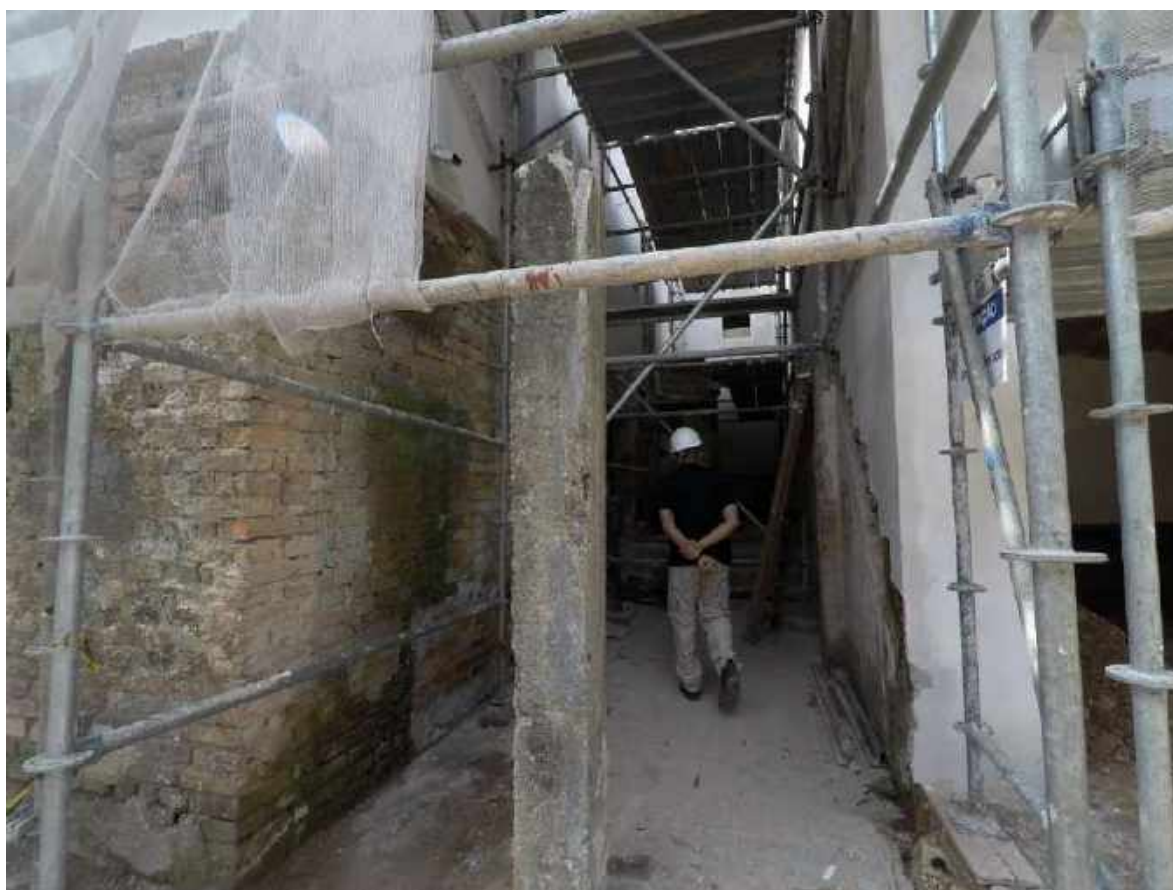
Foto 42– Demolição da escadaria e abobadilha – Casa 06
