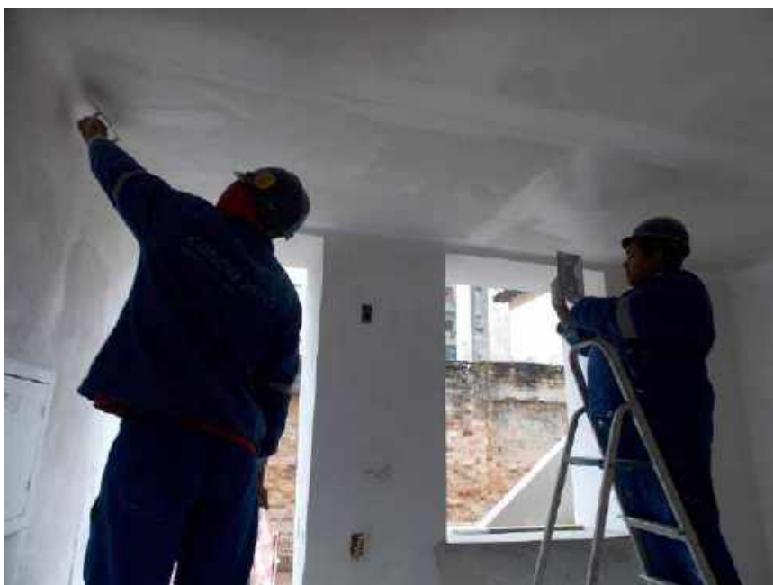
Foto 53 – Aplicação de massa corrida no forro – Casa 06
