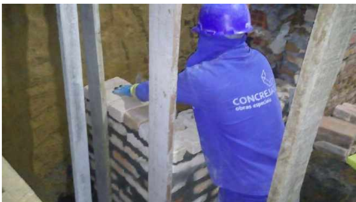
Foto 12 – Elevação da alvenaria externa após escavação do fosso do elevador
