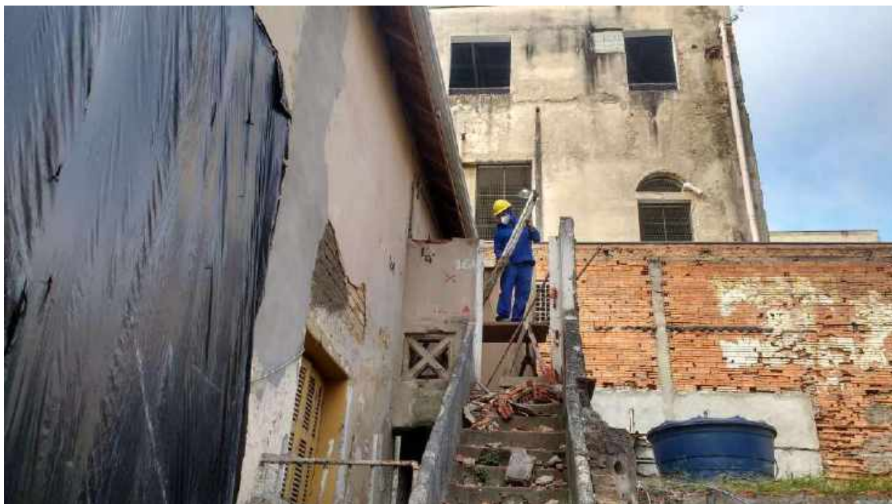
Foto 49: Substituição das peças danificadas da tesoura da Casa 6.
