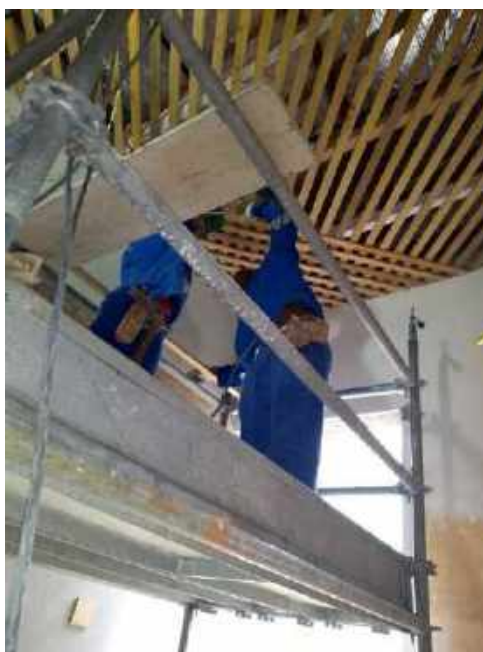
Foto 30 – Execução do forro treliçado de madeira – Casa 06
