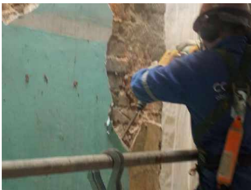
Foto 36 – Remoção da argamassa existente – Casa 06
