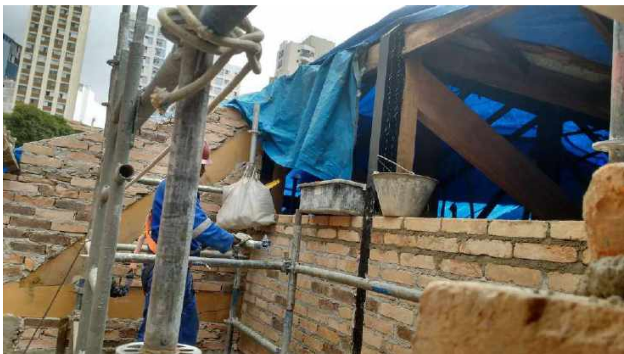
Foto 14: Remontagem da alvenaria da fachada dos fundos.
