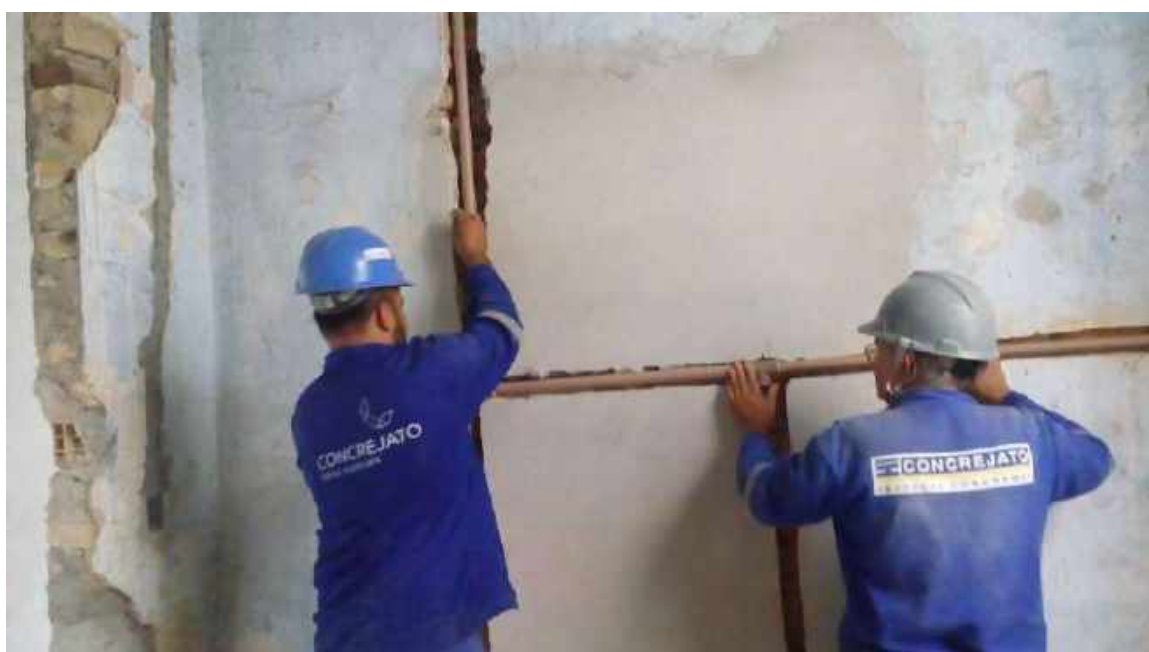
Foto 20 – Instalação da hidráulica – Casa 06
