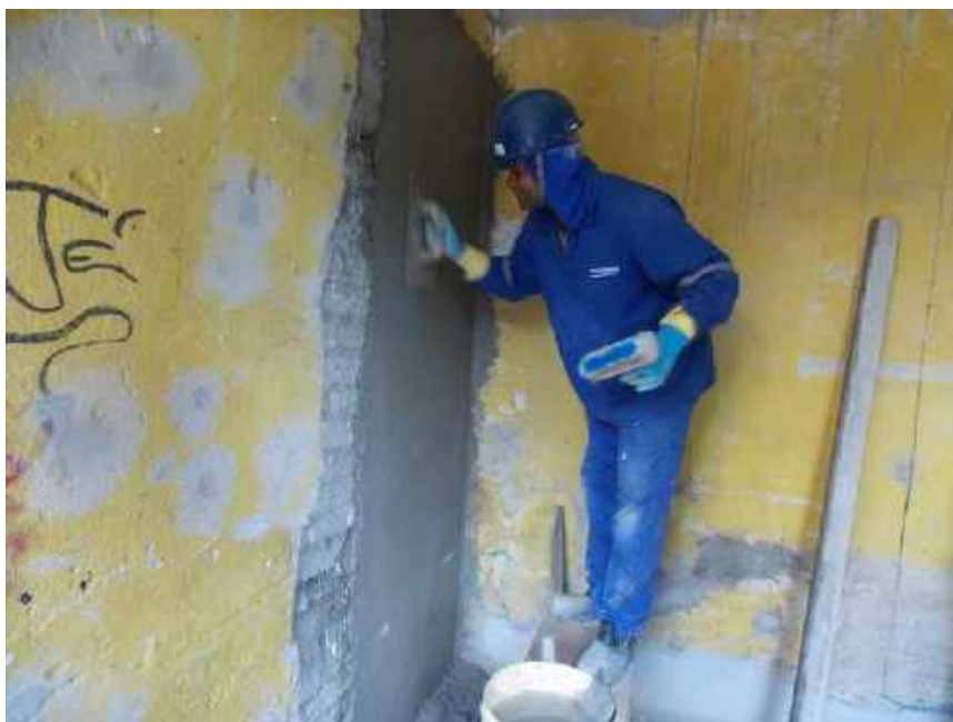
Foto 33 – Execução da argamassa de acabamento, após a elevação da alvenaria – Casa 06
