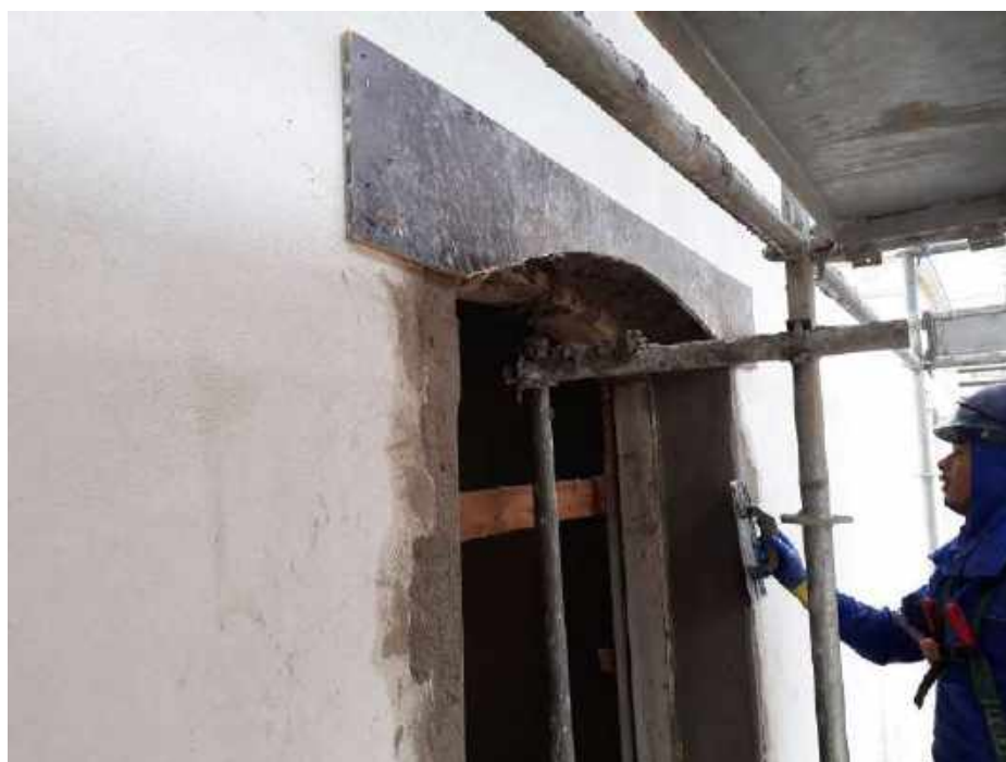
Foto 14– Regularização das portas e das janelas – Casa 06
