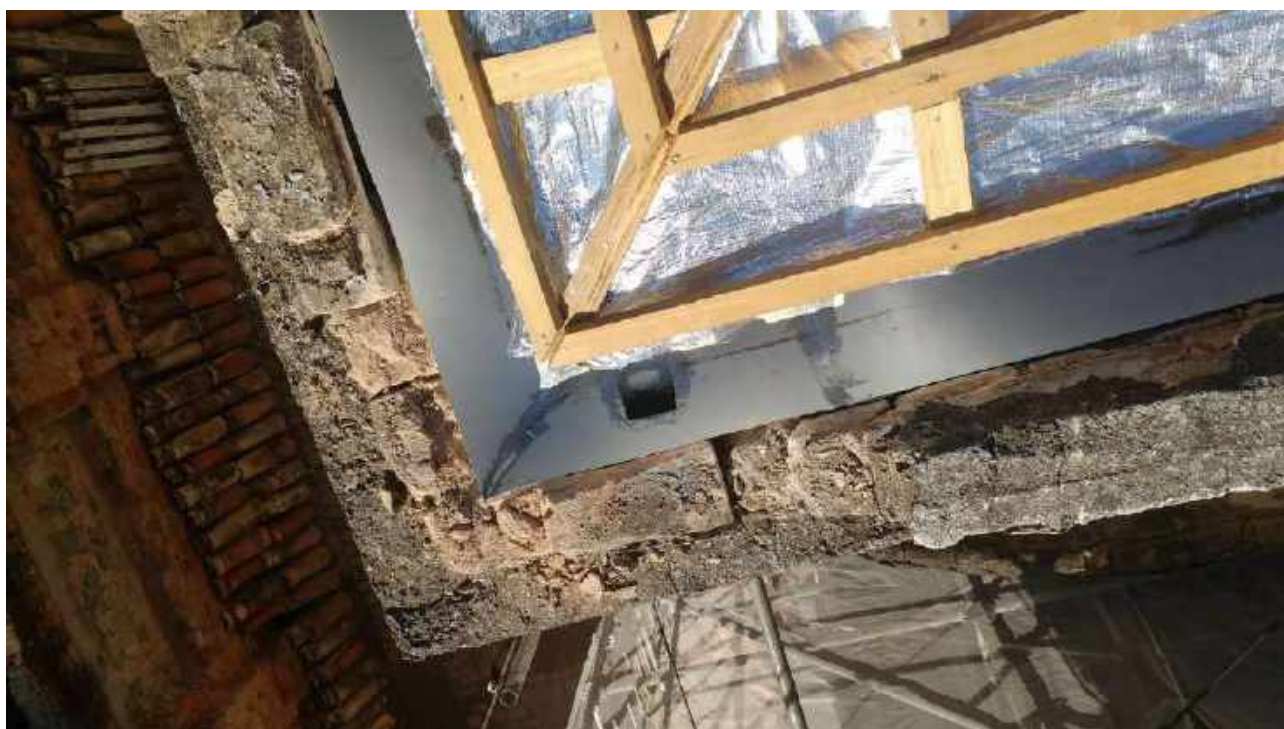
Foto 48: Instalação de calhas - Casa 06.
