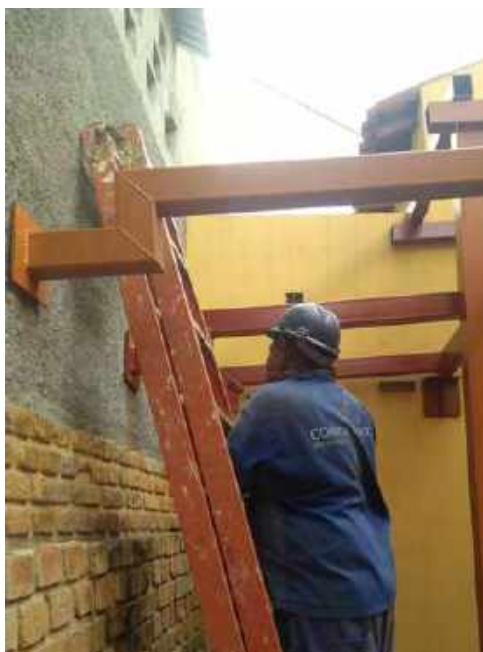
Foto 03 – Pintura lisa da estrutura metálico – Casa 06
