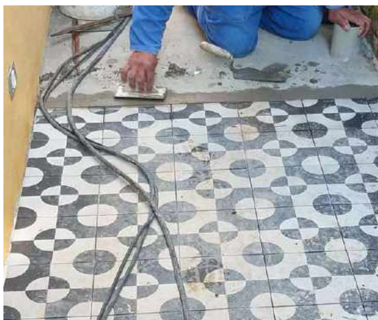
Foto 24 – Instalação do ladrilho hidráulico – Casa 06
