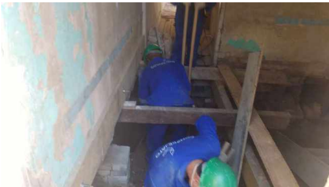
Foto 39 – Execução de escoramento – Casa 06
