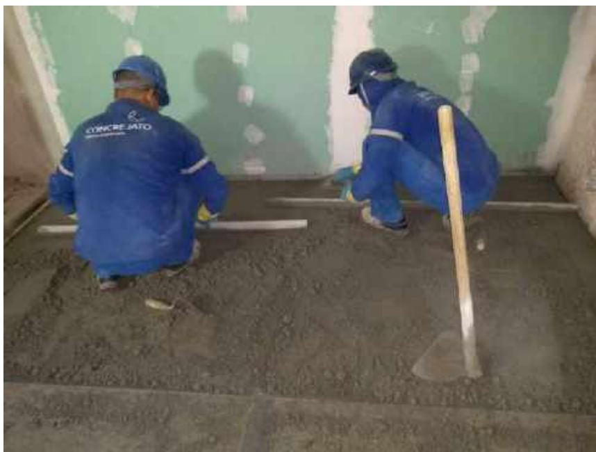
Foto 25 – Execução do piso cimentado – Casa 05
